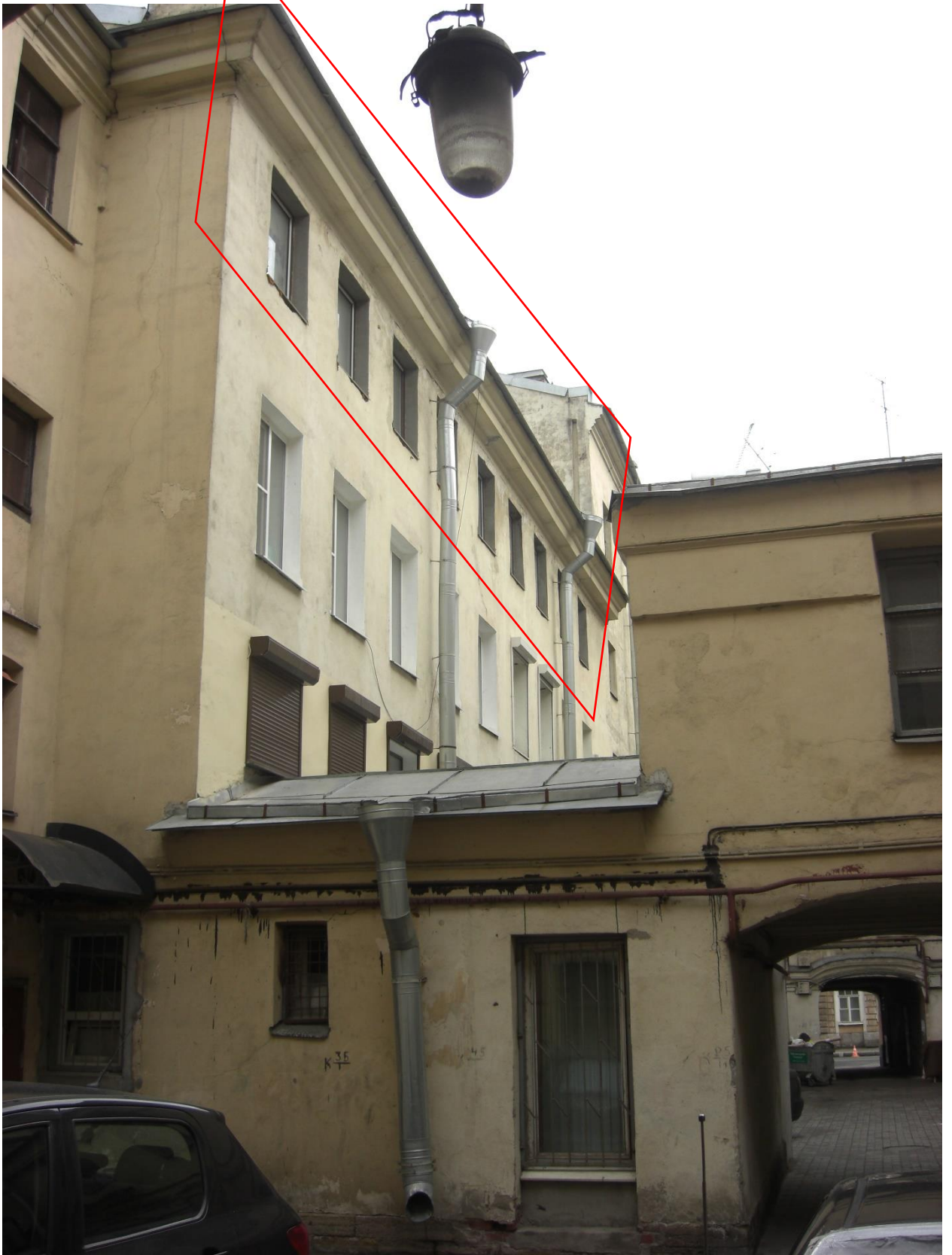
Фото 2. Выявленный объект культурного наследия «Дом И.А. Ушакова (доходный дом Петроградского Английского собрания)» расположенный по адресу: г. Санкт-Петербург, Миллионная ул., 17. Фасад дворового флигеля . Общий вид.
