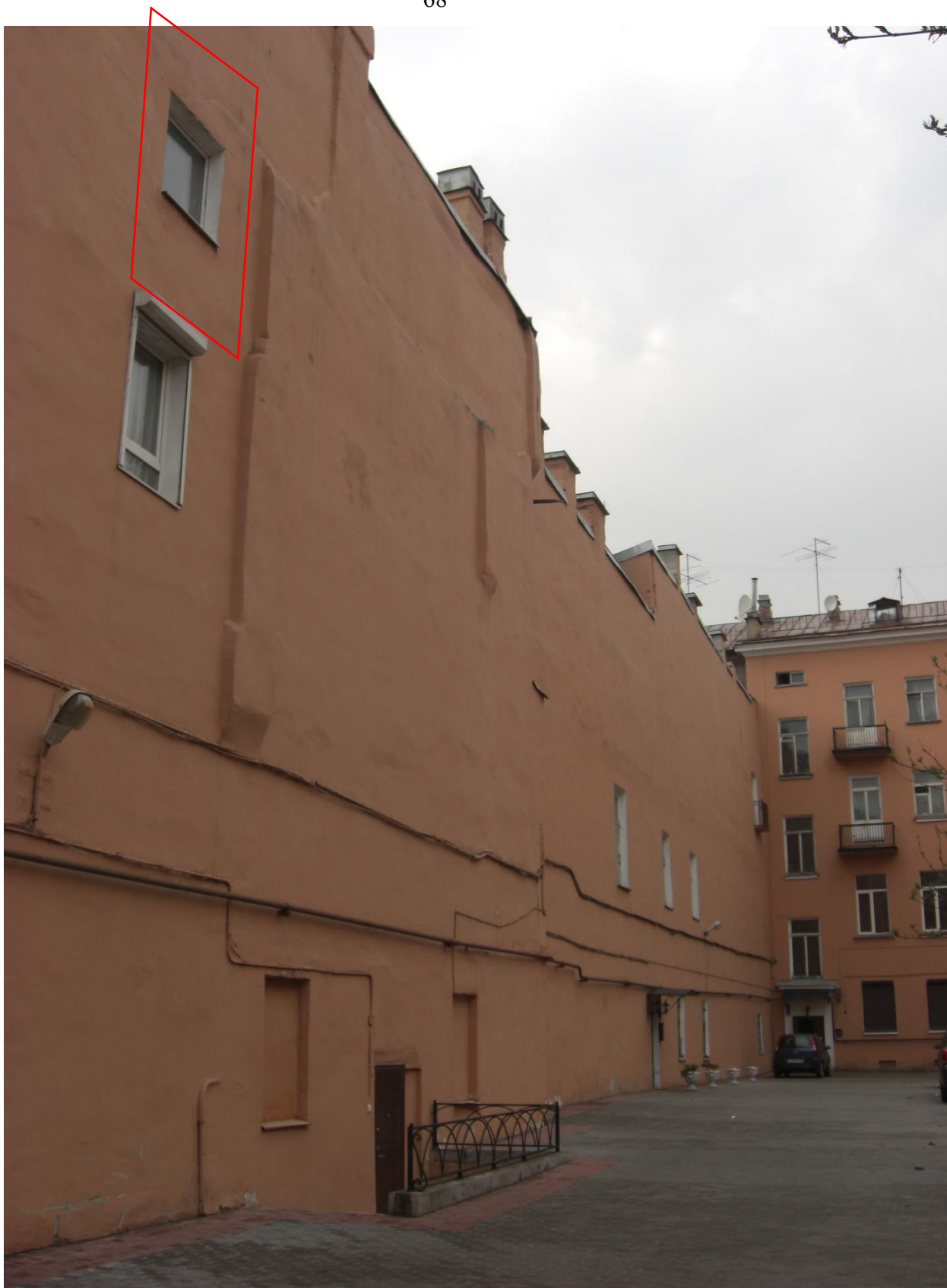
Фото 6. Выявленный объект культурного наследия «Дом И.А. Ушакова (доходный дом Петроградского Английского собрания)» расположенный по адресу: г. Санкт-Петербург, Миллионная ул., 17. Брандмауэр дворового флигеля . Общий вид.
