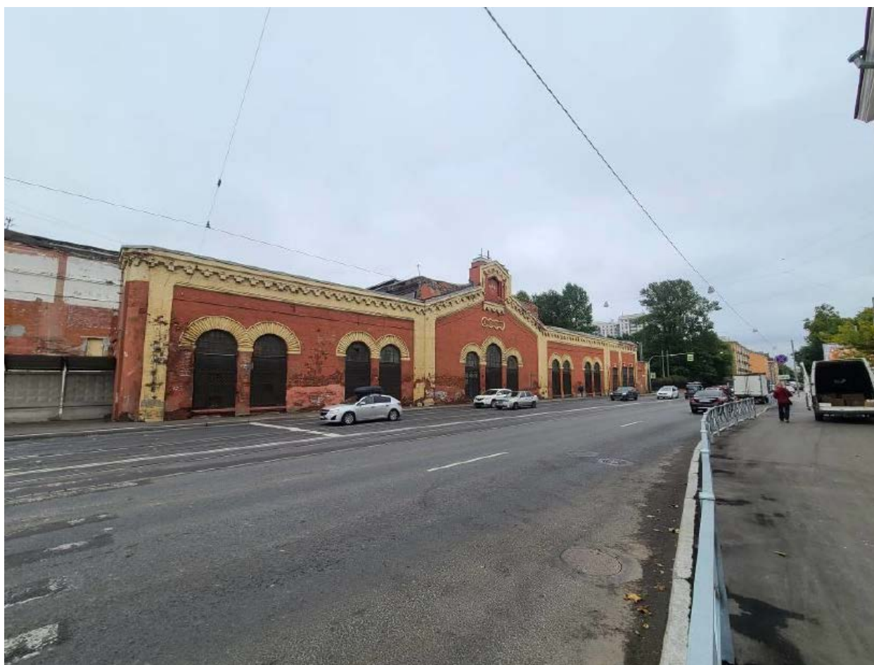
3. Вид на объект культурного наследия регионального значения «Прокатная и сталелитейная мастерская «Невского железоделательного, механического и корабельного завода» («Невского железопрокатного завода» П.Ф. Семянникова и В.А. Полетики)», расположенного по адресу: г. Санкт-Петербург, проспект Обуховской Обороны, дом 38, лит. В, с северо-запада. 30.09.2022
