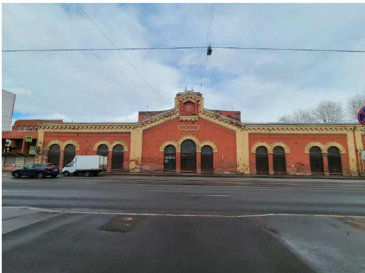
2. Юго-западный фасад объекта культурного наследия регионального значения «Прокатная и сталелитейная мастерская «Невского железодельного, механического и корабельного завода» («Невского железопрокатного завода» П.Ф. Семянникова и В.А. Полетики)», расположенного по адресу: г. Санкт-Петербург, проспект Обуховской Обороны, дом 38, лит. В. Центральная часть. 30.09.2022
