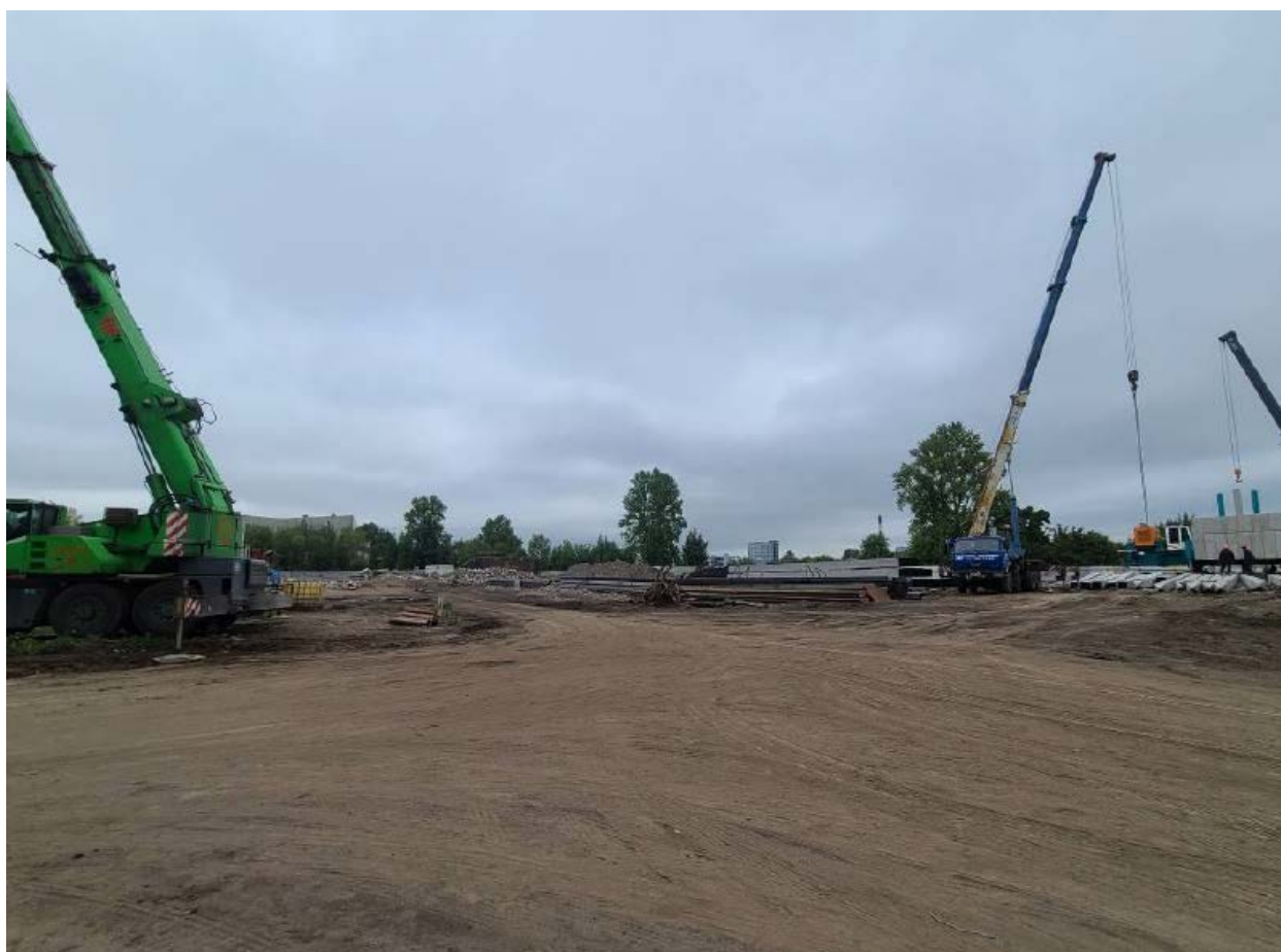
6. Вид от объекта культурного наследия регионального значения «Прокатная и сталелитейная мастерская «Невского железоделательного, механического и корабельного завода» («Невского железопрокатного завода» П.Ф. Семянникова и В.А. Полетики)», расположенного по адресу: г. Санкт-Петербург, проспект Обуховской Обороны, дом 38, лит. В, на зону производства работ. 30.09.2022
