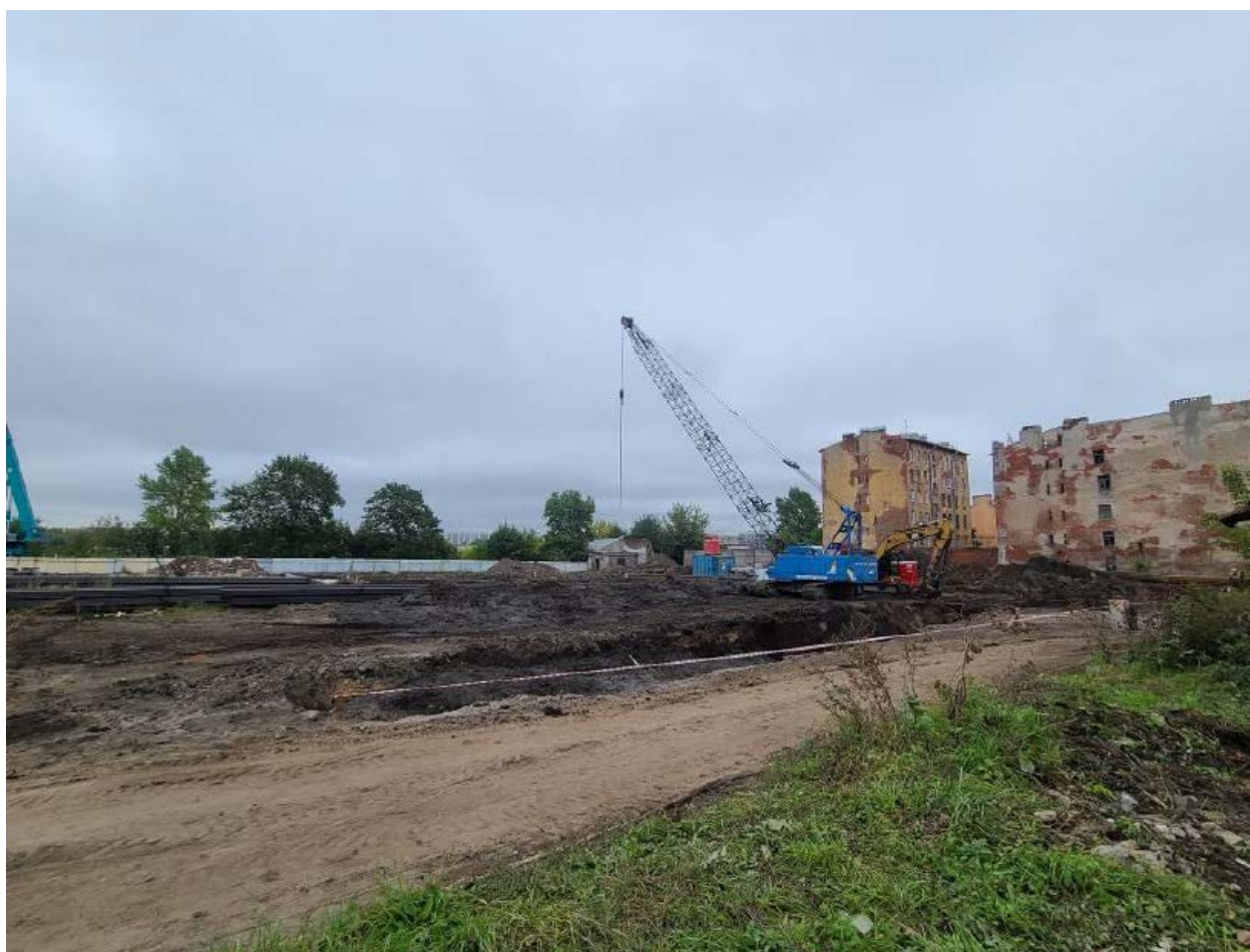
5. Вид от объекта культурного наследия регионального значения «Прокатная и сталелитейная мастерская «Невского железоделательного, механического и корабельного завода» («Невского железопрокатного завода» П.Ф. Семянникова и В.А. Полетики)», расположенного по адресу: г. Санкт-Петербург, проспект Обуховской Обороны, дом 38, лит. В, на зону производства работ. 30.09.2022
