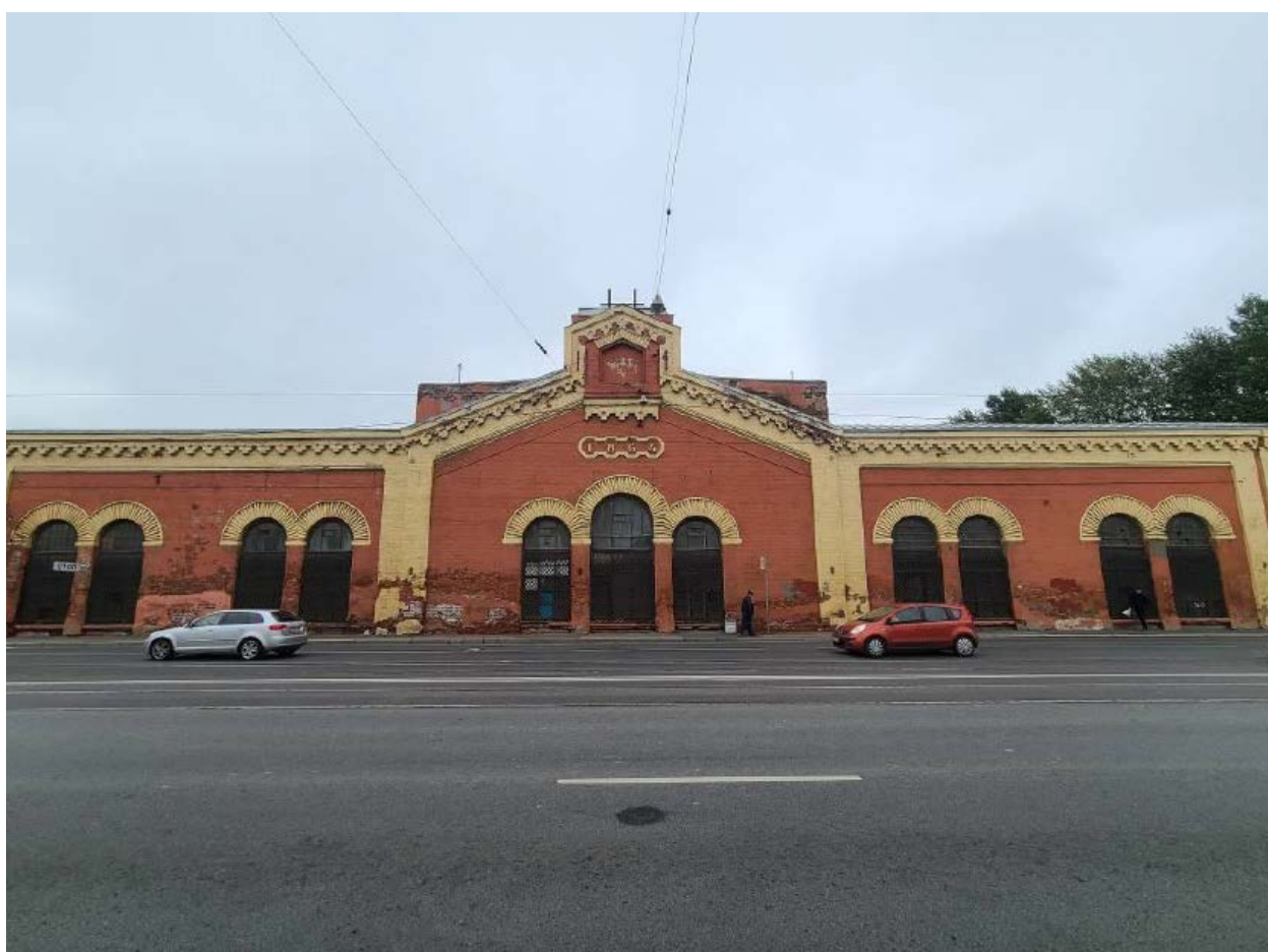
1. Юго-западный фасад объекта культурного наследия регионального значения «Прокатная и сталелитейная мастерская «Невского железоделательного, механического и корабельного завода» («Невского железопрокатного завода» П.Ф. Семянникова и В.А. Полетики)», расположенного по адресу: г. Санкт-Петербург, проспект Обуховской Обороны, дом 38, лит. В. 30.09.2022
