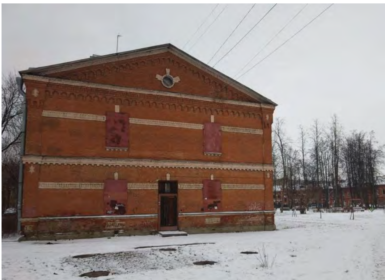
Фото 3. Восточный торцевой фасад.
