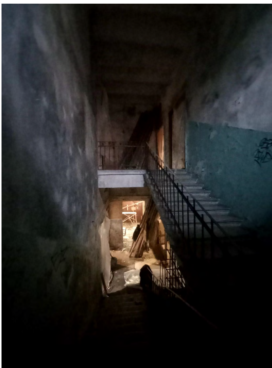
Фото 23. Вид с площадки между 1 и 2 этажами.
