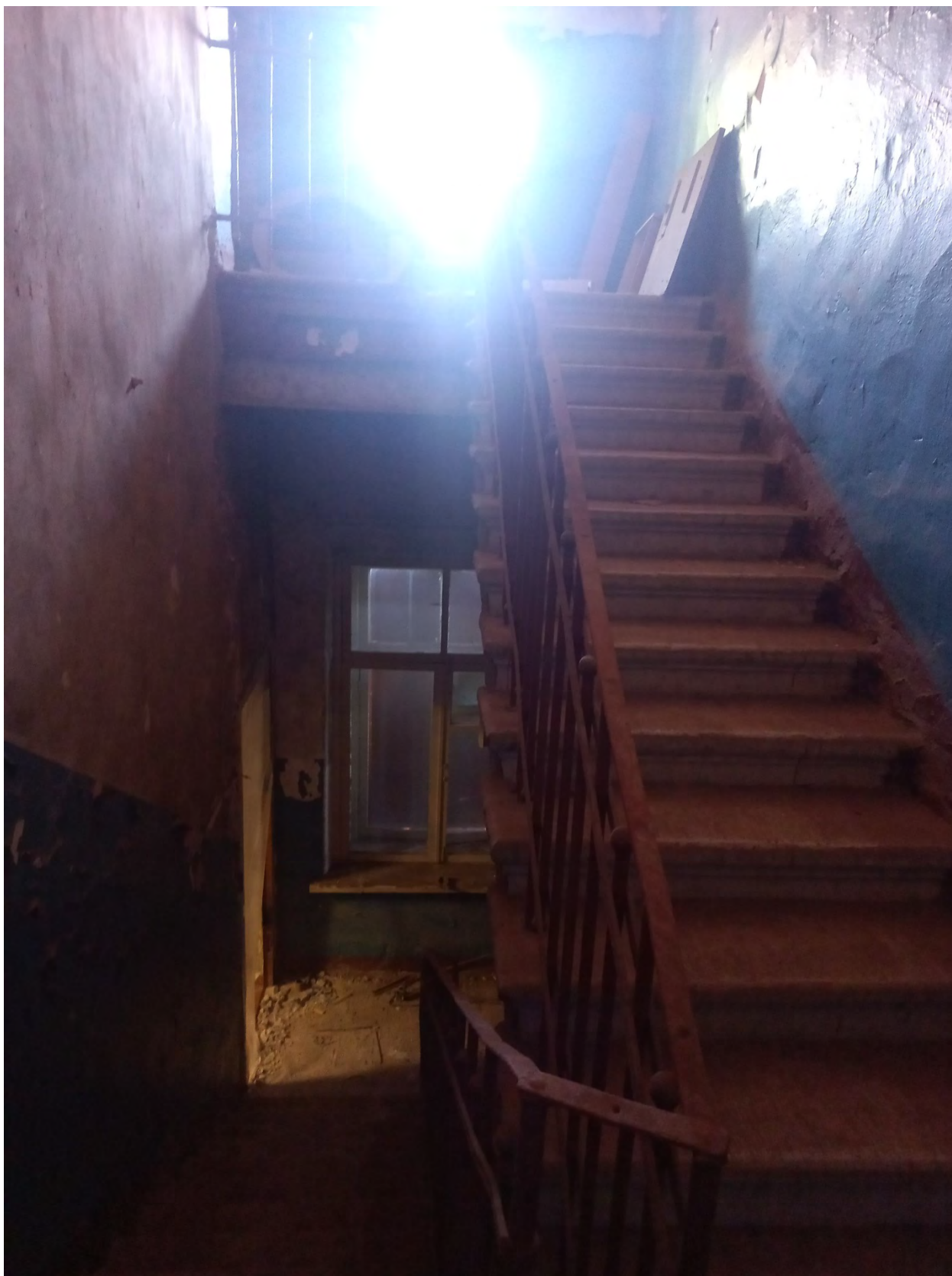
Фото 30. Подъем со второго этажа на чердак.
