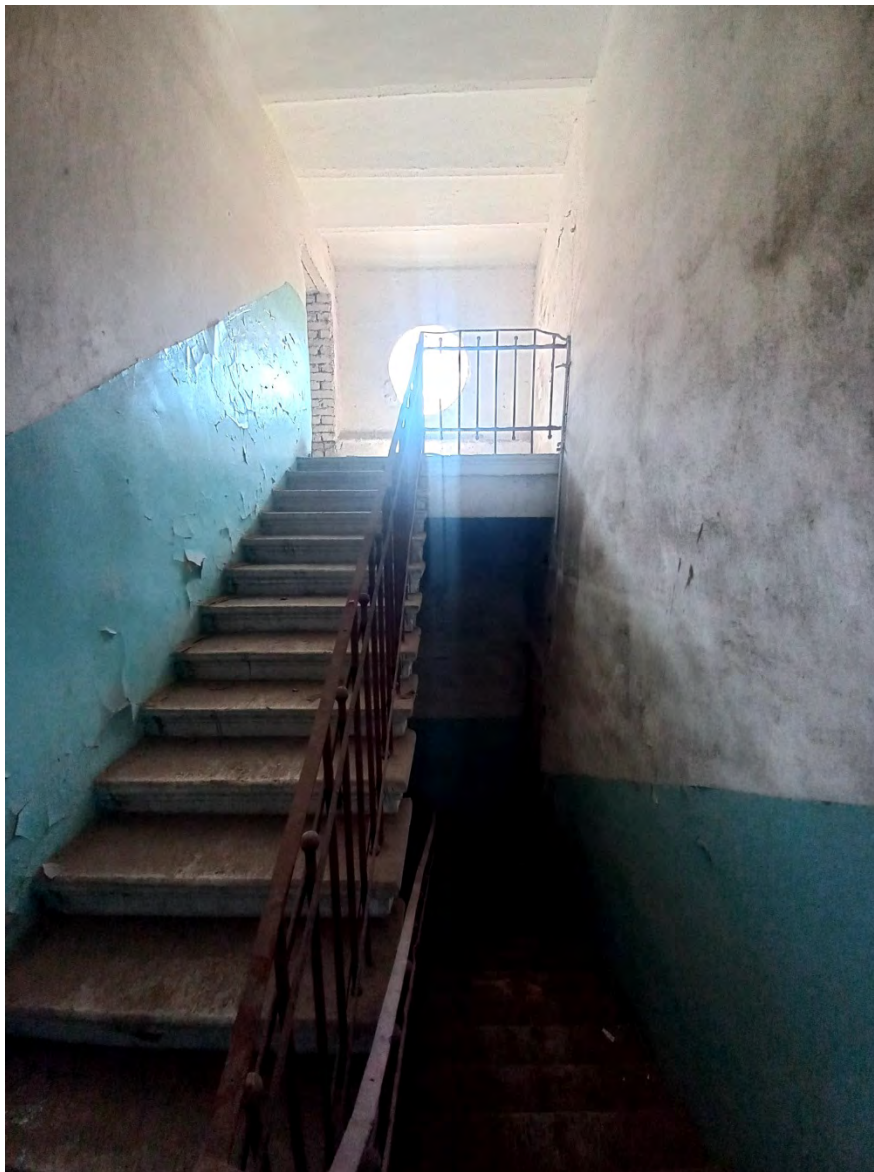
Фото 25. Площадка на уровне чердака.
