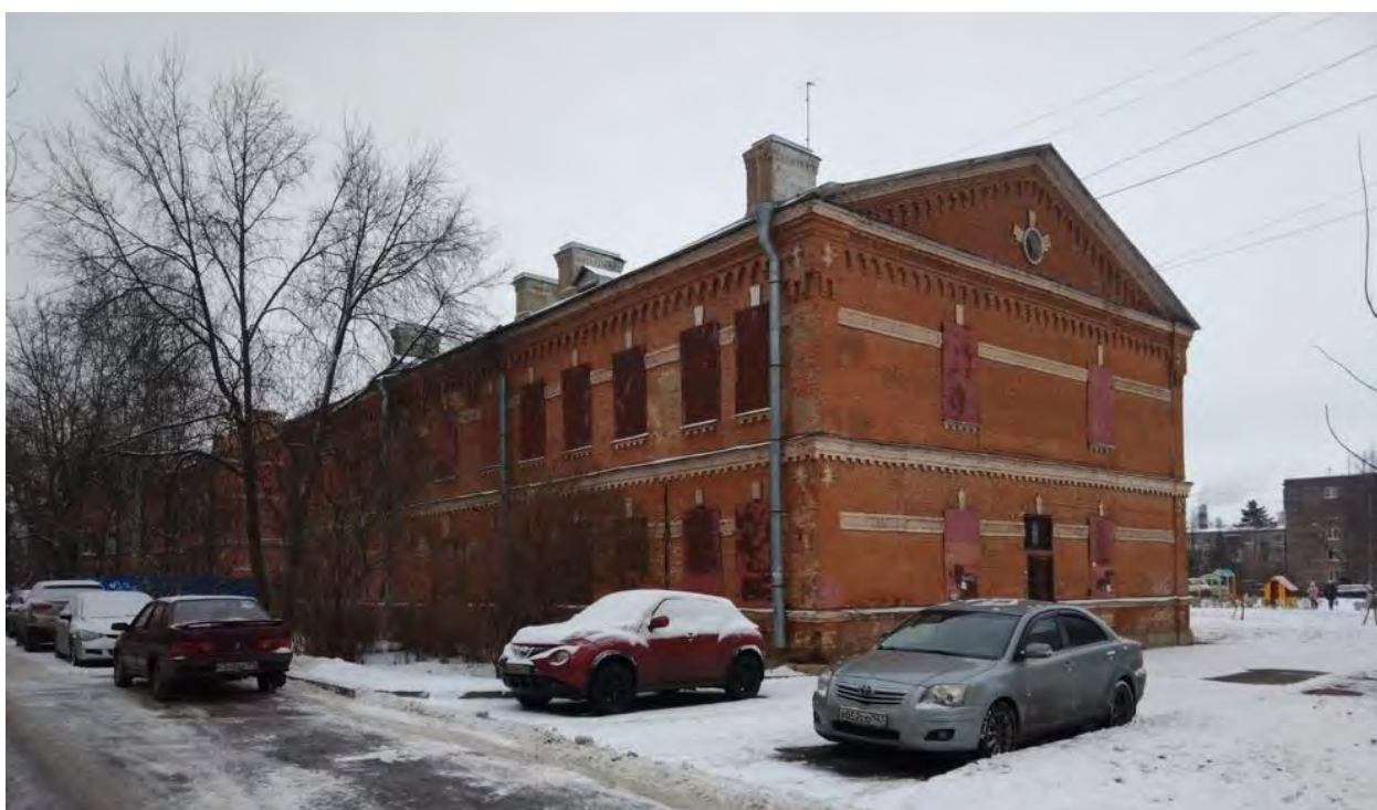
Фото 2. Южный, восточный торцевой фасады.
