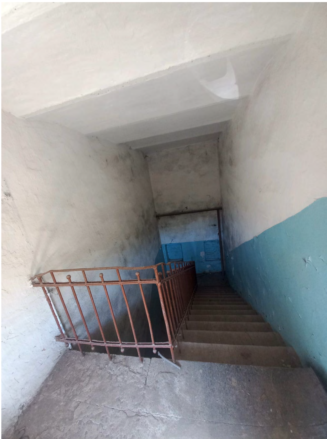
Фото 26. Площадка на уровне чердака. Бетонные своды.
