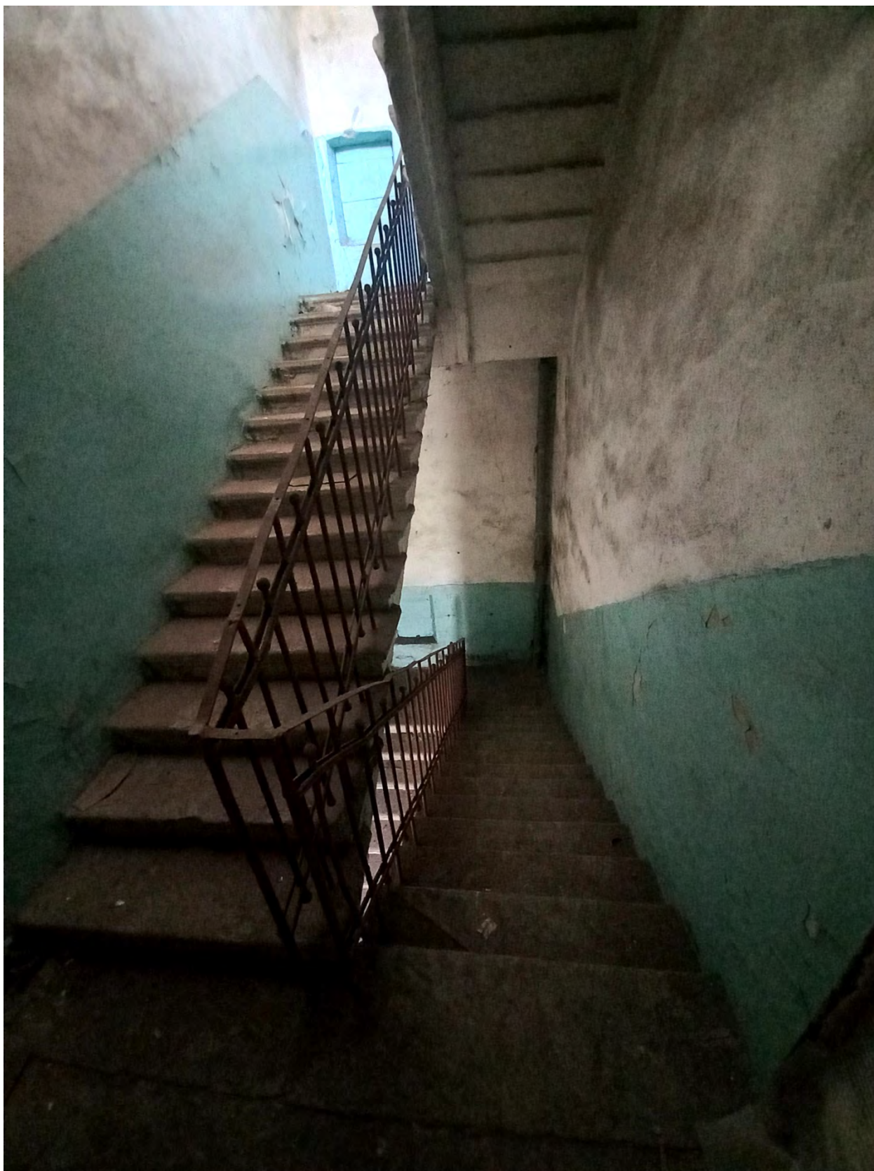
Фото 27. Площадка на уровне второго этажа.
