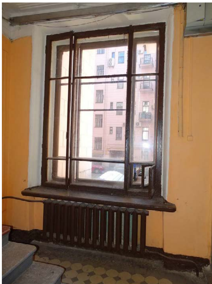
Фото 193. Лестница № 6: Площадка между 1-м и 2-м этажом. Съемка 26.04.2021 г. Кириков Б. М.
