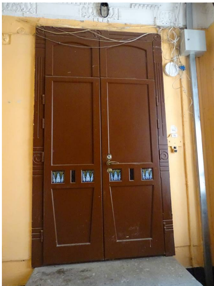
Фото 208. Лестница № 6: Площадка между 3-м и 4-м этажом. Съемка 26.04.2021 г. Кириков Б. М.
