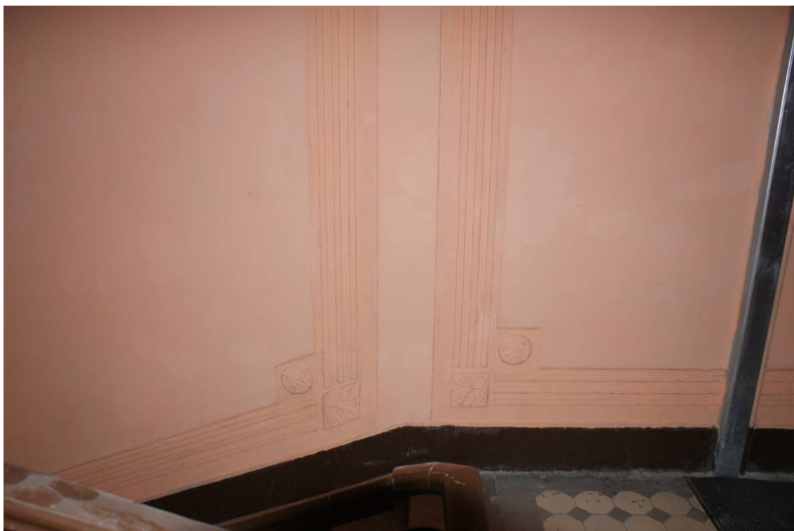
Фото 229. Лестница № 6: 6 этаж. Оформление стен. Съемка 26.04.2021 г. Кириков Б. М.
