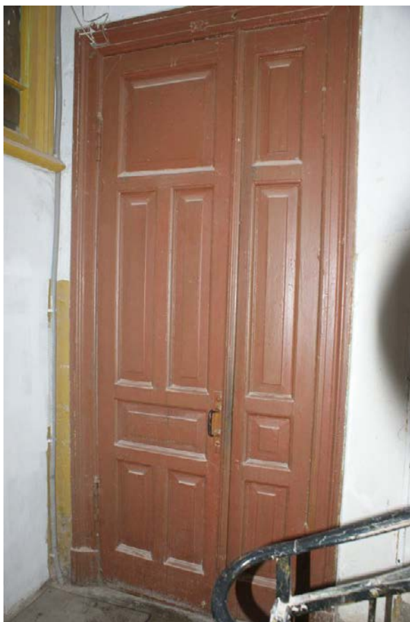
Фото 341. Лестница № 4: Площадка 5-го этажа. Оформление двери. Съемка 26.04.2021 г. Кириков Б. М.
