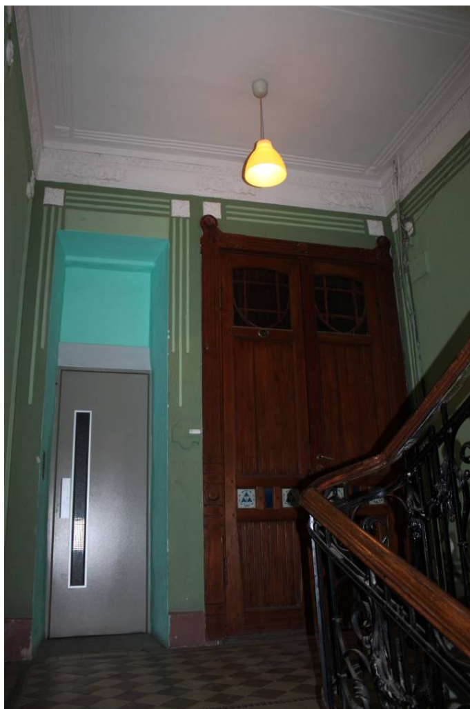
Фото 273. Лестница № 2: Площадка 2-го этажа. Съемка 26.04.2021 г. Кириков Б. М.
