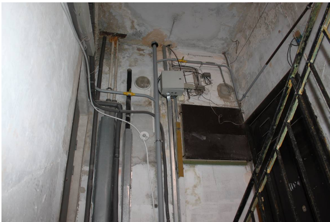
Фото 335. Лестница № 4: Площадка 3-го этажа. Съемка 26.04.2021 г. Кириков Б. М.
