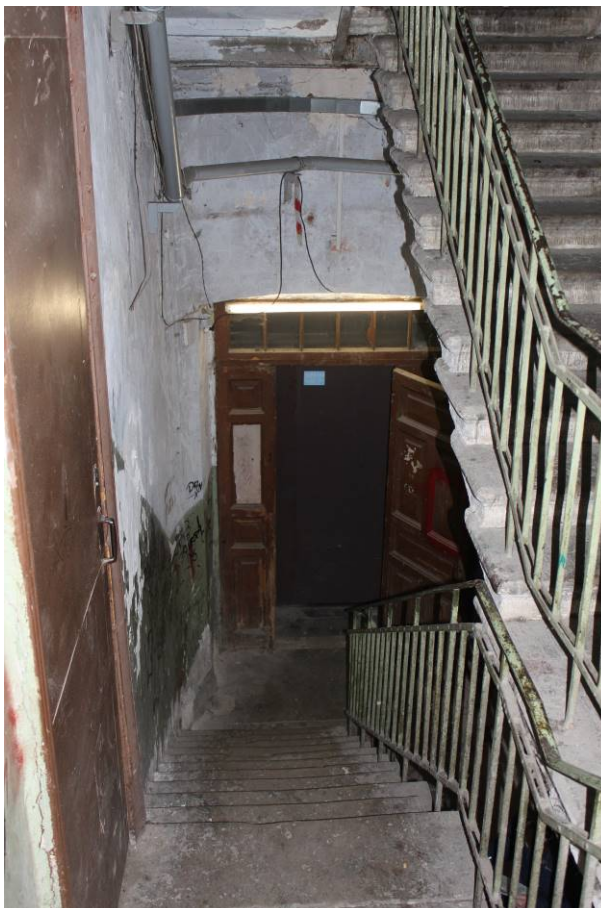
Фото 230. Лестница № 1 (двор): Входная дверь. Съёмка 26.04.2021 г. Кириков Б. М.
