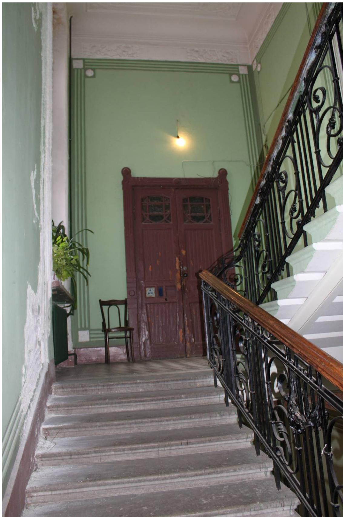
Фото 292. Лестница № 2: Площадка между 5-м и 6-м этажом. Съемка 26.04.2021 г. Кириков Б. М.
