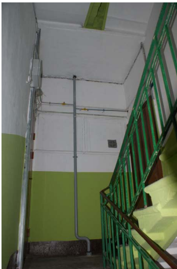
Фото 308. Лестница № 3: Площадка 2-го этажа. Съемка 26.04.2021 г. Кириков Б. М.
