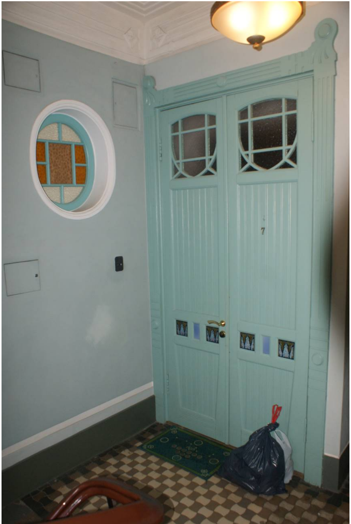
Фото 212. Лестница № 1: Площадка 4-го этажа. Покрытие пола. Съемка 26.04.2021 г. Кириков Б. М.
