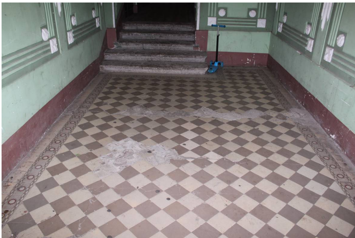
Фото 258. Лестница № 2: Вестибюль. 1-й этаж. Одномаршевая лестница. Покрытие пола. Съемка 26.04.2021 г. Кириков Б. М.
