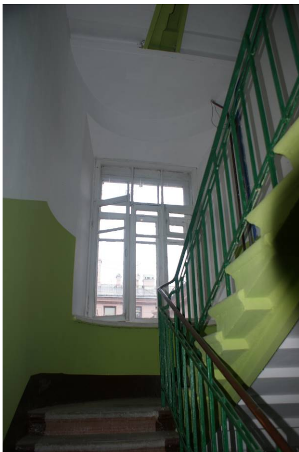
Фото 320. Лестница № 3: Площадка между 5-м и 6-м этажом. Съемка 26.04.2021 г. Кириков Б. М.
