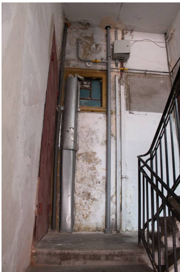
Фото 337. Лестница № 4: Площадка 4-го этажа. Съемка 26.04.2021 г. Кириков Б. М.
