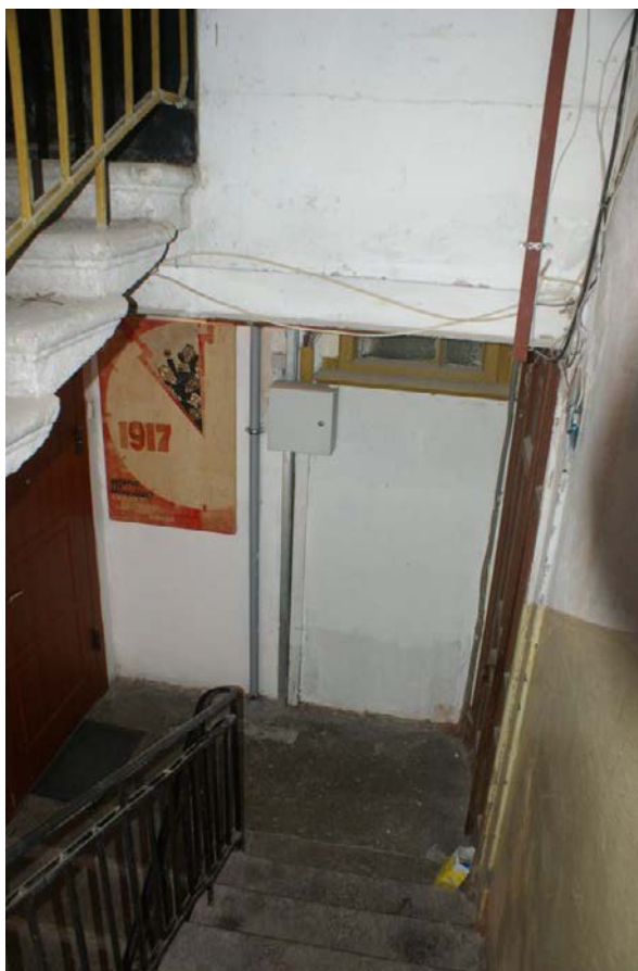
Фото 343. Лестница № 3: Площадка 6-го этажа. Съемка 26.04.2021 г. Кириков Б. М.
