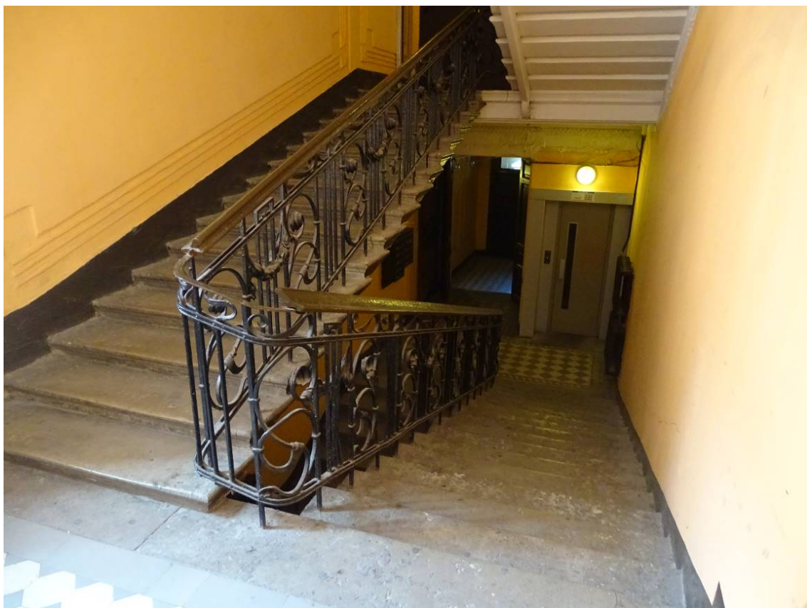
Фото 197. Лестница № 6: Площадка между 1-м и 2-м этажом. Съемка 26.04.2021 г. Кириков Б. М.
