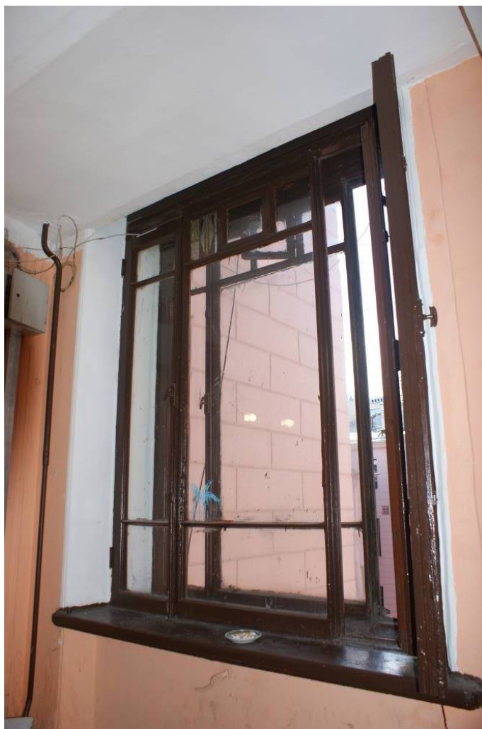
Фото 225. Лестница № 6: Площадка между 5-м и 6-м этажом. Съемка 26.04.2021 г. Кириков Б. М.
