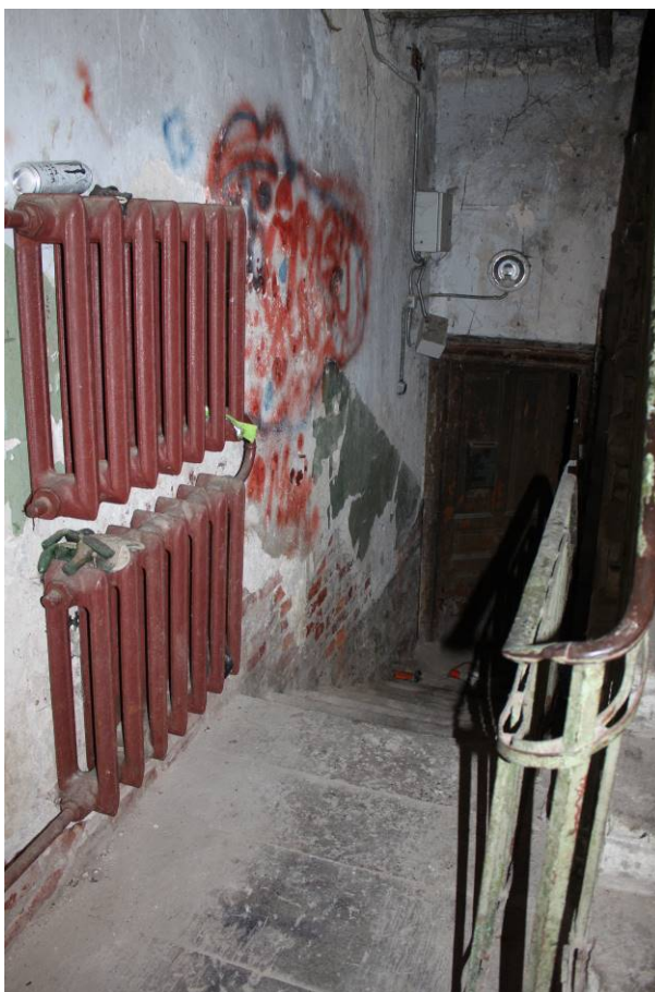
Фото 232. Лестница № 1 (двор): 1-й этаж. Пространство под лестницей. Съемка 26.04.2021 г. Кириков Б. М.
