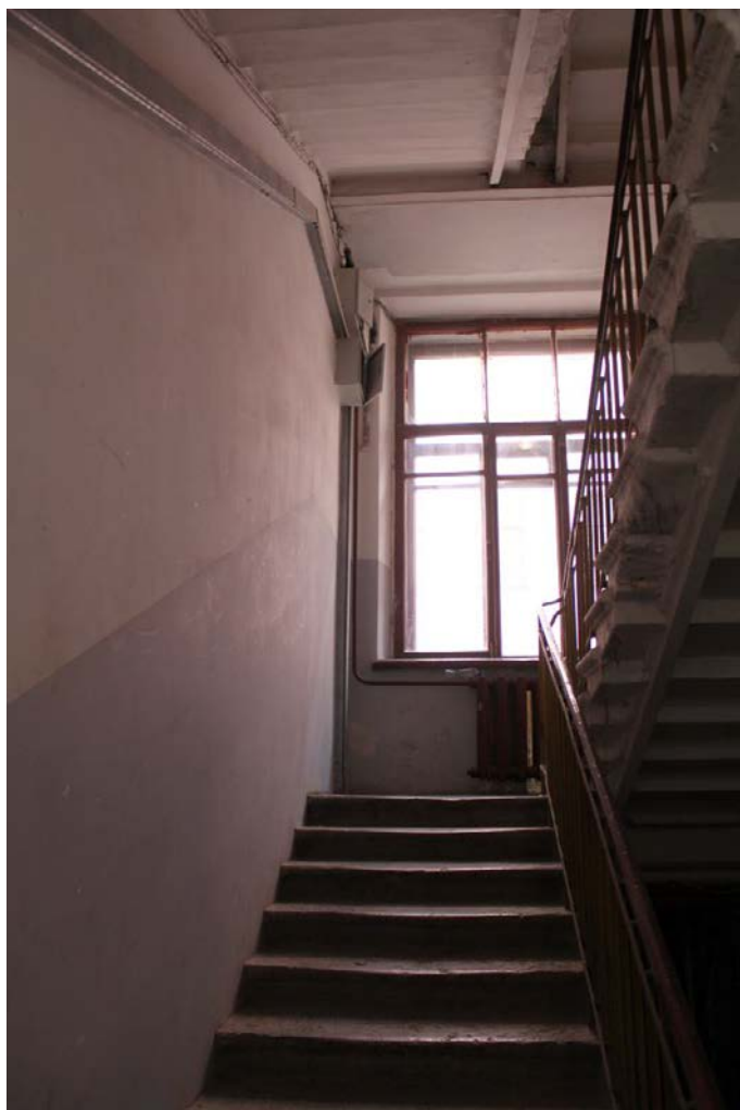
Фото 329. Лестница № 4: Площадка между 1-м и 2-м этажом. Съемка 26.04.2021 г. Кириков Б. М.
