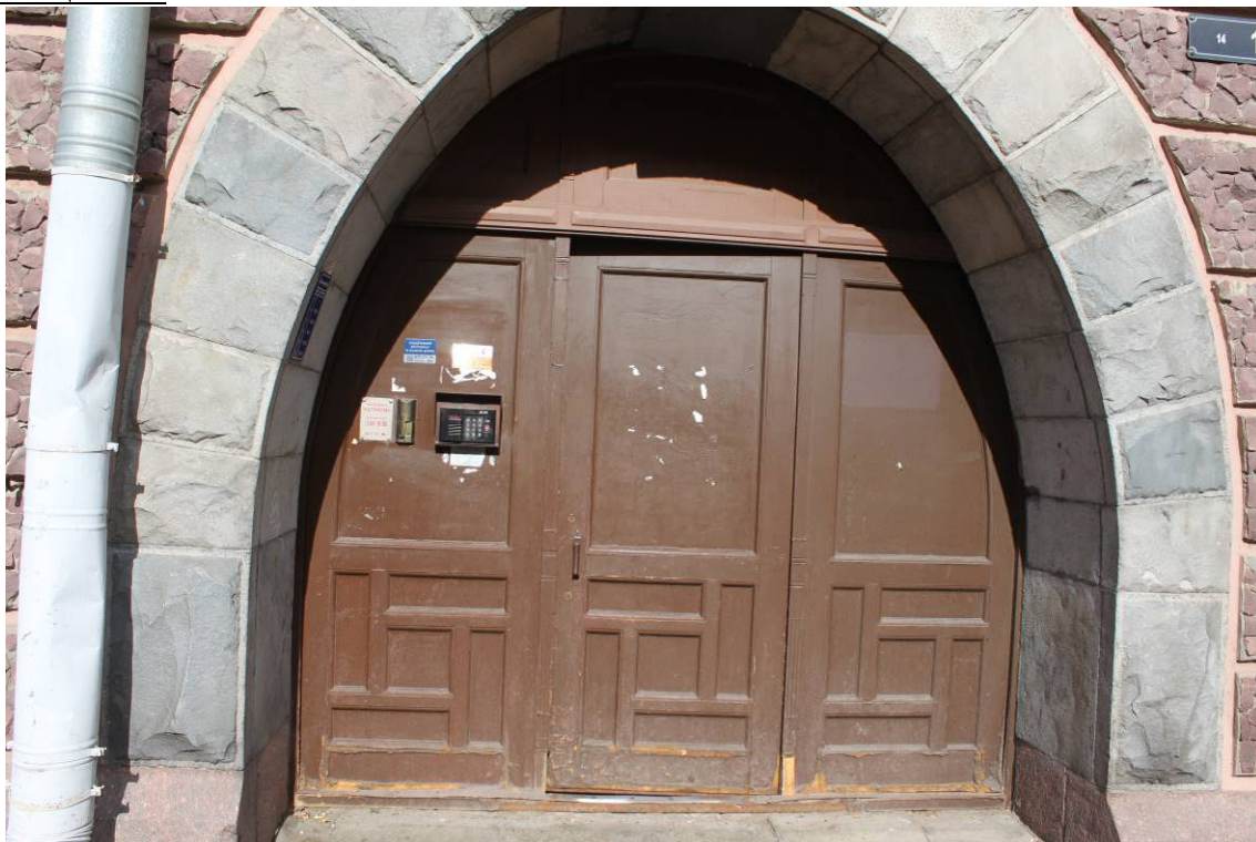
Фото 250. Лестница № 2: Входная дверь. Съемка 26.04.2021 г. Кириков Б. М.
