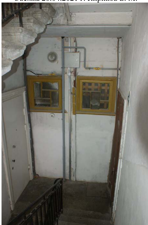
Фото 340. Лестница № 4: Площадка 5-го этажа. Съемка 26.04.2021 г. Кириков Б. М.
