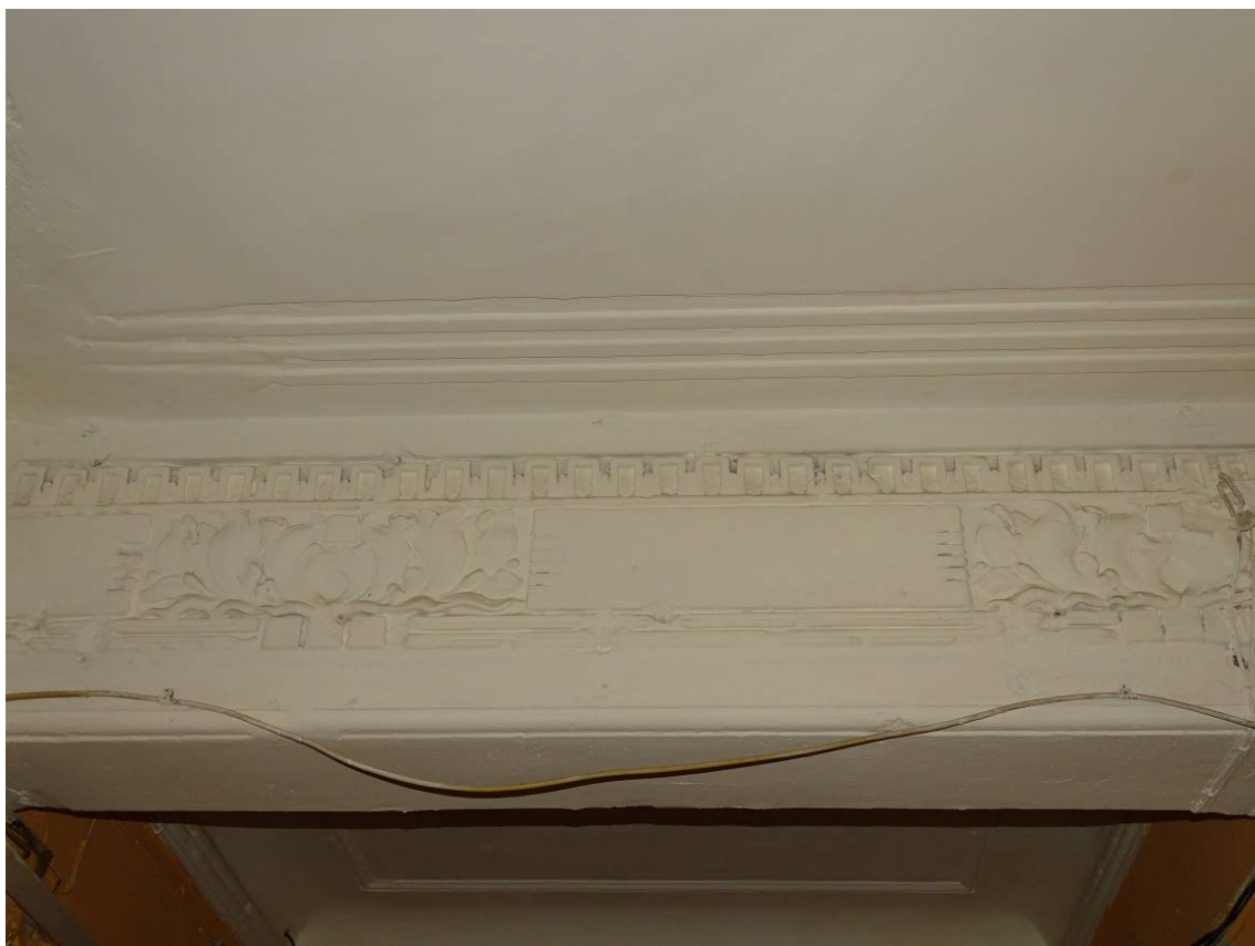
Фото 187. Лестница № 6: 1 этаж. Оформление стен. Съемка 26.04.2021 г. Кириков Б. М.
