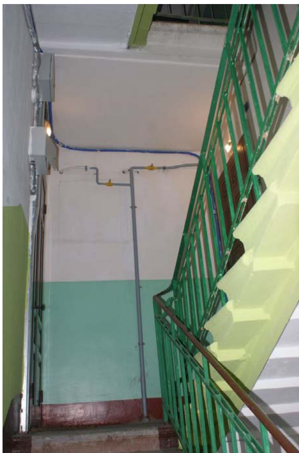
Фото 322. Лестница № 3: Площадка 6-го этажа. Съемка 26.04.2021 г. Кириков Б. М.
