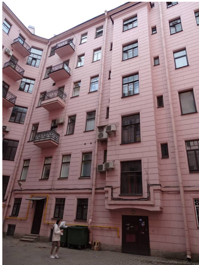
Фото 108. Фрагмент западного фасада внутреннего двора. Съемка 26.04.2021 г. Кириков Б. М.
