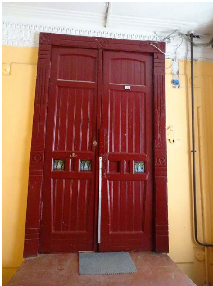
Фото 191. Лестница № 6: Площадка между 1-м и 2-м этажом. Съемка 26.04.2021 г. Кириков Б. М.
