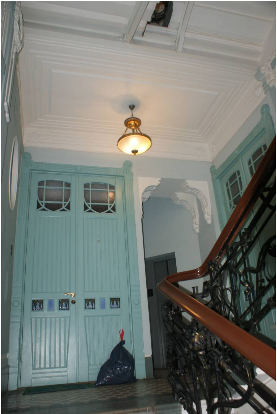
Фото 211. Лестница № 1: Площадка 4-го этажа. Съемка 26.04.2021 г. Кириков Б. М.
