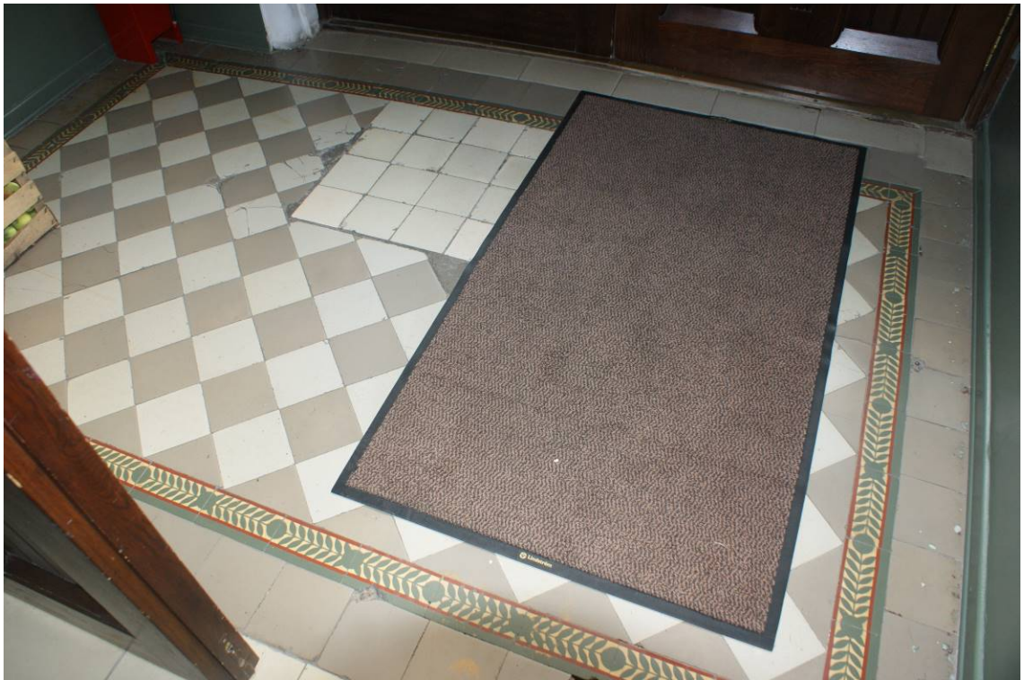
Фото 178. Лестница № 1: Тамбур. 1-й этаж. Покрытие пола. Съемка 26.04.2021 г. Кириков Б. М.
