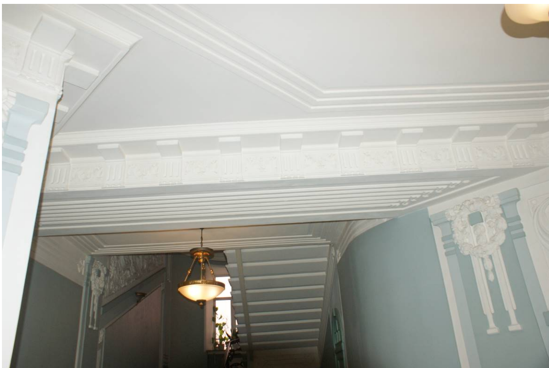
Фото 190. Лестница № 1: Вестибюль. 1-й этаж. Оформление потолка. Съемка 26.04.2021 г. Кириков Б. М.
