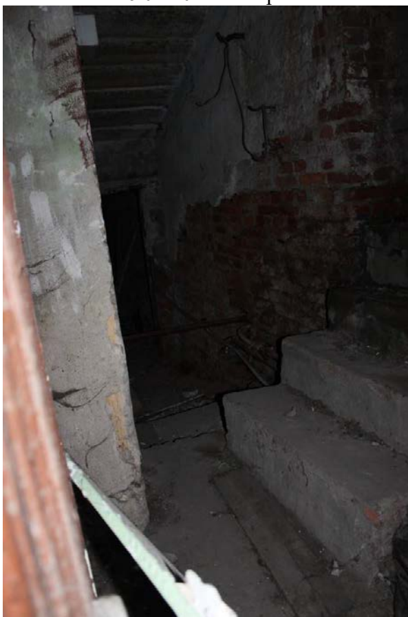
Фото 268. Лестница № 2: Цокольный этаж. Вход в подвал. Съемка 26.04.2021 г. Кириков Б. М.
