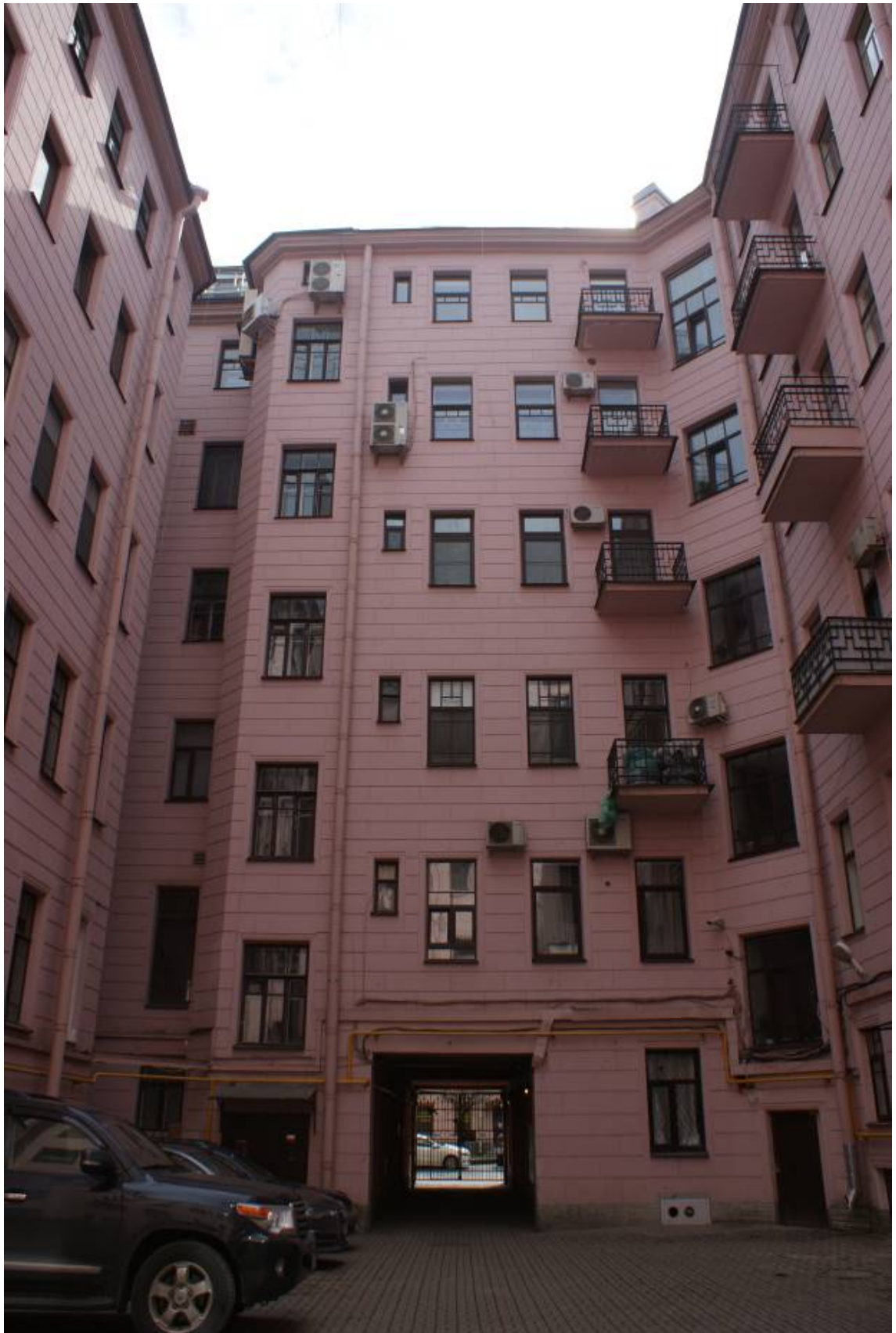
Фото 113. Южный фасад внутреннего двора. Съемка 26.04.2021 г. Кириков Б. М.
