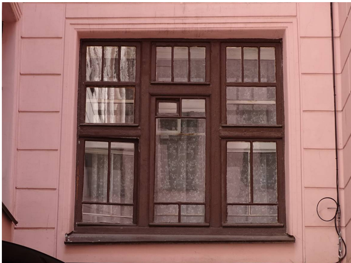
Фото 106. Фрагмент восточного фасада внутреннего двора. 2-й этаж. Съемка 26.04.2021 г. Кириков Б. М.
