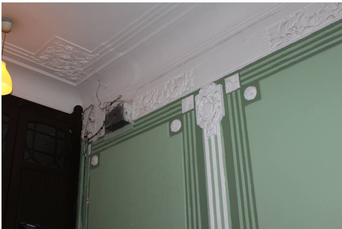
Фото 301. Лестница № 2: Площадка 6-го этажа. Оформление потолка. Съемка 26.04.2021 г. Кириков Б. М.
