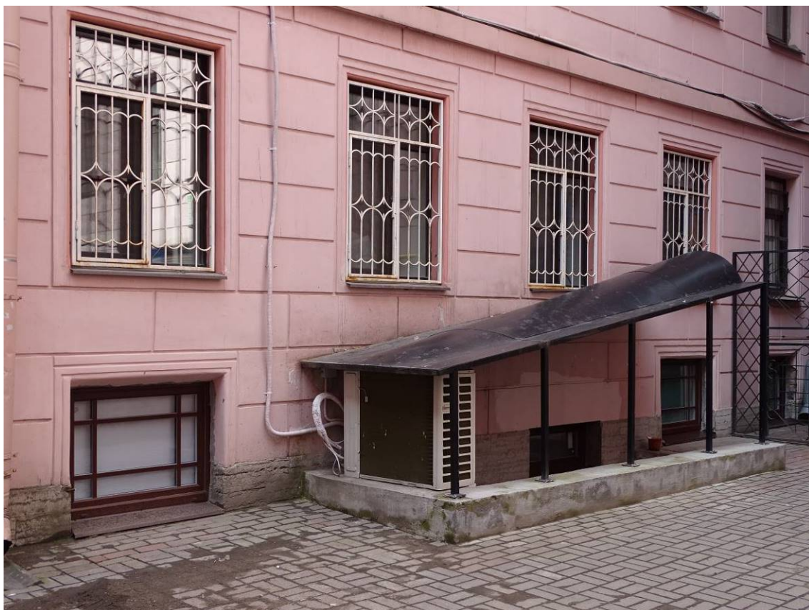
Фото 111. Фрагмент западного фасада внутреннего двора. Прямоук. Съемка 26.04.2021 г. Кириков Б. М.
