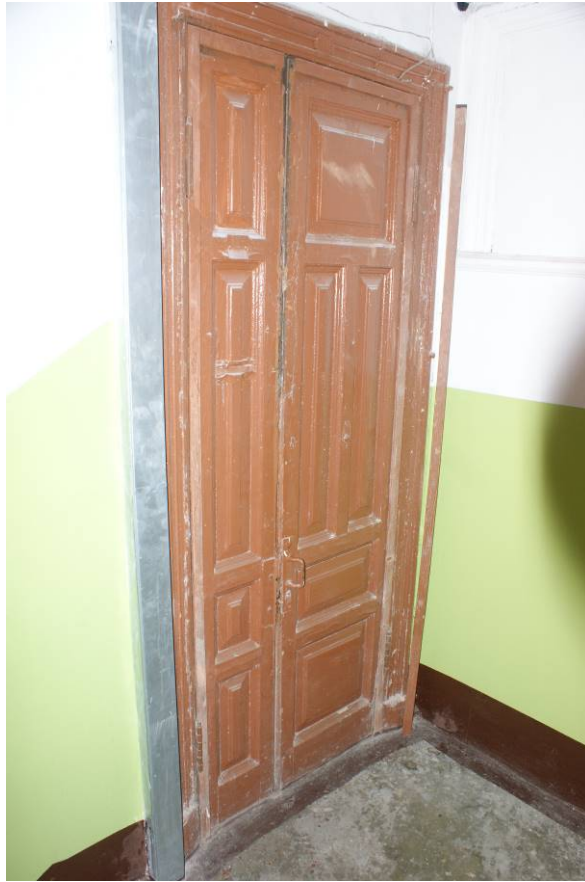
Фото 316. Лестница № 3: Площадка 4-го этажа. Оформление двери. Съемка 26.04.2021 г. Кириков Б. М.
