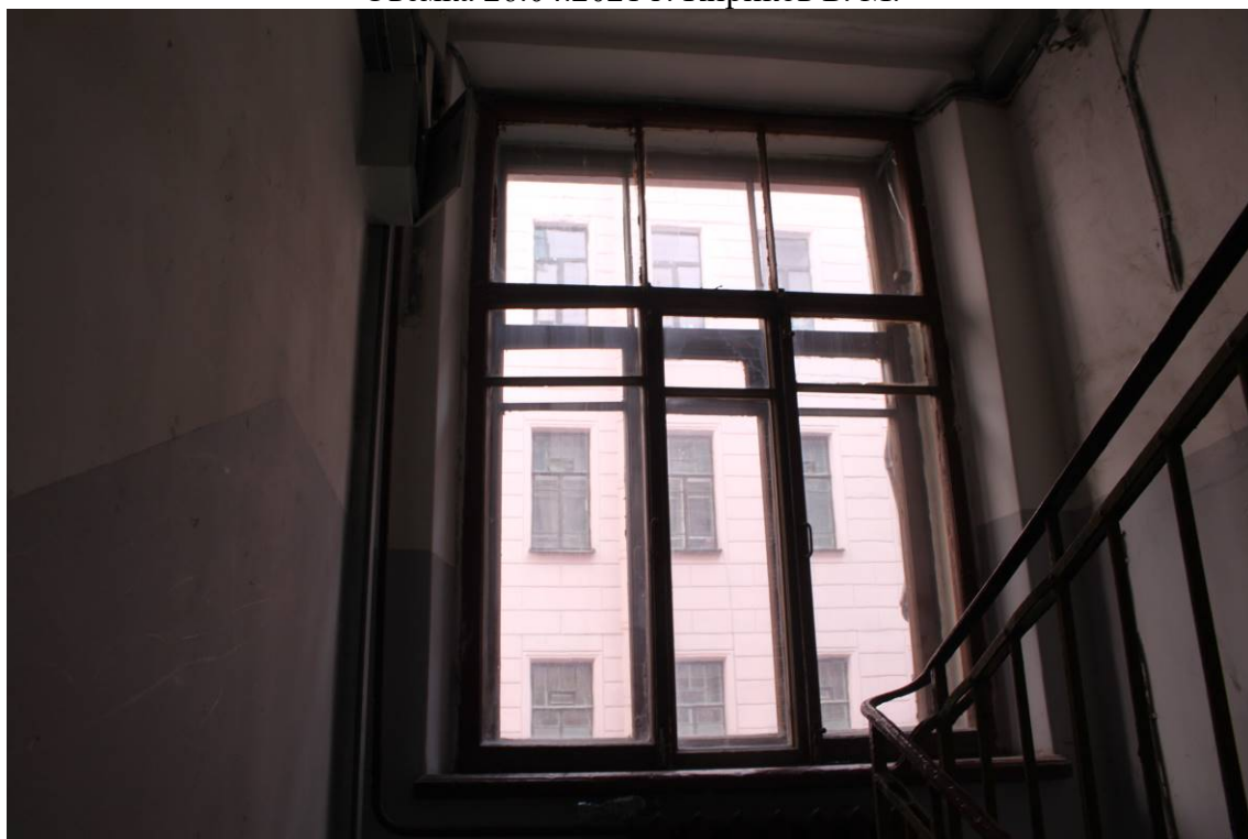
Фото 330. Лестница № 4: Площадка между 1-м и 2-м этажом. Съемка 26.04.2021 г. Кириков Б. М.
