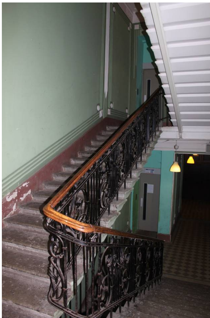
Фото 269. Лестница № 2: Вид на площадку 1-го этажа. Съемка 26.04.2021 г. Кириков Б. М.
