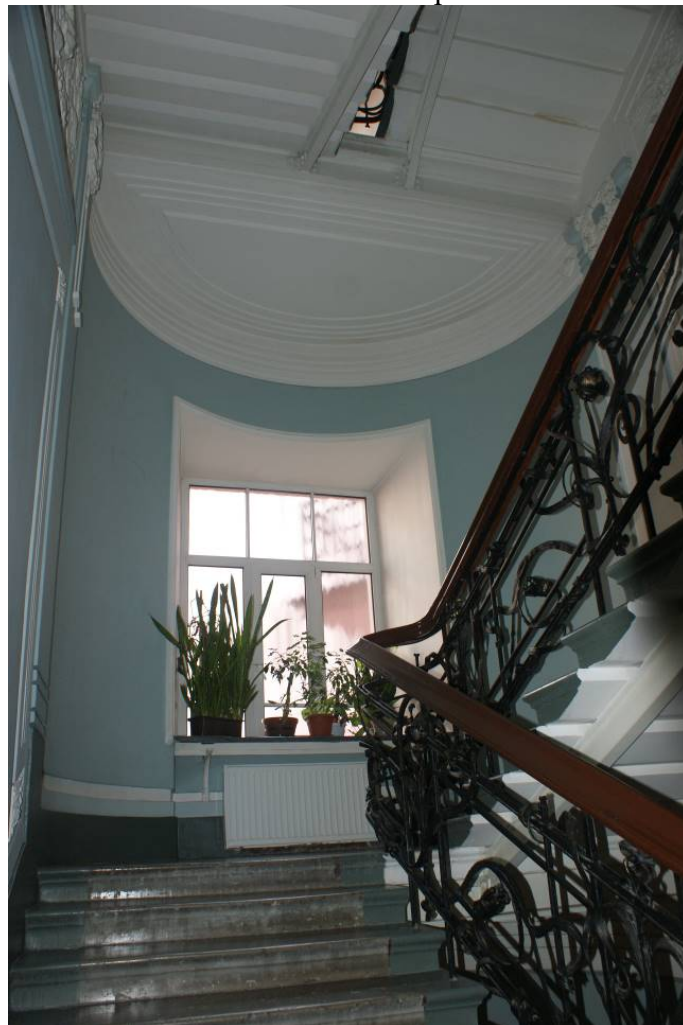
Фото 210. Лестница № 1: Площадка между 3-м и 4-м этажом. Съемка 26.04.2021 г. Кириков Б. М.
