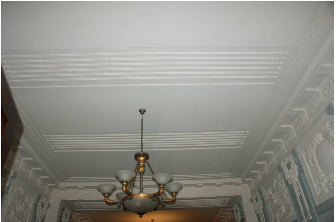
Фото 180. Лестница № 1: Вестибюль. 1-й этаж. Оформление потолка. Съемка 26.04.2021 г. Кириков Б. М.
