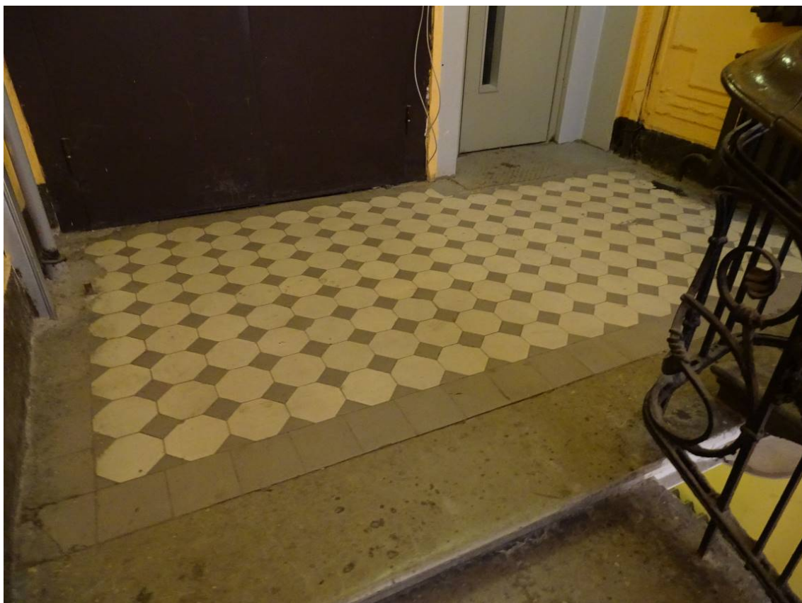
Фото 200. Лестница № 6: 2 этаж. Покрытие пола. Съемка 26.04.2021 г. Кириков Б. М.
