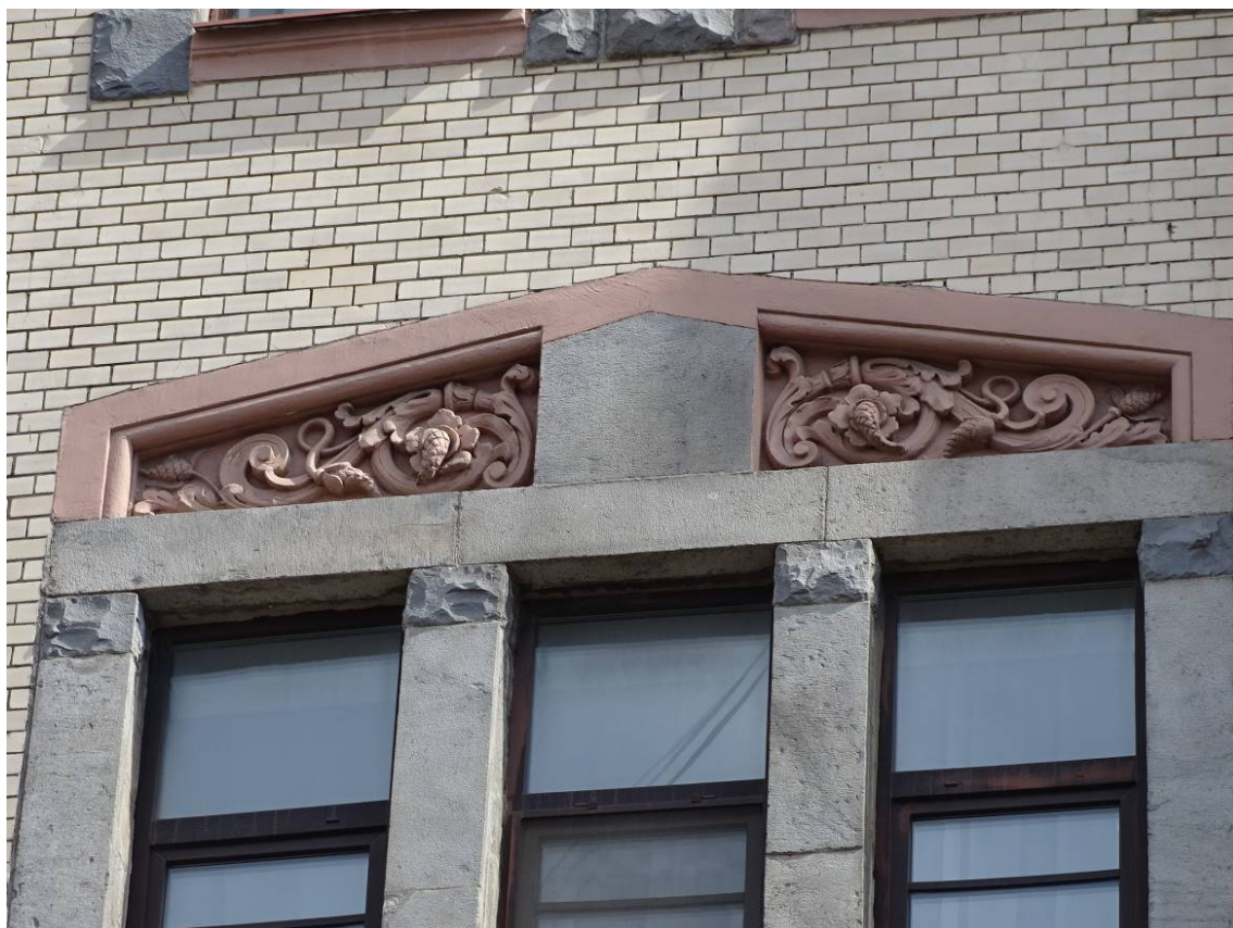
Фото 66. Фрагмент лицевого фасада с пр. Чернышевского. Оформление оконного проема. 4-й этаж. Съемка 26.04.2021 г. Кириков Б. М.
