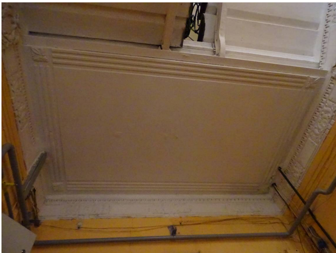
Фото 206. Лестница № 6: 3 этаж. Оформление потолка. Съемка 26.04.2021 г. Кириков Б. М.
