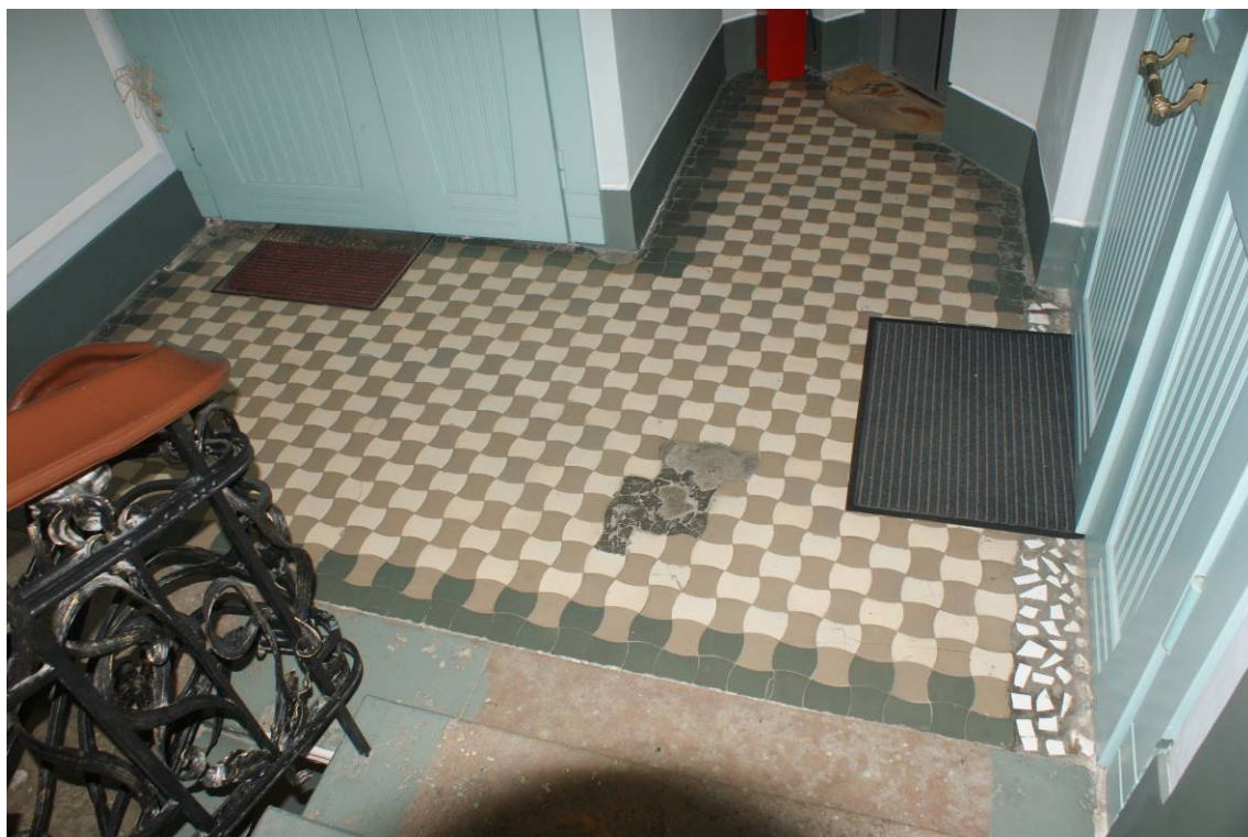
Фото 218. Лестница № 1: Площадка 5-го этажа. Покрытие пола. Съемка 26.04.2021 г. Кириков Б. М.
