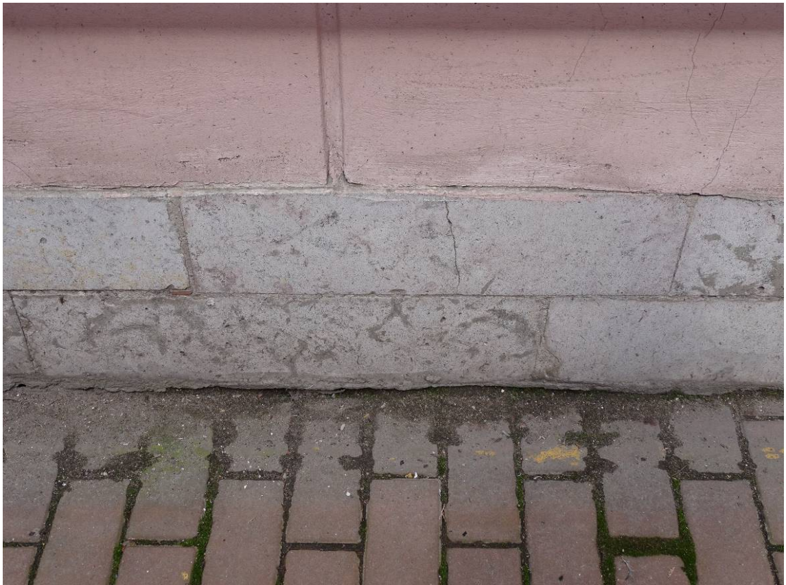
Фото 107. Фрагмент восточного фасада внутреннего двора. Известняковый цоколь. Съемка 26.04.2021 г. Кириков Б. М.
