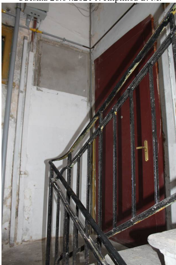
Фото 338. Лестница № 4: Площадка 4-го этажа. Съемка 26.04.2021 г. Кириков Б. М.
