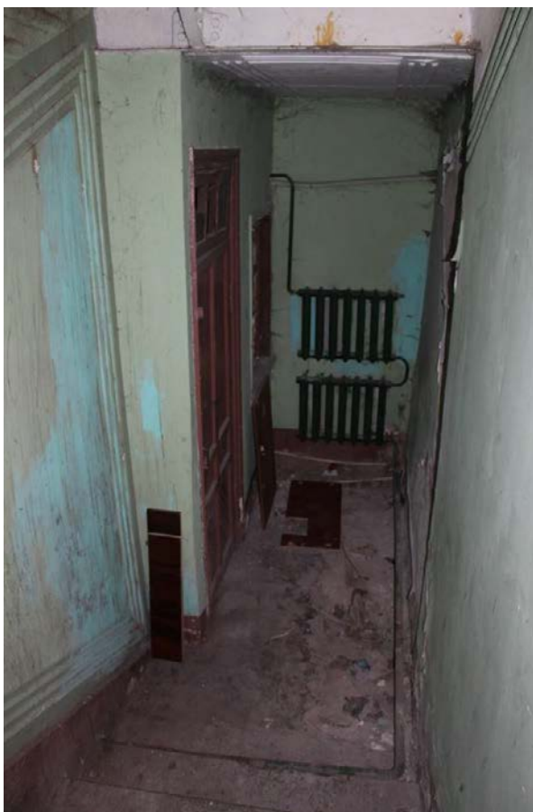
Фото 265. Лестница № 2: Цокольный этаж. Пространство под лестницей. Съемка 26.04.2021 г. Кириков Б. М.
