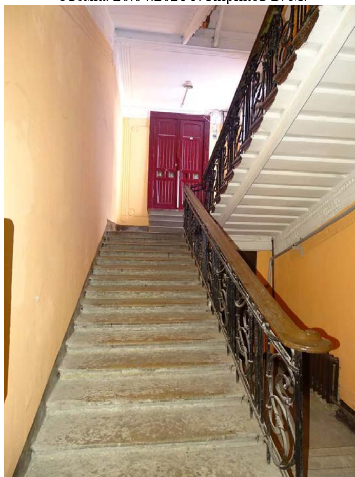
Фото 188. Лестница № 6: Площадка между 1-м и 2-м этажом. Съемка 26.04.2021 г. Кириков Б. М.
