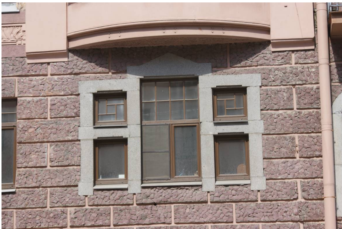
Фото 90. Фрагмент лицевого фасада с ул. Захарьевской. 2-й этаж. Съемка 26.04.2021 г. Кириков Б. М.
