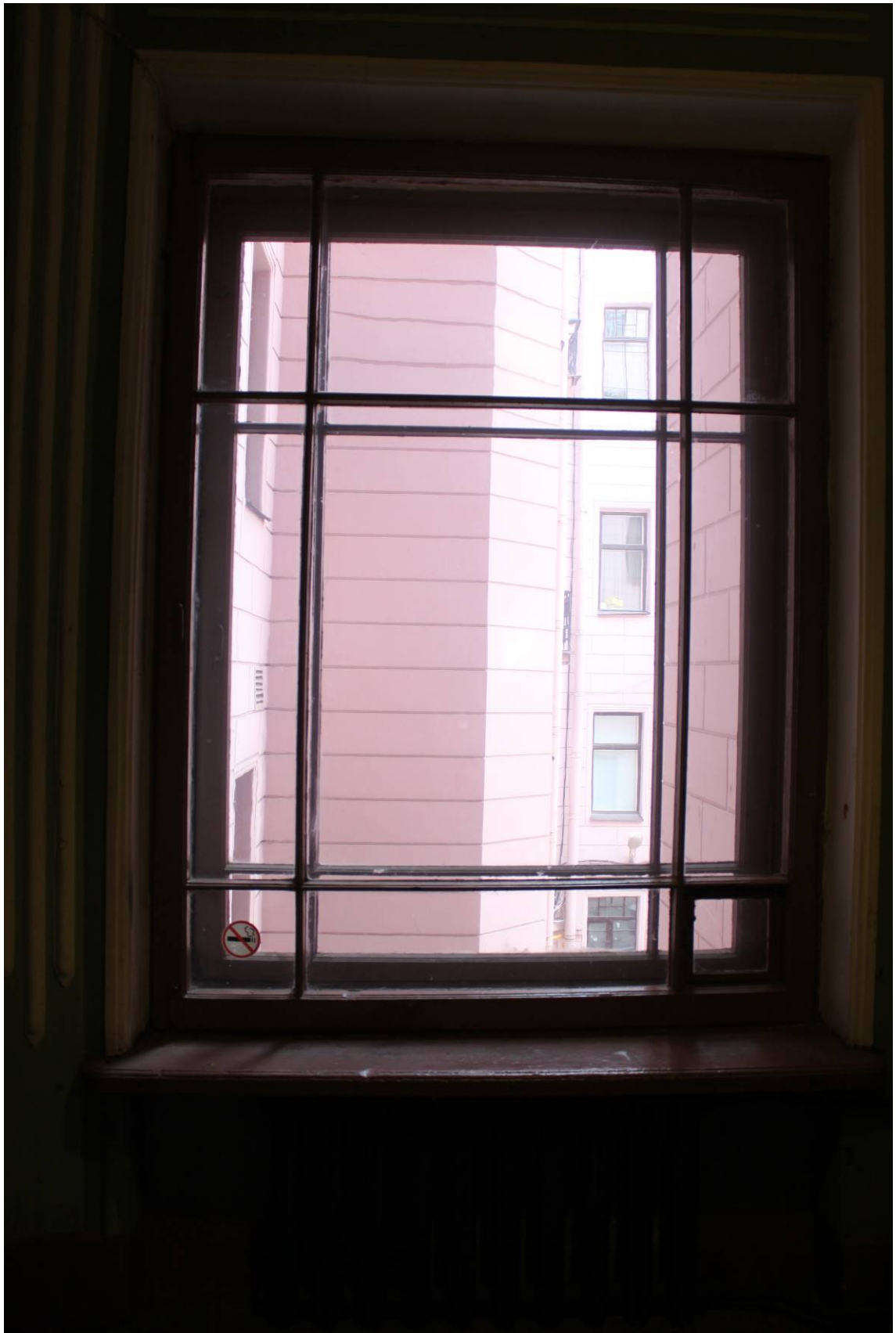
Фото 278. Лестница № 2: Площадка между 2-м и 3-м этажом. Оформление окна. Съемка 26.04.2021 г. Кириков Б. М.
