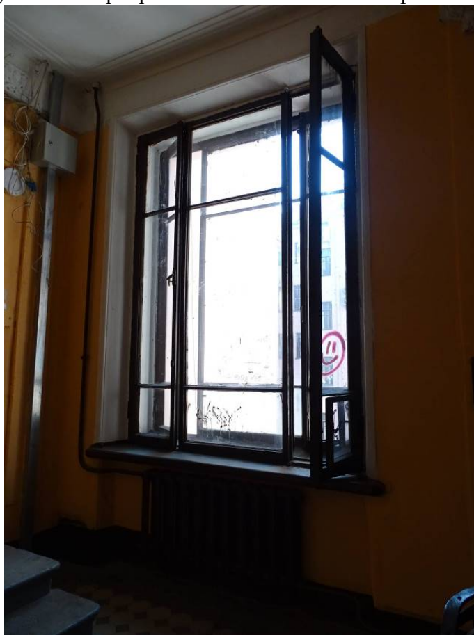
Фото 211. Лестница № 6: Площадка между 3-м и 4-м этажом. Съемка 26.04.2021 г. Кириков Б. М.
