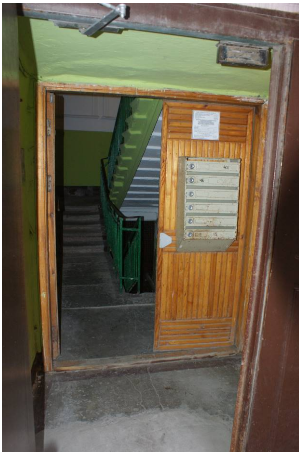
Фото 302. Лестница № 3: 1-й этаж. Входная дверь. Съемка 26.04.2021 г. Кириков Б. М.
