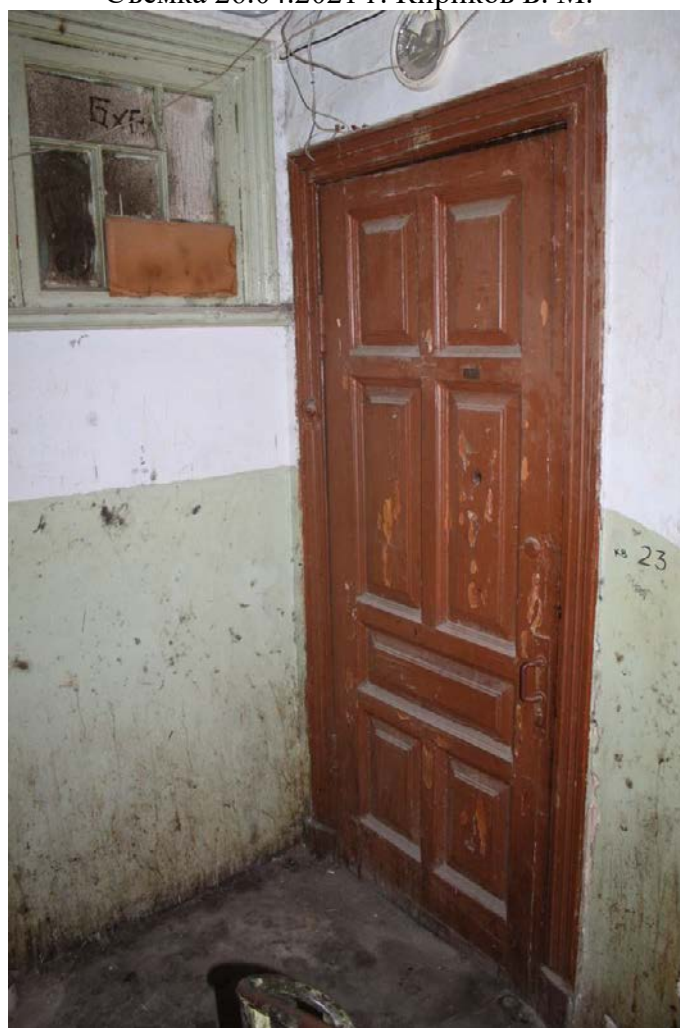
Фото 247. Лестница № 1 (двор): Площадка 5-го этажа. Оформление двери. Съемка 26.04.2021 г. Кириков Б. М.
