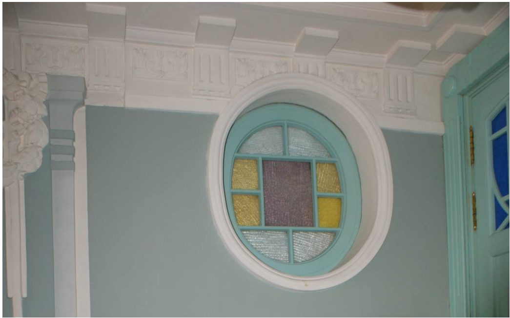
Фото 225. Лестница № 1: Площадка 6-го этажа. Съемка 26.04.2021 г. Кириков Б. М.
