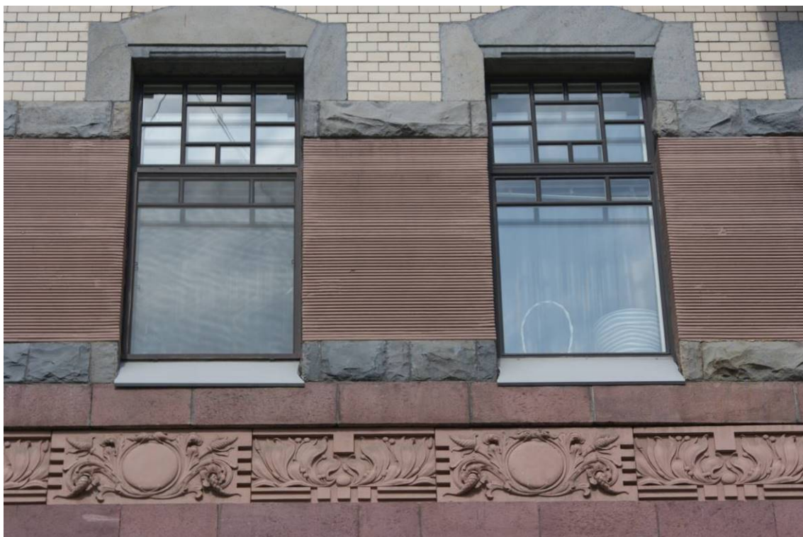
Фото 94. Фрагмент лицевого фасада с ул. Захарьевской. Оформление оконных проемов. 3-й этаж. Съемка 26.04.2021 г. Кириков Б. М.
