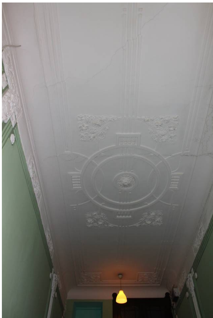
Фото 299. Лестница № 2: Площадка 6-го этажа. Оформление потолка. Съемка 26.04.2021 г. Кириков Б. М.
