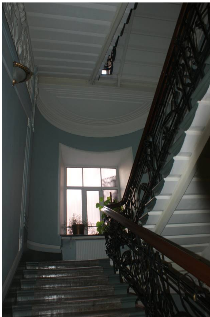
Фото 201. Лестница № 1: Площадка между 2-м и 3-м этажом. Съемка 26.04.2021 г. Кириков Б. М.
