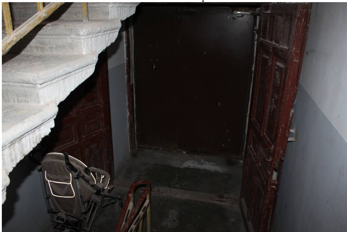
Фото 326. Лестница № 4: 1-й этаж. Входная дверь. Съемка 26.04.2021 г. Кириков Б. М.
