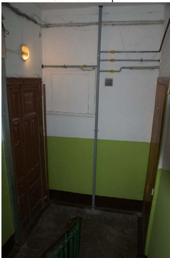
Фото 315. Лестница № 3: Площадка 4-го этажа. Съемка 26.04.2021 г. Кириков Б. М.
