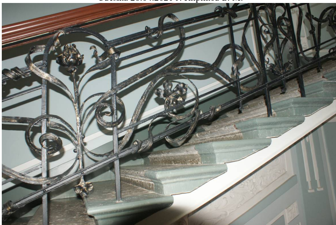
Фото 216. Лестница № 1: Лестничное ограждение. Съемка 26.04.2021 г. Кириков Б. М.
