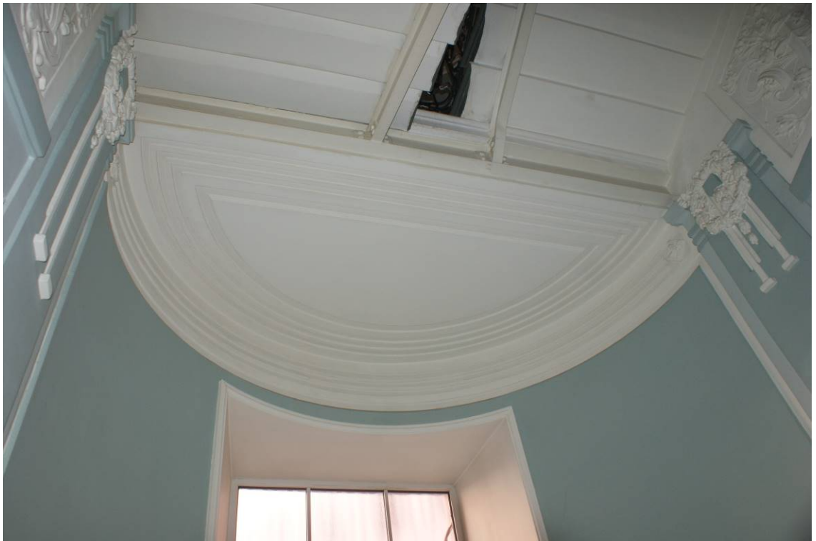
Фото 196. Лестница № 1: Площадка между 1-м и 2-м этажом. Съемка 26.04.2021 г. Кириков Б. М.
