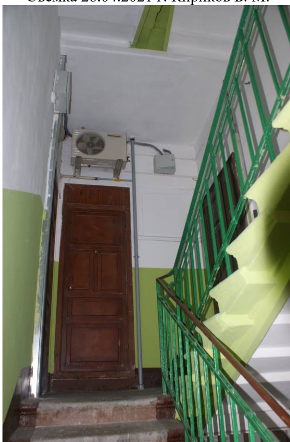
Фото 319. Лестница № 3: Площадка 5-го этажа. Съемка 26.04.2021 г. Кириков Б. М.
