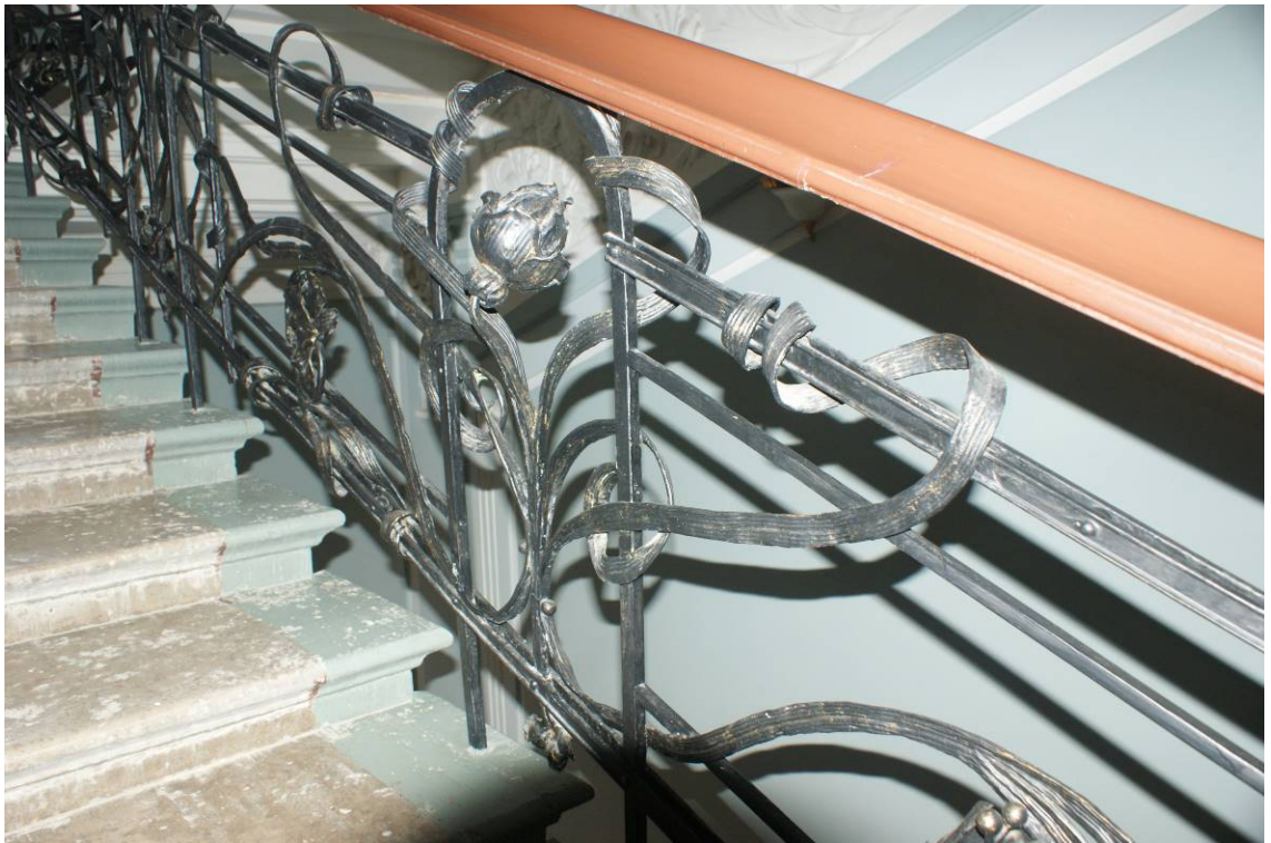
Фото 209. Лестница № 1: Лестничное ограждение. Фрагмент. Съемка 26.04.2021 г. Кириков Б. М.
