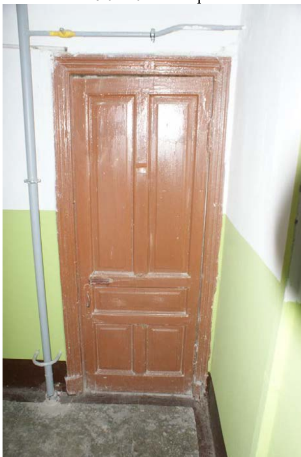
Фото 311. Лестница № 3: Площадка 3-го этажа. Оформление двери. Съемка 26.04.2021 г. Кириков Б. М.
