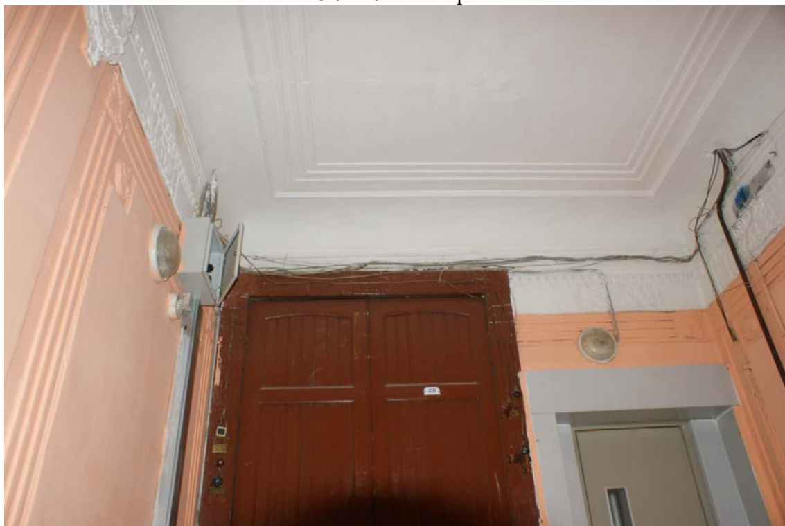
Фото 226. Лестница № 6: 6 этаж. Оформление потолка. Съемка 26.04.2021 г. Кириков Б. М.
