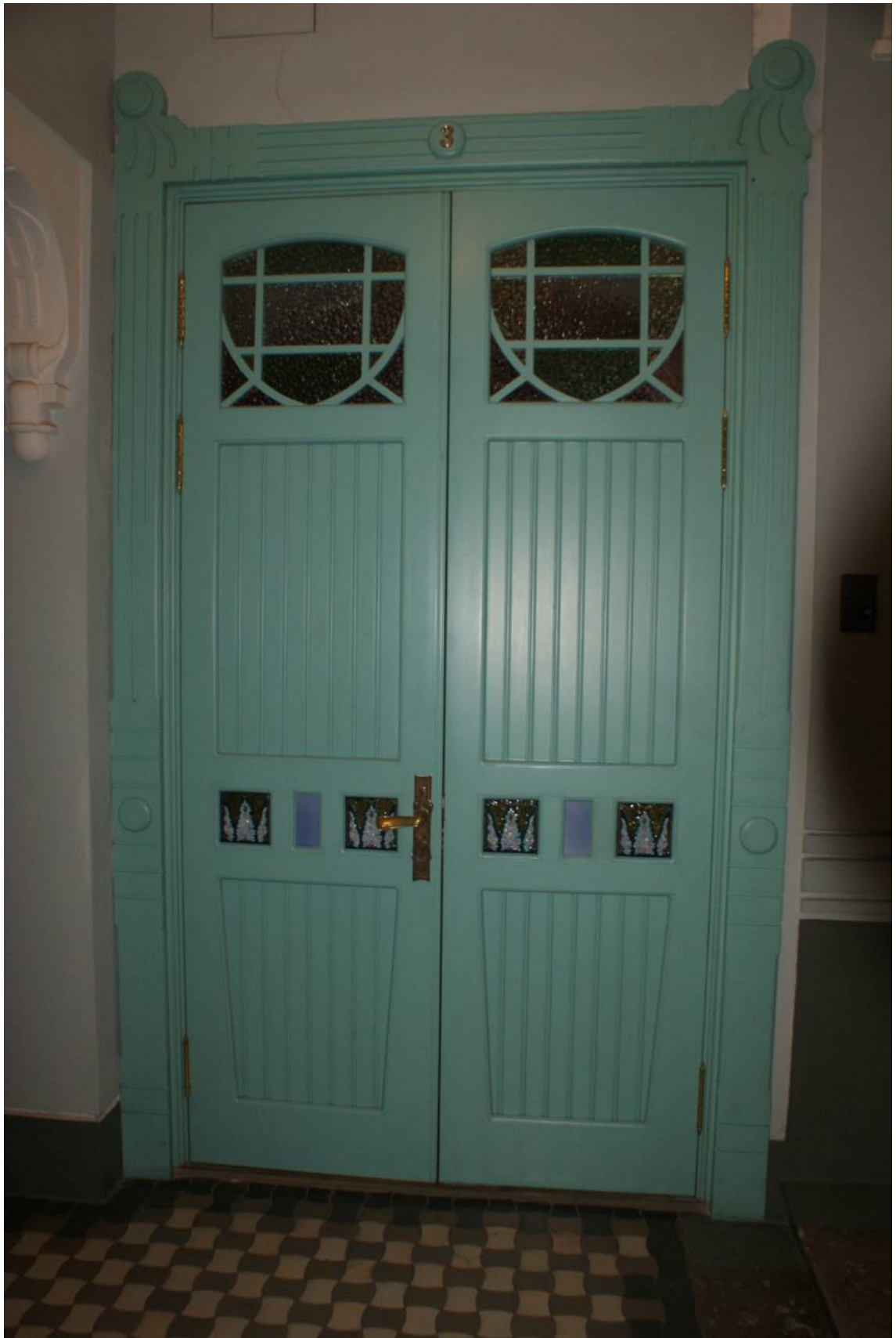
Фото 198. Лестница № 1: Площадка 2-го этажа. Оформление двери. Съемка 26.04.2021 г. Кириков Б. М.
