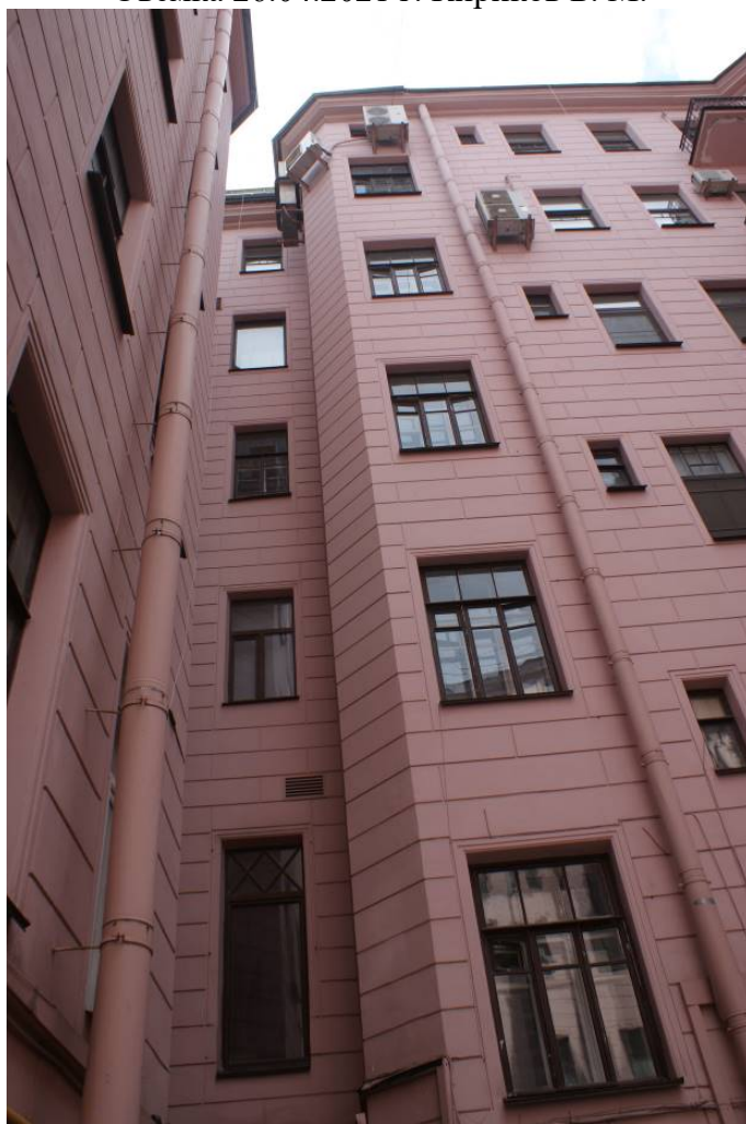
Фото 117. Фрагмент южного фасада внутреннего двора. Съемка 26.04.2021 г. Кириков Б. М.
