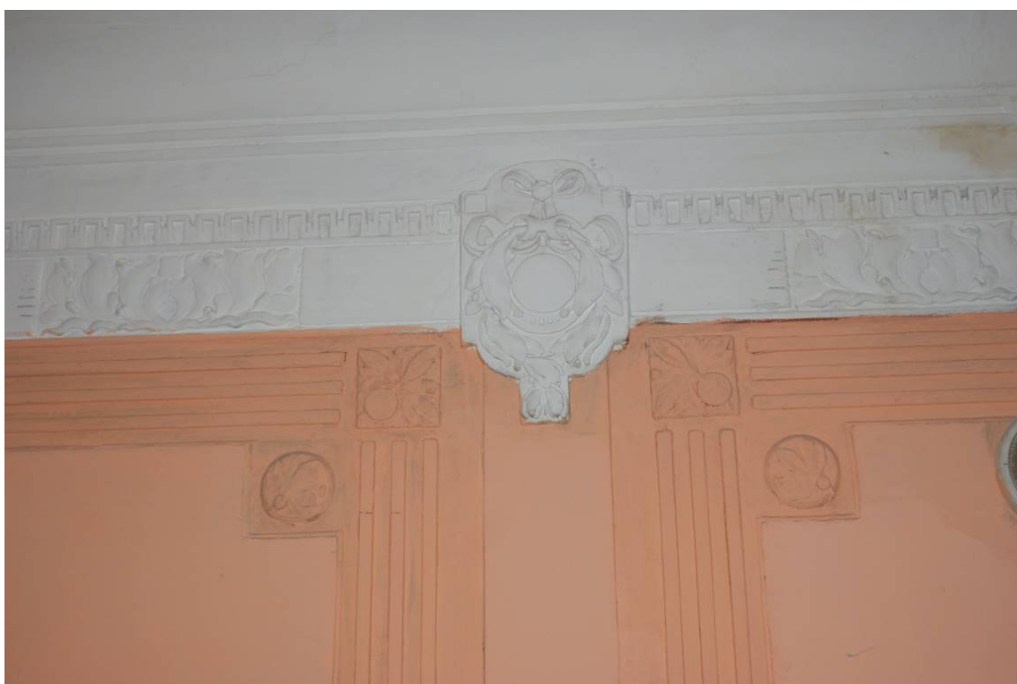
Фото 230. Лестница № 6: 6 этаж. Оформление стен. Съемка 26.04.2021 г. Кириков Б. М.
