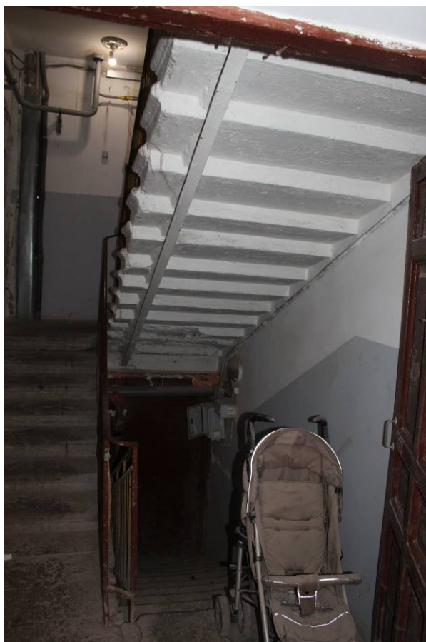
Фото 327. Лестница № 4: 1-й этаж. Пространство под лестницей. Съемка 26.04.2021 г. Кириков Б. М.
