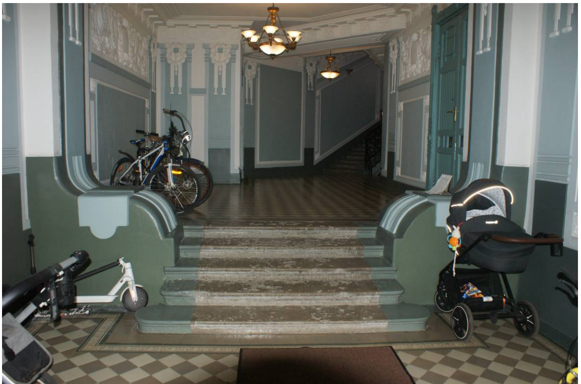
Фото 183. Лестница № 1: Вестибюль. 1-й этаж. Одномаршевая лестница. Съемка 26.04.2021 г. Кириков Б. М.
