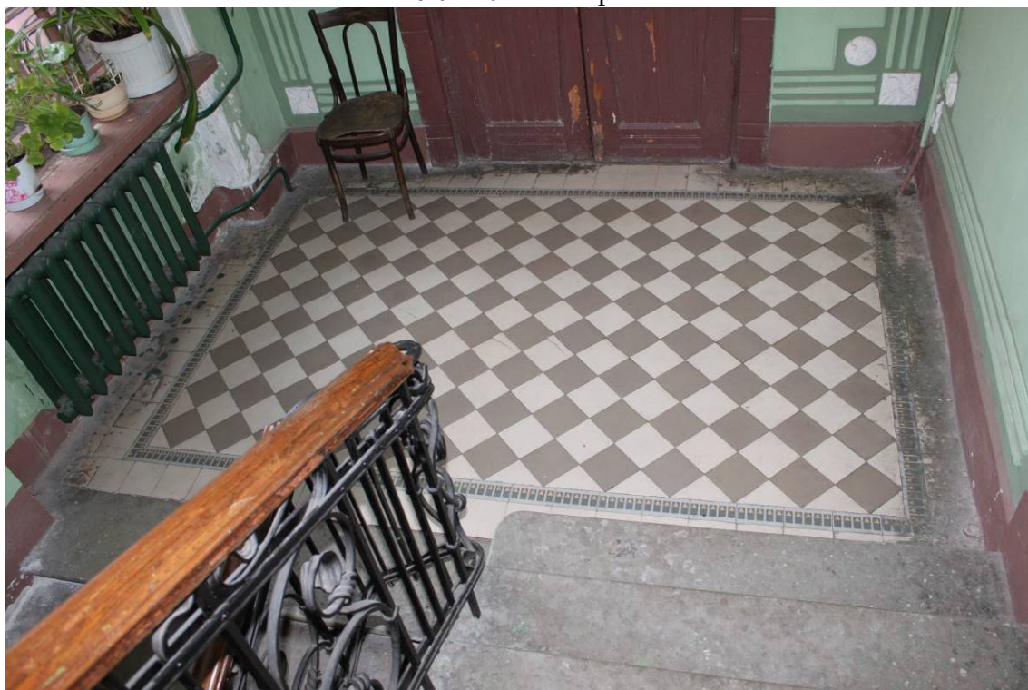
Фото 294. Лестница № 2: Площадка между 5-м и 6-м этажом. Покрытие пола. Съемка 26.04.2021 г. Кириков Б. М.
