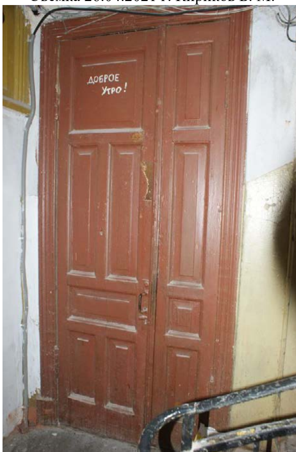
Фото 344. Лестница № 4: Площадка 6-го этажа. Оформление двери. Съемка 26.04.2021 г. Кириков Б. М.
