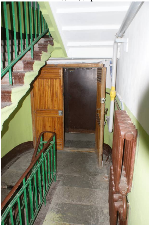
Фото 303. Лестница № 3: 1-й этаж. Входная дверь. Съемка 26.04.2021 г. Кириков Б. М.
