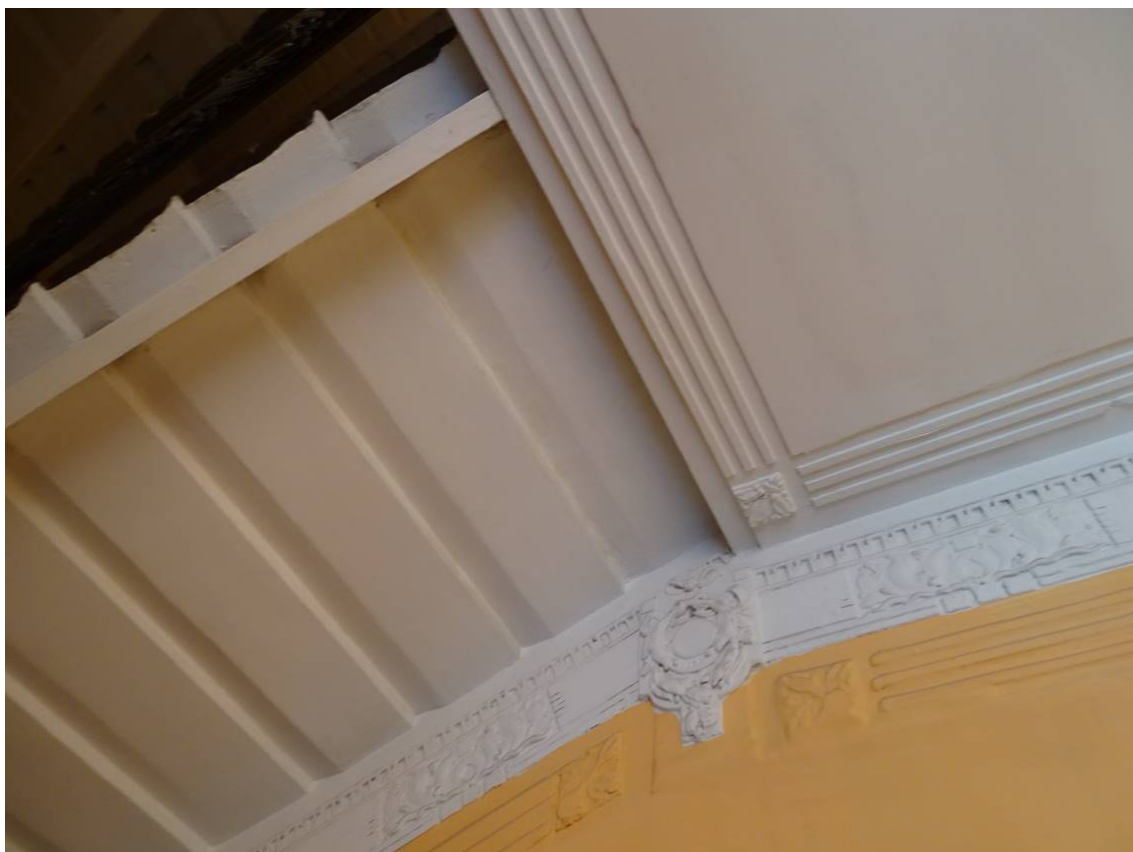
Фото 195. Лестница № 6: Площадка между 1-м и 2-м этажом. Съемка 26.04.2021 г. Кириков Б. М.
