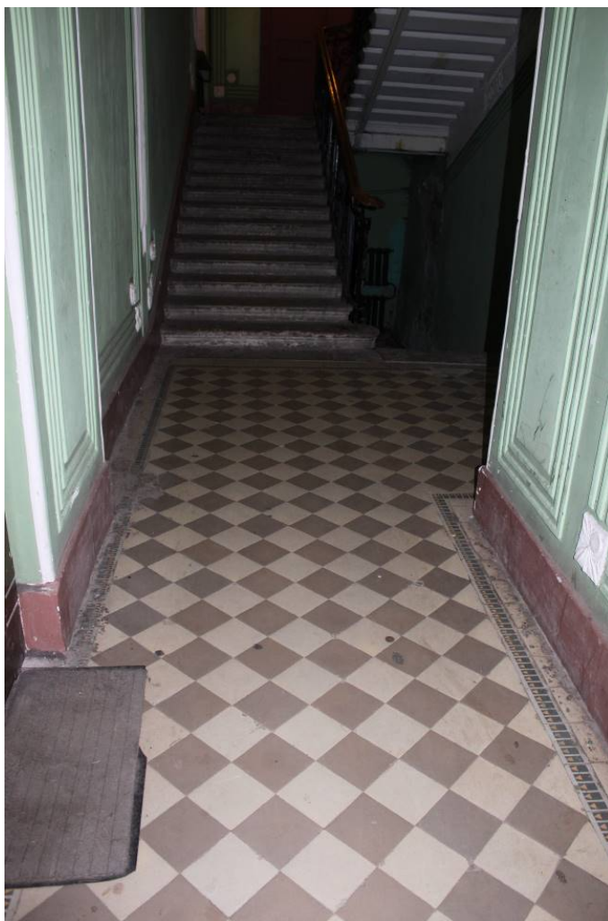
Фото 263. Лестница № 2: Площадка 1-го этажа. Съемка 26.04.2021 г. Кириков Б. М.
