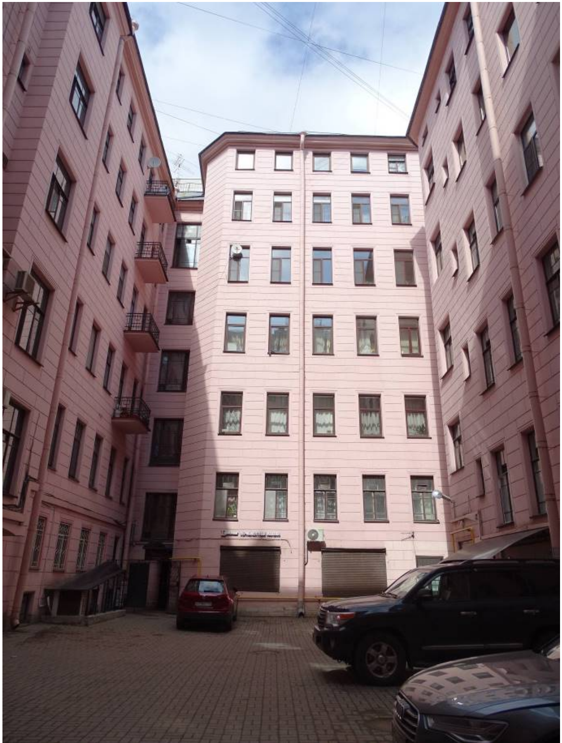
Фото 98. Северный фасад внутреннего двора. Съемка 26.04.2021 г. Кириков Б. М.
