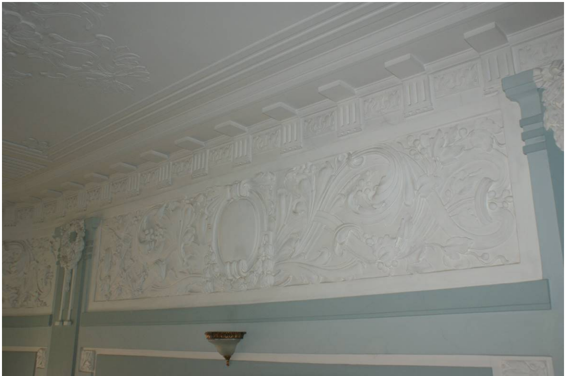
Фото 229. Лестница № 1: Площадка 6-го этажа. Оформление стен. Съемка 26.04.2021 г. Кириков Б. М.
