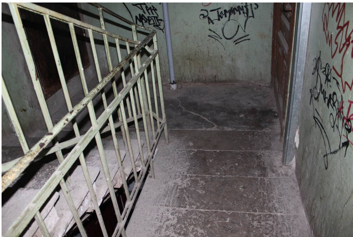
Фото 238. Лестница № 1 (двор): Площадка 2-го этажа Покрытие пола. Съемка 26.04.2021 г. Кириков Б. М.
