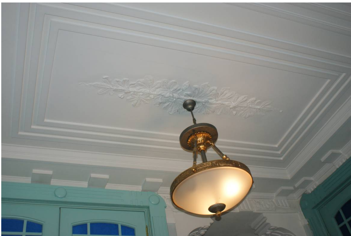
Фото 227. Лестница № 1: Площадка 6-го этажа. Оформление плафона. Съемка 26.04.2021 г. Кириков Б. М.
