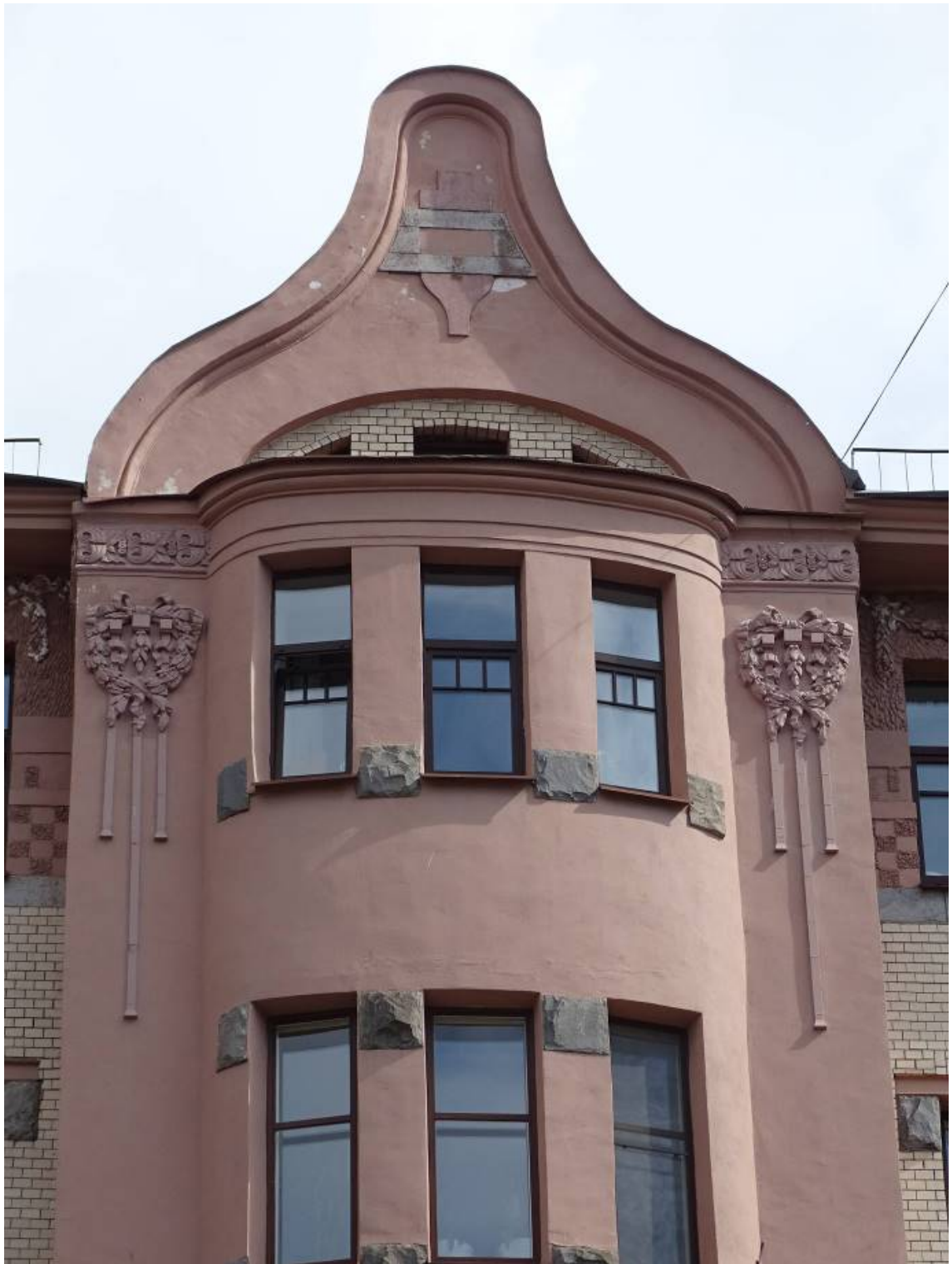
Фото 75. Фрагмент лицевого фасада с пр. Чернышевского. Эркер. 5-й и 6-й этажи. Щипец. Съемка 26.04.2021 г. Кириков Б. М.
