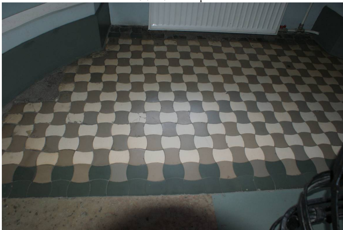
Фото 202. Лестница № 1: Площадка между 2-м и 3-м этажом. Покрытие пола. Съемка 26.04.2021 г. Кириков Б. М.
