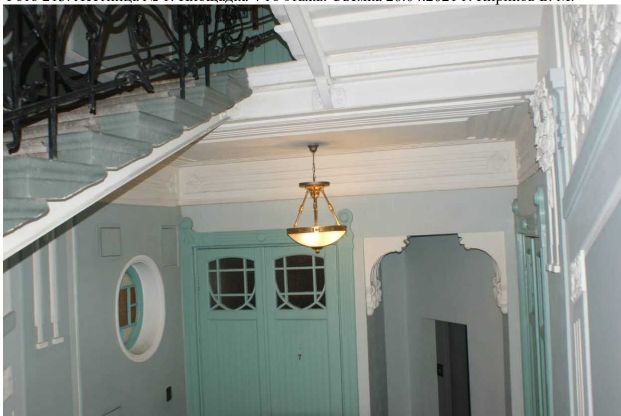
Фото 214. Лестница № 1: Площадка 4-го этажа. Съемка 26.04.2021 г. Кириков Б. М.
