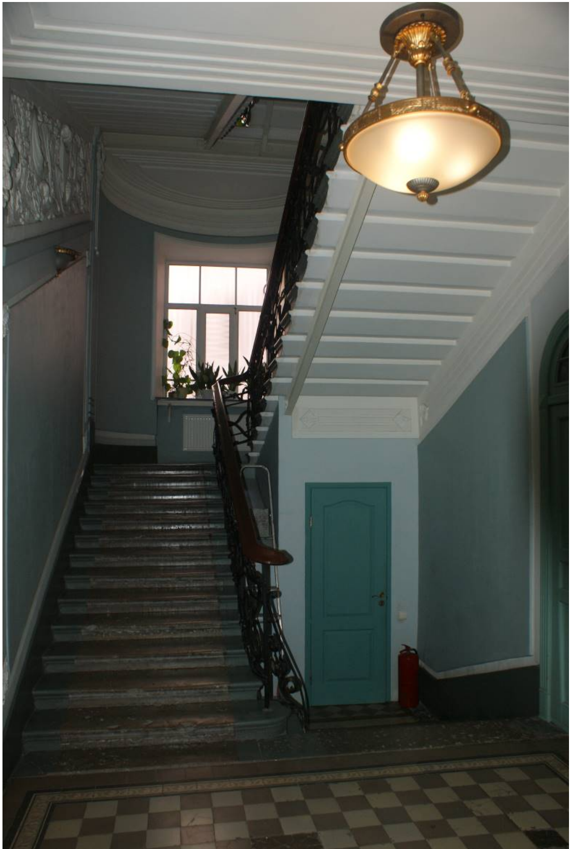
Фото 192. Лестница № 1: Вид на площадку между 1-м и 2-м этажом. Съемка 26.04.2021 г. Кириков Б. М.
