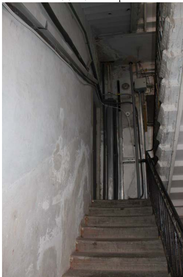
Фото 334. Лестница № 4: Площадка 3-го этажа. Съемка 26.04.2021 г. Кириков Б. М.
