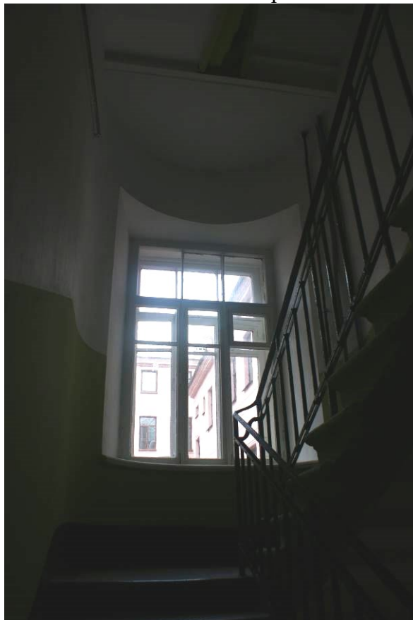
Фото 317. Лестница № 3: Площадка между 4-м и 5-м этажом. Съемка 26.04.2021 г. Кириков Б. М.
