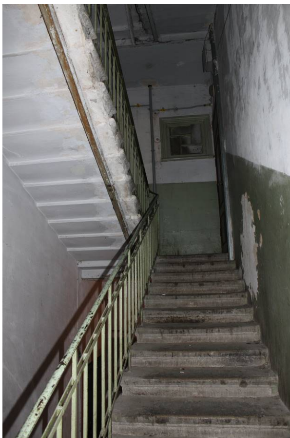
Фото 244. Лестница № 1 (двор): Площадка 4-го этажа. Съемка 26.04.2021 г. Кириков Б. М.
