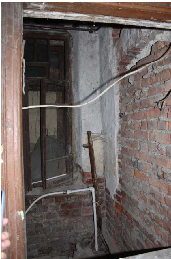
Фото 267. Лестница № 2: Цокольный этаж. Съемка 26.04.2021 г. Кириков Б. М.
