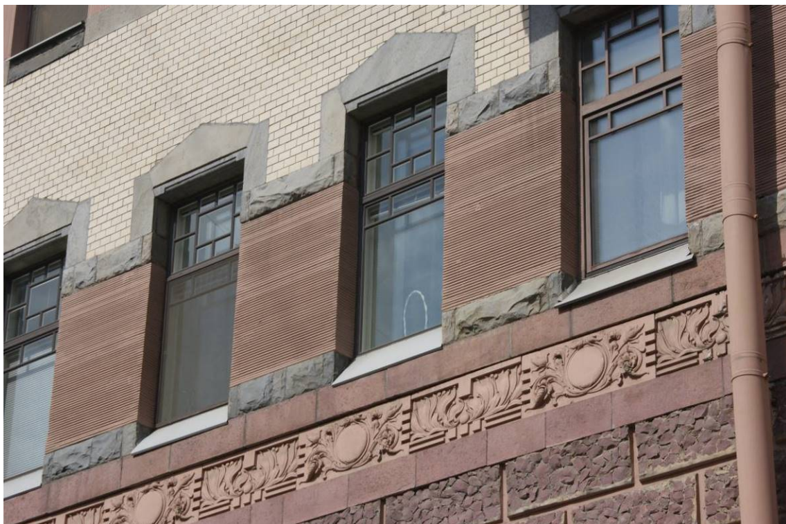
Фото 93. Фрагмент лицевого фасада с ул. Захарьевской. Оформление оконных проемов. 3-й этаж. Съемка 26.04.2021 г. Кириков Б. М.
