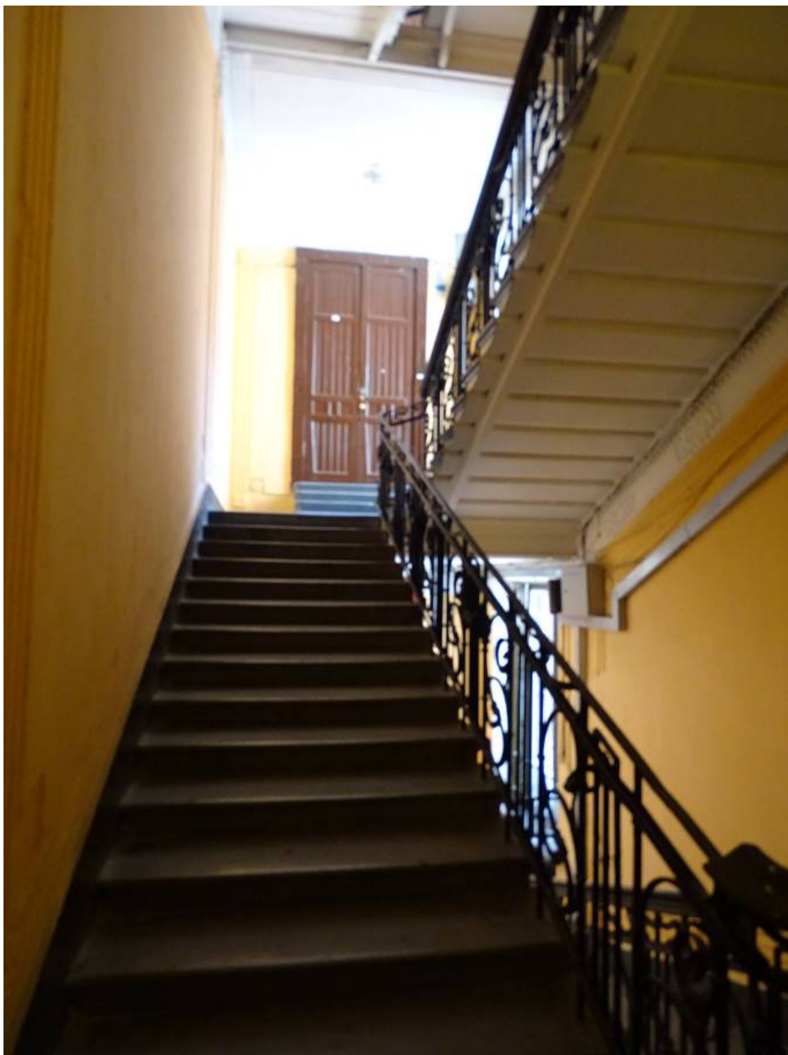
Фото 201. Лестница № 6: Площадка между 2-м и 3-м этажом. Съемка 26.04.2021 г. Кириков Б. М.
