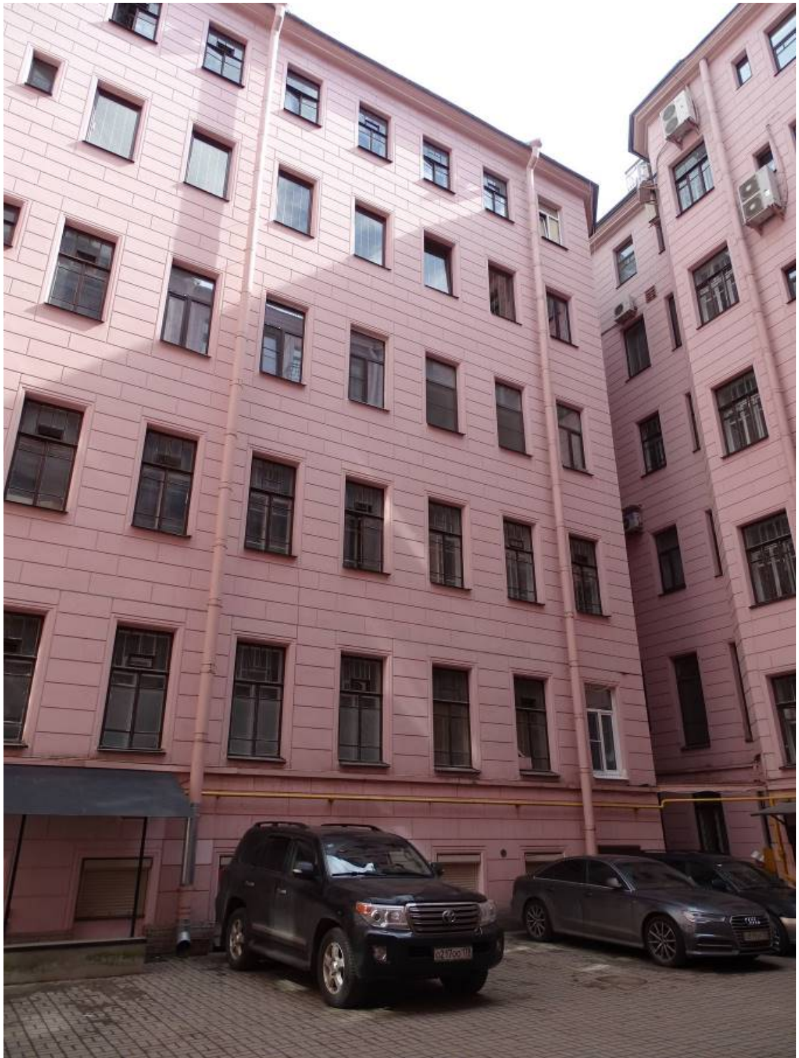
Фото 103. Фрагмент восточного фасада внутреннего двора. Съемка 26.04.2021 г. Кириков Б. М.
