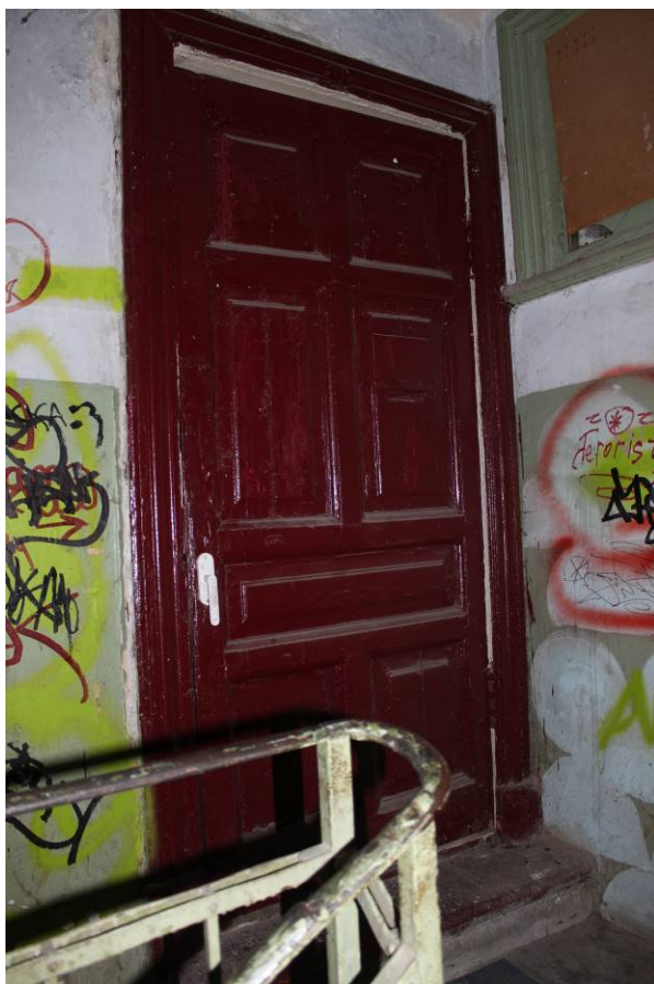
Фото 234. Лестница № 1 (двор): 1-й этаж. Оформление двери. Съемка 26.04.2021 г. Кириков Б. М.
