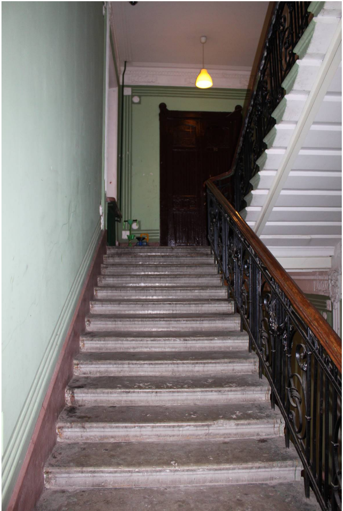
Фото 276. Лестница № 2: Лестничный марш на площадку между 2-м и 3-м этажом. Съемка 26.04.2021 г. Кириков Б. М.
