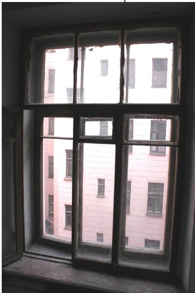
Фото 336. Лестница № 4: Площадка между 3-м и 4-м этажом. Оформление окна. Съемка 26.04.2021 г. Кириков Б. М.
