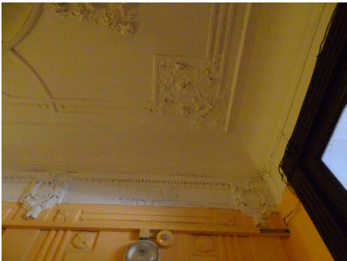
Фото 177. Лестница № 6: Лестница № 6: 1 этаж. Оформление плафона и стен. Съемка 26.04.2021 г. Кириков Б. М.
