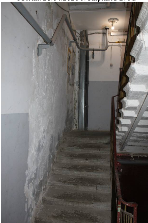
Фото 328. Лестница № 4: 1-й этаж. Съемка 26.04.2021 г. Кириков Б. М.
