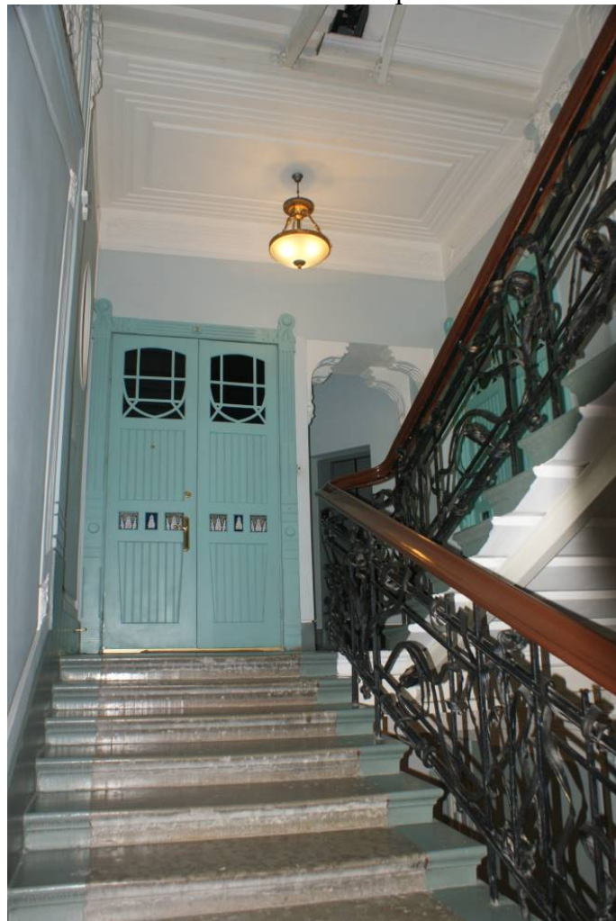
Фото 197. Лестница № 1: Площадка 2-го этажа. Съемка 26.04.2021 г. Кириков Б. М.
