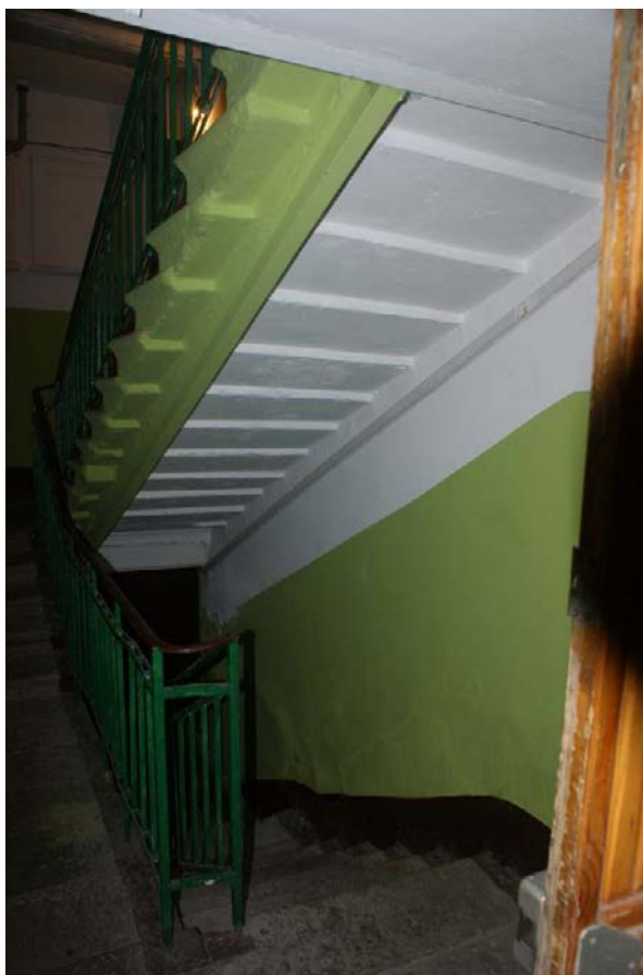
Фото 304. Лестница № 3: 1-й этаж. Пространство под лестницей. Съемка 26.04.2021 г. Кириков Б. М.
