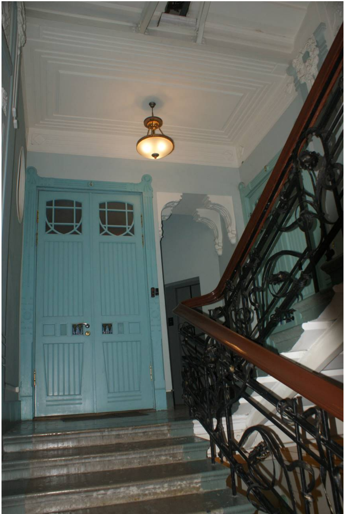
Фото 205. Лестница № 1: Площадка 3-го этажа. Съемка 26.04.2021 г. Кириков Б. М.
