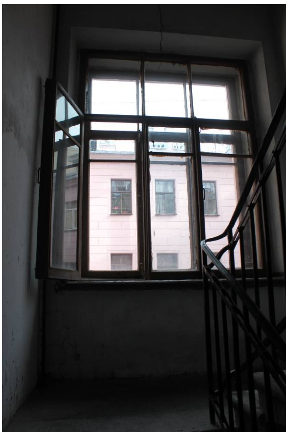
Фото 339. Лестница № 4: Площадка между 4-м и 5-м этажом. Оформление окна. Съемка 26.04.2021 г. Кириков Б. М.
