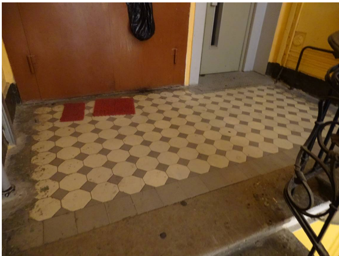
Фото 205. Лестница № 6: 3 этаж. Покрытие пола. Съемка 26.04.2021 г. Кириков Б. М.
