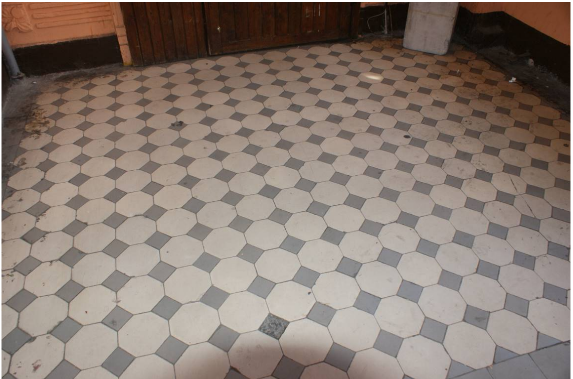
Фото 224. Лестница № 6: Площадка между 5-м и 6-м этажом. Покрытие пола. Съемка 26.04.2021 г. Кириков Б. М.
