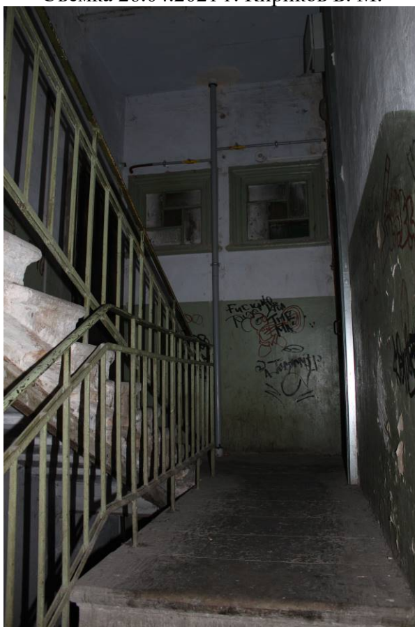
Фото 237. Лестница № 1 (двор): Площадка 2-го этажа. Съемка 26.04.2021 г. Кириков Б. М.
