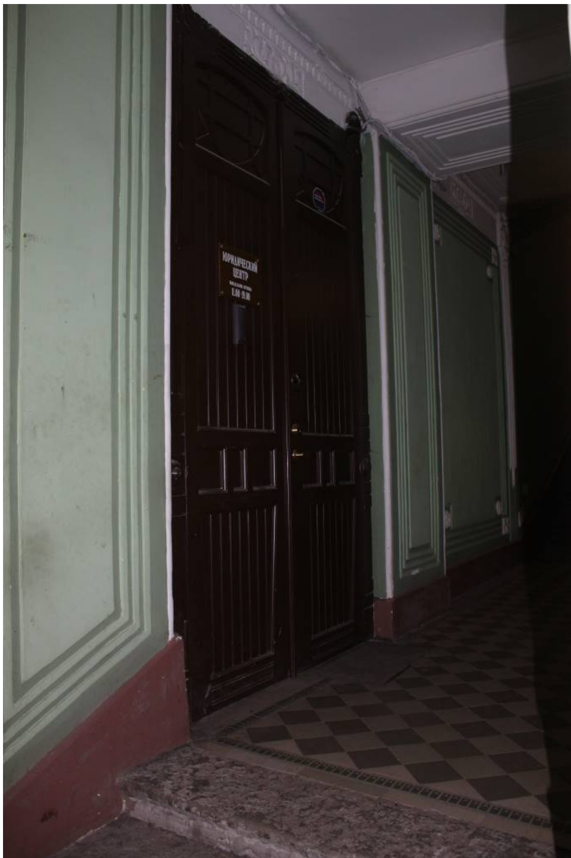
Фото 262. Лестница № 2: Площадка 1-го этажа. Съёмка 26.04.2021 г. Кириков Б. М.
