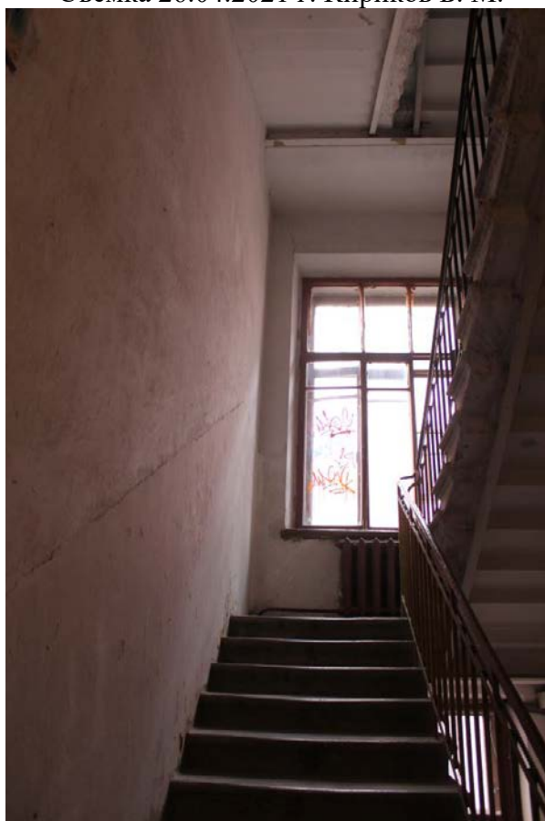
Фото 332. Лестница № 4: Площадка между 2-м и 3-м этажом. Съемка 26.04.2021 г. Кириков Б. М.
