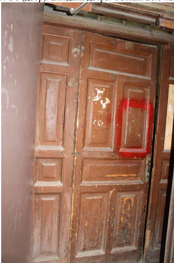
Фото 231. Лестница № 1 (двор): Оформление двери. Съёмка 26.04.2021 г. Кириков Б. М.
