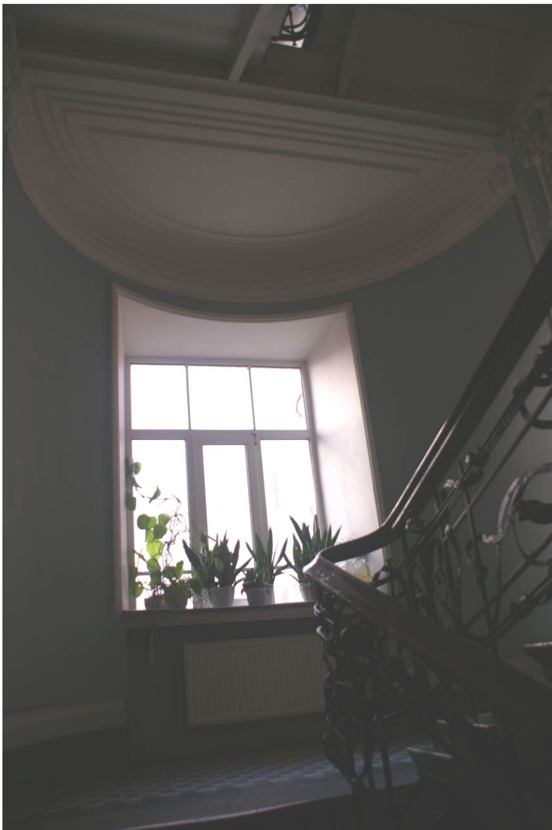
Фото 195. Лестница № 1: Площадка между 1-м и 2-м этажом. Съёмка 26.04.2021 г. Кириков Б. М.
