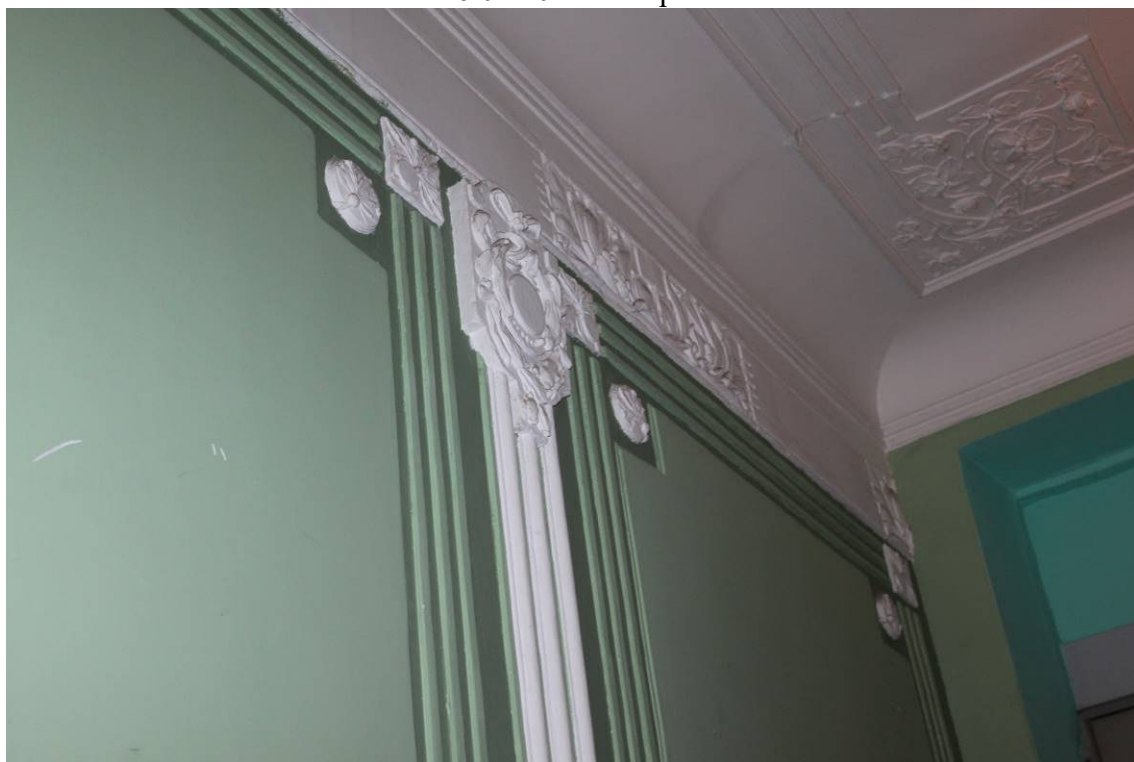
Фото 300. Лестница № 2: Площадка 6-го этажа. Лепное оформление. Съемка 26.04.2021 г. Кириков Б. М.
