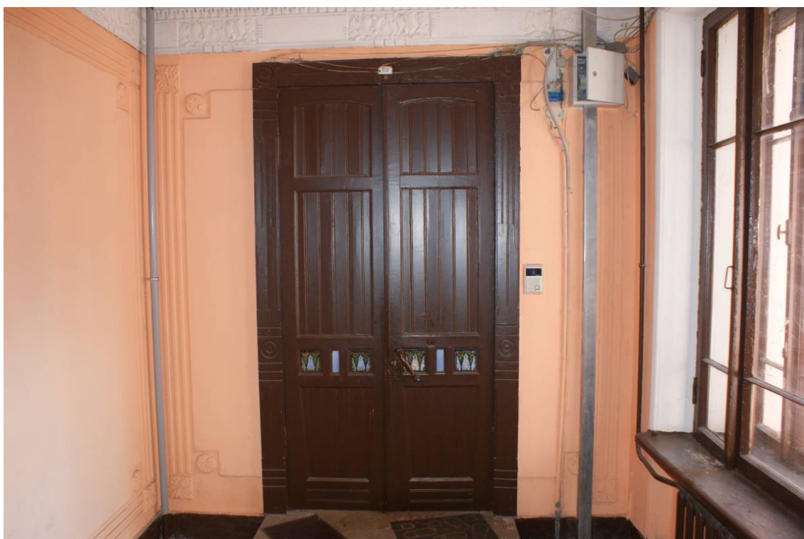
Фото 216. Лестница № 6: Площадка между 4-м и 5-м этажом. Съемка 26.04.2021 г. Кириков Б. М.
