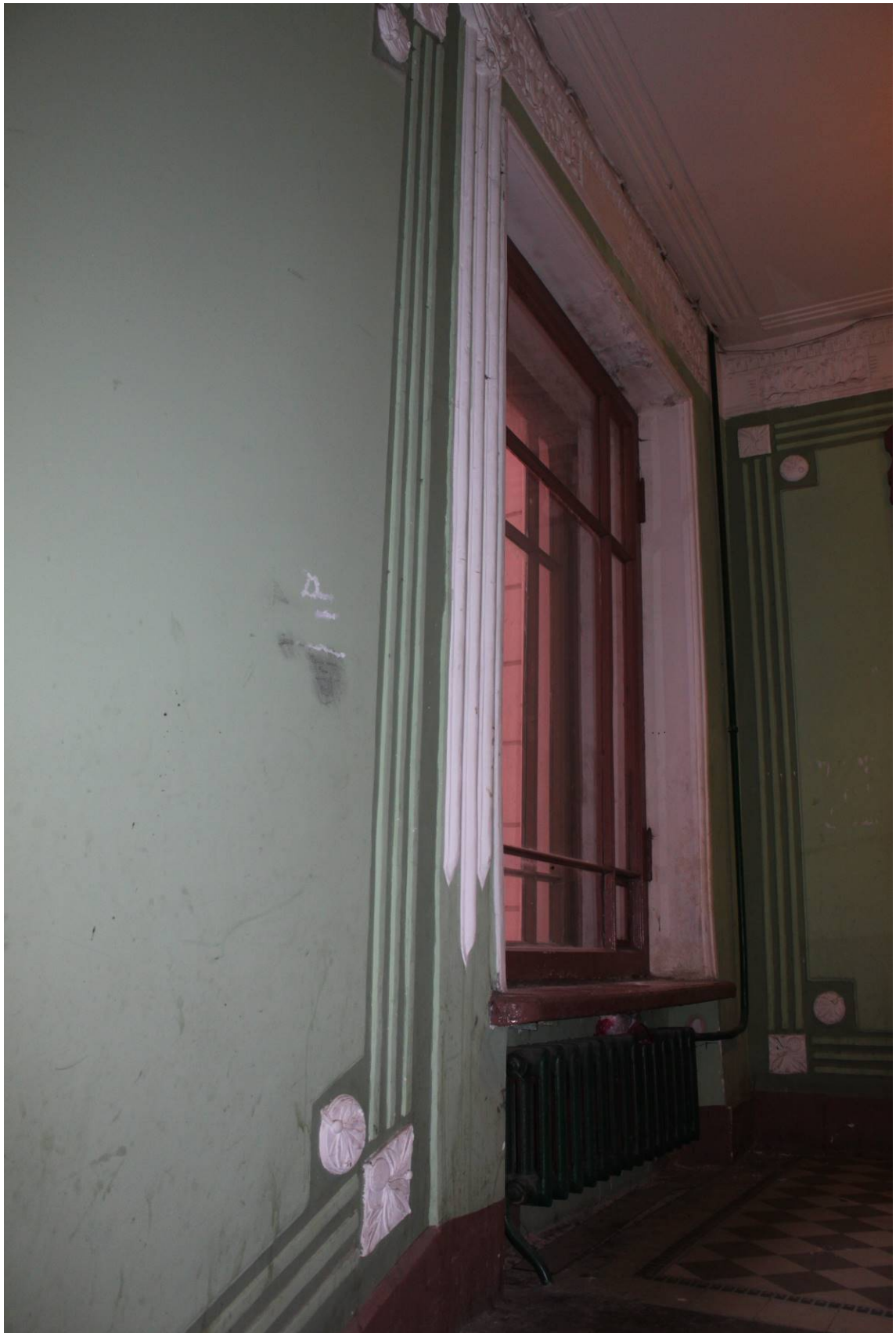
Фото 271. Лестница № 2: Площадка между 1-м и 2-м этажом. Оформление окна. Съемка 26.04.2021 г. Кириков Б. М.
