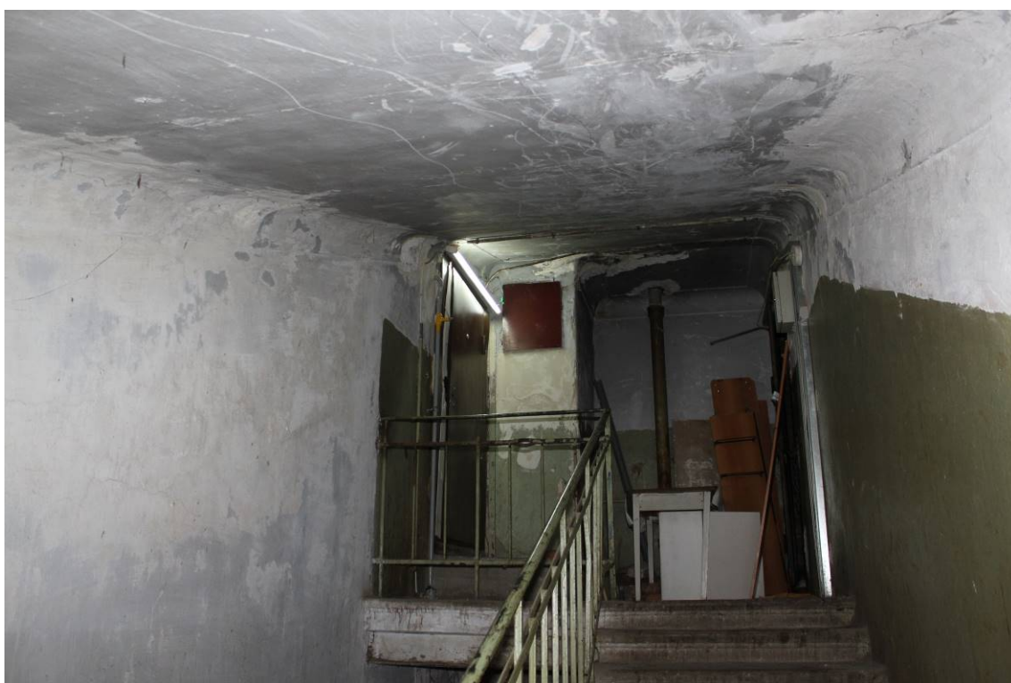
Фото 249. Лестница № 1 (двор): Площадка 6-го этажа. Съемка 26.04.2021 г. Кириков Б. М.
