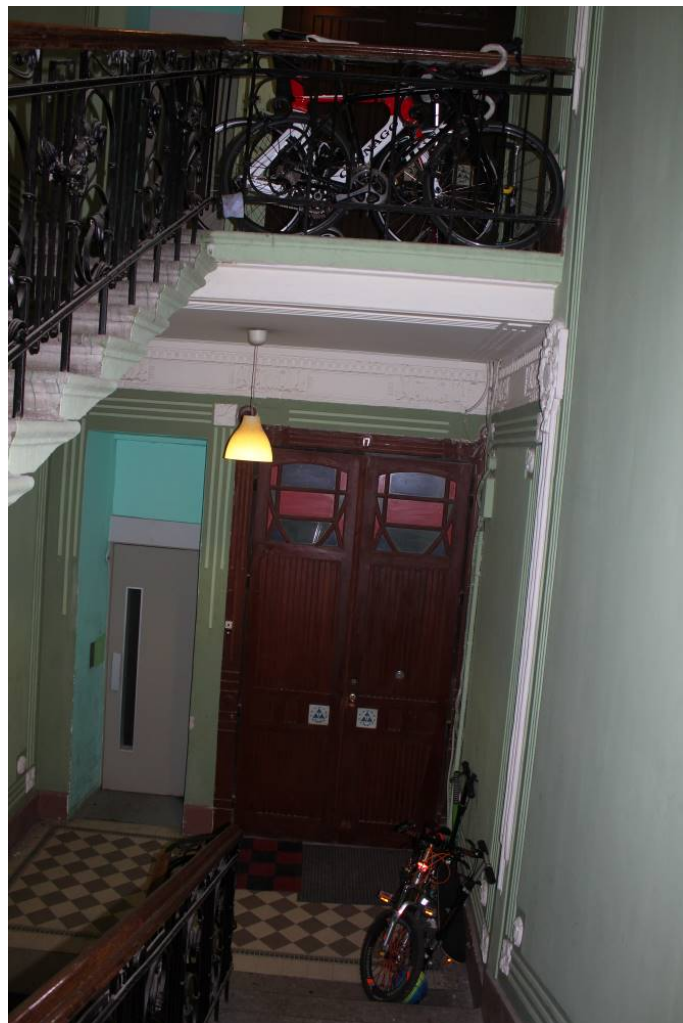
Фото 291. Лестница № 2: Площадка 5-го этажа. Съемка 26.04.2021 г. Кириков Б. М.
