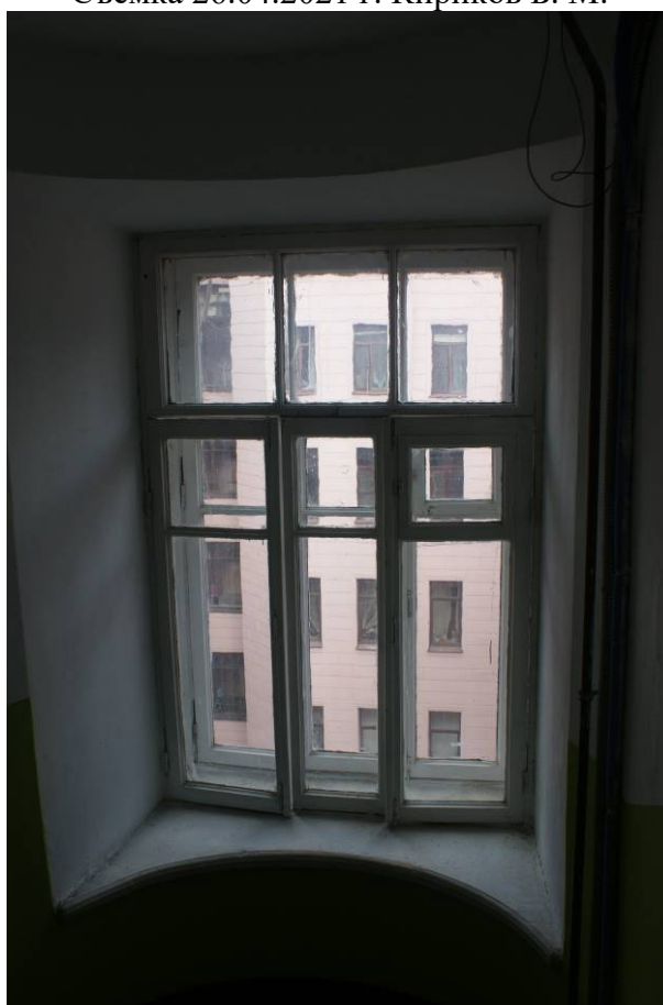
Фото 321. Лестница № 3: Площадка между 5-м и 6-м этажом. Оформление окна. Съемка 26.04.2021 г. Кириков Б. М.
