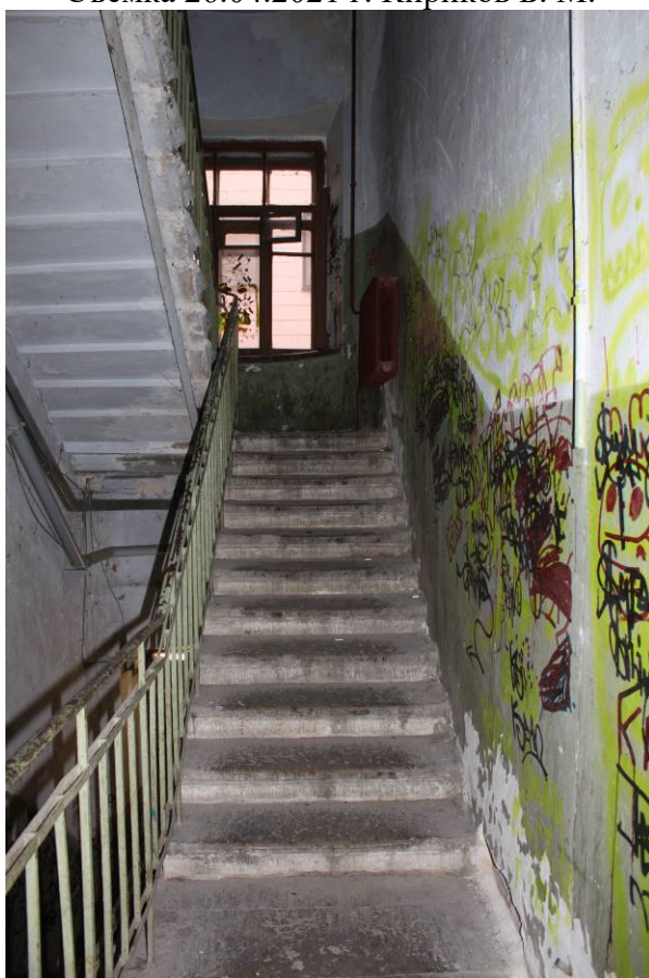
Фото 235. Лестница № 1 (двор): Лестничный марш на площадку между 1-м и 2-м этажом. Съемка 26.04.2021 г. Кириков Б. М.
