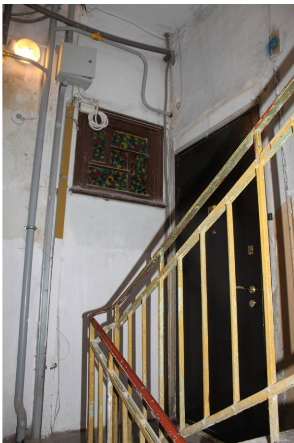
Фото 331. Лестница № 4: Площадка 2-го этажа. Съемка 26.04.2021 г. Кириков Б. М.
