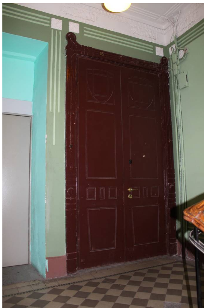
Фото 286. Лестница № 2: Площадка 4-го этажа. Оформление двери. Съемка 26.04.2021 г. Кириков Б. М.
