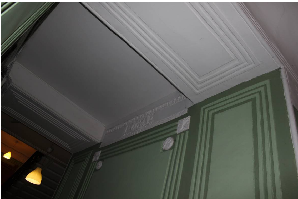
Фото 260. Лестница № 2: Вестибюль. 1-й этаж. Оформление потолка. Съемка 26.04.2021 г. Кириков Б. М.
