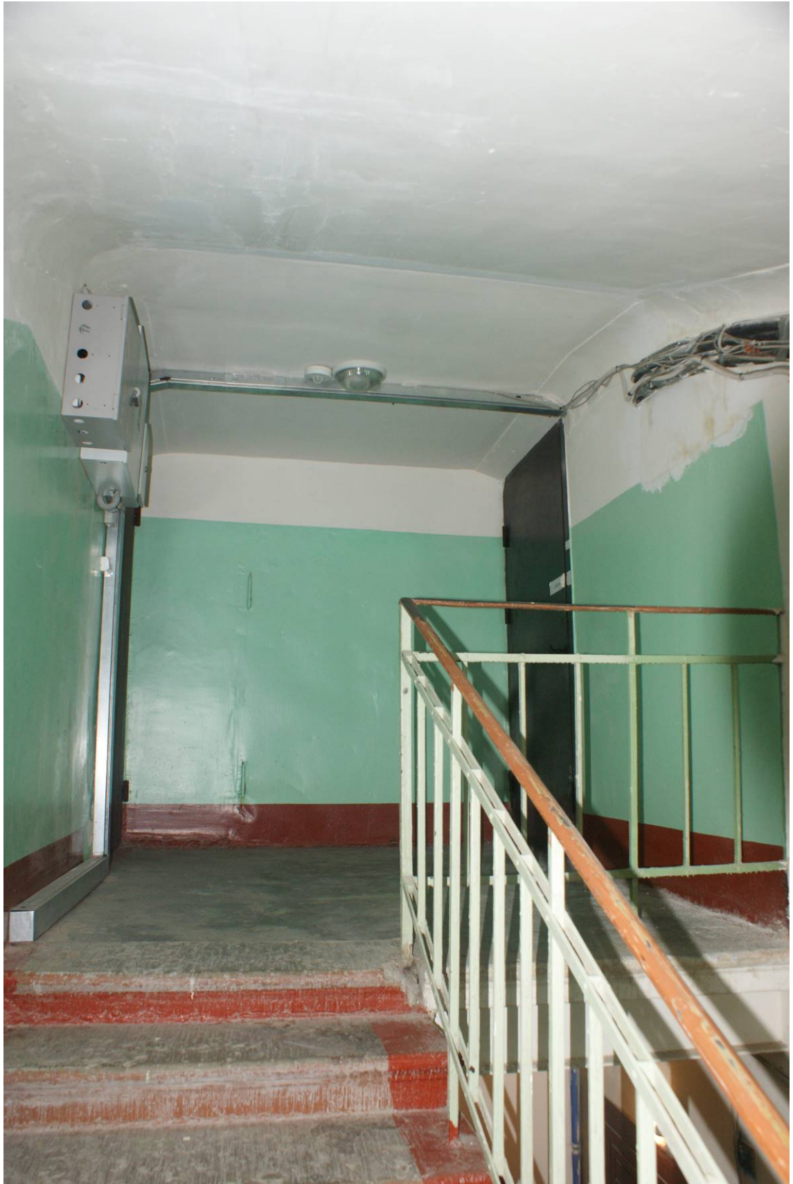
Фото 324. Лестница № 3: Площадка 7-го этажа. Съемка 26.04.2021 г. Кириков Б. М.
