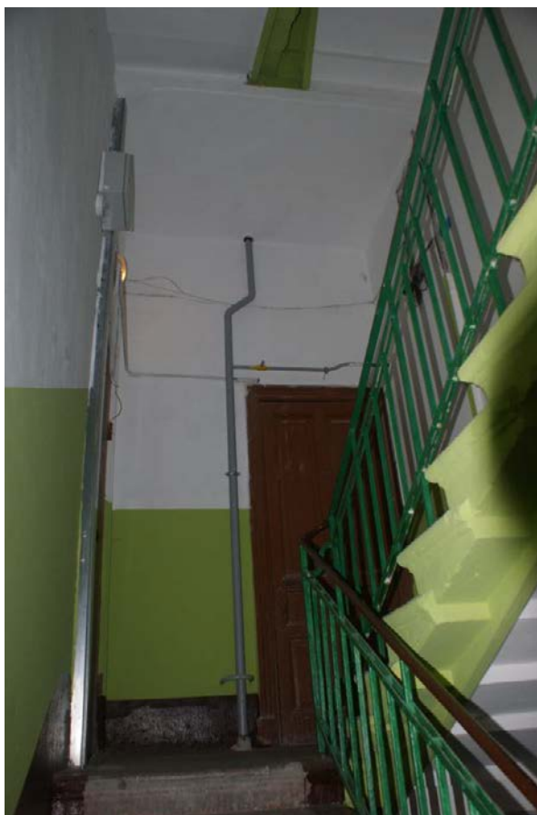
Фото 310. Лестница № 3: Площадка 3-го этажа. Съемка 26.04.2021 г. Кириков Б. М.
