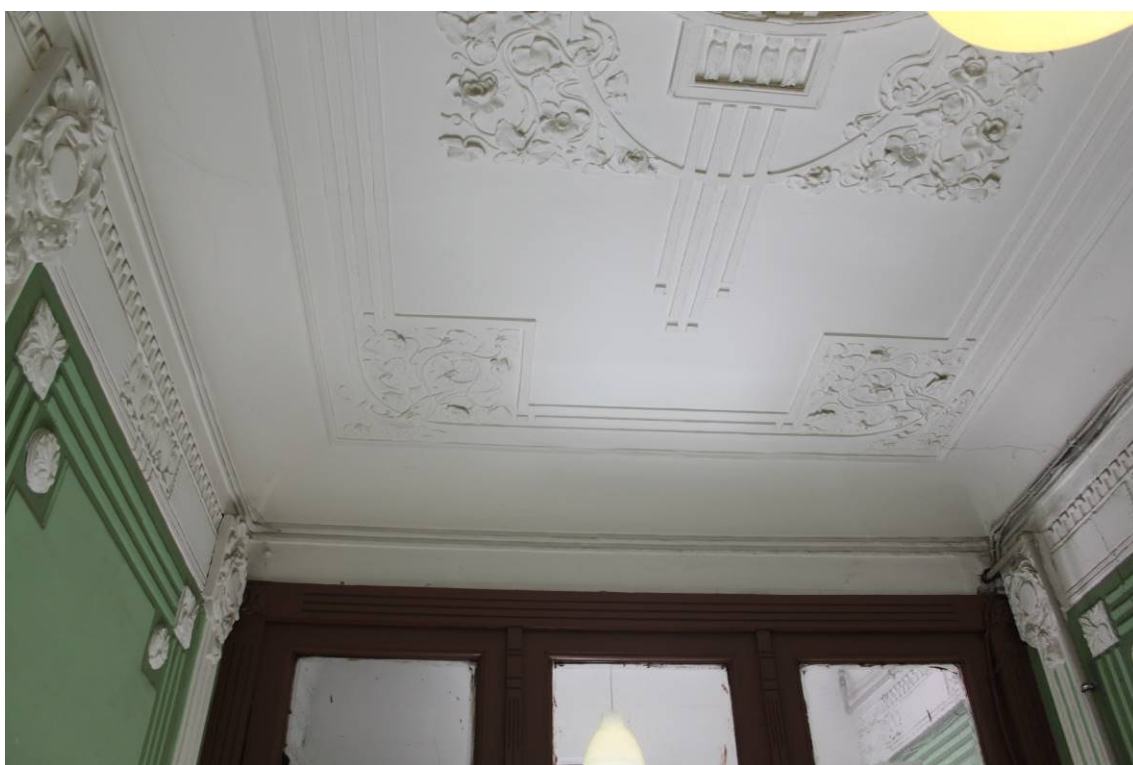
Фото 255. Лестница № 2: Вестибюль. 1-й этаж. Оформление потолка. Съемка 26.04.2021 г. Кириков Б. М.
