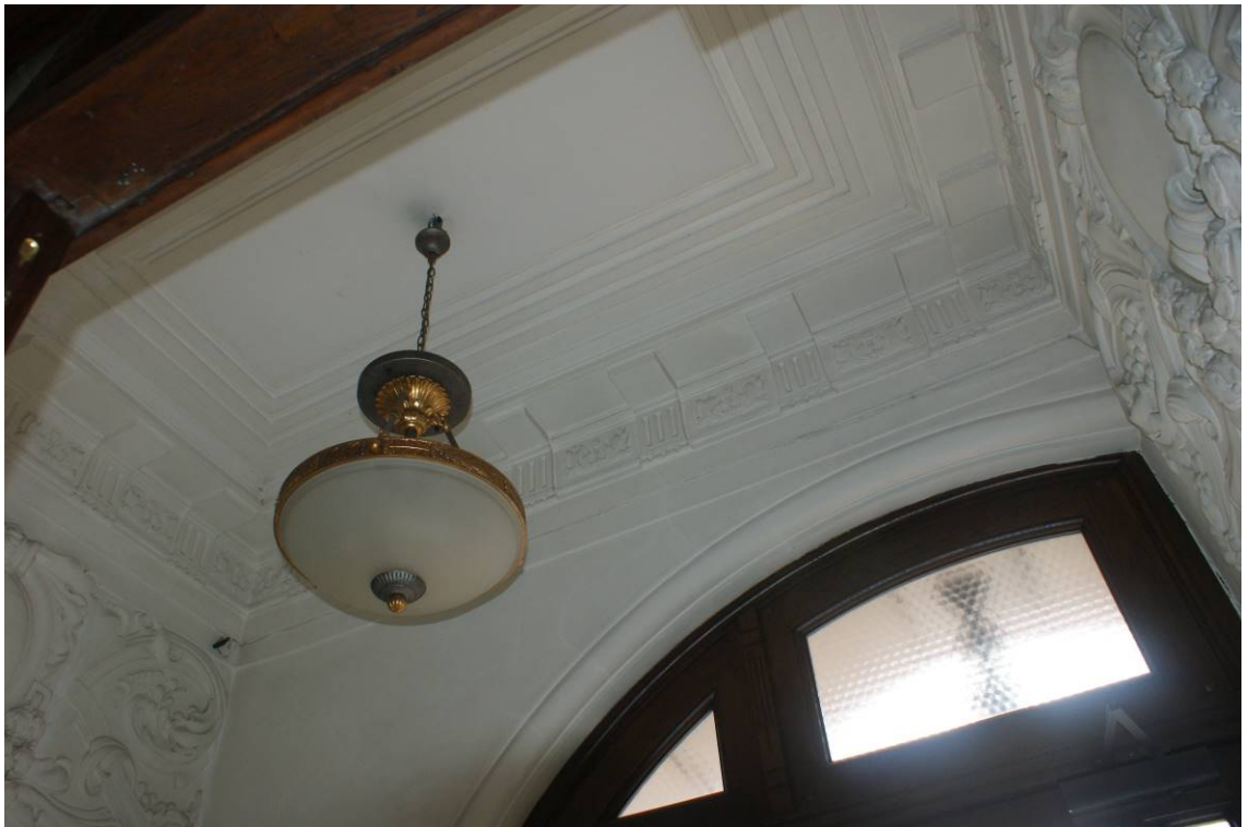
Фото 176. Лестница № 1: Тамбур. 1-й этаж. Съемка 26.04.2021 г. Кириков Б. М.
