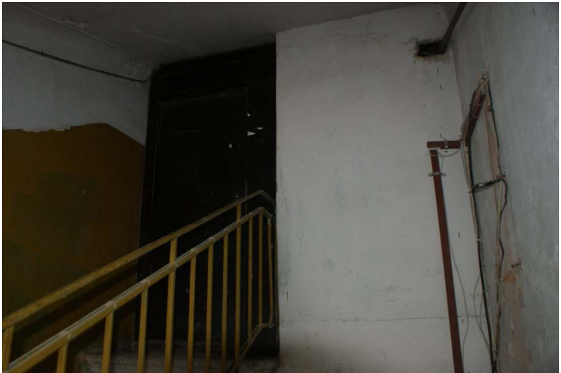
Фото 346. Лестница № 4: Площадка 7-го этажа. Съемка 26.04.2021 г. Кириков Б. М.
