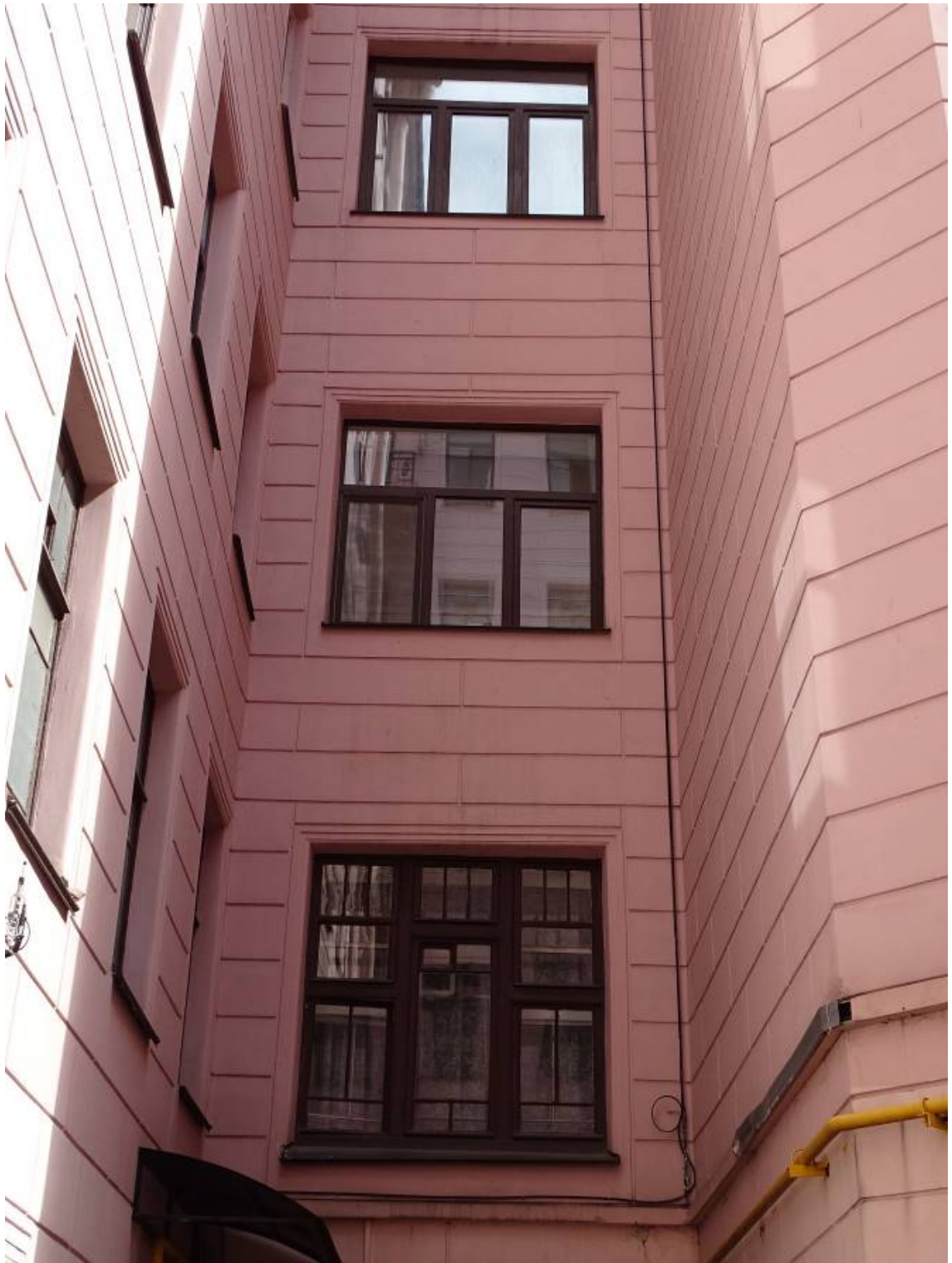
Фото 104. Фрагмент восточного фасада внутреннего двора. 2-й, 3-й, 4-й этажи. Съемка 26.04.2021 г. Кириков Б. М.
