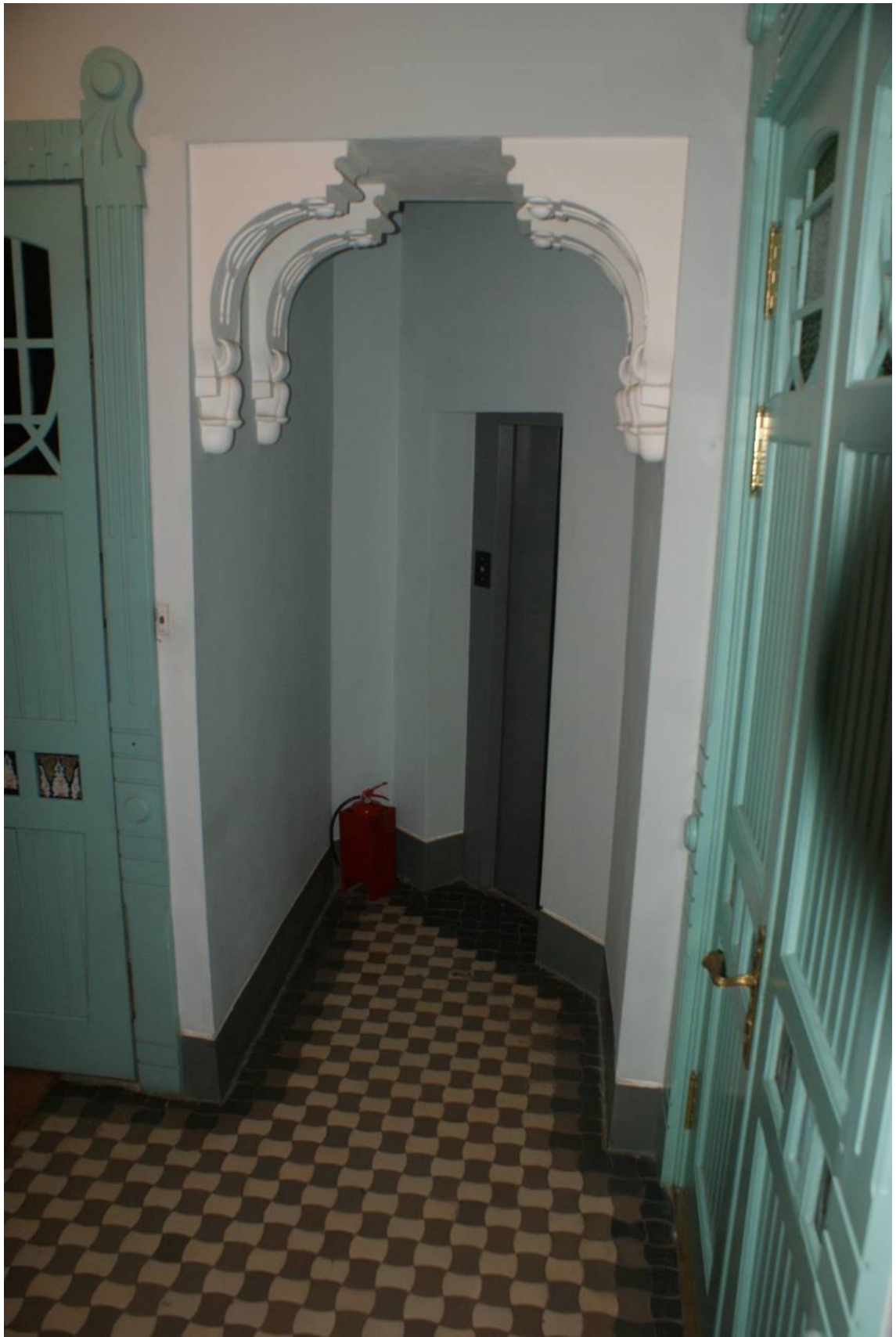
Фото 199. Лестница № 1: Площадка 2-го этажа. Съемка 26.04.2021 г. Кириков Б. М.
