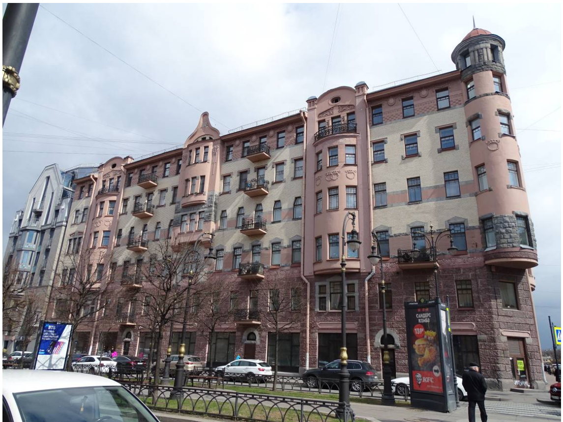
Фото 61. Вид на лицевой фасад с пр. Чернышевского. Съемка 26.04.2021 г. Кириков Б. М.
