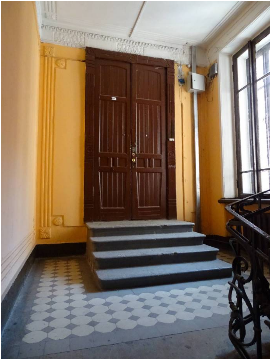
Фото 202. Лестница № 6: Площадка между 2-м и 3-м этажом. Съемка 26.04.2021 г. Кириков Б. М.
