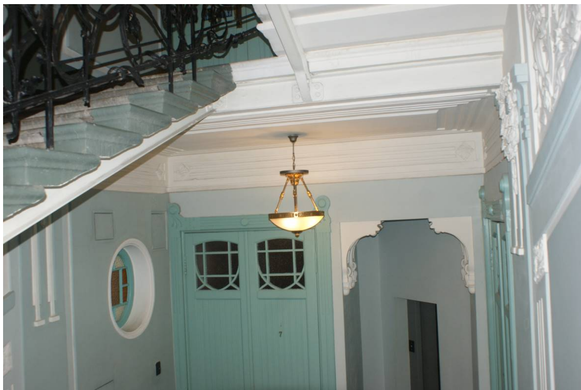
Фото 208. Лестница № 1: Площадка 3-го этажа. Покрытие пола. Съемка 26.04.2021 г. Кириков Б. М.
