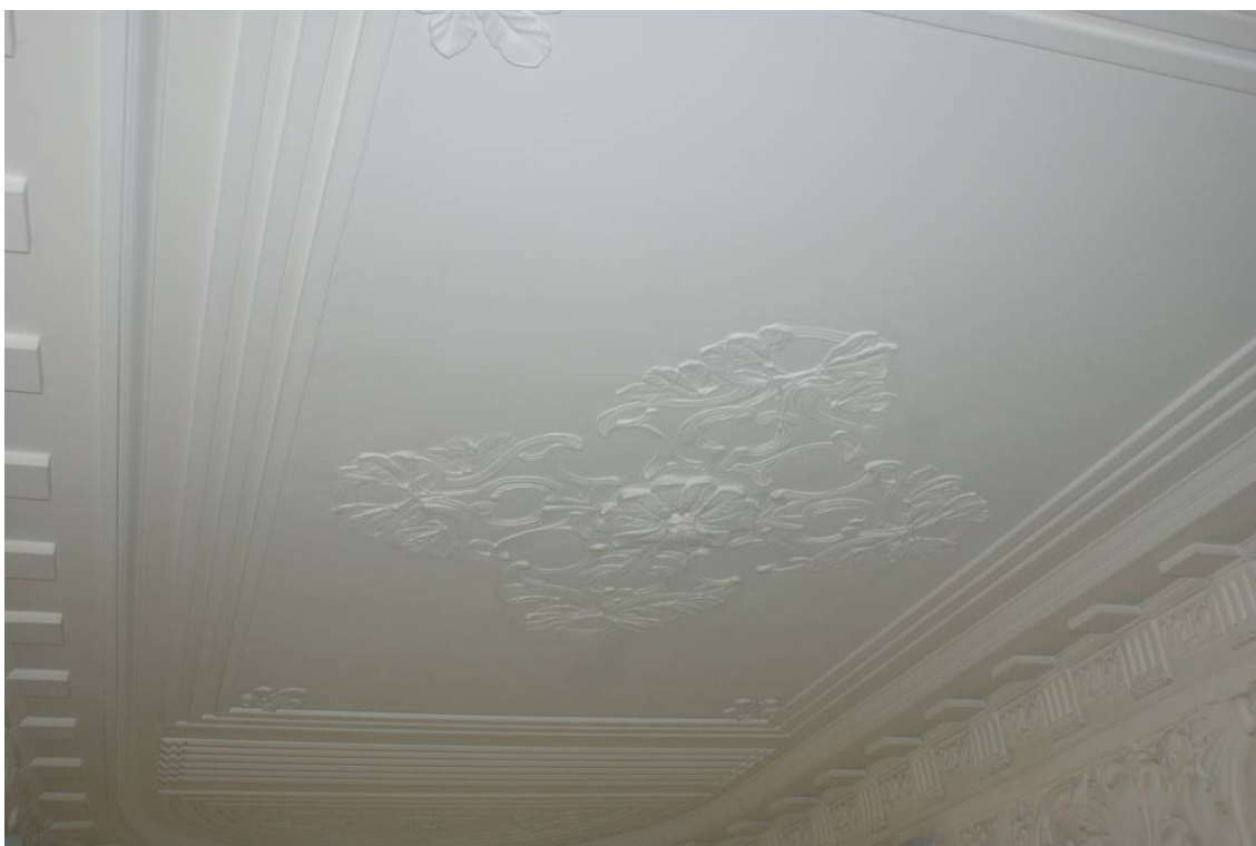
Фото 228. Лестница № 1: Площадка 6-го этажа. Оформление потолка. Съемка 26.04.2021 г. Кириков Б. М.
