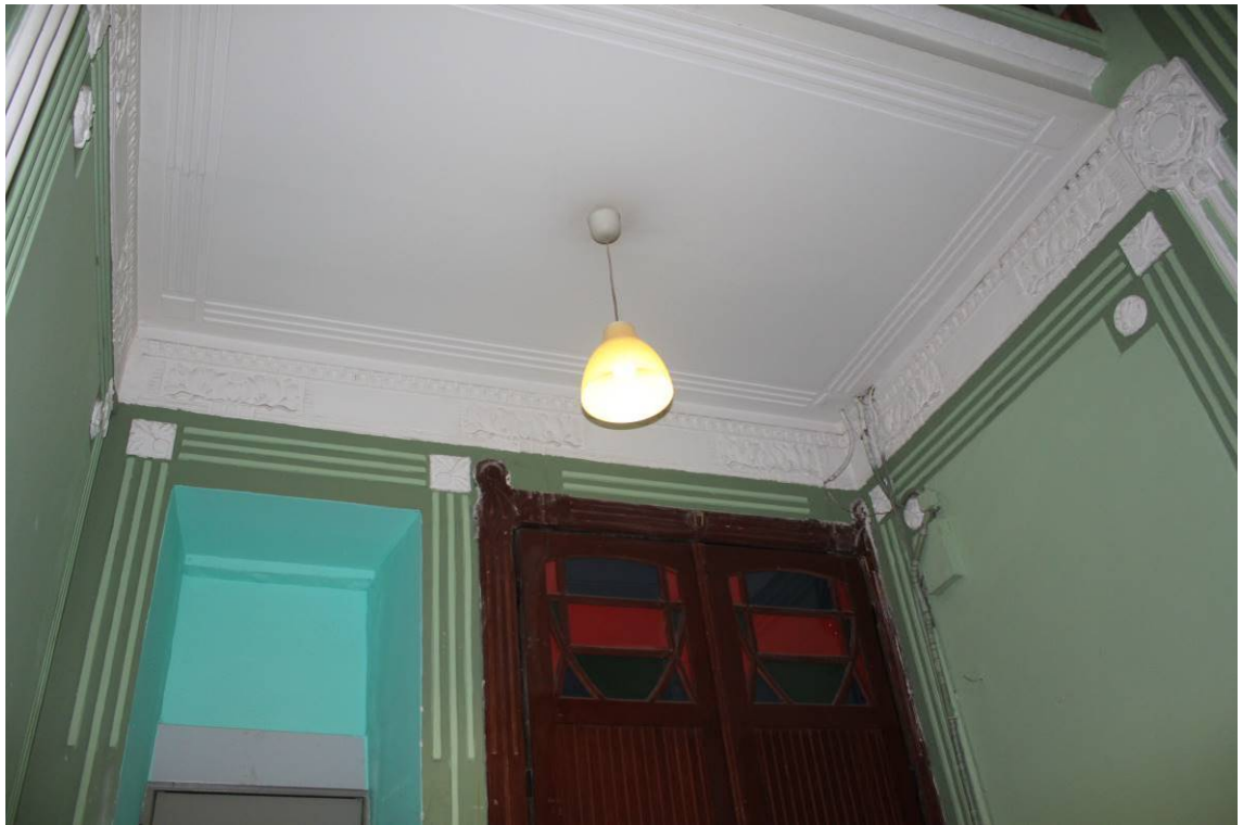
Фото 290. Лестница № 2: Площадка 5-го этажа. Оформление потолка. Съемка 26.04.2021 г. Кириков Б. М.
