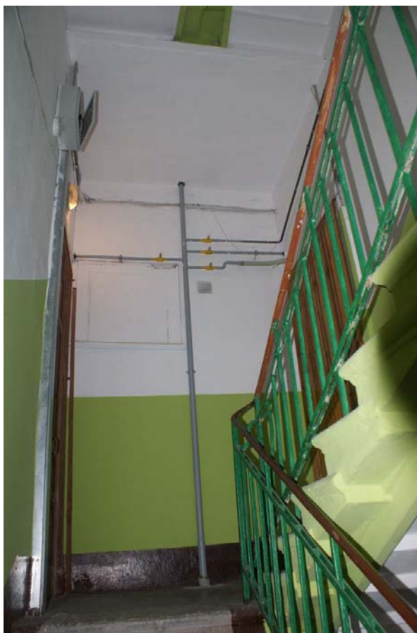
Фото 314. Лестница № 3: Площадка 4-го этажа. Съемка 26.04.2021 г. Кириков Б. М.
