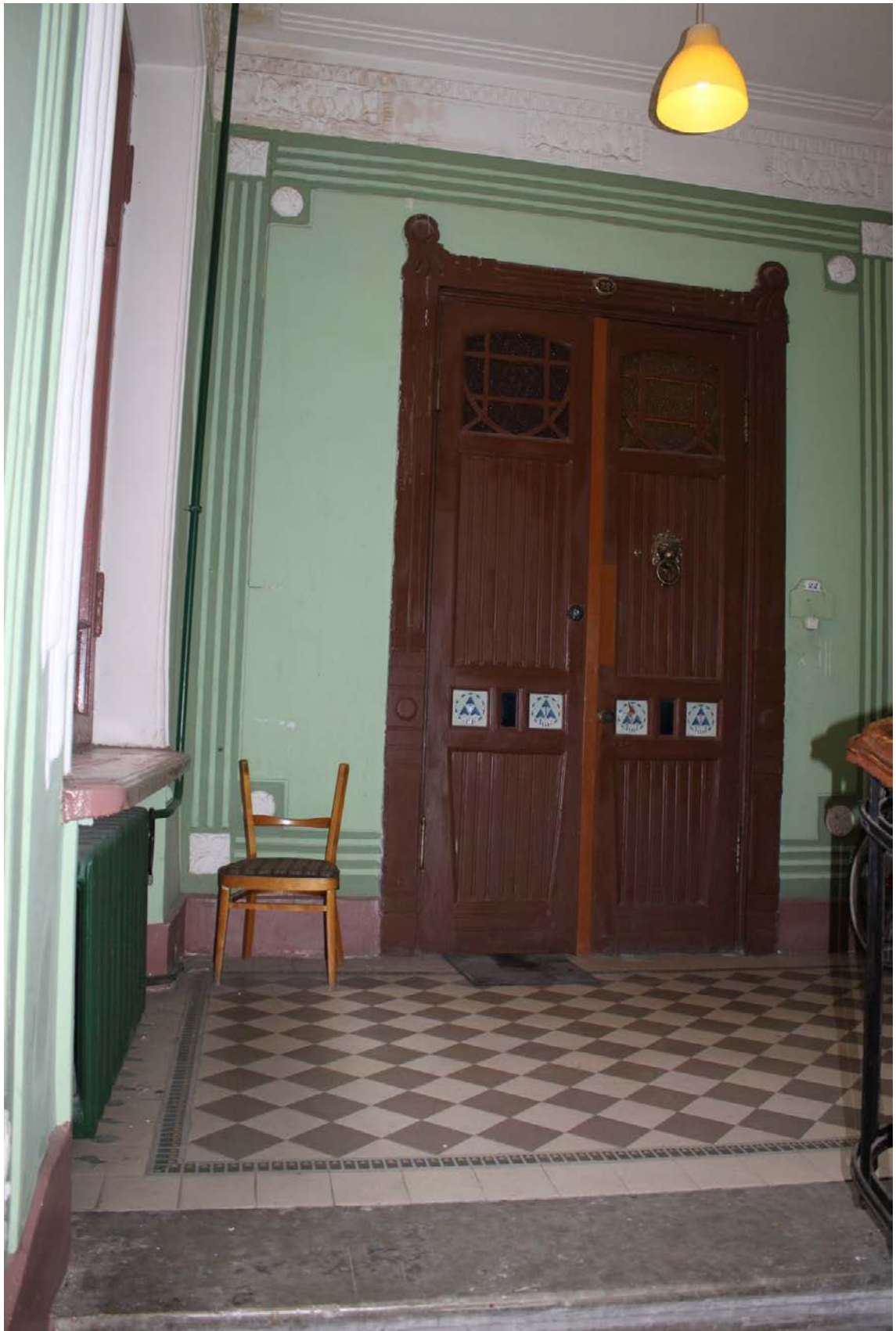
Фото 287. Лестница № 2: Площадка между 4-м и 5-м этажом. Съемка 26.04.2021 г. Кириков Б. М.
