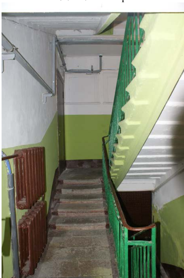
Фото 305. Лестница № 3: 1-й этаж. Съемка 26.04.2021 г. Кириков Б. М.
