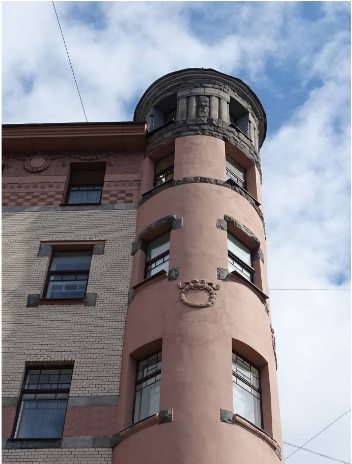
Фото 78. Фрагмент лицевого фасада с пр. Чернышевского. Угловой эркер. 4-й, 5-й, 6-й этажи. Съемка 26.04.2021 г. Кириков Б. М.
