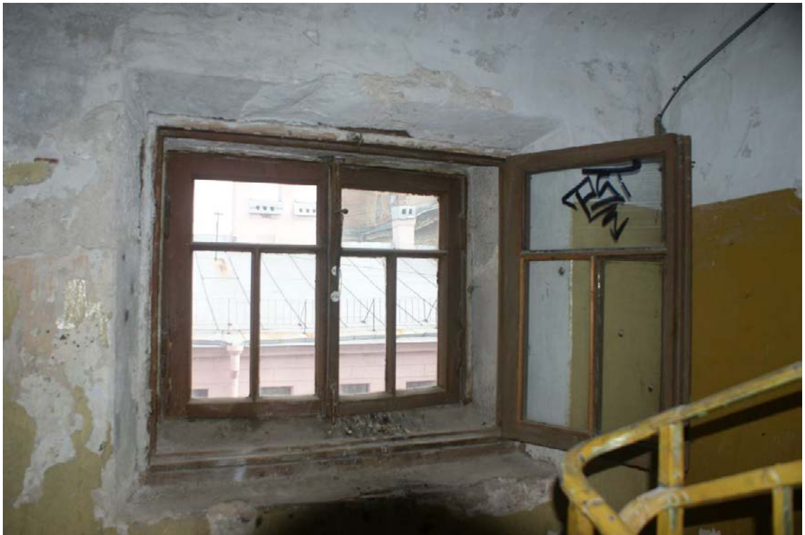
Фото 345. Лестница № 4: Площадка между 6-м и 7-м этажом. Съемка 26.04.2021 г. Кириков Б. М.
