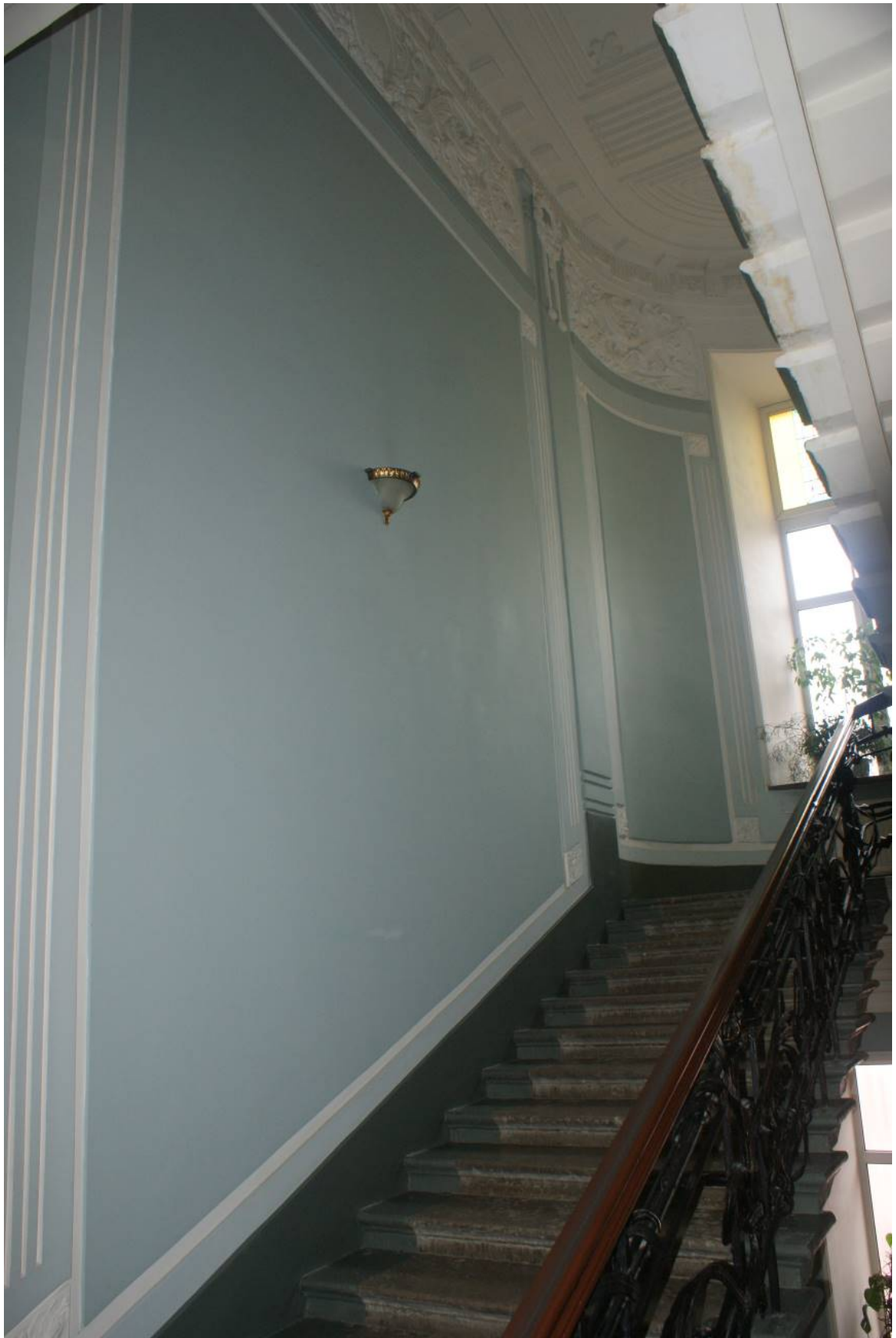
Фото 220. Лестница № 1: Лестничный марш на площадку между 5-м и 6-м этажом. Съемка 26.04.2021 г. Кириков Б. М.
