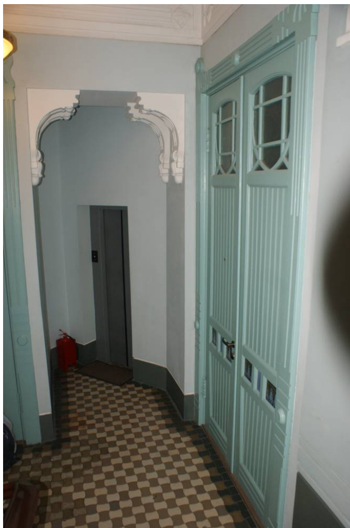
Фото 213. Лестница № 1: Площадка 4-го этажа. Съемка 26.04.2021 г. Кириков Б. М.
