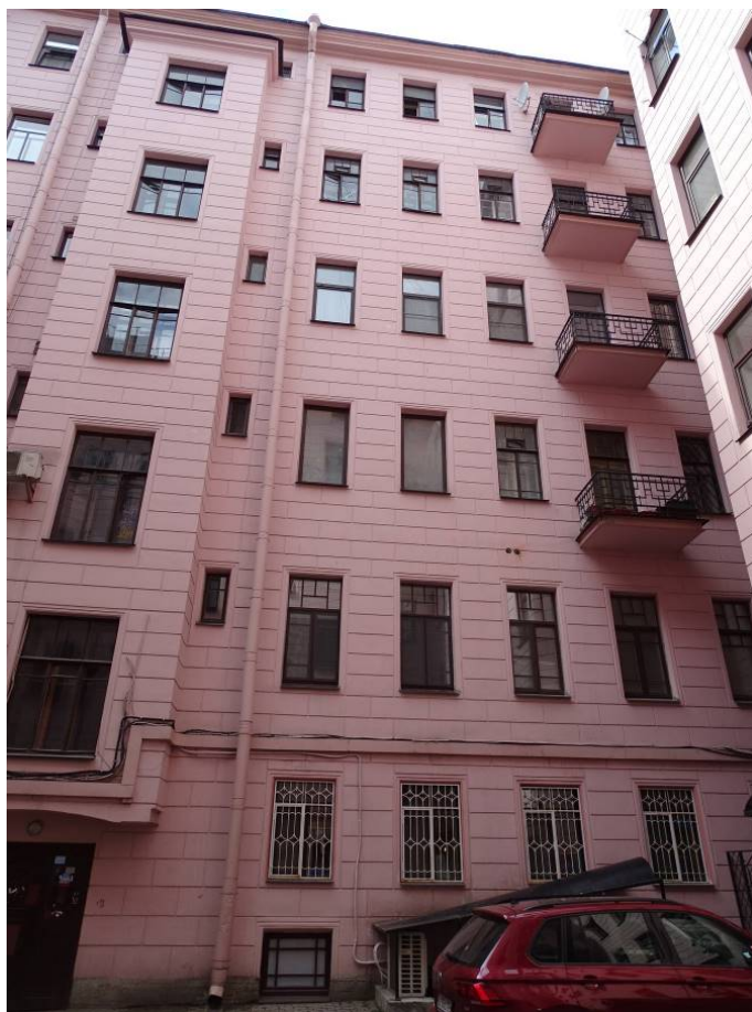
Фото 109. Фрагмент западного фасада внутреннего двора. Съемка 26.04.2021 г. Кириков Б. М.
