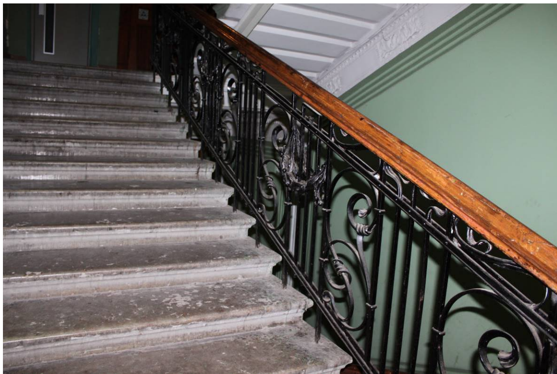
Фото 274. Лестница № 2: Лестничный марш на площадку 2-го этажа. Фрагмент ограждения. Съемка 26.04.2021 г. Кириков Б. М.
