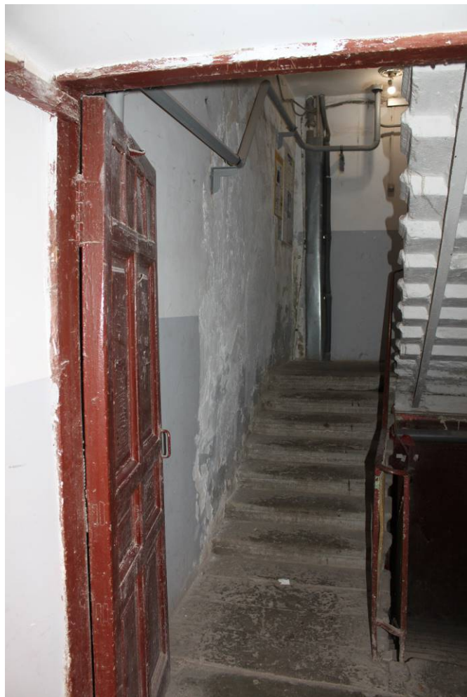
Фото 325. Лестница № 4: 1-й этаж. Съемка 26.04.2021 г. Кириков Б. М.
