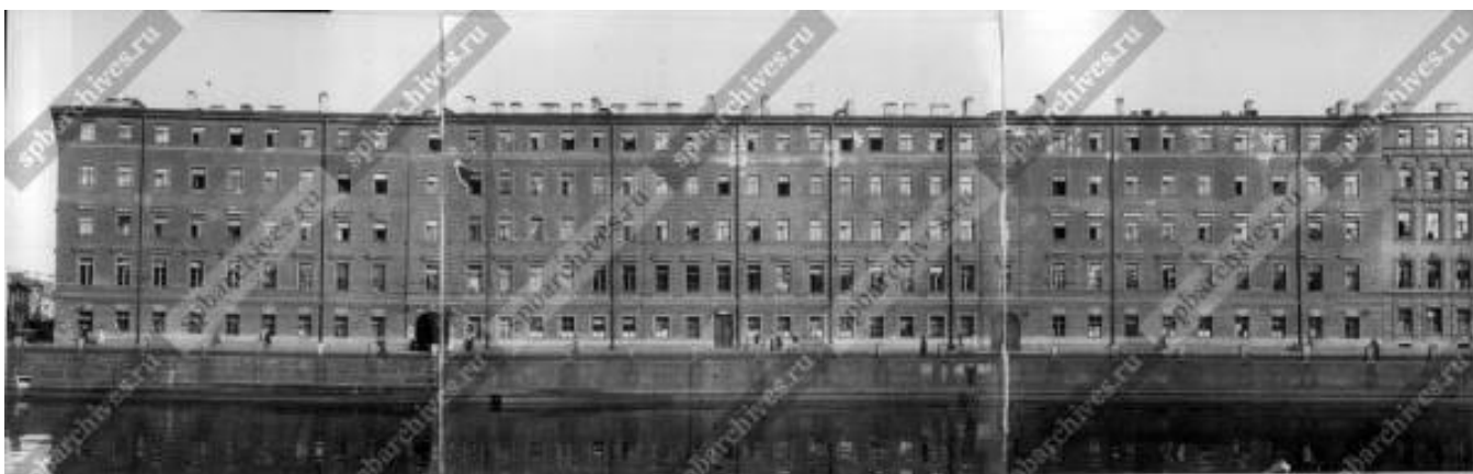
Илл. 5. Здание по набережной реки Фонтанки, дом 50. Фото 1930-х гг.//Сайт: oldsp.ru.
