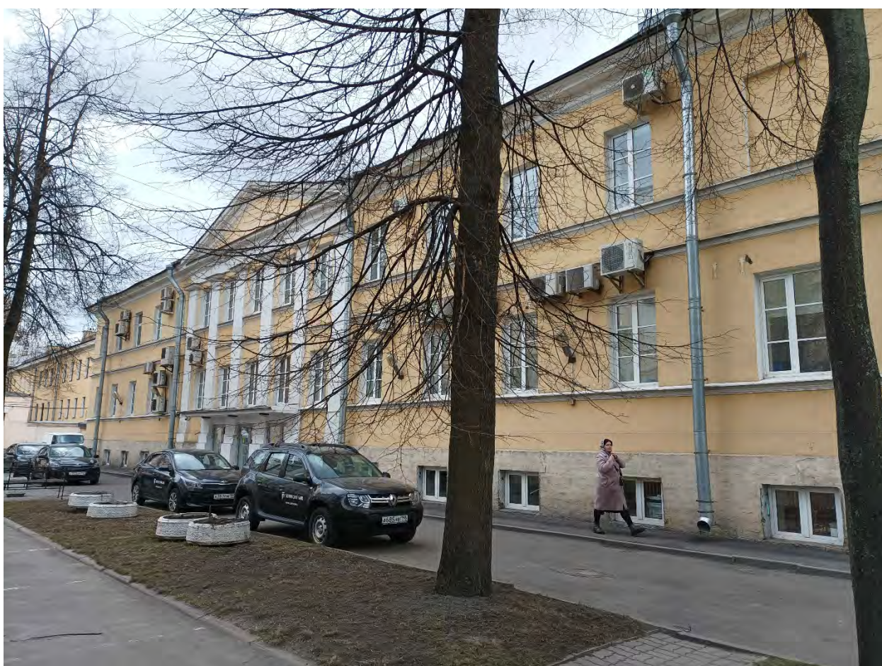
10. Объект культурного наследия регионального значения «9-я солдатская казарма», по адресу: Санкт-Петербург, ул. Радищева, д.39, литера А. Фрагмент дворового фасада. Дата съемки: 29.03.2022г.
