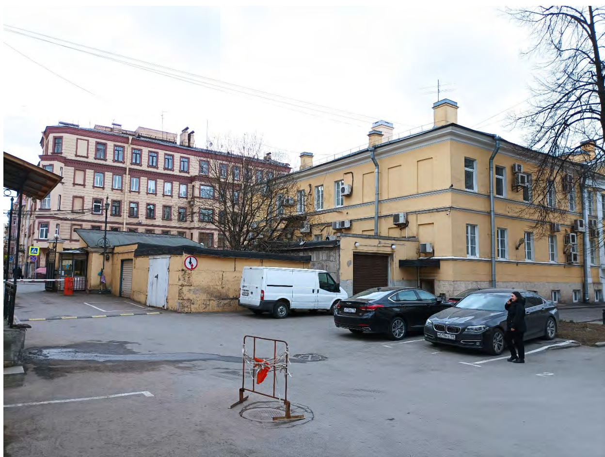
6. Объект культурного наследия регионального значения «9-я солдатская казарма», по адресу: Санкт-Петербург, ул. Радищева, д.39, литера А. Фрагмент дворового фасада. Дата съемки: 29.03.2022г.
