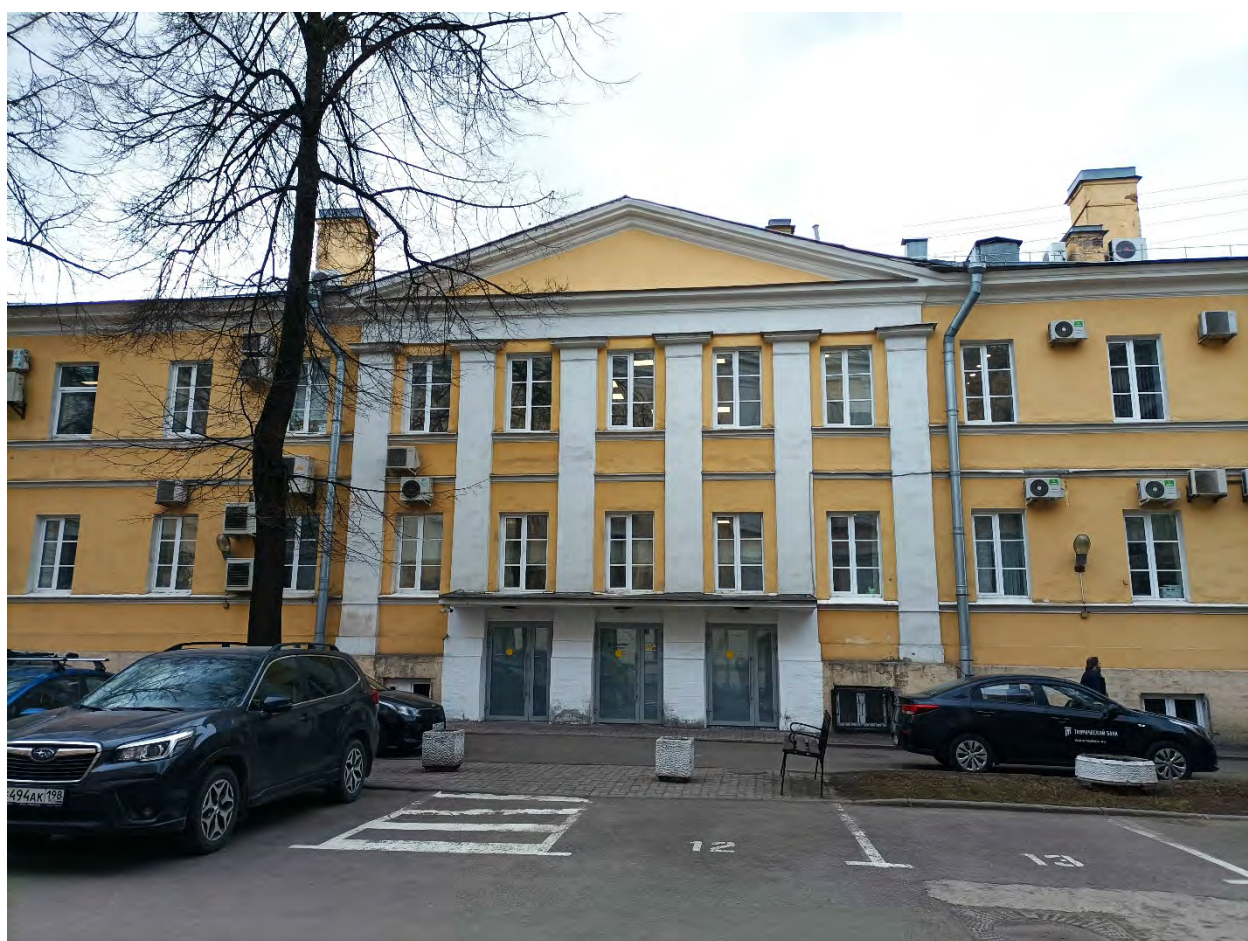
7. Объект культурного наследия регионального значения «9-я солдатская казарма», по адресу: Санкт-Петербург, ул. Радищева, д.39, литера А. Фрагмент дворового фасада. Дата съемки: 29.03.2022г.
