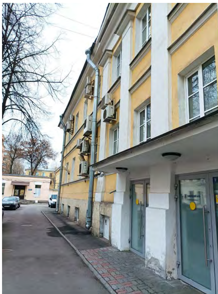
15. Объект культурного наследия регионального значения «9-я солдатская казарма», по адресу: Санкт-Петербург, ул. Радищева, д.39, литера А. Фрагмент дворового фасада. Дата съемки: 29.03.2022г.
