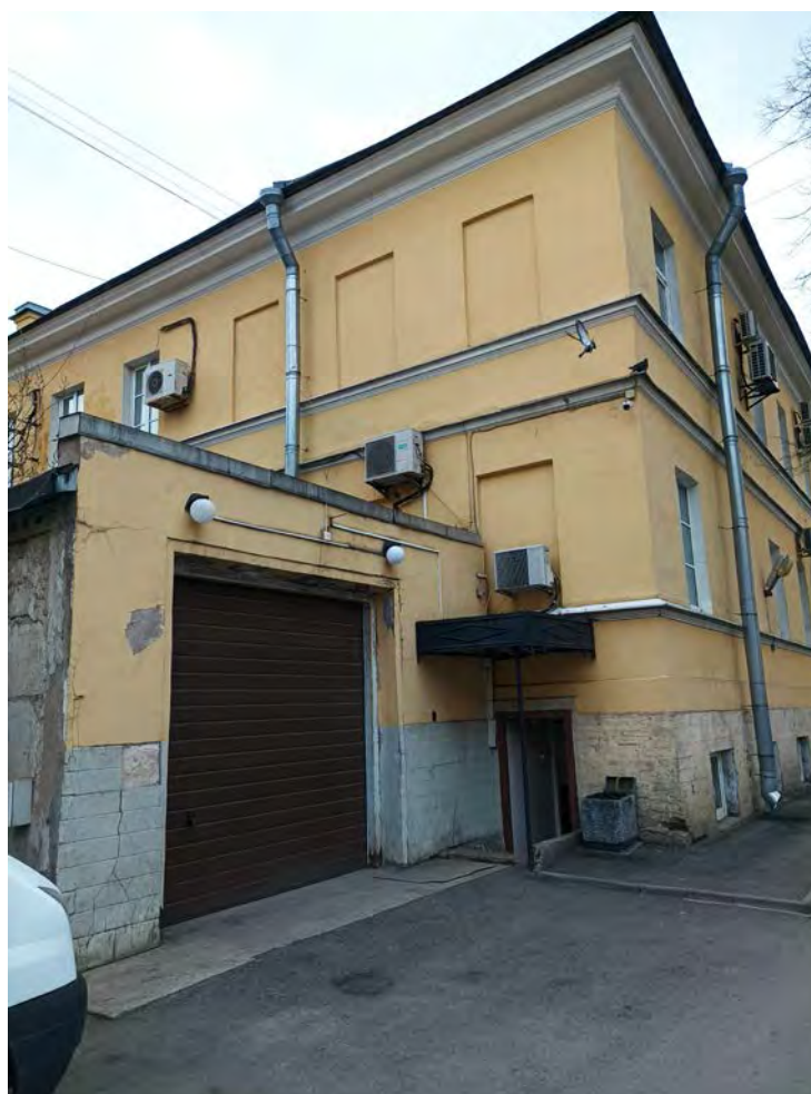
16. Объект культурного наследия регионального значения «9-я солдатская казарма», по адресу: Санкт-Петербург, ул. Радищева, д.39, литера А. Фрагмент дворового фасада. Дата съемки: 29.03.2022г.
