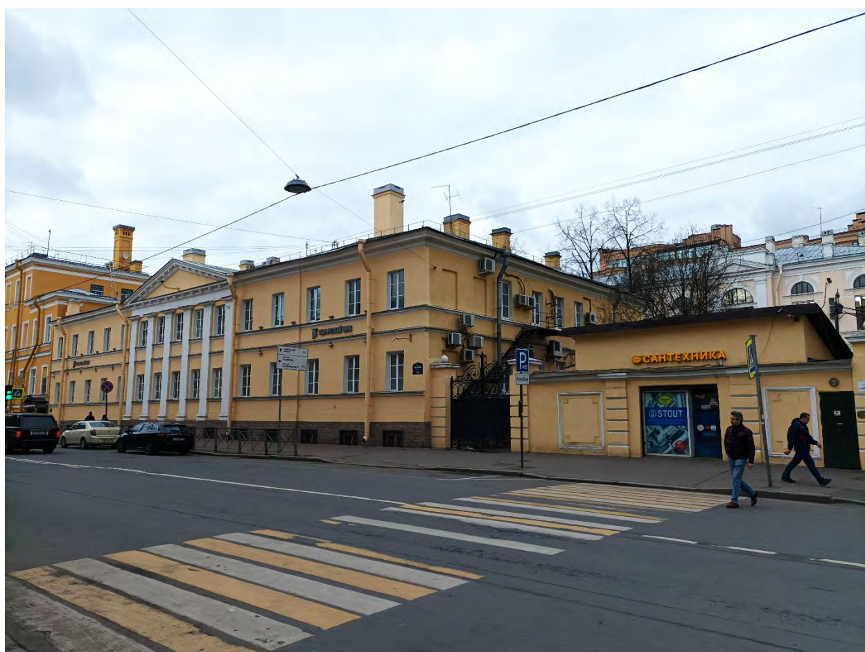
3. Объект культурного наследия регионального значения «9-я солдатская казарма», по адресу: Санкт-Петербург, ул. Радищева, д.39, литера А. Лицевой фасад. Дата съемки: 29.03.2022г.
