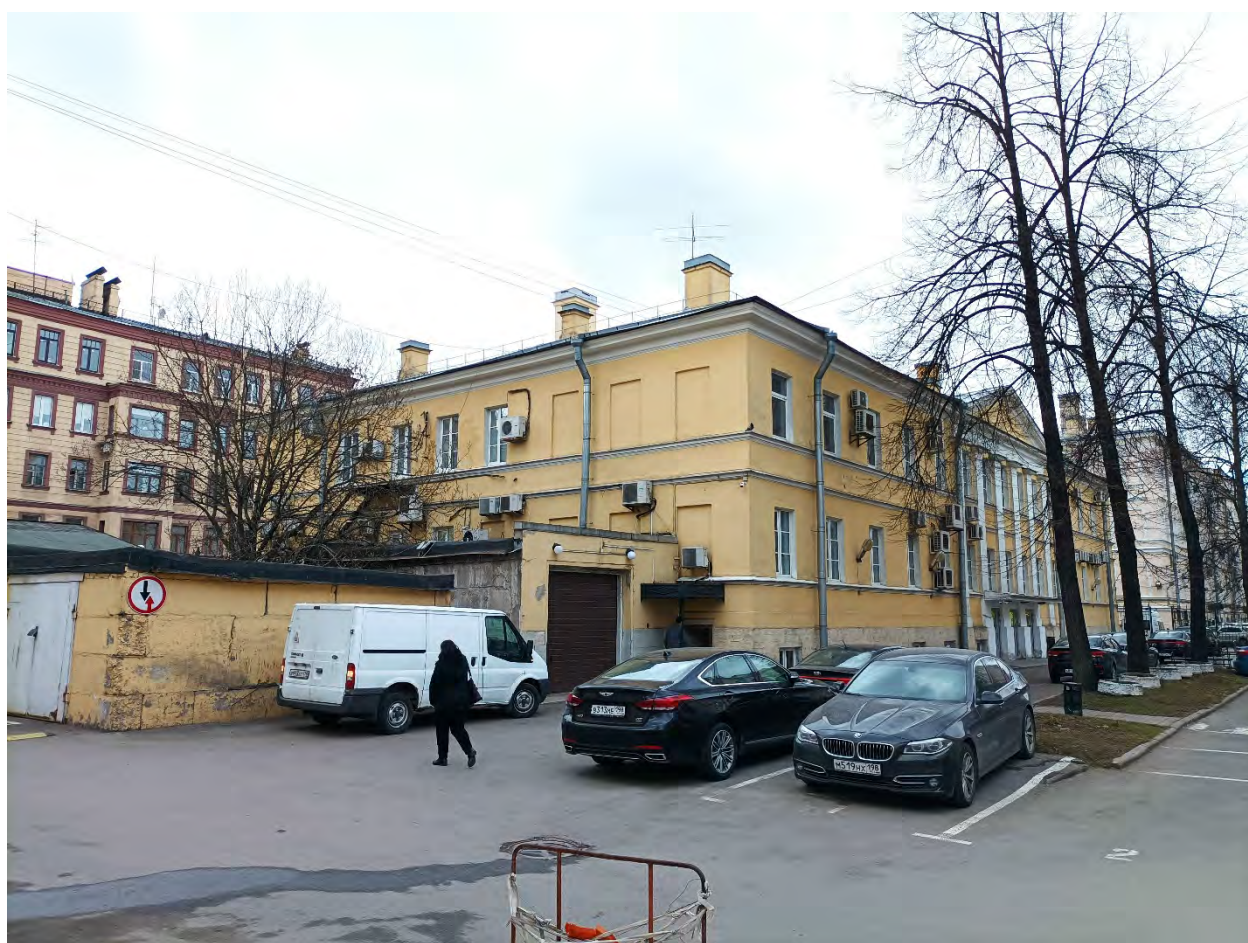
5. Объект культурного наследия регионального значения «9-я солдатская казарма», по адресу: Санкт-Петербург, ул. Радищева, д.39, литера А. Дворовый фасад. Дата съемки: 29.03.2022г.
