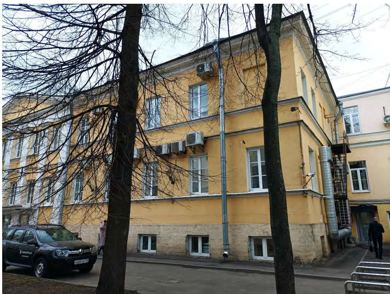
9. Объект культурного наследия регионального значения «9-я солдатская казарма», по адресу: Санкт-Петербург, ул. Радищева, д.39, литера А. Фрагмент дворового фасада. Дата съемки: 29.03.2022г.
