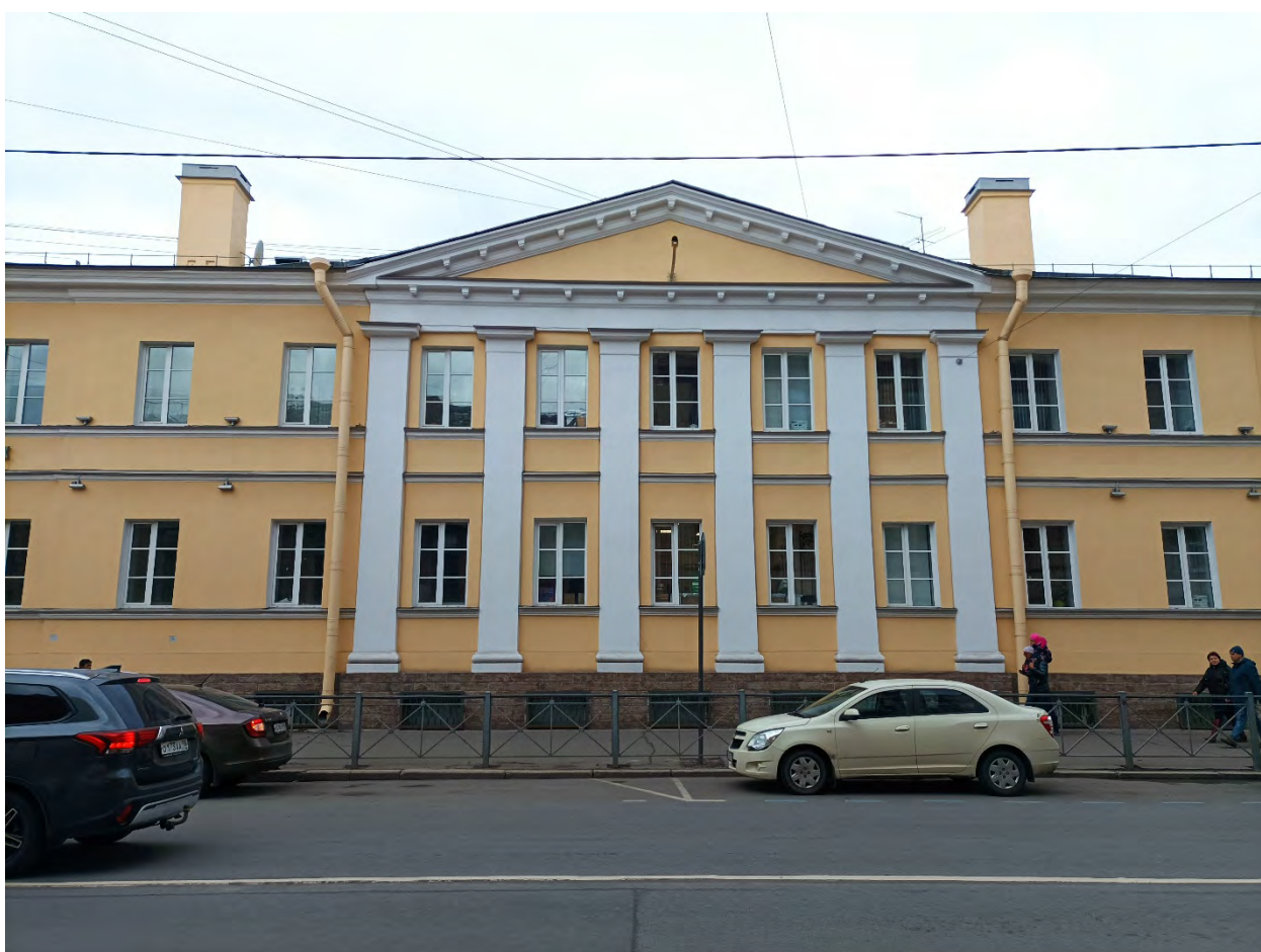
4. Объект культурного наследия регионального значения «9-я солдатская казарма», по адресу: Санкт-Петербург, ул. Радищева, д.39, литера А. Фрагмент лицевого фасада. Дата съемки: 29.03.2022г.
