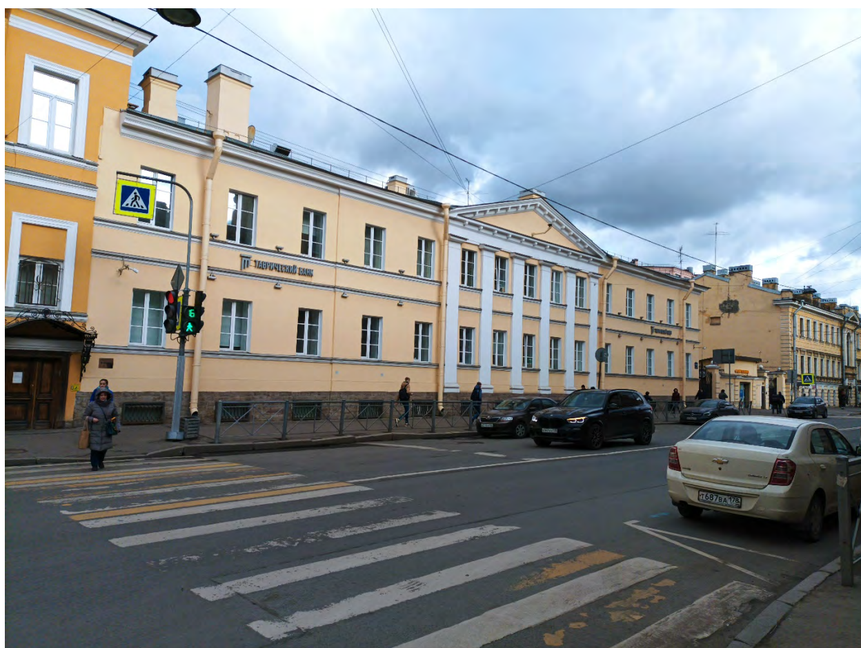
1. Объект культурного наследия регионального значения «9-я солдатская казарма», по адресу: Санкт-Петербург, ул. Радищева, д.39, литера А. Лицевой фасад. Дата съемки: 29.03.2022г.
