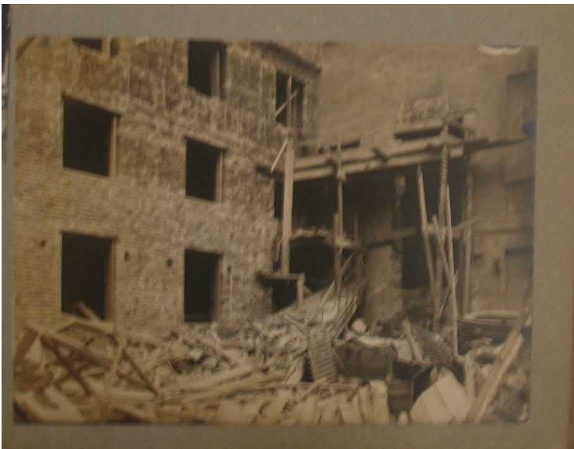
Илл. 22. Расширение помещений гримуборных . Вид со двора наб. канала Грибоедова. 1936 г. Фото из собрания театра.
