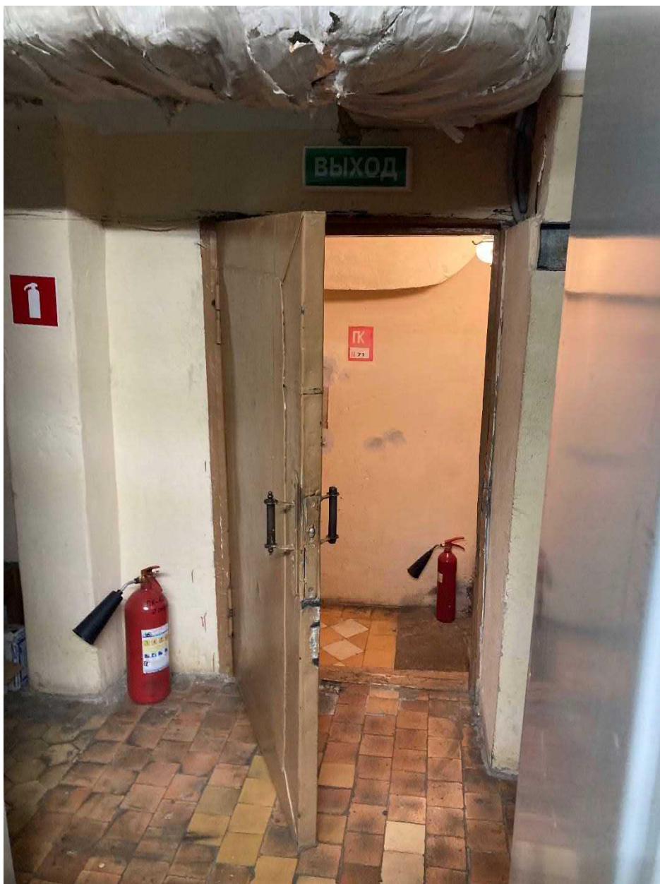
Фото 21. Помещение 366. Проход в помещение 365.
