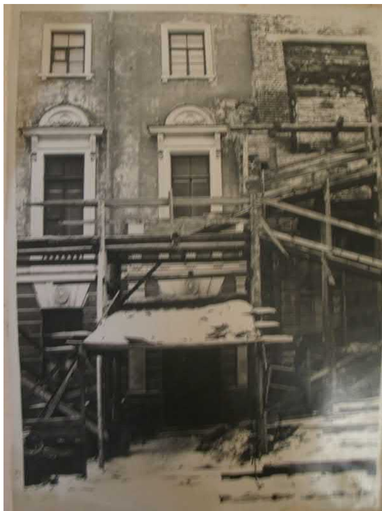
Илл. 24. Строительство репетиционных залов и гримборных на месте электростанции театра.1936 г. Фото из собрания театра.
