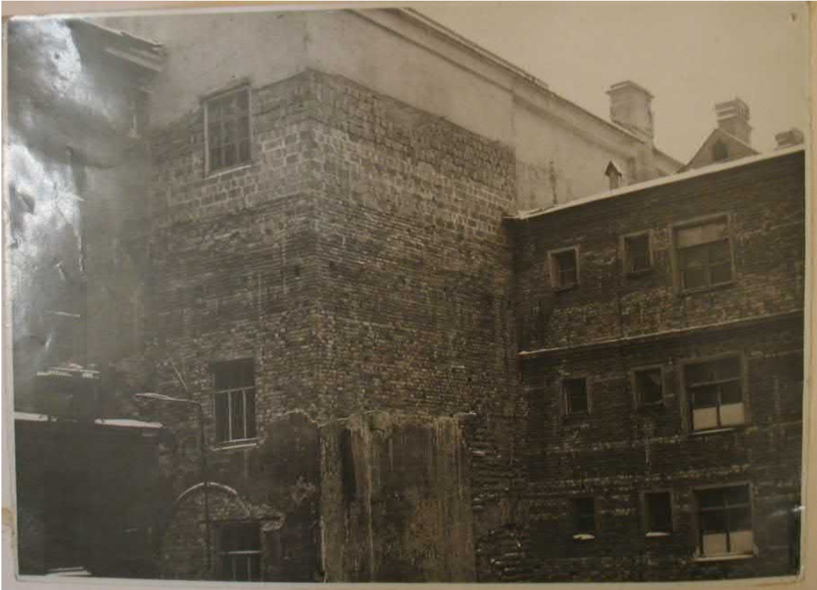
Илл. 26. Строительство репетиционных залов и расширение гримуборных . Вид со двора. 1937 г. Фото из собрания театра.
