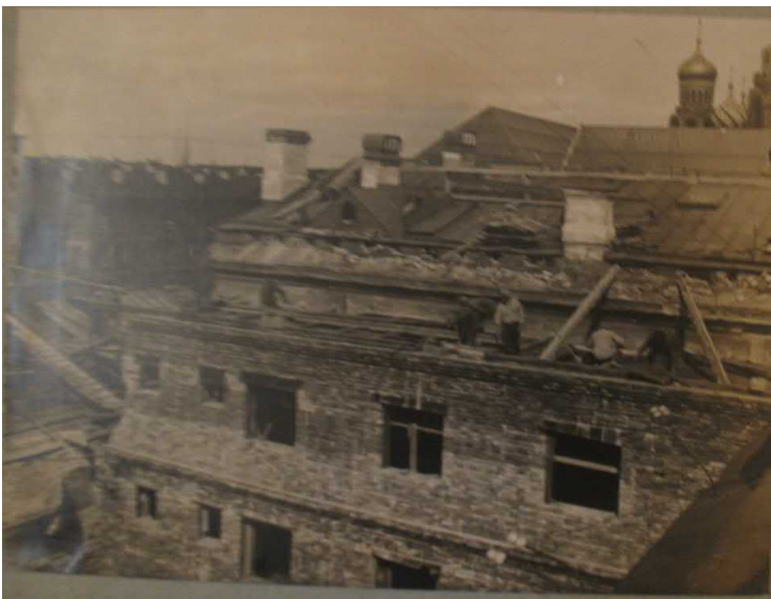
Илл. 23. Строительство репетиционных залов и гримуборных на месте электростанции театра. 1936 г. Фото из собрания театра.
