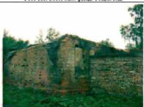
Фото 187. Северный фасад. Общий вид.
