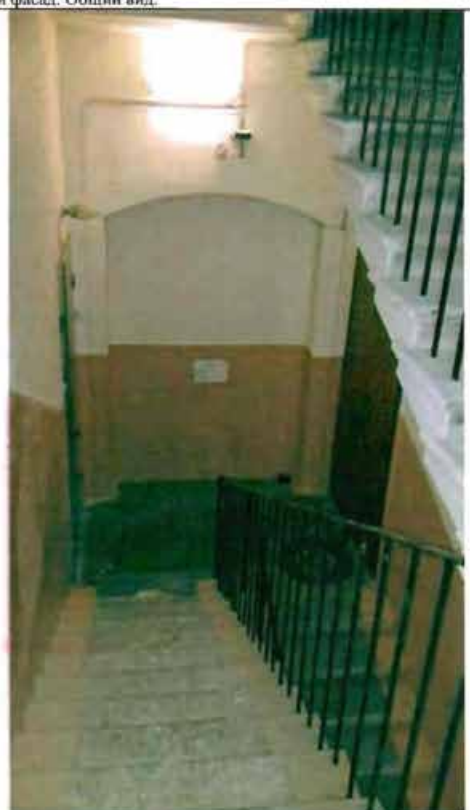
Фото 173. Лестница № 1 в северной части здания. Фрагмент.
