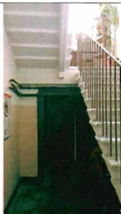
Фото 131. Лестница № 2 в северной части здания. Общий вид.
