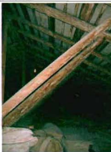
Фото 27. Конструкции крыши. Фрагмент.
