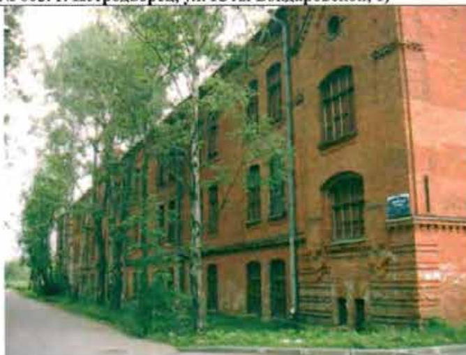
Фото 1. Западный фасад. Общий вид.
