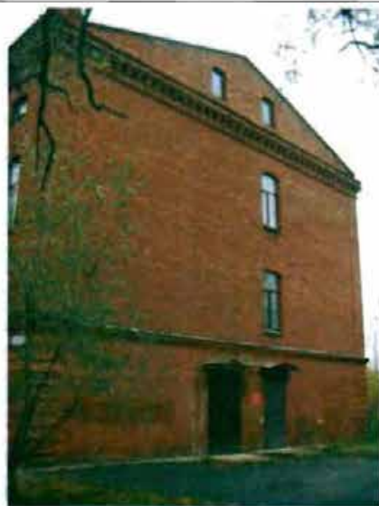
Фото 16. Южный фасад. Общий вид.
