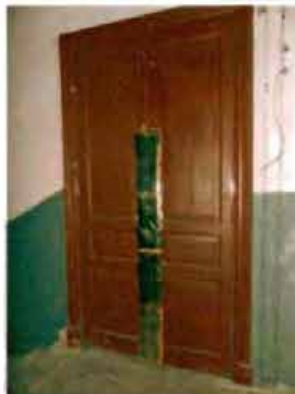
Фото 125. Дверное заполнение парадной лестницы в центральной части здания. Общий вид.
