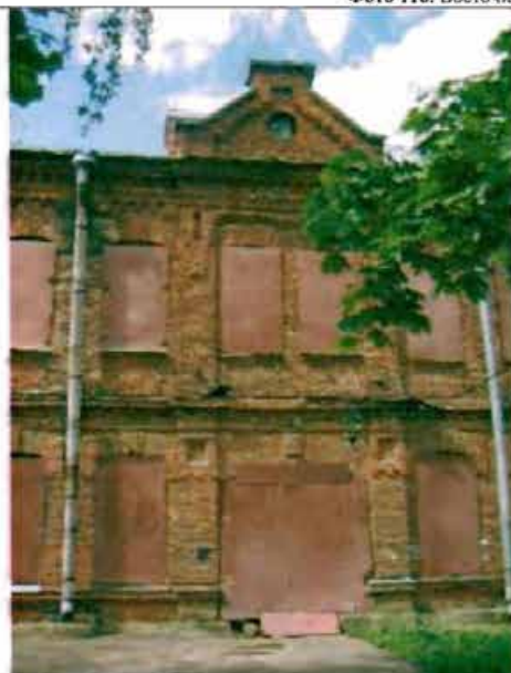
Фото 117. Восточный фасад. Фрагмент центральной части фасада.
