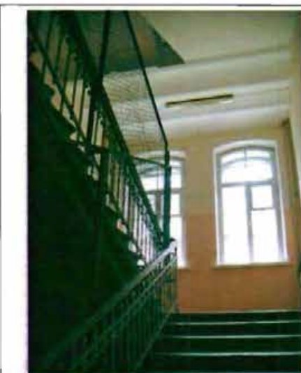
Фото 56. Лестница в центральной части здания. Фрагмент.
