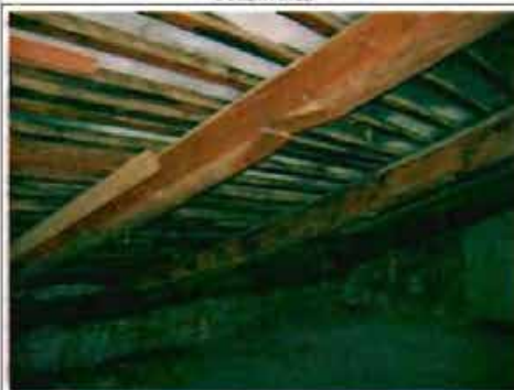
Фото 151. Конструкции крыши. Фрагмент.
