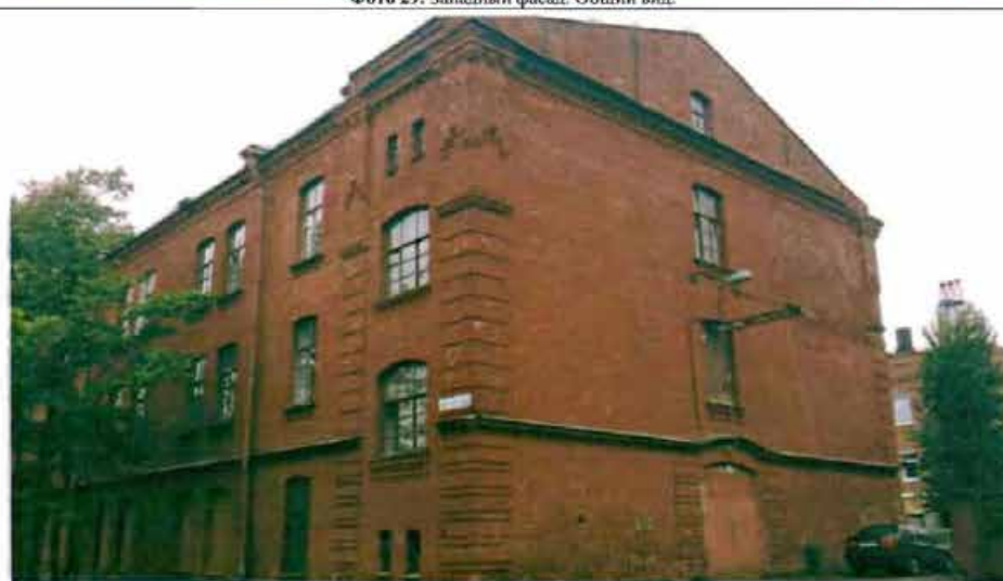
Фото 30. Северный фасад. Общий вид.
