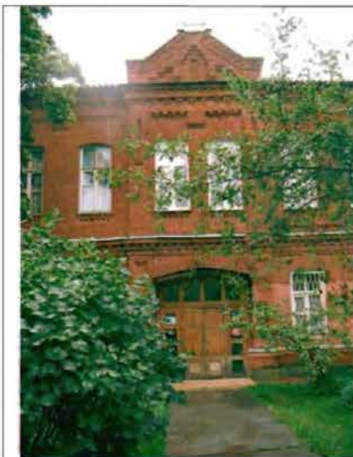
Фото 90. Восточный фасад. Центральная часть. Общий вид.
