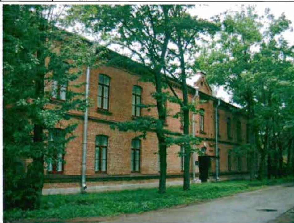
Фото 39. Восточный фасад. Общий вид.
