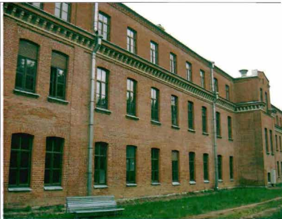
Фото 66. Южный фасад. Общий вид. 05.07.2016.
