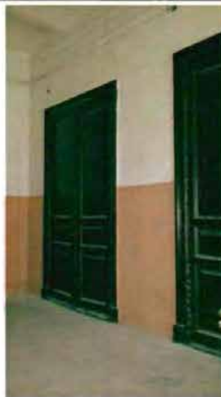
Фото 175. Дверные заполнения парадной лестницы в центральной части здания. Общий вид.
