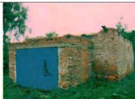
Фото 185. Восточный фасад. Общий вид.
