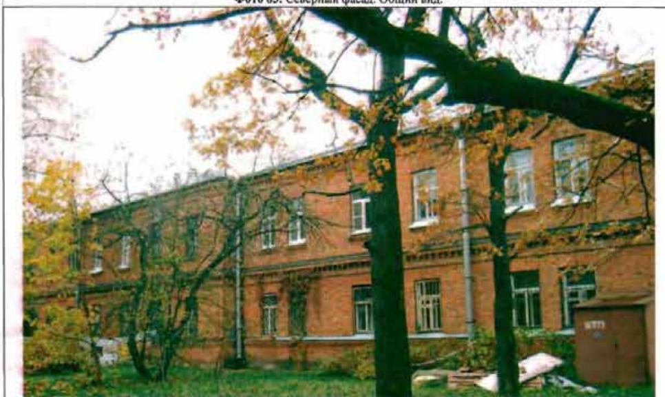
Фото 84. Южный фасад. Общий вид.
