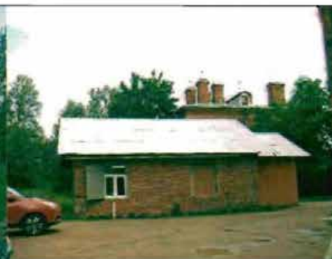
Фото 154. Южный фасад. Общий вид.
