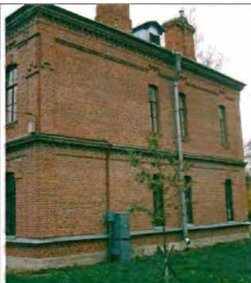
Фото 134. Южный фасад. Общий вид.
