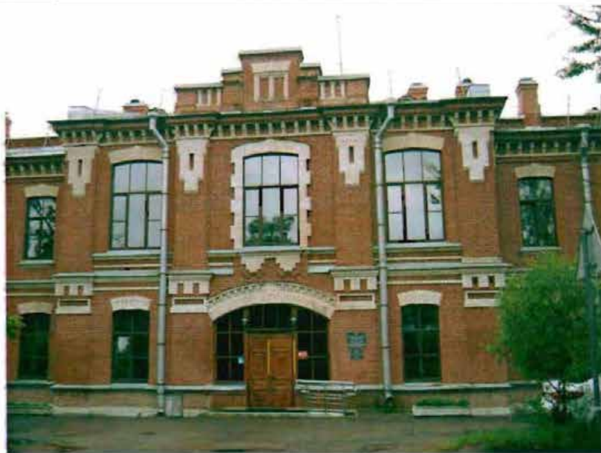
Фото 65. Северный фасад. Фрагмент центральной части фасада.
