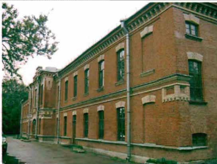
Фото 64. Северный фасад. Общий вид.
