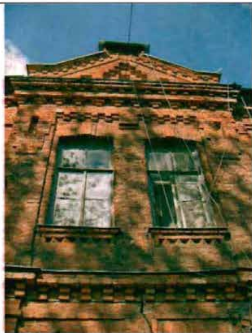
Фото 177. Восточный фасад. Центральная часть. Фрагмент.
