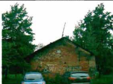
Фото 94. Восточный фасад. Общий вид.
