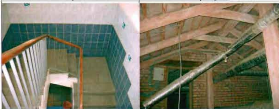
Фото 114. Лестница. Общий вид.
