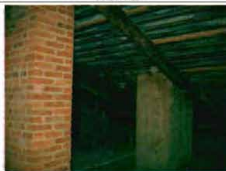
Фото 152. Конструкции крыши. Фрагмент.
