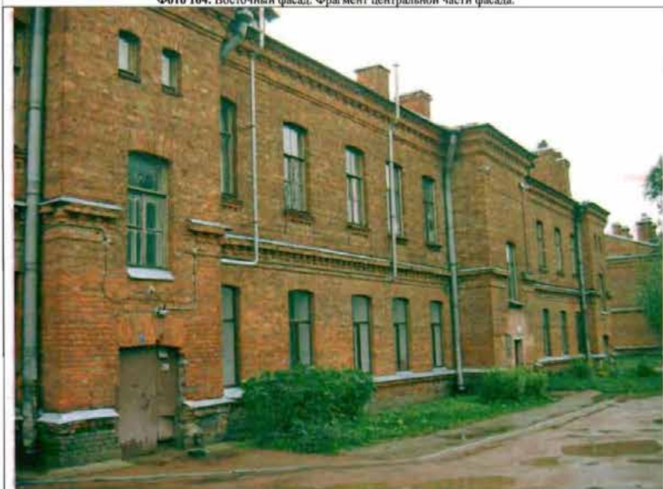
Фото 165. Западный фасад. Общий вид.
