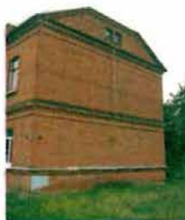
Фото 86. Западный фасад. Общий вид.
