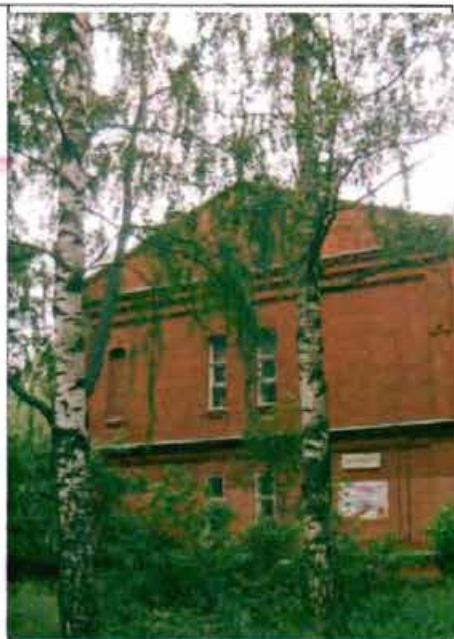
Фото 91. Северный фасад. Общий вид.
