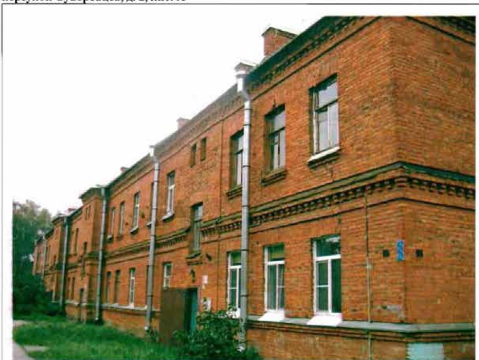
Фото 83. Северный фасад. Общий вид.
