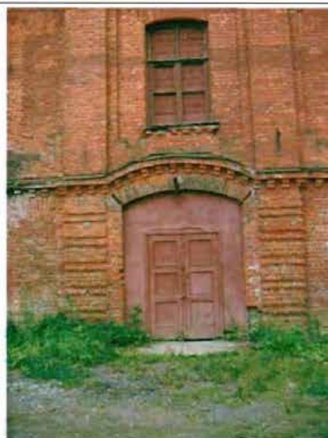
Фото 4. Западный фасад. Фрагмент центральной части фасада.
