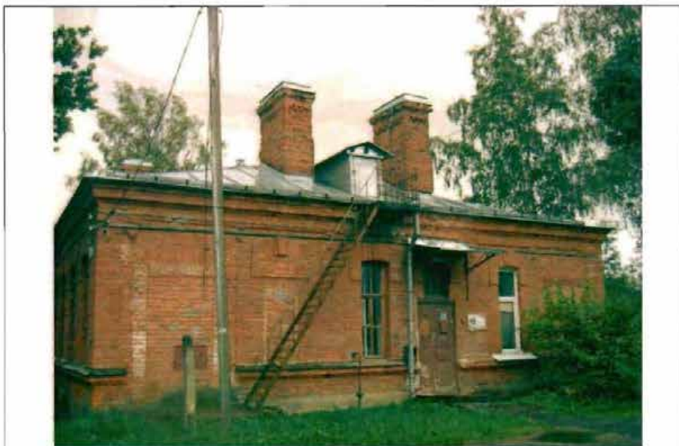
Фото189. Северный фасад. Общий вид.
