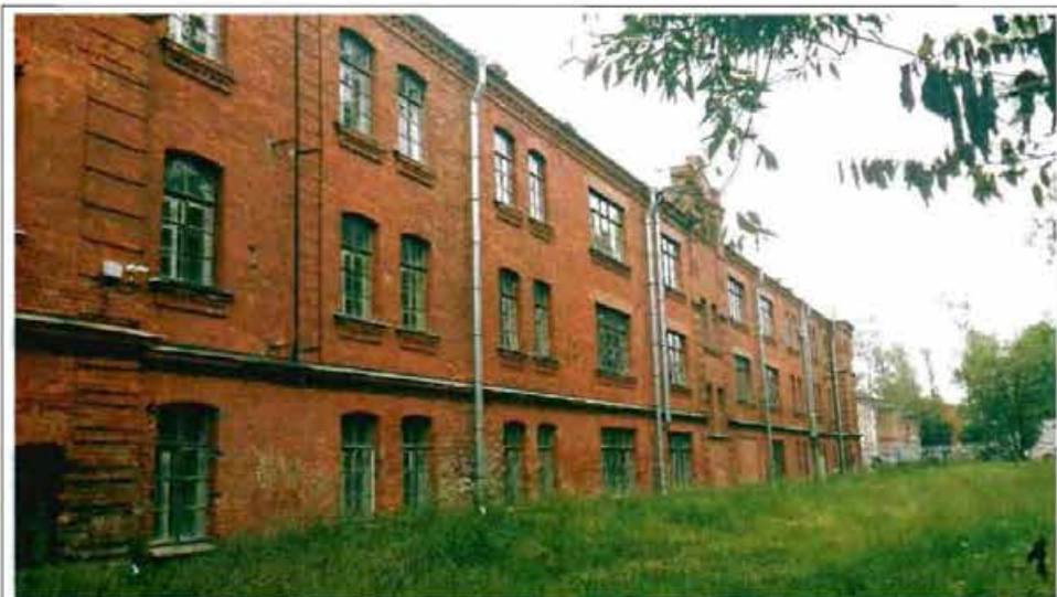
Фото 48. Западный фасад. Общий вид.
