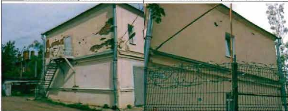
Фото 112. Южный фасад. Общий вид.
