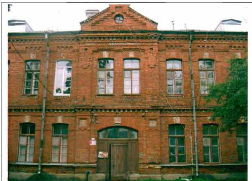
Фото 104. Восточный фасад. Центральная часть. Общий вид.
