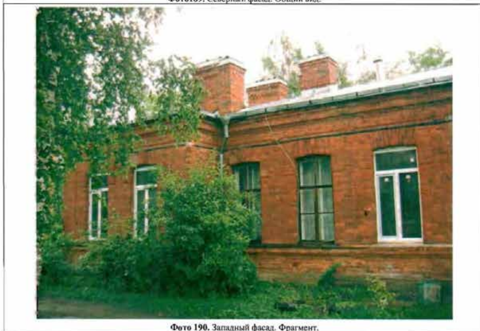
Фото 190. Западный фасад. Фрагмент.
