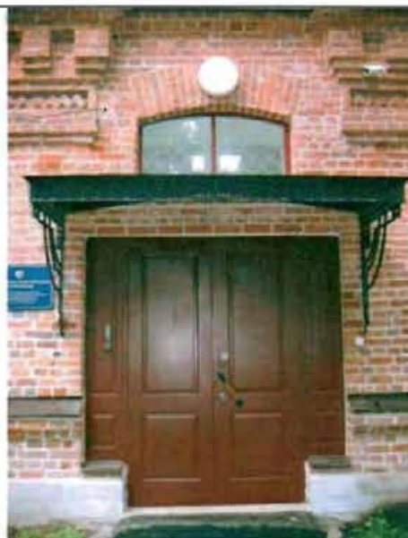
Фото 41. Дверной проем восточного фасада. Общий вид.
