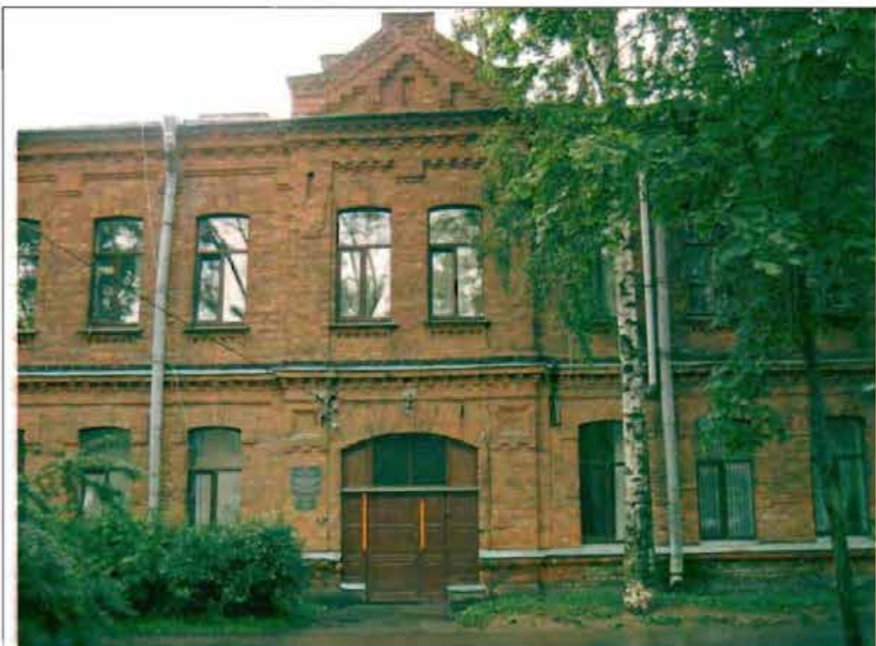
Фото 164. Восточный фасад. Фрагмент центральной части фасада.
