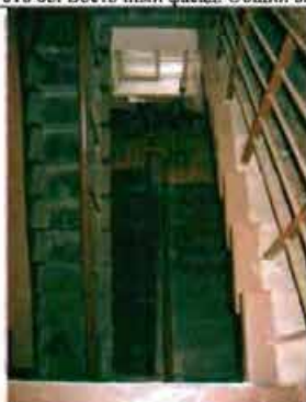
Фото 87. Лестница № 1. Общий вид.
