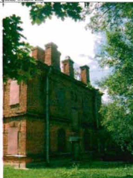
Фото 118. Северный фасад. Общий вид.
