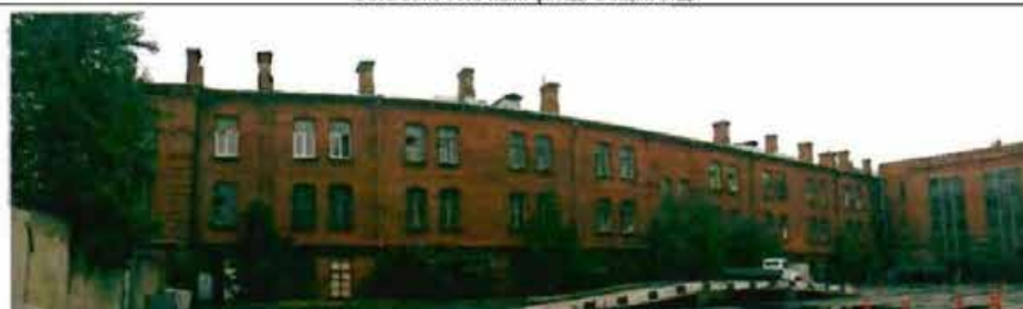
Фото 29. Западный фасад. Общий вид.
