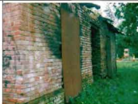
Фото 95. Северный фасад. Общий вид.
