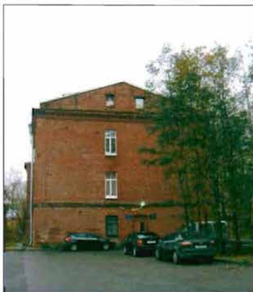
Фото 15. Северный фасад. Общий вид.
