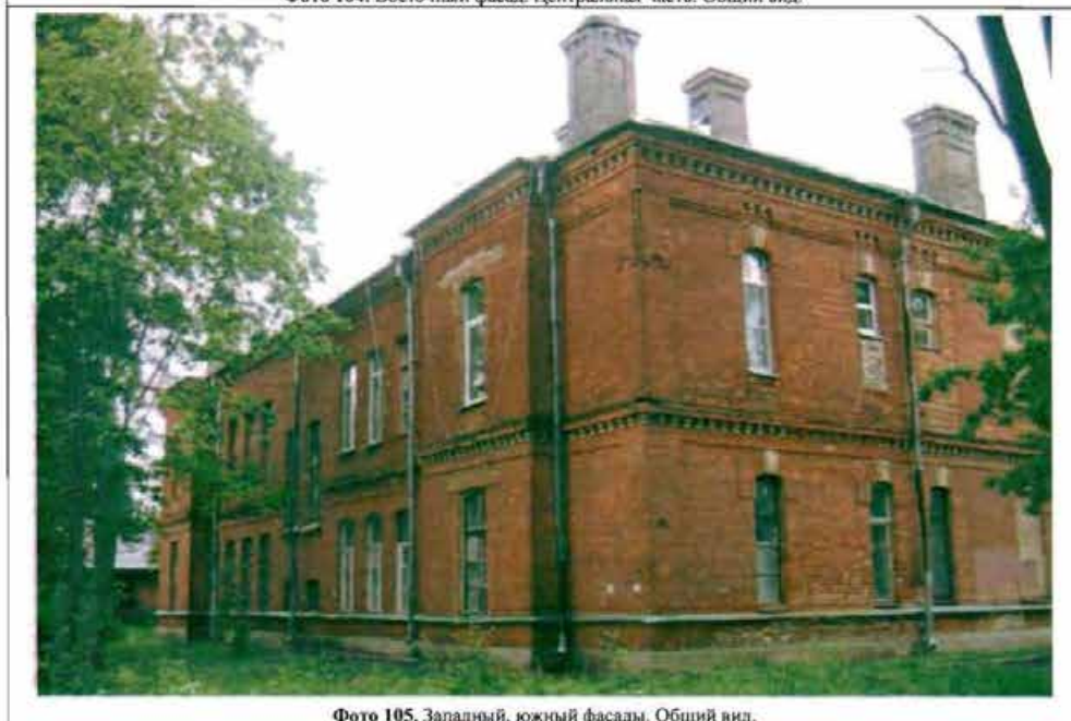
Фото 105. Западный, южный фасады. Общий вид.
