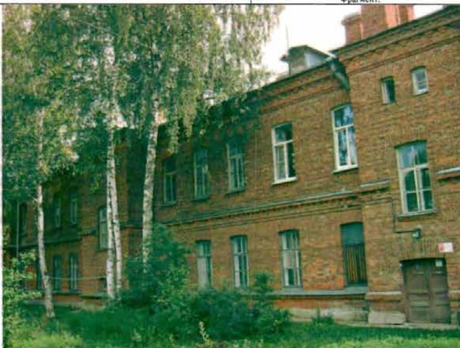
Фото 179. Западный фасад. Общий вид.
