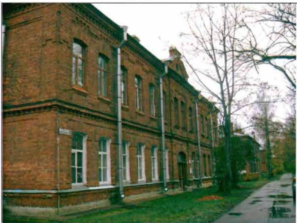
Фото 146. Западный фасад. Общий вид.
