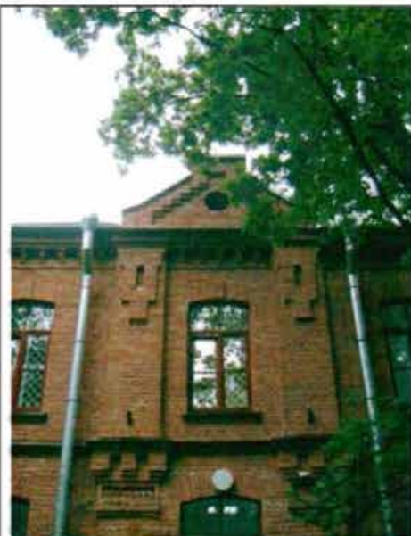
Фото 40. Восточный фасад. Фрагмент центральной части фасада.
