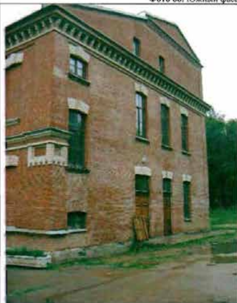
Фото 67. Западный фасад. Общий вид.
