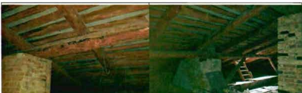
Фото 62. Конструкции крыши. Общий вид.
