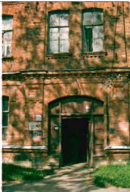
Фото 178. Восточный фасад. Центральная часть. Фрагмент.
