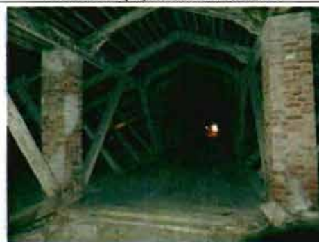
Фото 12. Конструкции крыши. Общий вид. 29.12.2015.
