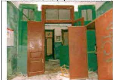
Фото 101. Дверной проем тамбура. Общий вид.
