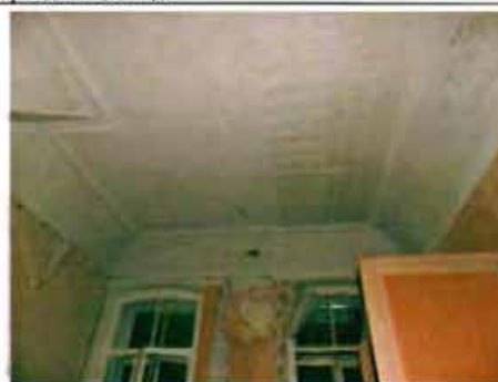
Фото 121. Помещение 1-го этажа.
