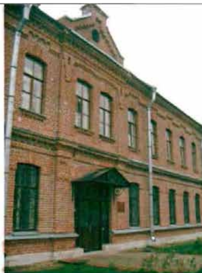
Фото 135. Западный фасад. Фрагмент центральной части фасада.
