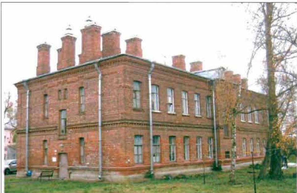
Фото 129. Западный, северный фасады. Общий вид.
