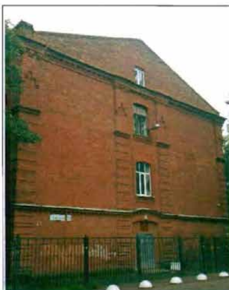
Фото 49. Северный фасад. Общий вид.
