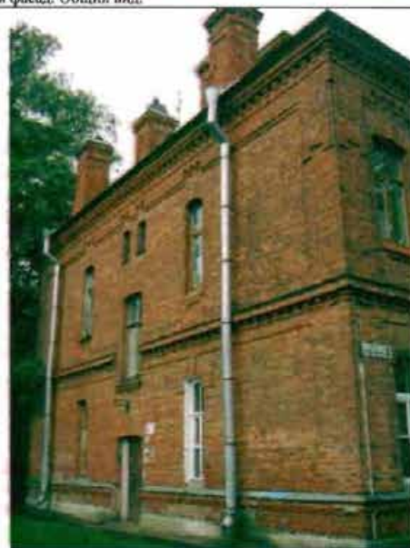
Фото 148. Северный фасад. Общий вид.
