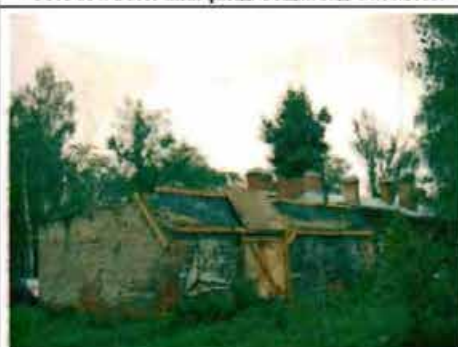
Фото 186. Западный, северный фасады. Общий вид.
