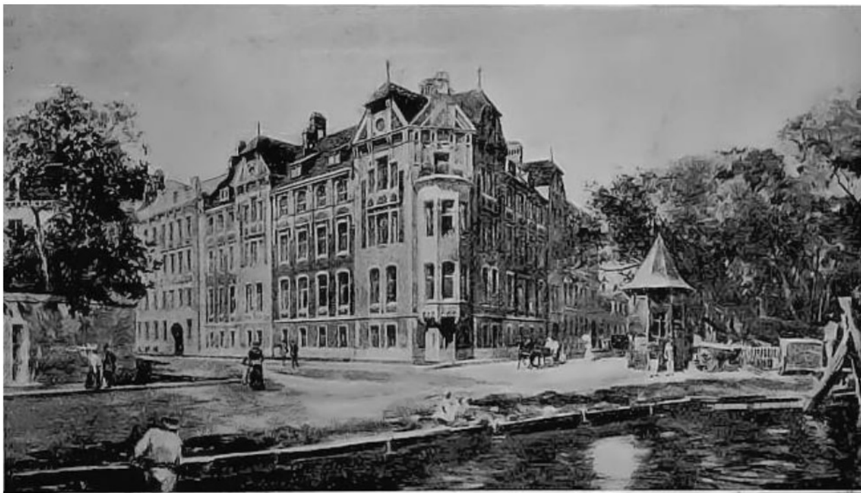
32. Дом потомственного почетного гражданина Ивана Ефимовича Ритинга (Санкт-Петербург, угол Александровского и Кронверкского пр. №1-79). Фото 1903 г.
