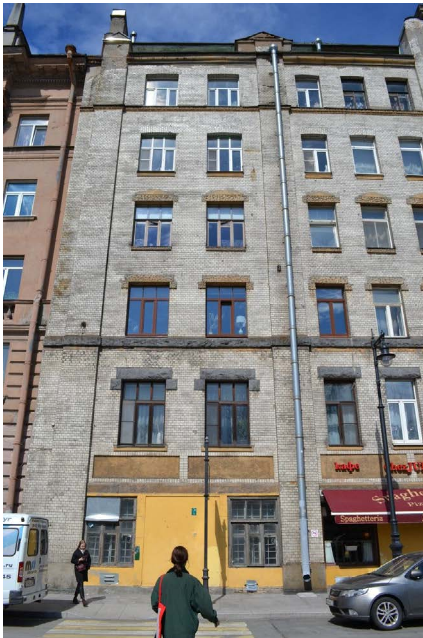
2. Лицевой фасад. Фрагмент. Направление съемки север.
