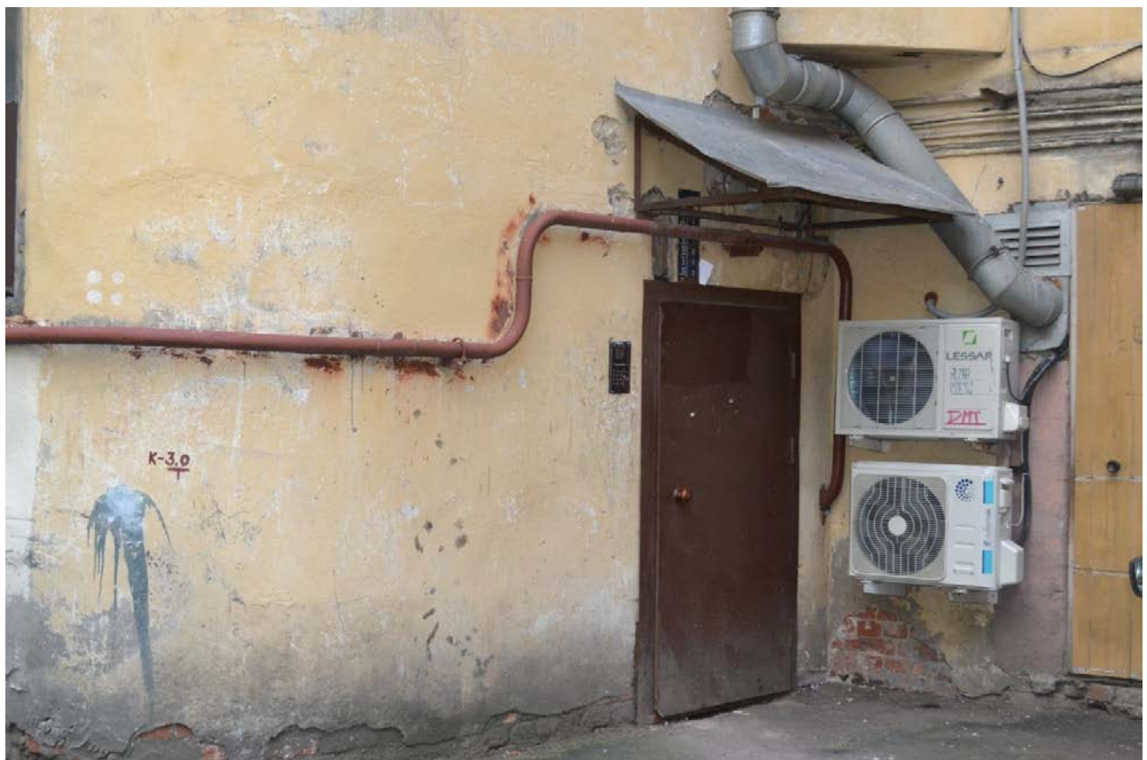
13. Дворовый фасад. Фрагмент. Дверной проем лестницы (западный лестничный ризалит).
