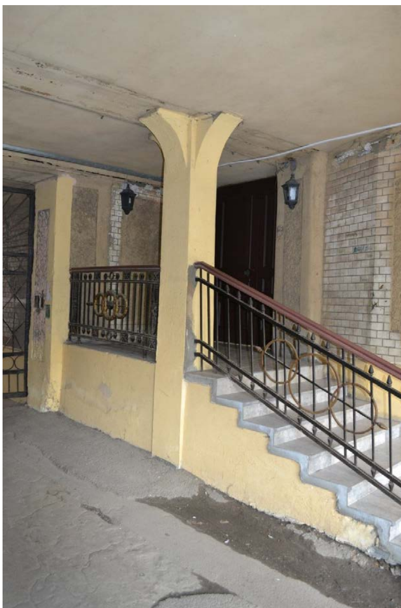
23. Крыльцо и дверной проем лестницы Л-1.
