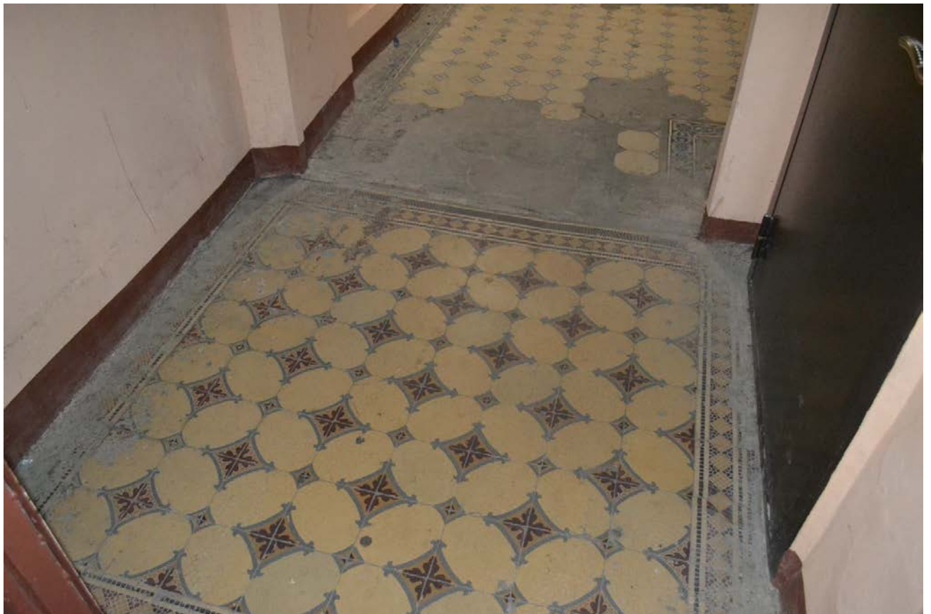
38. Тамбур лестницы Л-2.
