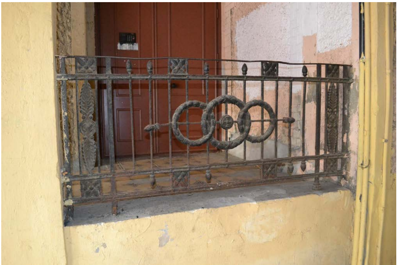
22. Крыльцо и дверной проем лестницы Л-2. Фрагмент ограждения.
