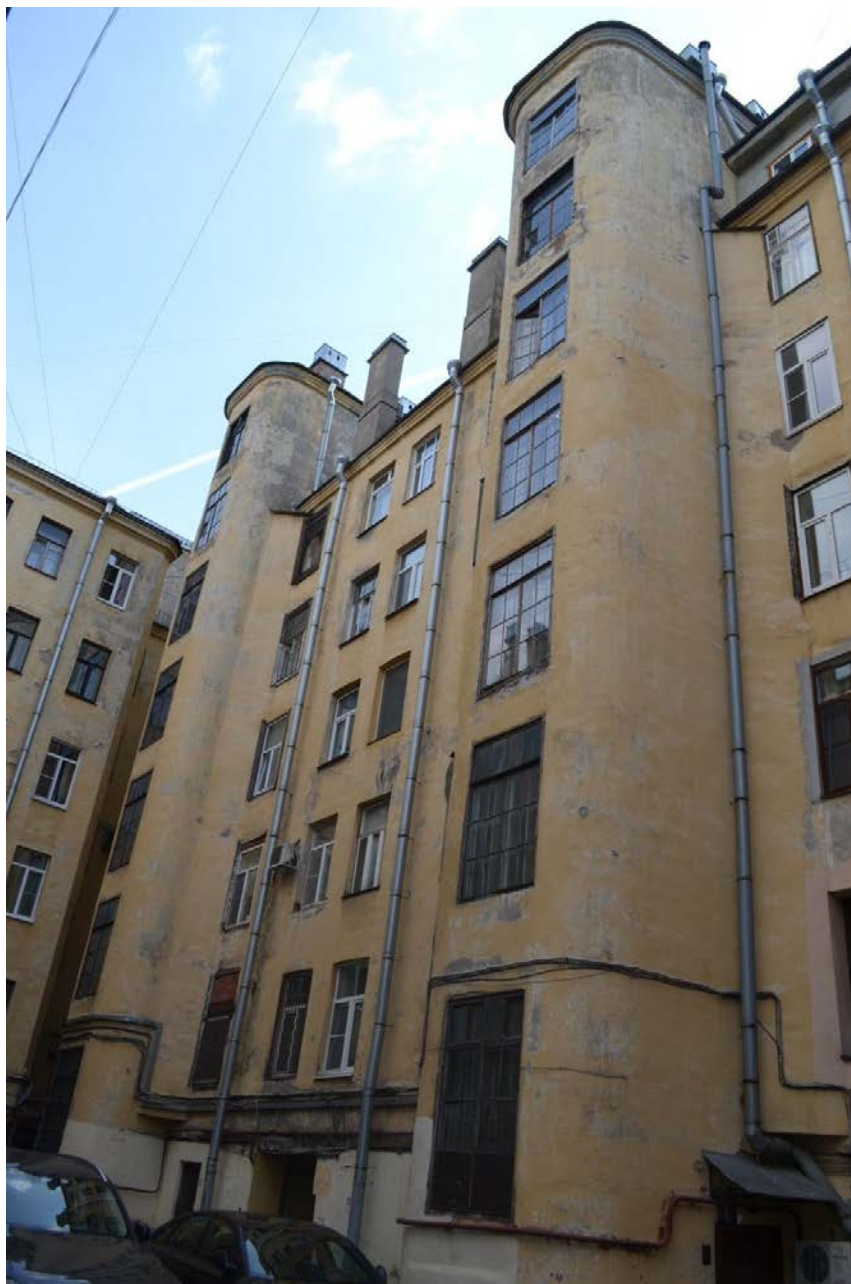
10. Дворовый фасад. Общий вид.
