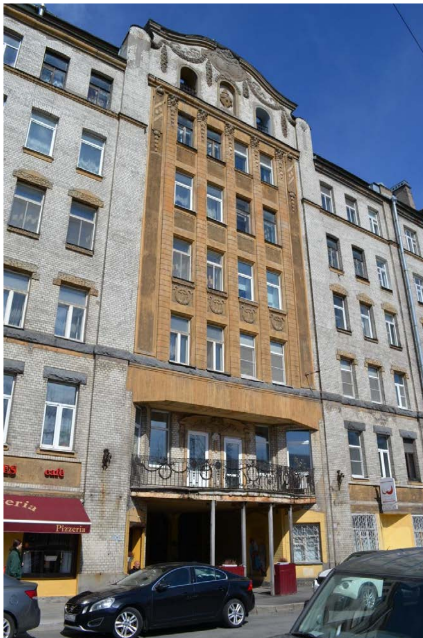
3. Лицевой фасад. Фрагмент. Направление съемки северо-восток.
