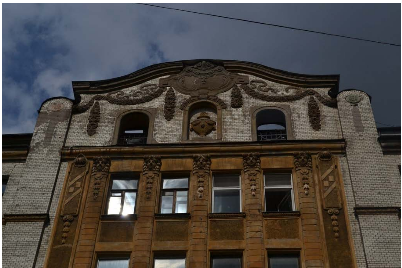
9. Лицевой фасад. Фрагмент. Направление съемки север.
