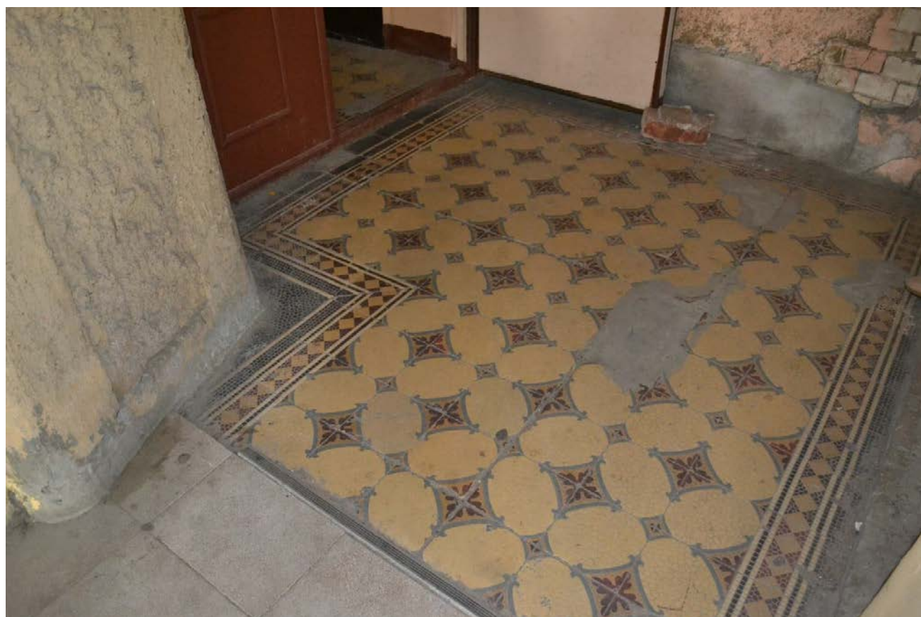
37. Крыльцо лестницы Л-2.
