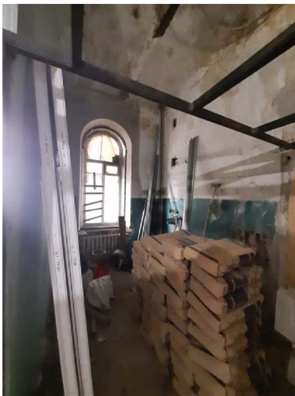
Фото 19 Интерьер квартиры № 1 выявленного объекта культурного наследия «Доходный дом сельскохозяйственного товарищества "Помещик» расположенного по адресу: г. Санкт-Петербург, Измайловский проспект, дом 16/30, лит. А (Измайловский пр-кт., 16; ул.7-я Красноармейская, 30)
