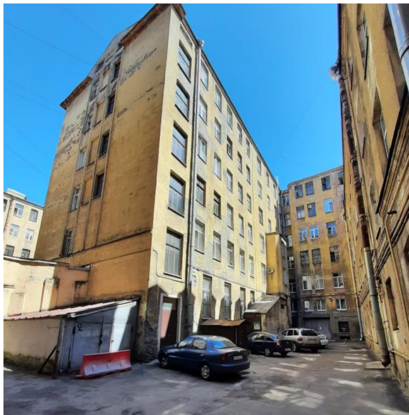
Фото 9 Фрагмент дворового фасада выявленного объекта культурного наследия «Доходный дом сельскохозяйственного товарищества "Помещик» расположенного по адресу: г. Санкт-Петербург, Измайловский проспект, дом 16/30, лит. А (Измайловский пр-кт., 16; ул.7-я Красноармейская, 30)
