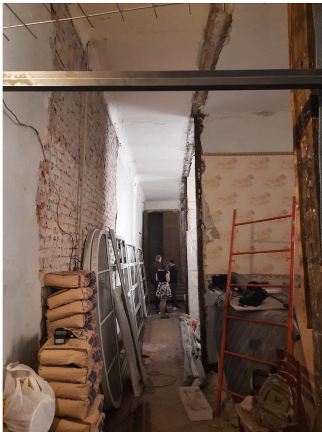
Фото 21 Интерьер квартиры № 1 выявленного объекта культурного наследия «Доходный дом сельскохозяйственного товарищества "Помещик"» расположенного по адресу: г. Санкт-Петербург, Измайловский проспект, дом 16/30, лит. А (Измайловский пр-кт., 16; ул.7-я Красноармейская, 30)
