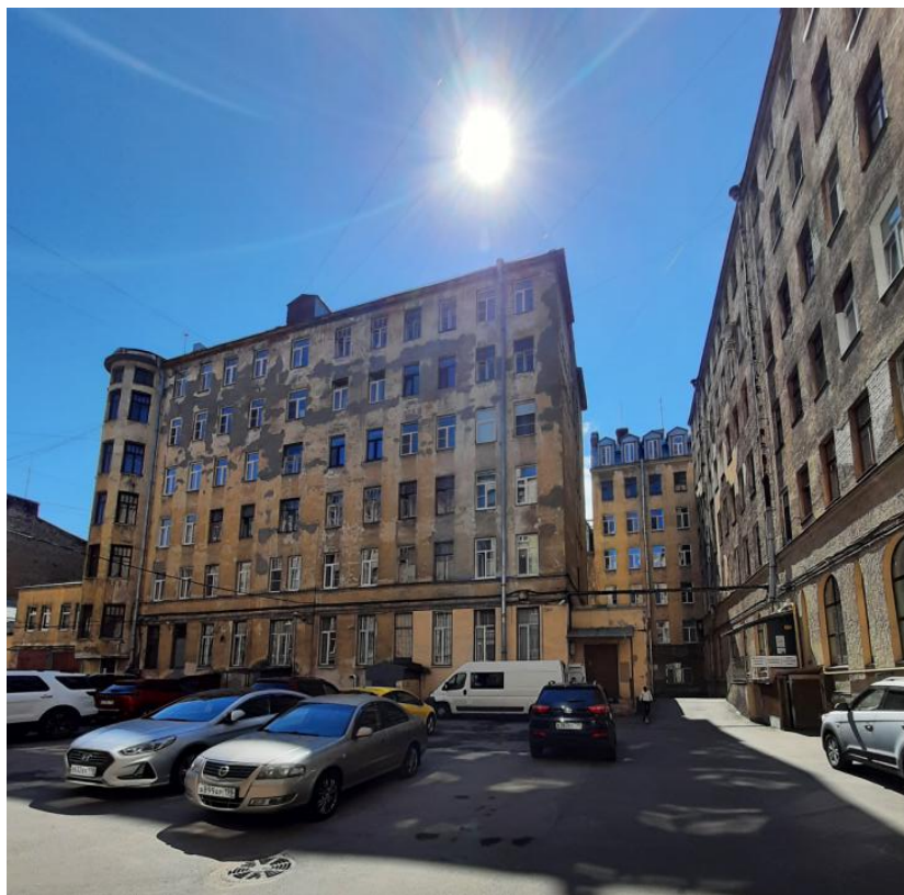
Фото 5 Фрагмент дворового фасада выявленного объекта культурного наследия «Доходный дом сельскохозяйственного товарищества "Помещик» расположенного по адресу: г. Санкт-Петербург, Измайловский проспект, дом 16/30, лит. А (Измайловский пр-кт., 16; ул.7-я Красноармейская, 30)
