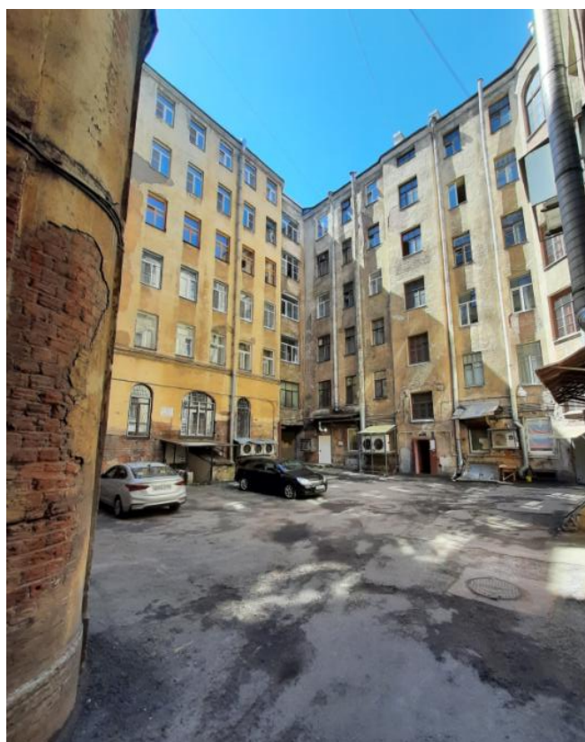
Фото 6 Фрагмент дворового фасада выявленного объекта культурного наследия «Доходный дом сельскохозяйственного товарищества "Помещик» расположенного по адресу: г. Санкт-Петербург, Измайловский проспект, дом 16/30, лит. А (Измайловский пр-кт., 16; ул.7-я Красноармейская, 30)
