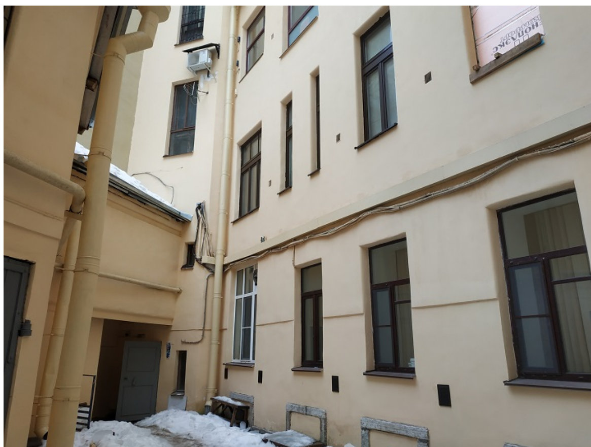
12. Здание по адресу: Санкт-Петербург, Каменноостровский проспект, д. 1-3. Вид фасада и входной группы со стороны двора.
