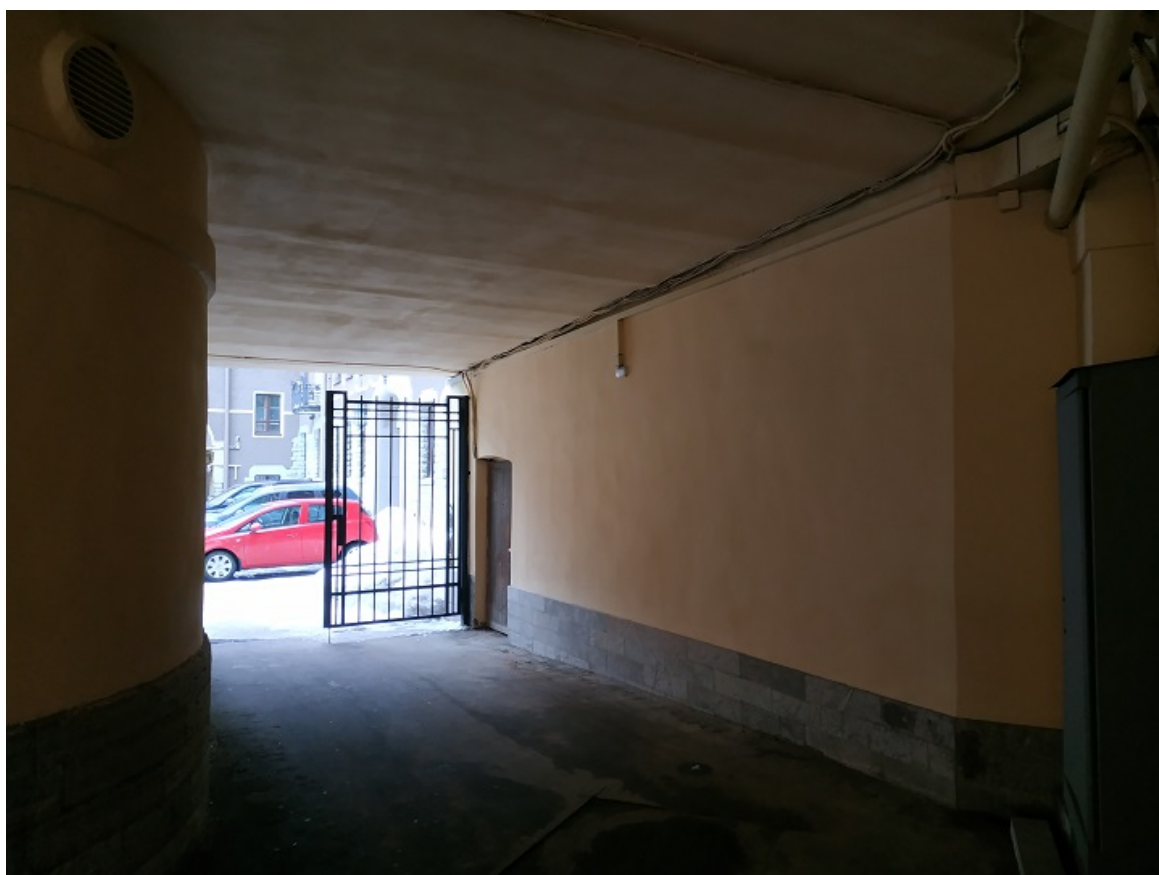
10. Здание по адресу: Санкт-Петербург, Каменноостровский проспект, д. 1-3. Вид арочного проезда и ворот, ведущих во двор.
