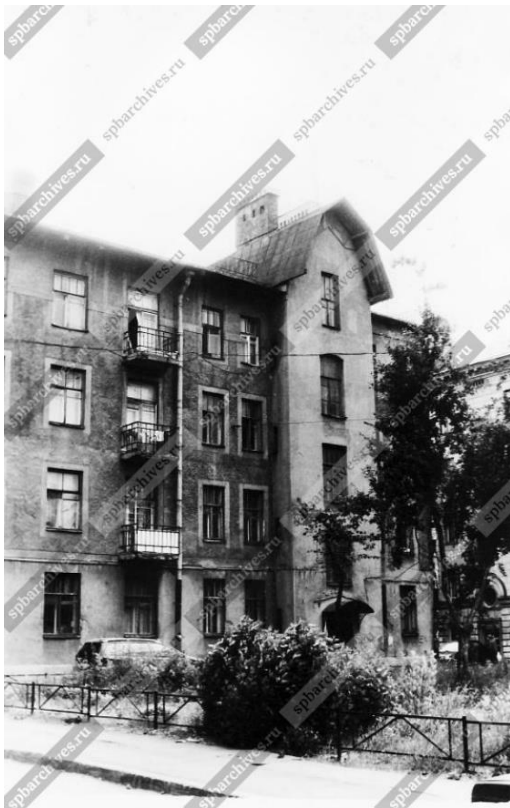
Илл. 30. Вид центрального фасада жилого дома № 20 корп. 1 со стороны Большого Сампсониевского проспекта (бывший дом для рабочих жилого городка завода «Людвиг Нобель») в квартале, ограниченном проспектами Лесным и Большим Сампсониевским. 03.07.2004 г. (источник: ЦГАКФФД СПб. Фотодокумент Ар 222386).
