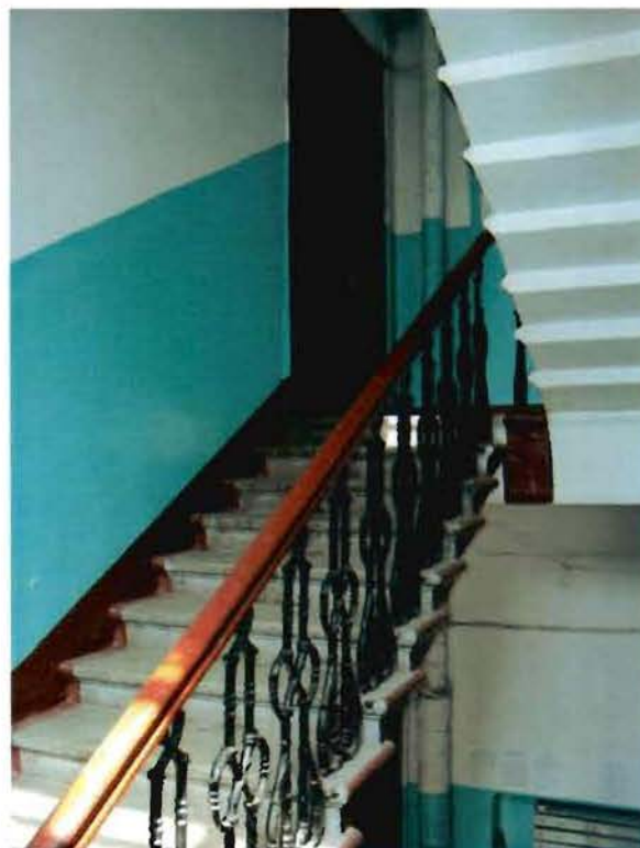
Фото 33. Лестничный объем. Фрагмент.
