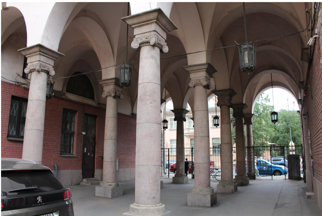
Фото 17. Вид на арку воротного проезда жилого дома по адресу: Санкт-Петербург, Лесной пр., 20, корп. 8, лит. Ф со стороны двора.
