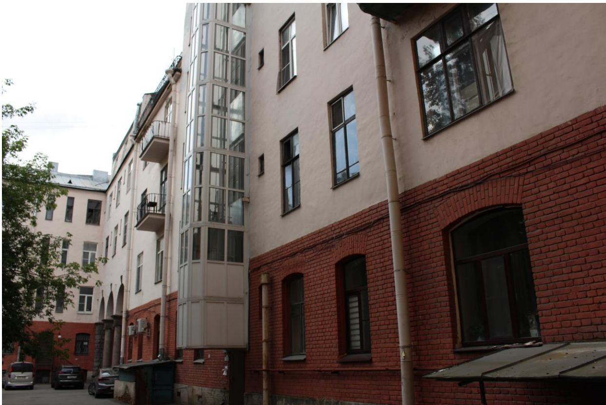
Фото 9. Вид на дворовые фасады жилого дома по адресу: Санкт-Петербург, Лесной пр., 20, корп. 8, лит. Ф с юга.
