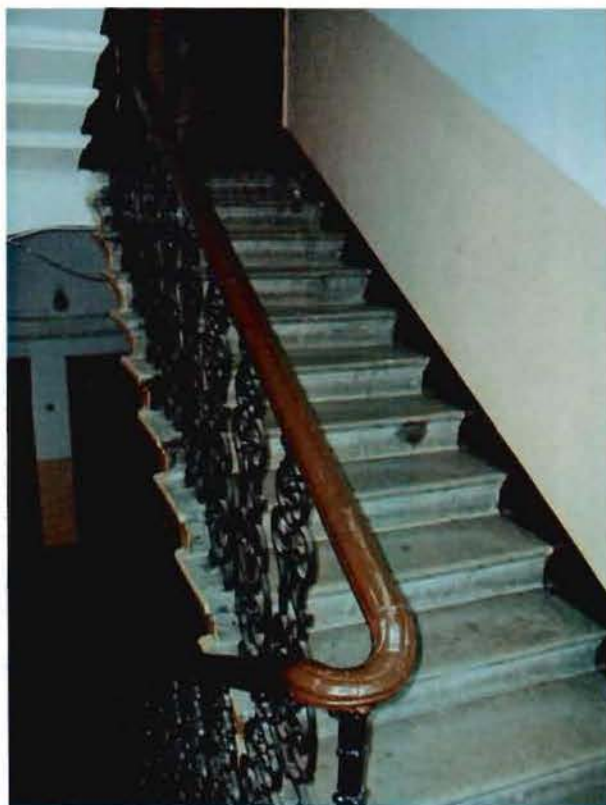
Фото 11. Лестничный объем. Фрагмент.
