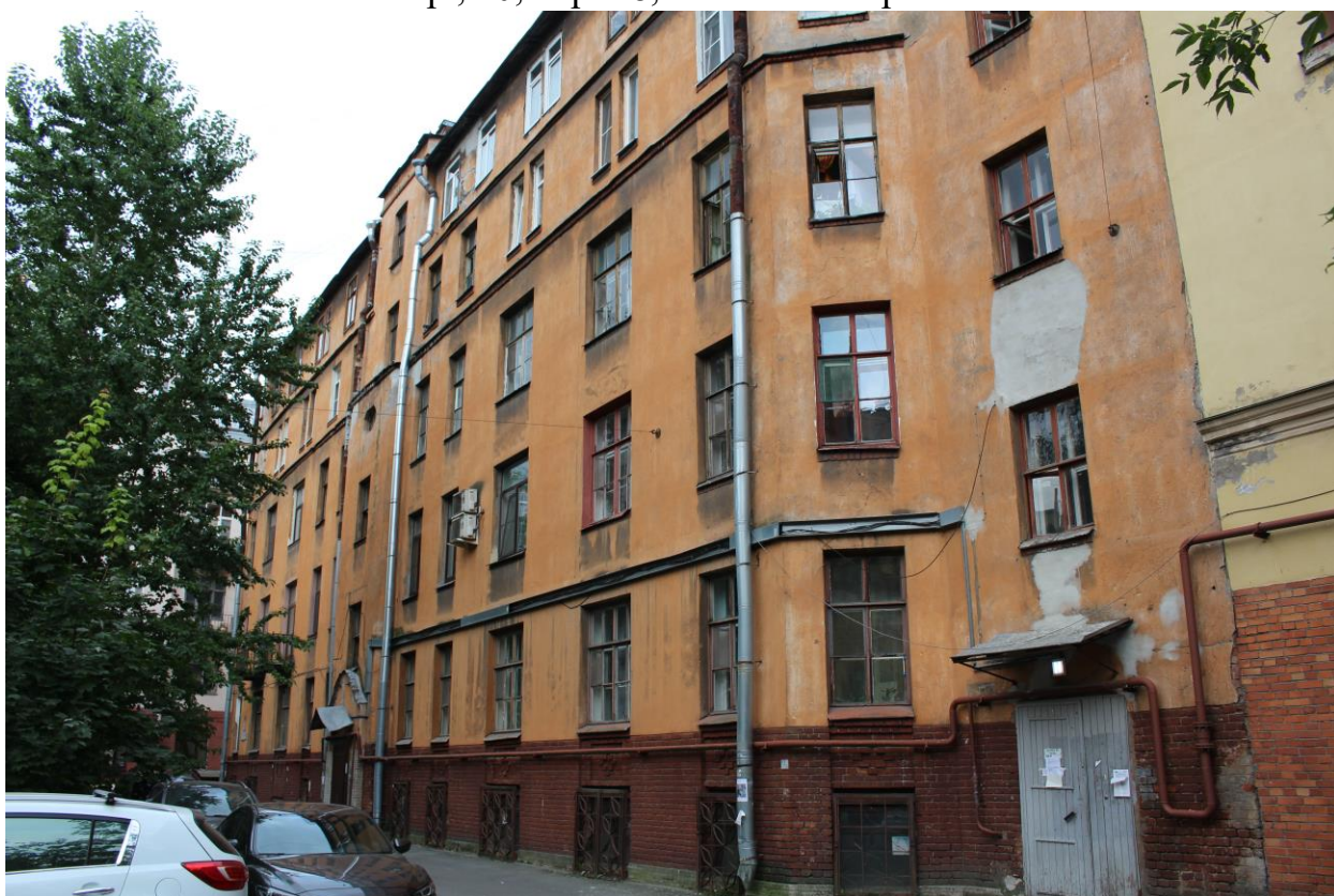
Фото 22. Вид на фасад жилого дома по адресу: Санкт-Петербург, Лесной пр., корп. 7, лит. Ч с северо-запада.
