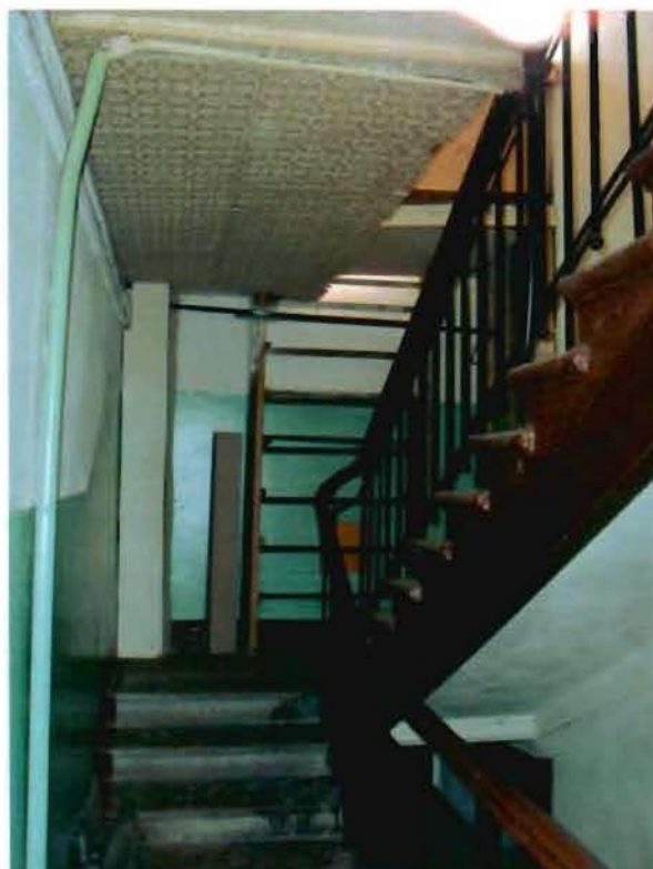
Фото 36. Лестничный объем. Фрагмент.
