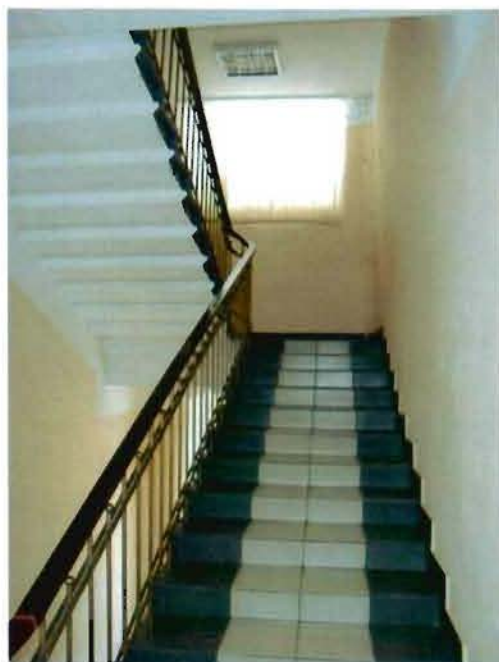
Фото 29. Лестничный объем. Фрагмент.
