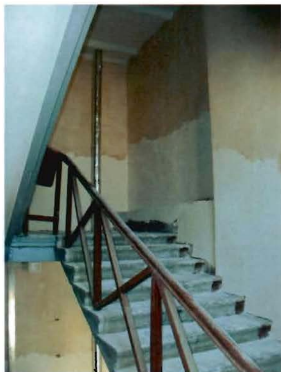
Фото 27. Лестничный объем. Фрагмент.
