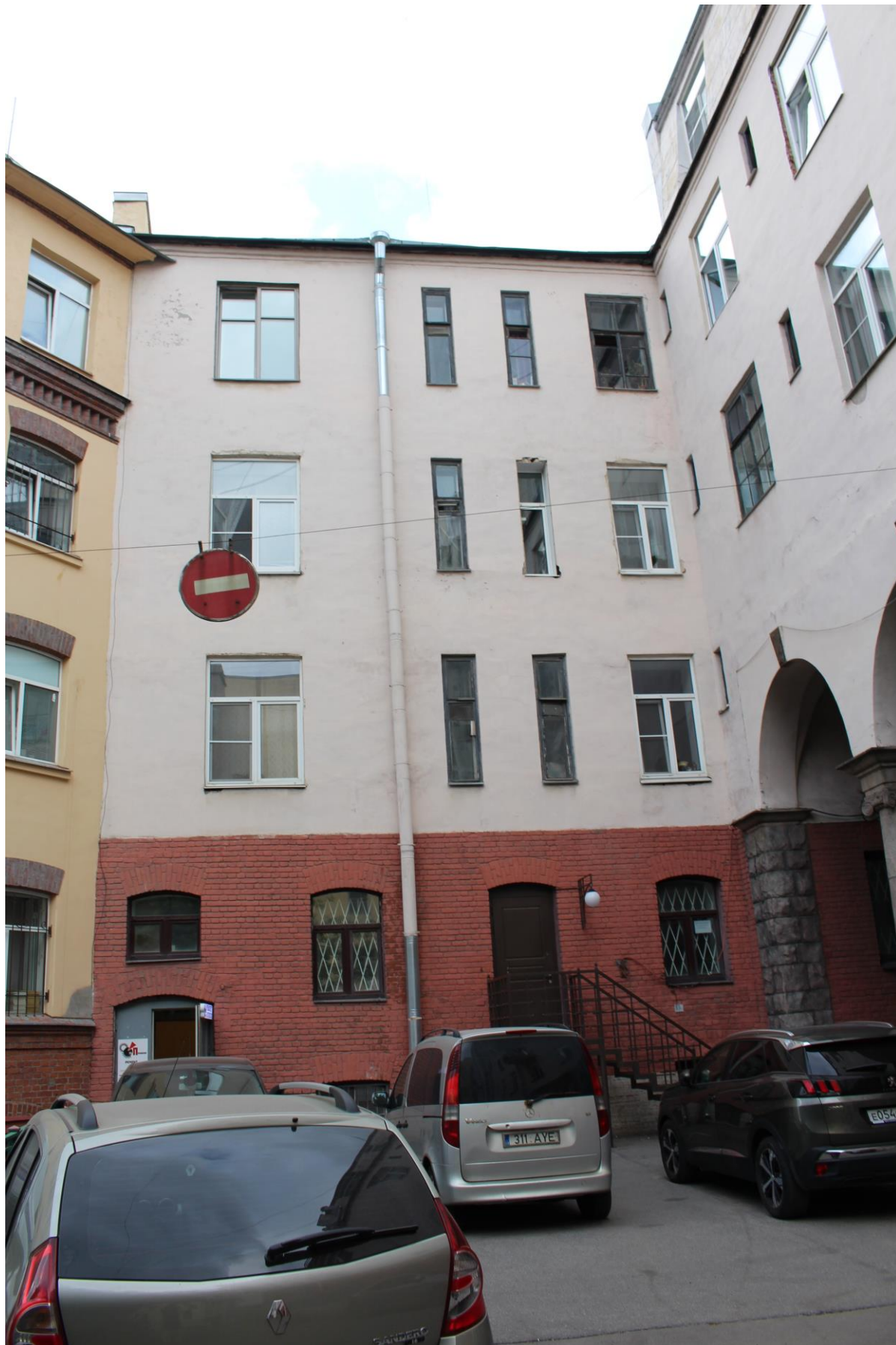
Фото 7. Вид на дворовый фасад жилого дома по адресу: Санкт-Петербург, Лесной пр., 20, корп. 8, лит. Ф с юга.
