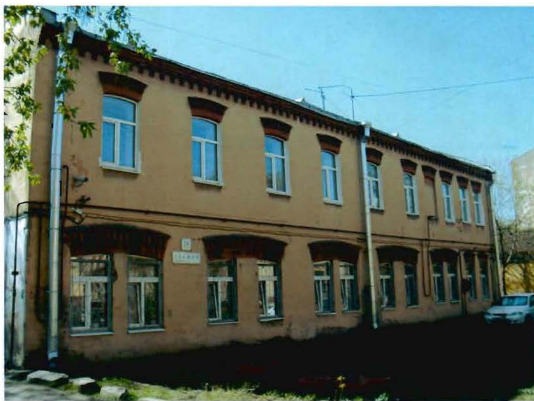
Фото 21. Вид на северный фасад.
