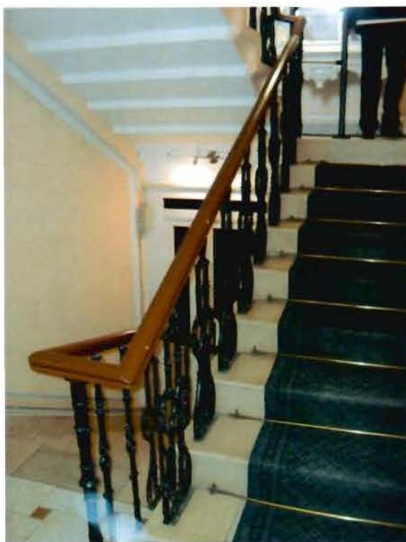
Фото 38. Лестничный объем. Фрагмент.
