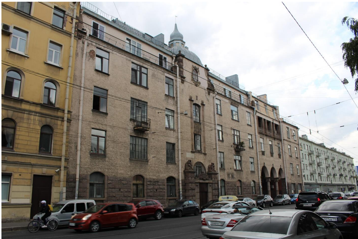
Фото 19. Вид на лицевой фасад жилого дома по адресу: Санкт-Петербург, Лесной пр., 20, корп. 8, лит. Ф с юго-востока.
