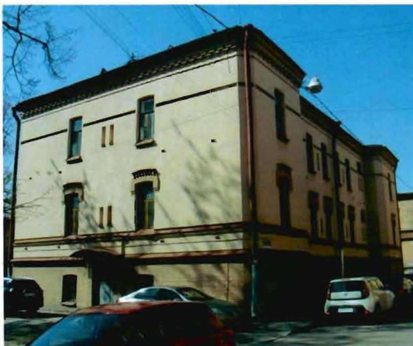
Фото 18. Вид на северный и восточный фасады.
