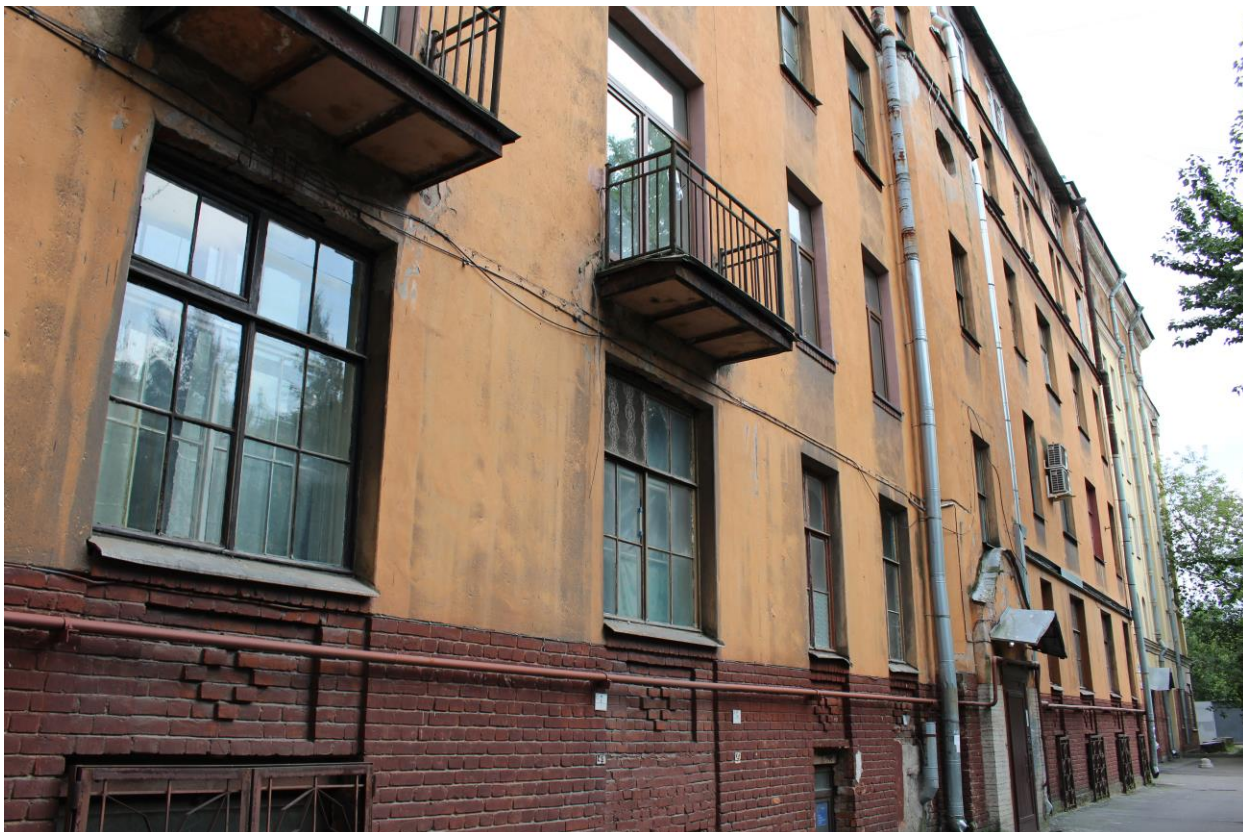
Фото 23. Вид на фасад жилого дома по адресу: Санкт-Петербург, Лесной пр., корп. 7, лит. Ч с северо-востока.
