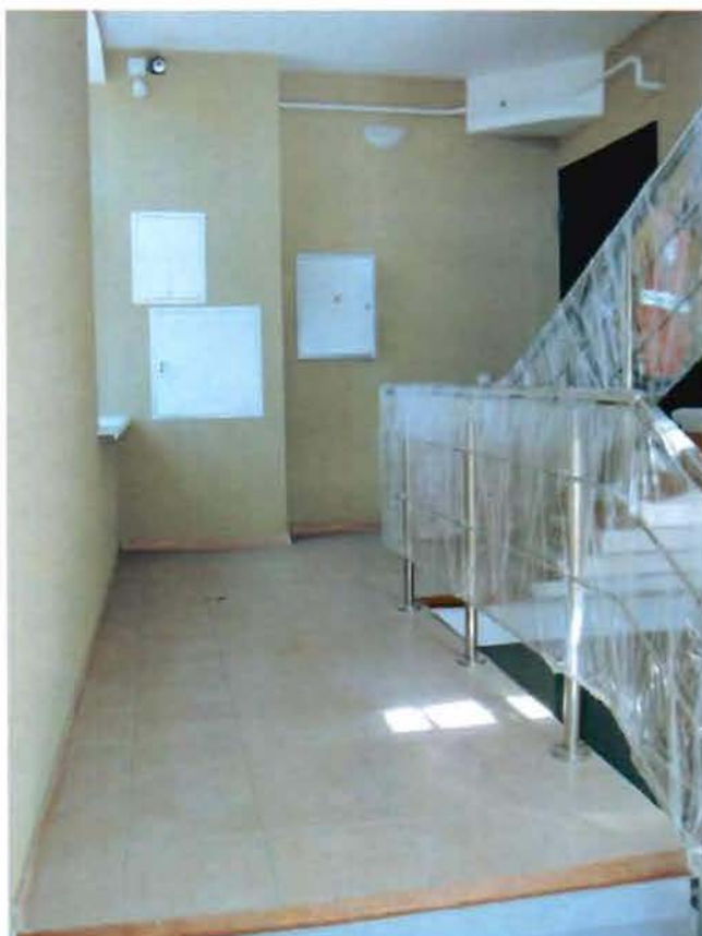
Фото 24. Лестничный объем. Фрагмент.
