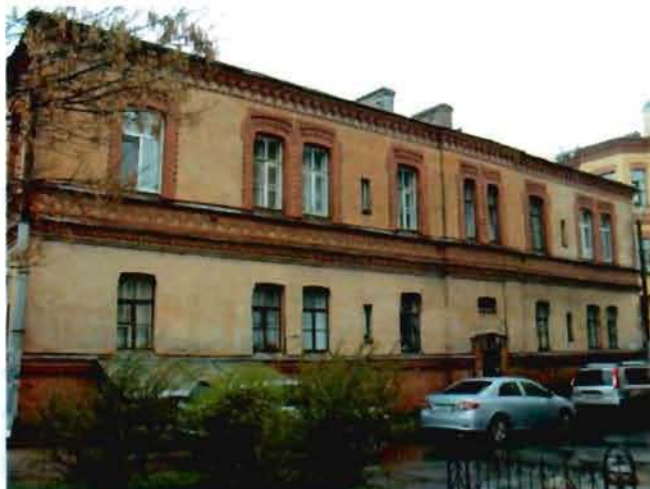
Фото 14. Вид на восточный фасад.
