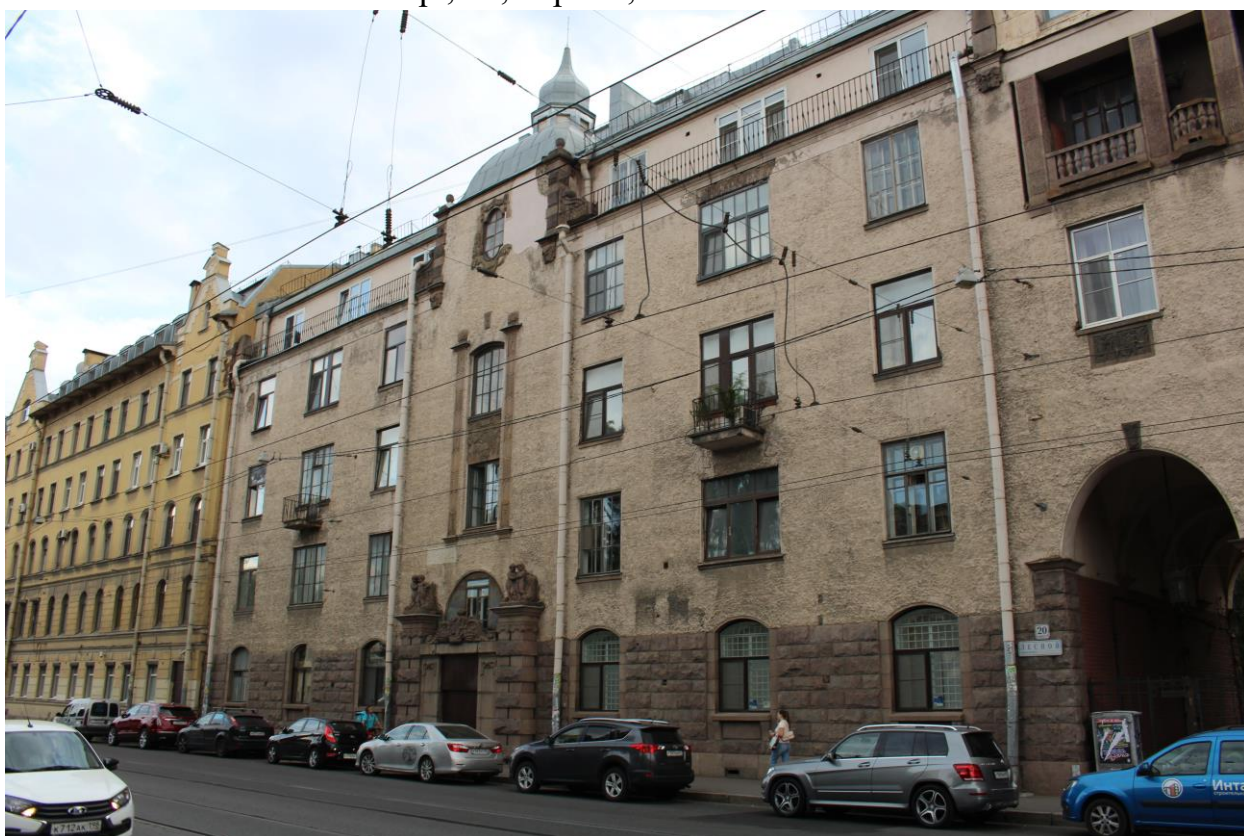
Фото 20. Вид на лицевой фасад жилого дома по адресу: Санкт-Петербург, Лесной пр., 20, корп. 8, лит. Ф с северо-востока.
