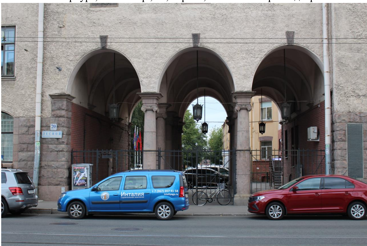
Фото 18. Вид на арку воротного проезда жилого дома по адресу: Санкт-Петербург, Лесной пр., 20, корп. 8, лит. Ф со стороны Лесного проезда.
