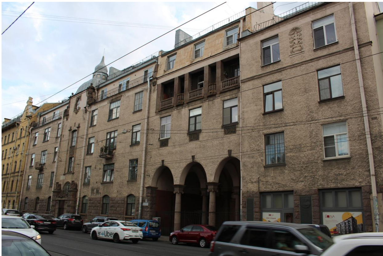
Фото 21. Вид на лицевой фасад жилого дома по адресу: Санкт-Петербург, Лесной пр., 20, корп. 8, лит. Ф с северо-востока.
