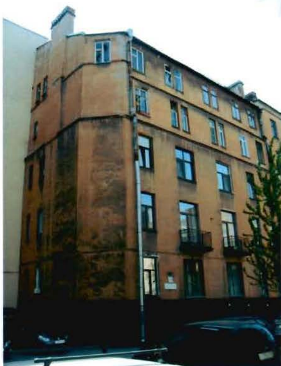
Фото 26. Вид на северный фасад. Фрагмент.
