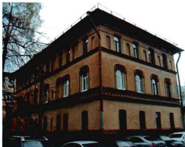
Фото 10. Вид на западный и южный фасады.
