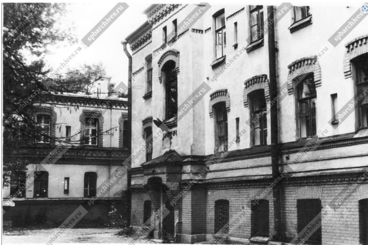
Илл. 31. Вид малоэтажных жилых домов в квартале, ограниченном Лесным и Большим Сампсониевским проспектами. На переднем плане дом 20 корп. 3. 03.07.2004 г. (источник: ЦГАКФФД СПб. Фотодокумент Ар 222387).
