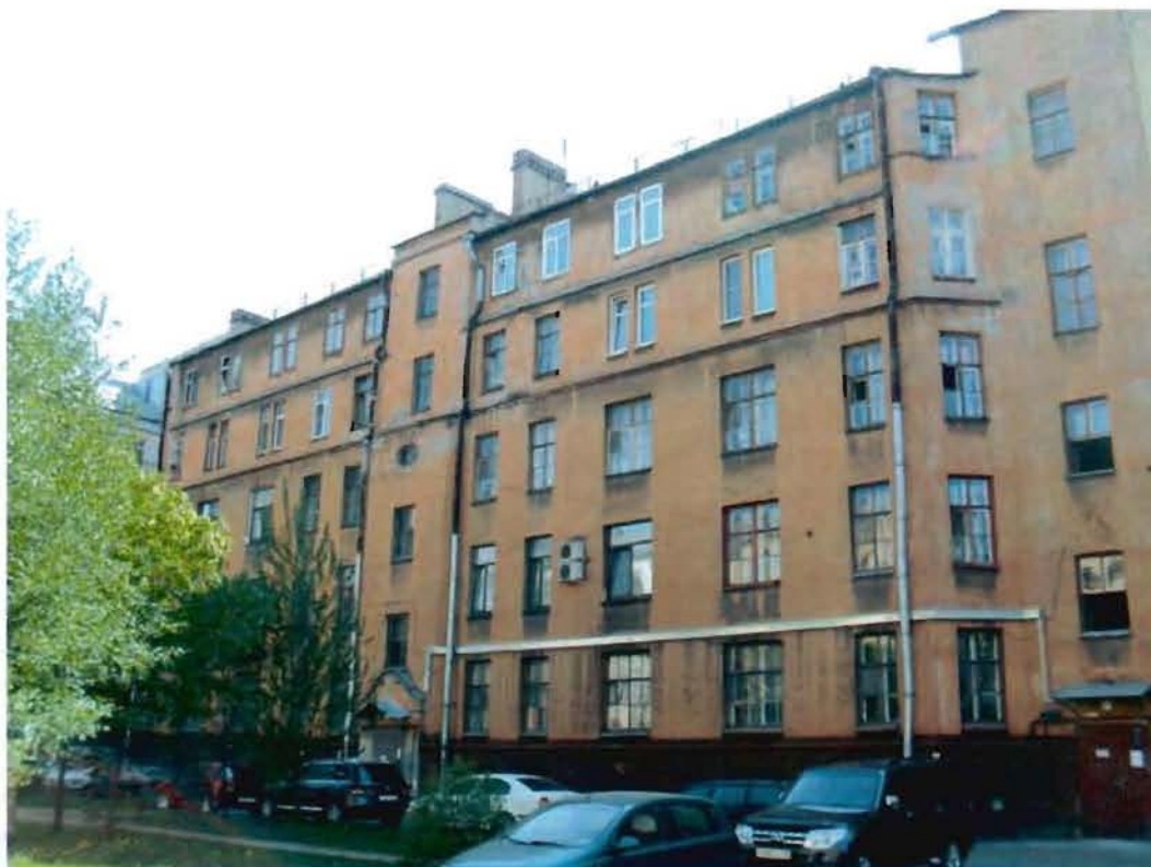
Фото 25. Вид на северный фасад. Фрагмент.
