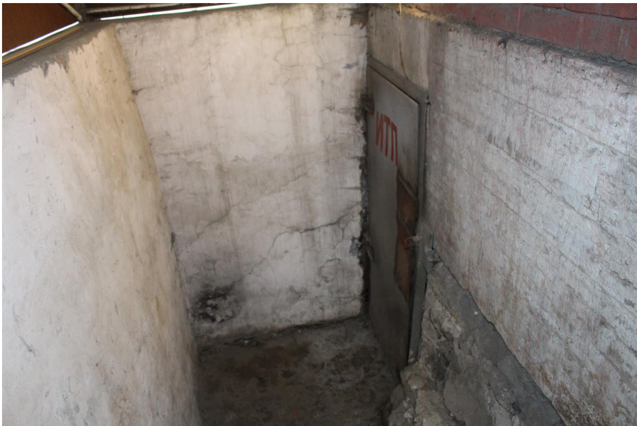
Фото 11. Вход в тепловой пункт (помещение 3-Н).
