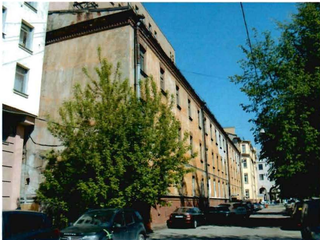
Фото 31. Вид на южный и западный фасады.
