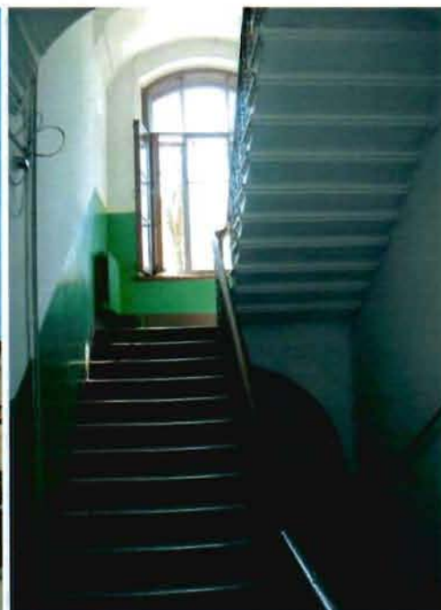
Фото 19. Лестничный объем. Фрагмент.
