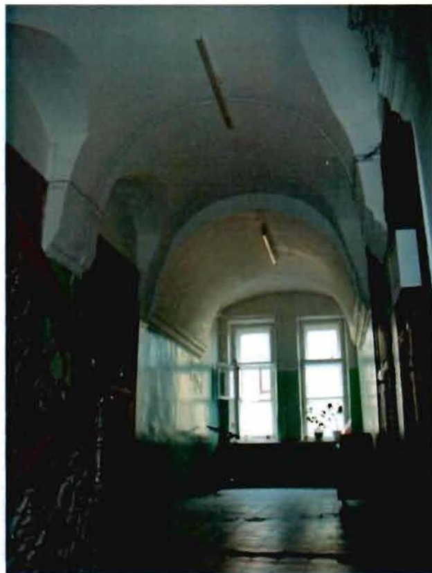
Фото 16. Вестибюль 2-го этажа. Цилиндрические своды с распалубками.
