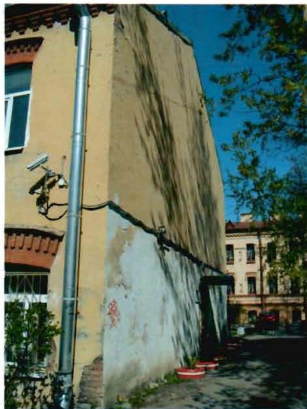
Фото 23. Вид на восточный фасад.
