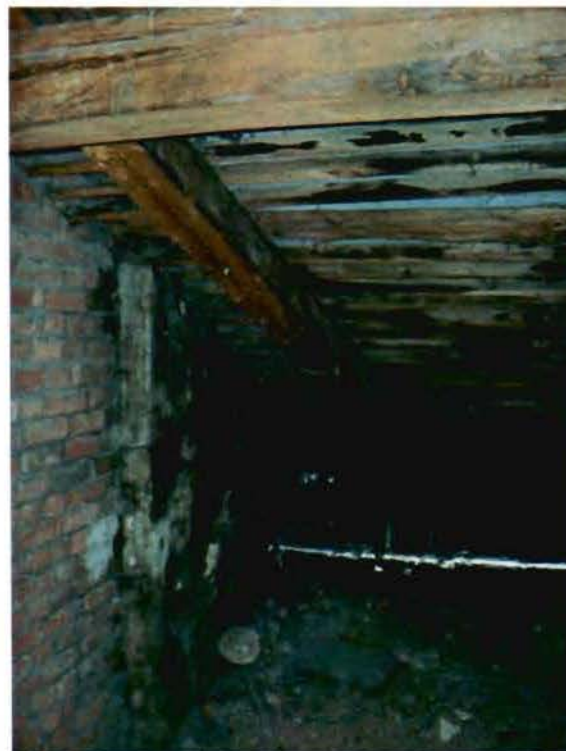
Фото 4. Чердачные помещения. Фрагмент.
