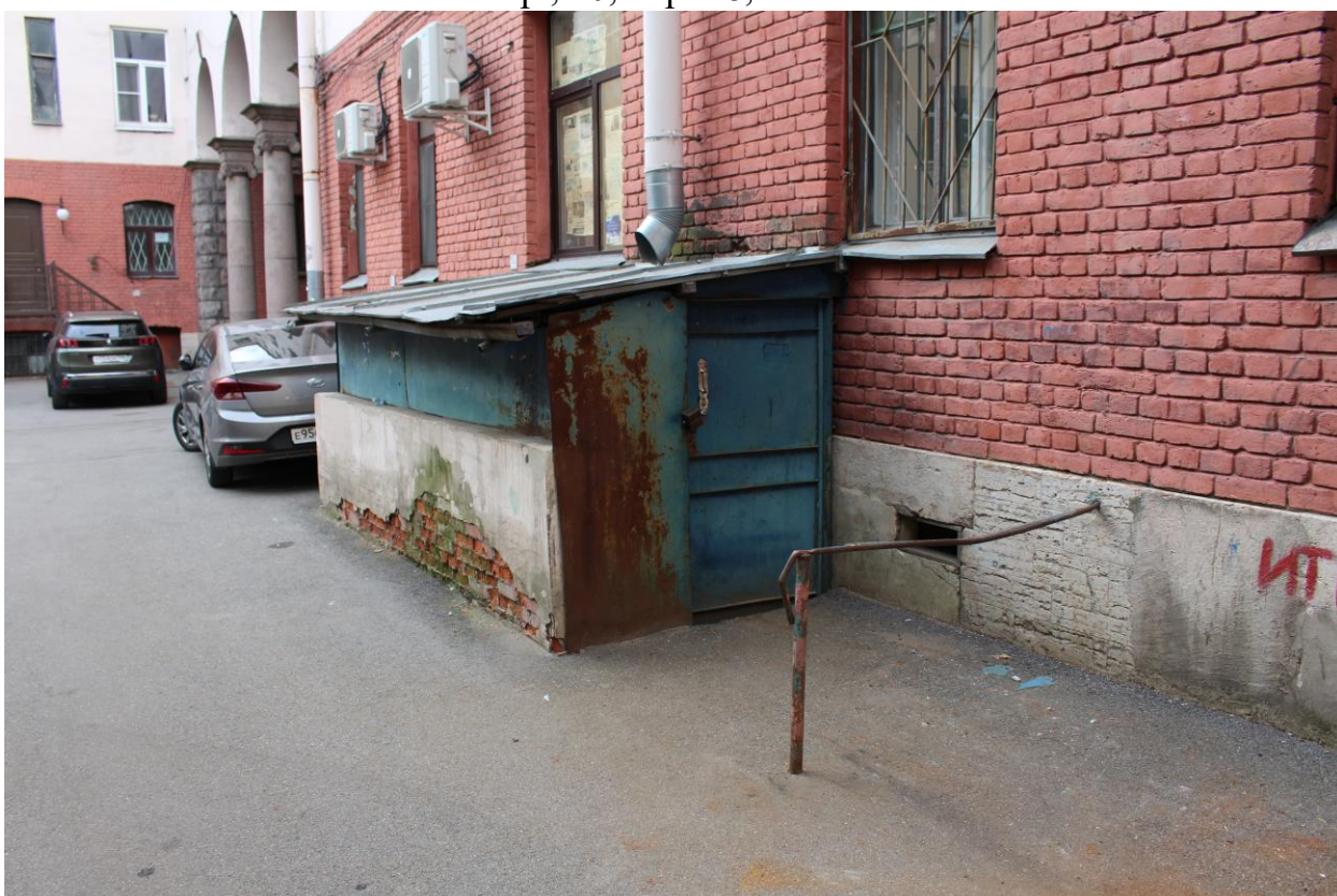
Фото 10. Вид на вход в тамбур теплового пункта (помещение 3-Н).
