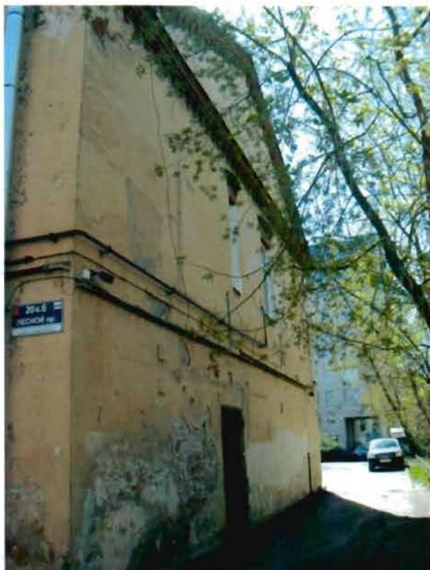
Фото 22. Вид на западный фасад.
