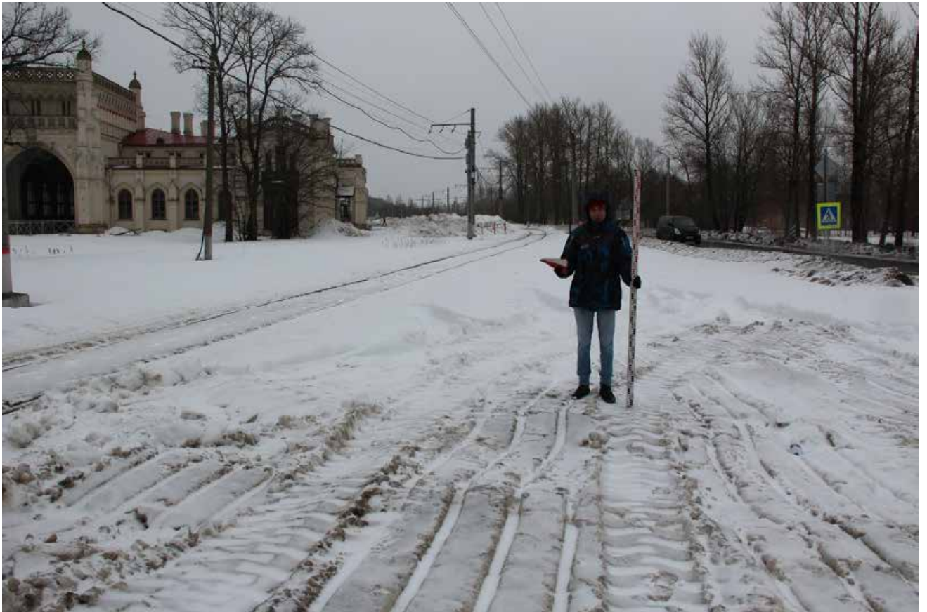
Рис. 25. Санкт-Петербург, Петродворцовый район, г. Петергоф. Точка съемки 11. Общий вид участка обследования. Вид на В.
