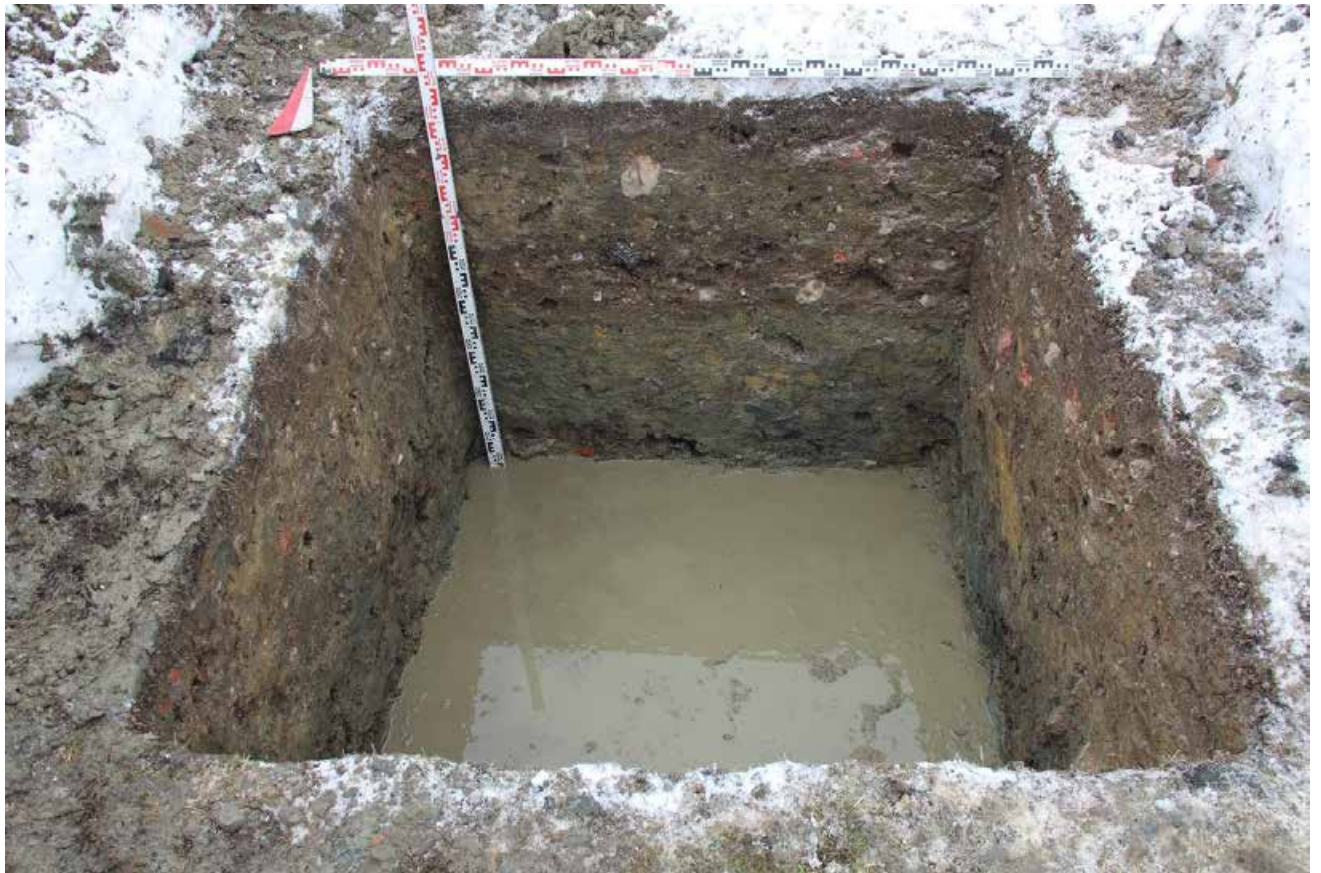
Рис. 30. Санкт-Петербург, Петродворцовый район, г. Петергоф. Общий вид Шурфа 1. Вид на С.
