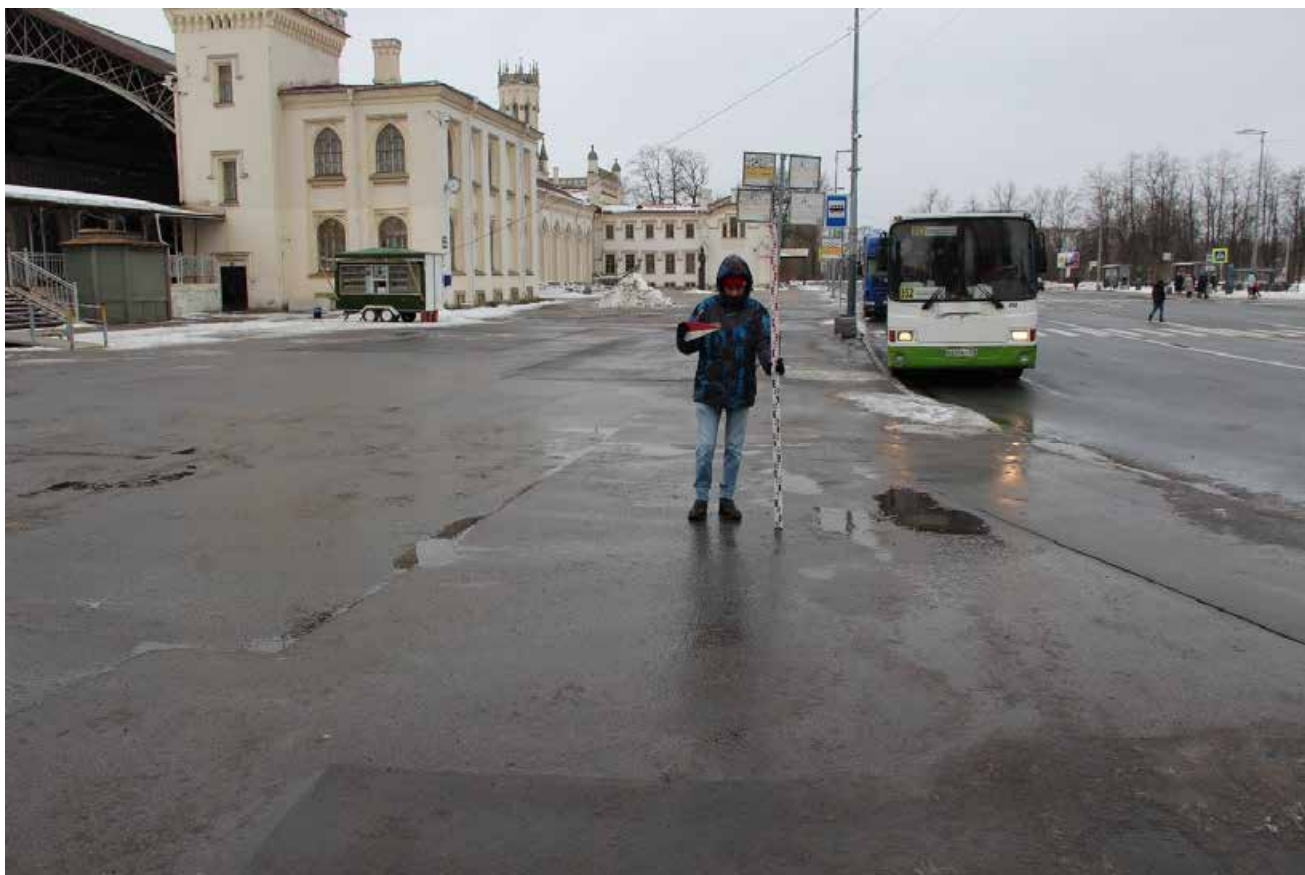
Рис. 20. Санкт-Петербург, Петродворцовый район, г. Петергоф. Точка съемки 8. Общий вид участка обследования. Вид на З.
