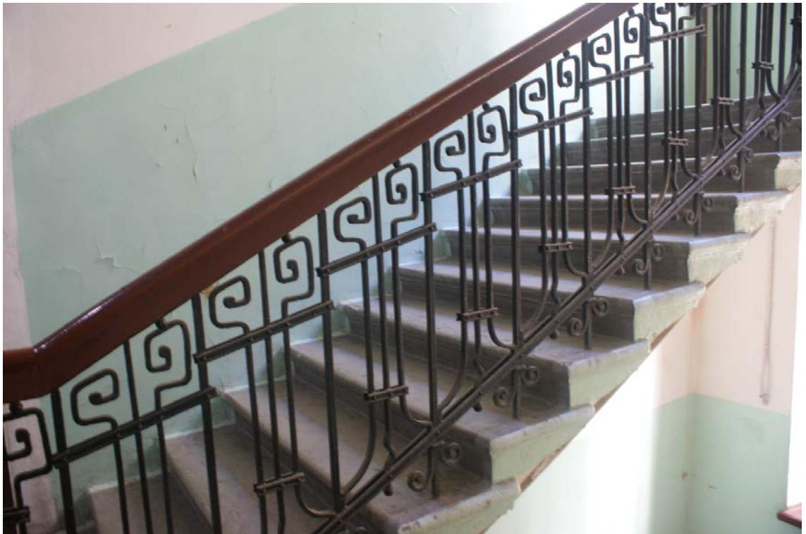
Фото 71. Ограждение лестничных маршей. Съемка 19.04.2021 г. Штиглиц М. С.
