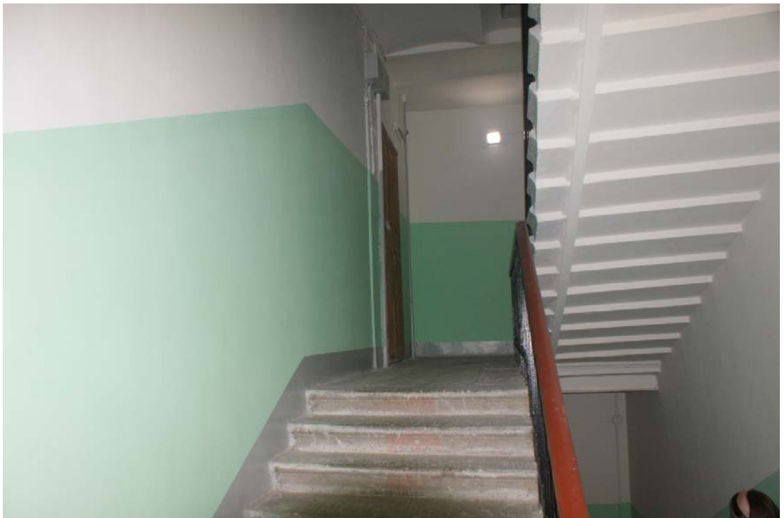
Фото 16. Площадка между 4-м и 5-м этажом. Съемка 19.04.2021 г. Штиглиц М. С.
