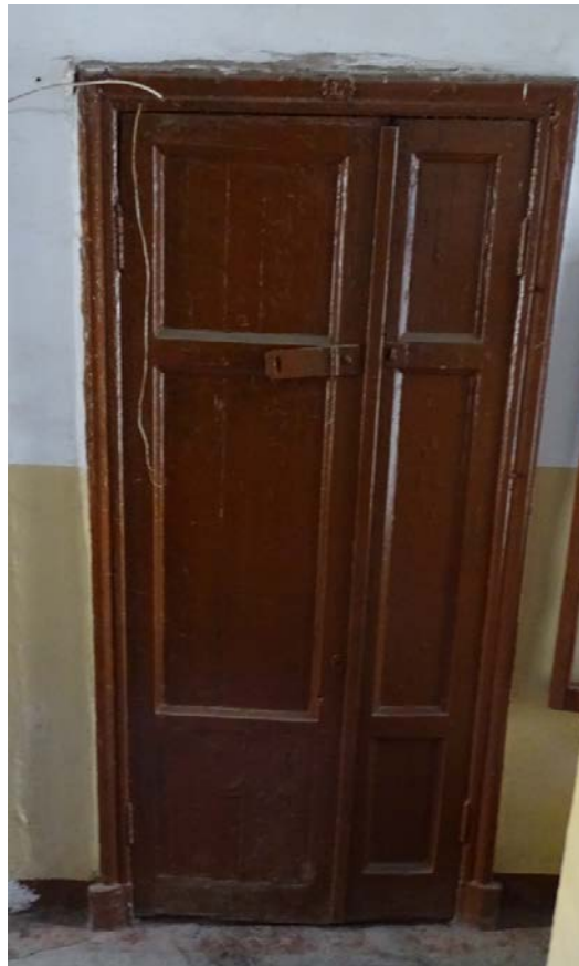
Фото 22. Площадка между 4-м и 5-м этажом. Оформление двери. Съемка 19.04.2021 г. Штиглиц М. С.
