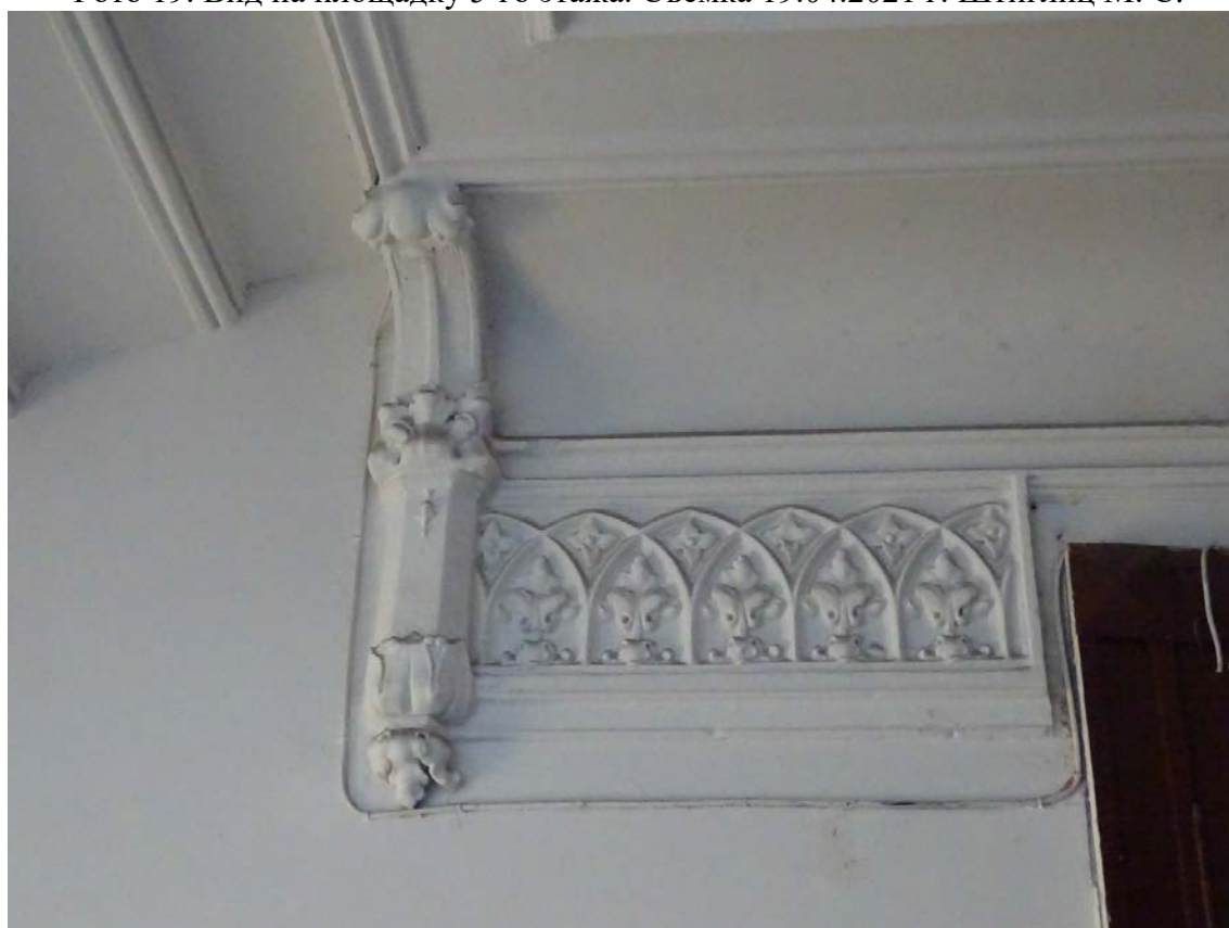
Фото 20. Площадка 5-го этажа. Оформление стен. Съемка 19.04.2021 г. Штиглиц М. С.
