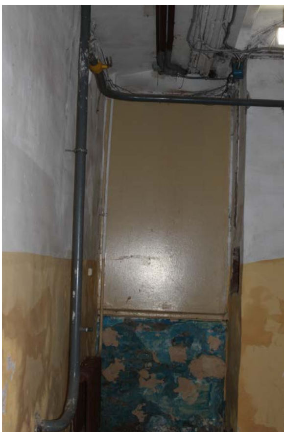
Фото 2. Площадка 1-го этажа. Съемка 19.04.2021 г. Штиглиц М. С.
