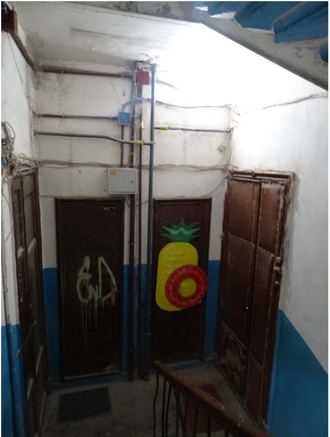
Фото 15. Вид на площадку 5-го этажа. Съемка 19.04.2021 г. Штиглиц М. С.
