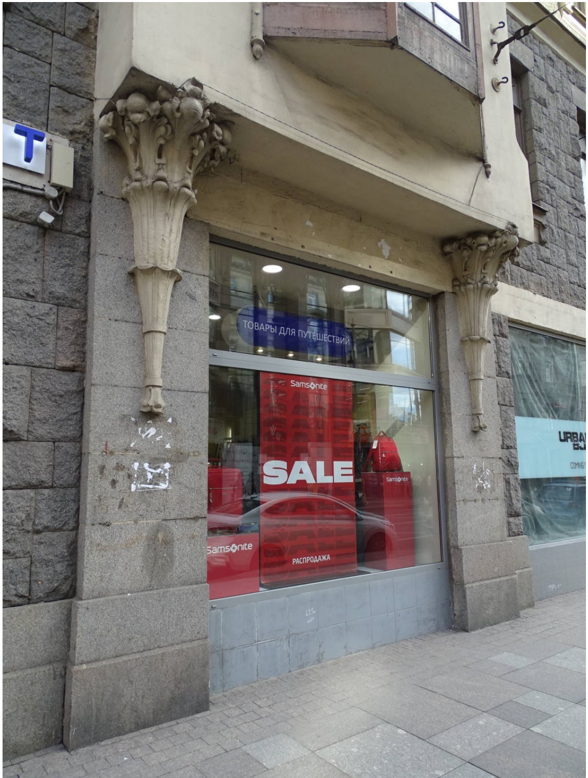
Фото 15. Здание по адресу: Большой проспект П.С., дом 69. Лицевой фасад по Большому пр. Фрагмент фасада. Кронштейны с лепным декором Съемка 19.04.2021 г. Штиглиц М. С.
