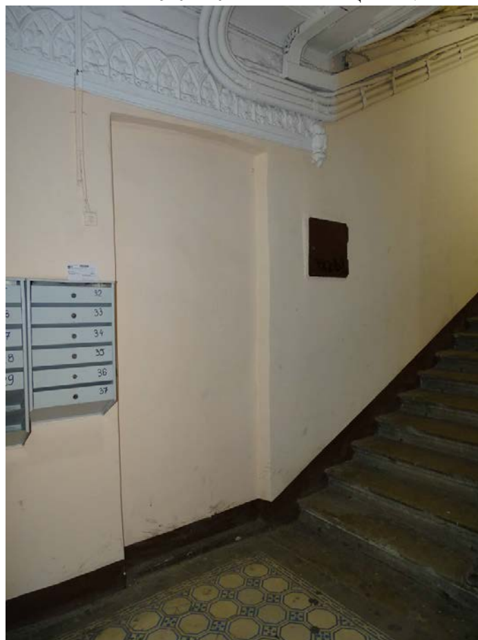
Фото 43. Вестибюль 1-го этажа. Ниша. Оформление стен. Съемка 19.04.2021 г. Штиглиц М. С.
