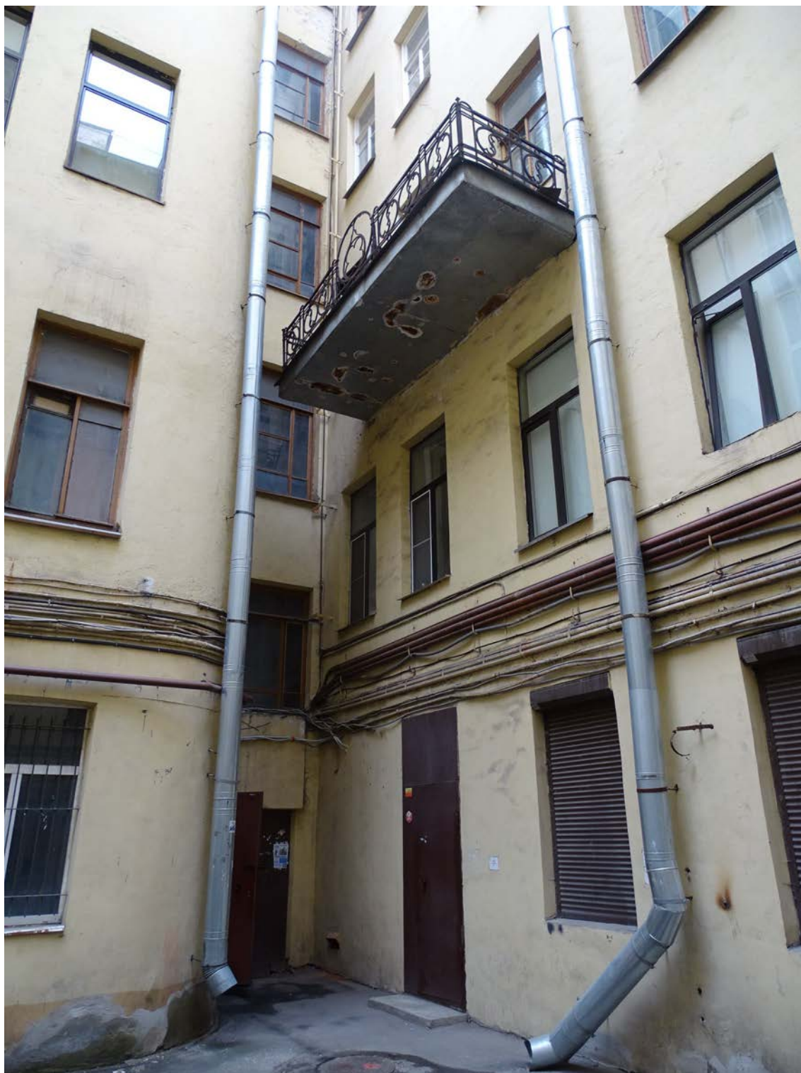
Фото 45. Здание по адресу: Большой проспект П.С., дом 69. Западный внутренний двор. Фрагмент фасада. Съемка 19.04.2021 г. Штиглиц М. С.
