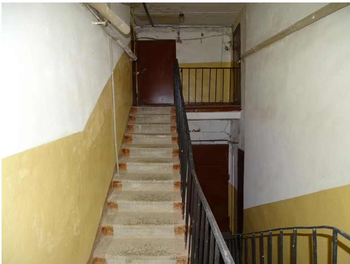
Фото 33. Площадка чердачного этажа. Съемка 19.04.2021 г. Штиглиц М. С.
