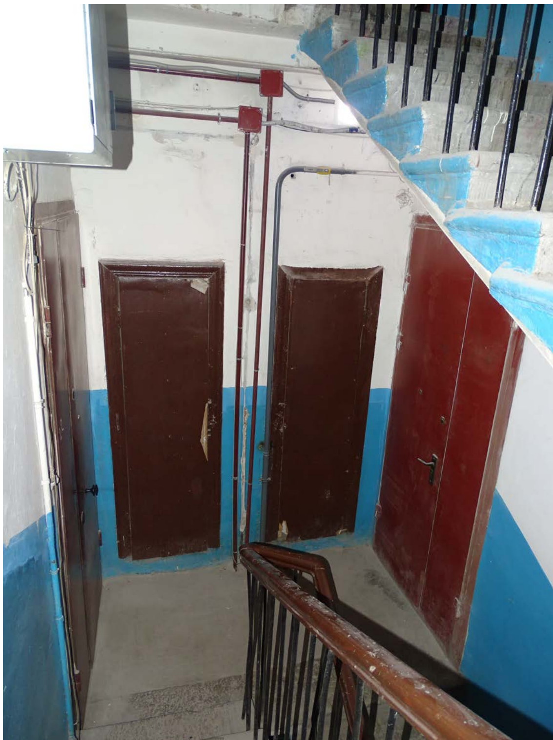
Фото 17. Площадка 6-го этажа. Съемка 19.04.2021 г. Штиглиц М. С.
