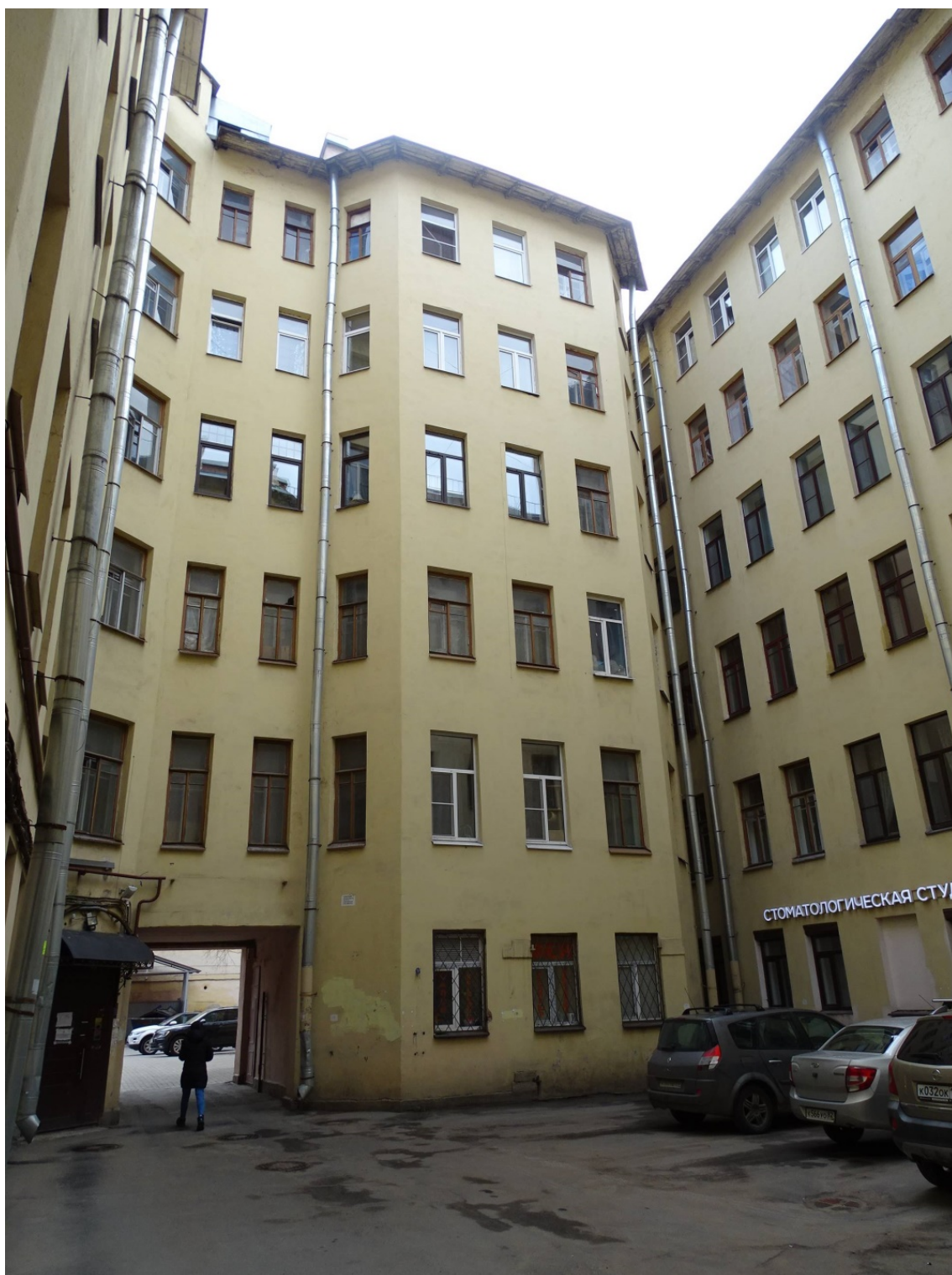
Фото 41. Здание по адресу: Большой проспект П.С., дом 69. Южный внутренний двор. Фрагмент фасада. Съемка 19.04.2021 г. Штиглиц М. С.
