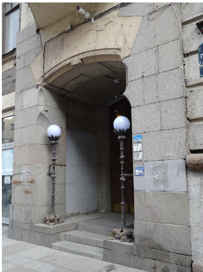
Фото 5. Здание по адресу: Большой проспект П.С., дом 69. Лицевой фасад по Большому пр. Фрагмент. Съемка 19.04.2021 г. Штиглиц М. С.
