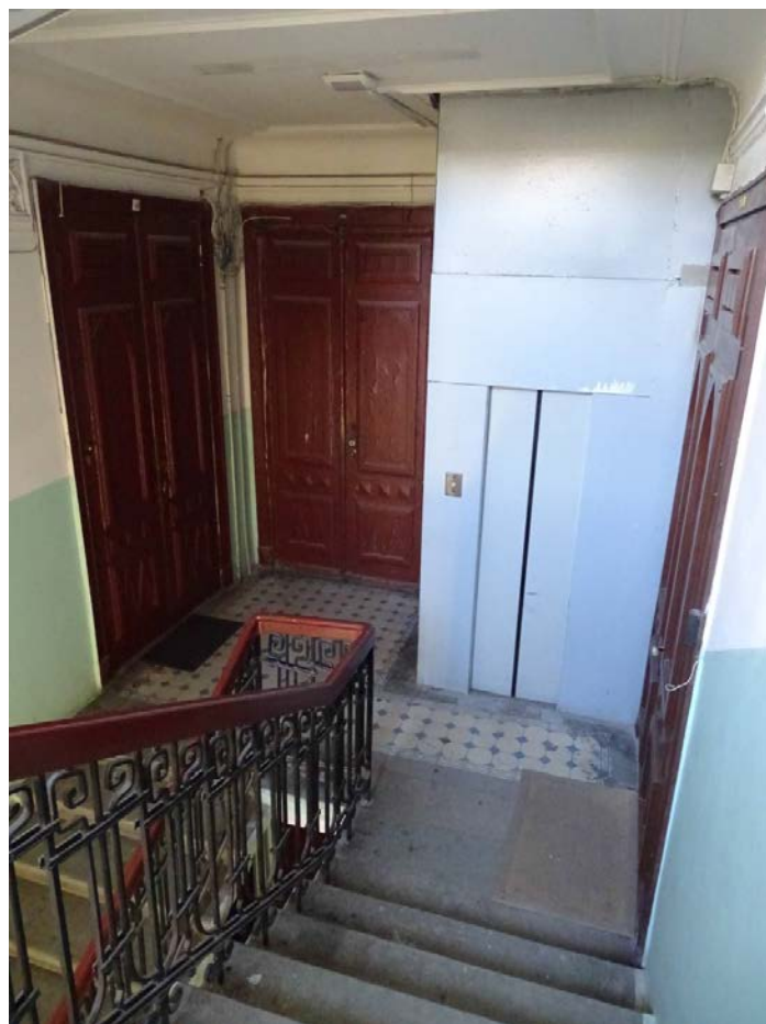
Фото 19. Вид на площадку 5-го этажа. Съемка 19.04.2021 г. Штиглиц М. С.
