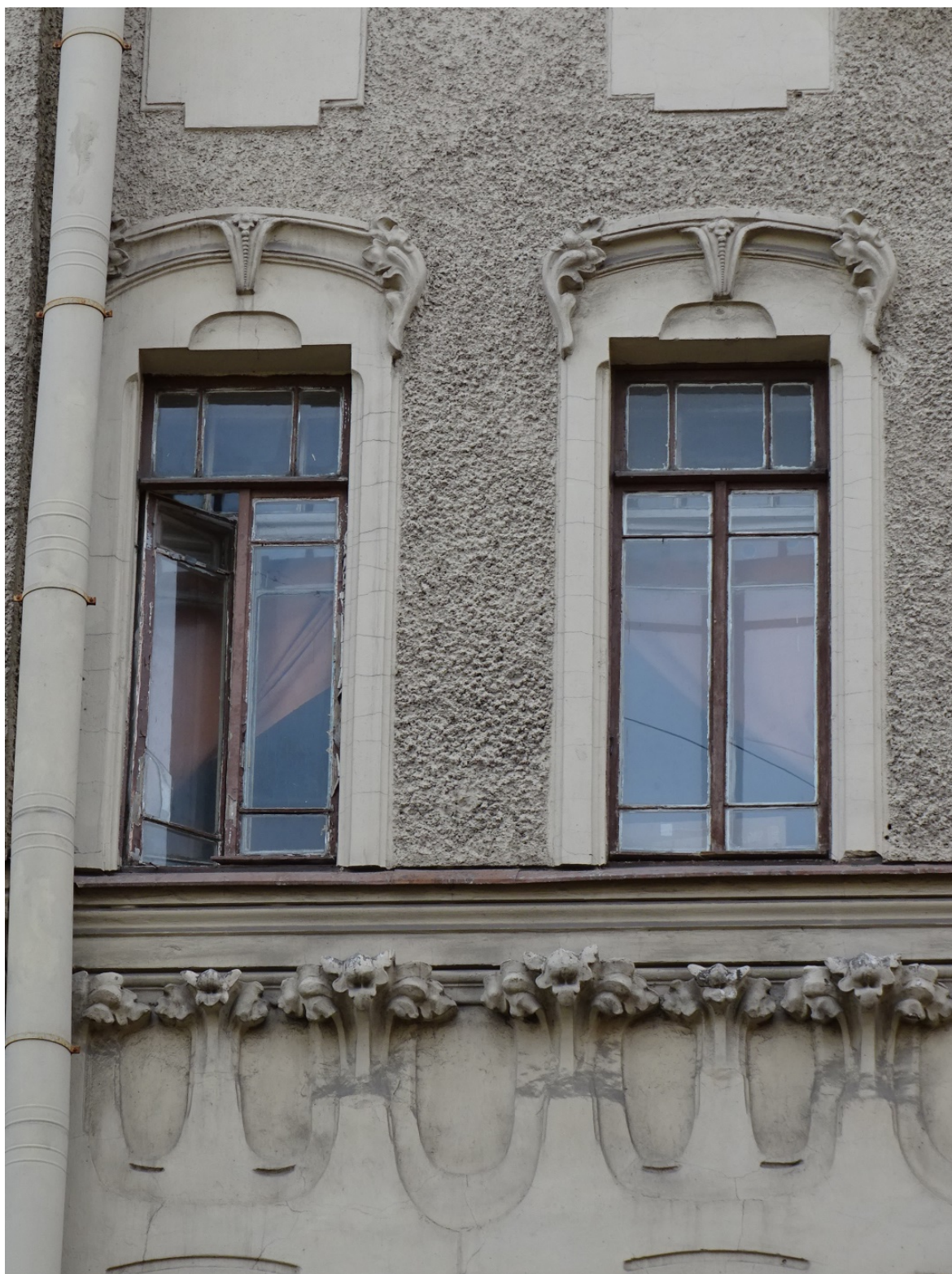
Фото 25 Здание по адресу: Большой проспект П.С., дом 69. Лицевой фасад по Ординарной ул. Фрагмент фасада. Оформление оконных проемов. Съемка 19.04.2021 г. Штиглиц М. С.
