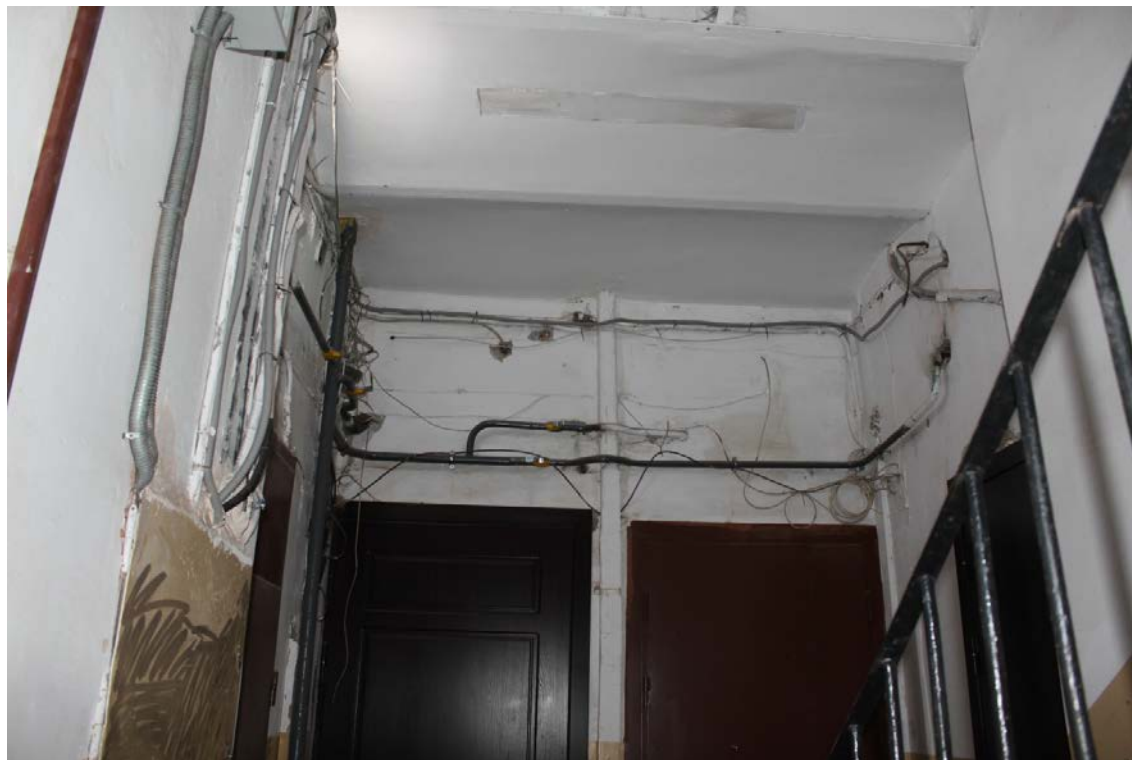
Фото 10. Площадка 2-го этажа. Съемка 19.04.2021 г. Штиглиц М. С.
