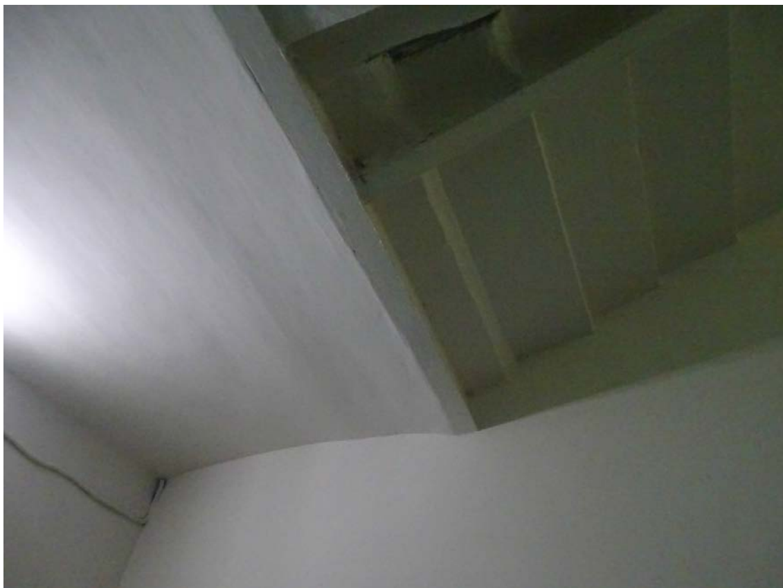
Фото 4. Площадка между 1-м и 2-м этажом. Съемка 19.04.2021 г. Штиглиц М. С.
