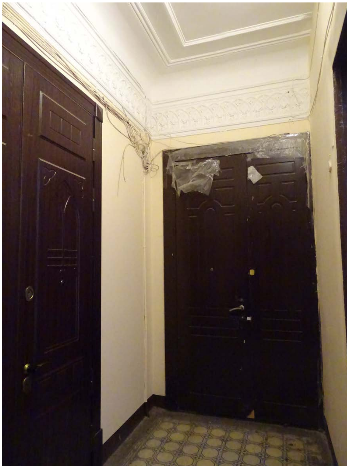
Фото 50. Площадка 2-го этажа. Съемка 19.04.2021 г. Штиглиц М. С.
