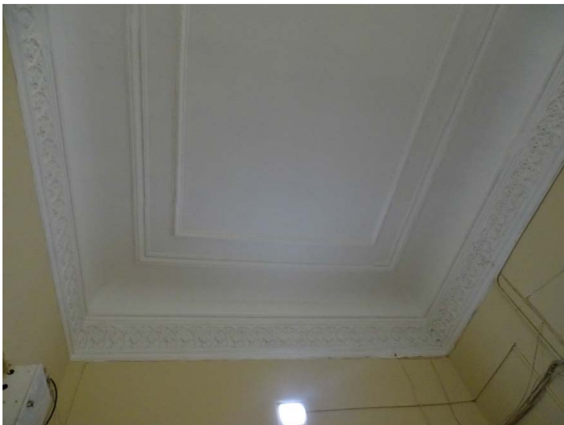
Фото 22. Площадка 6-го этажа. Оформление потолка. Съемка 19.04.2021 г. Штиглиц М. С.
