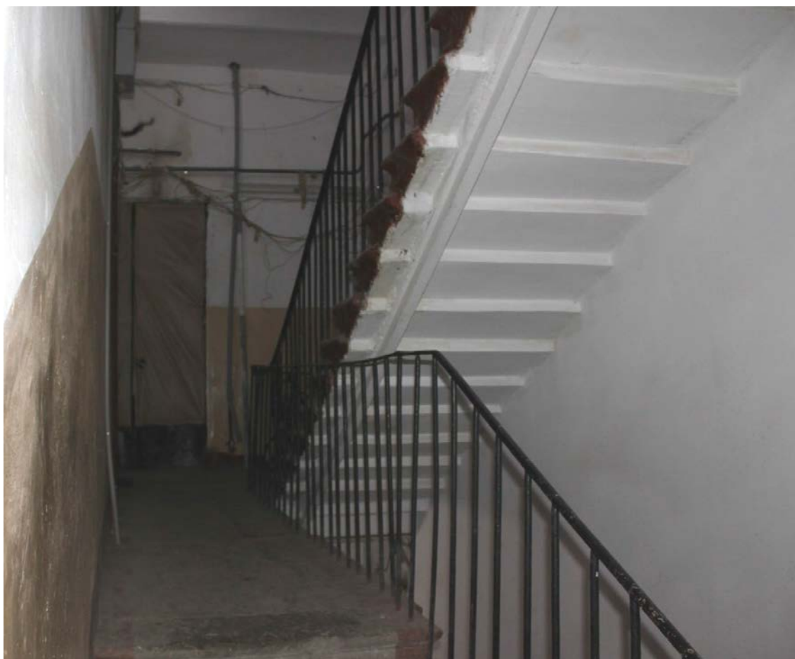
Фото 14. Вид на площадку 3-го этажа. Съемка 19.04.2021 г. Штиглиц М. С.
