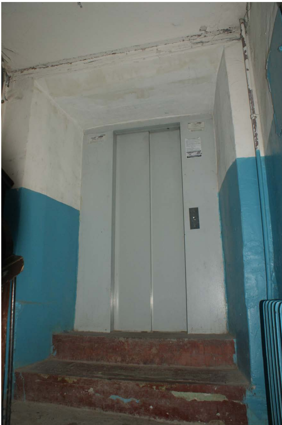
Фото 5. Вид на площадку между 1-м и 2-м этажом. Съёмка 19.04.2021 г. Штиглиц М. С.
