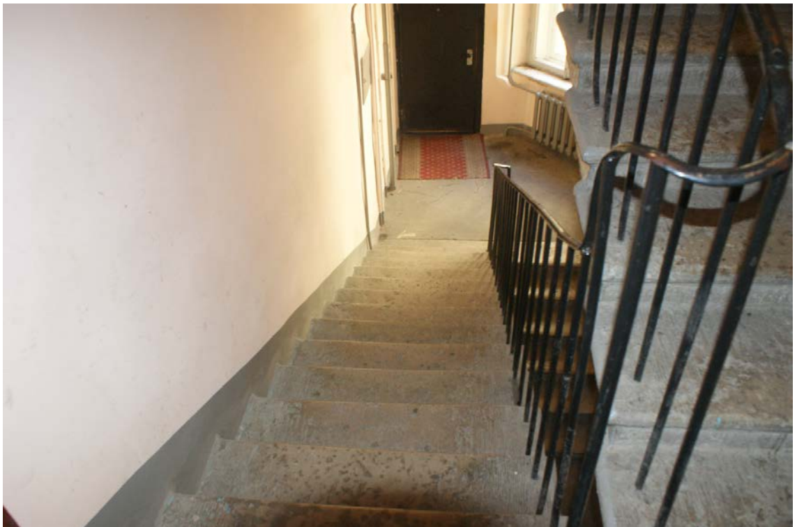
Фото 10. Вид на площадку 4-го этажа. Съёмка 19.04.2021 г. Штиглиц М. С.
