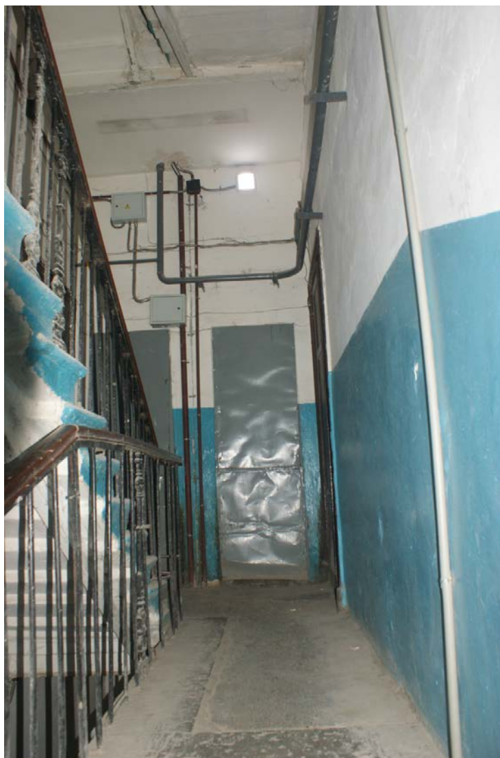
Фото 6 Вид на площадку 2-го этажа. Съемка 19.04.2021 г. Штиглиц М. С.
