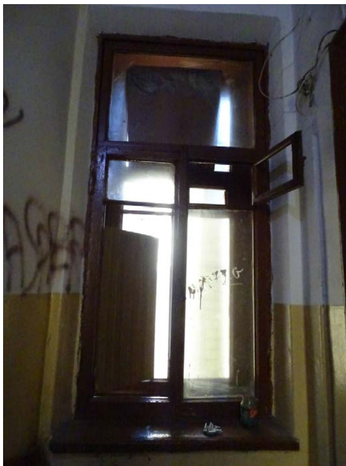
Фото 17. Площадка между 3-м и 4-м этажом. Съемка 19.04.2021 г. Штиглиц М. С.
