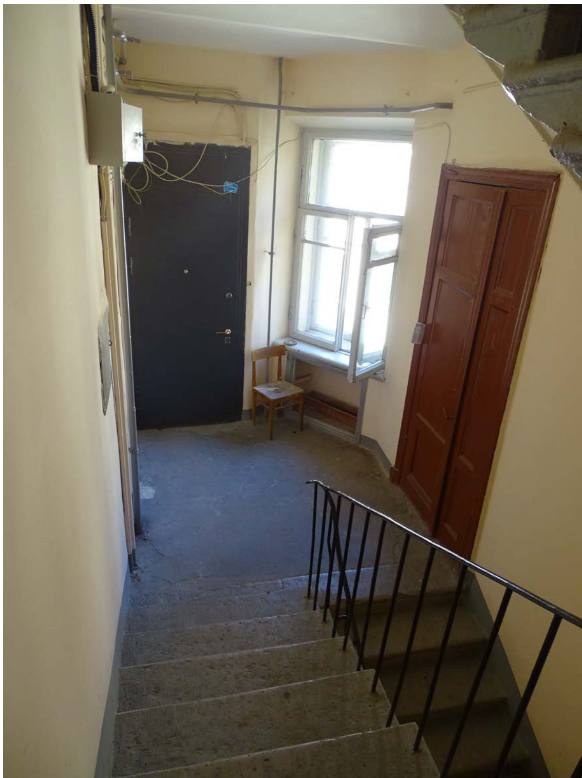
Фото 12. Площадка 5-го этажа. Съемка 19.04.2021 г. Штиглиц М. С.
