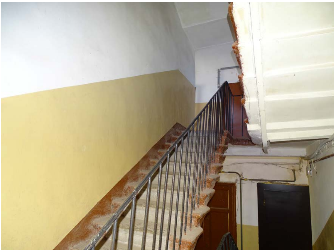
Фото 28. Лестничный марш между 5-м и 6-м этажом. Съемка 19.04.2021 г. Штиглиц М. С.
