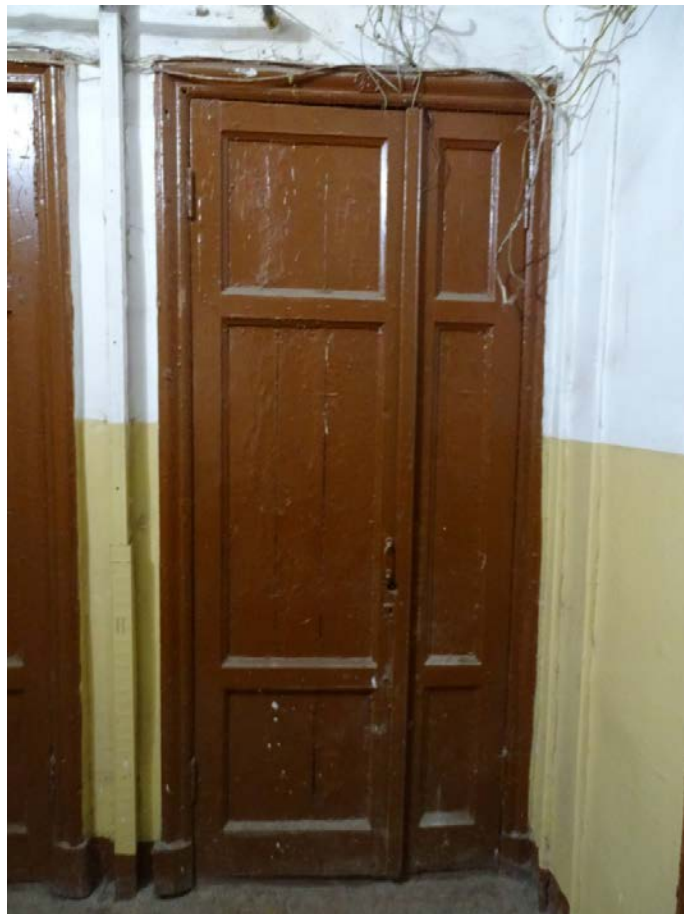
Фото 24. Площадка 5-го этажа. Оформление двери. Съемка 19.04.2021 г. Штиглиц М. С.
