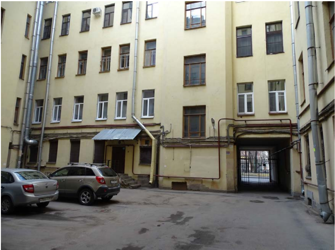
Фото 36. Здание по адресу: Большой проспект П.С., дом 69. Южный внутренний двор. Фрагмент фасада. Съемка 19.04.2021 г. Штиглиц М. С.
