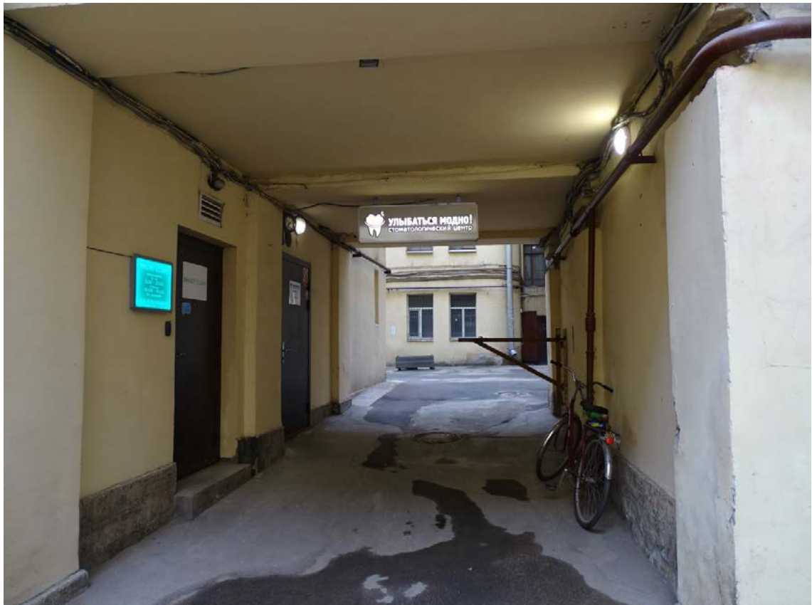
Фото 43. Здание по адресу: Большой проспект П.С., дом 69. Воротный проезд в западный внутренний двор. Съемка 19.04.2021 г. Штиглиц М. С.
