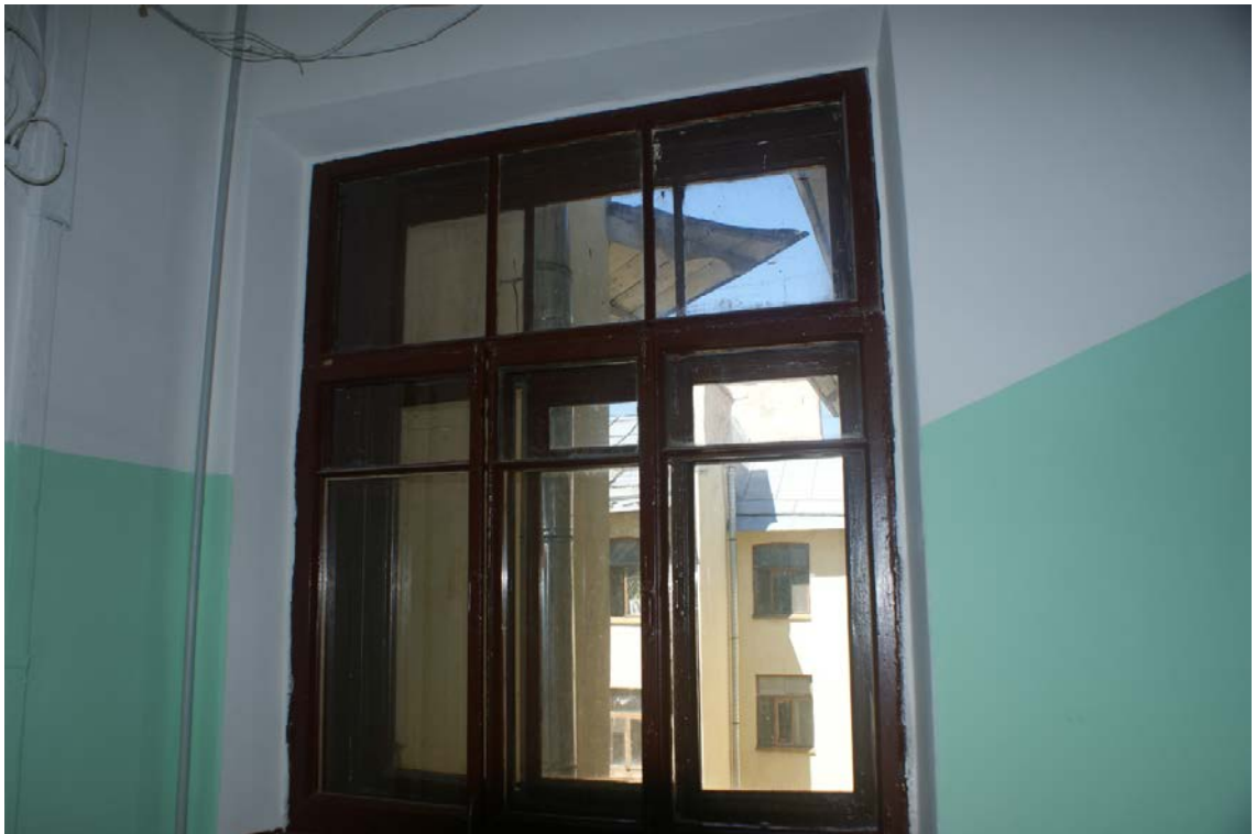
Фото 19. Площадка 5-го этажа. Оконный проем. Съемка 19.04.2021 г. Штиглиц М. С.
