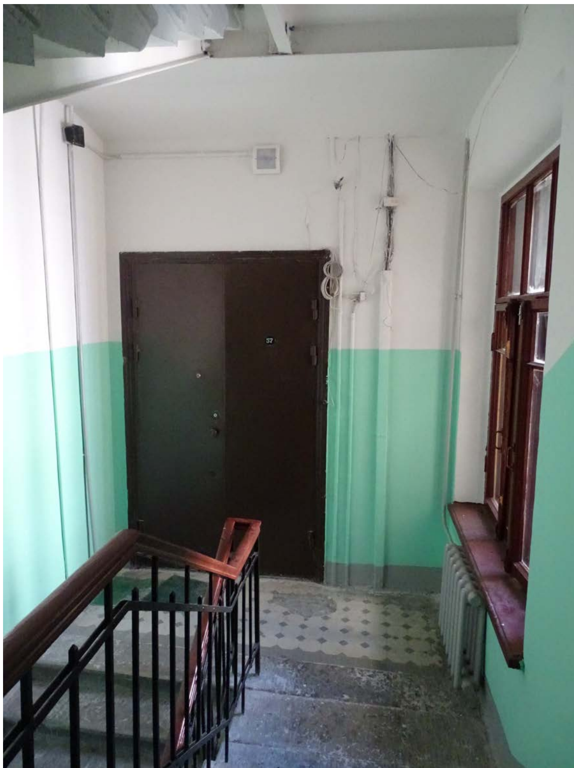
Фото 8. Вид на площадку 3-го этажа. Съемка 19.04.2021 г. Штиглиц М. С.
