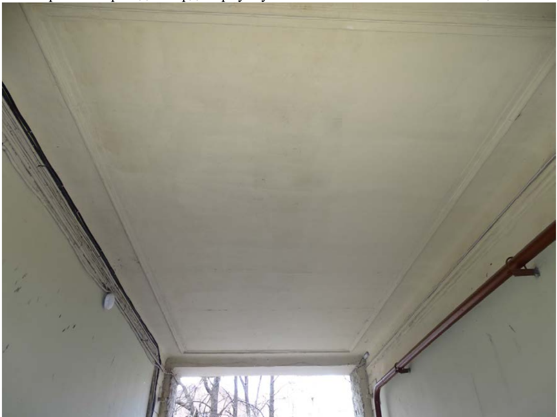
Фото 54. Здание по адресу: Большой проспект П.С., дом 69. Воротный проезд на Ординарную ул. Оформление перекрытия. Съемка 19.04.2021 г. Штиглиц М. С.
