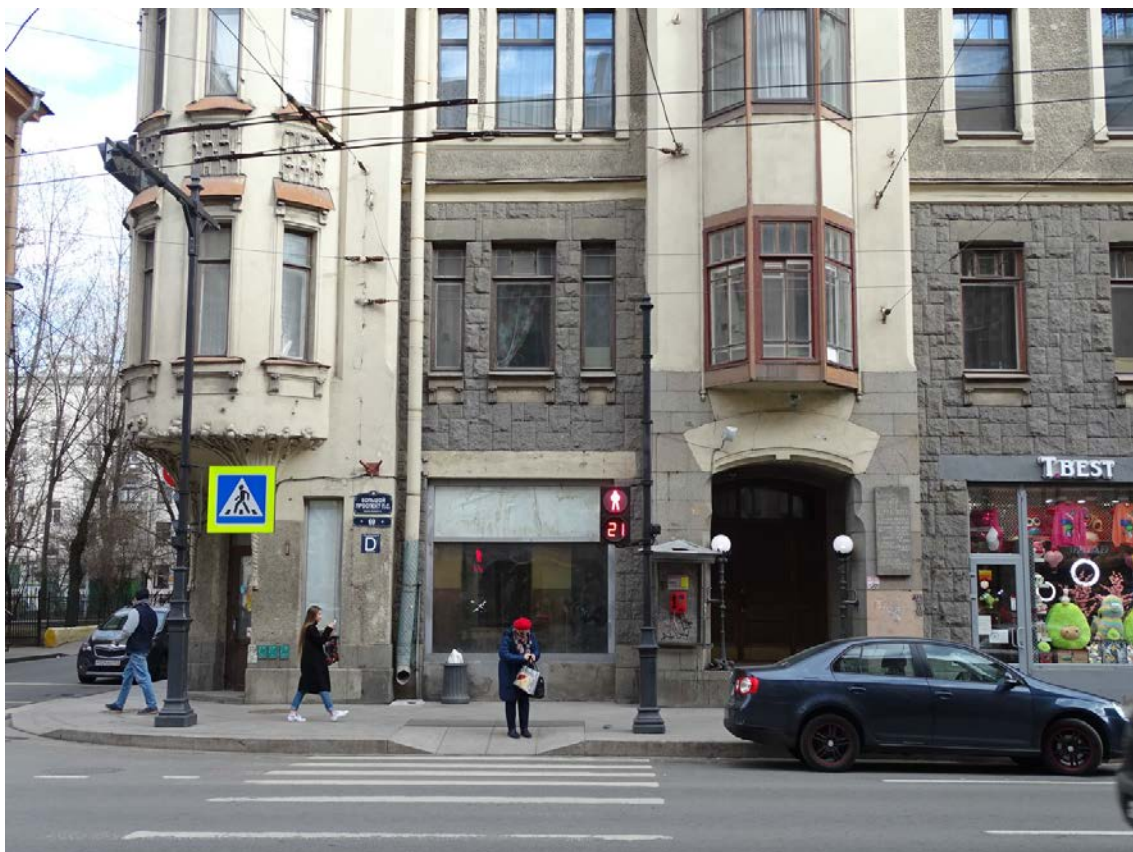
Фото 9. Здание по адресу: Большой проспект П.С., дом 69. Лицевой фасад по Большому пр. Фрагмент. Съемка 19.04.2021 г. Штиглиц М. С.
