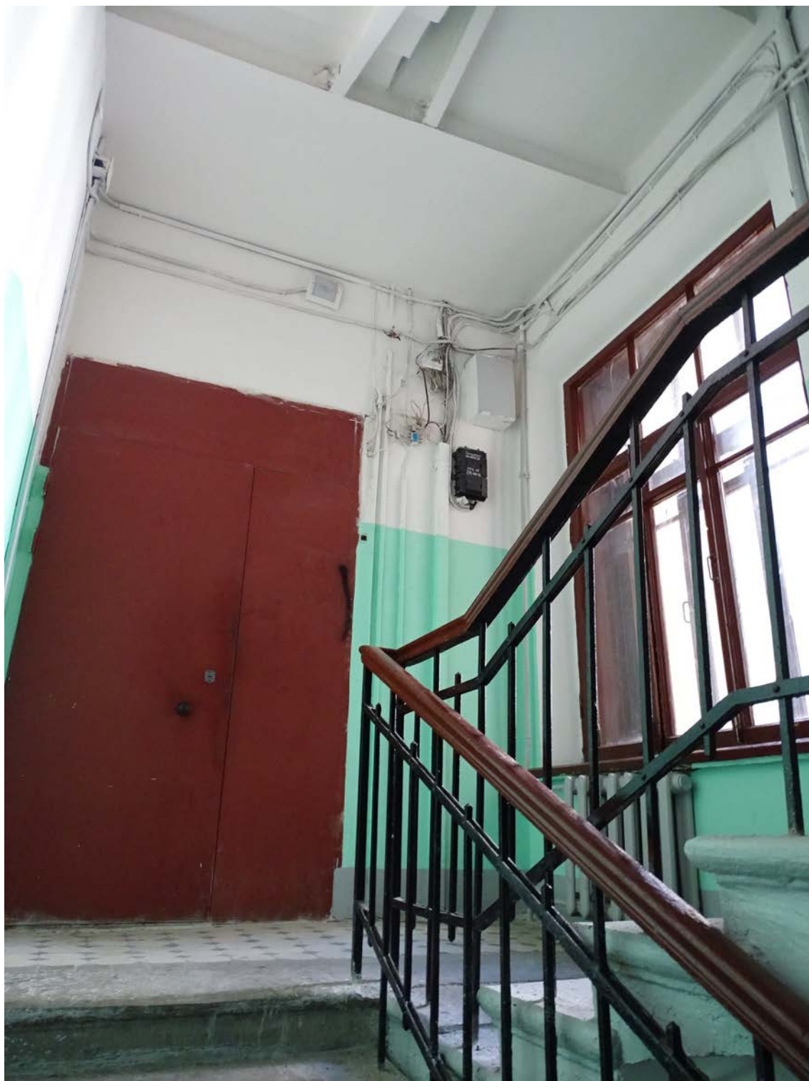
Фото 5. Вид на площадку 2-го этажа. Съемка 19.04.2021 г. Штиглиц М. С.
