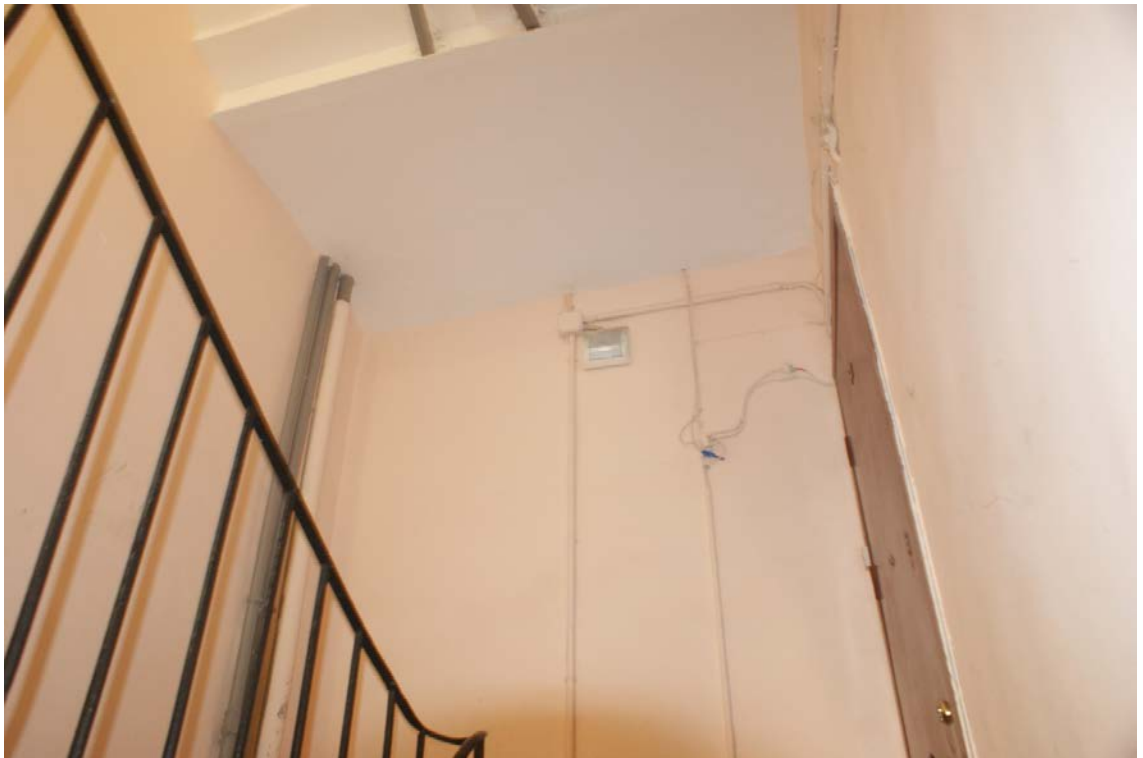
Фото 9. Вид на площадку между 3-м и 4-м этажом. Съёмка 19.04.2021 г. Штиглиц М. С.
