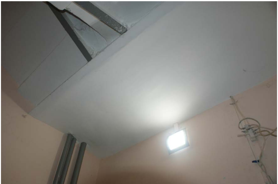
Фото 4. Площадка между 1-м и 2-м этажом. Съёмка 19.04.2021 г. Штиглиц М. С
