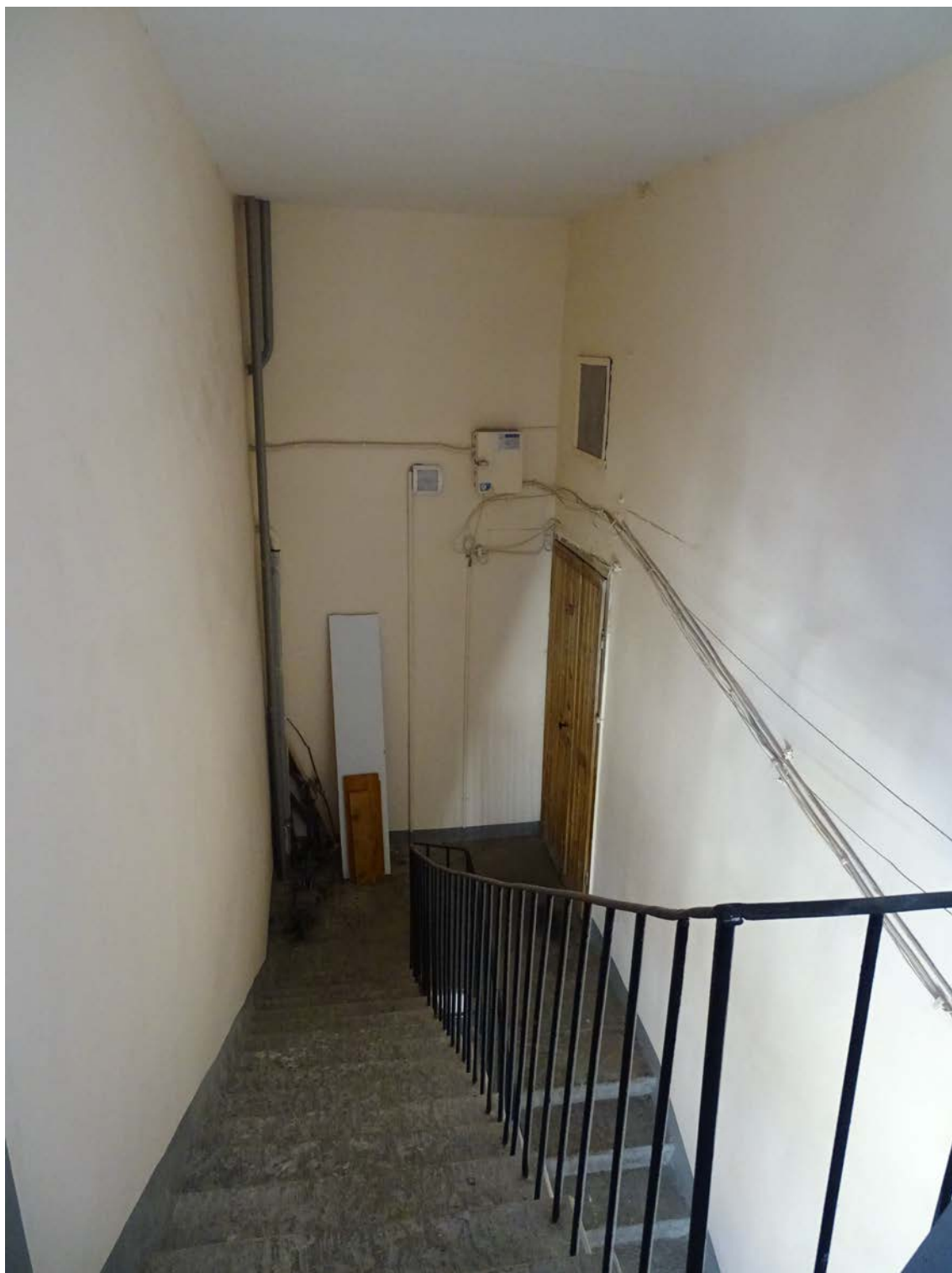
Фото 15. Площадка 6-го этажа. Съемка 19.04.2021 г. Штиглиц М. С.
