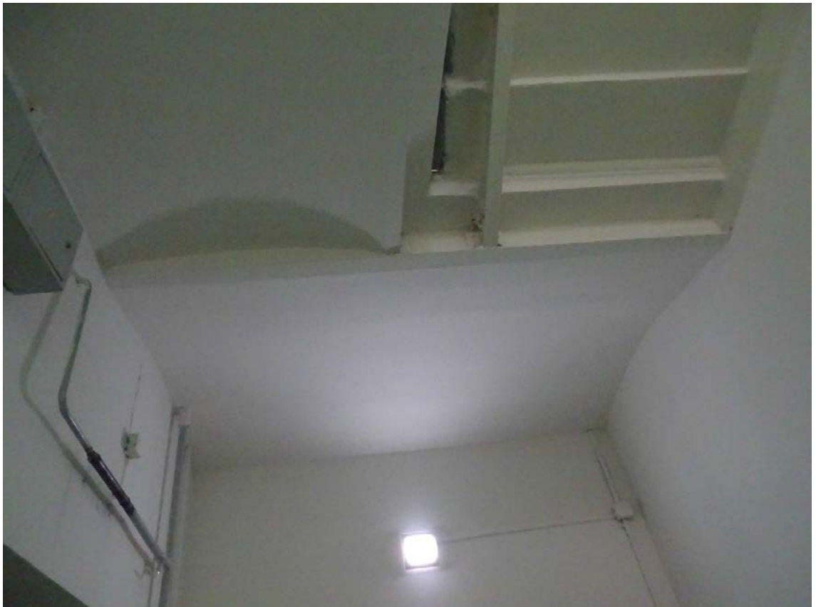
Фото 13. Площадка между 3-м и 4-м этажом. Съемка 19.04.2021 г. Штиглиц М. С.
