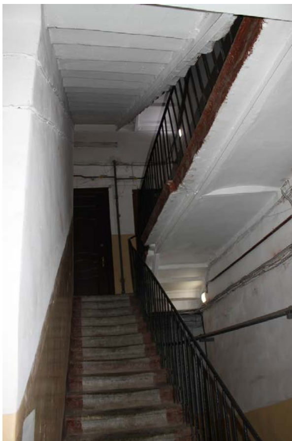
Фото 4. Вид на площадку между 1-м и 2-м этажом. Съёмка 19.04.2021 г. Штиглиц М. С.
