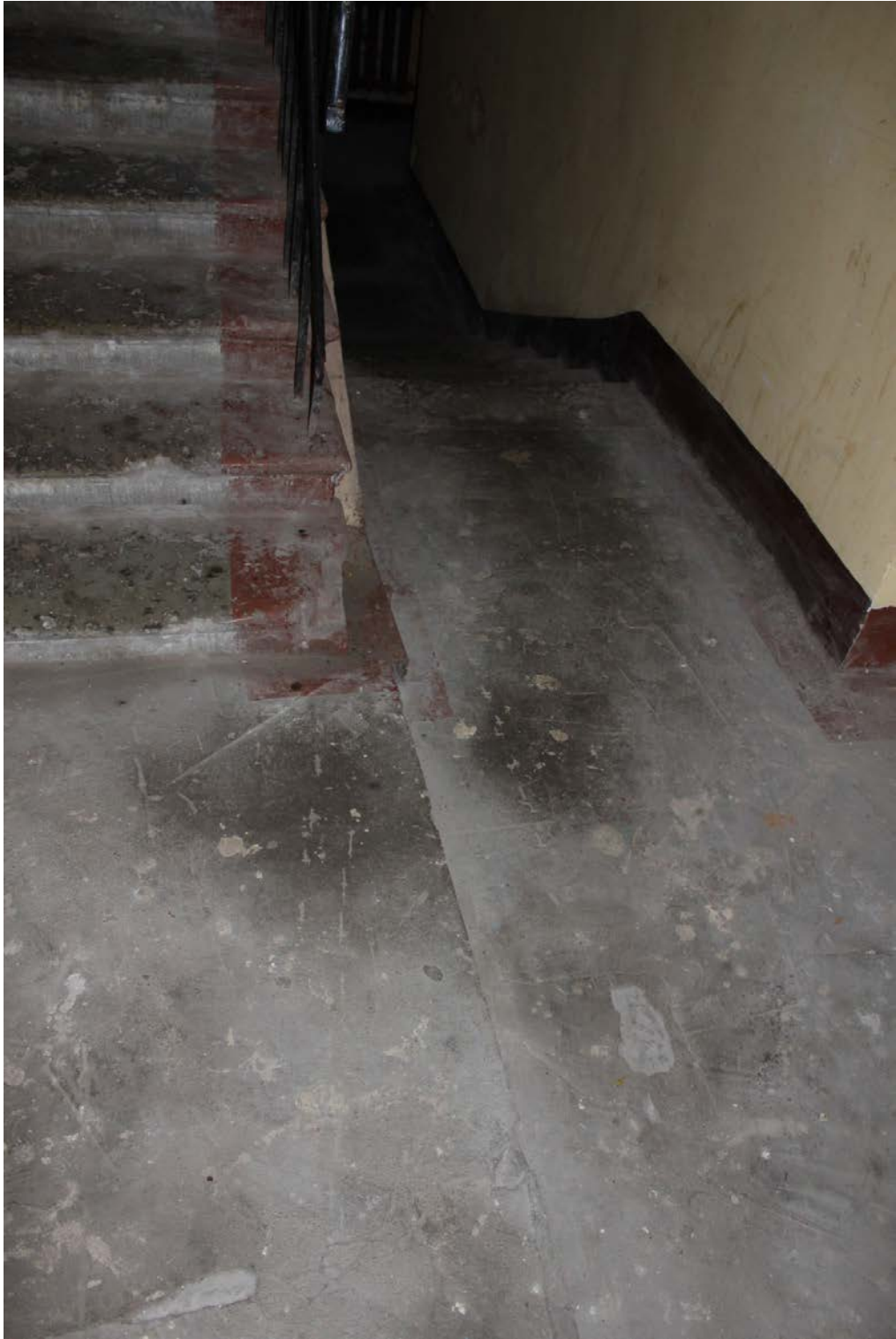
Фото 3. Площадка 1-го этажа. Покрытие пола. Съемка 19.04.2021 г. Штиглиц М. С.
