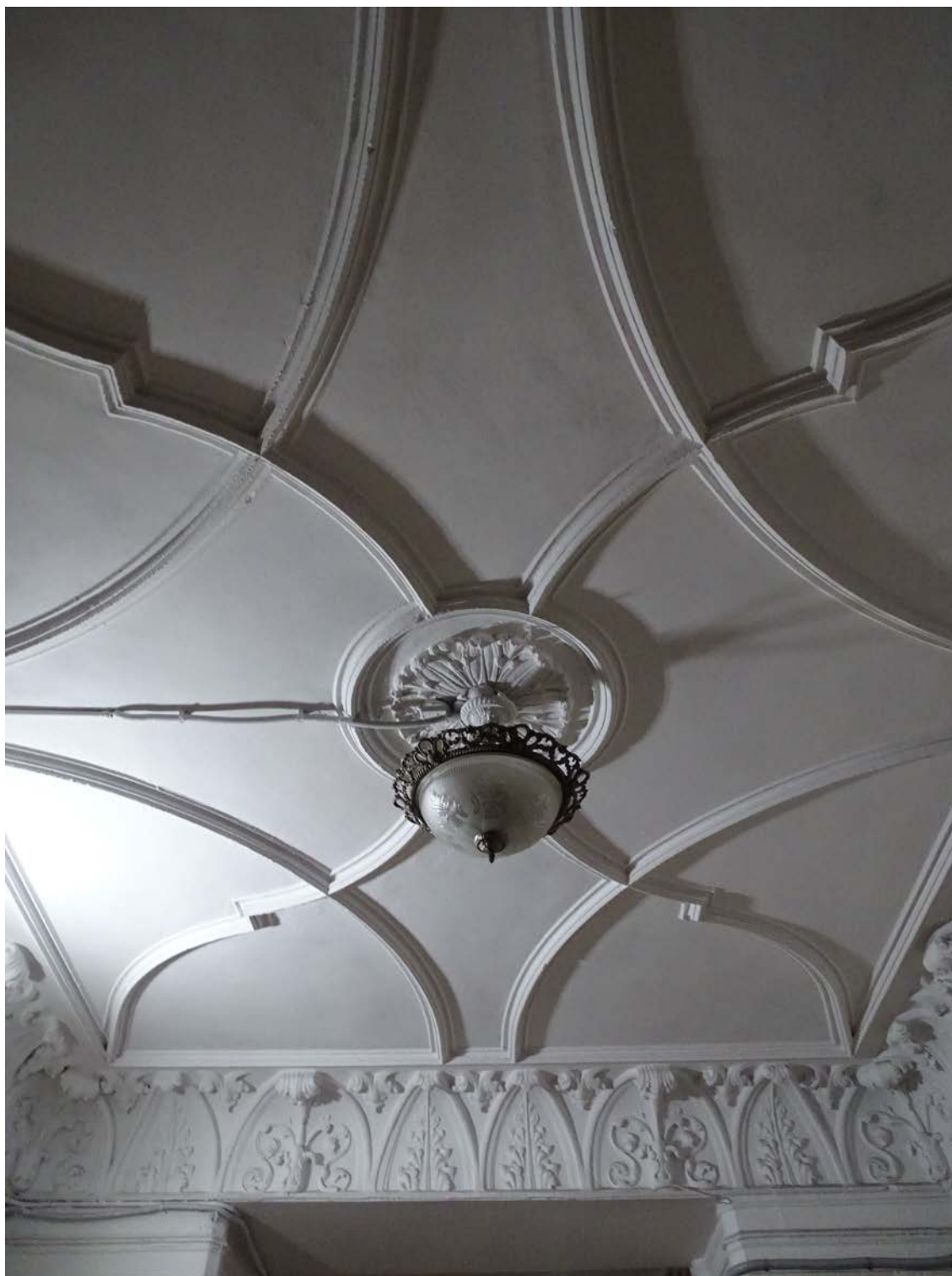
Фото 40. Вестибюль 1-го этажа. Перекрытие вестибюля. Съемка 19.04.2021 г. Штиглиц М. С.
