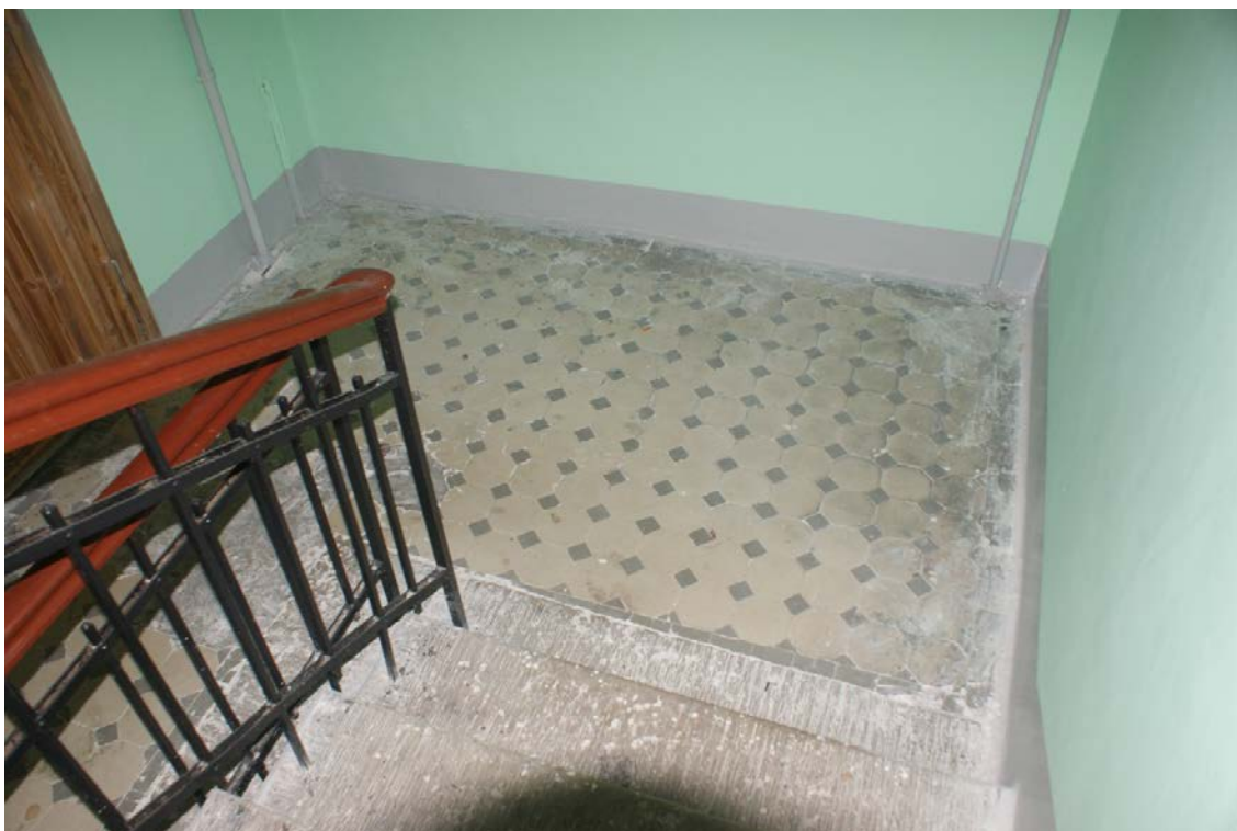
Фото 17. Площадка между 4-м и 5-м этажом. Съемка 19.04.2021 г. Штиглиц М. С.
