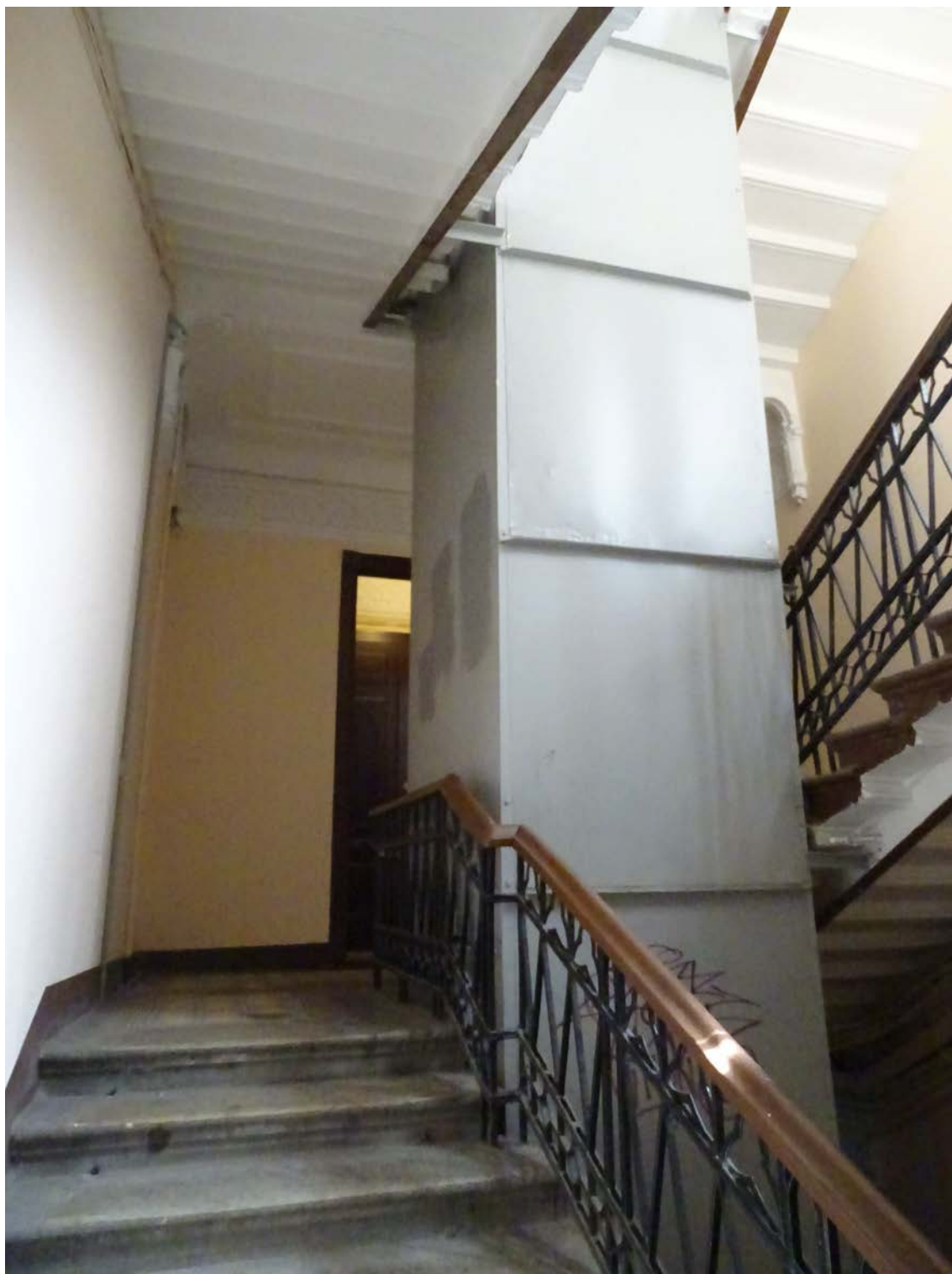
Фото 48. Вид на площадку 2-го этажа. Съемка 19.04.2021 г. Штиглиц М. С.
