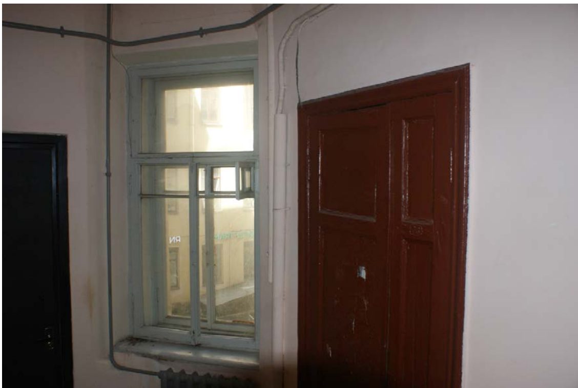
Фото 8. Площадка 3-го этажа. Съёмка 19.04.2021 г. Штиглиц М. С.
