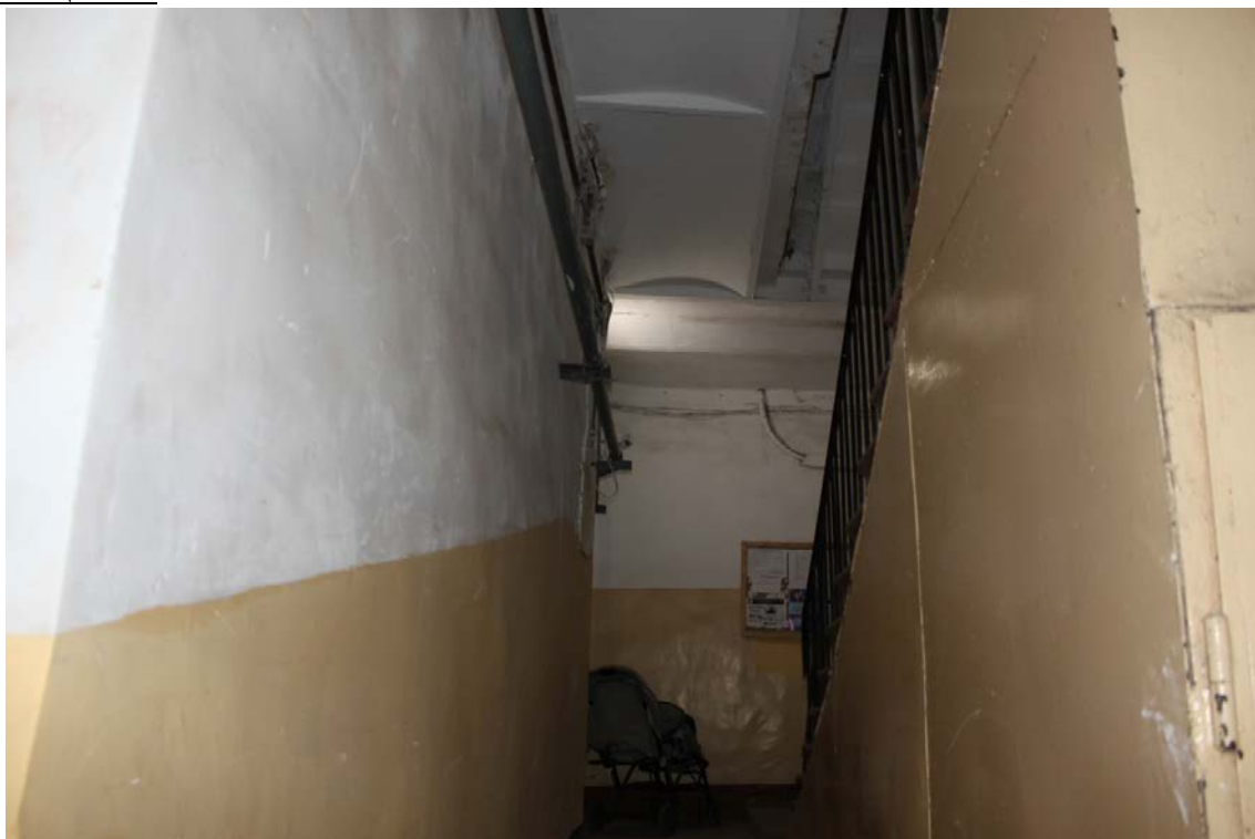
Фото 1. Площадка 1-го этажа. Съемка 19.04.2021 г. Штиглиц М. С.
