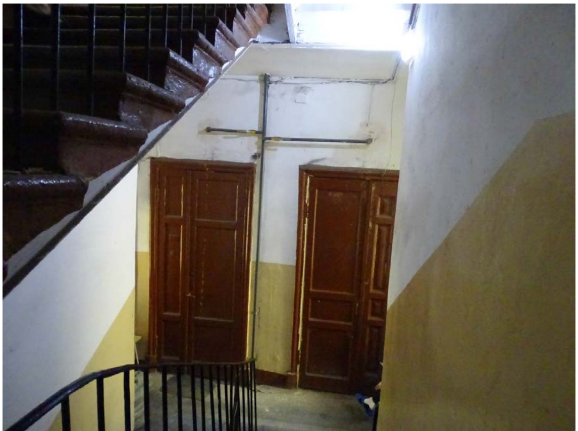
Фото 16. Площадка между 3-м и 4-м этажом. Съемка 19.04.2021 г. Штиглиц М. С.
