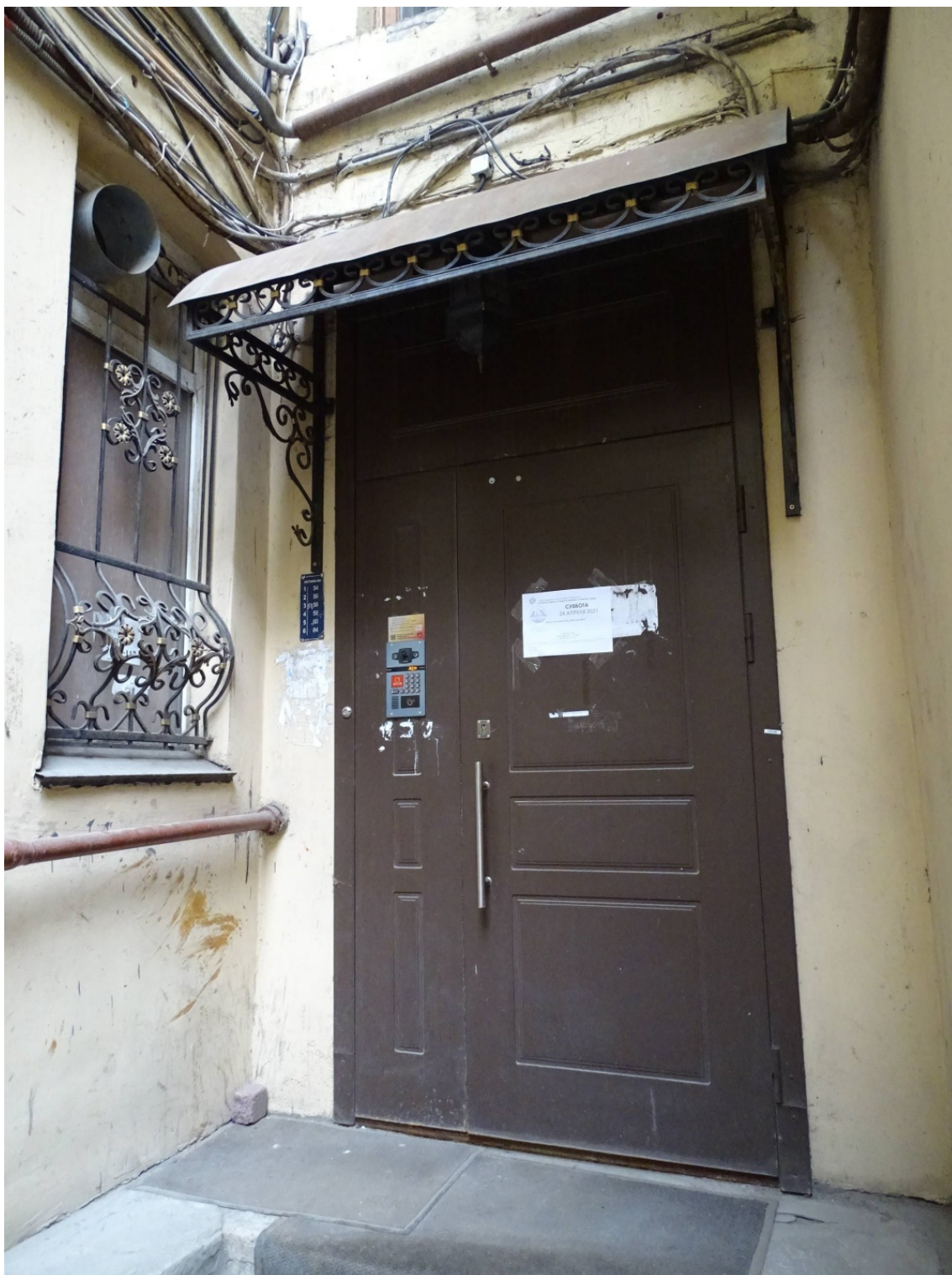
Фото 40. Здание по адресу: Большой проспект П.С., дом 69. Южный внутренний двор. Лестница № 4. Съемка 19.04.2021 г. Штиглиц М. С.
