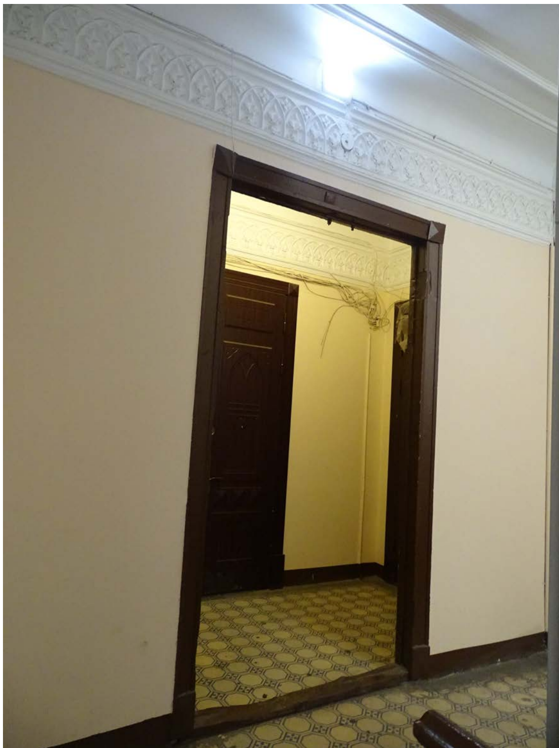
Фото 49. Площадка 2-го этажа. Съемка 19.04.2021 г. Штиглиц М. С.
