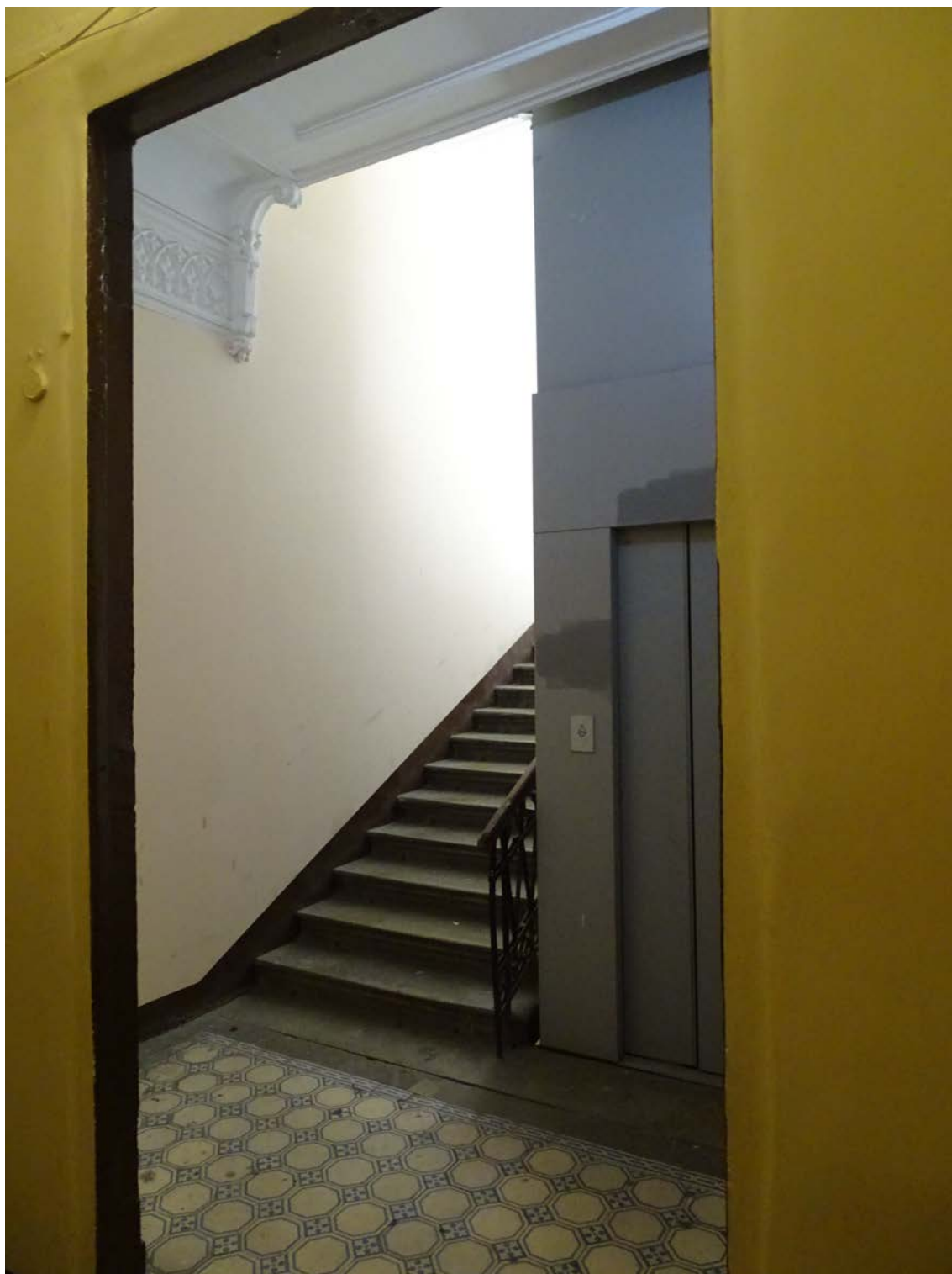
Фото 52. Площадка 2-го этажа. Съемка 19.04.2021 г. Штиглиц М. С.
