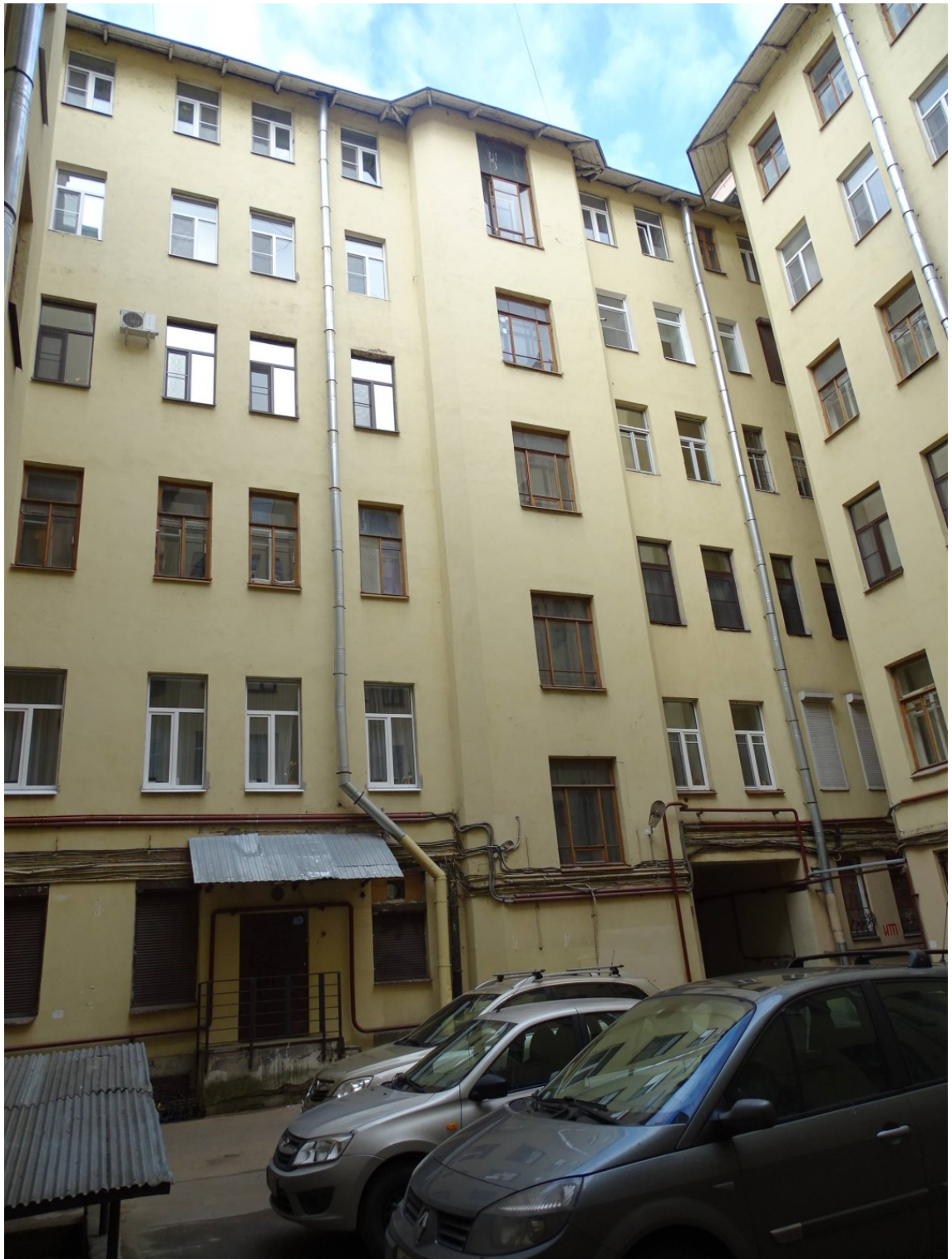
Фото 38. Здание по адресу: Большой проспект П.С., дом 69. Южный внутренний двор. Фрагмент фасада. Съемка 19.04.2021 г. Штиглиц М. С.
