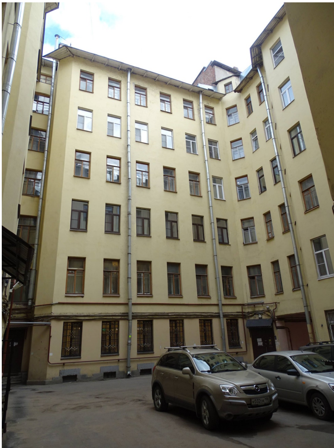
Фото 39. Здание по адресу: Большой проспект П.С., дом 69. Южный внутренний двор. Фрагмент фасада. Съемка 19.04.2021 г. Штиглиц М. С.
