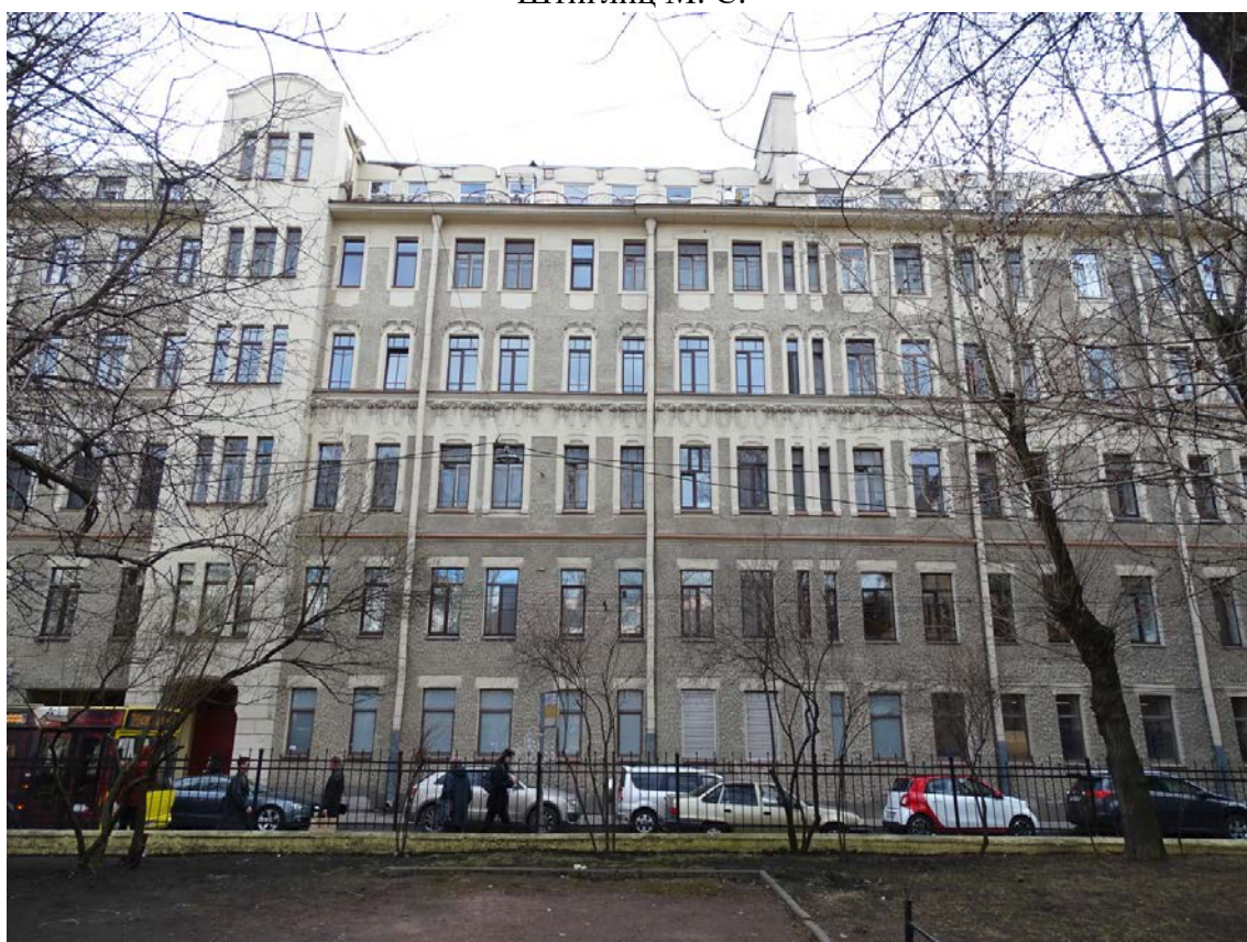
Фото 21 Здание по адресу: Большой проспект П.С., дом 69. Лицевой фасад по Ординарной ул. Фрагмент фасада. Съемка 19.04.2021 г. Штиглиц М. С.
