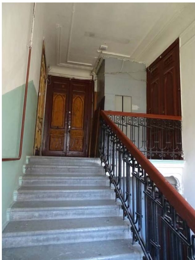
Фото 23. Площадка между 5-м и 6-м этажом. Съемка 19.04.2021 г. Штиглиц М. С.
