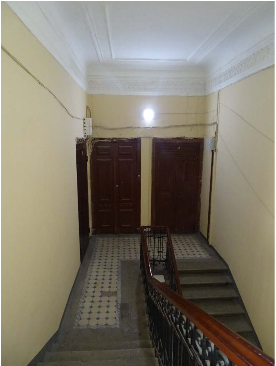
Фото 20. Площадка между 5-м и 6-м этажом. Съемка 19.04.2021 г. Штиглиц М. С.
