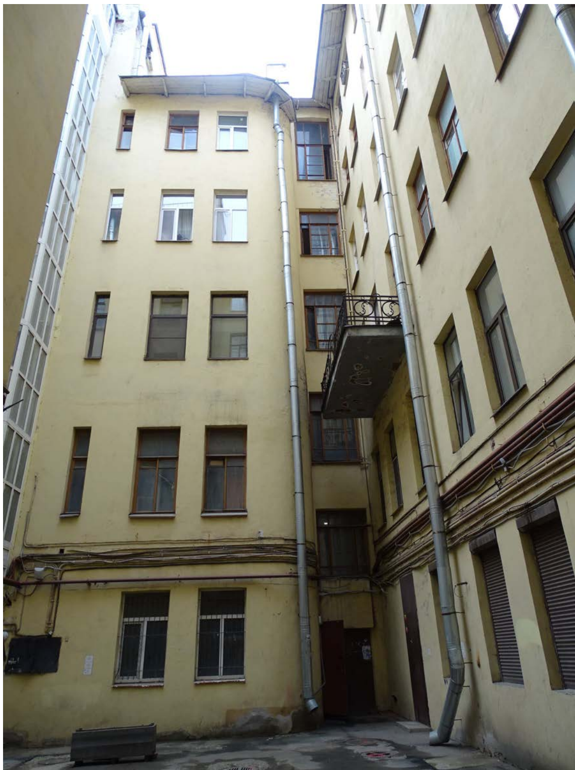
Фото 44. Здание по адресу: Большой проспект П.С., дом 69. Западный внутренний двор. Съемка 19.04.2021 г. Штиглиц М. С.
