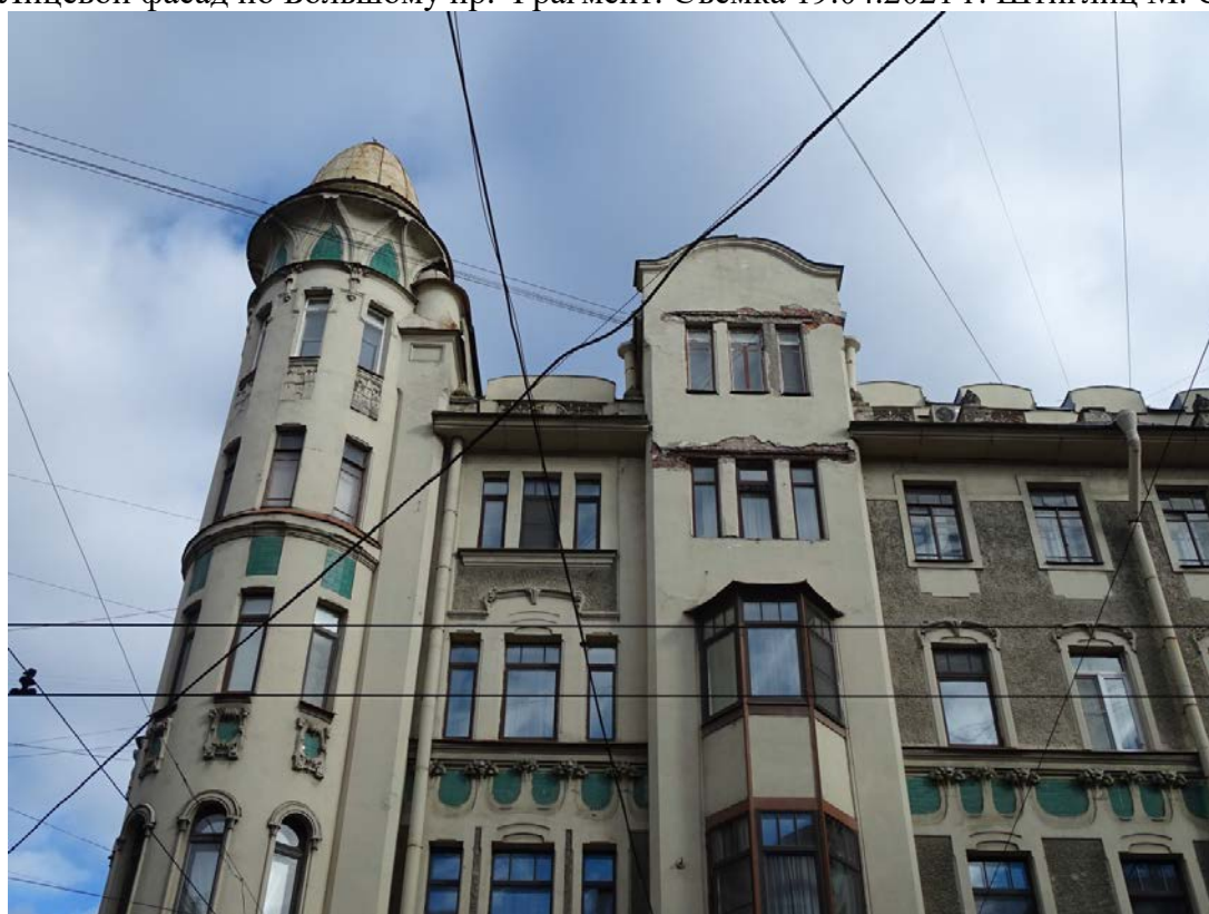
Фото 8. Здание по адресу: Большой проспект П.С., дом 69. Лицевой фасад по Большому пр. Фрагмент. Съемка 19.04.2021 г. Штиглиц М. С.
