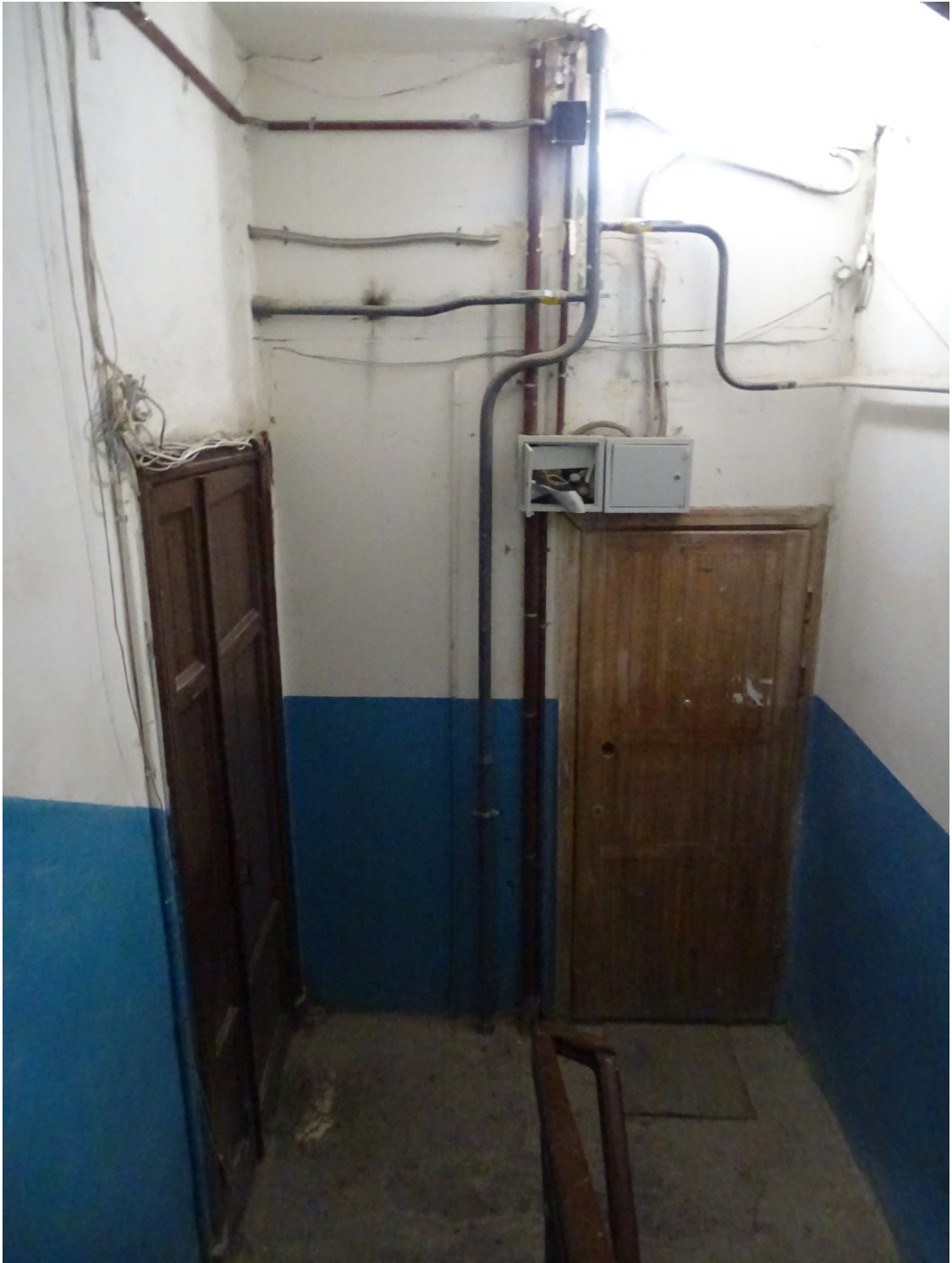
Фото 9. Вид на площадку 3-го этажа. Съемка 19.04.2021 г. Штиглиц М. С.
