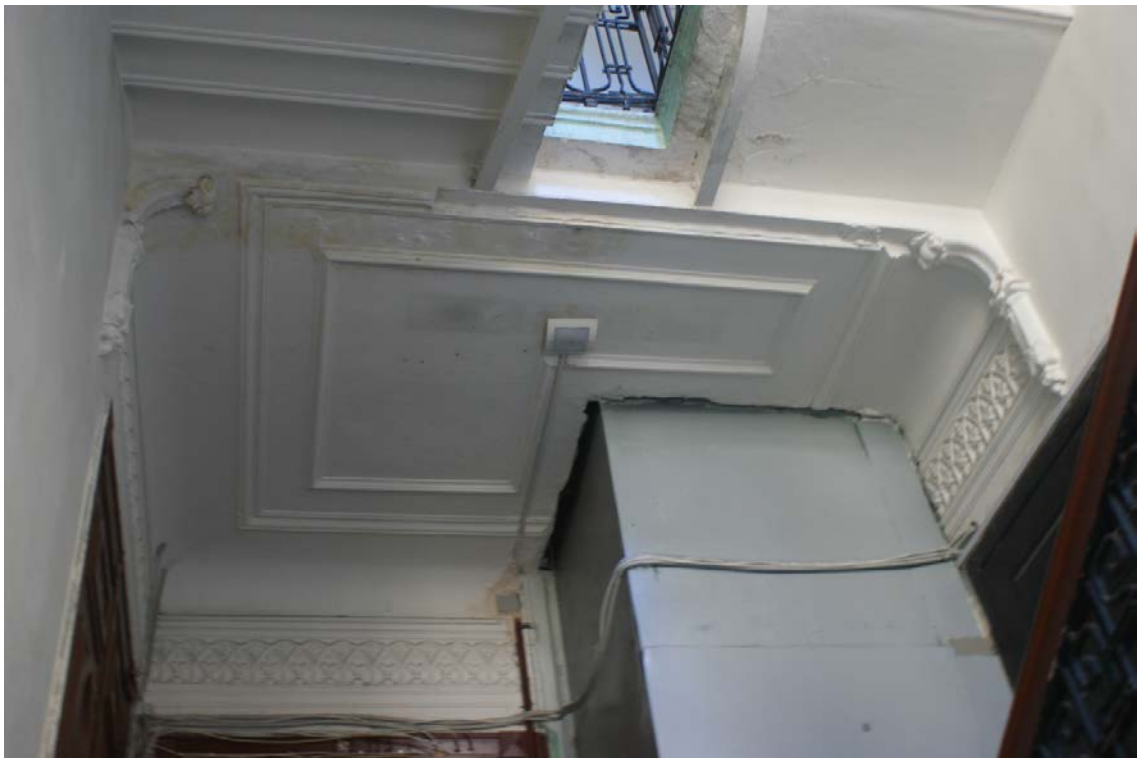
Фото 13. Площадка 3-го этажа. Оформление потолка. Съемка 19.04.2021 г. Штиглиц М. С.
