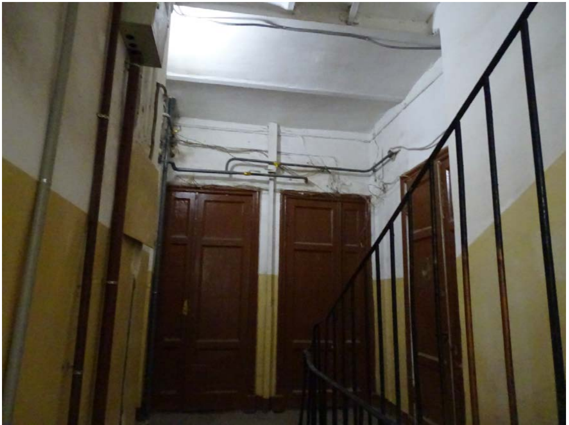
Фото 23. Вид на площадку 5-го этажа. Съемка 19.04.2021 г. Штиглиц М. С.
