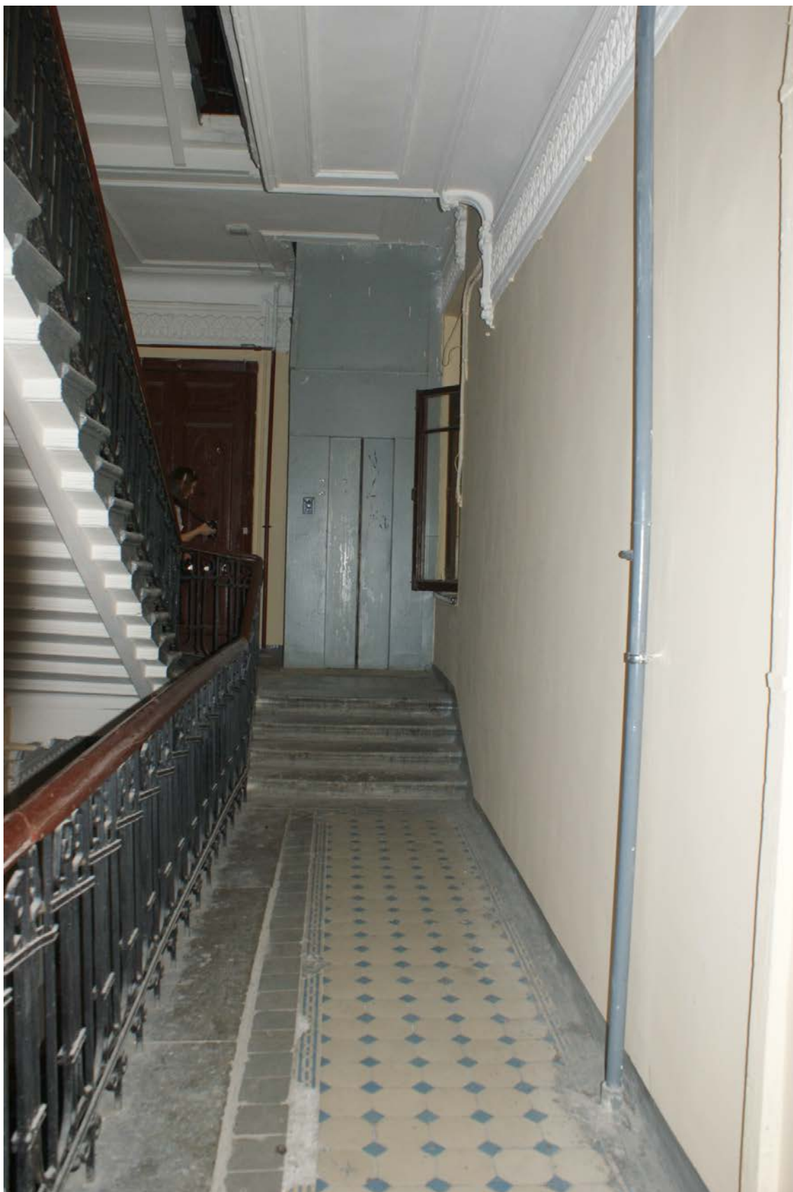
Фото 9. Вид на площадку 2-го этажа. Съемка 19.04.2021 г. Штиглиц М. С.
