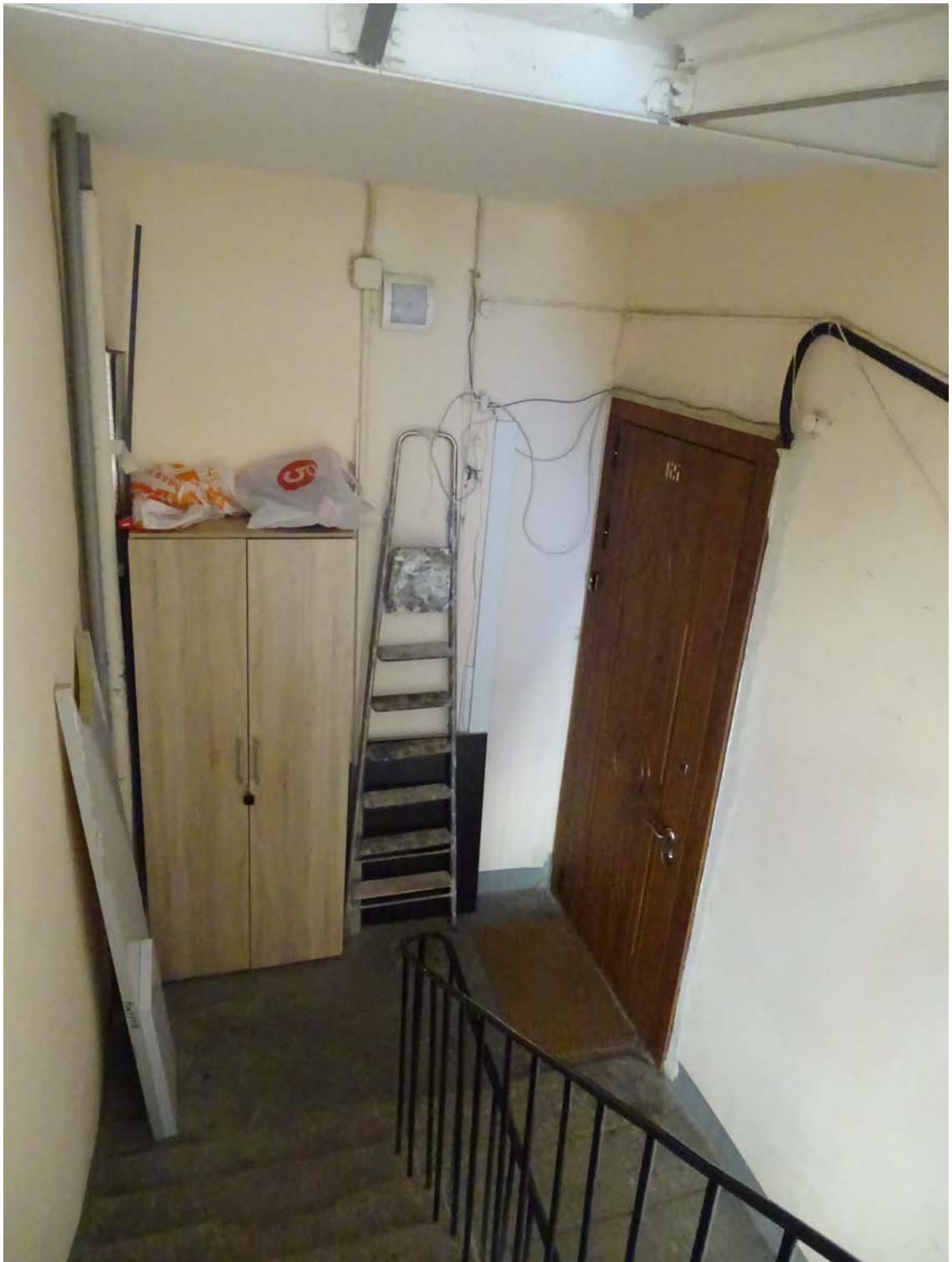
Фото 13. Площадка между 5-м и 6-м этажом. Съемка 19.04.2021 г. Штиглиц М. С.
