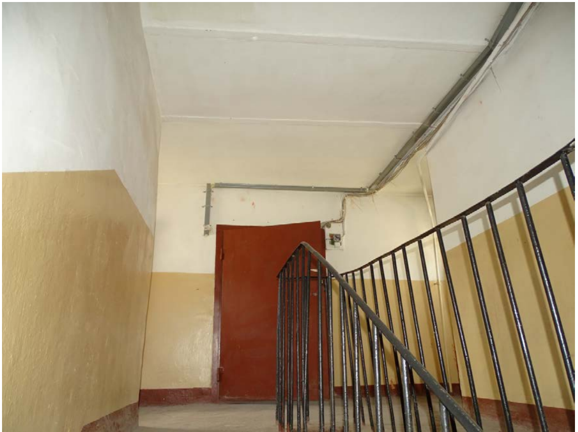
Фото 31. Площадка между 6-м и чердачным этажом. Съемка 19.04.2021 г. Штиглиц М. С.
