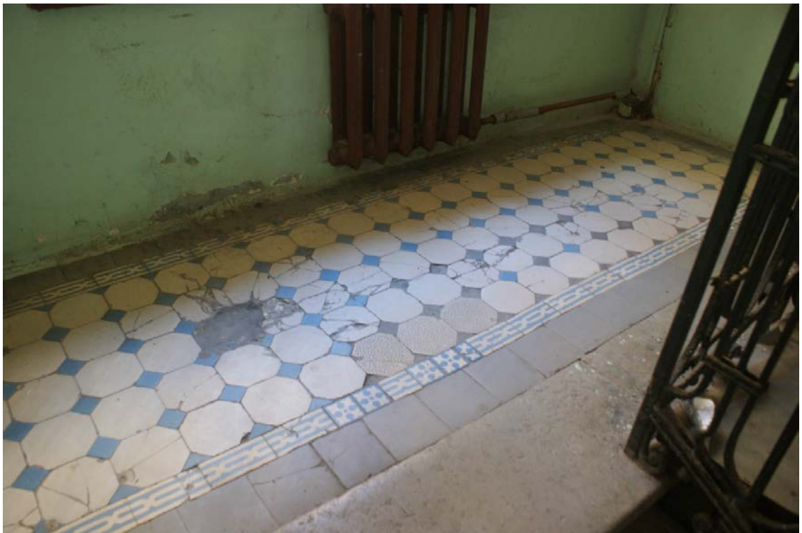
Фото 70. Площадка между 1-м и 2-м этажом. Съемка 19.04.2021 г. Штиглиц М. С.
