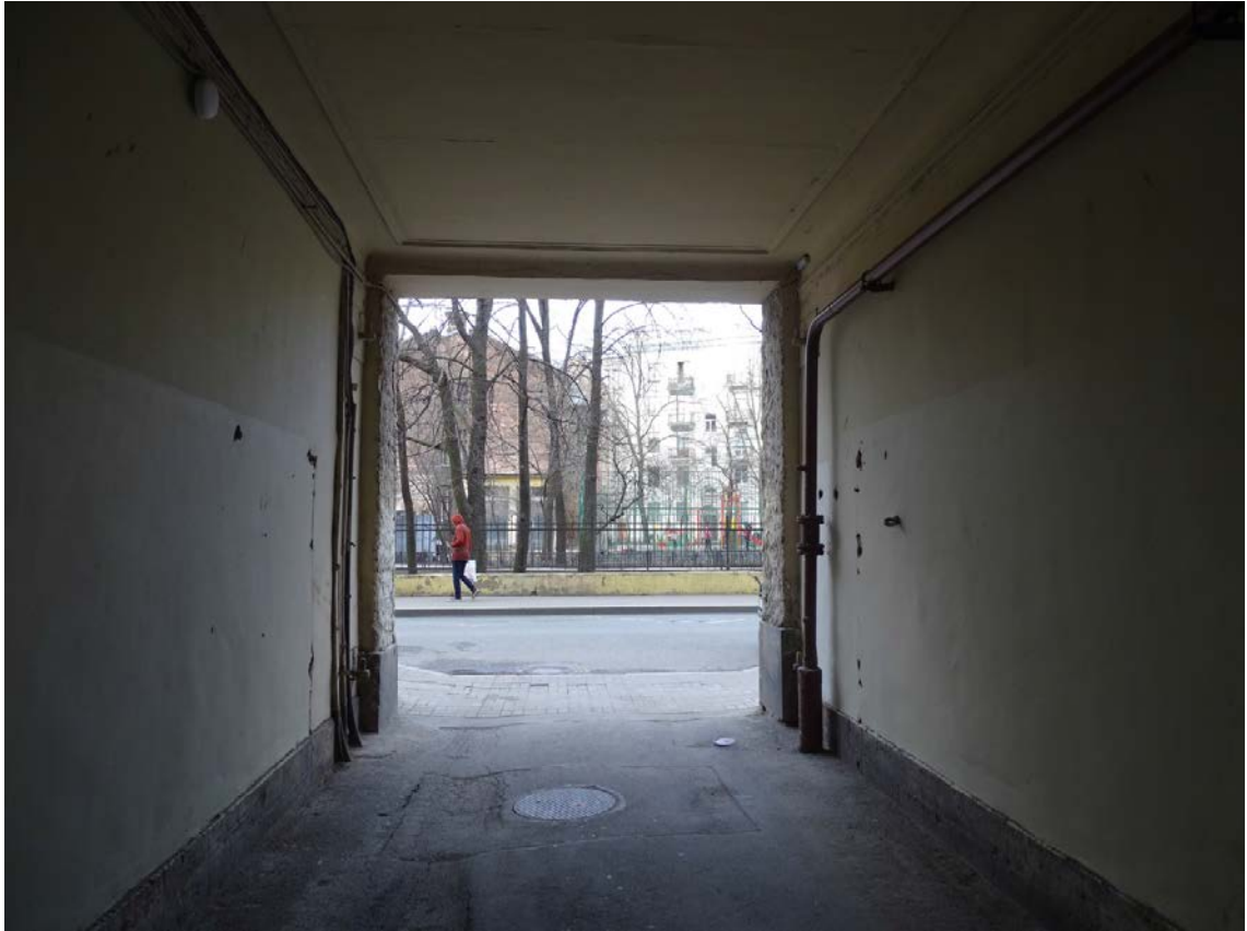
Фото 53. Здание по адресу: Большой проспект П.С., дом 69. Воротный проезд на Ординарную ул. Съемка 19.04.2021 г. Штиглиц М. С.
