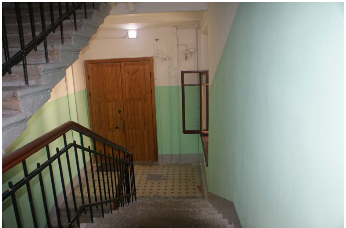
Фото 14. Вид на площадку 4-го этажа. Съемка 19.04.2021 г. Штиглиц М. С.
