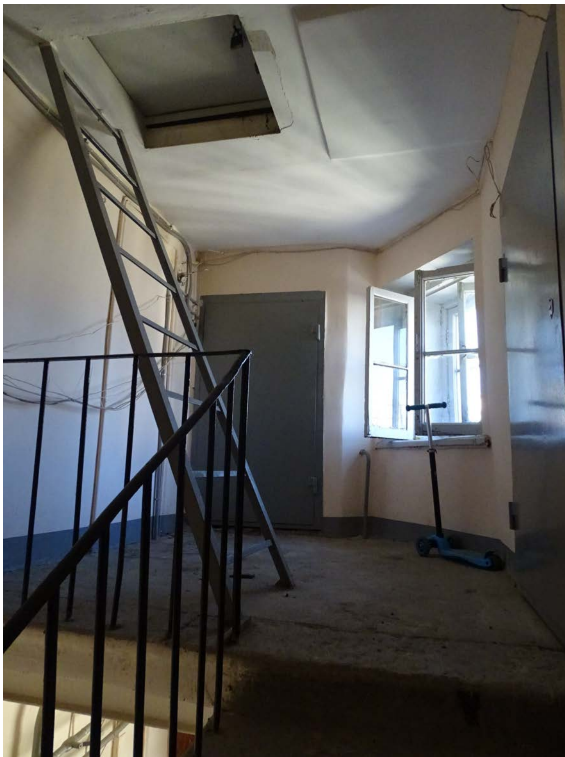
Фото 16. Площадка технического этажа. Выход на чердак. Съемка 19.04.2021 г. Штиглиц М. С.
