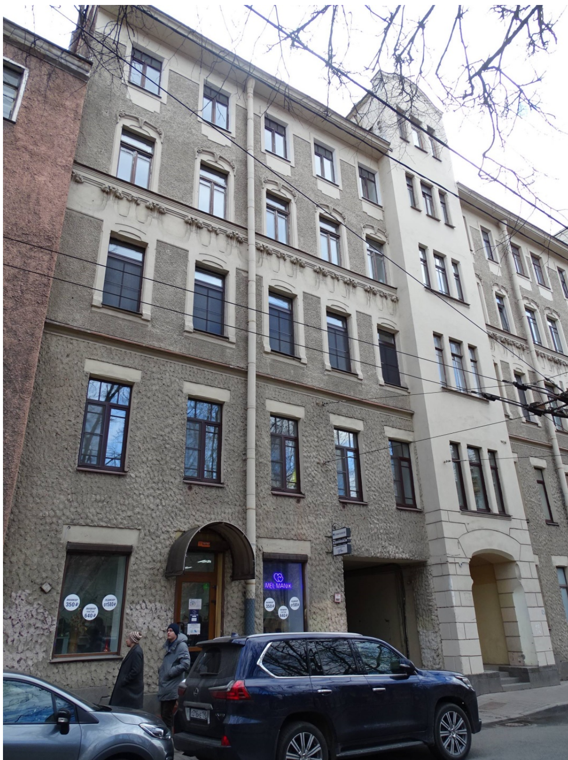
Фото 26. Здание по адресу: Большой проспект П.С., дом 69. Лицевой фасад по Ординарной ул. Фрагмент фасада. Съемка 19.04.2021 г. Штиглиц М. С.
