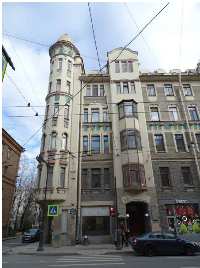
Фото 7 Здание по адресу: Большой проспект П.С., дом 69. Лицевой фасад по Большому пр. Фрагмент. Съемка 19.04.2021 г. Штиглиц М. С.
