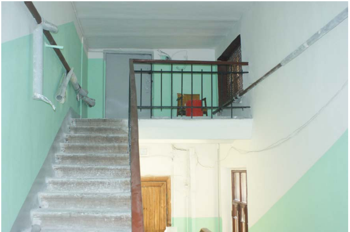
Фото 21. Вид на чердак. Съемка 19.04.2021 г. Штиглиц М. С.
