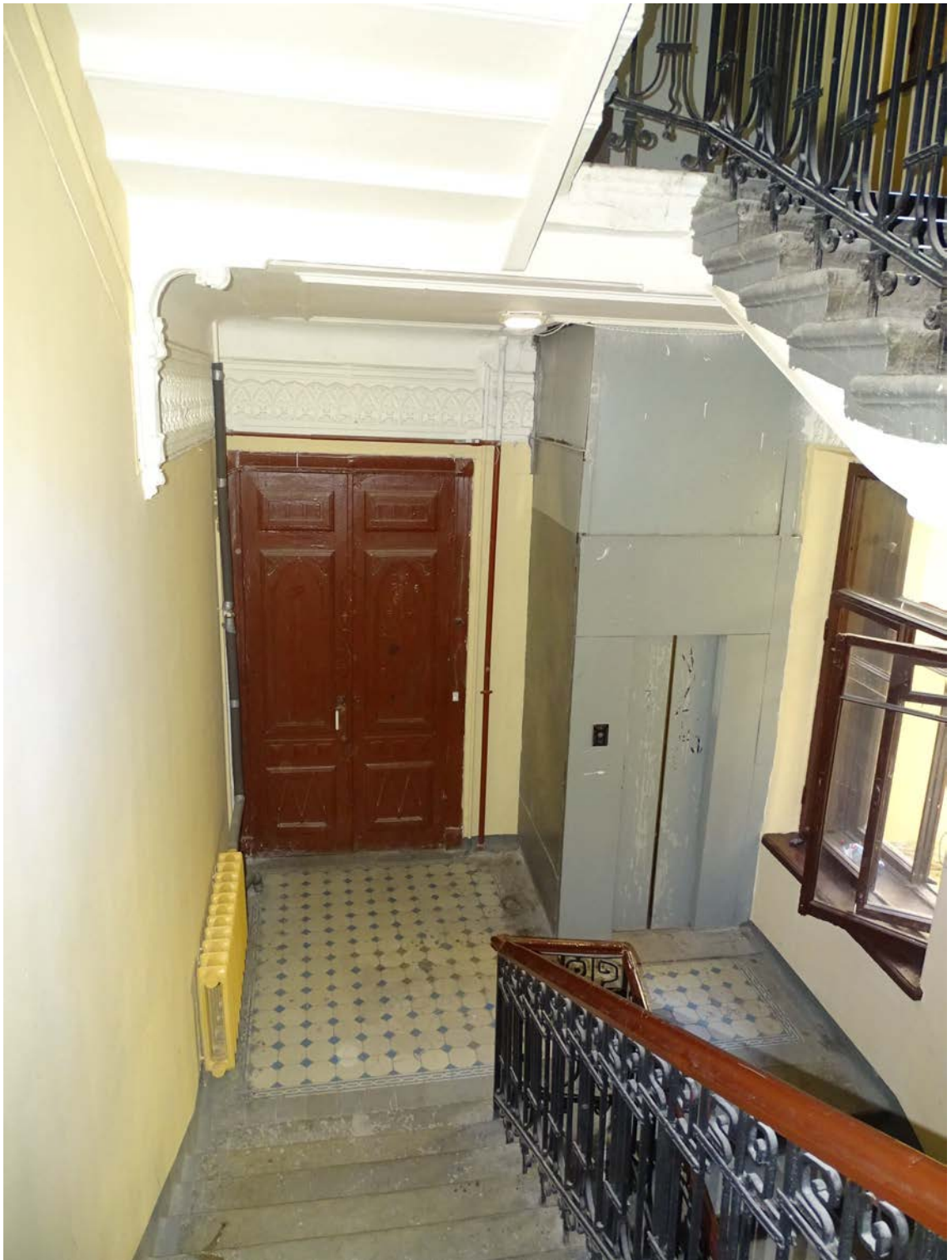
Фото 11. Площадка 2-го этажа. Съемка 19.04.2021 г. Штиглиц М. С.
