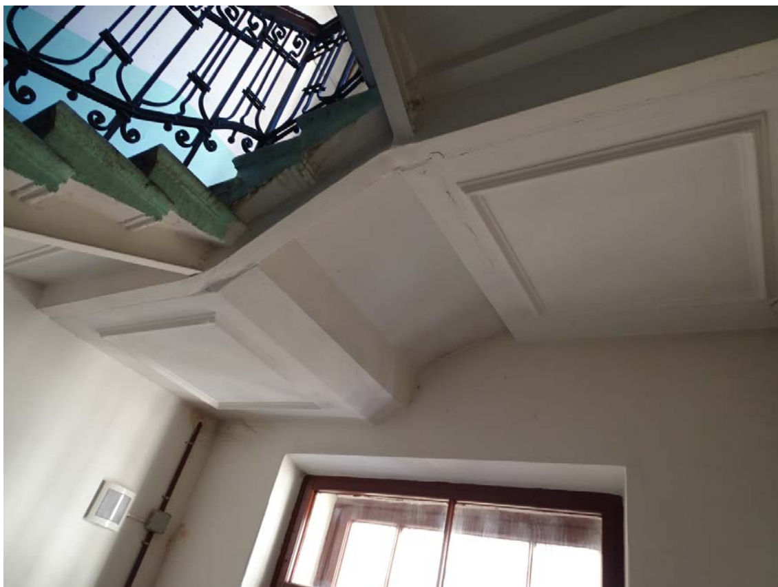
Фото 17. Площадка между 4-м и 5-мэтажом. Съемка 19.04.2021 г. Штиглиц М. С.
