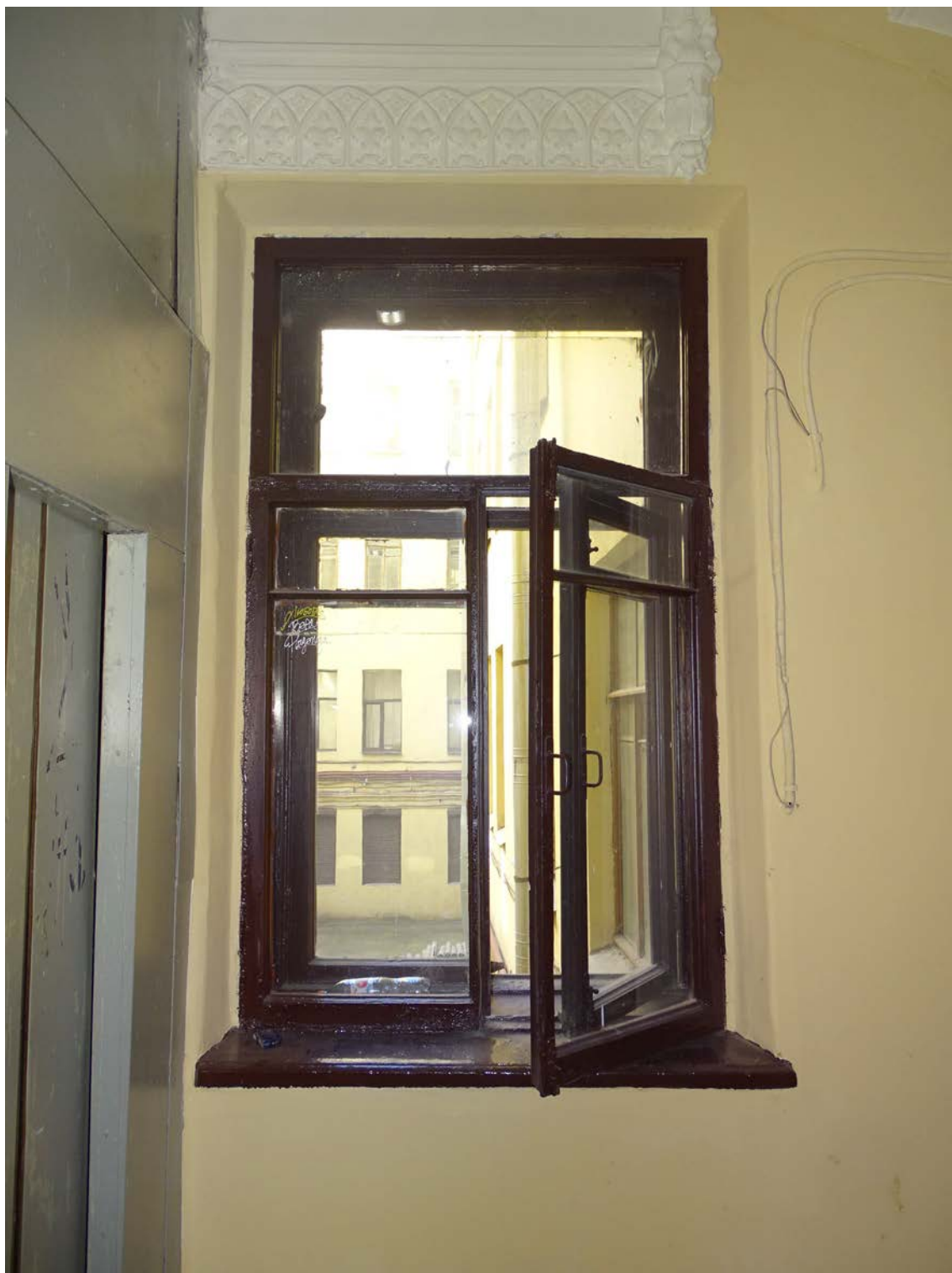
Фото 10. Площадка 2-го этажа. Съемка 19.04.2021 г. Штиглиц М. С.
