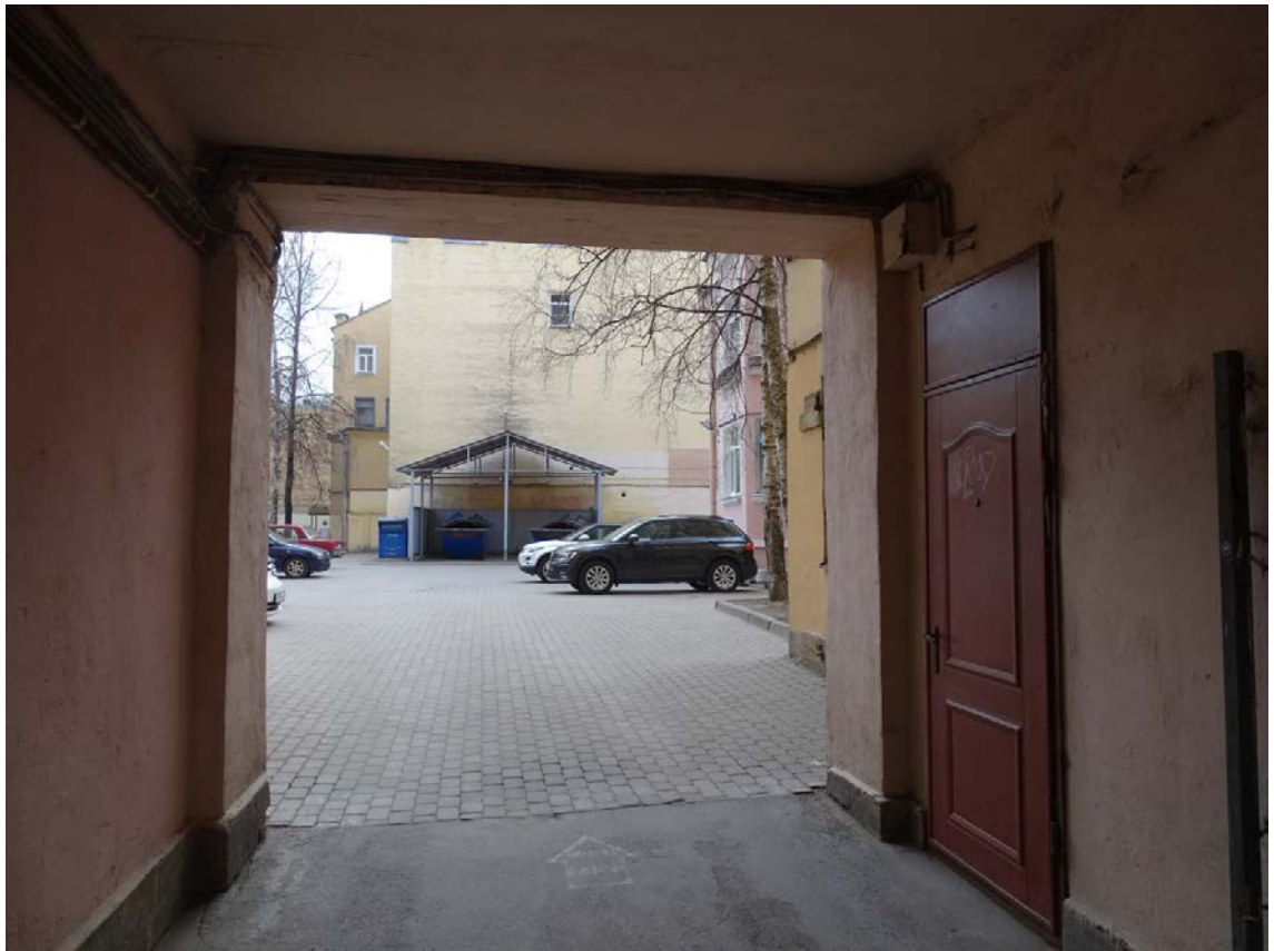
Фото 34. Здание по адресу: Большой проспект П.С., дом 69. Вид на юго-западный двор. Воротный проезд. Съемка 19.04.2021 г. Штиглиц М. С.
