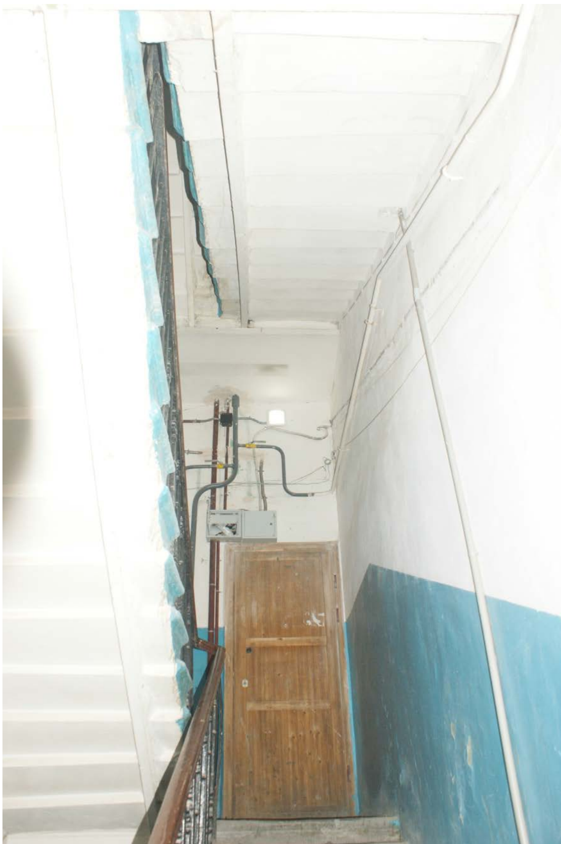
Фото 8. Вид на площадку 3-го этажа. Съемка 19.04.2021 г. Штиглиц М. С.
