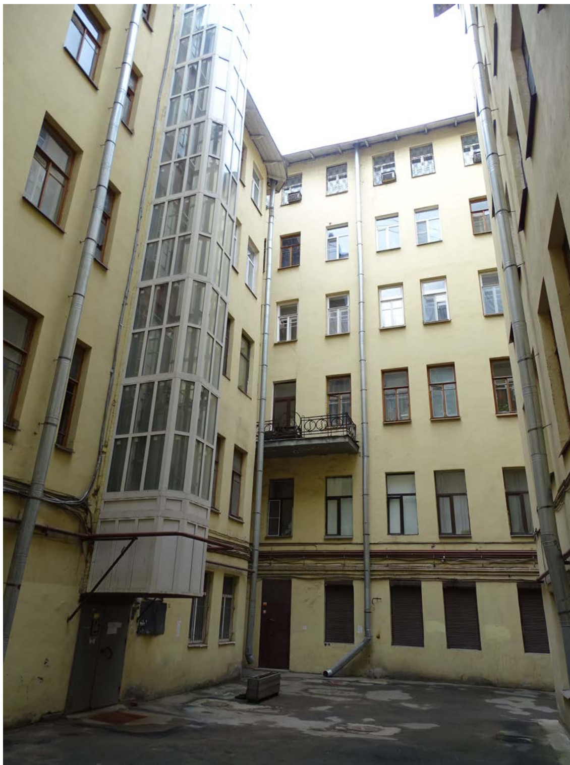
Фото 48. Здание по адресу: Большой проспект П.С., дом 69. Западный внутренний двор. Фрагмент фасада. Съемка 19.04.2021 г. Штиглиц М. С.
