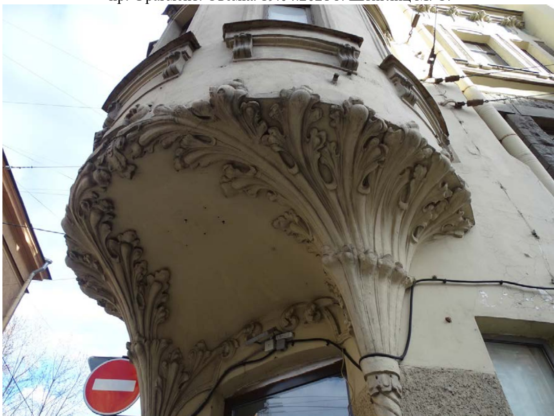
Фото 10. Здание по адресу: Большой проспект П.С., дом 69. Лицевой фасад по Большому пр. Кронштейн эркера с лепным декором. Съемка 19.04.2021 г. Штиглиц М. С.
