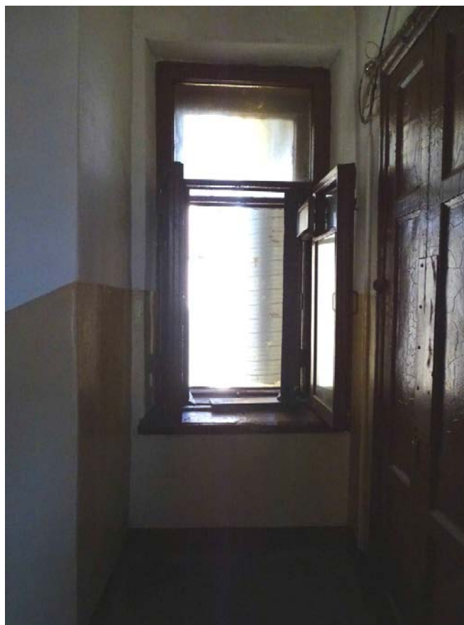
Фото 29. Вид на площадку между 5-м и 6-м этажом. Съемка 19.04.2021 г. Штиглиц М. С.
