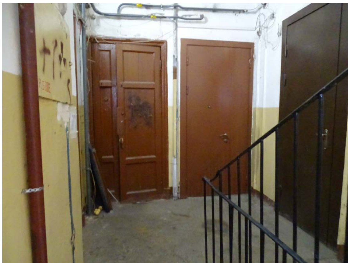
Фото 18. Площадка 4-го этажа. Съемка 19.04.2021 г. Штиглиц М. С.
