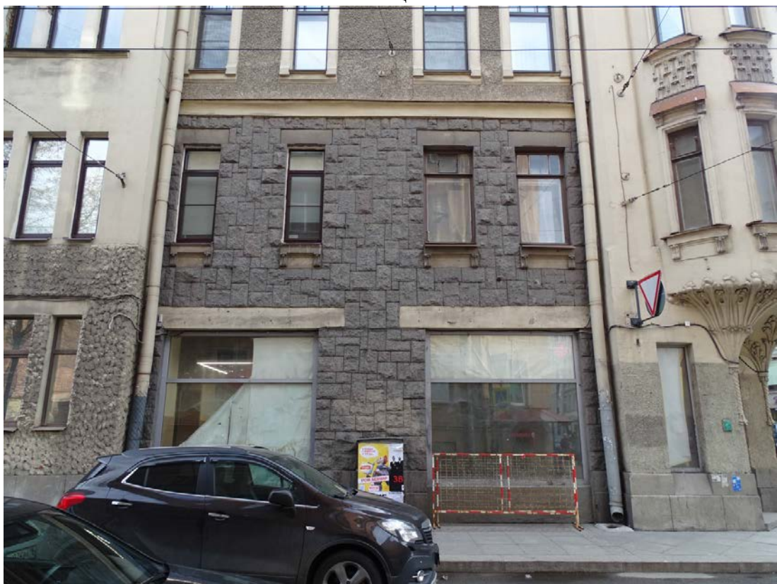
Фото 19. Здание по адресу: Большой проспект П.С., дом 69. Лицевой фасад по Ординарной ул. Фрагмент фасада. Съемка 19.04.2021 г. Штиглиц М. С.
