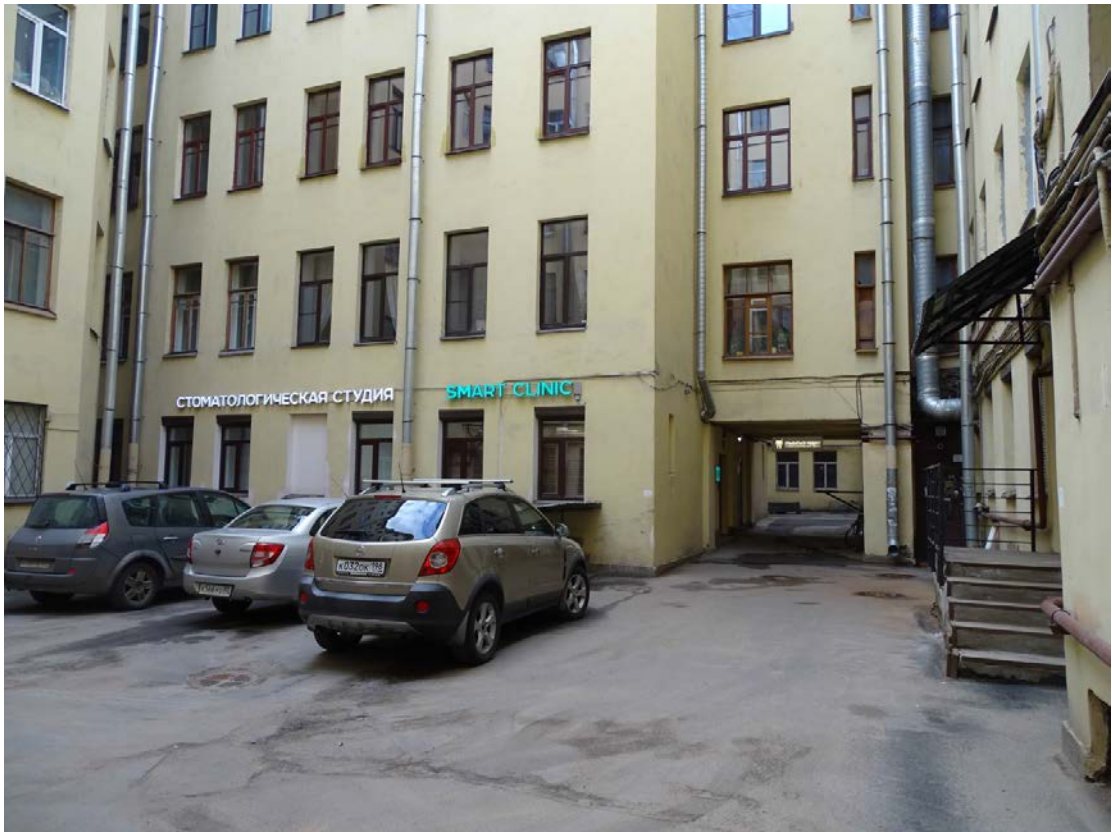
Фото 42. Здание по адресу: Большой проспект П.С., дом 69. Южный внутренний двор. Фрагмент фасада. Съемка 19.04.2021 г. Штиглиц М. С.
