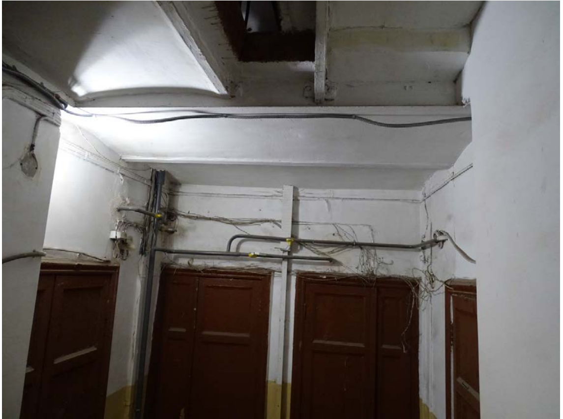
Фото 25. Площадка 5-го этажа. Съемка 19.04.2021 г. Штиглиц М. С.
