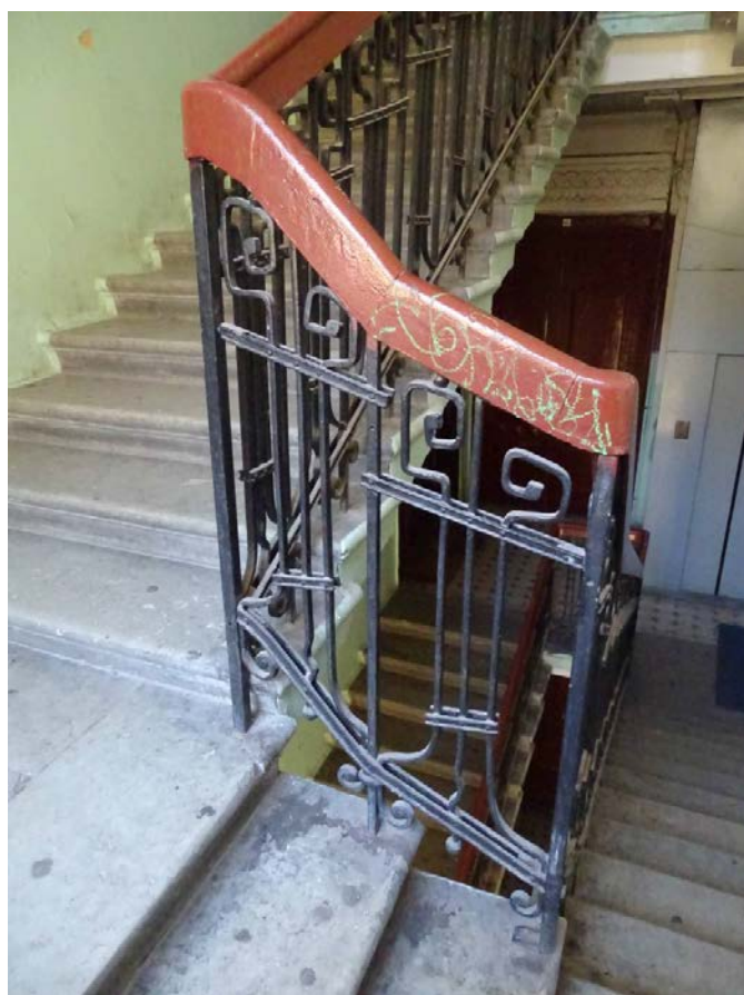
Фото 18. Площадка между 4-м и 5-мэтажом. Съемка 19.04.2021 г. Штиглиц М. С.
