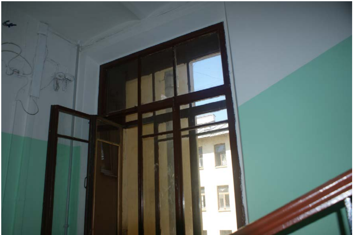
Фото 15. Площадка 4-го этажа. Съемка 19.04.2021 г. Штиглиц М. С.
