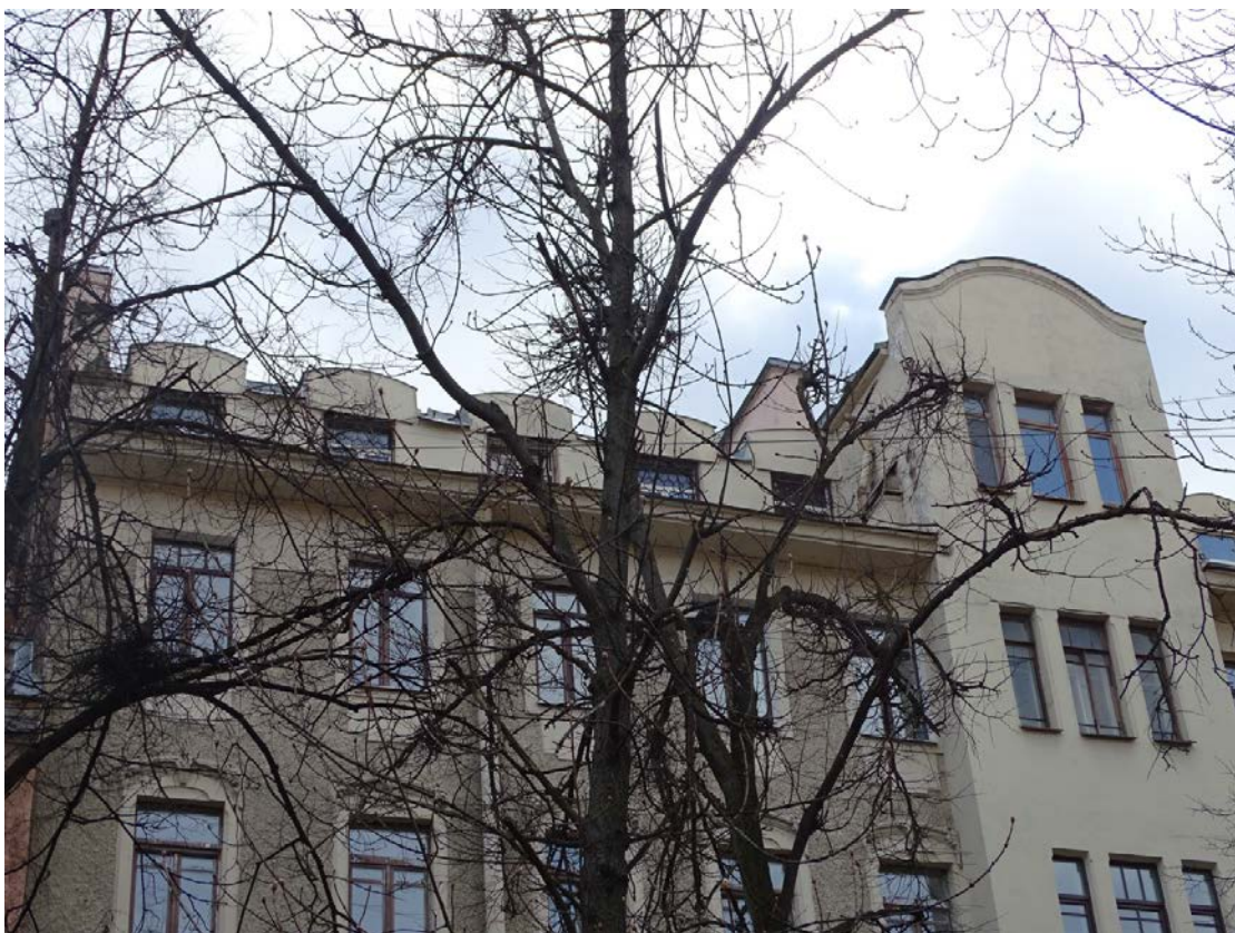
Фото 20. Здание по адресу: Большой проспект П.С., дом 69. Лицевой фасад по Ординарной ул. Фрагмент фасада. Съемка 19.04.2021 г. Штиглиц М. С.
