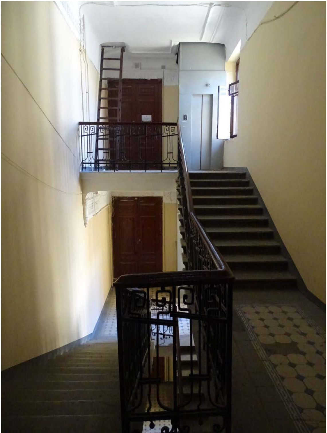
Фото 21. Вид на площадку 6-го этажа. Съемка 19.04.2021 г. Штиглиц М. С.
