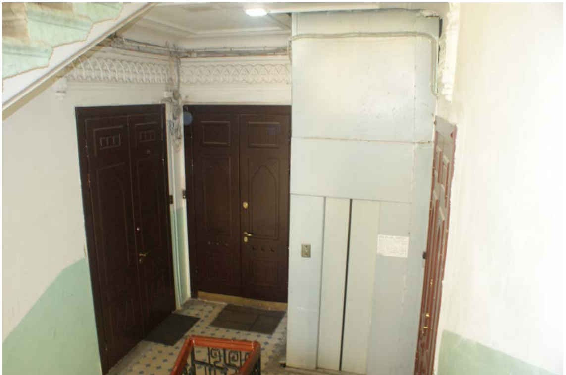
Фото 11 Вид на площадку 2-го этажа. Съемка 19.04.2021 г. Штиглиц М. С.
