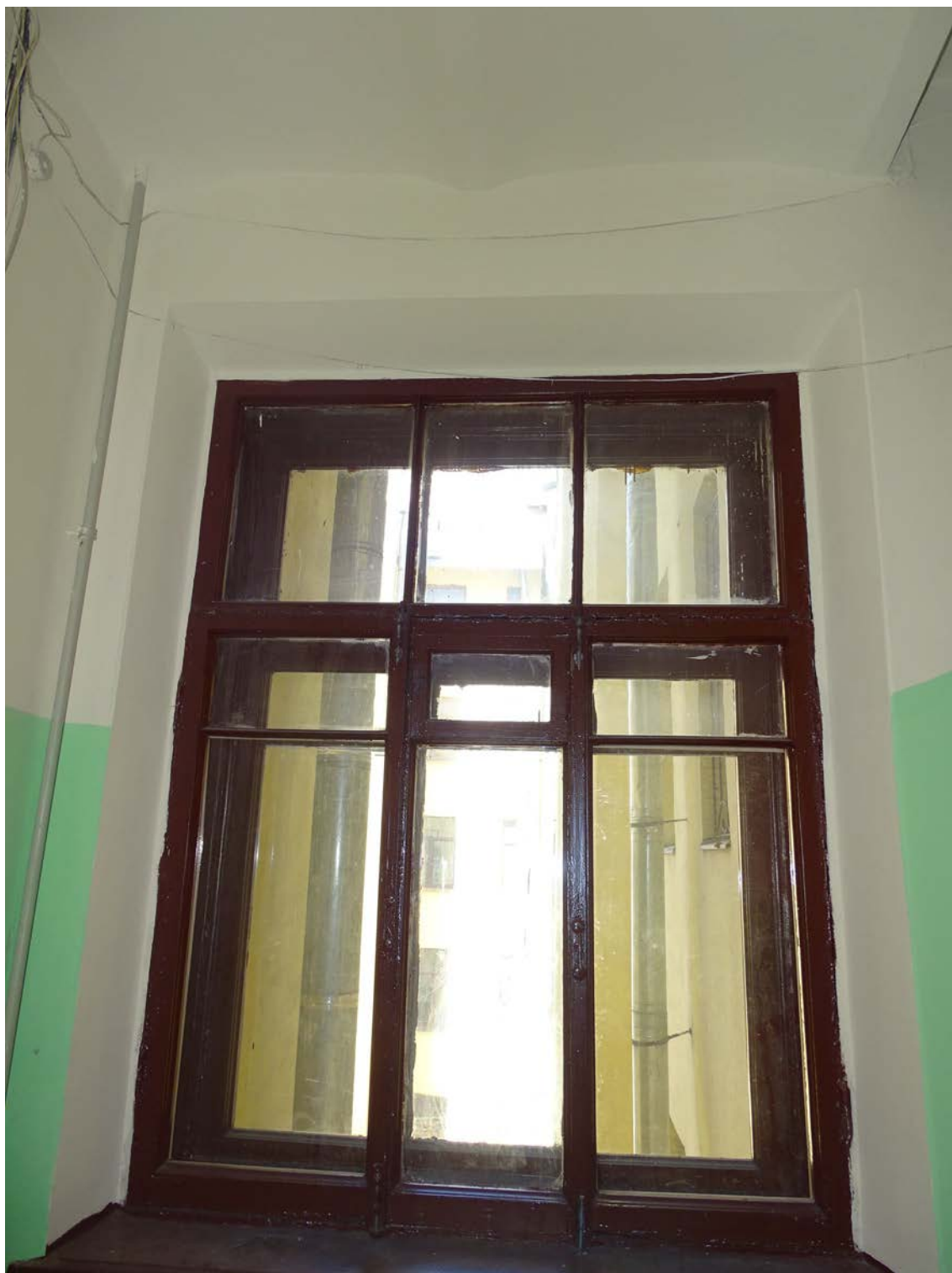
Фото 11. Вид на площадку 3-го этажа. Съемка 19.04.2021 г. Штиглиц М. С.
