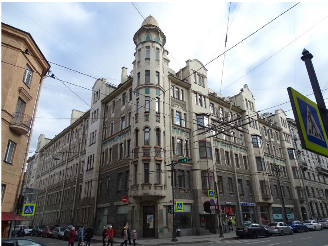
Фото 6. Здание по адресу: Большой проспект П.С., дом 69. Вид с пересечения Большого пр. и Ординарная ул. Съемка 19.04.2021 г. Штиглиц М. С.
