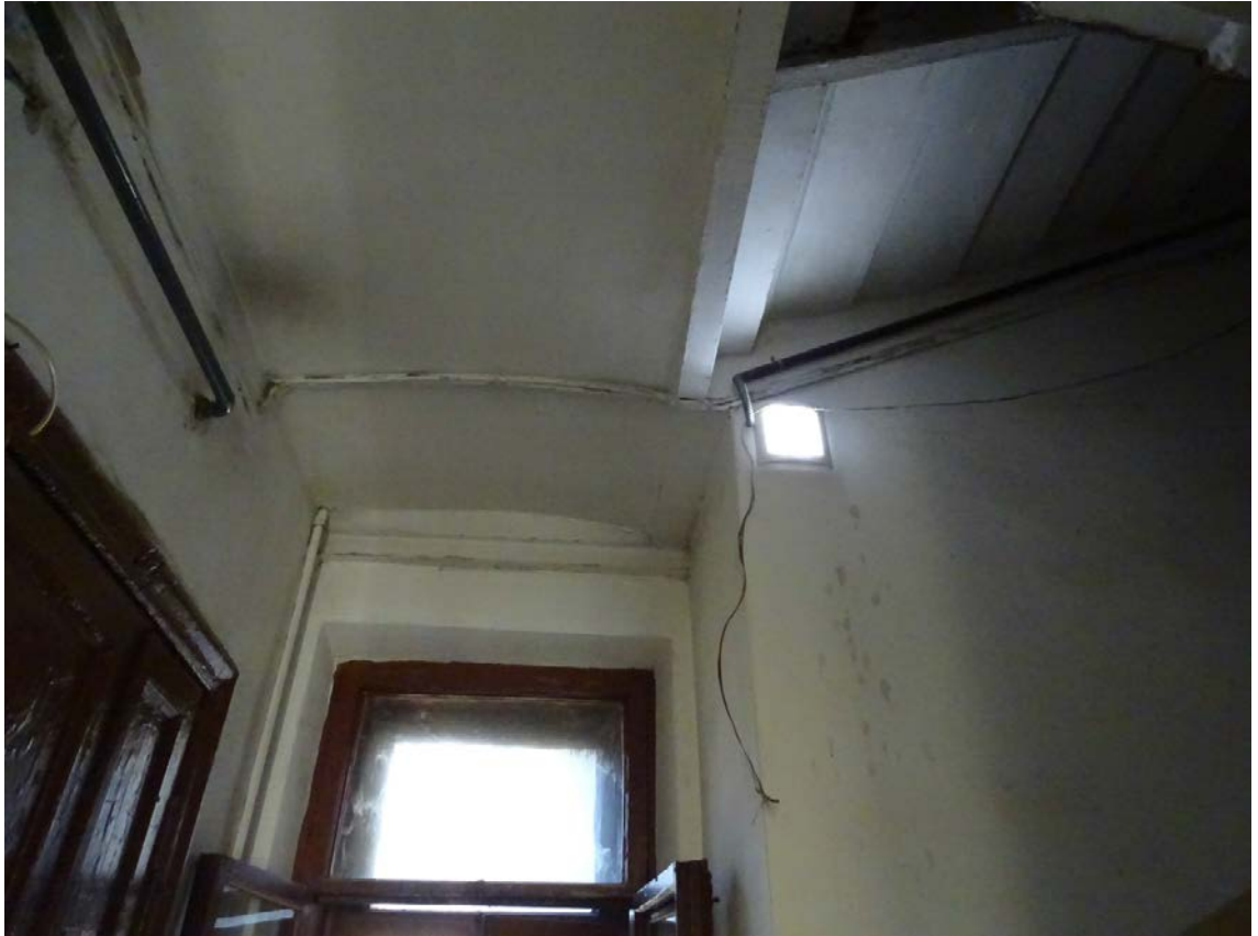
Фото 21. Площадка между 4-м и 5-м этажом. Съемка 19.04.2021 г. Штиглиц М. С.
