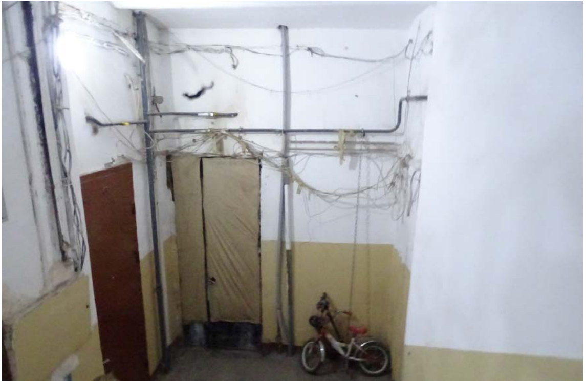
Фото 15. Вид на площадку 3-го этажа. Съемка 19.04.2021 г. Штиглиц М. С.
