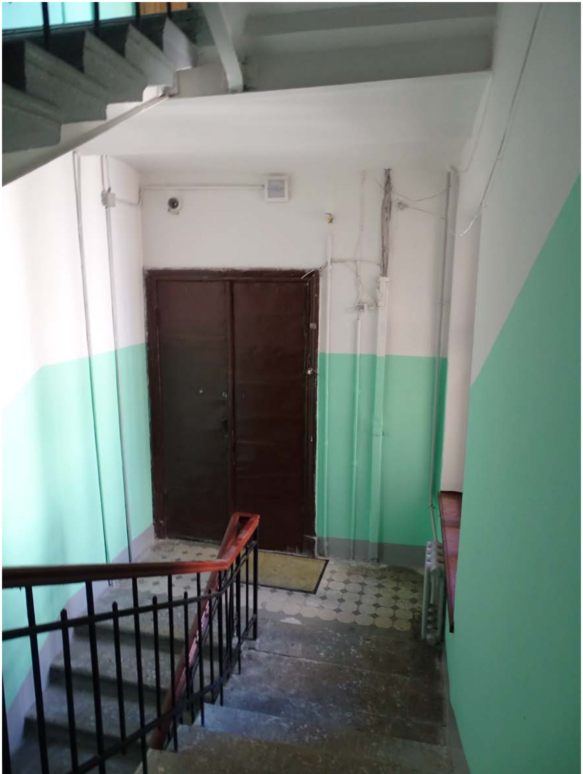
Фото 10. Вид на площадку 3-го этажа. Съемка 19.04.2021 г. Штиглиц М. С.
