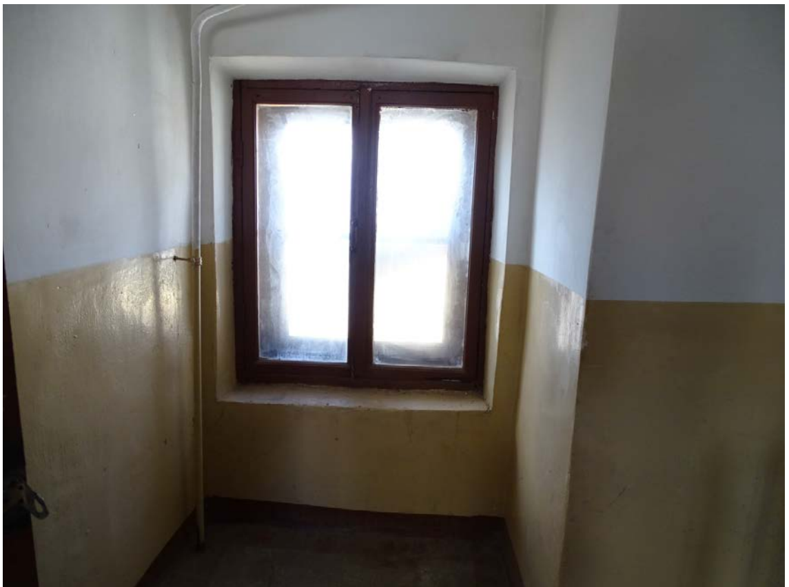
Фото 32. Площадка между 6-м и чердачным этажом. Съемка 19.04.2021 г. Штиглиц М. С.
