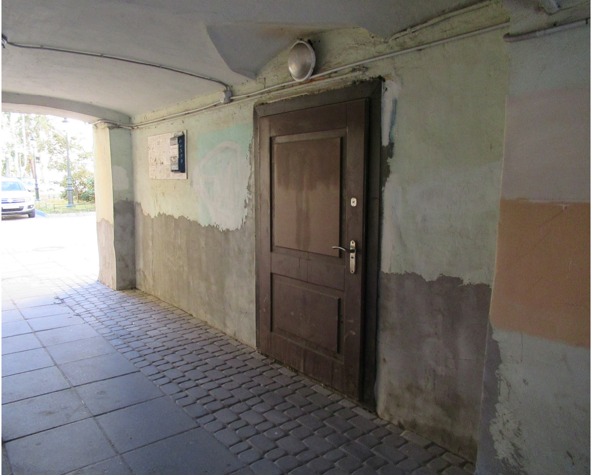
7. Вид внутри воротного проезда на вход в помещение 2-Н.
