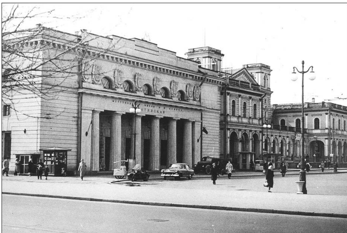
26. Наземный павильон. Март 1962 года. — Станция «Балтийская» // Mirmetro.net – русскоязычный интернет-ресурс, посвященный метрополитенам [Электронный ресурс]. URL: https://mirmetro.net/spb/01/16_baltiyskaya .
