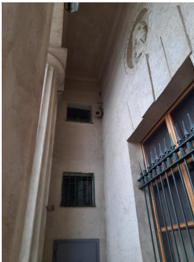
Фото 6 Фрагмент лицевого фасада объекта культурного наследия регионального значения «Станция метро «Балтийская» (существующий громкоговоритель)
