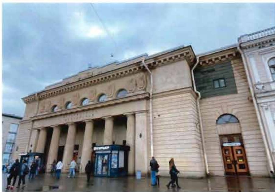
1. Общий вид на объект культурного наследия.
