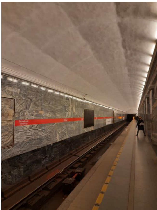
Фото 21 Фрагмент интерьера объекта культурного наследия регионального значения «Станция метро «Балтийская» (перронный зал)
