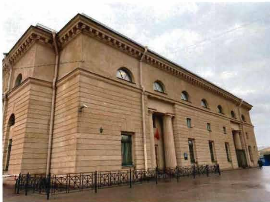
2. Общий вид на объект культурного наследия.
