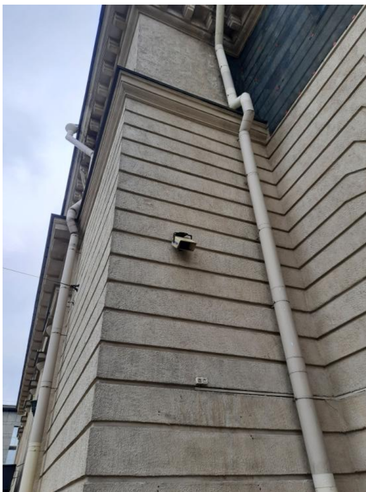
Фото 4 Фрагмент лицевого фасада объекта культурного наследия регионального значения «Станция метро «Балтийская» (существующий громкоговоритель)
