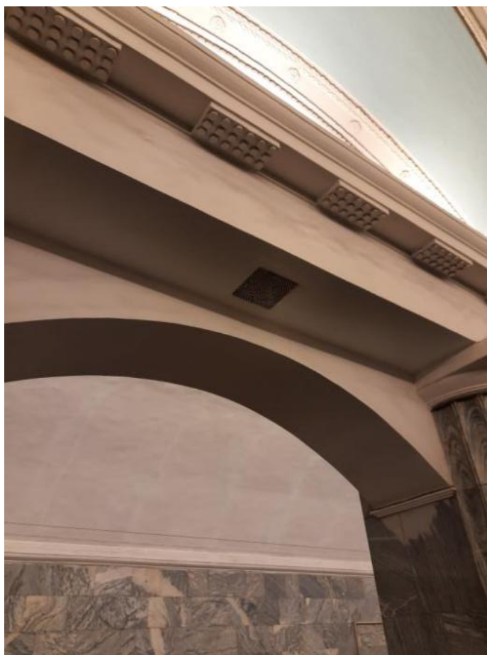
Фото 24 Фрагмент интерьера объекта культурного наследия регионального значения «Станция метро «Балтийская» (перронный зал, решетка громкоговорителя).
