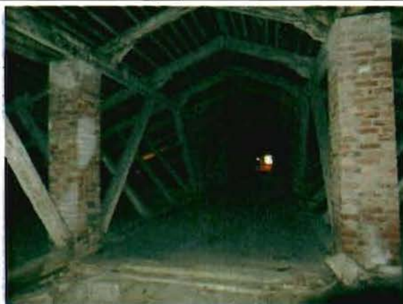
Фото 12. Конструкции крыши. Общий вид. 29.12.2015.
