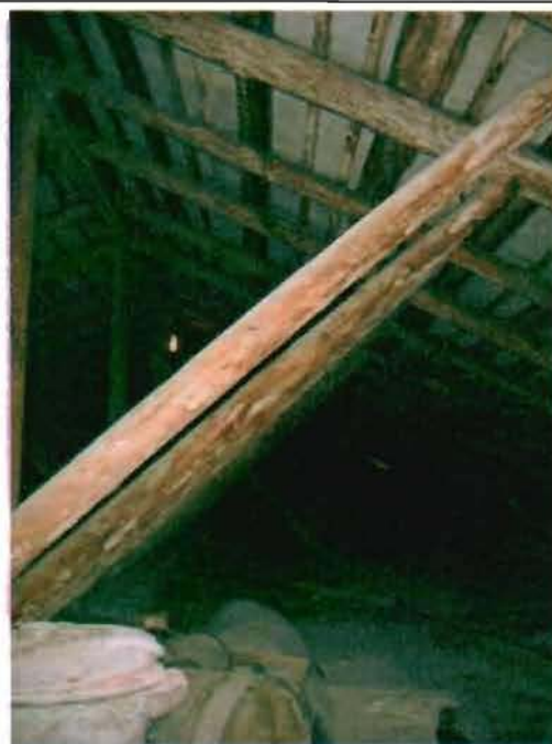
Фото 27. Конструкции крыши. Фрагмент.
