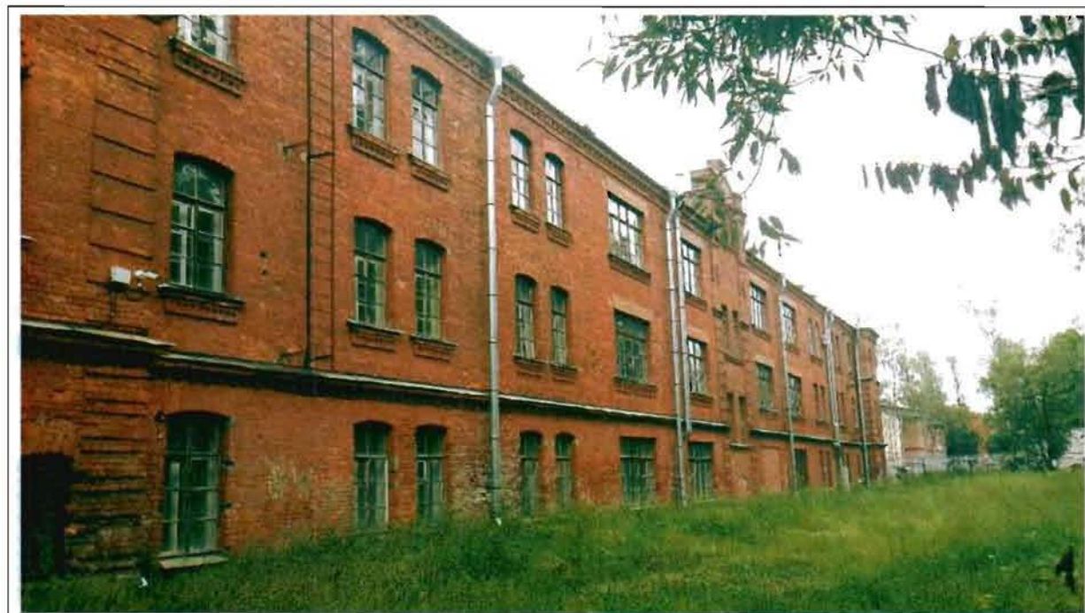
Фото 48. Западный фасад. Общий вид.
