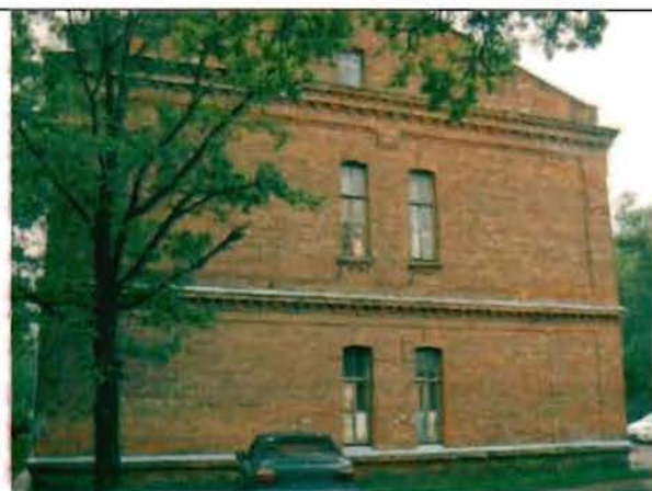
Фото 167. Северный фасад. Общий вид.
