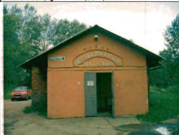
Фото 153. Восточный фасад. Общий вид.
