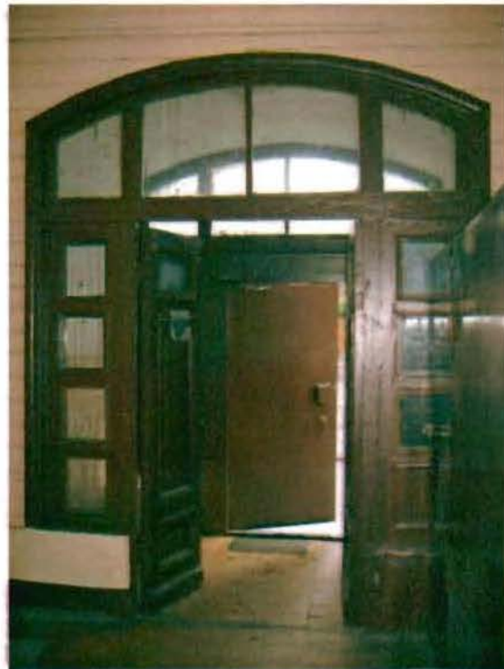
Фото 107. Дверной проем тамбура. Общий вид.
