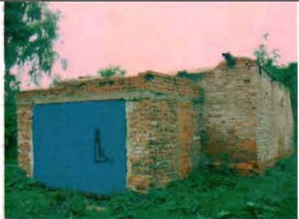
Фото 185. Восточный фасад. Общий вид.
