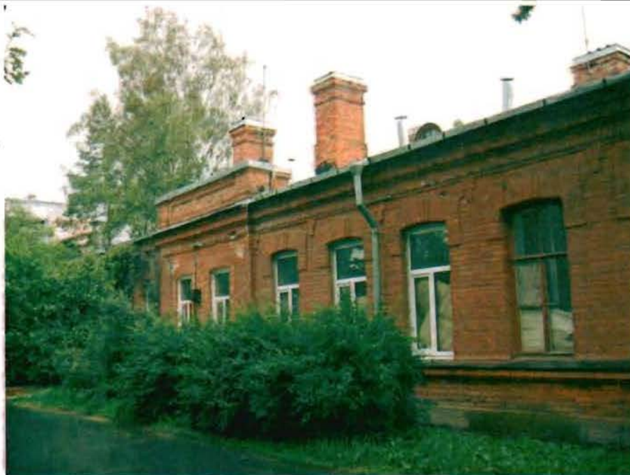
Фото 188. Восточный фасад. Фрагмент.
