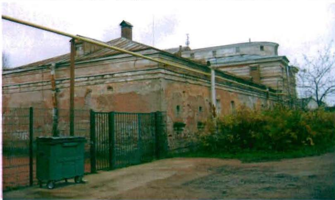
Фото 24. Западный, северный фасады. Общий вид.
