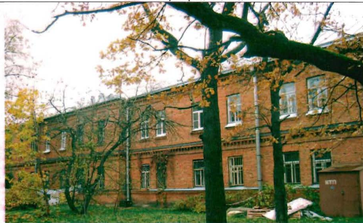
Фото 84. Южный фасад. Общий вид.
