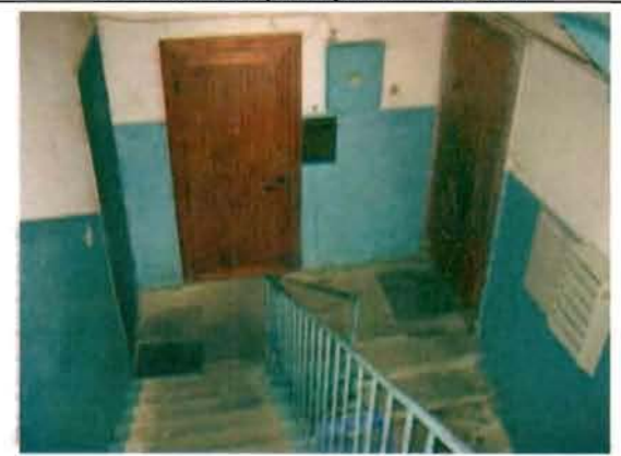
Фото 162. Лестница № 2 в северной части здания. Фрагмент.
