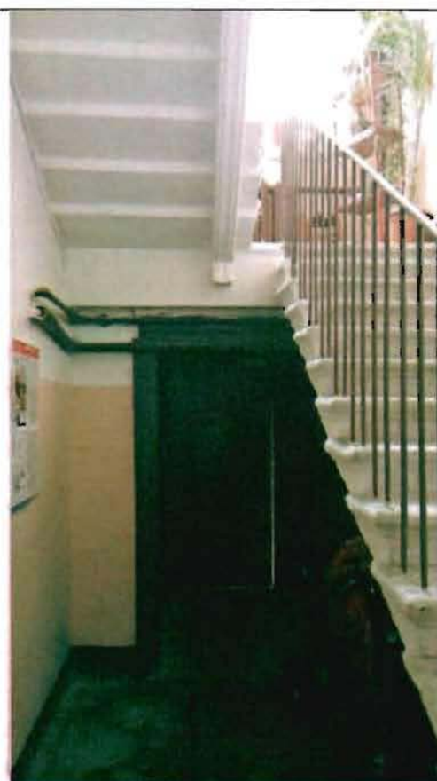
Фото 131. Лестница № 2 в северной части здания. Общий вид.
