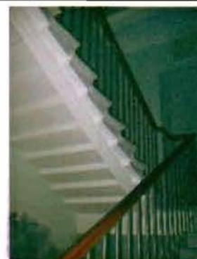
Фото 75. Интерьер. Лестница в западной части здания. Общий вид.
