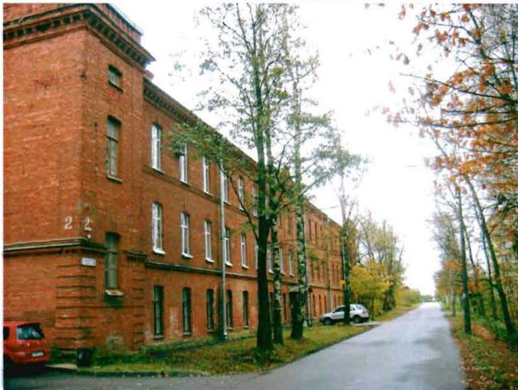
Фото 13. Западный фасад. Общий вид.
