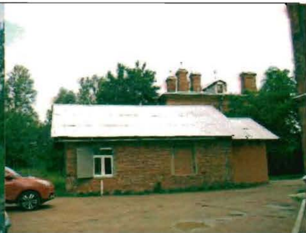
Фото 154. Южный фасад. Общий вид.
