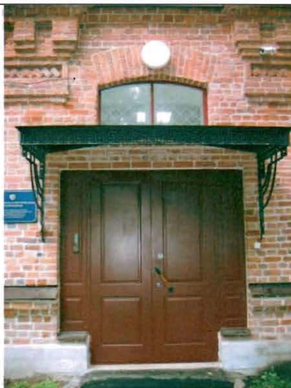
Фото 41. Дверной проем восточного фасада. Общий вид.
