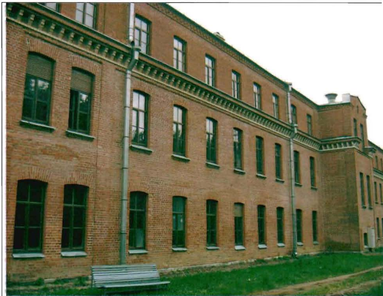
Фото 66. Южный фасад. Общий вид. 05.07.2016.
