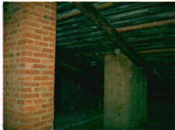
Фото 152. Конструкции крыши. Фрагмент.
