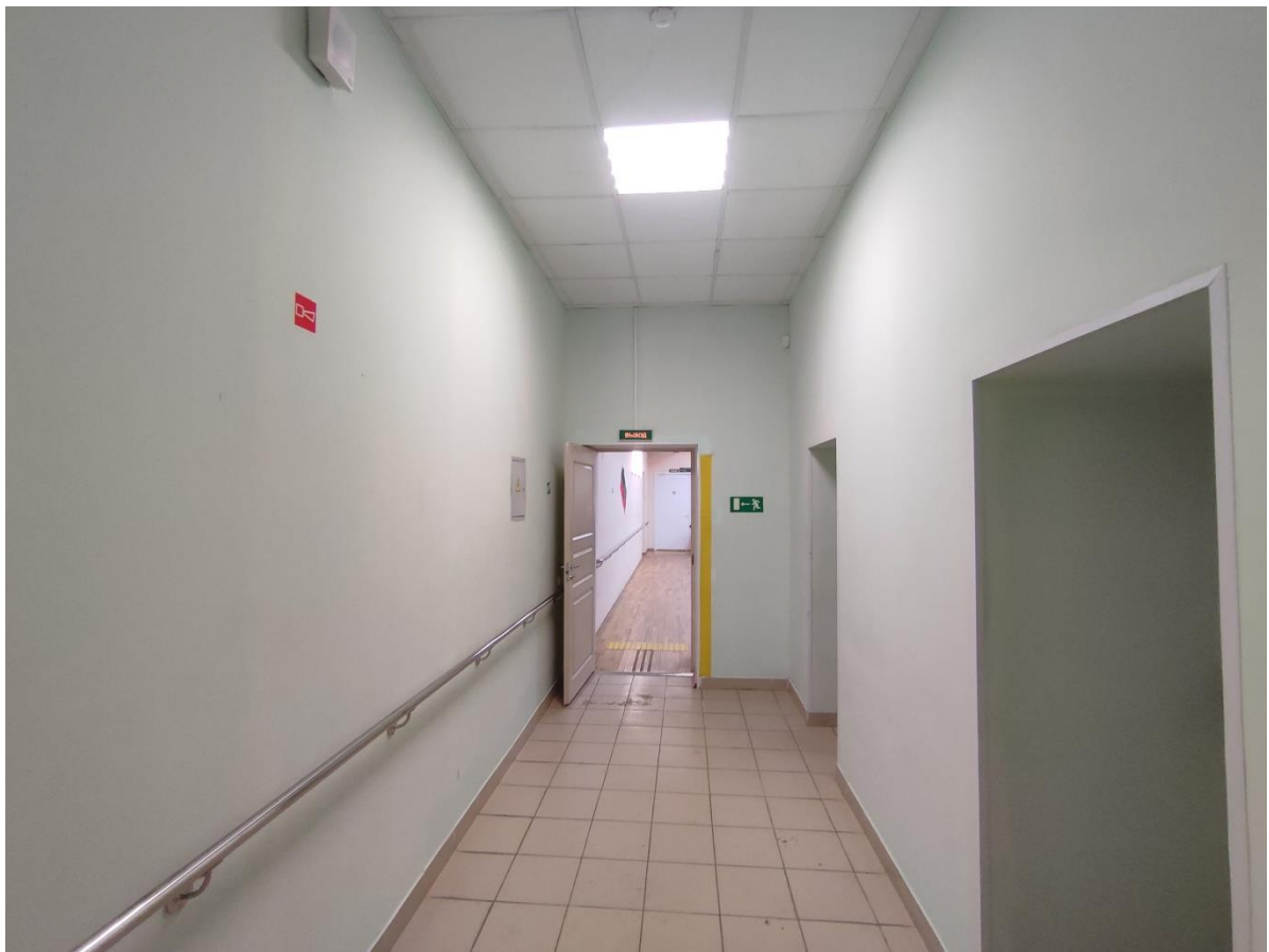
16. Общий вид пом. 1-Н (41) в уровне 1-го этажа.
