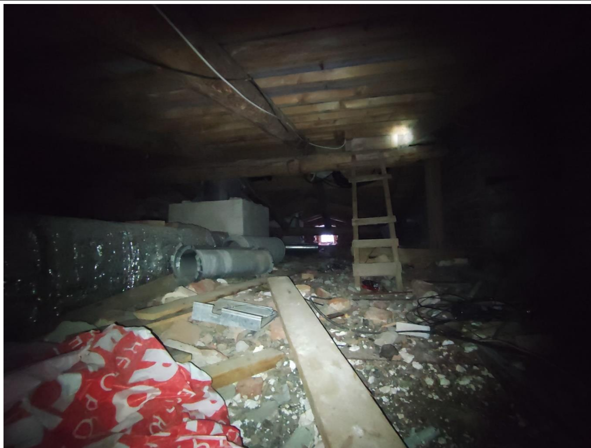
50. Фрагмент обрешетки крыши в центральной части чердака.
