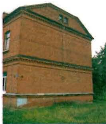
Фото 86. Западный фасад. Общий вид.
