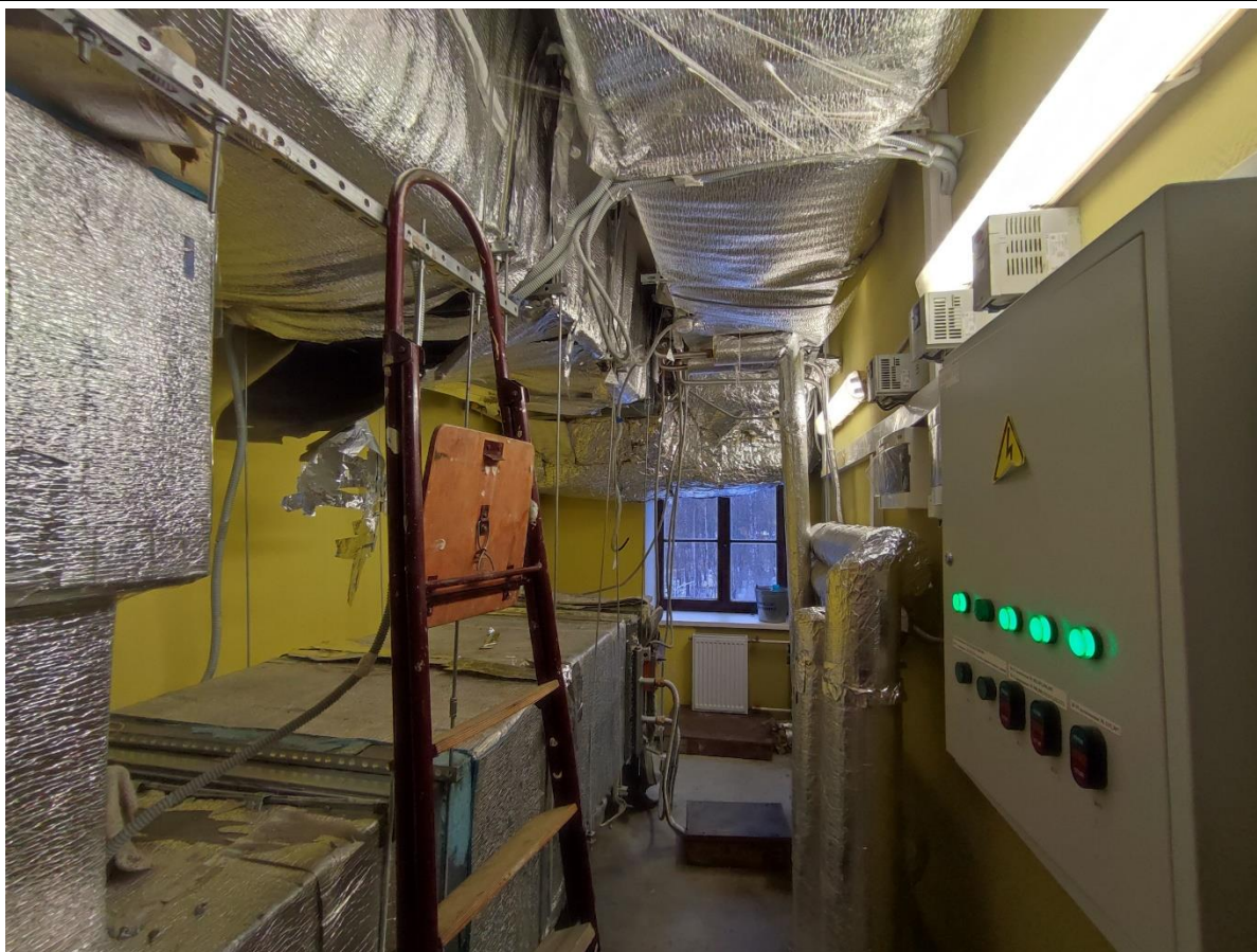
40. Общий вид пом. 1-Н (106) в уровне 3-го этажа.
