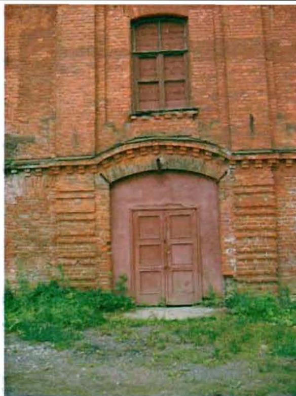
Фото 4. Западный фасад. Фрагмент центральной части фасада.
