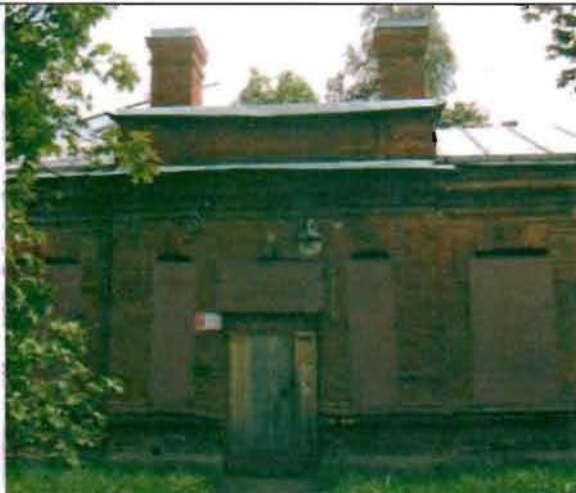
Фото 99. Западный фасад. Центральная часть. Общий вид.
