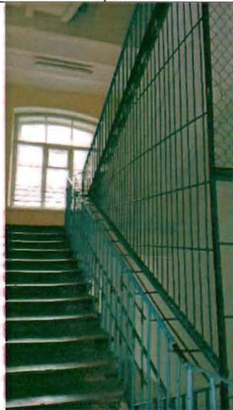
Фото 61. Интерьер. Лестница в южной части здания. Фрагмент.
