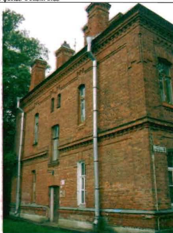
Фото 148. Северный фасад. Общий вид.
