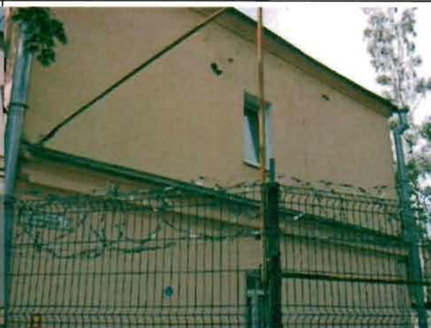
Фото 113. Северный фасад. Общий вид.
