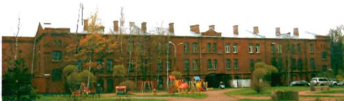
Фото 28. Восточный фасад. Общий вид.
