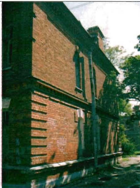
Фото 138. Южный фасад. Общий вид.
