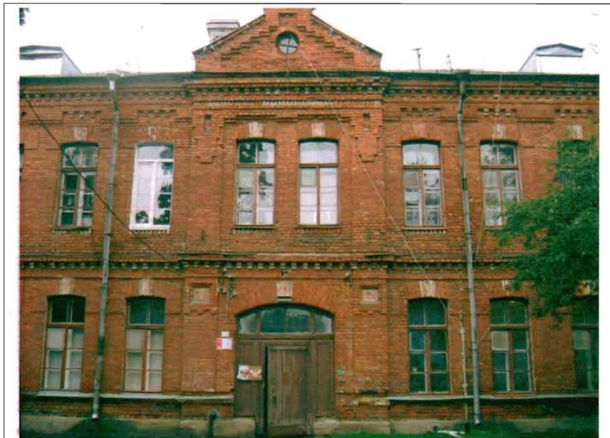
Фото 104. Восточный фасад. Центральная часть. Общий вид.
