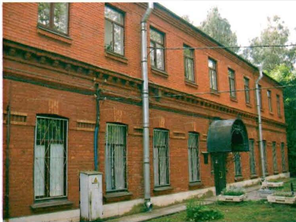
Фото 78. Западный фасад. Общий вид.
