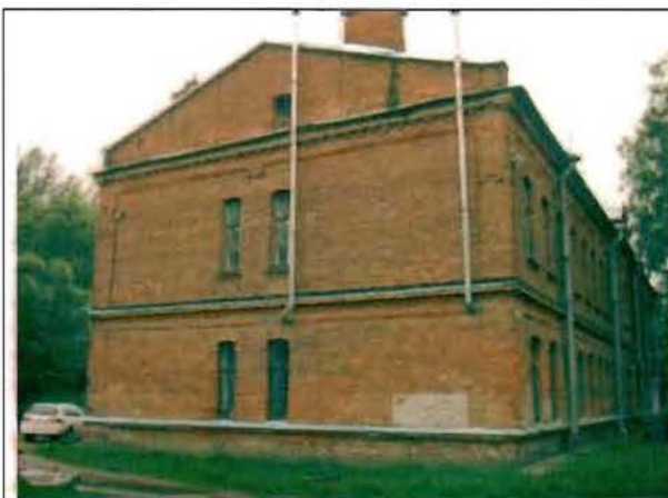
Фото 166. Южный фасад. Общий вид.
