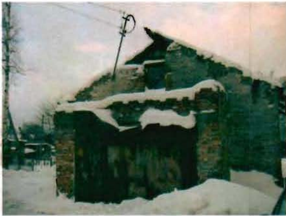
Фото 184. Восточный фасад. Общий вид. 14.01.2015.
