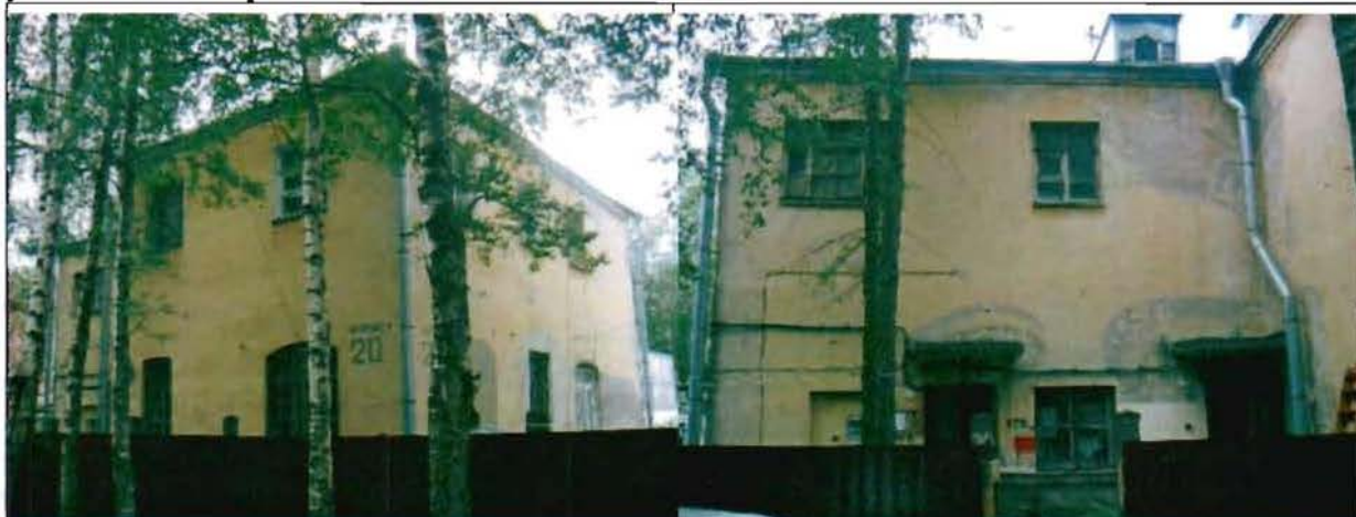
Фото 43. Северный, восточный фасады. Общий вид.
