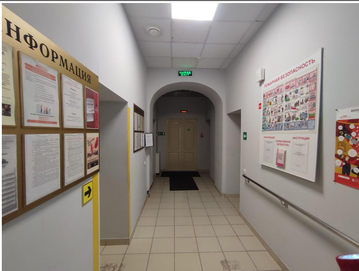
17. Общий вид пом. 1-Н (40) в уровне 1-го этажа.
