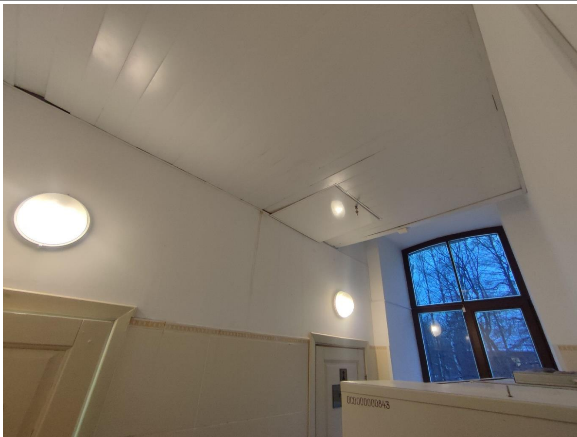
33. Общий вид пом. 1-Н (70) в уровне 2-го этажа.
