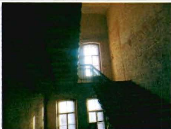
Фото 11. Интерьер. Лестница. Общий вид. 29.12.2015.
