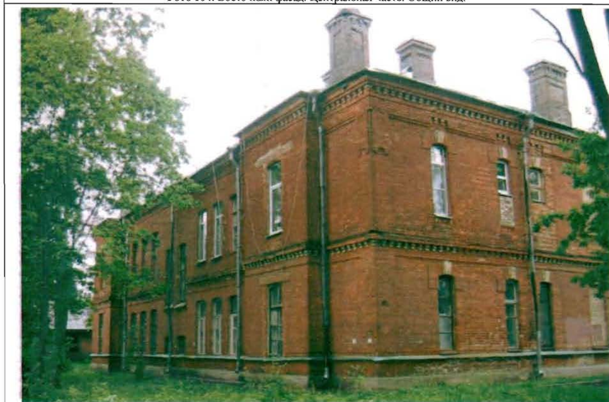
Фото 105. Западный, южный фасады. Общий вид.
