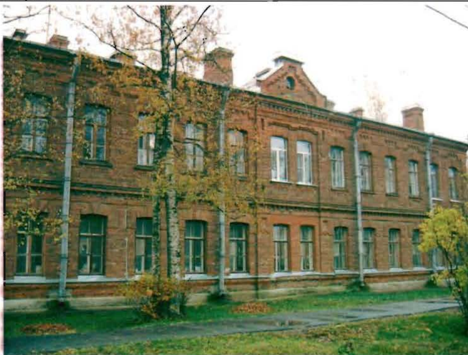
Фото 157. Западный фасад. Общий вид.
