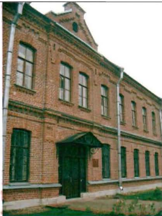
Фото 135. Западный фасад. Фрагмент центральной части фасада.
