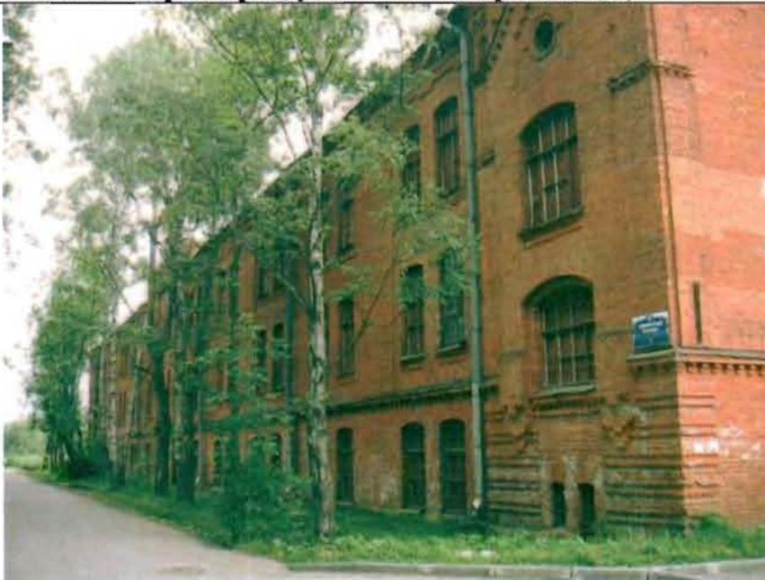
Фото 1. Западный фасад. Общий вид.
