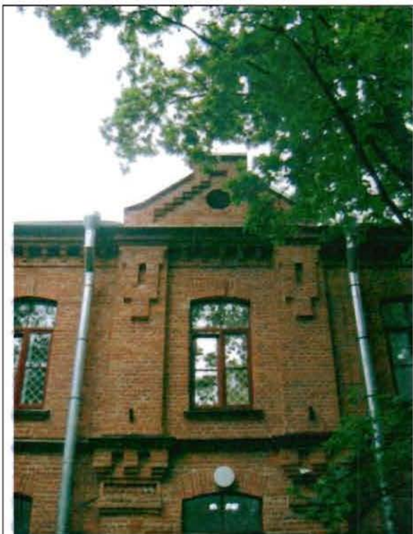
Фото 40. Восточный фасад. Фрагмент центральной части фасада.
