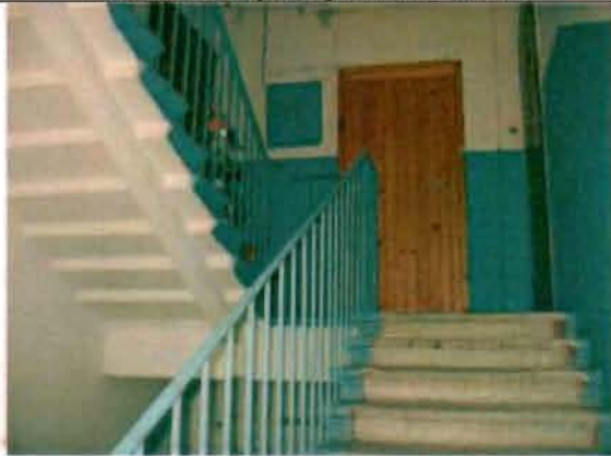
Фото 161. Лестница № 1 в южной части здания. Фрагмент.
