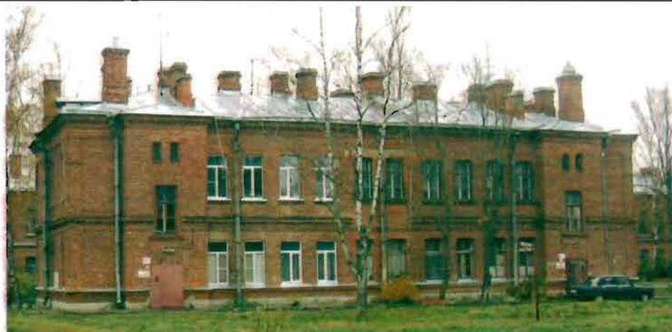
Фото 158. Восточный фасад. Общий вид.
