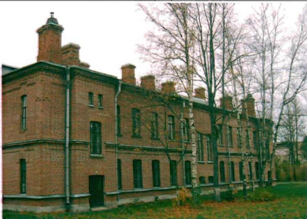
Фото 133. Восточный фасад. Общий вид.
