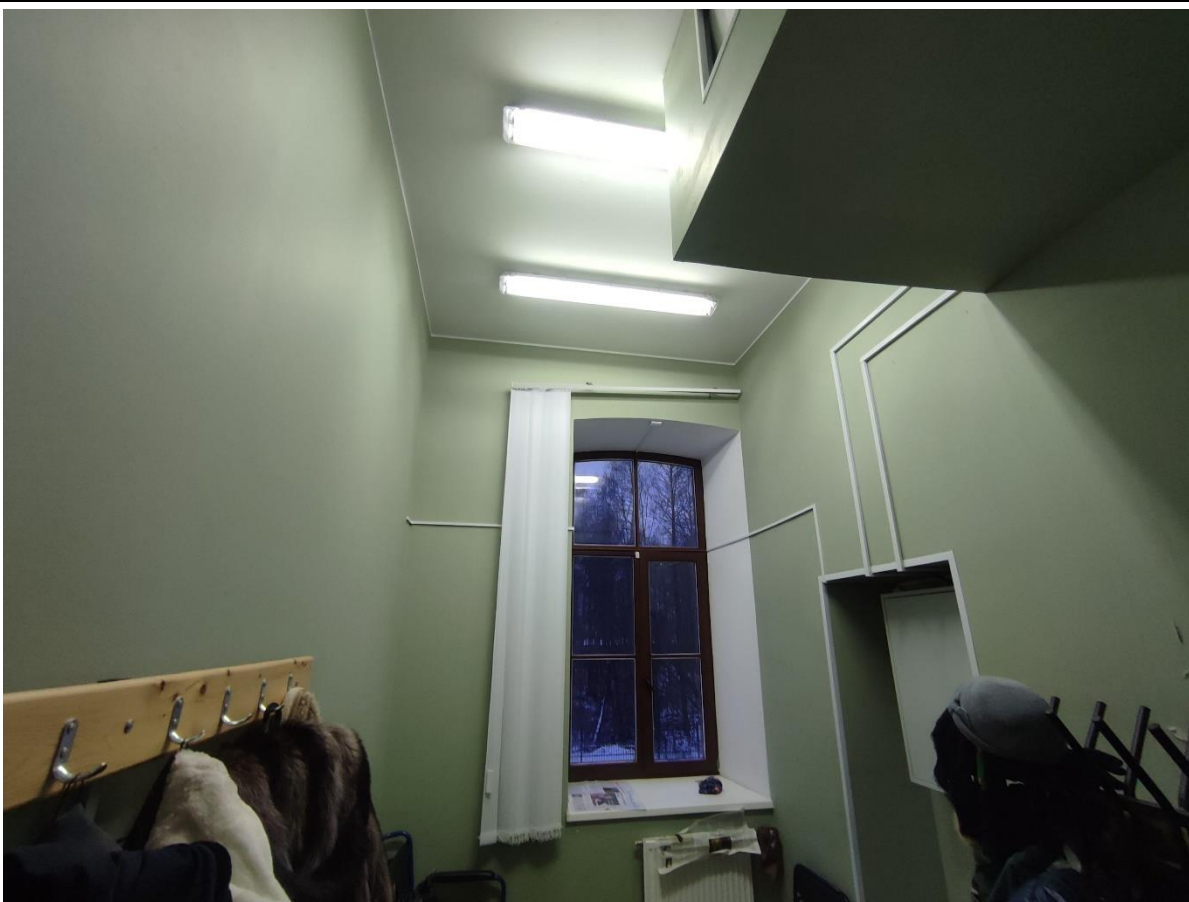
24. Общий вид пом. 1-Н (96) в уровне 2-го этажа.
