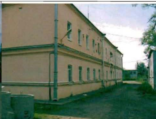
Фото 111. Западный фасад. Общий вид.
