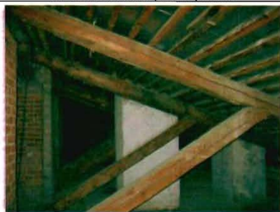
Фото 141. Конструкции крыши. Фрагмент.
