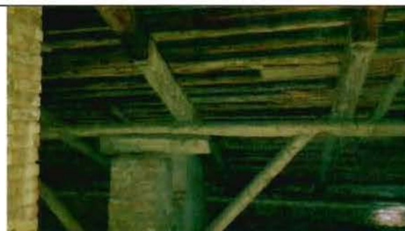
Фото 38. Конструкции крыши. Фрагмент.
