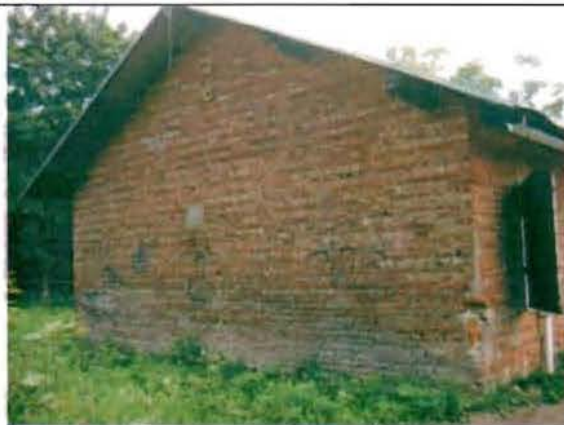
Фото 155. Северный фасад. Общий вид.
