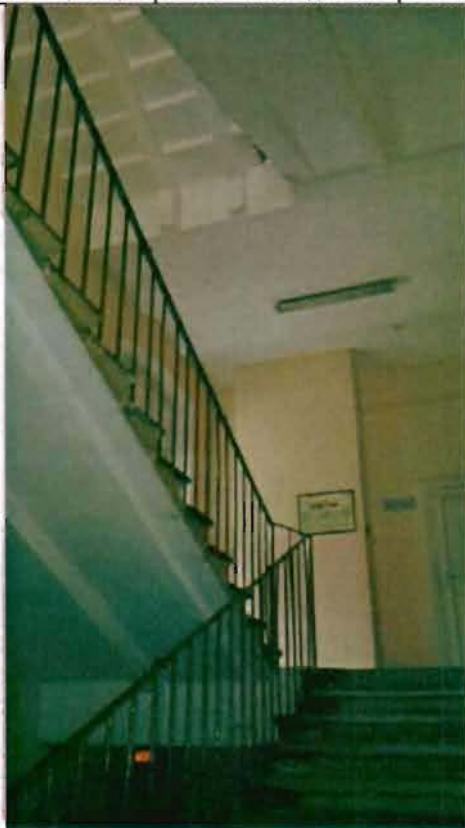
Фото 60. Интерьер. Лестница в южной части здания. Фрагмент.
