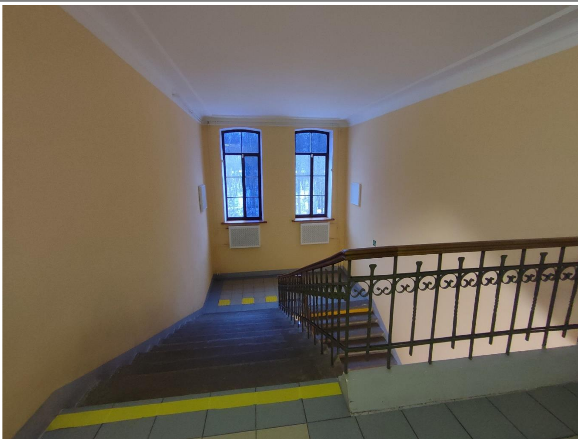
38. Общий вид центральной двухмаршевой лестницы (пом. 1-Н (108)) в уровне 3-го этажа.
