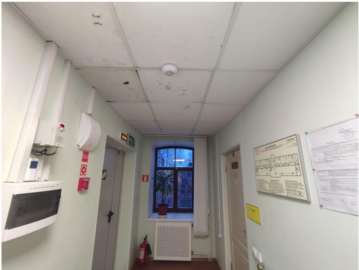
46. Фрагмент пом. 1-Н (104) в уровне 3-го этажа.
