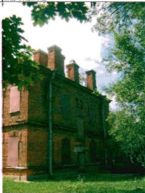
Фото 118. Северный фасад. Общий вид.
