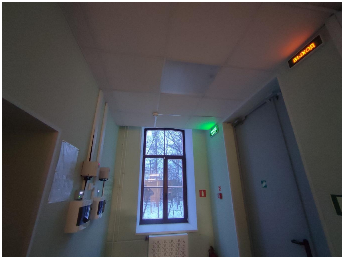
32. Фрагмент пом. 1-Н (59) в уровне 2-го этажа.
