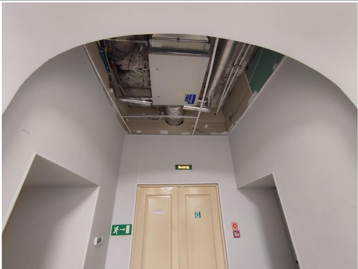
18. Фрагмент пом. 1-Н (39, 40) в уровне 1-го этажа.
