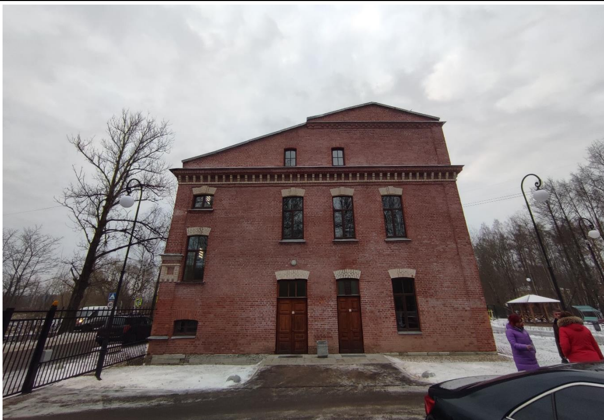
8. Общий вид западного торцевого фасада объекта культурного наследия регионального значения «Казарма», расположенного по адресу: Санкт-Петербург, г. Петергоф, ул. Юты Бондаровской, д. 23, лит. А.
