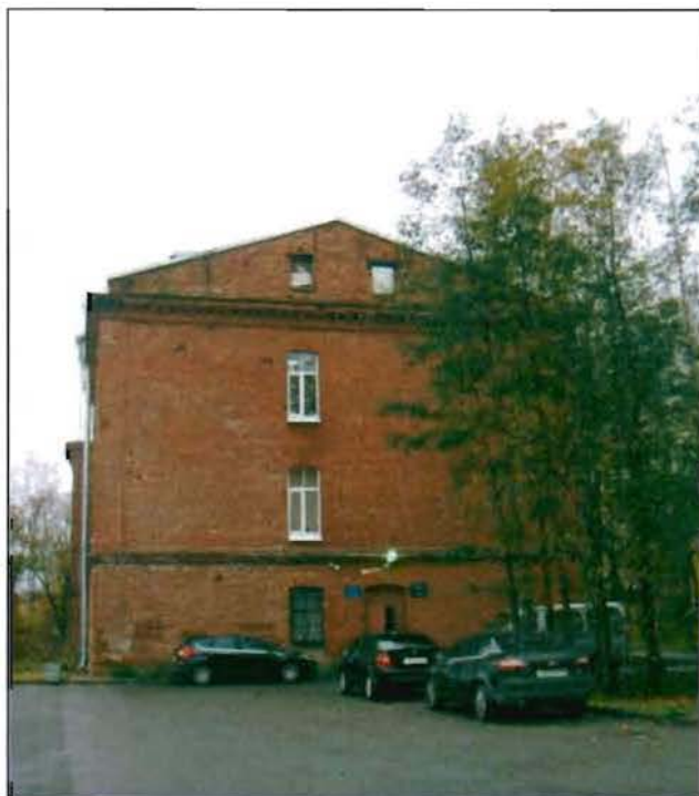
Фото 15. Северный фасад. Общий вид.
