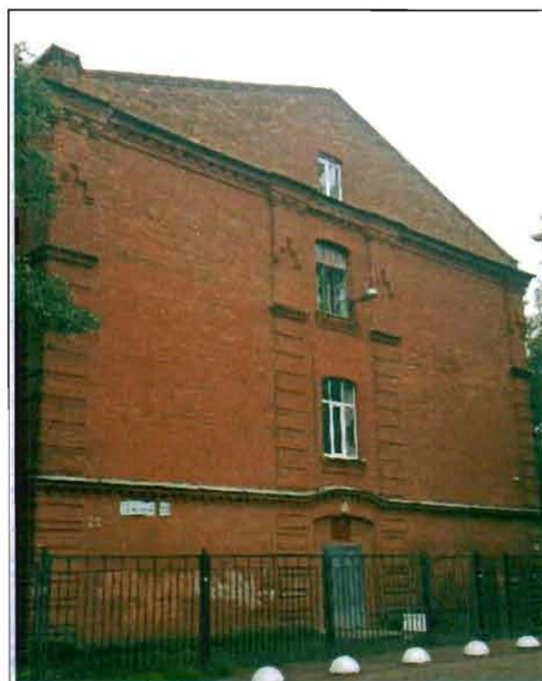
Фото 49. Северный фасад. Общий вид.
