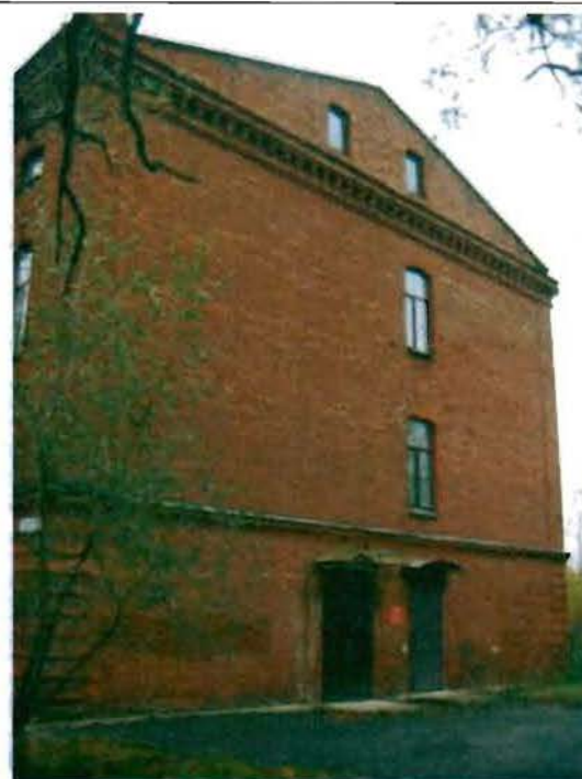
Фото 16. Южный фасад. Общий вид.
