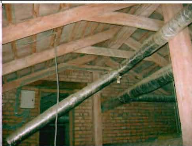
Фото 115. Конструкции крыши. Фрагмент.
