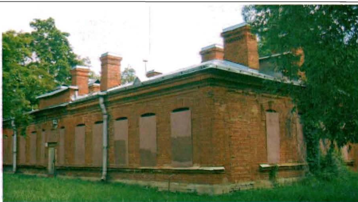
Фото 98. Западный фасад. Общий вид.
