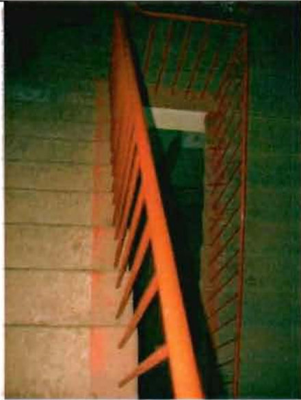
Фото 149. Лестница № 1 в северной части здания. Общий вид.
