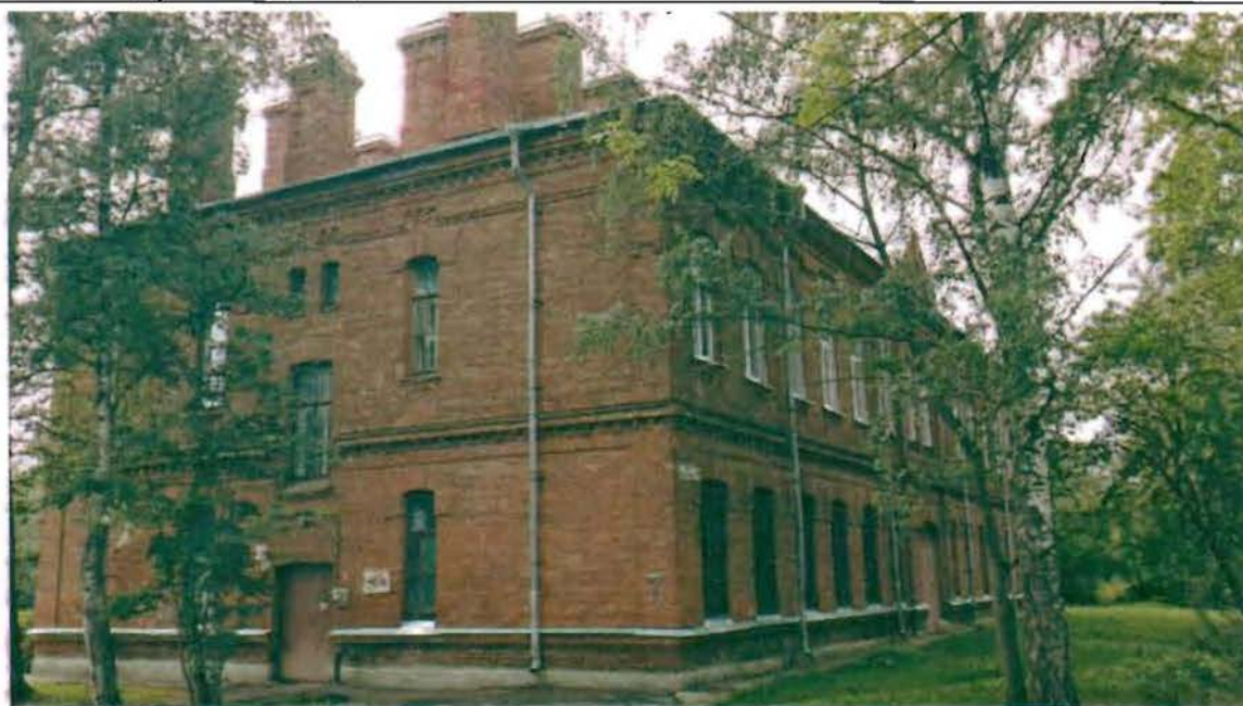
Фото 170. Северный, западный фасады. Общий вид.
