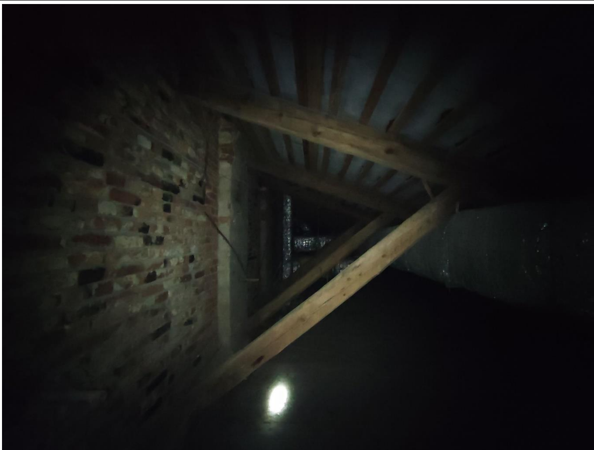
47. Фрагмент стропильной системы крыши в восточной части чердака.
