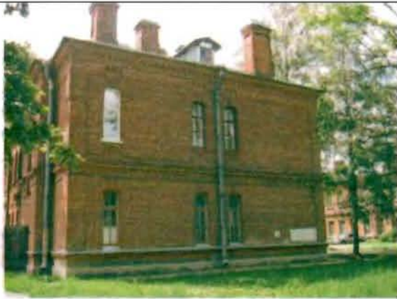
Фото 159. Северный фасад. Общий вид.
