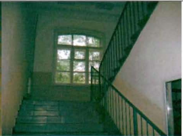
Фото 59. Интерьер. Лестница в северной части здания. Фрагмент.
