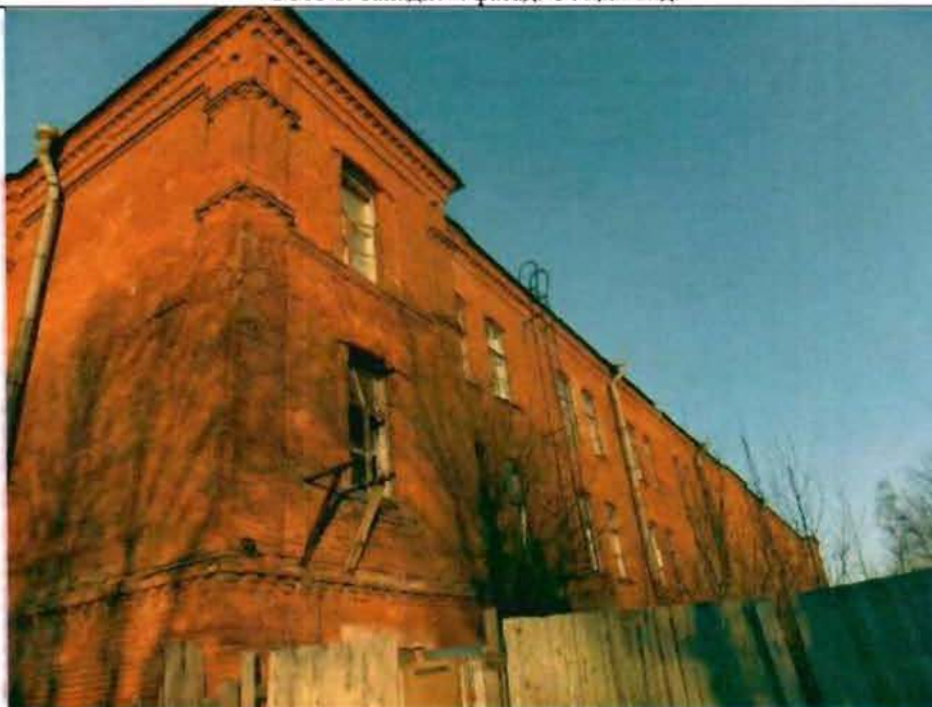
Фото 2. Восточный фасад. Общий вид. 29.12.2015.
