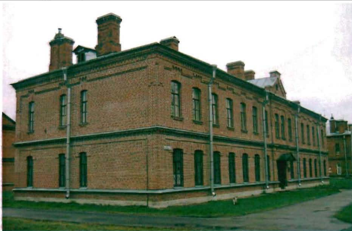
Фото 132. Западный, северный фасады. Общий вид.
