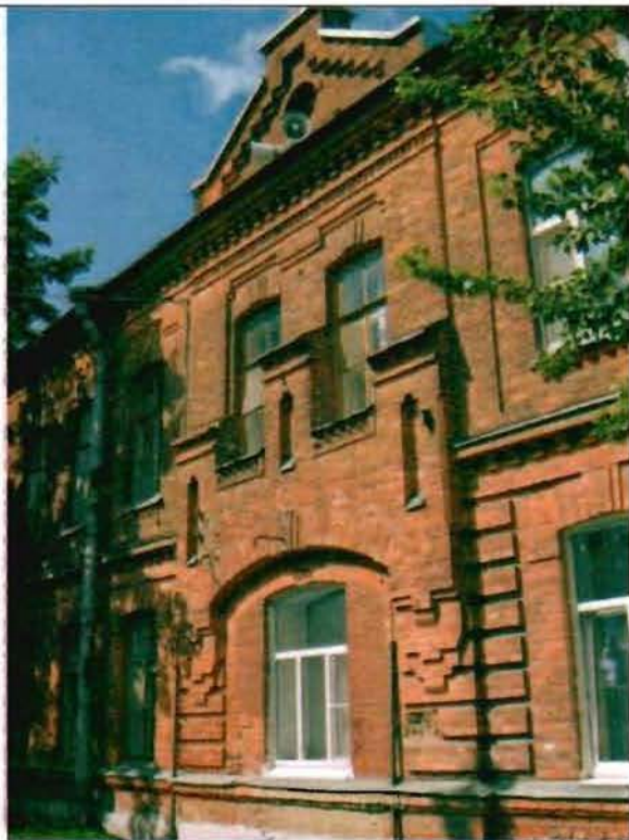
Фото 137. Восточный фасад. Фрагмент.
