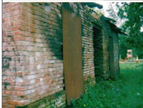
Фото 95. Северный фасад. Общий вид.
