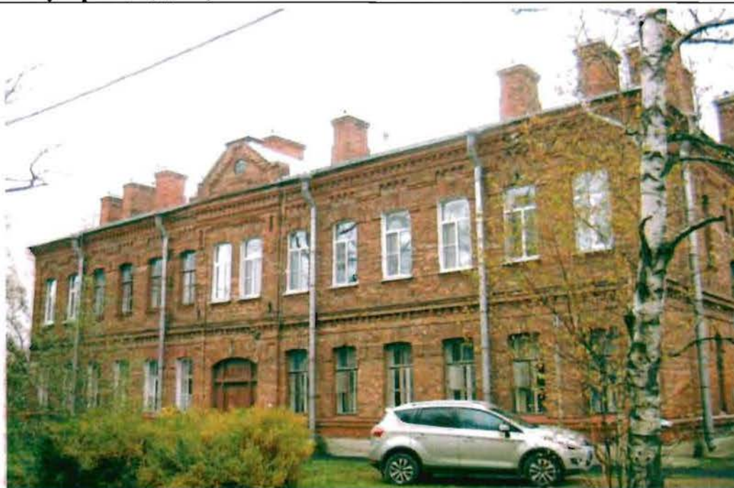
Фото 128. Восточный фасад. Общий вид.
