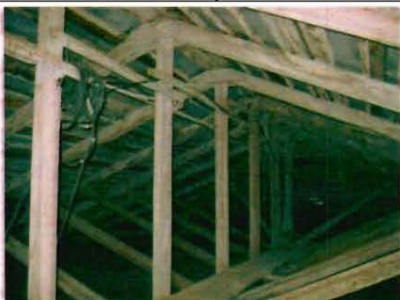
Фото 81. Конструкции крыши. Общий вид.
