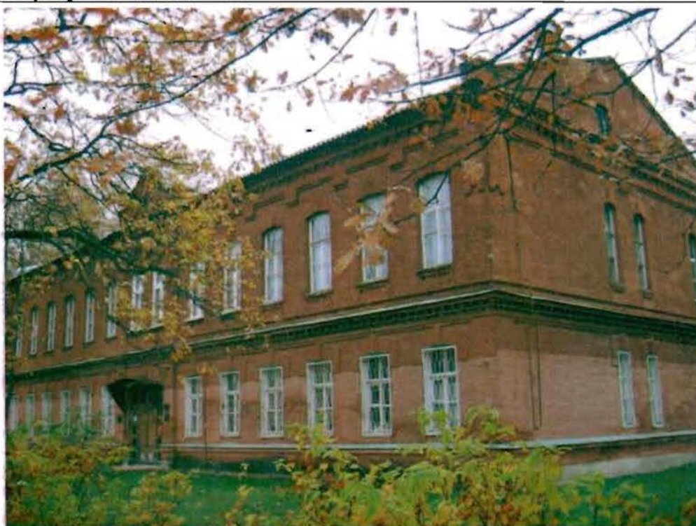
Фото 89. Западный, южный фасады. Общий вид.
