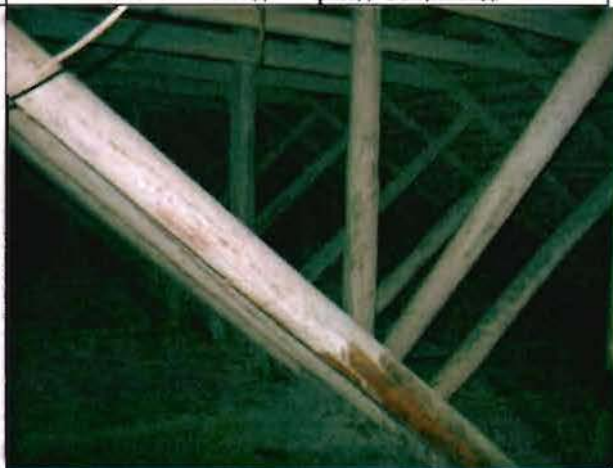
Фото 88. Конструкции крыши. Общий вид.
