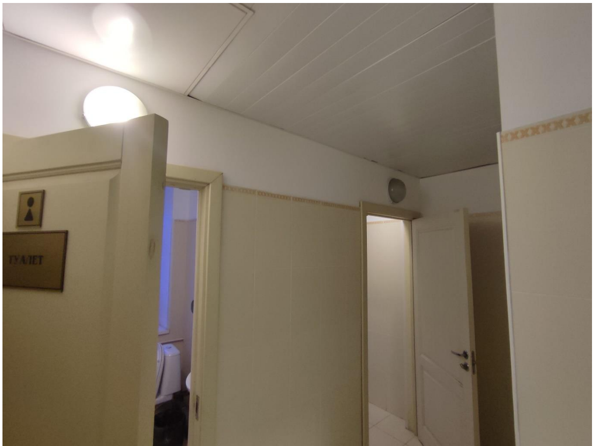
36. Общий вид пом. 1-Н (119) в уровне 3-го этажа.
