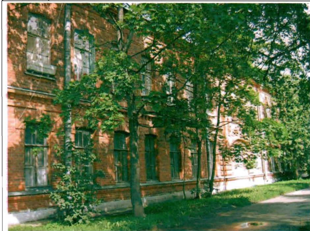
Фото 136. Восточный фасад. Общий вид.
