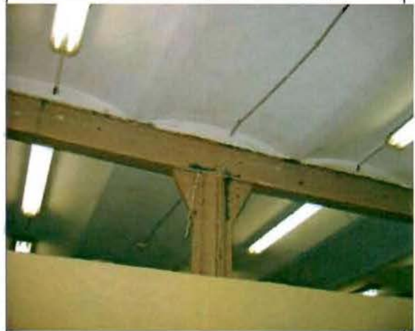
Фото 23. Интерьер. Металлические клепаные колонны и балки. Фрагмент.
