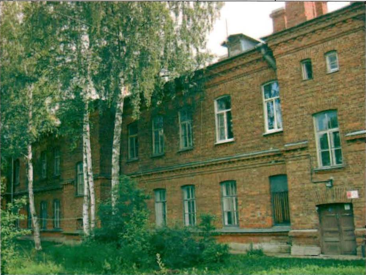
Фото 179. Западный фасад. Общий вид.
