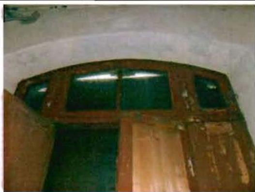
Фото 126. Дверное заполнение центральной части лестницы. Фрагмент.
