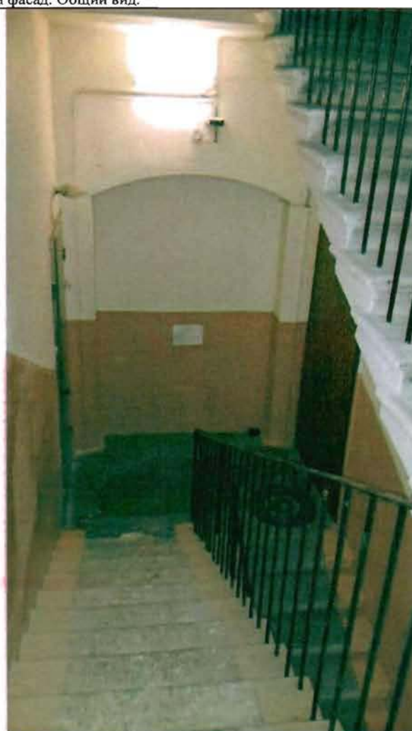
Фото 173. Лестница № 1 в северной части здания. Фрагмент.
