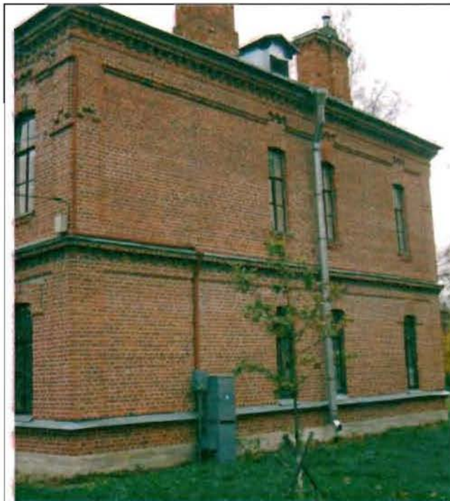
Фото 134. Южный фасад. Общий вид.
