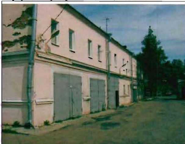
Фото 110. Восточный фасад. Общий вид.
