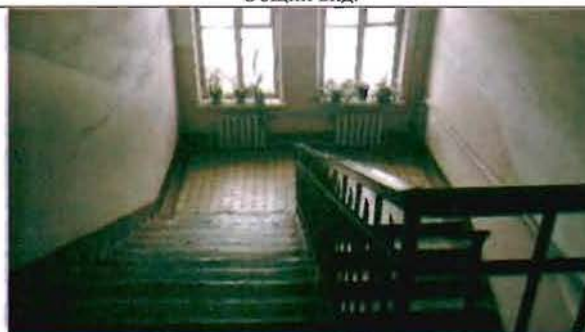
Фото 34. Интерьер. Лестница. Общий вид.
