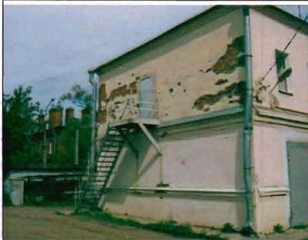
Фото 112. Южный фасад. Общий вид.
