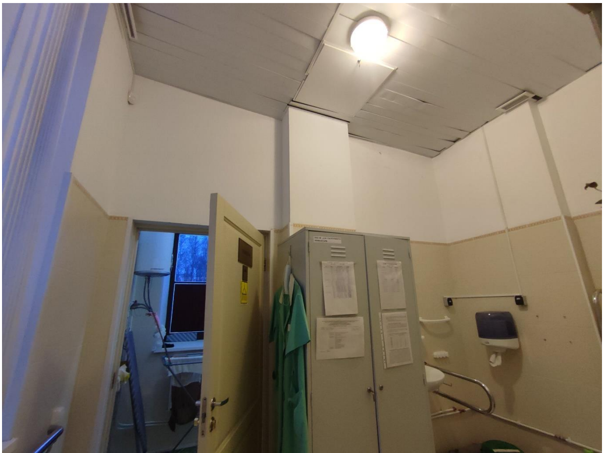
27. Общий вид пом. 1-Н (89) в уровне 2-го этажа.
