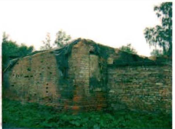
Фото 187. Северный фасад. Общий вид.
