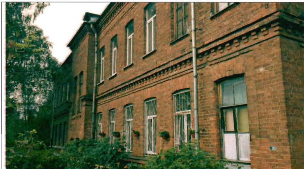
Фото 171. Восточный фасад. Общий вид.
