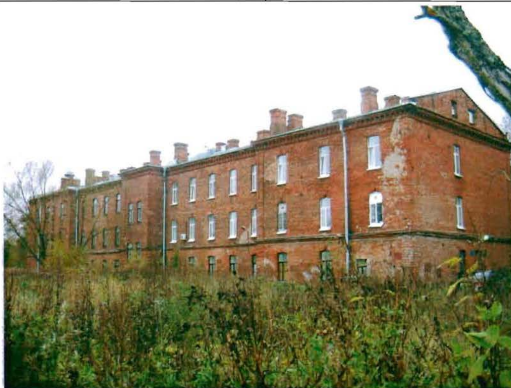
Фото 14. Восточный фасад. Общий вид.
