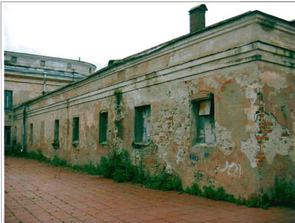
Фото 25. Восточный фасад. Общий вид.
