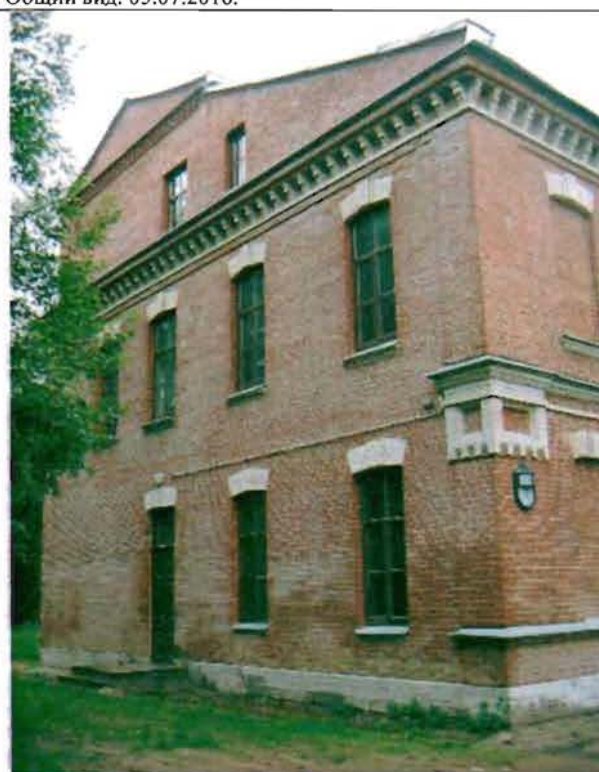
Фото 68. Восточный фасад. Общий вид.
