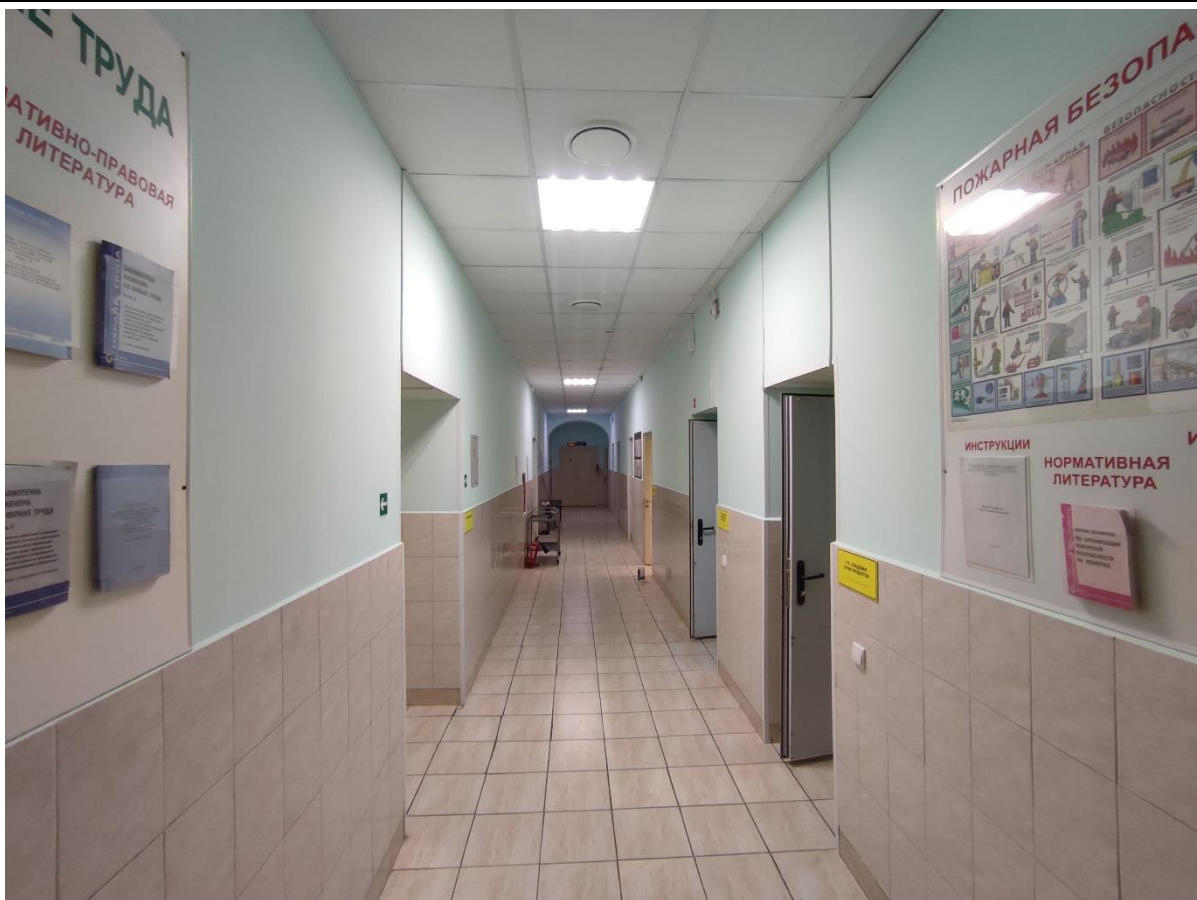
20. Общий вид пом. 1-Н (15) в уровне 1-го этажа.
