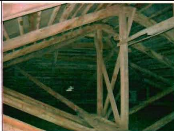
Фото 82. Конструкции крыши. Общий вид.
