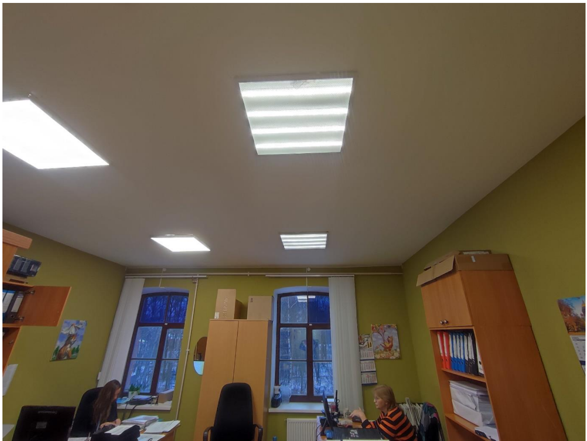
42. Общий вид пом. 1-Н (103) в уровне 3-го этажа.
