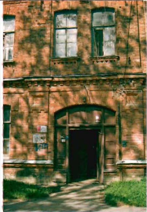
Фото 178. Восточный фасад. Центральная часть. Фрагмент.
