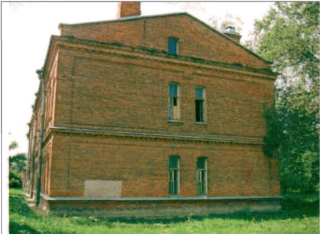
Фото 180. Северный фасад. Общий вид.
