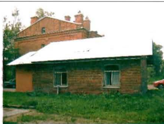
Фото 156. Западный фасад. Общий вид.
