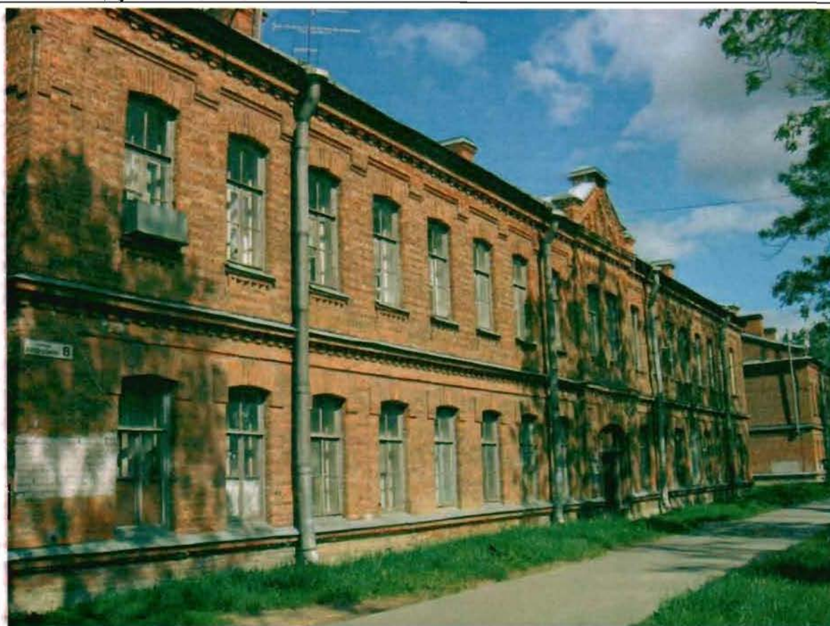
Фото 176. Восточный фасад. Общий вид.
