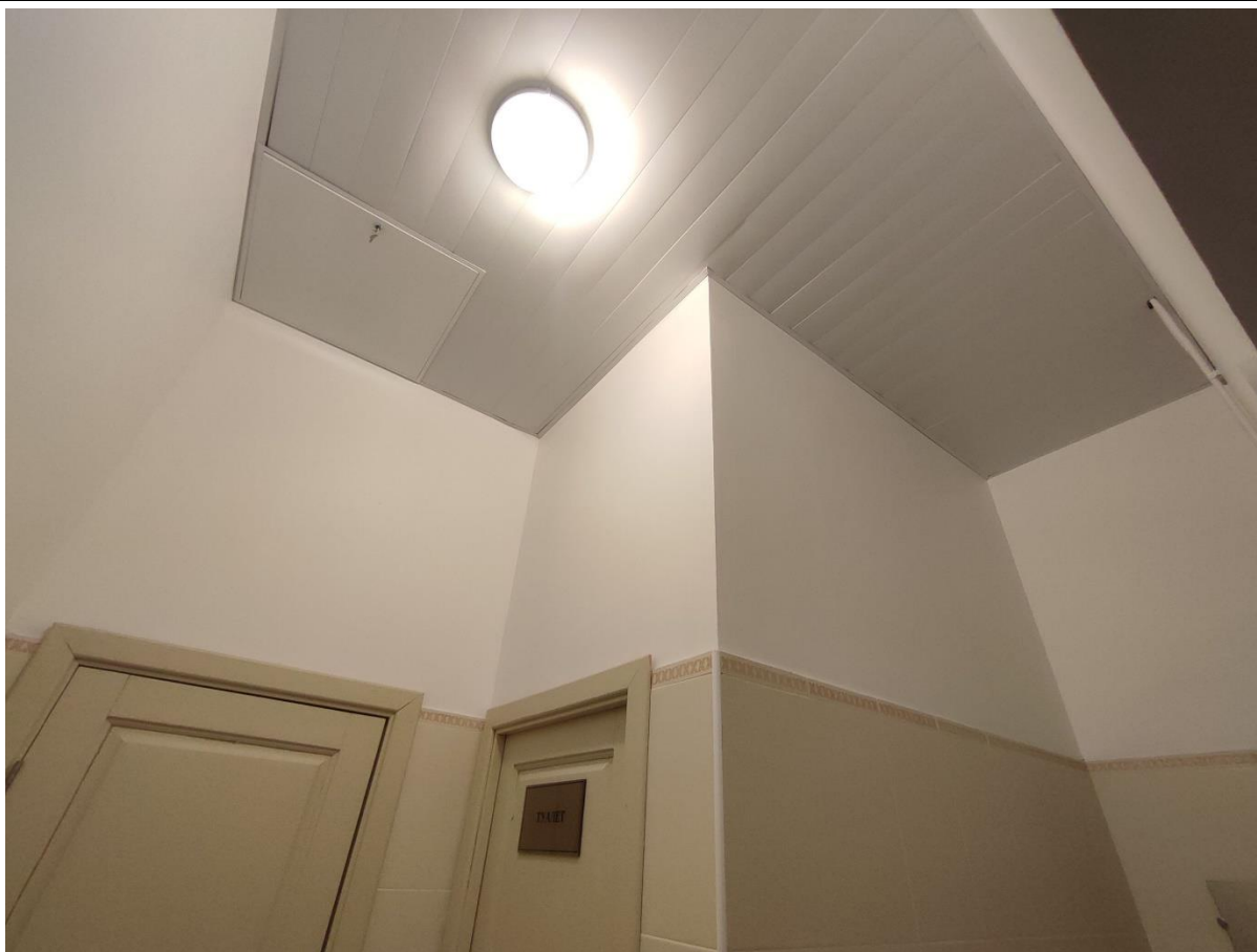
31. Общий вид пом. 1-Н (64) в уровне 2-го этажа.
