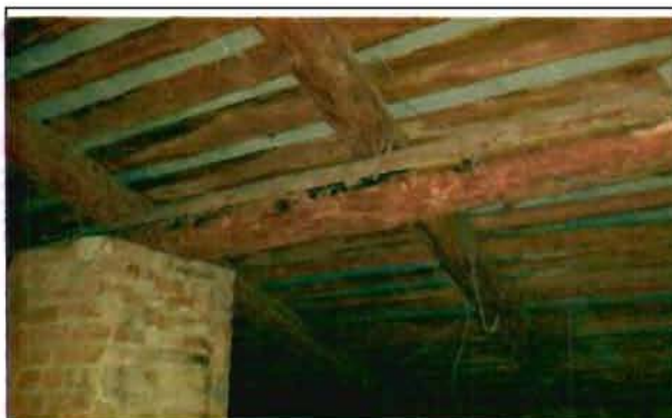
Фото 62. Конструкции крыши. Общий вид.
