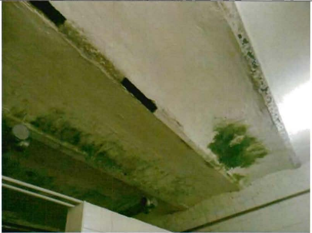
Своды по металлическим балкам. Съемка 27.11.2012, Воронина Н.В.
