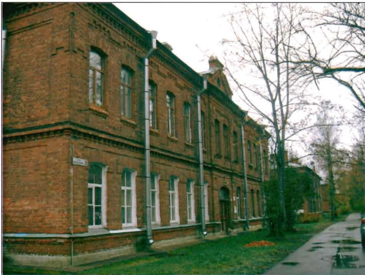
Фото 146. Западный фасад. Общий вид.
