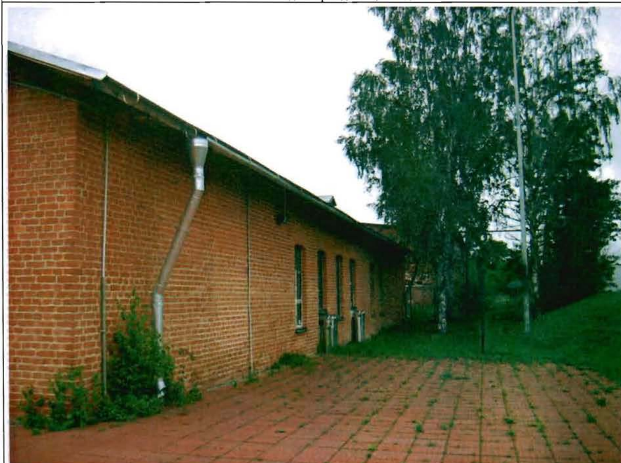
Фото 19. Восточный фасад. Общий вид.
