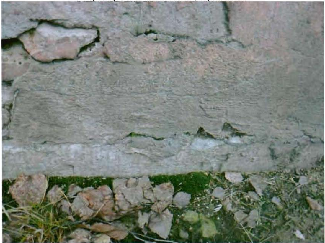
Цоколь, облицованный известняковой скобой. Съемка 27.11.2012, Воронина Н.В.
