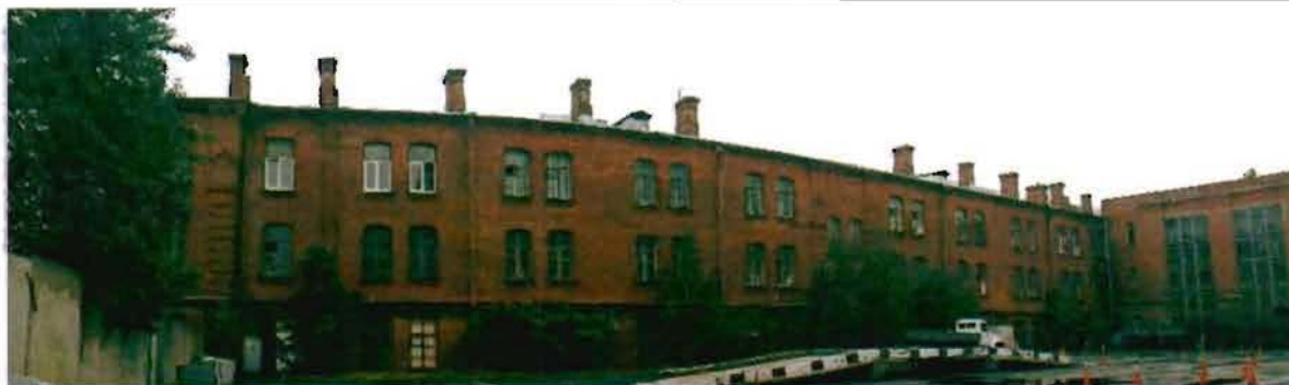
Фото 29. Западный фасад. Общий вид.
