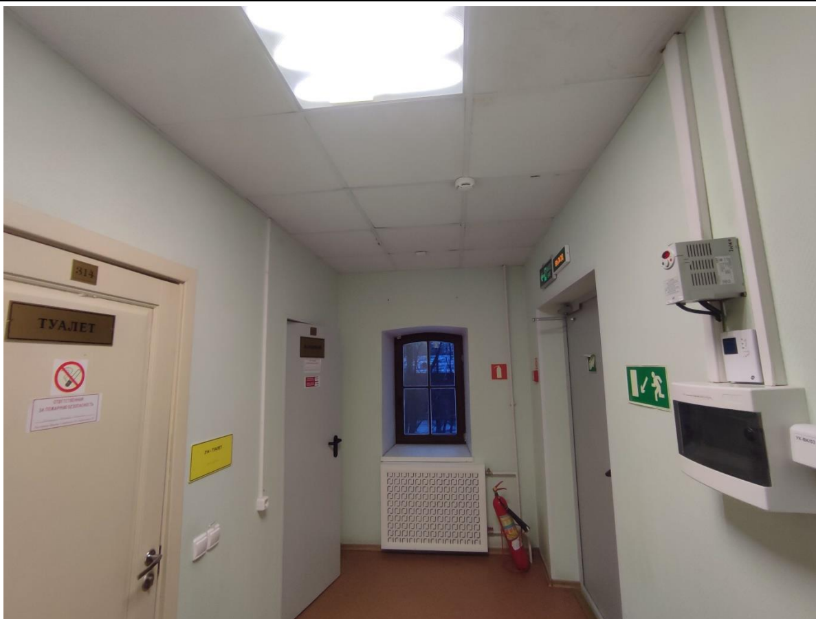
35. Фрагмент пом. 1-Н (113) в уровне 3-го этажа.
