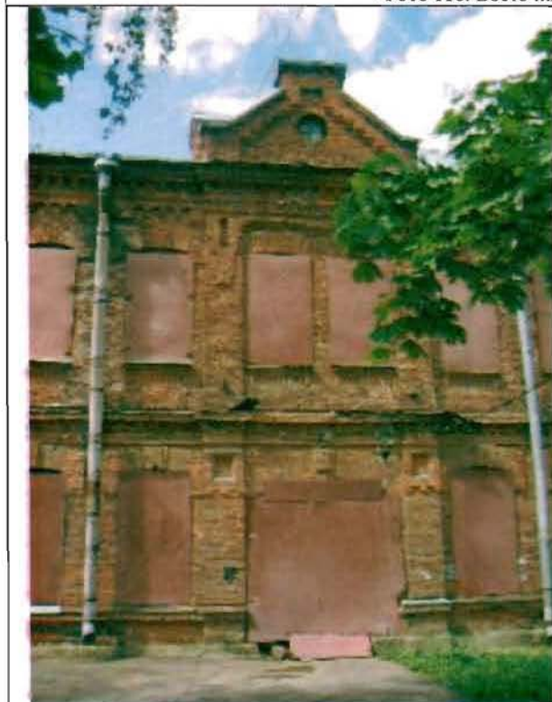
Фото 117. Восточный фасад. Фрагмент центральной части фасада.
