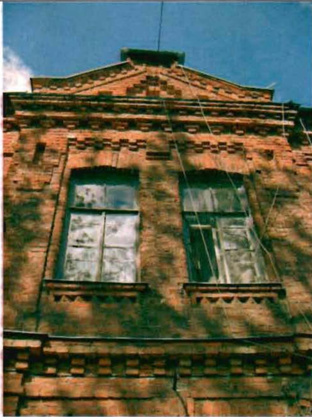
Фото 177. Восточный фасад. Центральная часть. Фрагмент.
