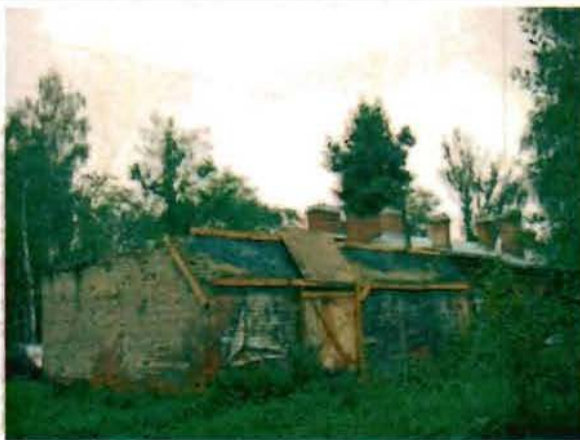
Фото 186. Западный, северный фасады. Общий вид.
