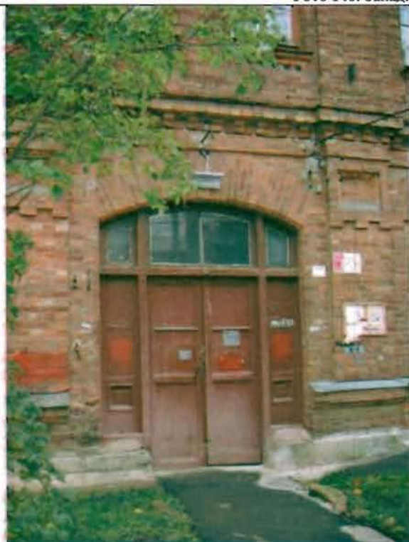
Фото 147. Дверной проем западного фасада. Общий вид.
