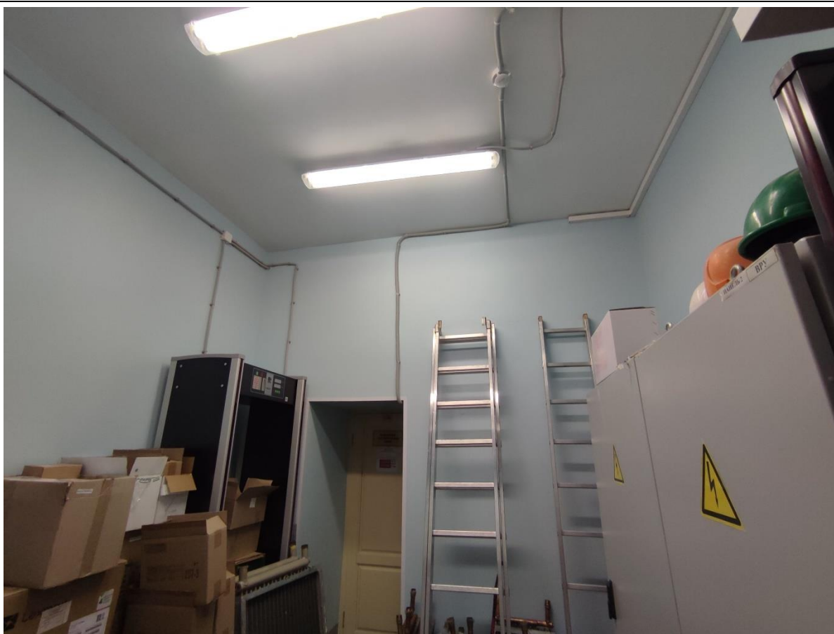
11. Общий вид пом. 1-Н (52) в уровне 1-го этажа.
