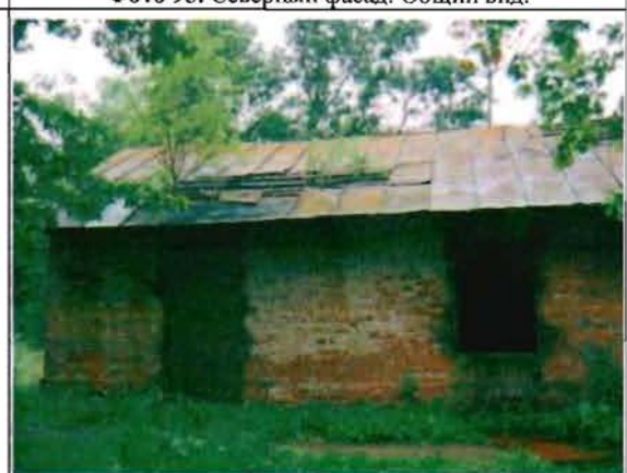
Фото 97. Южный фасад. Общий вид.
