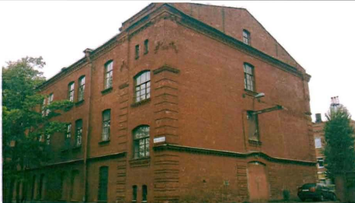
Фото 30. Северный фасад. Общий вид.
