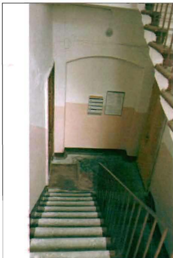
Фото 130. Лестница № 1 в южной части здания. Общий вид.
