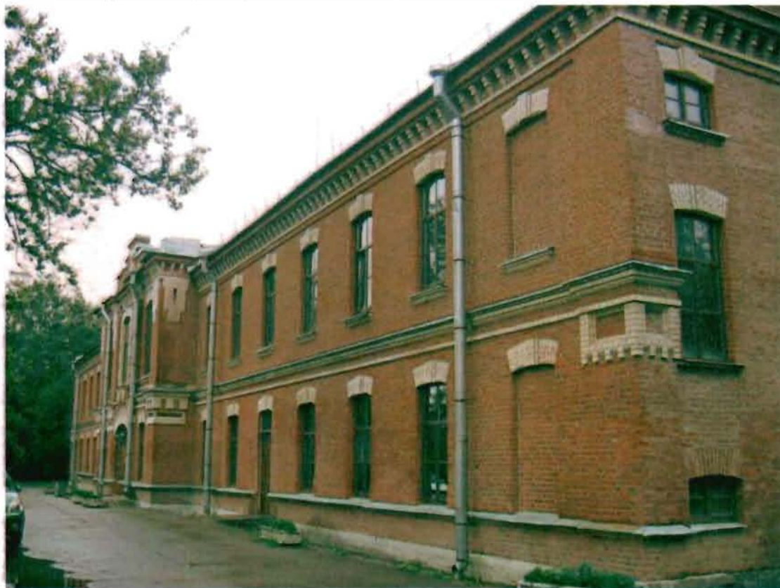
Фото 64. Северный фасад. Общий вид.
