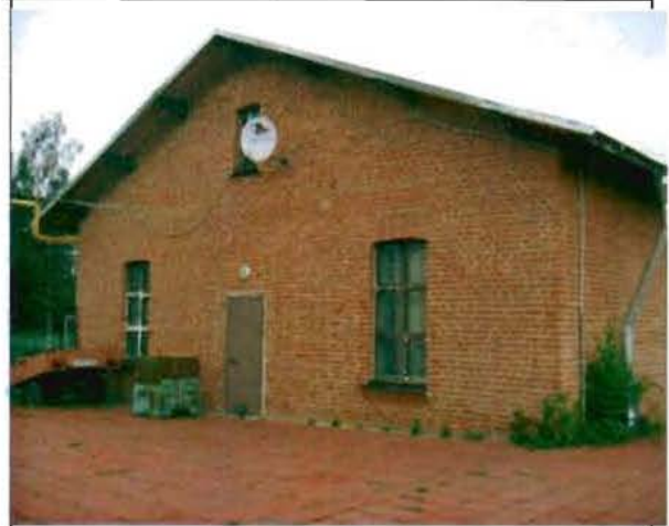
Фото 21. Южный фасад. Общий вид.
