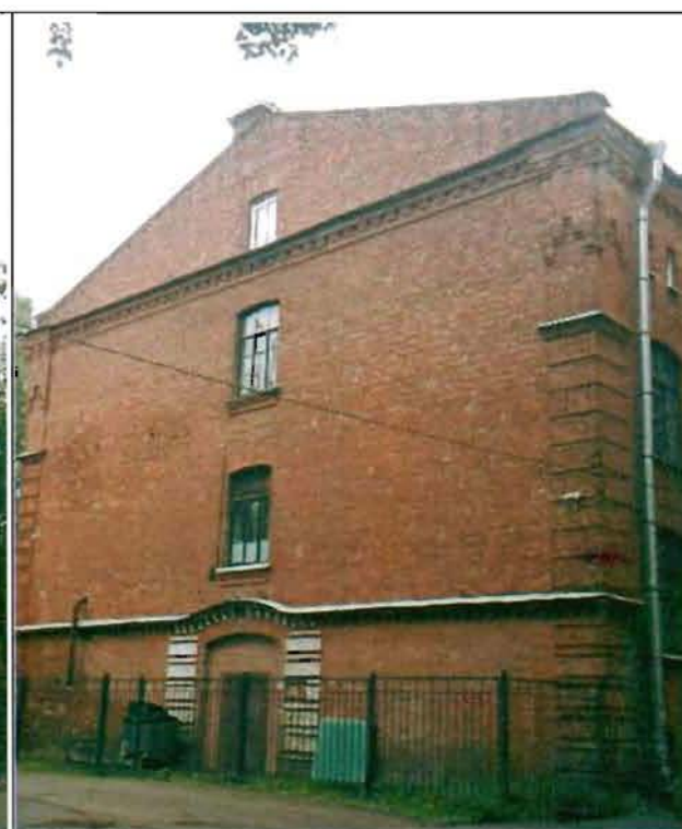
Фото 50. Южный фасад. Общий вид.
