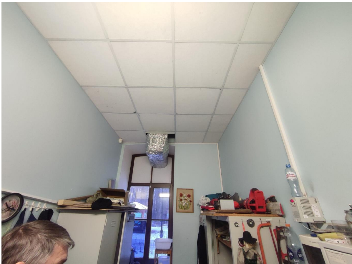
15. Общий вид пом. 1-Н (32) в уровне 1-го этажа.
