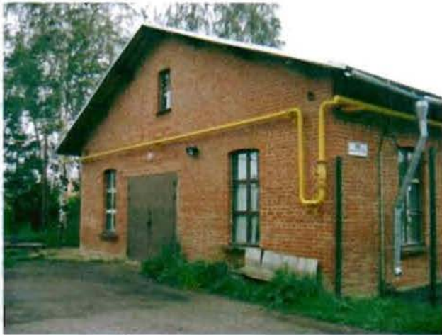
Фото 20. Северный фасад. Общий вид.
