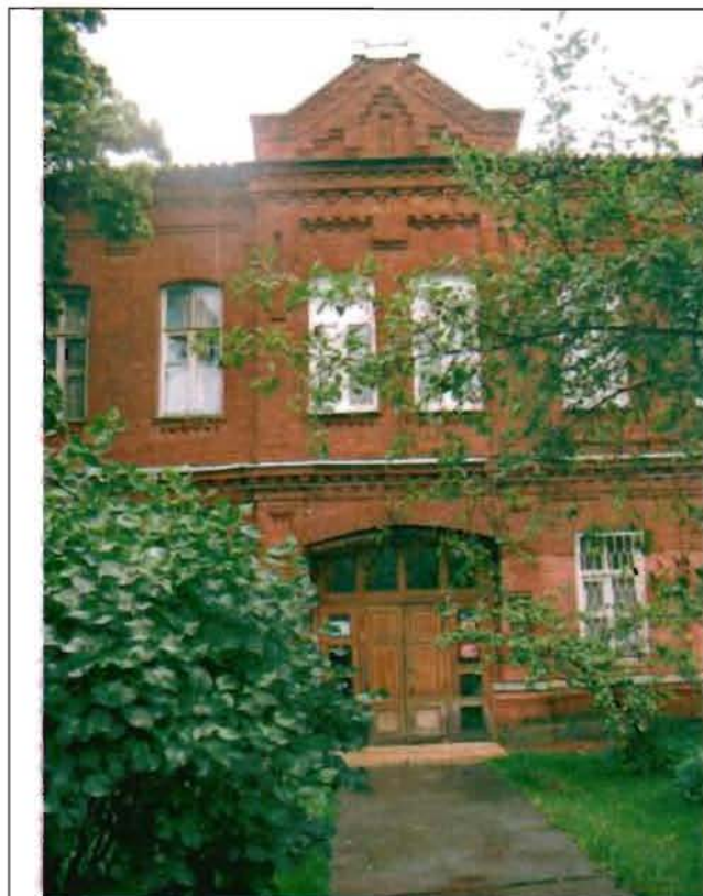
Фото 90. Восточный фасад. Центральная часть. Общий вид.
