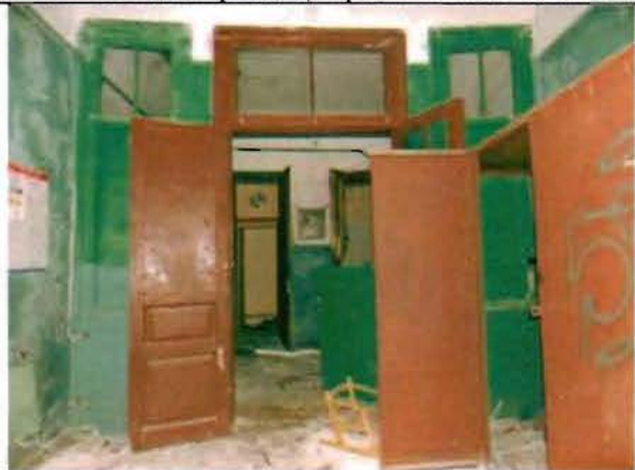
Фото 101. Дверной проем тамбура. Общий вид.
