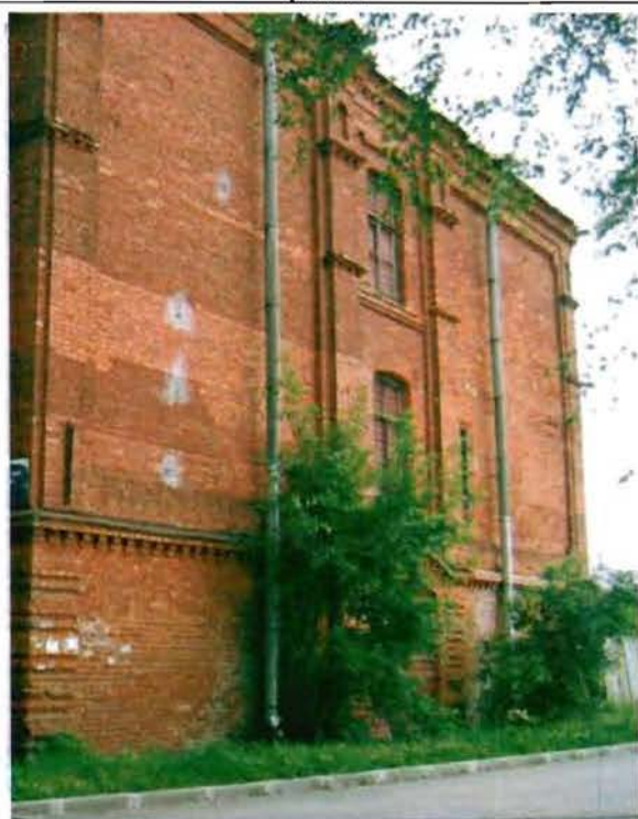
Фото 5. Южный фасад. Общий вид.
