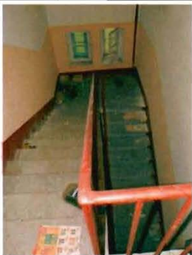
Фото 124. Лестница в южной части здания. Общий вид.
