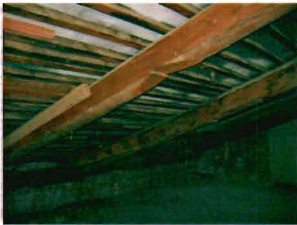
Фото 151. Конструкции крыши. Фрагмент.
