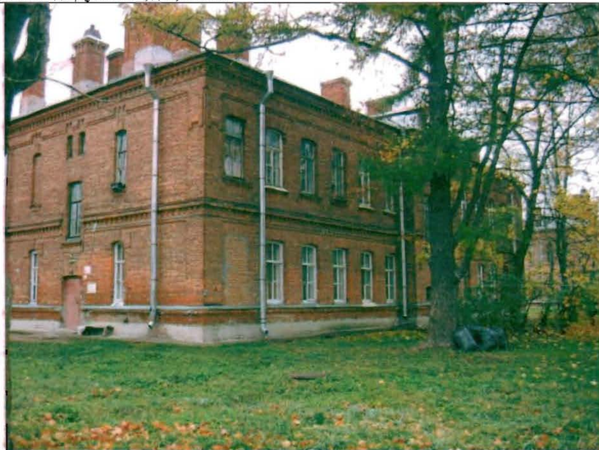
Фото 145. Восточный фасад. Общий вид.
