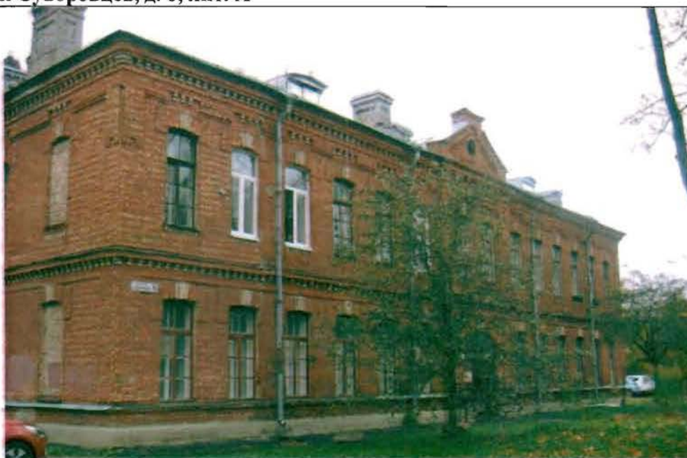
Фото 103. Восточный фасад. Общий вид.
