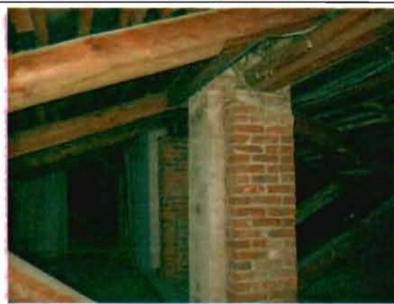
Фото 142. Конструкции крыши. Фрагмент.
