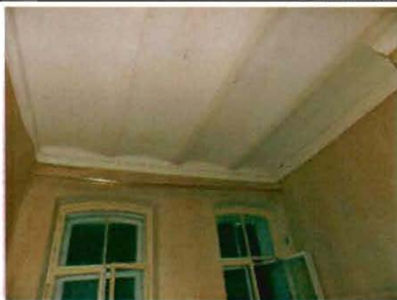
Фото 120. Помещение 1-го этажа. Общий вид.
