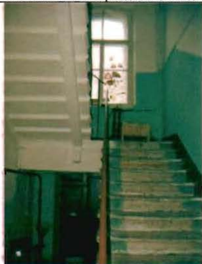
Фото 168. Лестница в южной части здания. Общий вид.
