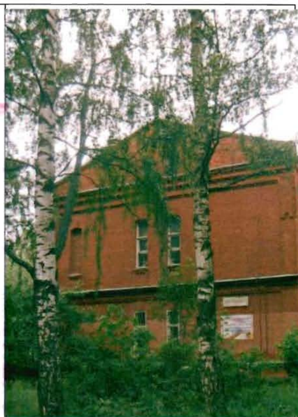
Фото 91. Северный фасад. Общий вид.
