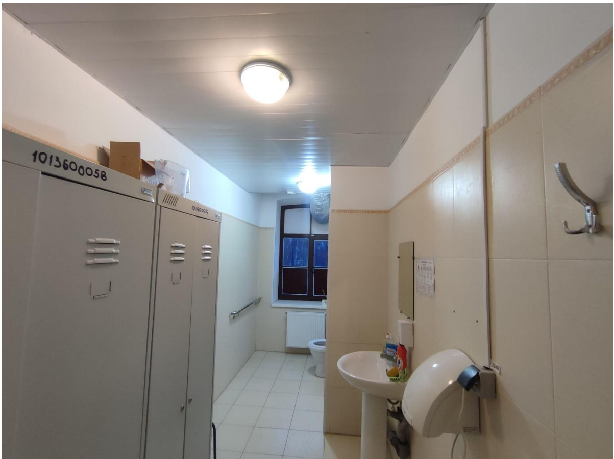
45. Общий вид пом. 1-Н (103) в уровне 3-го этажа.
