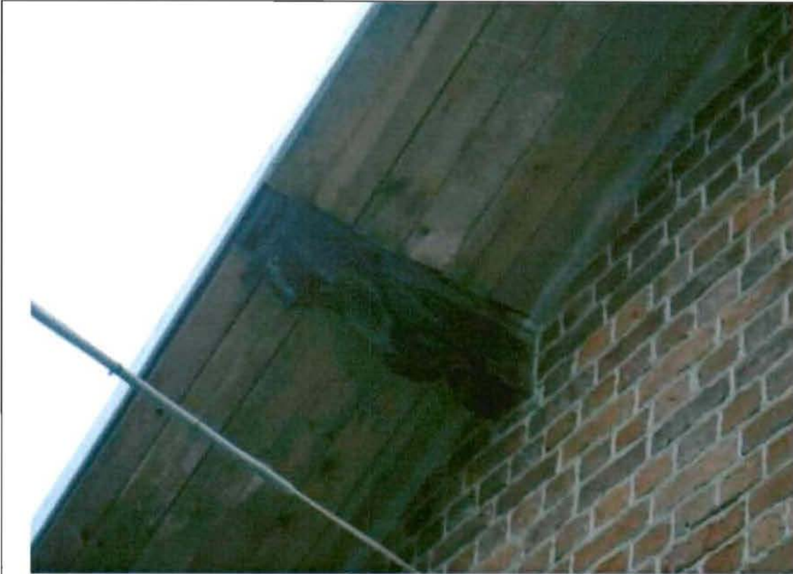
Деревянные кобылки. Съёмка 20.11.2012, Воронина Н.В.
