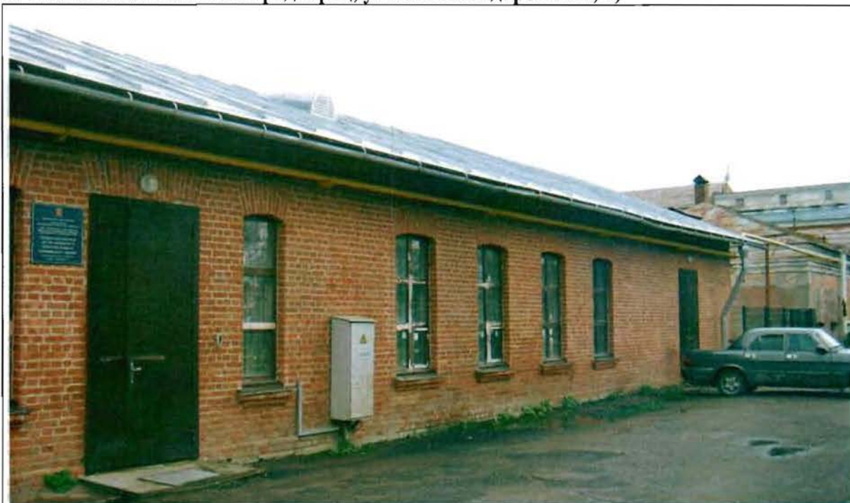
Фото 18. Западный фасад. Общий вид.
