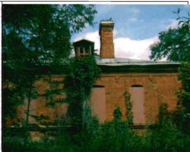
Фото 100. Южный фасад. Фрагмент.
