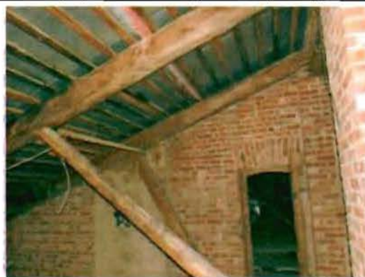
Фото 127. Конструкции крыши. Общий вид.
