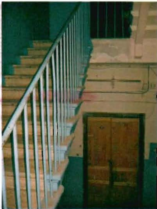
Фото 143. Лестница № 1 в северной части здания. Общий вид.
