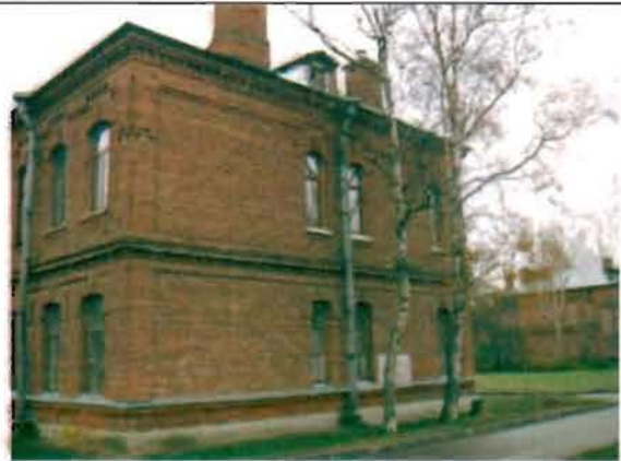
Фото 160. Северный фасад. Общий вид.
