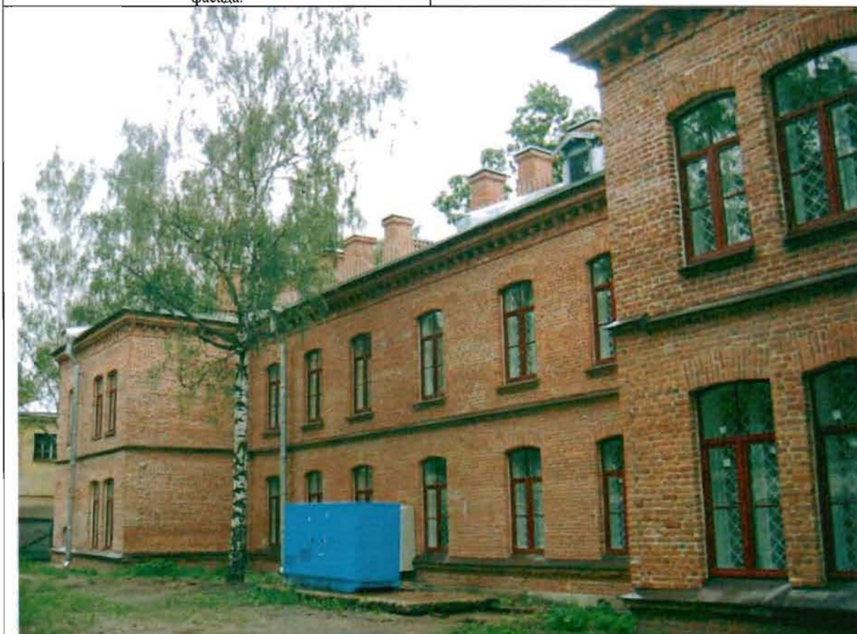
Фото 42. Западный фасад. Общий вид.
