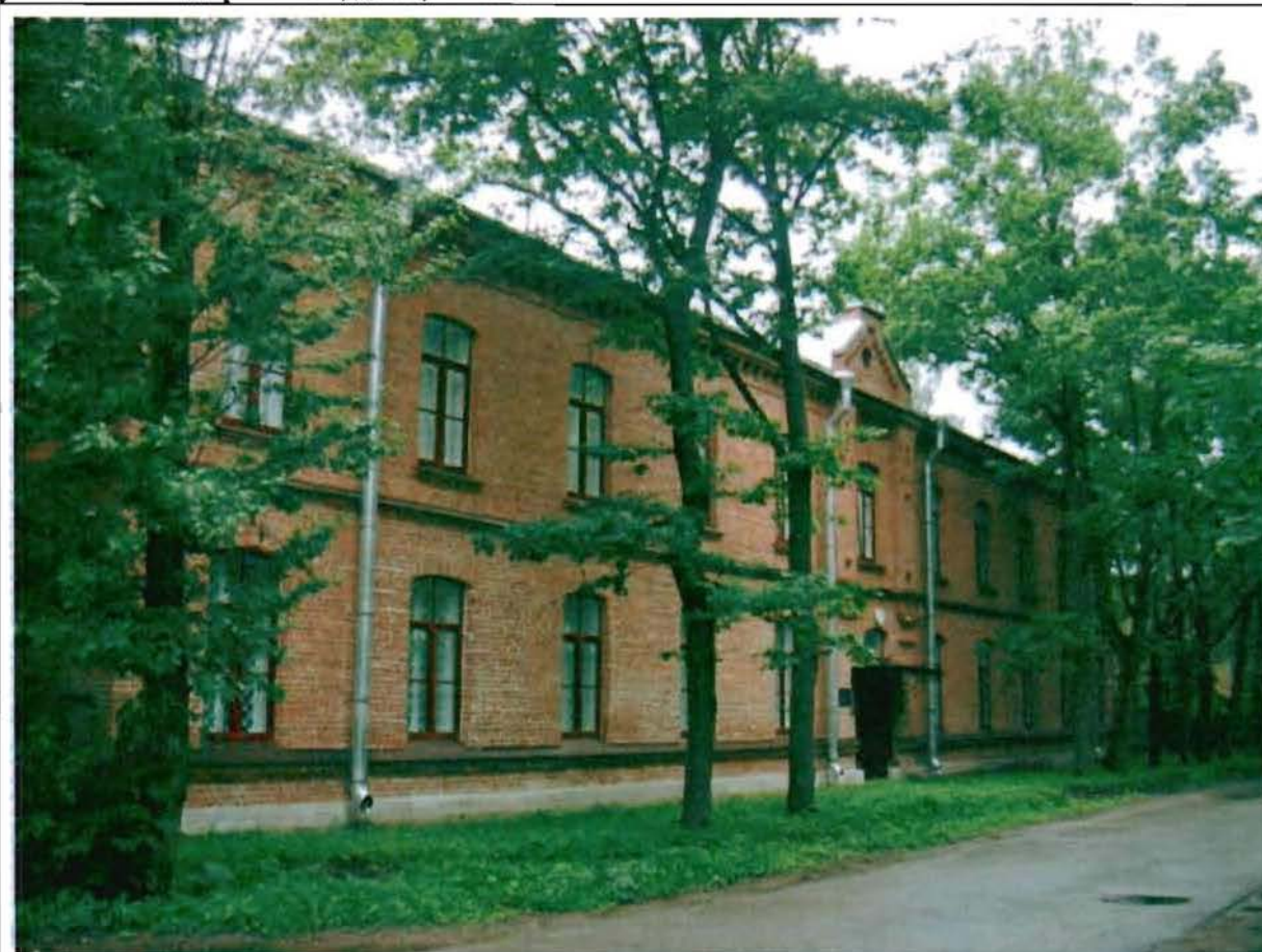
Фото 39. Восточный фасад. Общий вид.
