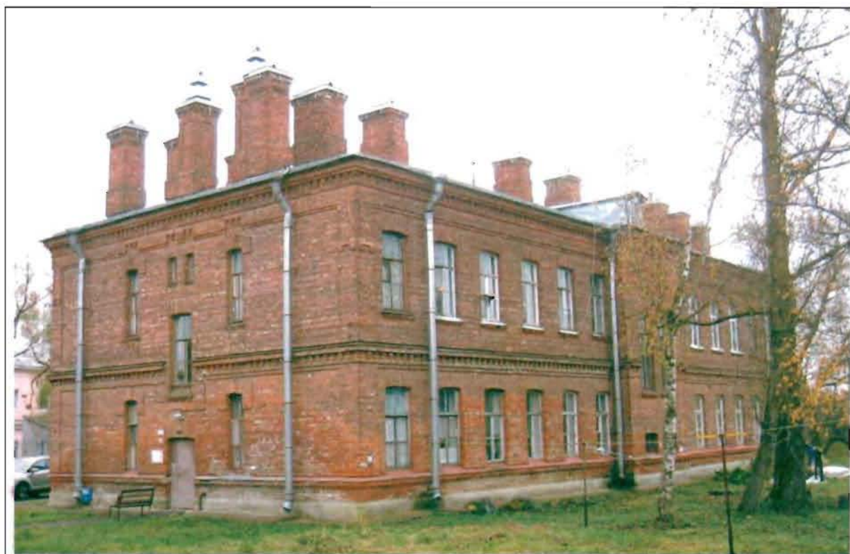
Фото 129. Западный, северный фасады. Общий вид.
