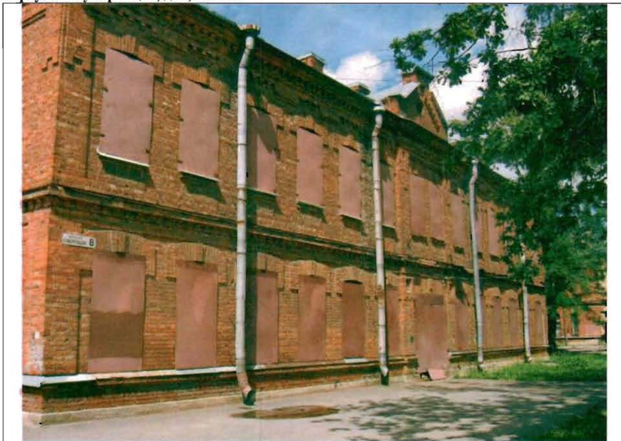
Фото 116. Восточный фасад. Общий вид.
