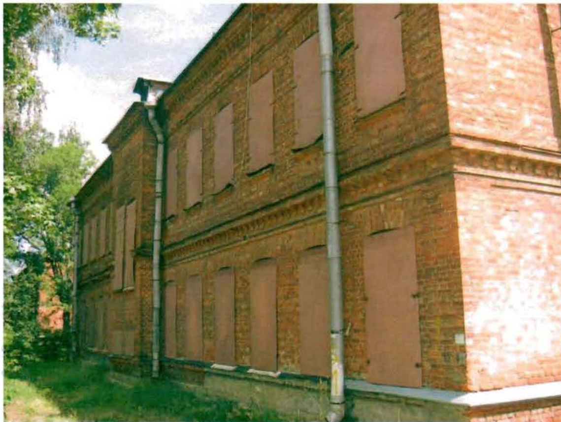
Фото 119. Западный фасад. Общий вид.
