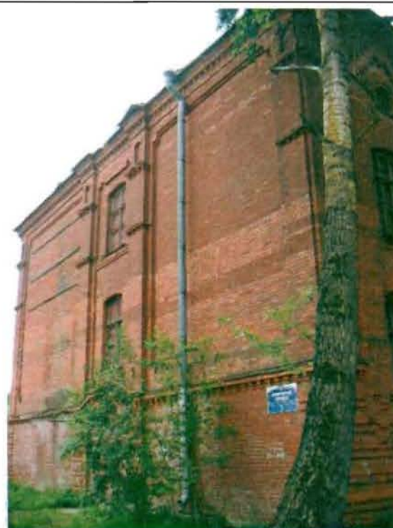
Фото 6. Северный фасад. Общий вид.
