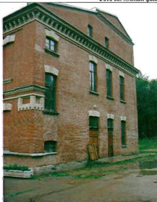
Фото 67. Западный фасад. Общий вид.
