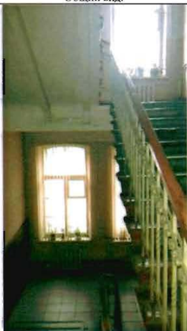
Фото 35. Интерьер. Лестница. Общий вид.
