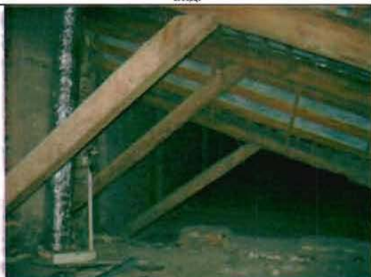
Фото 76. Конструкции крыши. Общий вид.
