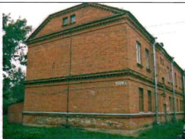
Фото 85. Восточный фасад. Общий вид.
