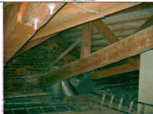
Фото 77. Конструкции крыши. Общий вид.
