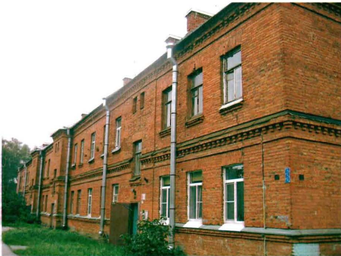
Фото 83. Северный фасад. Общий вид.
