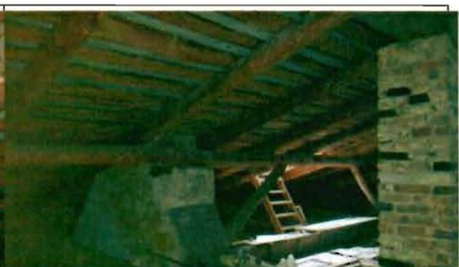
Фото 63. Конструкции крыши. Общий вид.
