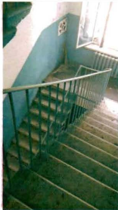
Фото 144. Лестница № 2 в южной части здания. Общий вид.
