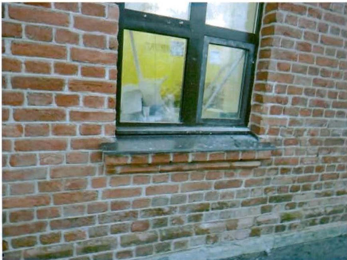
Ступенчатые подоконные доски. Съемка 20.11.2012, Воронина Н.В.
