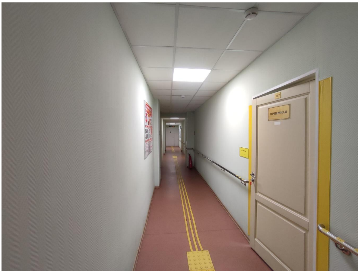
34. Общий вид пом. 1-Н (113) в уровне 3-го этажа.
