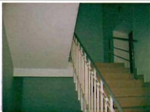
Фото 74. Интерьер. Лестница в восточной части здания. Общий вид.
