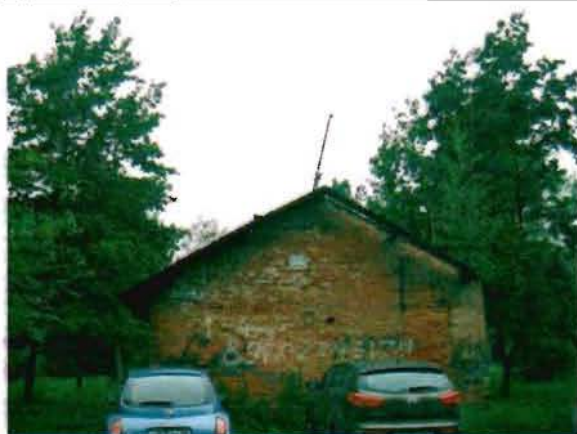
Фото 94. Восточный фасад. Общий вид.
