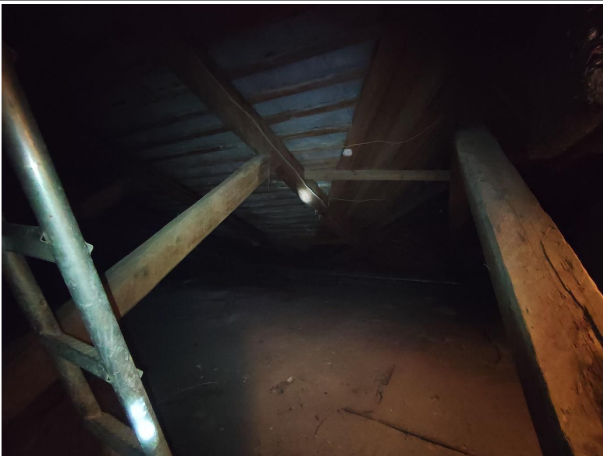
48. Фрагмент стропильной системы крыши в центральной части чердака.
