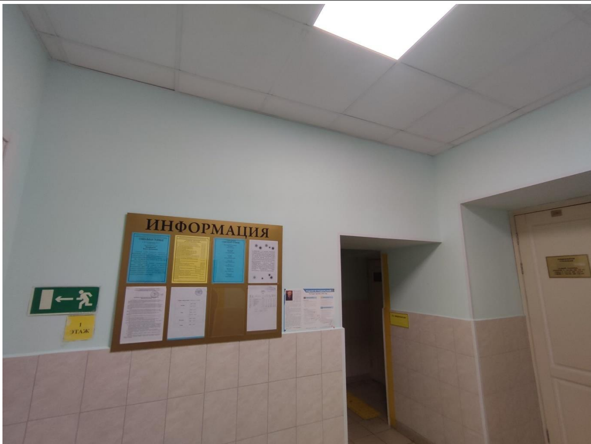
19. Общий вид пом. 1-Н (29) в уровне 1-го этажа.
