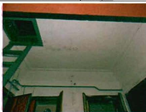
Фото 102. Отделка потолка тамбура. Общий вид.
