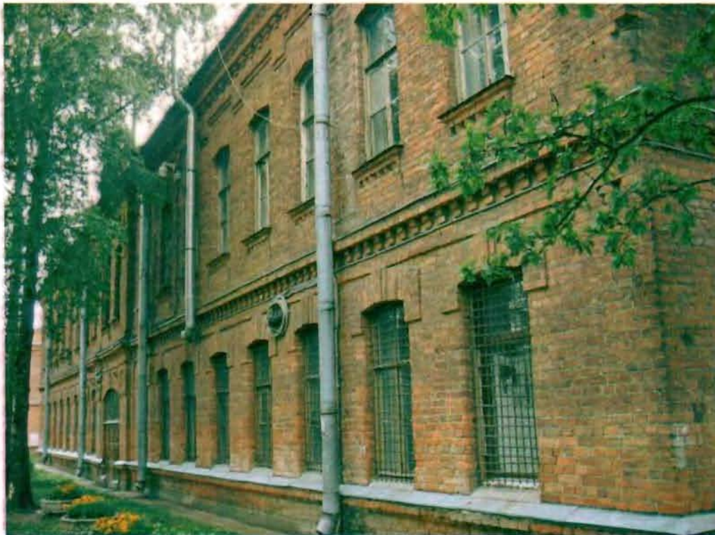
Фото 163. Восточный фасад. Общий вид.
