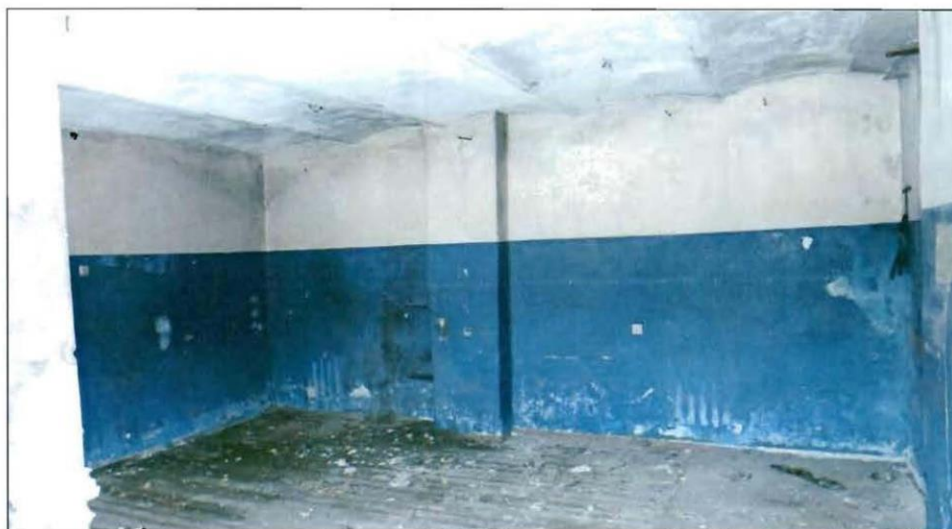
3. Санкт-Петербург, г. Кронштадт, Кронштадтское шоссе, д. 30, лит. Б. Перекрытие.
