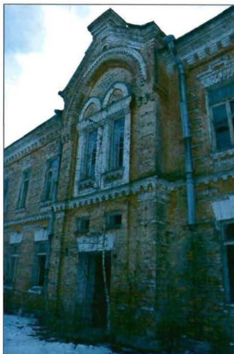
9. Санкт-Петербург, г. Кронштадт, Кронштадтское шоссе, д. 30, лит. Е. Северный фасад. Фрагмент.
