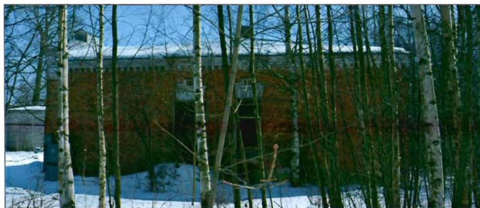
13. Санкт-Петербург, г. Кронштадт, Кронштадтское шоссе, д. 30, лит. Ж. Западный фасад.
