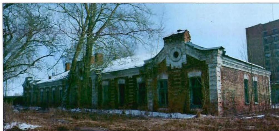
5. Санкт-Петербург, г. Кронштадт, Кронштадтское шоссе, д. 30, лит. Д. Общий вид с запада.
