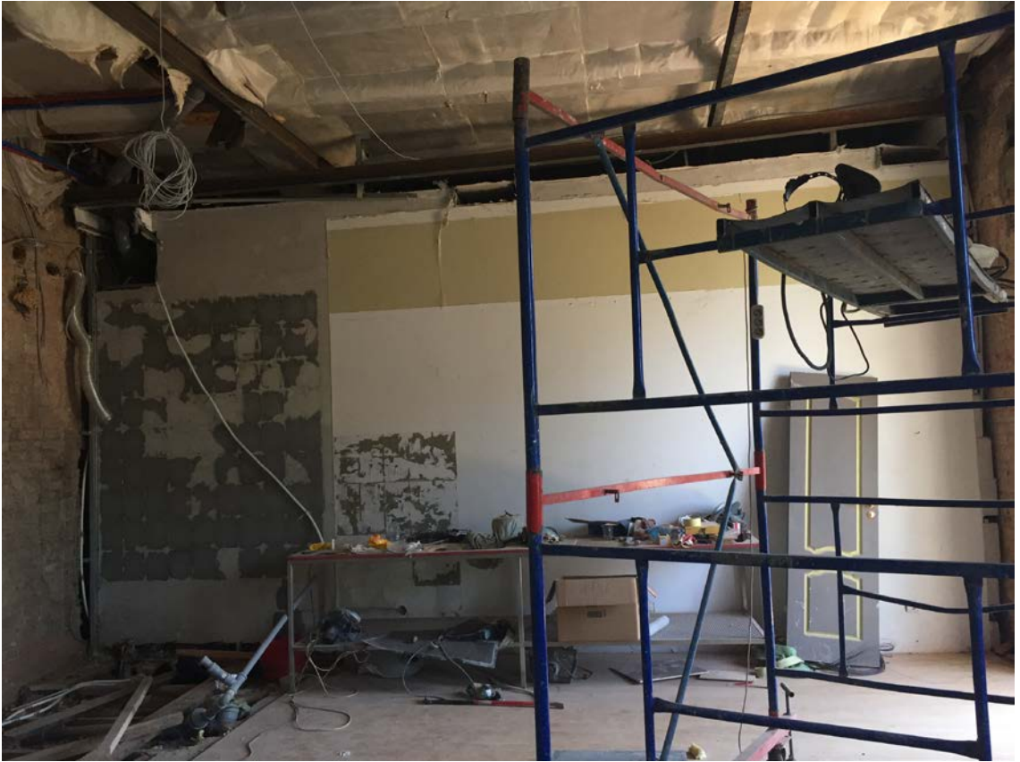
Фото 1. Объект культурного наследия регионального значения «Дом А.Б. Фитингофа». Интерьер пом. №2. Вид на юг. Дата съемки 29.06.2022
