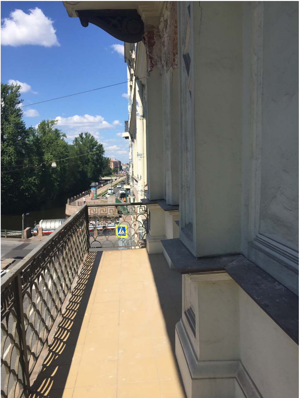
Фото 11. Объект культурного наследия регионального значения «Дом А.Б. Фитингофа». Балкон. Вид в сторону севера. Дата съемки 29.06.2022
