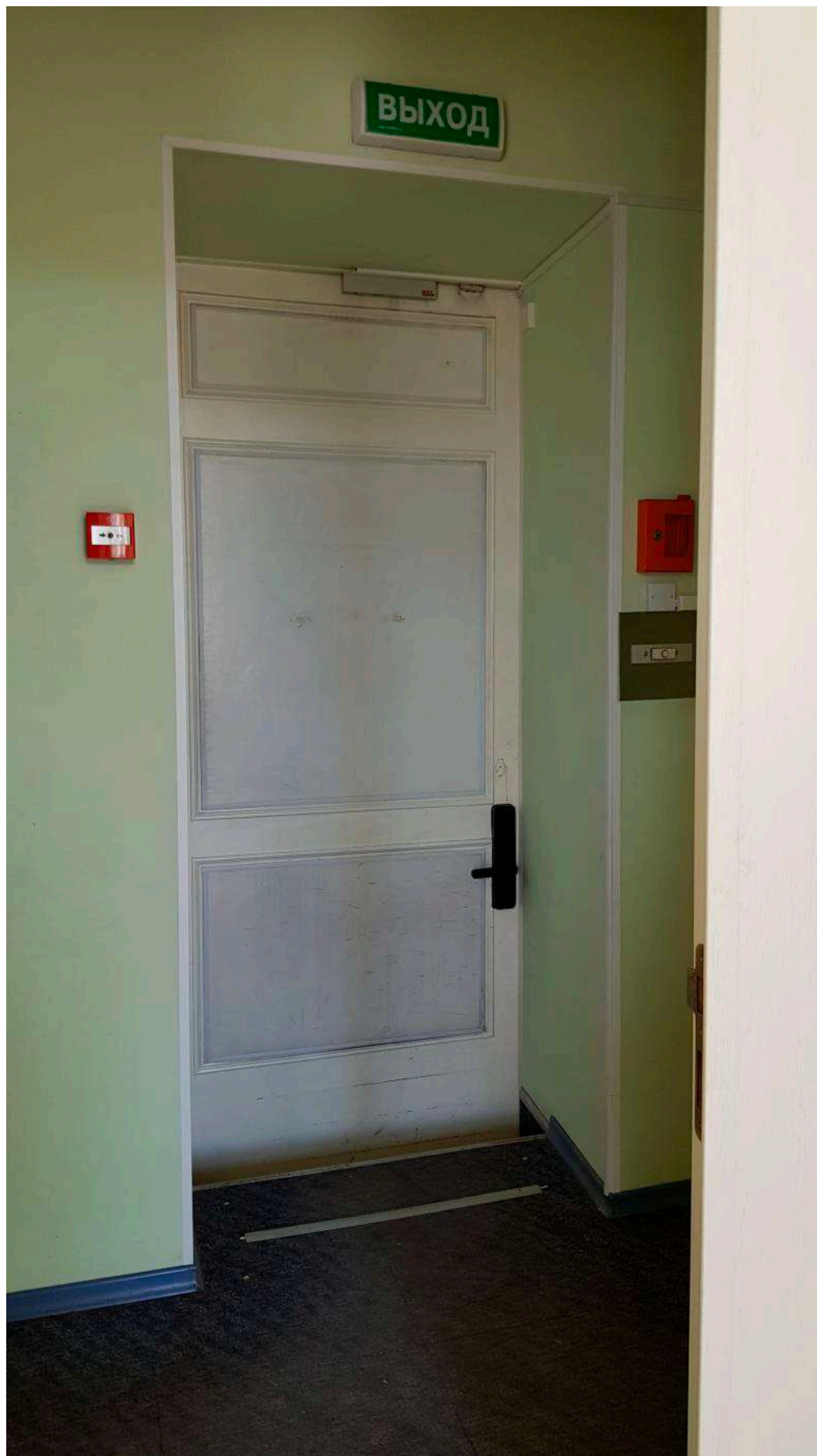
Фото 21. Общий вид части пом. 26-Н (№ 3 по ПИБ), элементы ДПИ отсутствуют.
