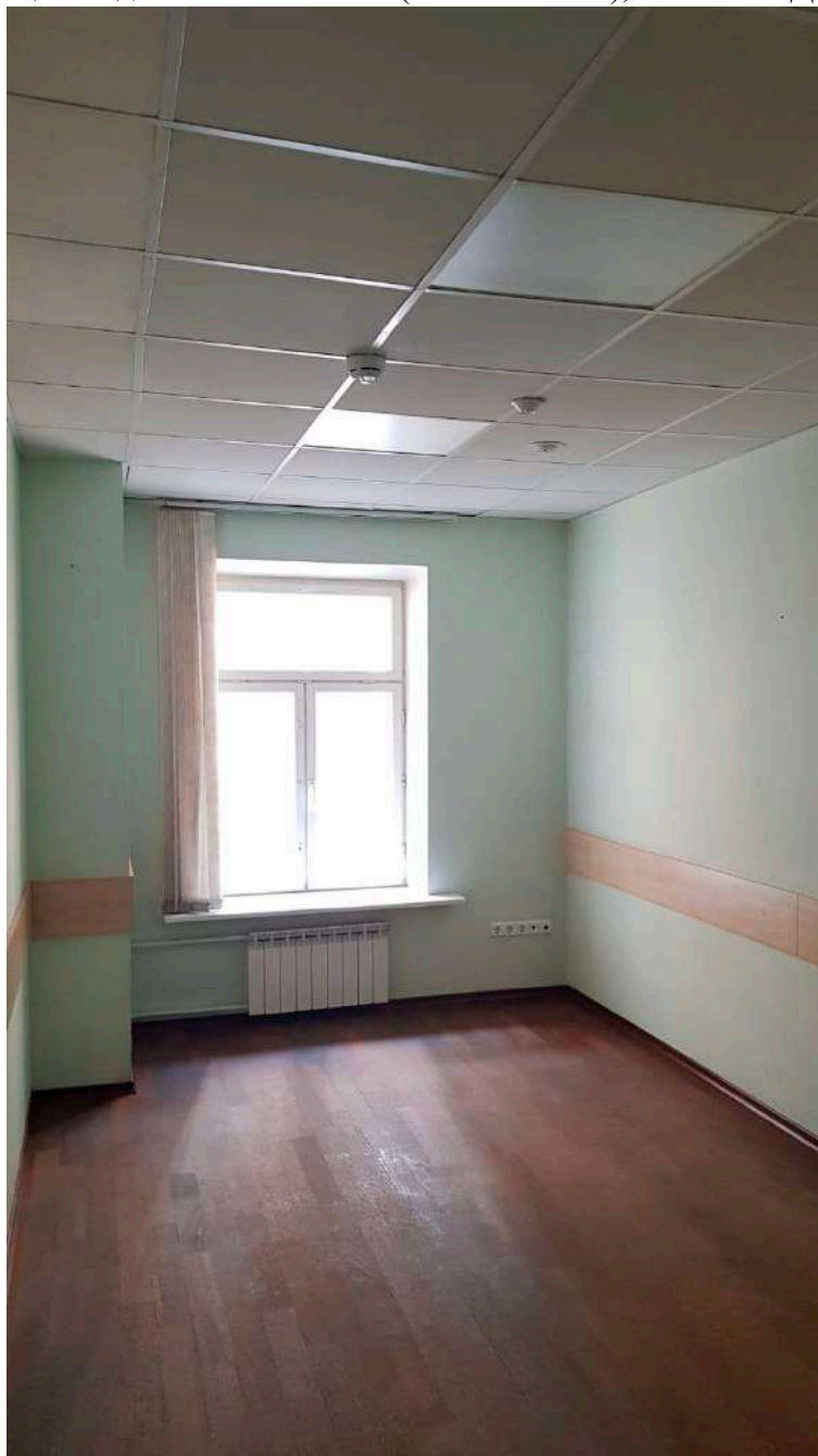
Фото 7. Общий вид части пом. 26-Н (№ 12 по ПИБ), элементы ДПИ отсутствуют.
