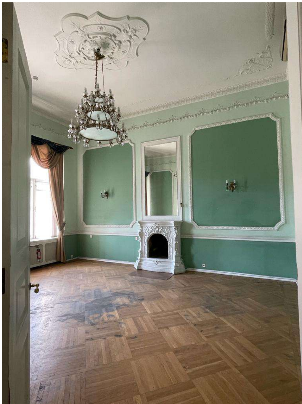
Фото 40. Общий вид части пом. 26-Н (№ 43 по ПИБ). Нижняя часть стен отделена профилированным карнизом; стены разбиты лепными орнаментированными тягами на филенки прямоугольной формы с вырезанными углами; в верхней части стен лепной пояс в виде цветочных гирлянд с лентами; потолок по периметру оформлен лепным орнаментальным поясом; в углах потолка лепные композиции, включающие изображение раковины, рога изобилия и птиц; в центре потолка лепная фигурная орнаментированная розетка.
