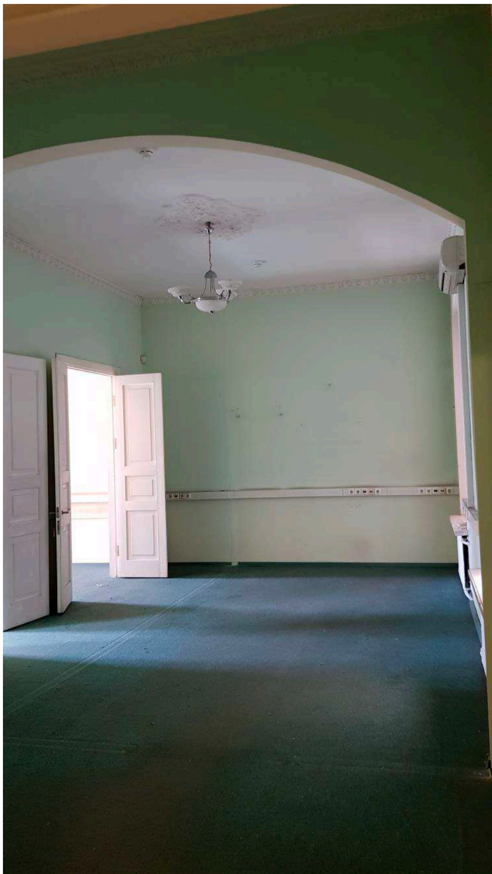
Фото 57. Общий вид части пом. 26-Н (№ 52 по ПИБ). Лепная орнаментированная розетка на потолке, орнаментированная тяга в верхней части стен.
