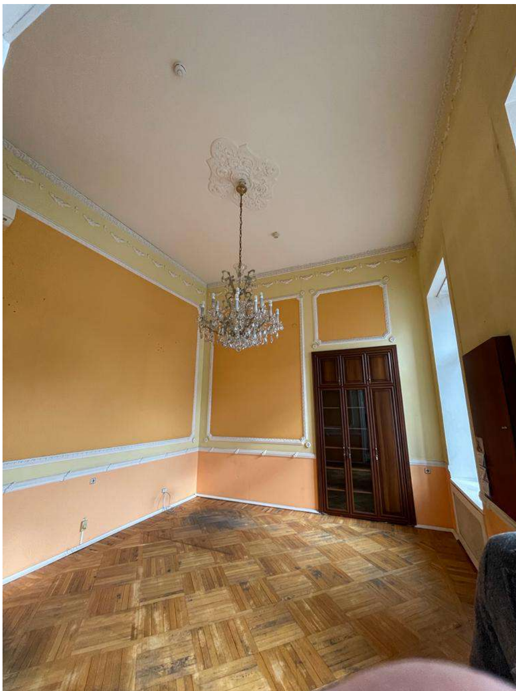
Фото 37. Общий вид части помещения 26-Н (№42 по ПИБ). Нижняя часть стен отделена профилированным карнизом, декорированным лепными листьями; стены разбиты лепными орнаментированными тягами на филенки прямоугольной формы с вырезанными углами; у вырезанных углов филенок расположены лепные розетки в виде цветков; в верхней части стен лепные цветочные гирлянды; в центре потолка лепная фигурная орнаментированная розетка.
