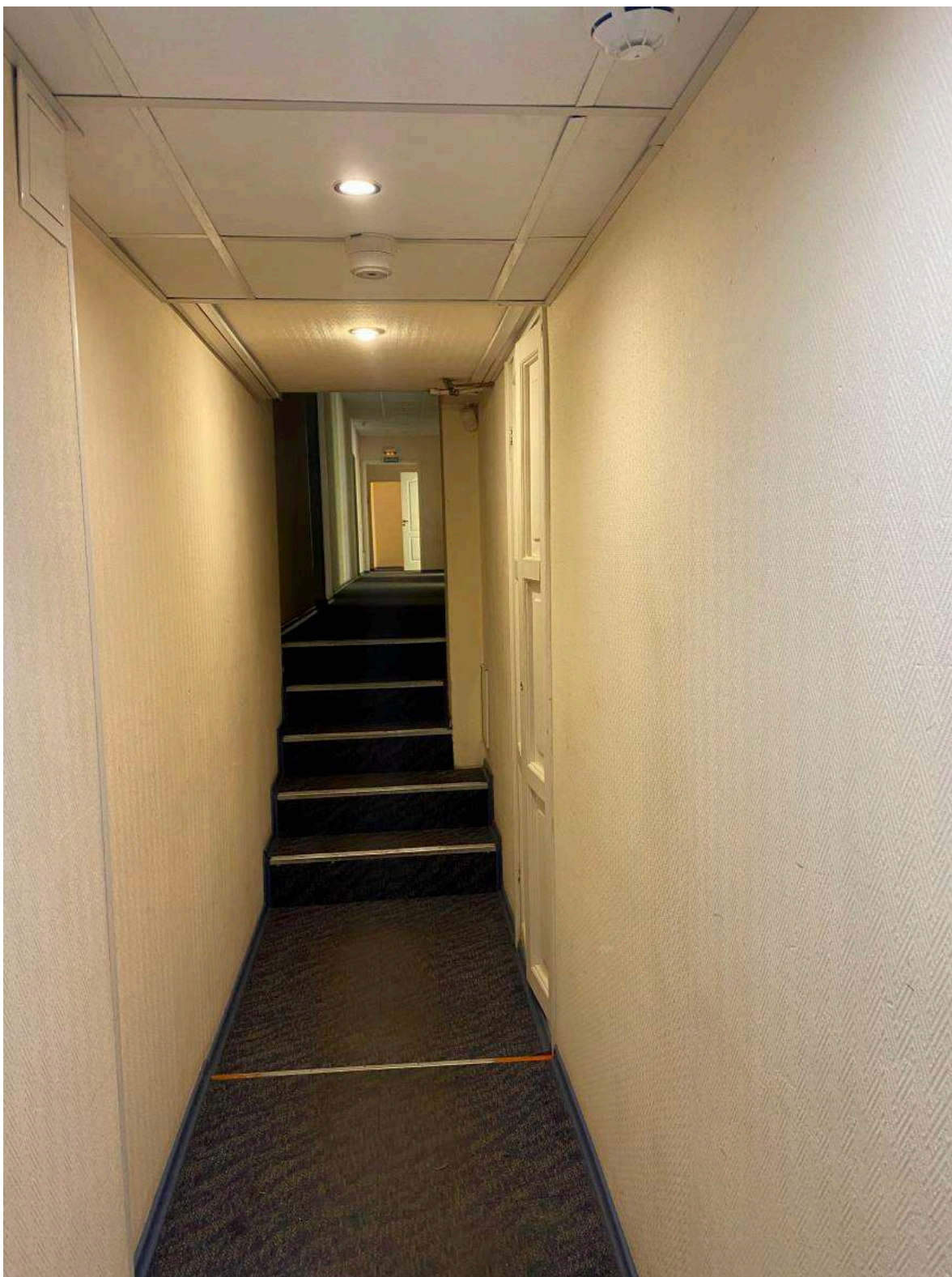
Фото 3. Общий вид части пом. 26-Н. Элементы ДПИ отсутствуют.
