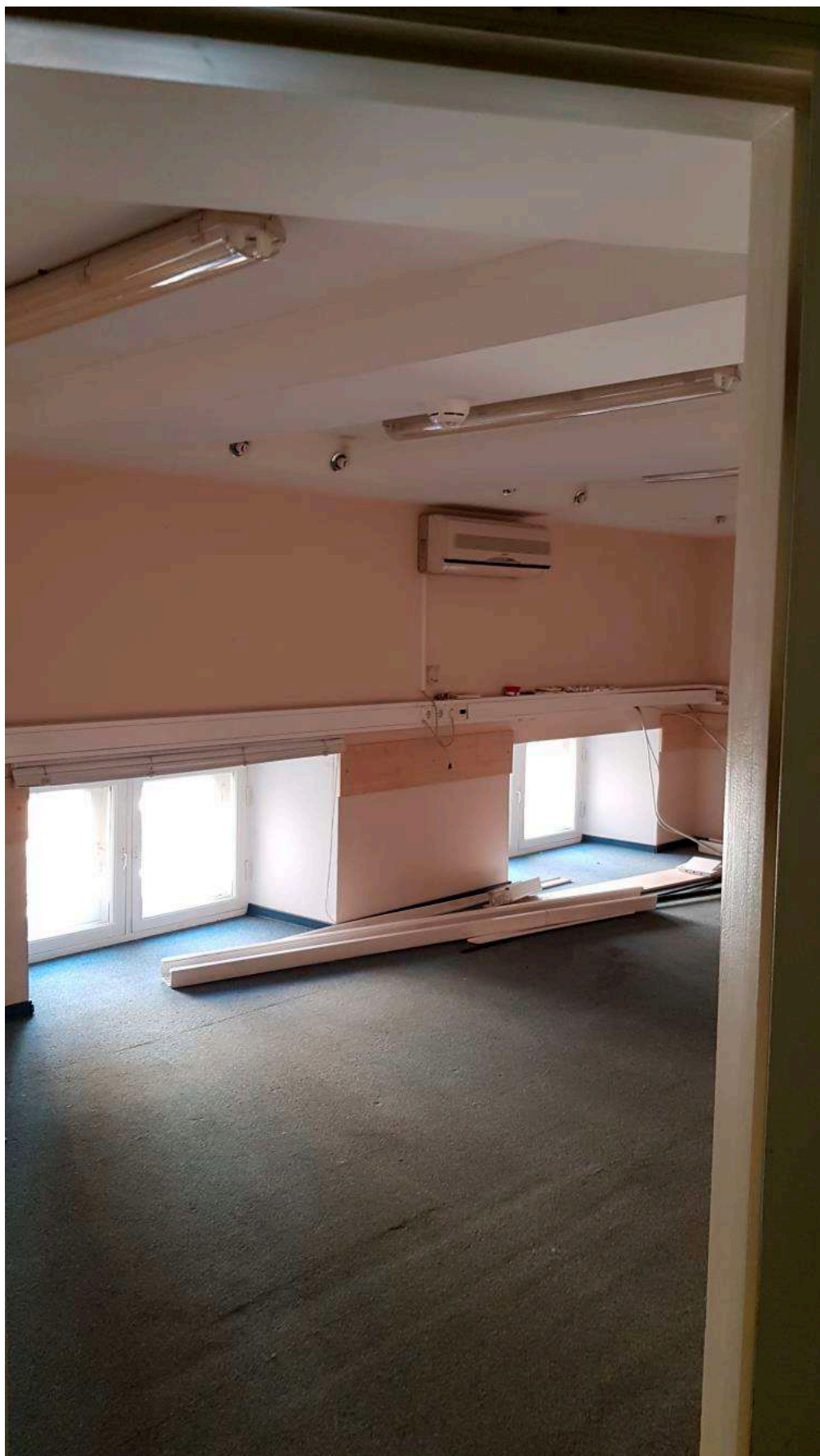
Фото 75. Общий вид части пом. 26-Н (№ 68 по ПИБ).
