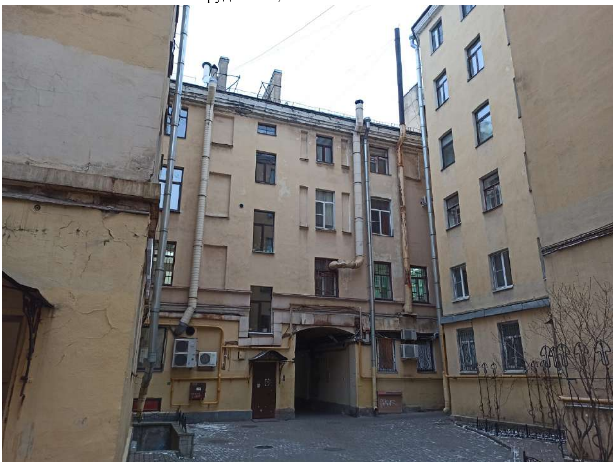
Фото 8. Вид на часть дворового фасада, наблюдается установка дополнительного оборудования, замена оконных заполнений.
