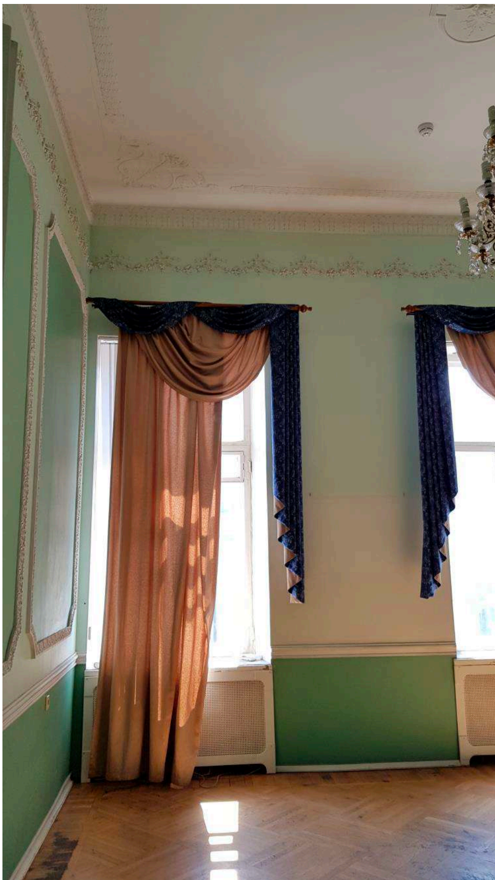
Фото 42. Общий вид части пом. 26-Н (№ 43 по ПИБ).
