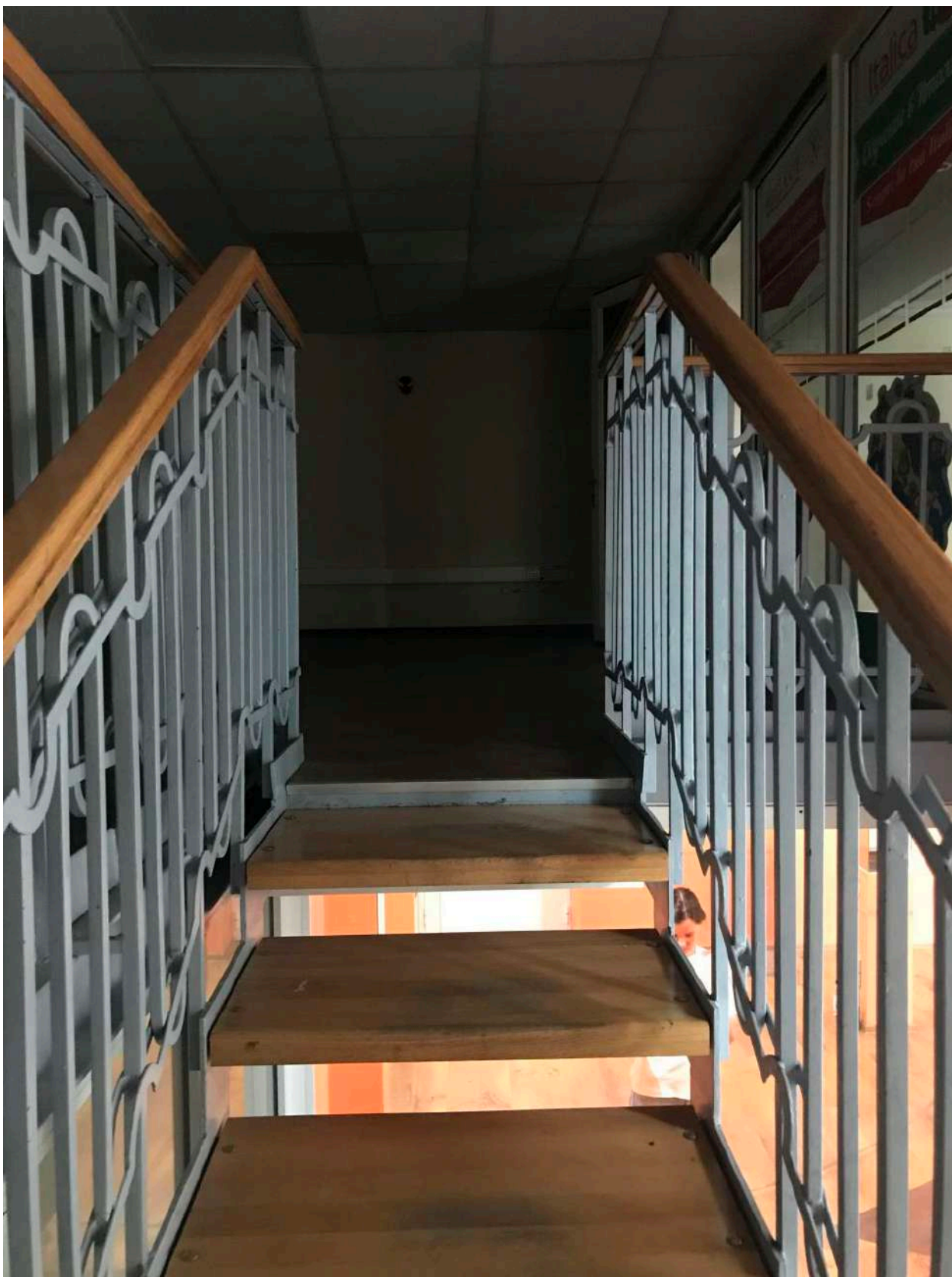
Фото 63. Общий вид части пом. 26-Н (№ 57 по ПИБ).
