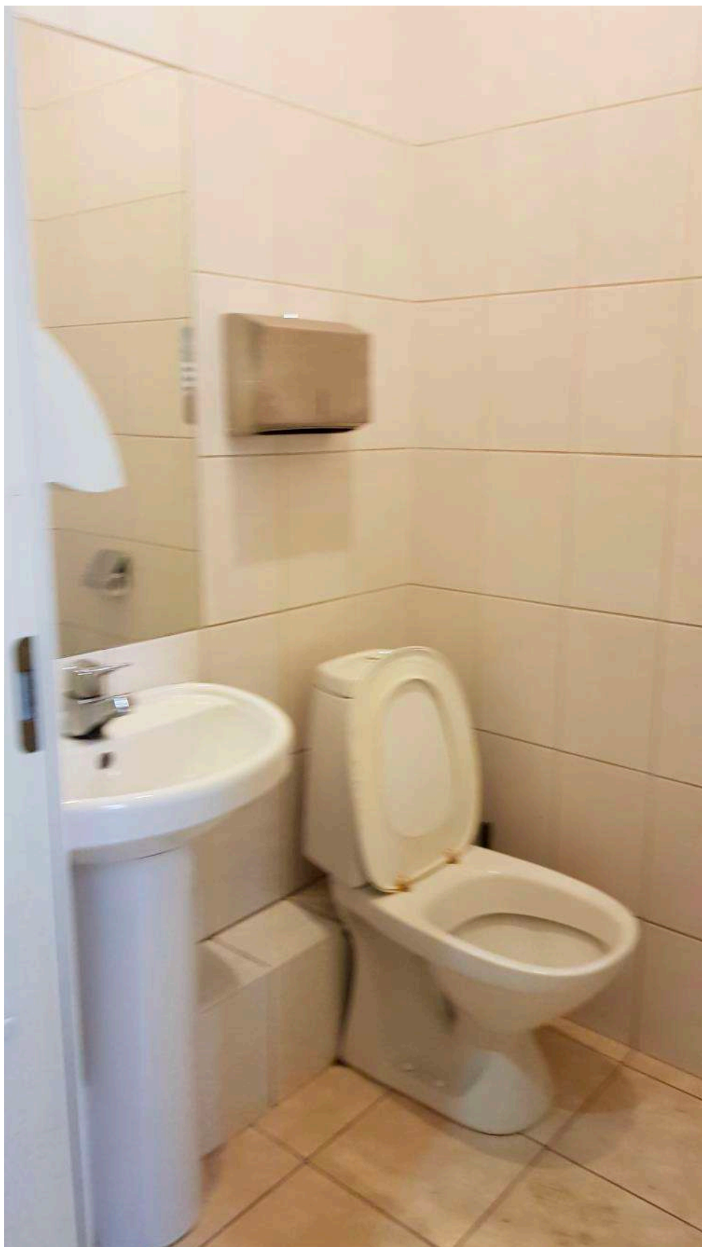
Фото 81. Общий вид части пом. 29-Н (№ 4 по ПИБ).
