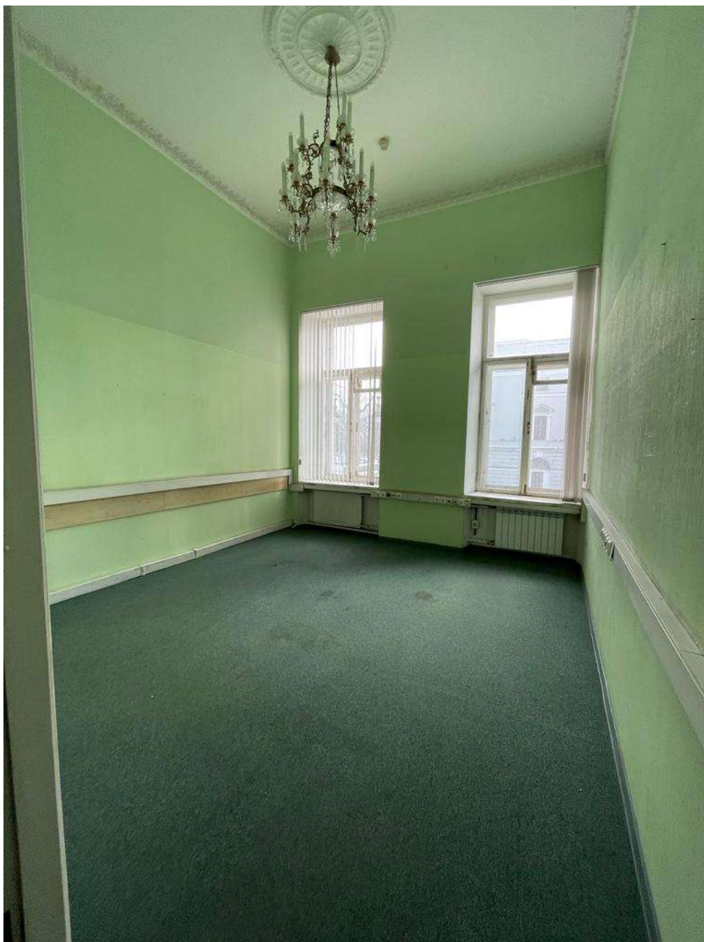
Фото 60. Общий вид части пом. 26-Н (№ 55 по ПИБ). Лепная орнаментированная розетка на потолке, орнаментированная тяга в верхней части стен.
