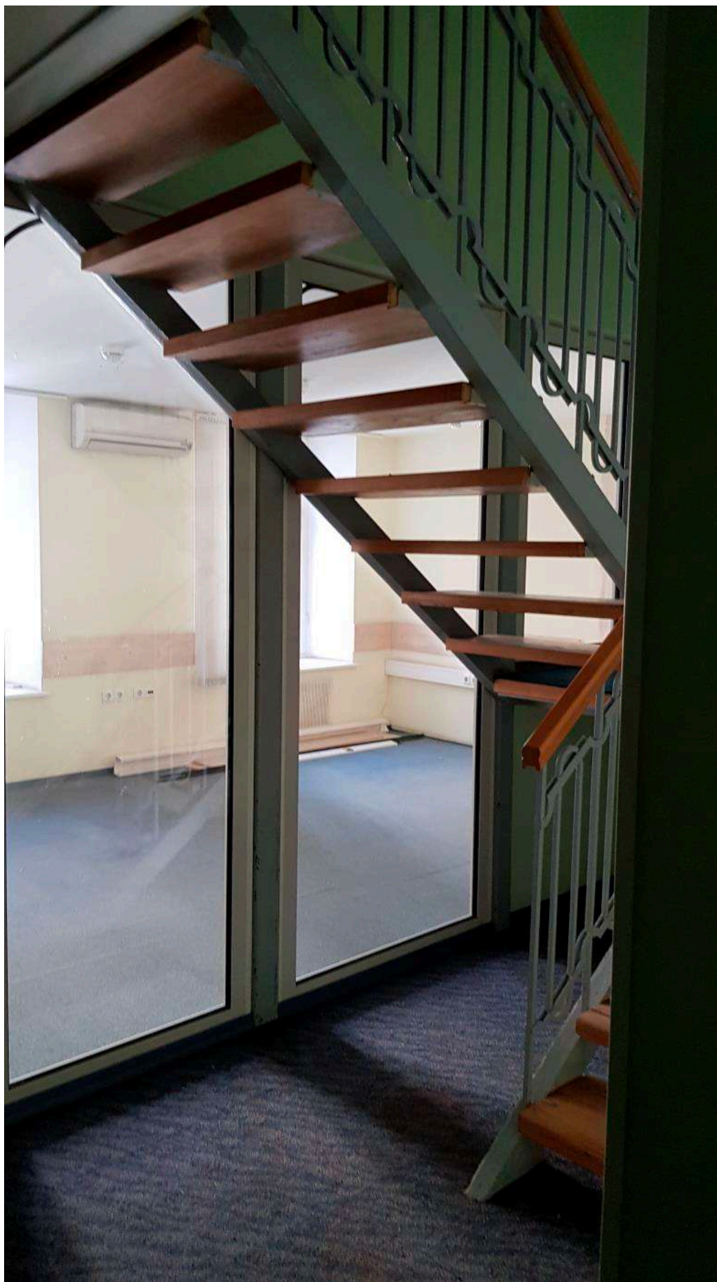
Фото 18. Общий вид части пом. 26-Н (№ 28 по ПИБ), элементы ДПИ отсутствуют.
