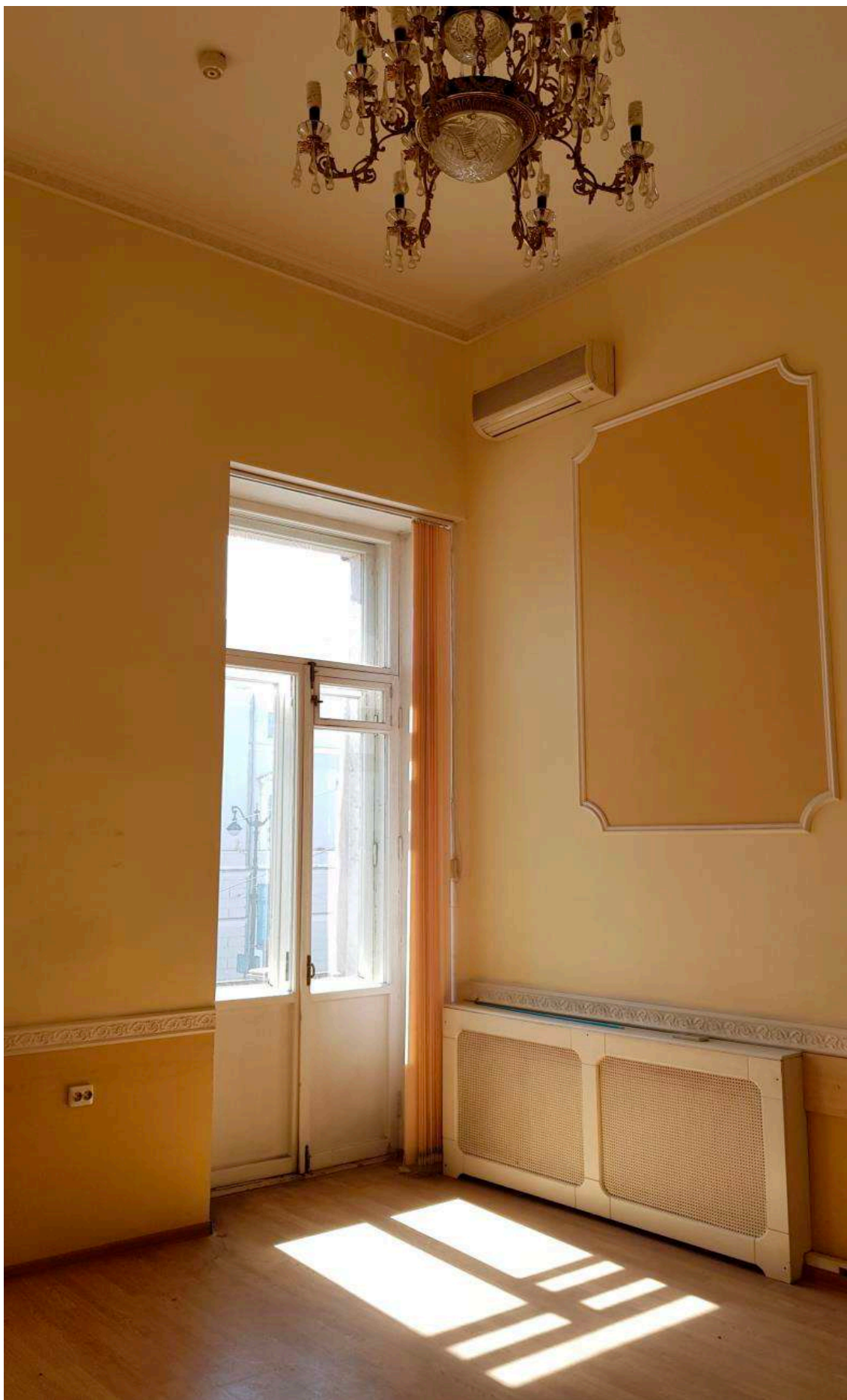
Фото 29. Общий вид части пом. 26-Н (№ 34 по ПИБ), нижняя часть стен отделена лепной тягой с растительным орнаментом, стены разбиты лепными профилированными тягами на филенки прямоугольной формы с вырезанными углами.
