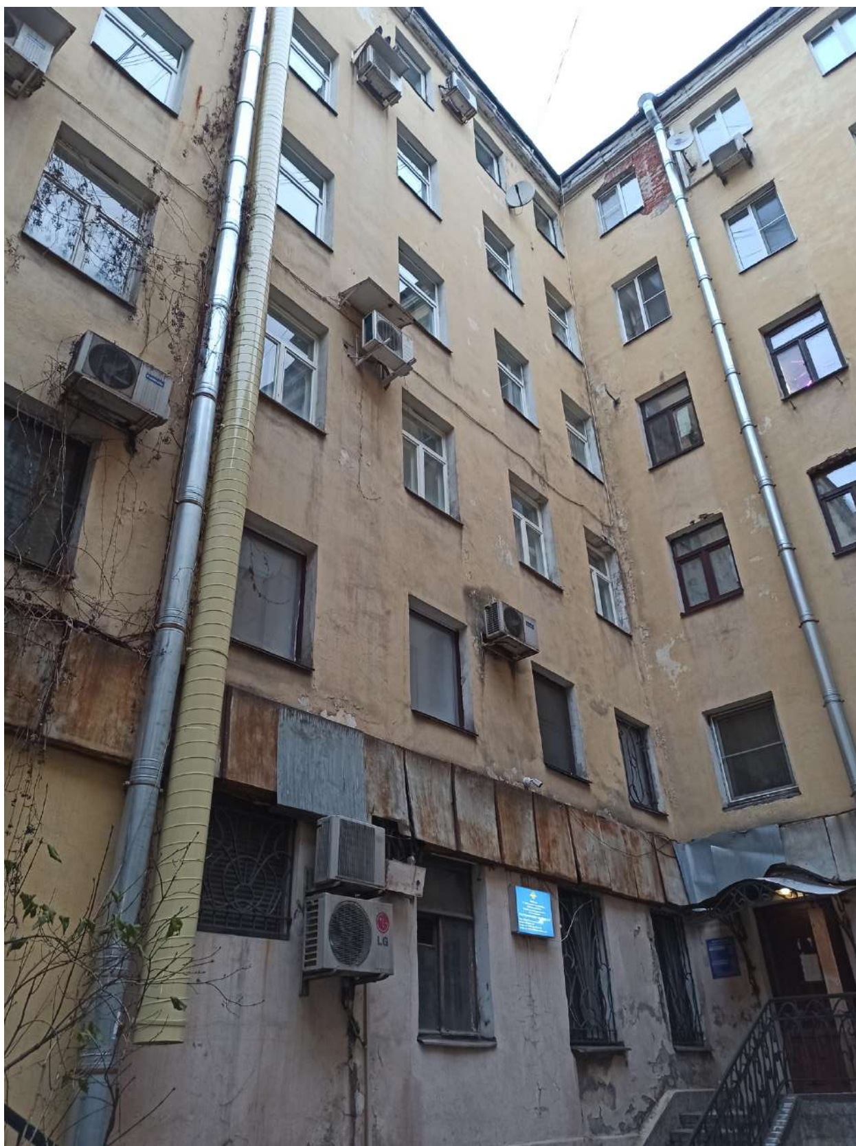
Фото 9. Вид на часть дворового фасада, наблюдается установка дополнительного оборудования, замена оконных заполнений.
