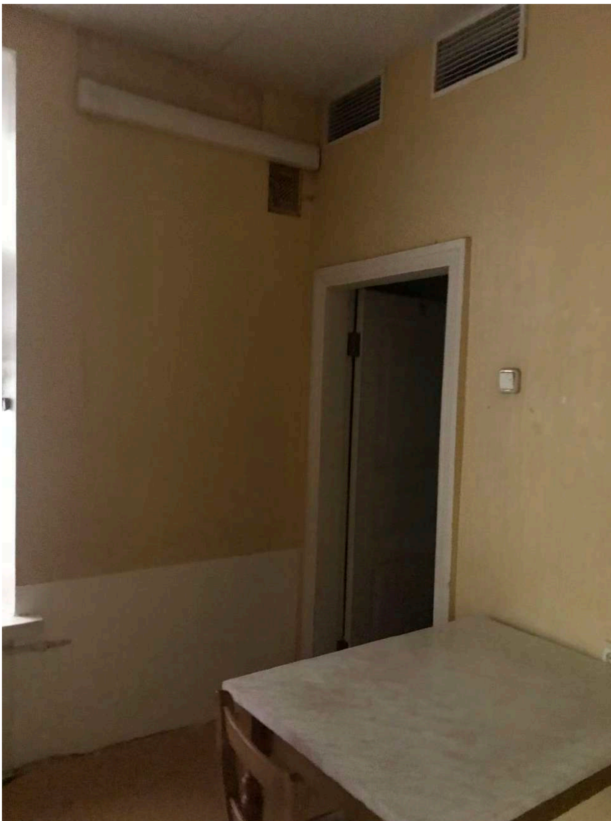
Фото 55. Общий вид части пом. 26-Н (№ 50 по ПИБ).
