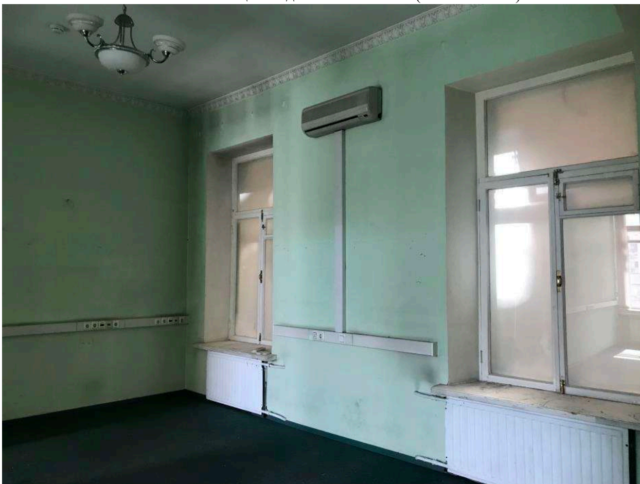
Фото 59. Общий вид части пом. 26-Н (№ 52 по ПИБ). Лепная орнаментированная розетка на потолке, орнаментированная тяга в верхней части стен.
