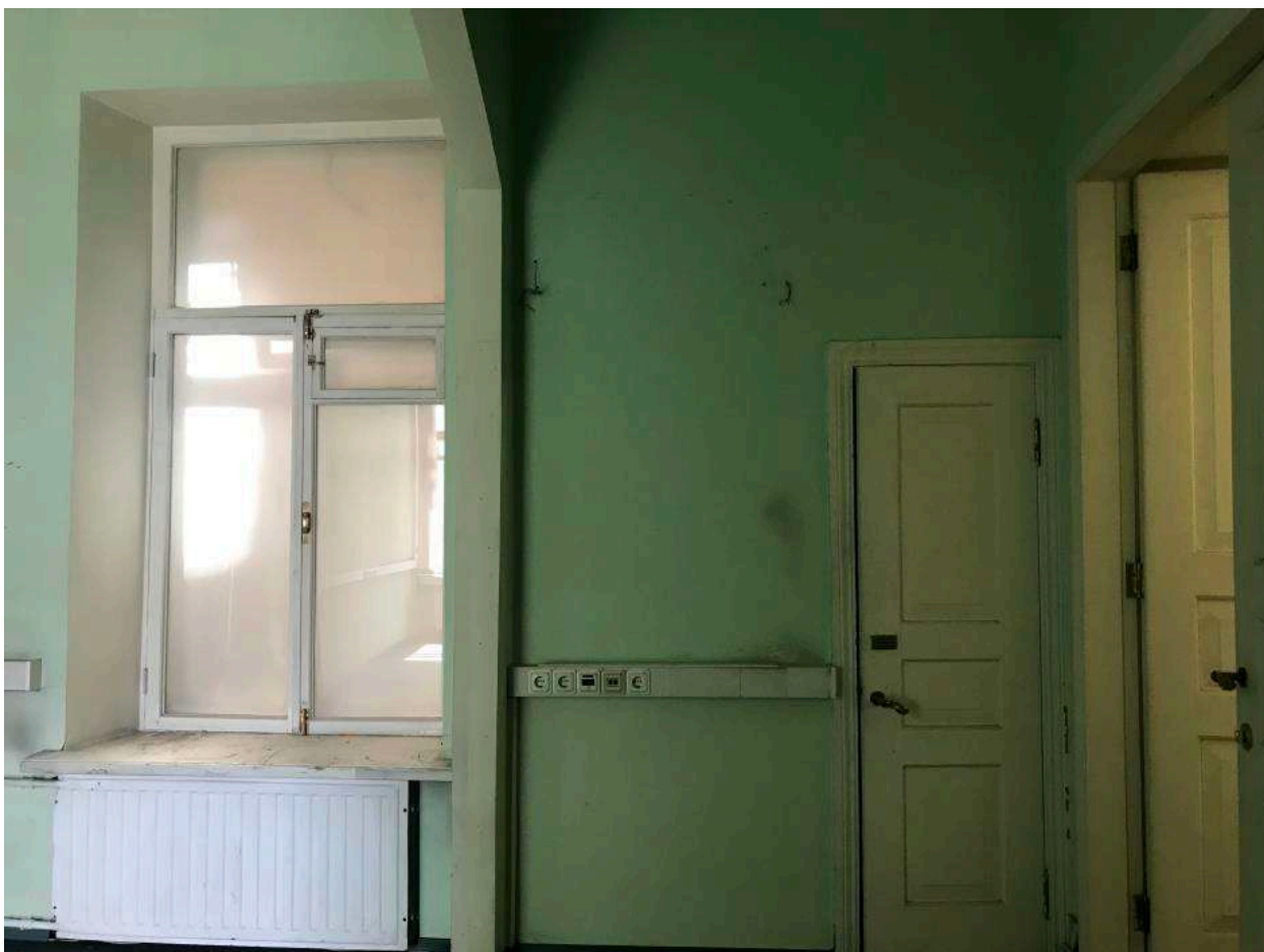
Фото 58. Общий вид части пом. 26-Н (№ 52 по ПИБ).
