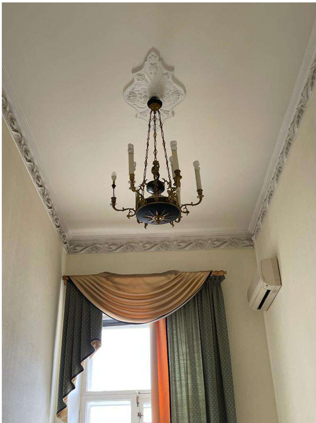
Фото 31. Общий вид части пом. 26-Н (№ 37 по ПИБ), верхняя часть стен отделена лепной тягой с растительным орнаментом, посередине потолка лепная фигурная орнаментированная розетка.
