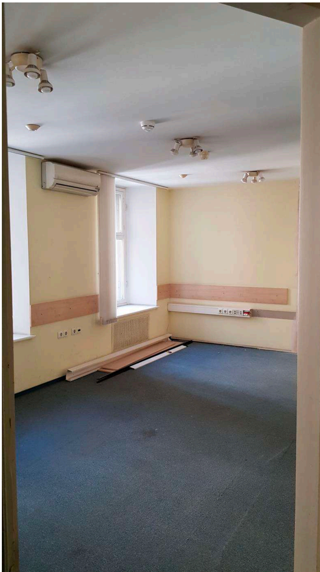
Фото 19. Общий вид части пом. 26-Н (№ 29 по ПИБ), элементы ДПИ отсутствуют.
