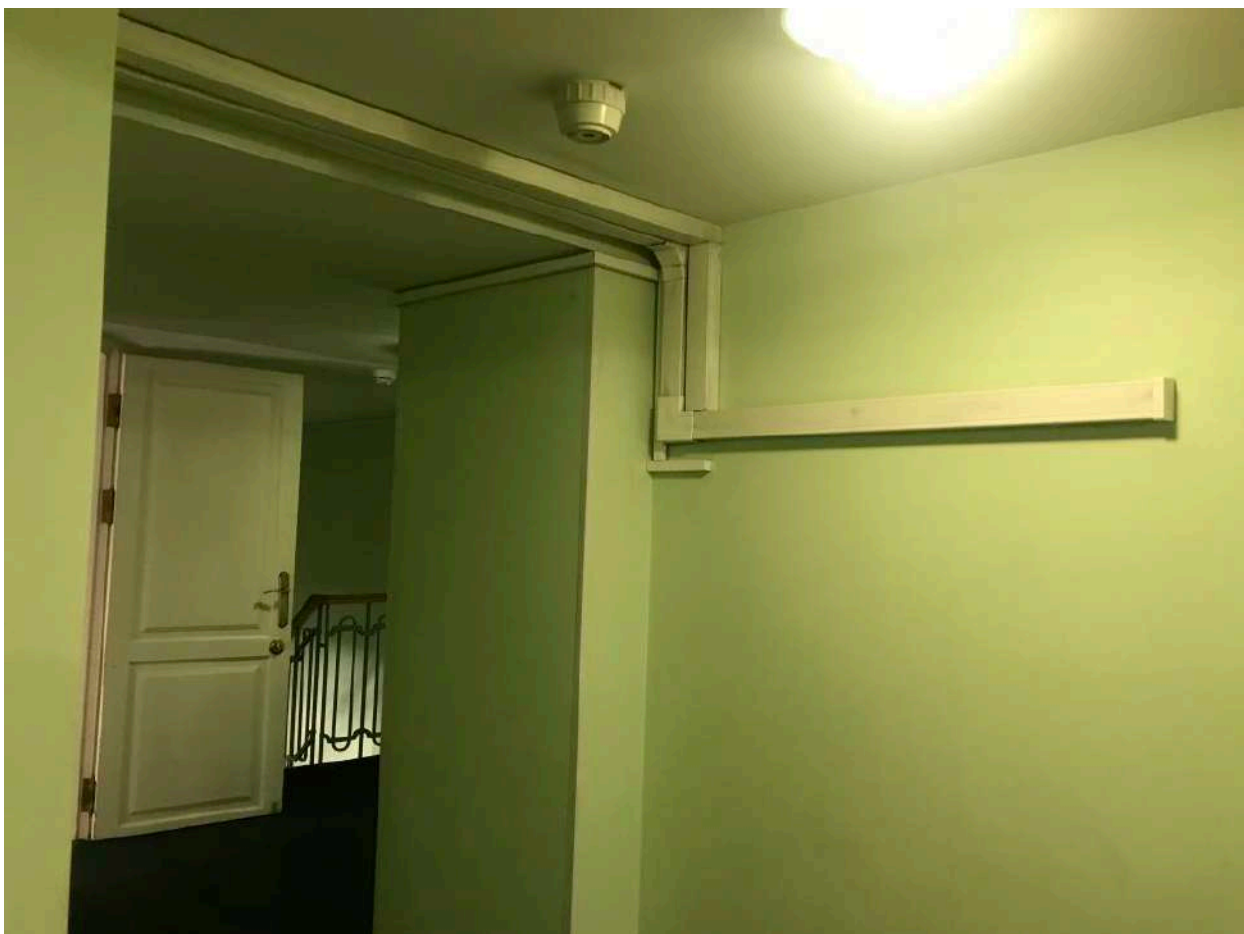
Фото 73. Общий вид части пом. 26-Н (№ 65 по ПИБ).
