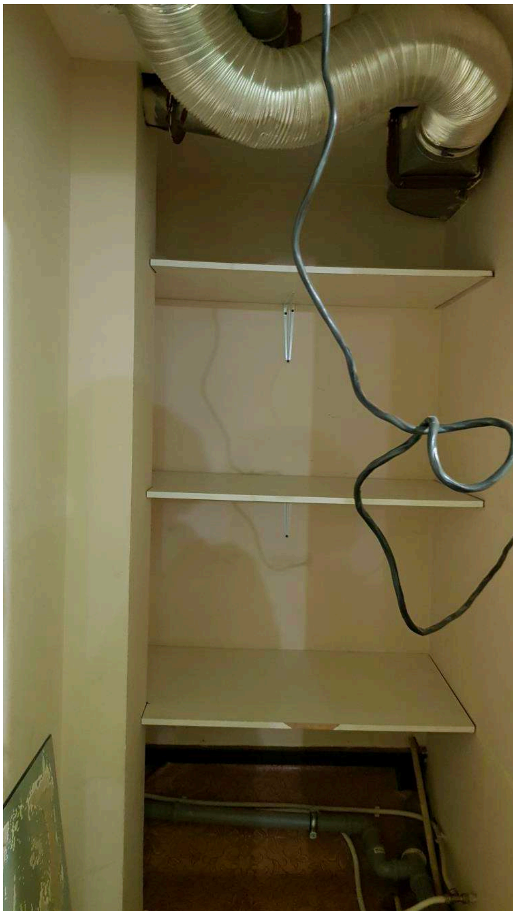
Фото 71. Общий вид части пом. 26-Н (№ 62 по ПИБ).
