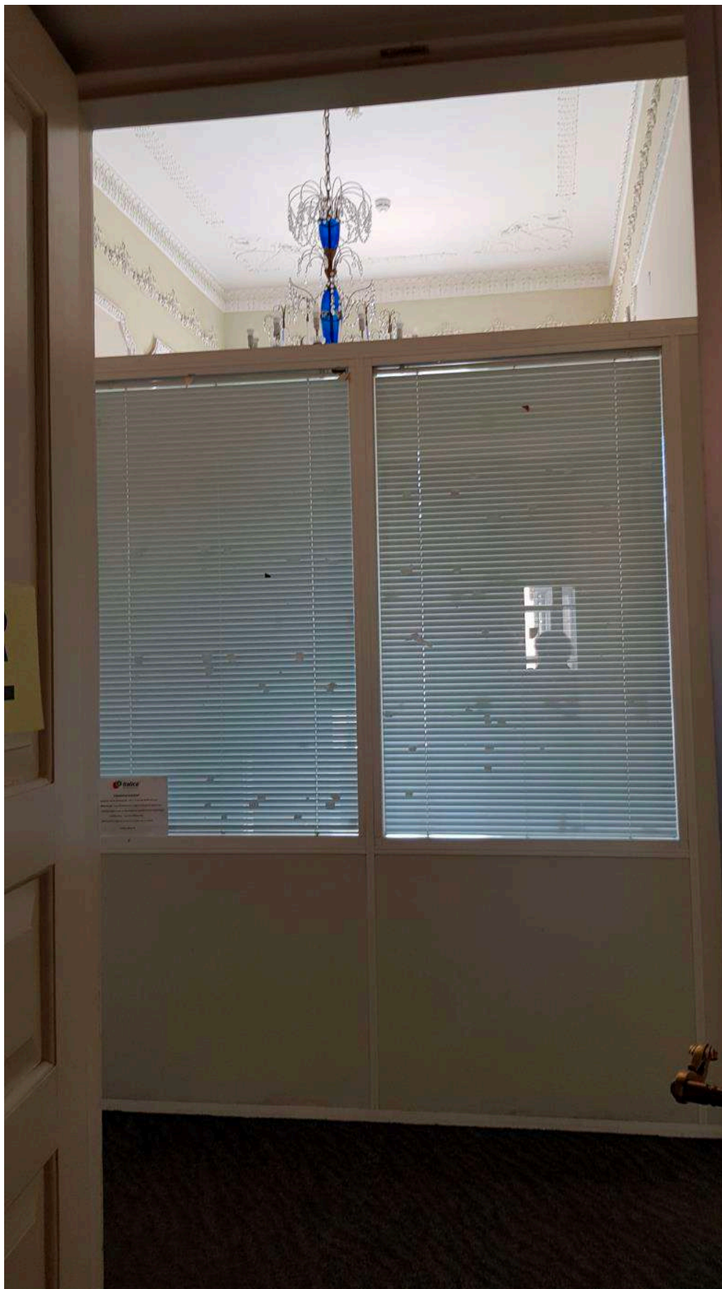
Фото 35. Общий вид части пом. 26-Н (№ 40 по ПИБ). Устроена некапитальная перегородка в высоту дверного проема.
