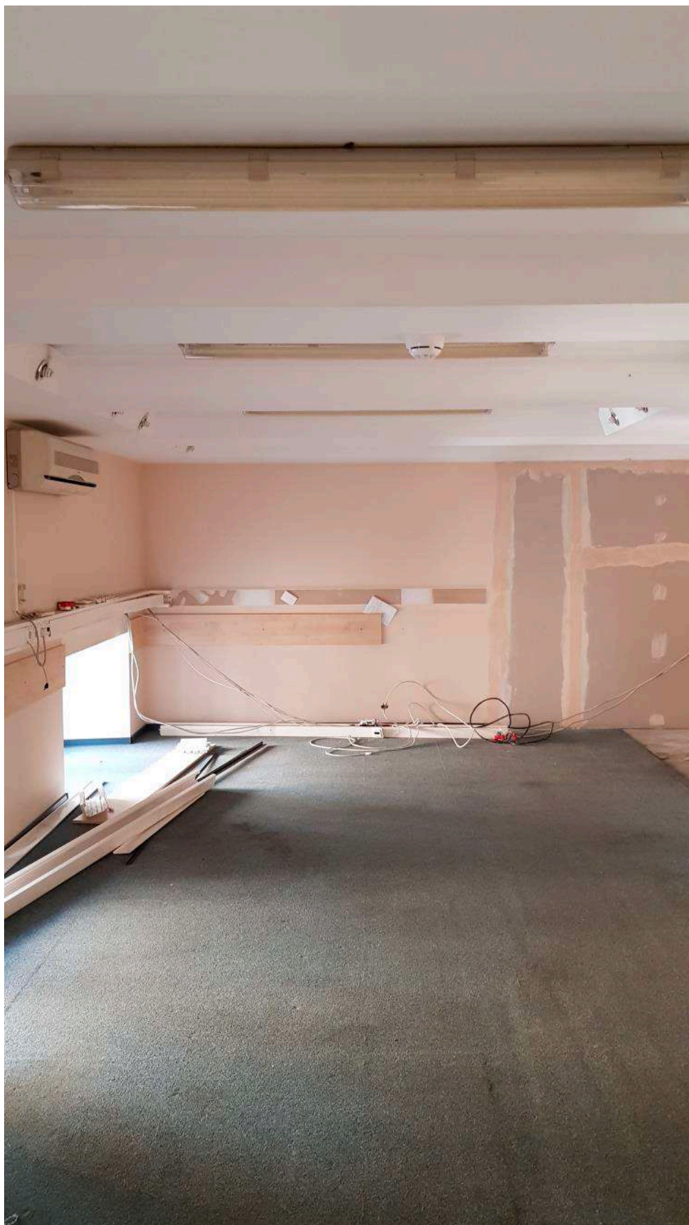
Фото 76. Общий вид части пом. 26-Н (№ 68 по ПИБ).
