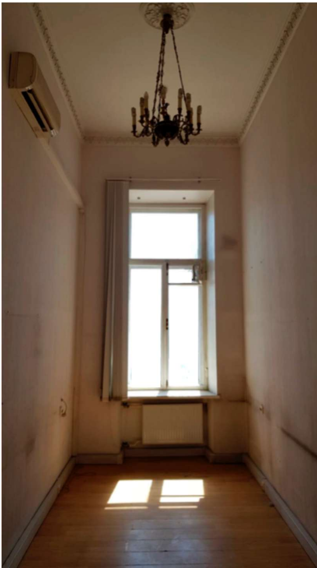
Фото 32. Общий вид части пом. 26-Н (№ 38 по ПИБ), верхняя часть стен отделена лепной тягой с растительным орнаментом, посередине потолка лепная фигурная орнаментированная розетка.
