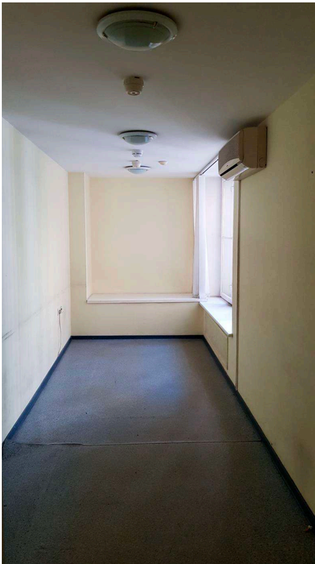
Фото 17. Общий вид части пом. 26-Н (№ 27 по ПИБ), элементы ДПИ отсутствуют.
