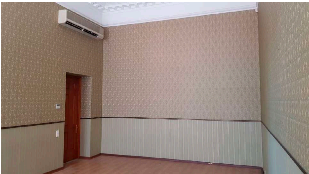
Фото 84. Общий вид части пом. 29-Н (№ 8 по ПИБ).
