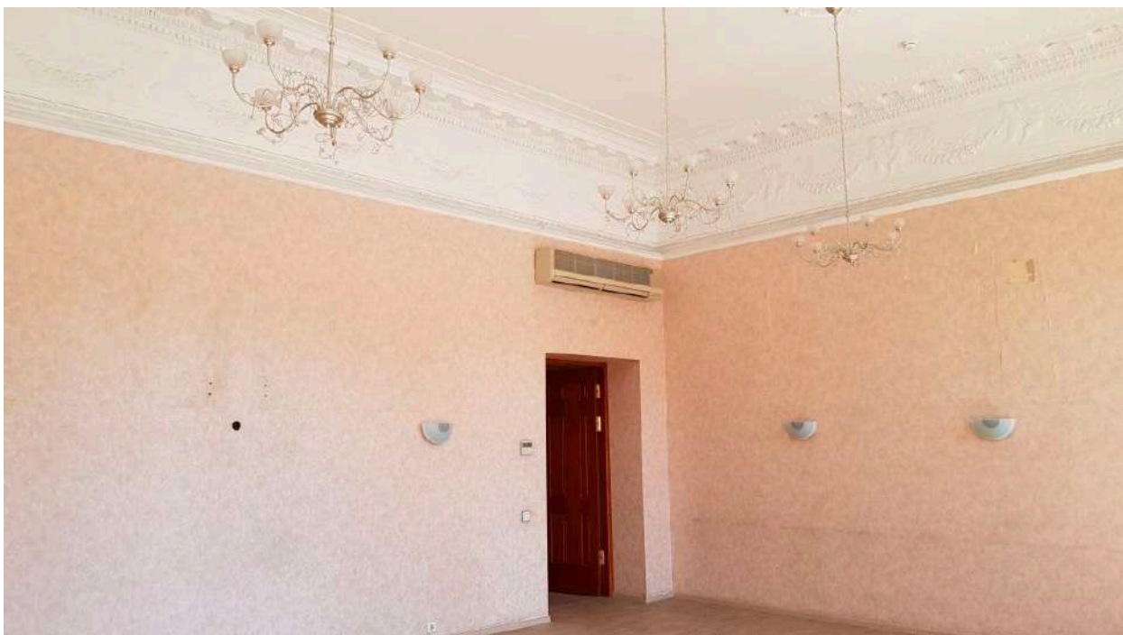
Фото 88. Общий вид части пом. 29-Н (№ 11 по ПИБ).
