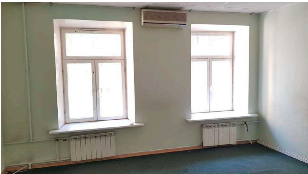
Фото 12. Общий вид части пом. 26-Н (№ 16 по ПИБ), элементы ДПИ отсутствуют.
