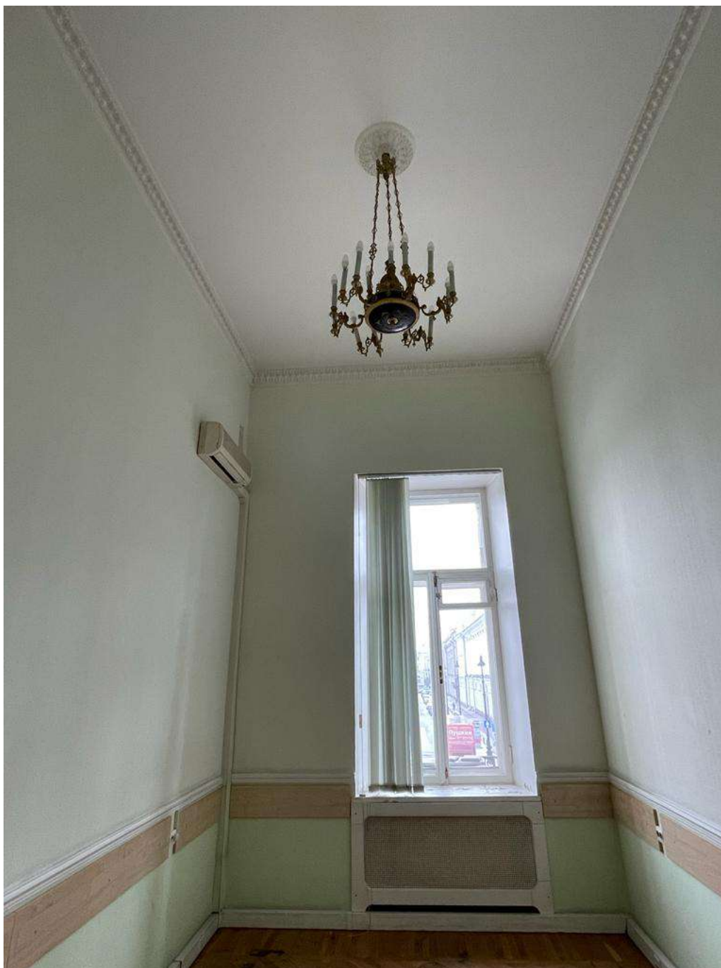
Фото 30. Общий вид части пом. 26-Н (№ 35 по ПИБ), верхняя часть стен отделена лепной тягой с растительным орнаментом, посередине потолка лепная фигурная орнаментированная розетка.
