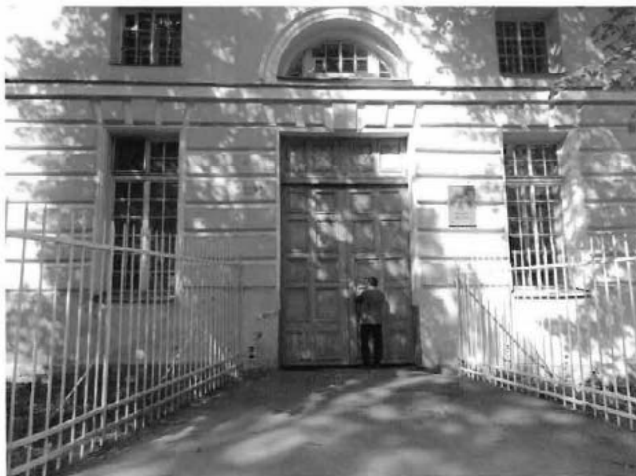
1. Фрагмент восточного фасада
