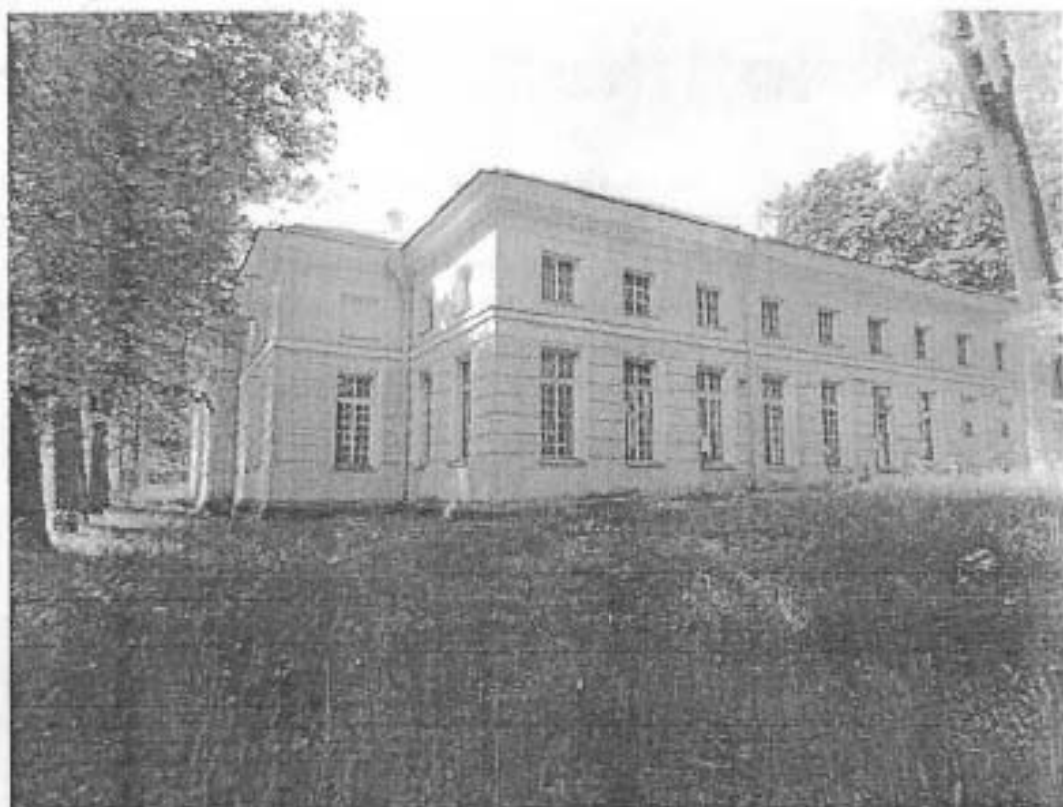
2. Вид со стороны северного фасада.
