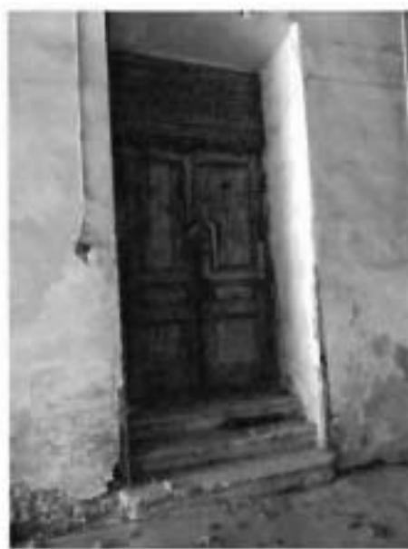
6. Деряное заполнение воротного проезда.
