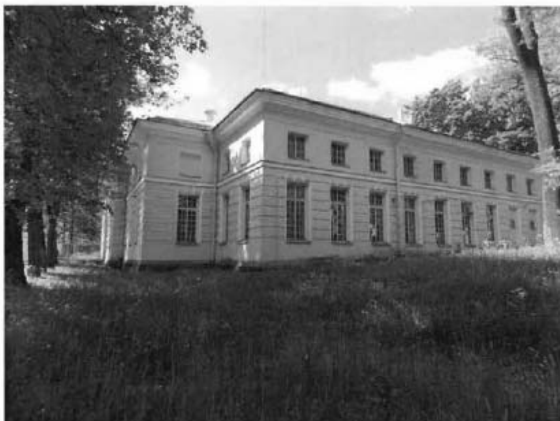
2. Вид со стороны северного фасада.
