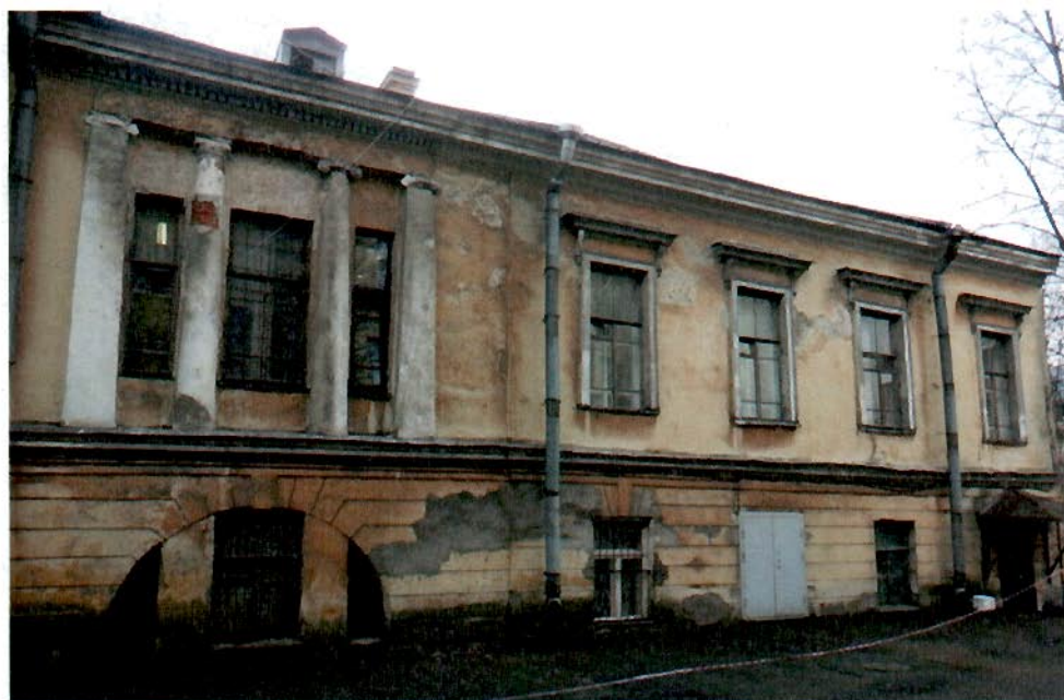
10. Фрагмент северного дворового фасада здания.
