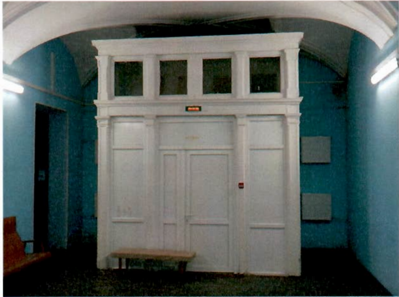
3. Тамбур парадного входа в здание.
