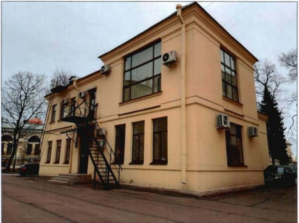
1. Вид на западный и южный фасады.
