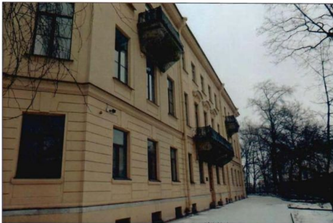
2. Общий вид объекта культурного наследия с юга. Юго-восточный фасад.
