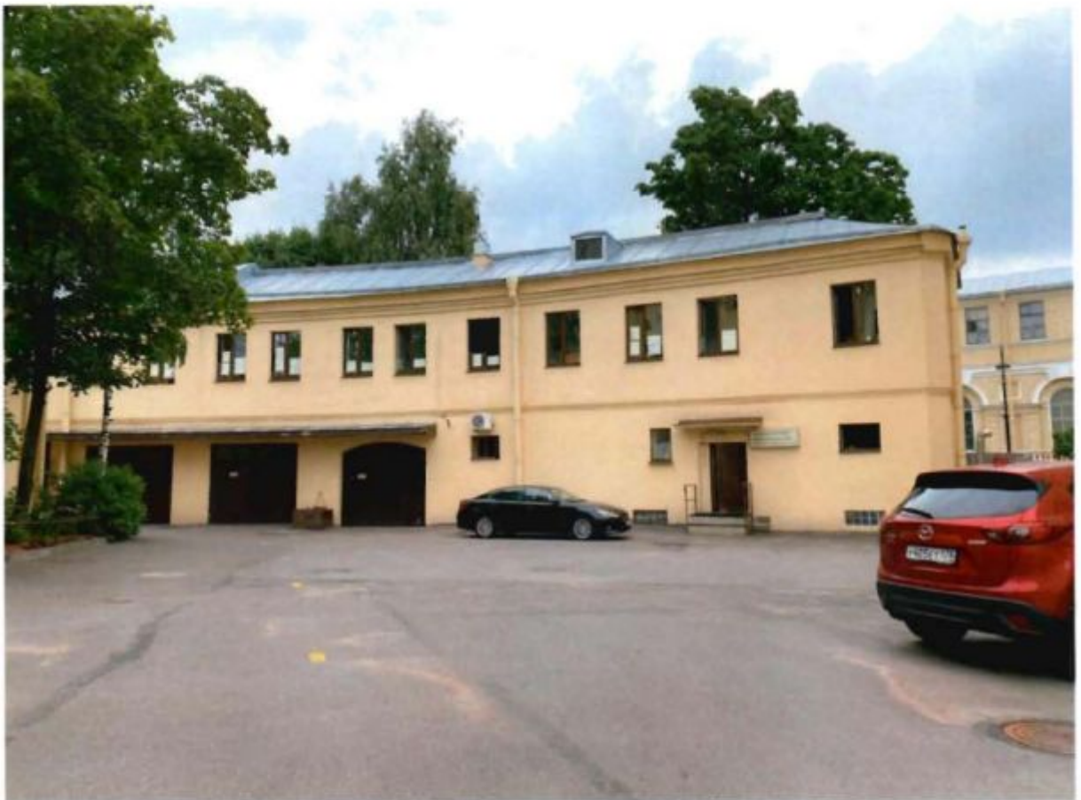
1. Фрагмент западного фасада объекта культурного наследия.
