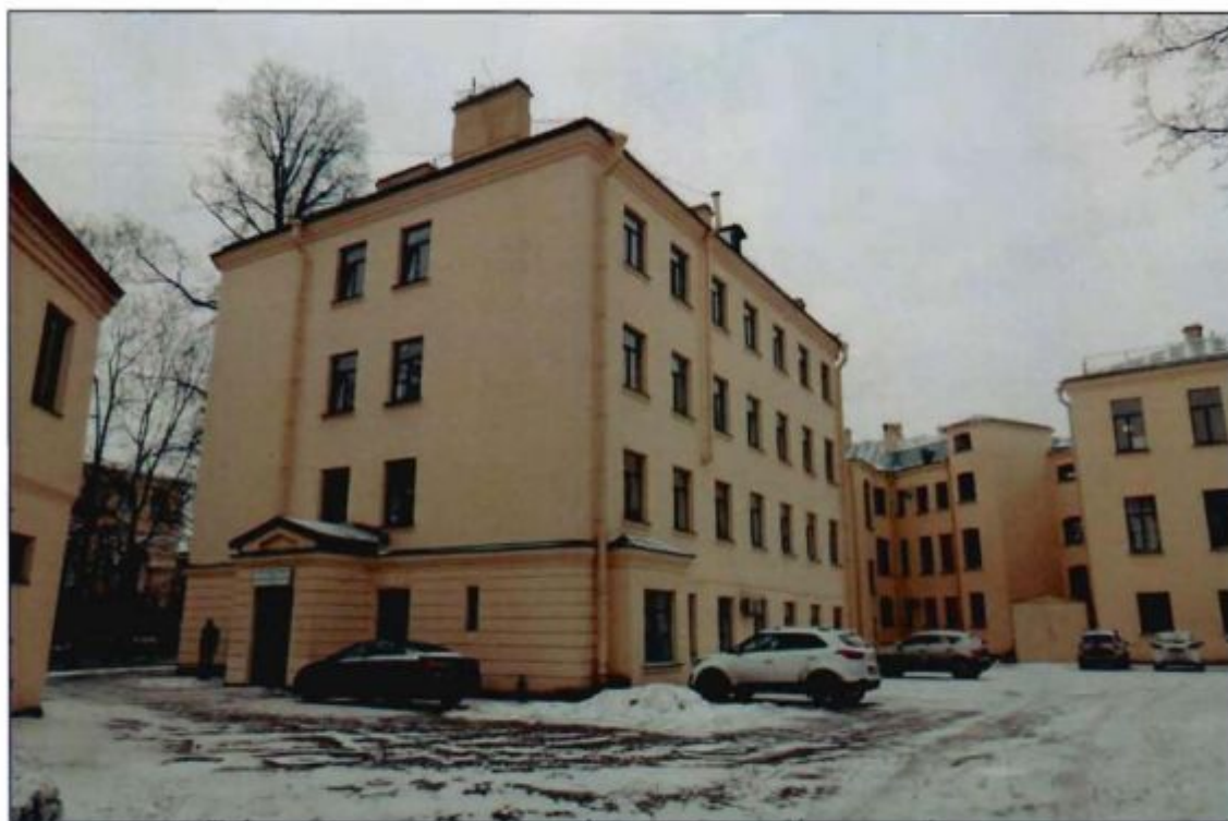
3. Общий вид объекта культурного наследия с севера. Дворовые фасады.
