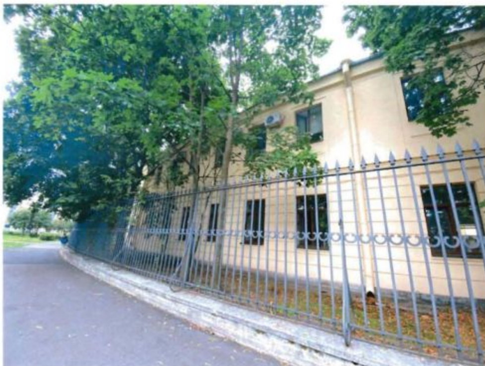
4. Фрагмент восточного фасада объекта культурного наследия.
