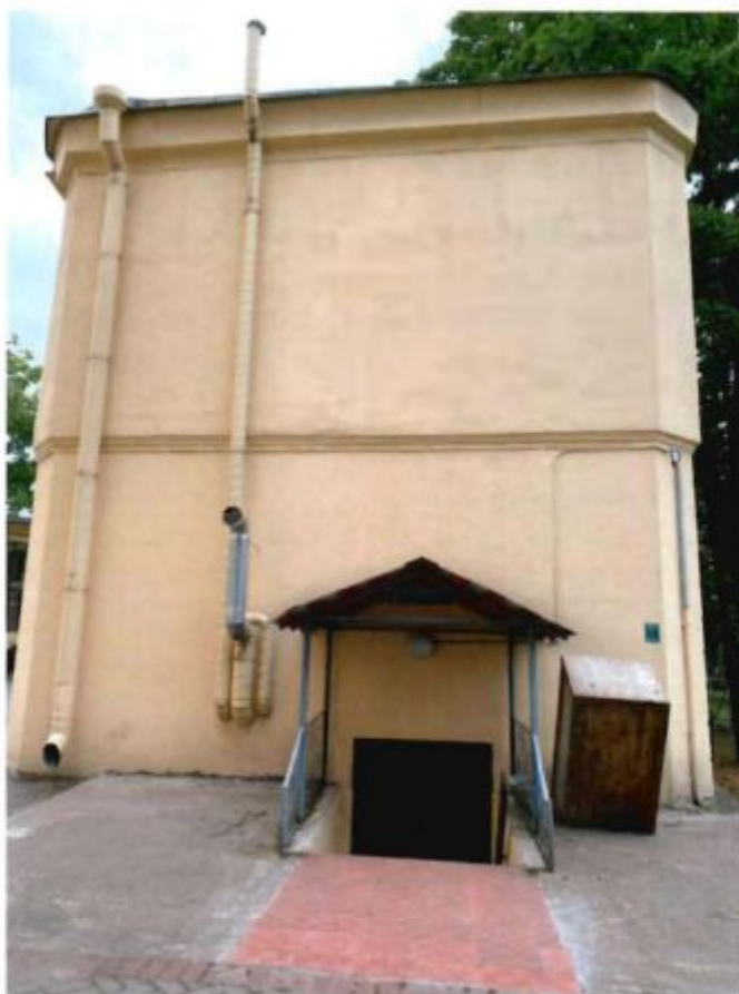
2. Южный фасад объекта культурного наследия.
