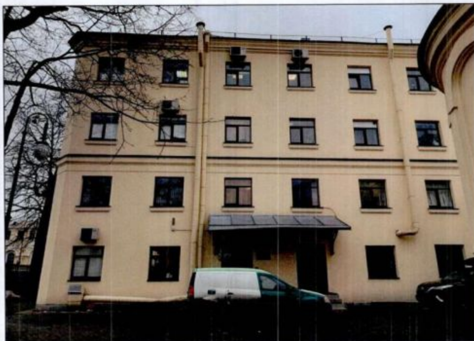
2. Северный фасад. Фрагмент.
