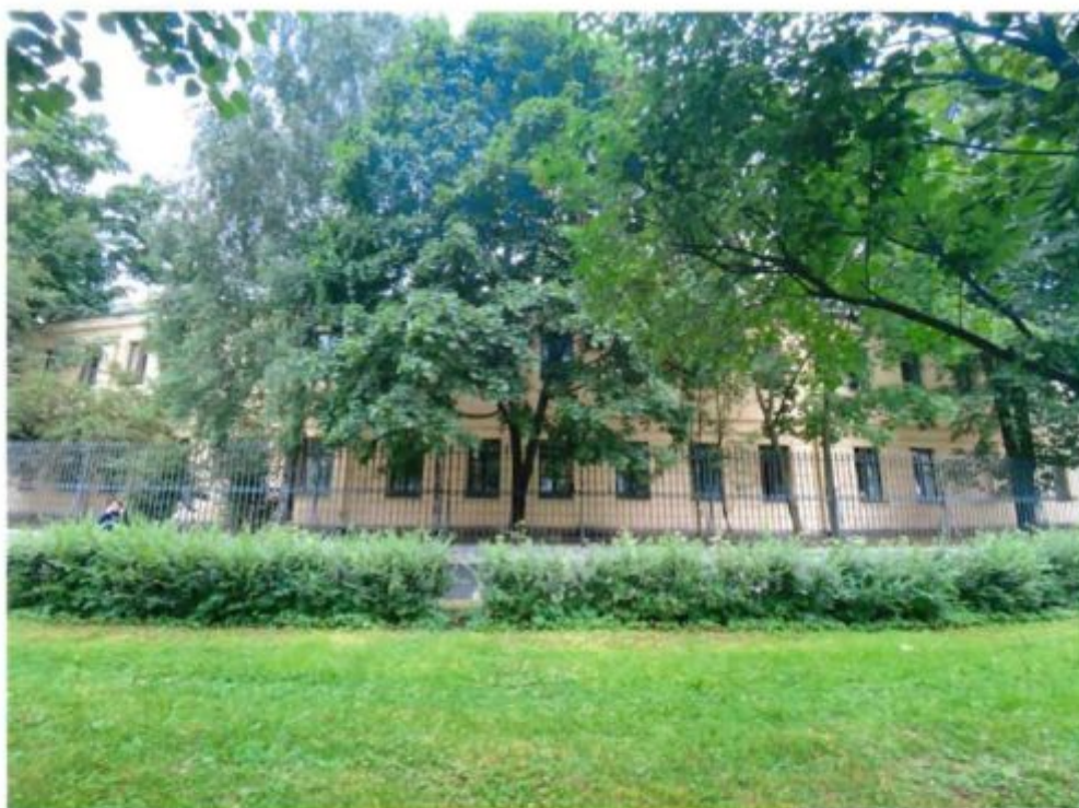
5. Фрагмент восточного фасада объекта культурного наследия.
