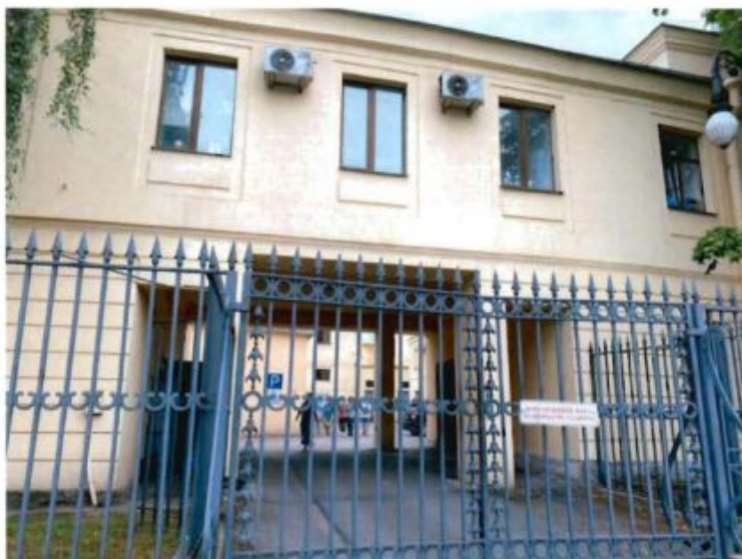
3. Арочный проезд и фрагмент восточного фасада объекта культурного наследия.
