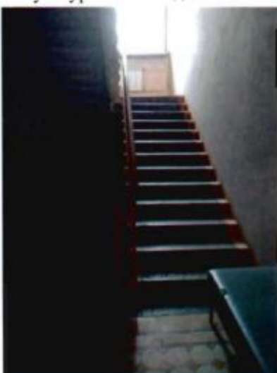
6. Лестница в северной части объекта культурного наследия.
