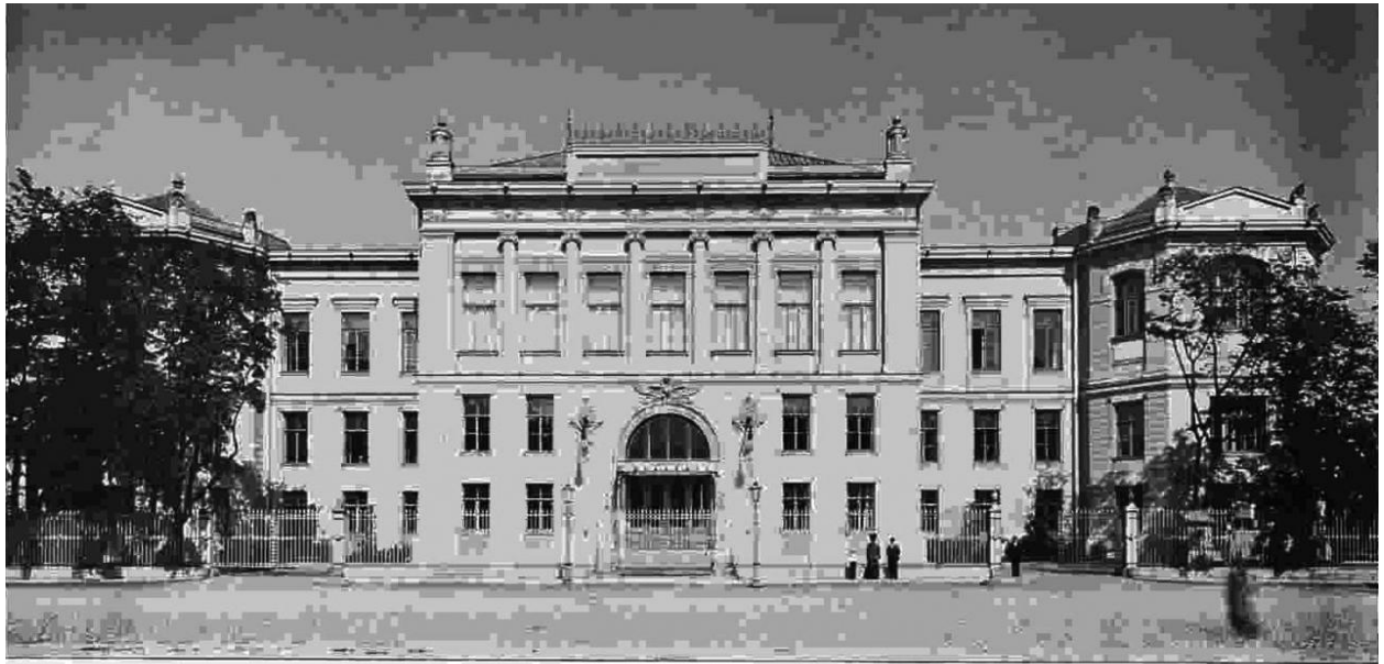
Главный фасад.—Façade principale.
