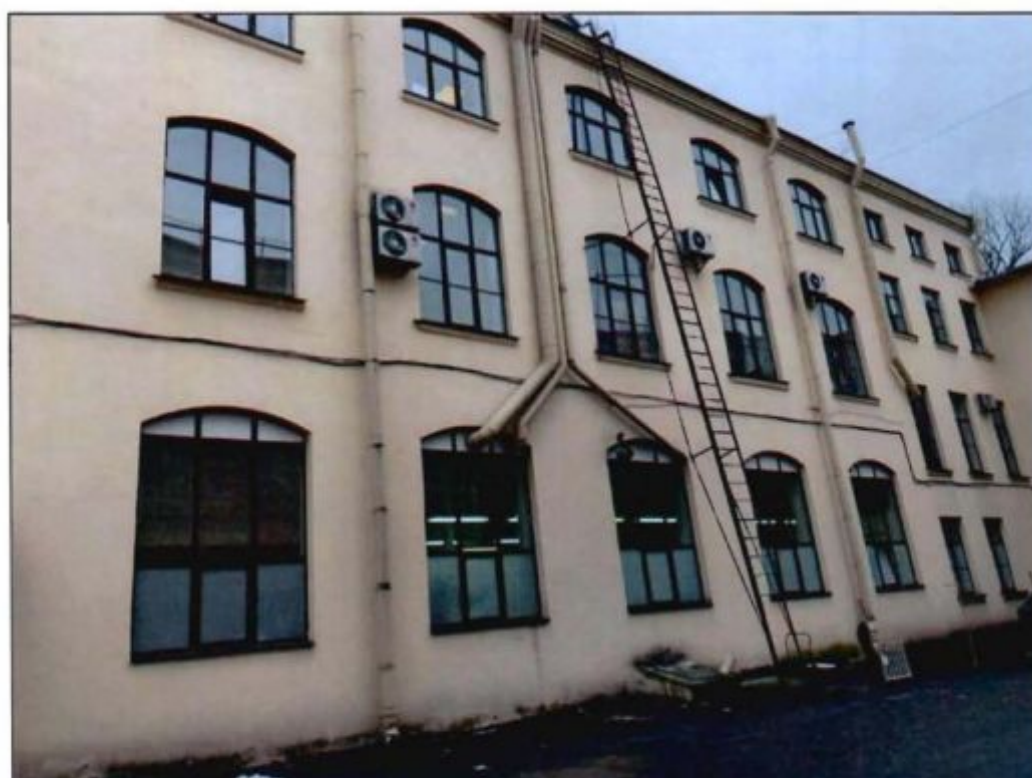
3. Северный фасад. Фрагмент.
