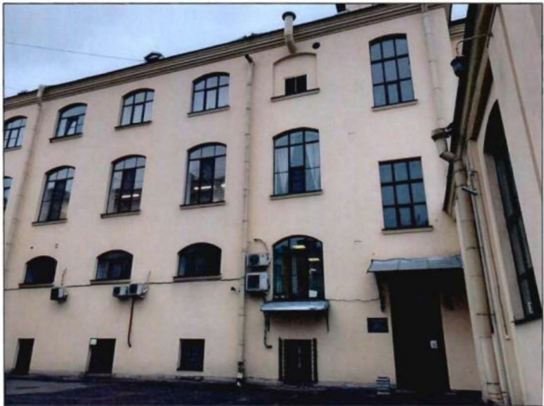
1. Южный фасад. Фрагмент.
