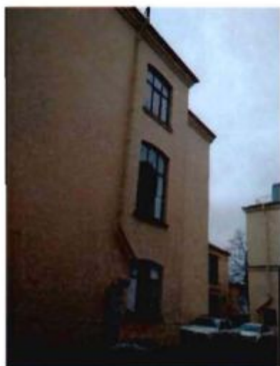
4. Вид на южный фасад объекта культурного наследия.
