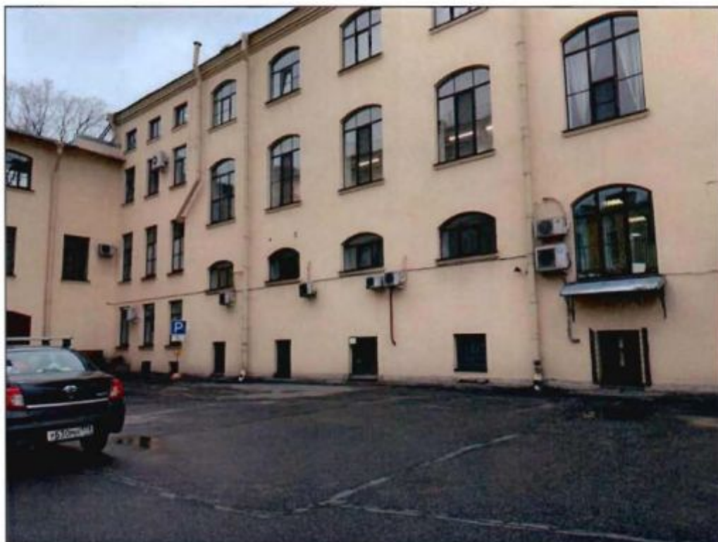
2. Южный фасад. Фрагмент.
