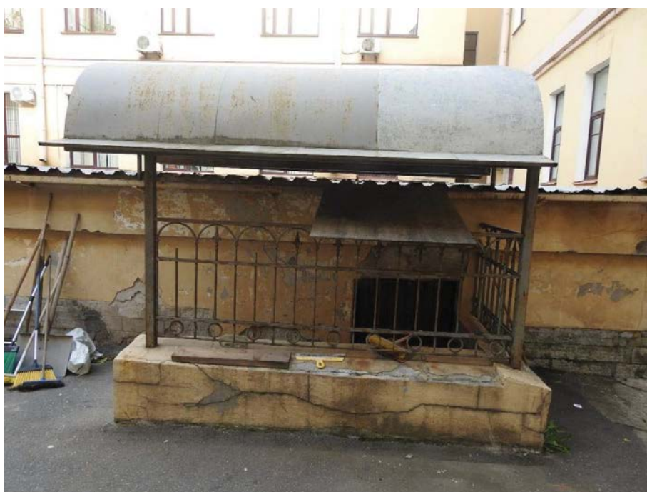
10. «Особняк Дурново П.П., ХУІІІ в.;1872, арх. Фонтана Л.Ф.», Английская наб., д.16, Галерная ул., д.15. Общий вид прямка в уровне цоколя пристройки с металлическим ограждением и линейным окрытием. Фото 06.09.2021г.
