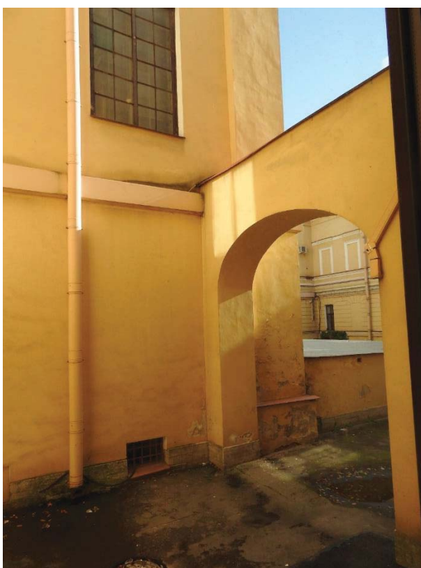
20. «Особняк Дурново П.П., ХУІІІ в.;1872, арх. Фонтана Л.Ф.», Английская наб., д.16, Галерная ул., д.15. Фрагмент левой части Северного фасада за арочным проёмом. Фото 06.09.2021г.
