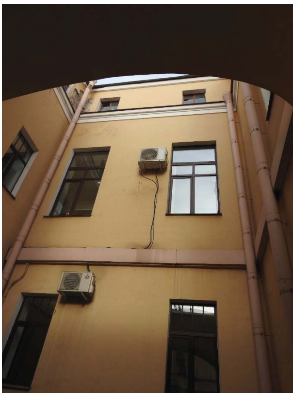
19. «Особняк Дурново П.П., ХУІІІ в.;1872, арх. Фонтана Л.Ф.», Английская наб., д.16, Галерная ул., д.15. Фрагмент левой части Северного фасада за арочным проёмом. Фото 06.09.2021г.
