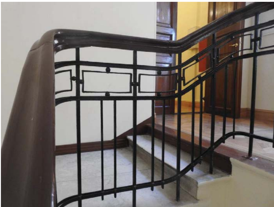
31. «Особняк Дурново П.П., ХУІІІ в.;1872, арх. Фонтана Л.Ф.», Английская наб., д.16, Галерная ул., д.15. Фрагмент лестничного ограждения. Фото 06.09.2021г.
