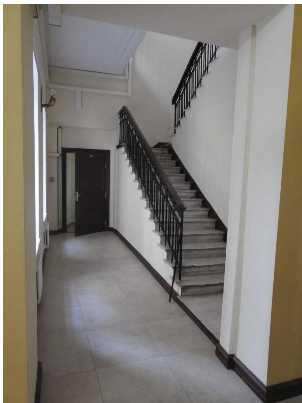
28. «Особняк Дурново П.П., ХУІІІ в.;1872, арх. Фонтана Л.Ф.», Английская наб., д.16, Галерная ул., д.15. Общий вид помещения левой части здания. Западная лестница лицевого флигеля. Фото 06.09.2021г.
