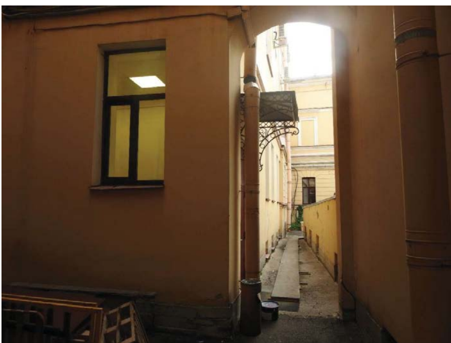
6. «Особняк Дурново П.П., ХУІІІ в.;1872, арх. Фонтана Л.Ф.», Английская наб., д.16, Галерная ул., д.15. Фрагмент дворового фасада левая сторона Восточного флигеля. Фото 06.09.2021г.
