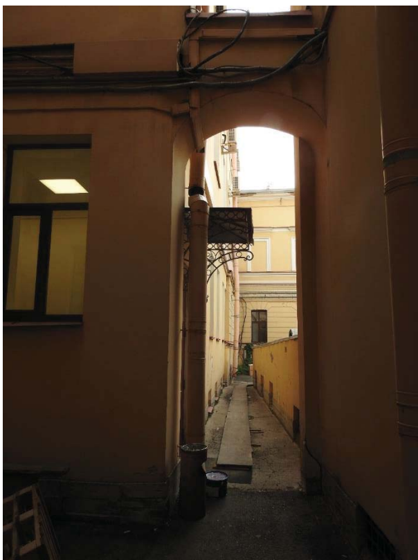
5. «Особняк Дурново П.П., ХУІІІ в.;1872, арх. Фонтана Л.Ф.», Английская наб., д.16, Галерная ул., д.15. Фрагмент дворового фасада левая сторона Восточного флигеля. Фото 06.09.2021г.
