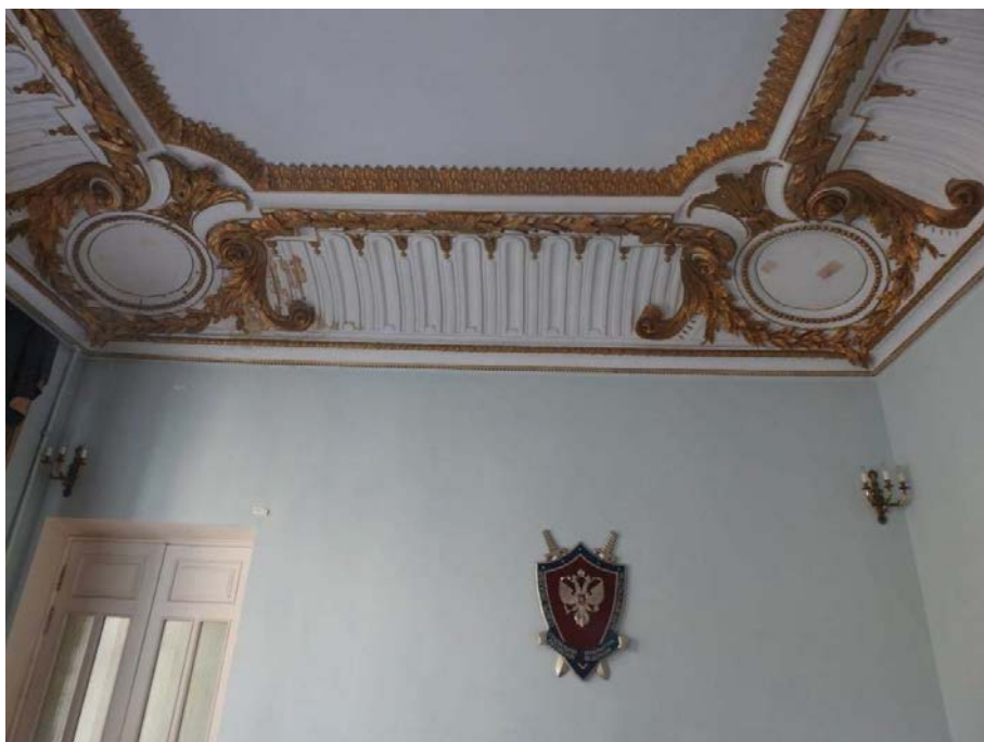
41. «Особняк Дурново П.П., ХУІІІ в.;1872, арх. Фонтана Л.Ф.», Английская наб., д.16, Галерная ул., д.15. Фрагмент южной части стены и потолка с расчистками на предмет выявления живописи и позолоты. Фото 06.09.2021г.
