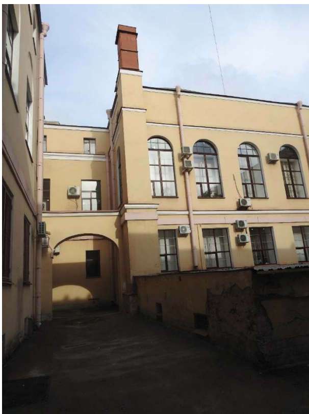
17. «Особняк Дурново П.П., ХУІІІ в.;1872, арх. Фонтана Л.Ф.», Английская наб., д.16, Галерная ул., д.15. Общий вид левой части фасада Западного флигеля с арочным проёмом. Фото 06.09.2021г.
