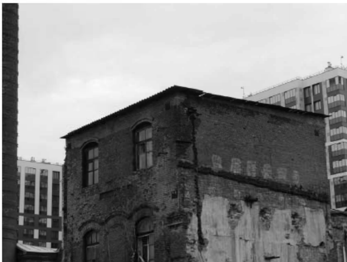
26 Выявленный ОКН «Производственное здание с дымовой трубой Кисловожского Ультрамаршинового завода ГИ. Веген», по адресу: г. Санкт-Петербург, Октябрьская набережная, дом 38, литера АН. Литера АН5. Фрагмент 3-х этажной части. Вид с юга. Дата съемки: 12.09.2022
