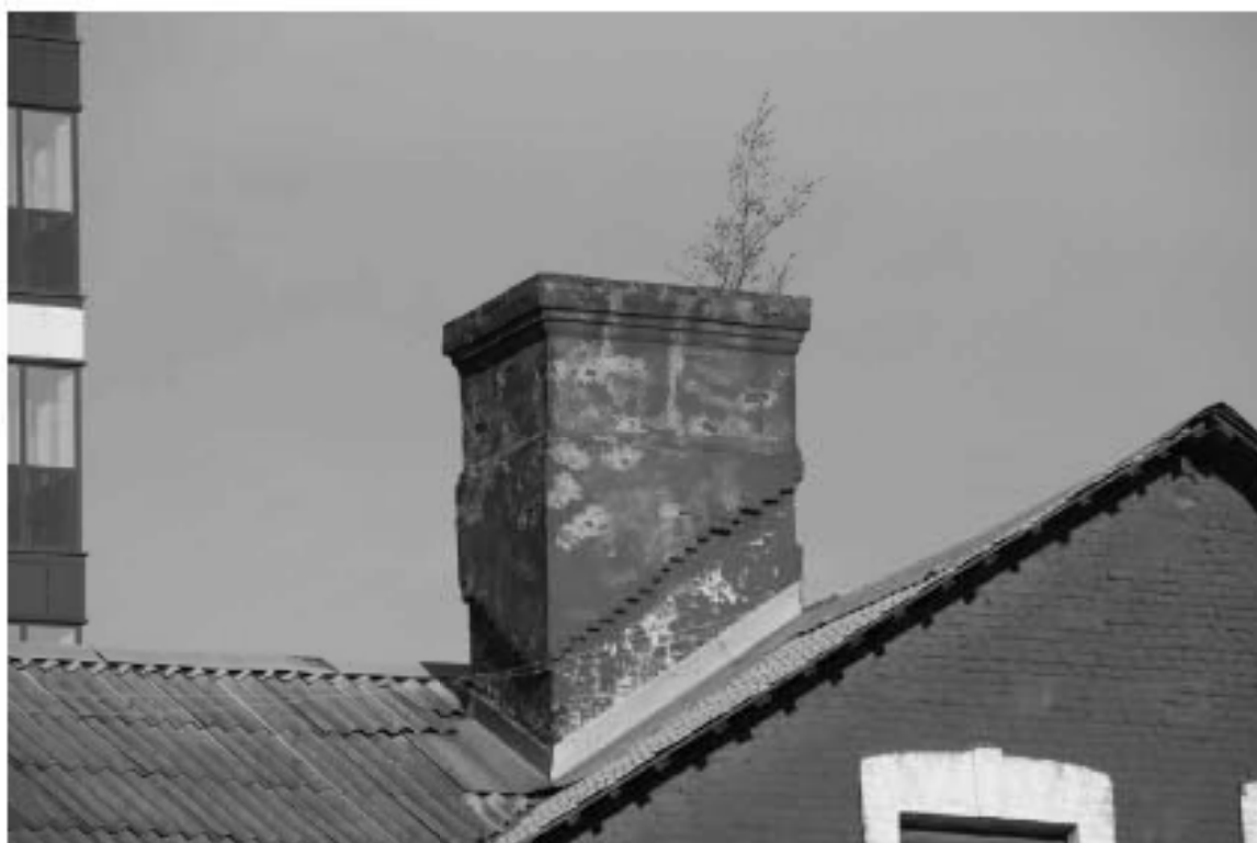
17 Выявленный ОКН «Производственное здание с дымовой трубой Кизованского Ультрамаринового завода Г.И. Веген», по адресу: г. Санкт-Петербург, Октябрьская набережная, дом 38, литера АН. Литера АН6. Вентиляционная труба Дата съемки: 12.09.2022
