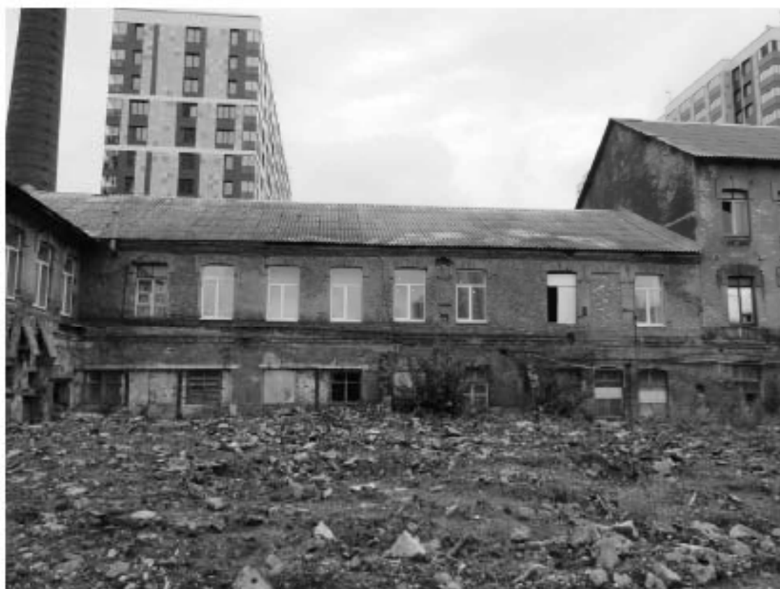
21 Выделенный ОКН «Производственное здание с дымовой трубой Кизованского Ультрамаринового завода Г.И. Веген, по адресу: г. Санкт-Петербург, Октябрьская набережная, дом 38, литера АН. Литера АН6. 2-х этажная часть. Вид с юго-востока. Дата съемки: 12.09.2022
