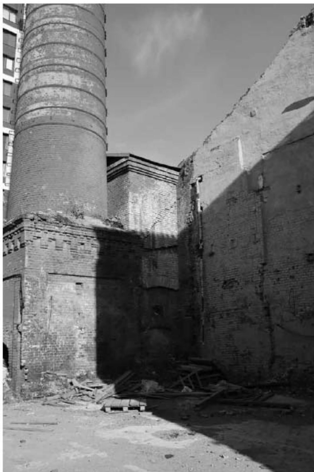
8 Выявленный ОКН «Производственное здание с дымовой трубой Киновиевского Ультрамаринового завода Г.И. Веге», по адресу: г. Санкт-Петербург, Октябрьская набережная, дом 38, литеры АН. Присоединение литеры АН-8 к АН-10 (слева) и к АН-6 (справа). Вид с юга. Дата съемки: 12.09.2022
