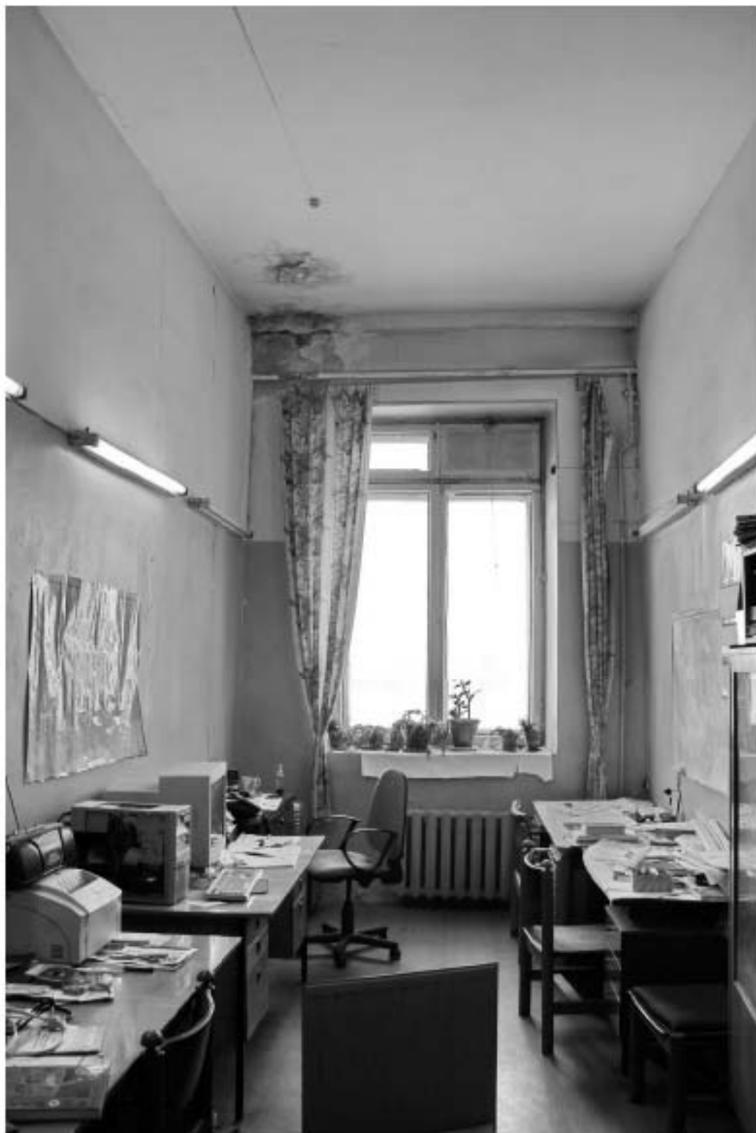
69 Выявленный ОКН «Производственное здание с дымовой трубой Киновиевского Ультрамаринового завода ГИ. Веге», по адресу: г. Санкт-Петербург, Октябрьская набережная, дом 38, литера АН, Лит. АН6, 3 этаж. Помещение 30 (согласно планам ПИБ) Дата съемки: 12.09.2022
