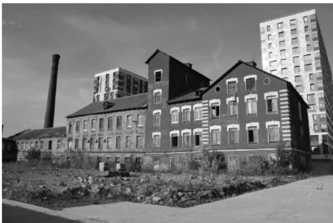
11 Выделенный ОКН «Производственное здание с дымовой трубой Кизованского Ультрамаринового завода ГИ. Веген», по адресу: г. Санкт-Петербург, Октябрьская набережная, дом 38, литера АН. Литера АН-6. Вид с юго-востока. Дата съемки: 12.09.2022
