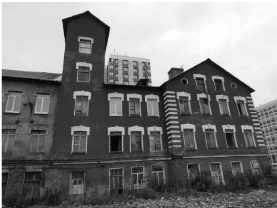
13 Выделенный ОКН «Производственное здание с дымовой трубой Кизовского Ультрамаринового завода Г.И. Веген», по адресу: г. Санкт-Петербург, Октябрьская набережная, дом 38, литера АН. Литера АН6. 3-х этажный объем. Вид с юго-востока. Дата съемки: 12.09.2022
