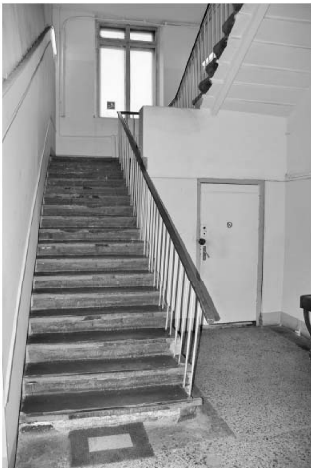
83 Выявленный ОКН «Производственное здание с дымовой трубой Киновиевского Ультрамаринового завода ГИ. Веге», по адресу: г. Санкт-Петербург, Октябрьская набережная, дом 38, литера АН, Лит. АН6. Лестница. 1 этаж Дата съемки: 12.09.2022
