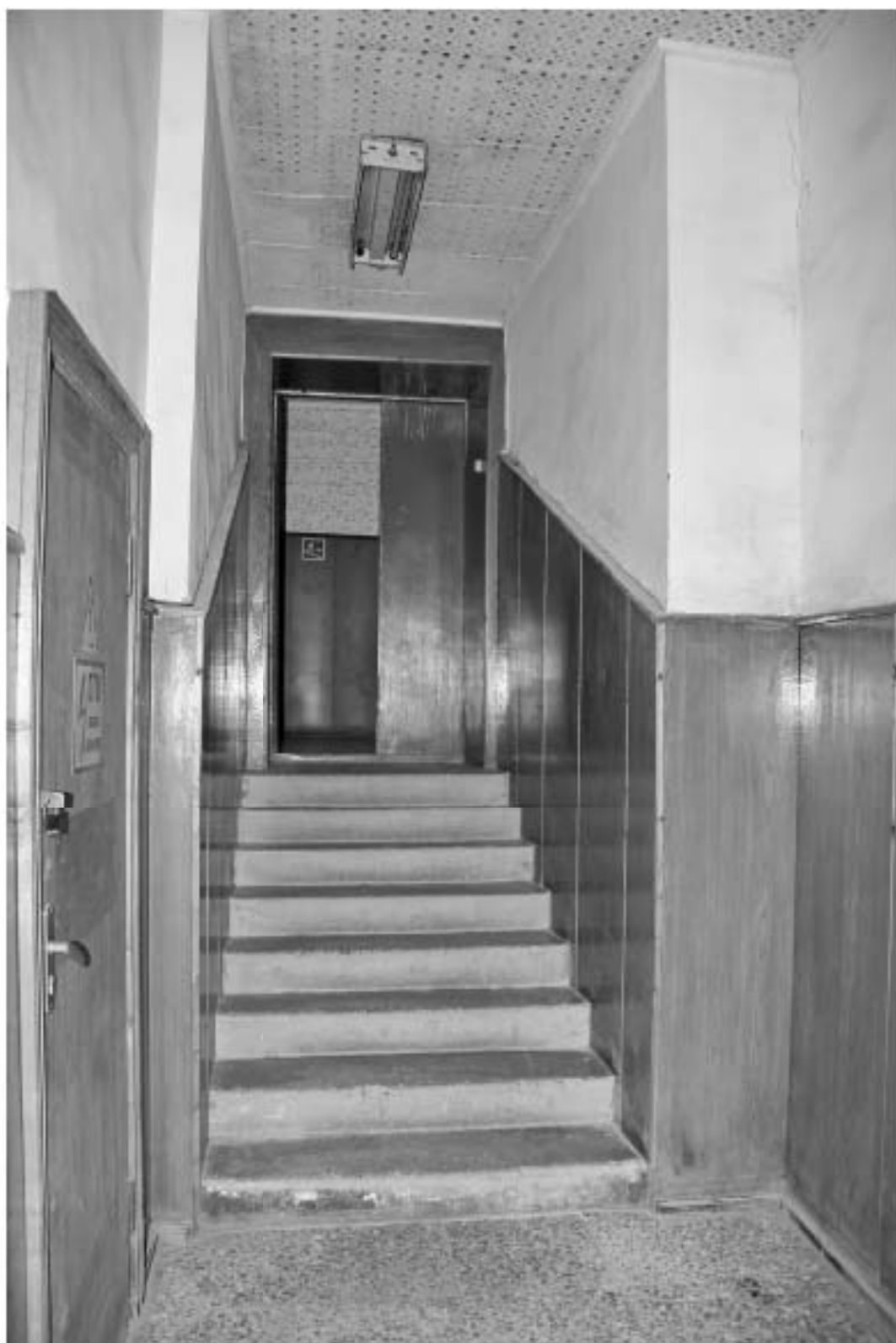
91 Выявленный ОКН «Производственное здание с дымовой трубой Киновисеского Ультрамаринного завода ГИ. Веге», по адресу: г. Санкт-Петербург, Октябрьская набережная, дом 38, литера АН. Лит. АН7. 1 этаж. Помещение 1 (согласно планам ПИБ) Дата съемки: 12.09.2022
