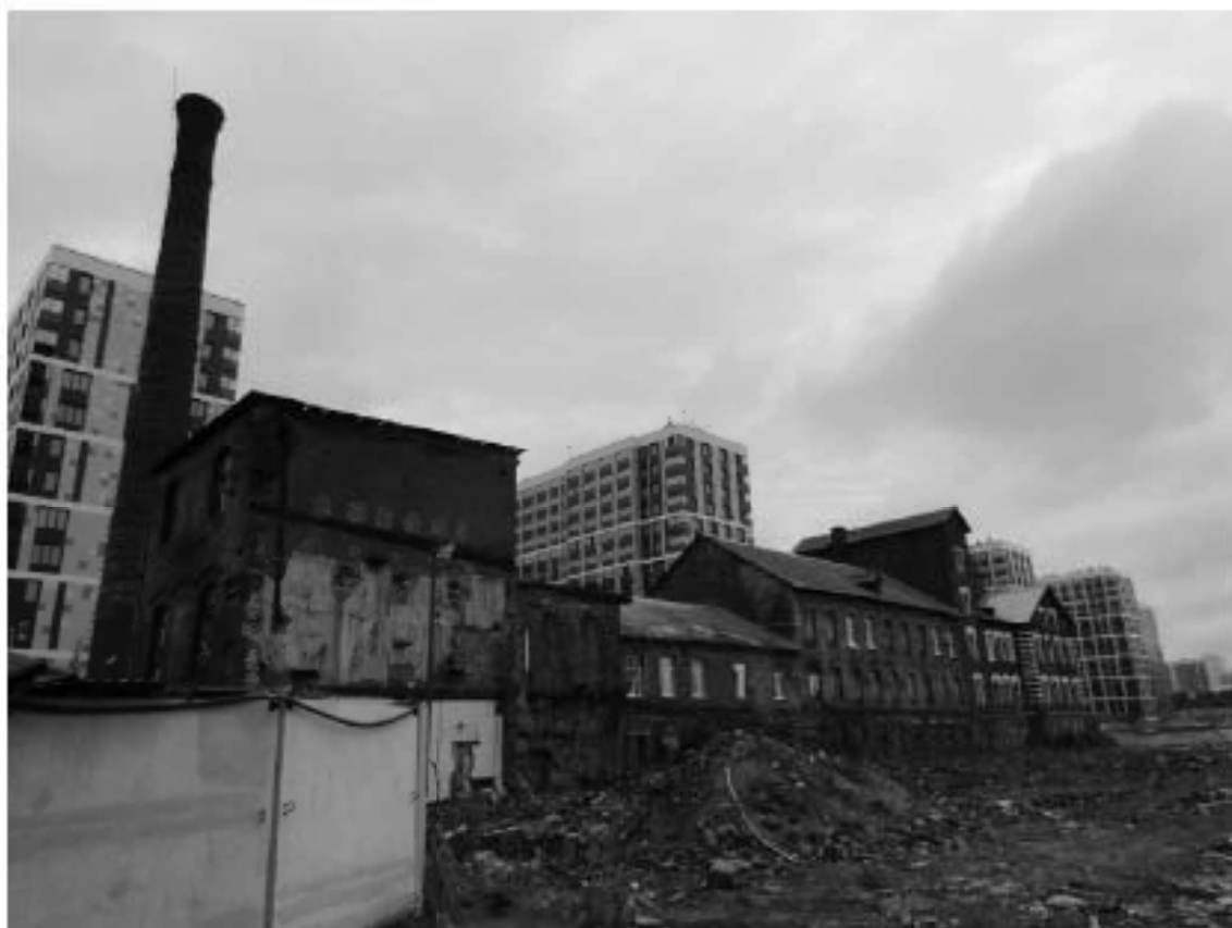
23 Выделенный ОКН «Производственное здание с дымовой трубой Кизованского Ультрамаринового завода Г.И. Веген», по адресу: г. Санкт-Петербург, Октябрьская набережная, дом 38, литера АН. Общий вид с юга. Дата съемки: 12.09.2022
