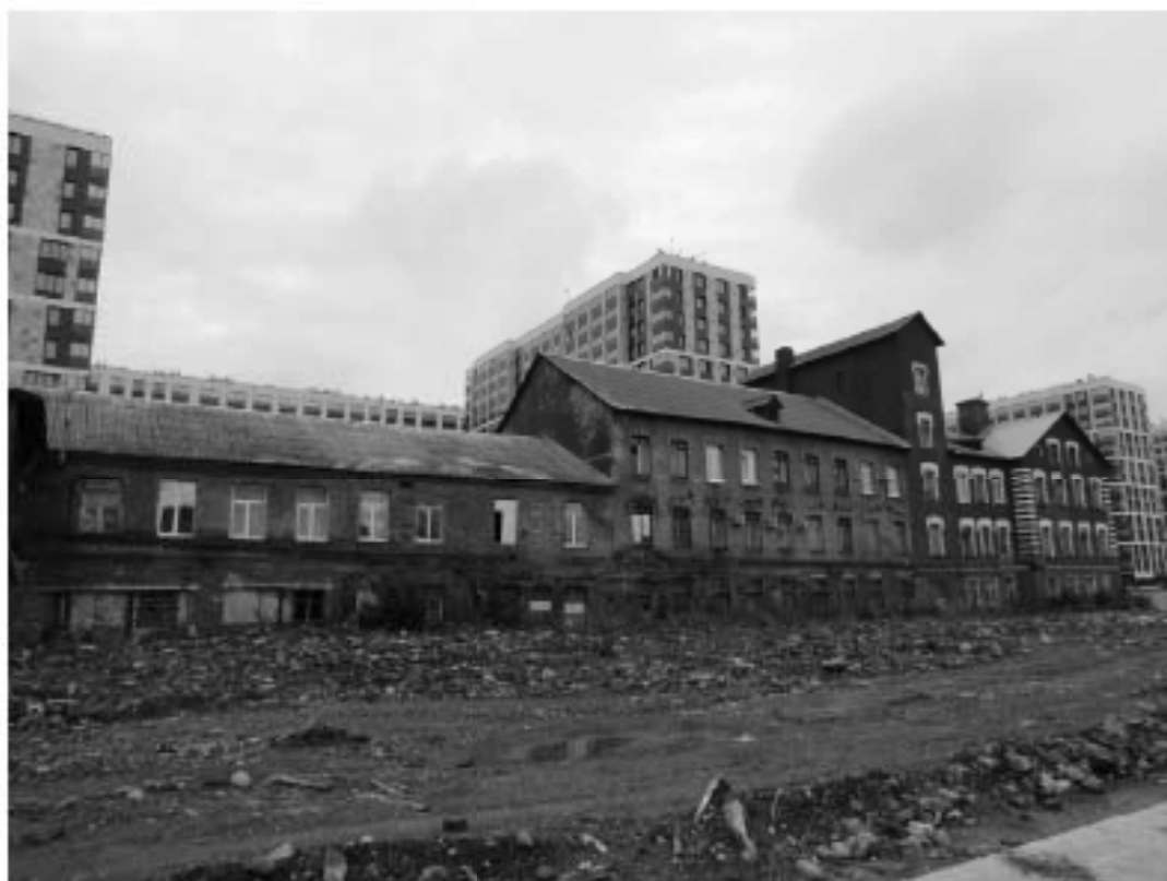
7 Выявленный ОКН «Производственное здание с дымоходной трубой Кировского Ул.трамвайного завода Г.И. Вегера», по адресу: г. Санкт-Петербург, Октябрьская набережная, дом 38, литера АН. Литера АН6. Вид с юга. Дата съемки: 12.09.2022
