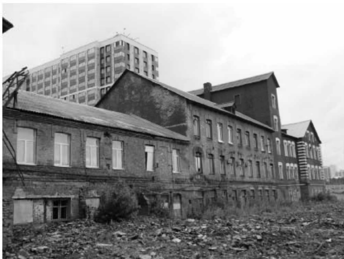
24 Выделенный ОКН «Производственное здание с дымовой трубой Кизованского Ультрамаринового завода Г.И. Веген», по адресу: г. Санкт-Петербург, Октябрьская набережная, дом 38, литера АН. Литера АН6. Вид с юга. Дата съемки: 12.09.2022
