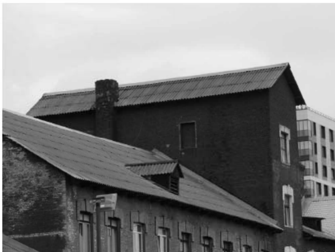
28 Выявленный ОКН «Производственное здание с дымовой трубой Кисловоленского Ультрамаринового завода ГИ. Вегет», по адресу: г. Санкт-Петербург, Октябрьская набережная, дом 38, литера АН. Литера АН6. Кровля 3-х-этажной части и мезонин 5-ти-этажной части. Вид с юга. Дата съёмки: 12.09.2022
