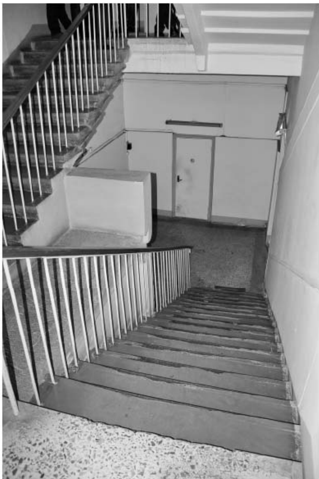
82 Выявленный ОКН «Производственное здание с дымовой трубой Киновиевского Ультрамаринового завода ГИ. Веге», по адресу: г. Санкт-Петербург, Октябрьская набережная, дом 38, литера АН, Лит. АН6. Лестница. Вид с площадки между 1 и 2 этажами Дата съемки: 12.09.2022
