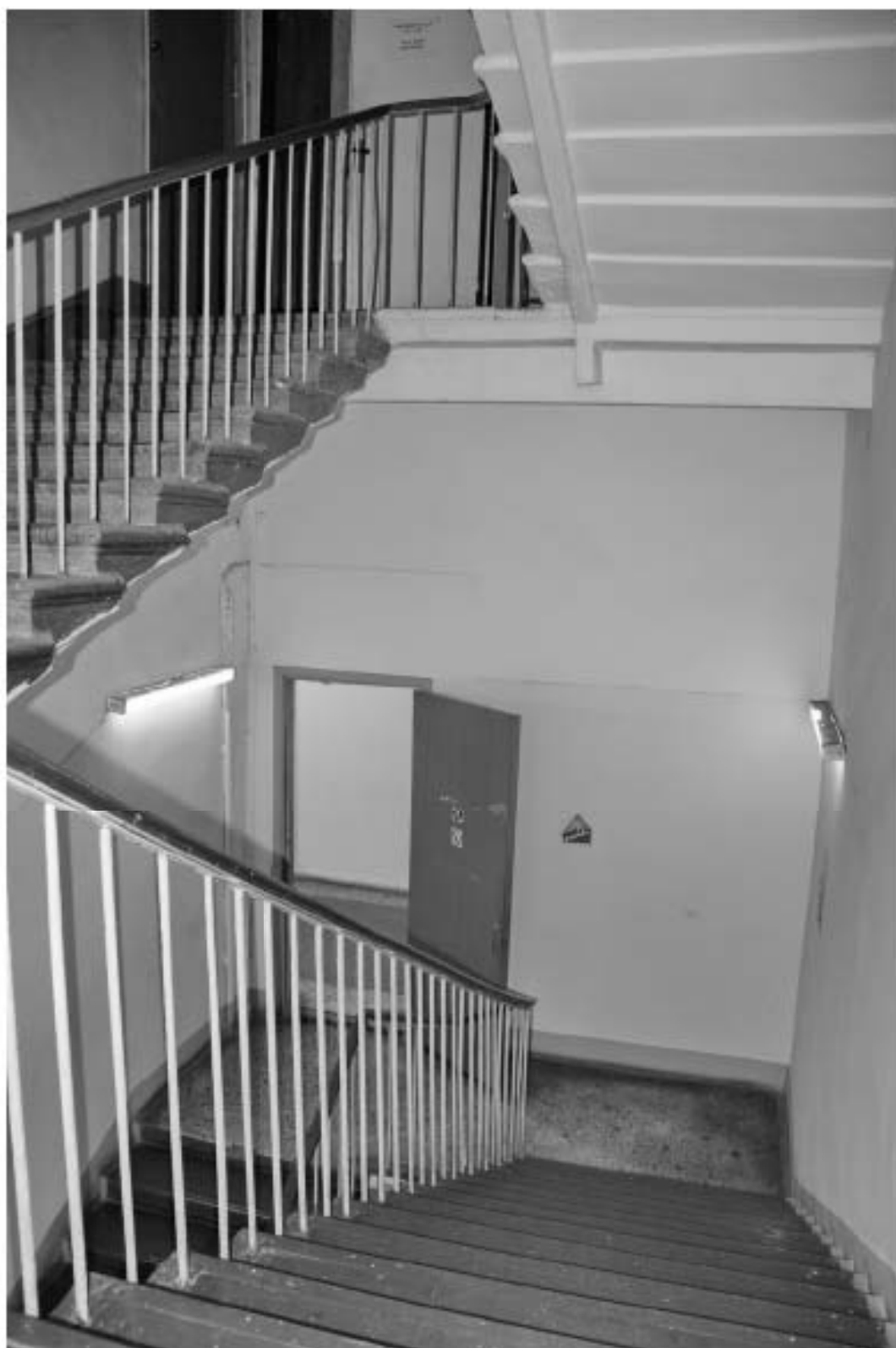
84 Выявленный ОКН «Производственное здание с дымовой трубой Киновиевского Ультрамаринового завода ГИ. Веге», по адресу: г. Санкт-Петербург, Октябрьская набережная, дом 38, литера АН. Лит. АН6. Лестница. Вид с площадки между 3 и 4 этажами Дата съемки: 12.09.2022
