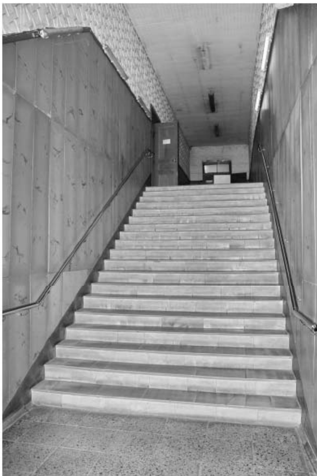
90 Выявленный ОКН «Производственное здание с дымовой трубой Киновиевского Ультрамаринного завода ГИ. Веге», по адресу: г. Санкт-Петербург, Октябрьская набережная, дом 38, литера АН, Лит. АН7, 1 этаж. Лестница на 2 этаж Дата съемки: 12.09.2022
