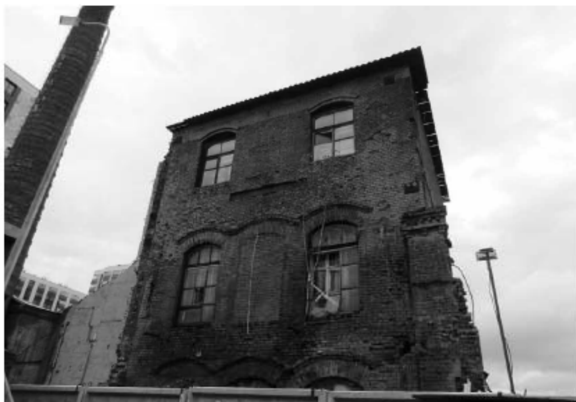
3 Выявленный ОКН «Промышленное здание с дымовой трубой Киншасинского Удгирмаритового завода Г.И. Веген», по адресу: г. Санкт-Петербург, Огужьрская набережная, дом 38, литера АН. Литера АН5. Вид с юго-запада. Дата съёмки: 12.09.2022
