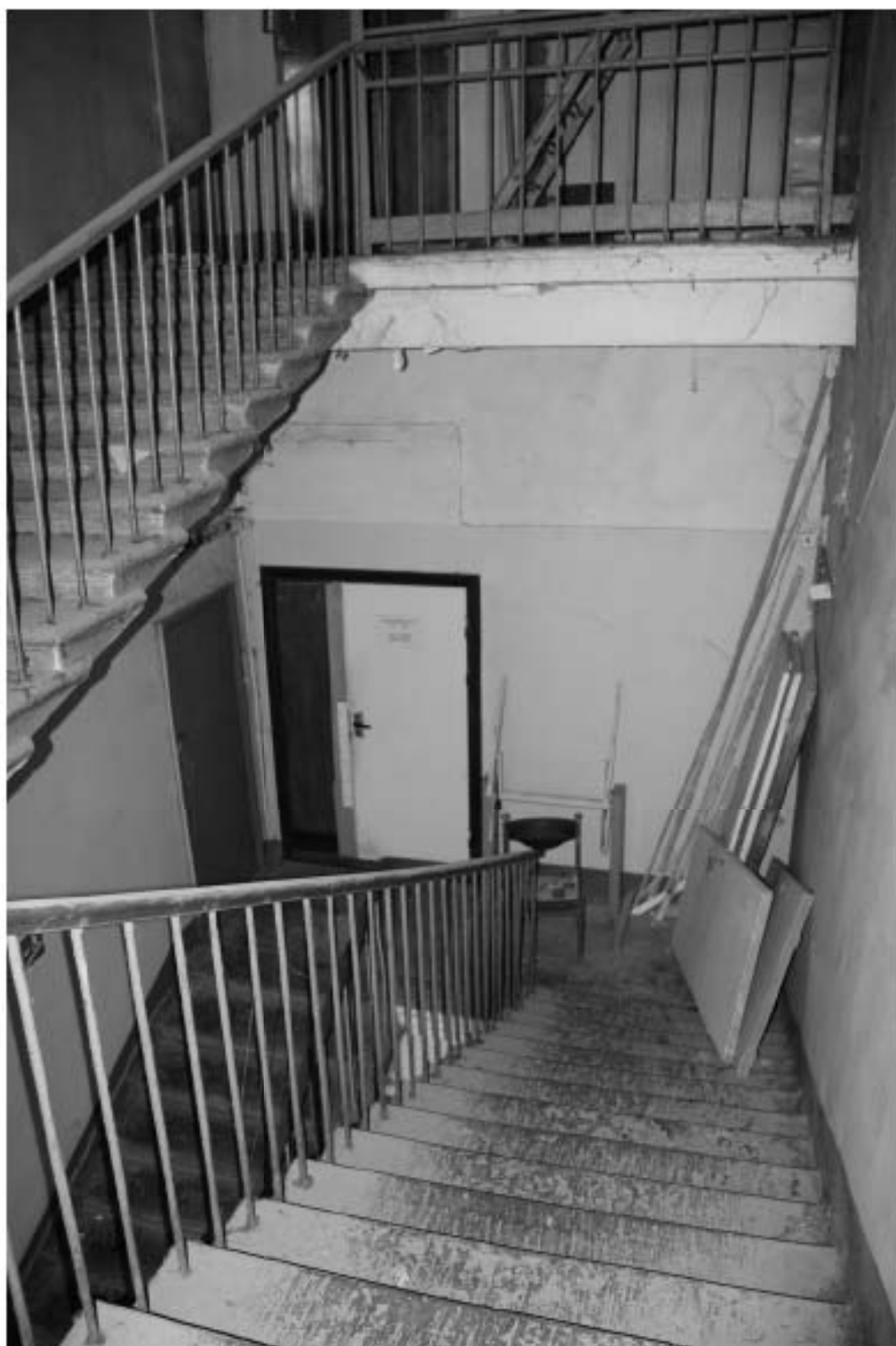
86 Выявленный ОКН «Производственное здание с дымовой трубой Киновиевского Ультрамаринового завода ГИ. Веге», по адресу: г. Санкт-Петербург, Октябрьская набережная, дом 38, литера АН. Лит. АН6. Лестница. Вид с площадки между 4 и 5 этажами Дата съемки: 12.09.2022
