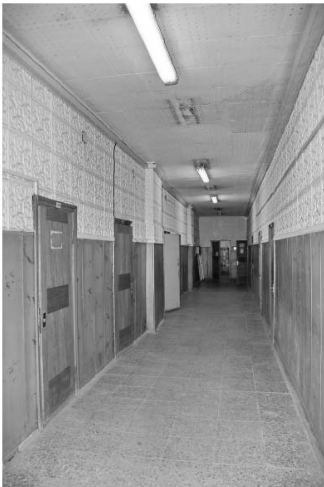
87 Выявленный ОКН «Производственное здание с дымовой трубой Киновисевского Ультрамаринового завода ГИ. Веге», по адресу: г. Санкт-Петербург, Октябрьская набережная, дом 38, литера АН, Лит. АН7, 1 этаж. Помещение 15 (согласно планам ПИБ) Дата съемки: 12.09.2022
