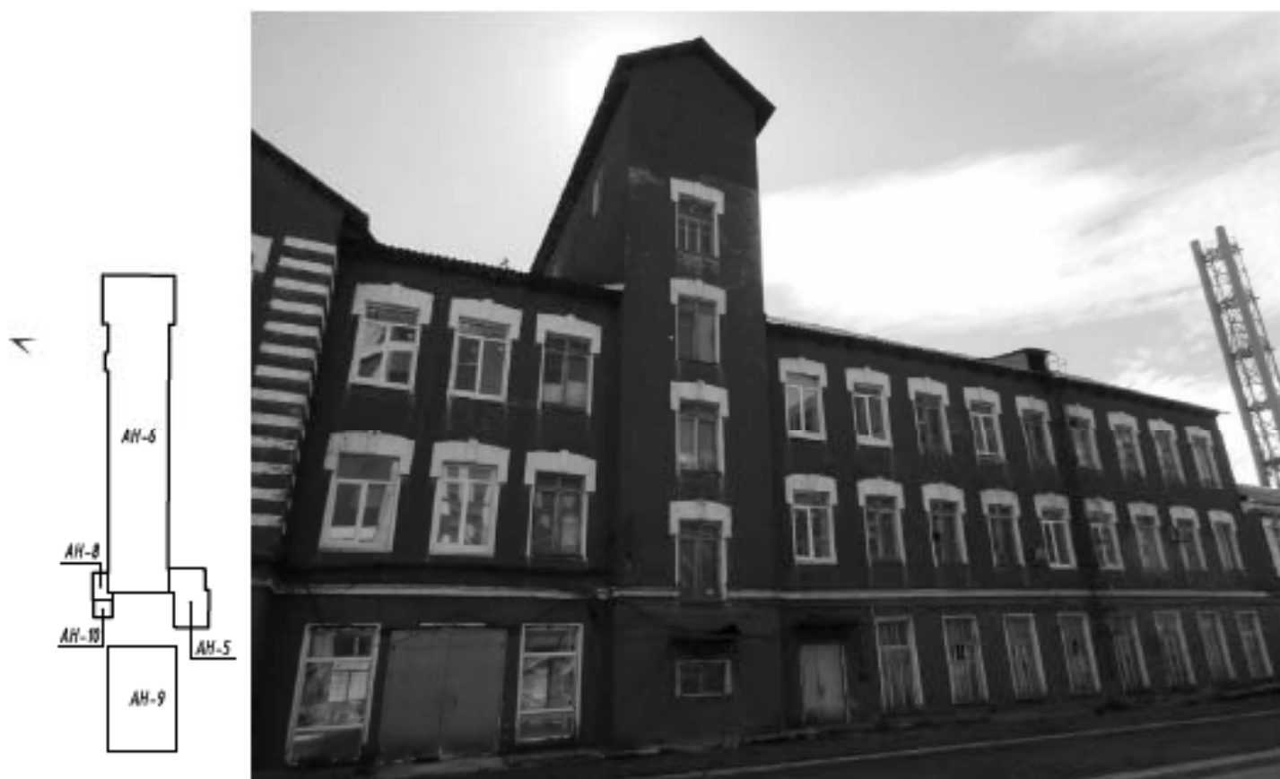
34 Выделенный ОКН «Производственное здание с дымовой трубой Кизованского Ультрамаринового завода ГИ. Веген», по адресу: г. Санкт-Петербург, Октябрьская набережная, дом 38, литера АН. Литера АН6. 3-х этажная часть. Вид с северо-запада. Дата съемки: 12.09.2022
