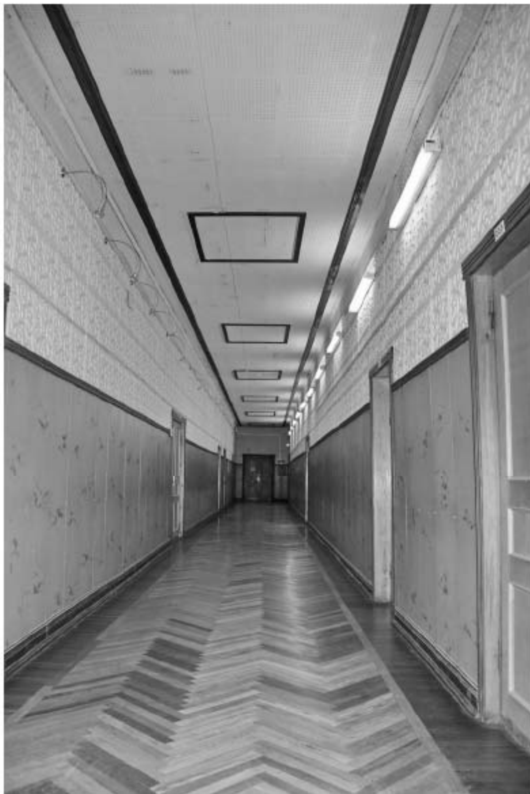
93 Выявленный ОКН «Производственное здание с дымовой трубой Киновиевского Ультрамаринового завода ГИ. Веге», по адресу: г. Санкт-Петербург, Октябрьская набережная, дом 38, литера АН, Лит. АН7, 2 этаж. Помещение 42 (согласно планам ПИБ) Дата съемки: 12.09.2022
