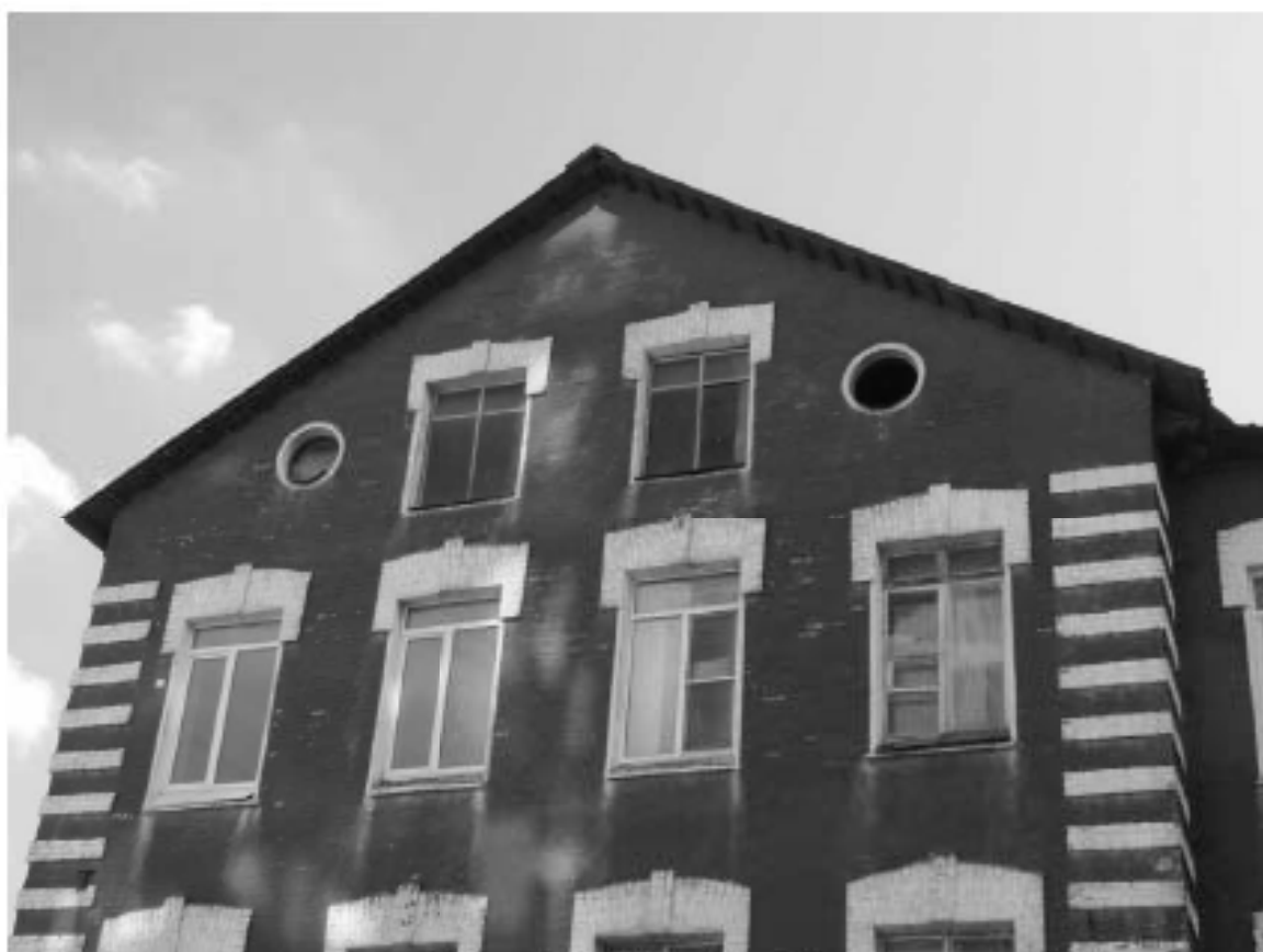
35 Выявленный ОКН «Производственное здание с дымовой трубой Кизованского Ультрамаринового завода Г.И. Веген», по адресу: г. Санкт-Петербург, Октябрьская набережная, дом 38, литера АН. Литера АН6. Фронтон 3-х этажной части. Вид с запада. Дата съемки: 12.09.2022
