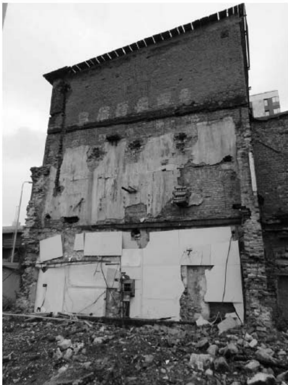
25 Выявленный ОКН «Производственное здание с дымовой трубой Киновисевского Ультрамаринового завода ГИ. Веге», по адресу: г. Санкт-Петербург, Октябрьская набережная, дом 38, литера АН. Литера АН5. 3-х этажная часть. Вид с юго-востока. Дата съемки: 12.09.2022
