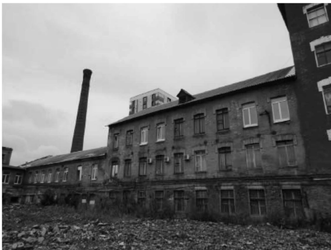
15 Выявленный ОКН «Производственное здание с дымовой трубой Кизованского Ультрамаринового завода Г.И. Веген, по адресу: г. Санкт-Петербург, Октябрьская набережная, дом 38, литера АН. Литера АН6. Вид с запада. Дата съемки: 12.09.2022
