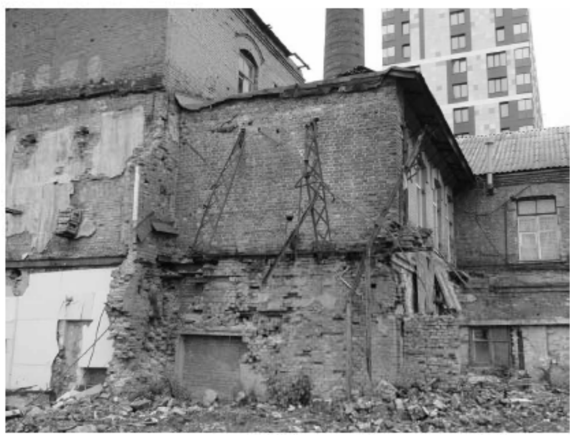
22 Выявленный ОКН «Производственное здание с дымовой трубой Кизованского Ультрамаринового завода Г.И. Веген», по адресу: г. Санкт-Петербург, Октябрьская набережная, дом 38, литера АН. Литера АН5. Вид с востока. Дата съемки: 12.09.2022
