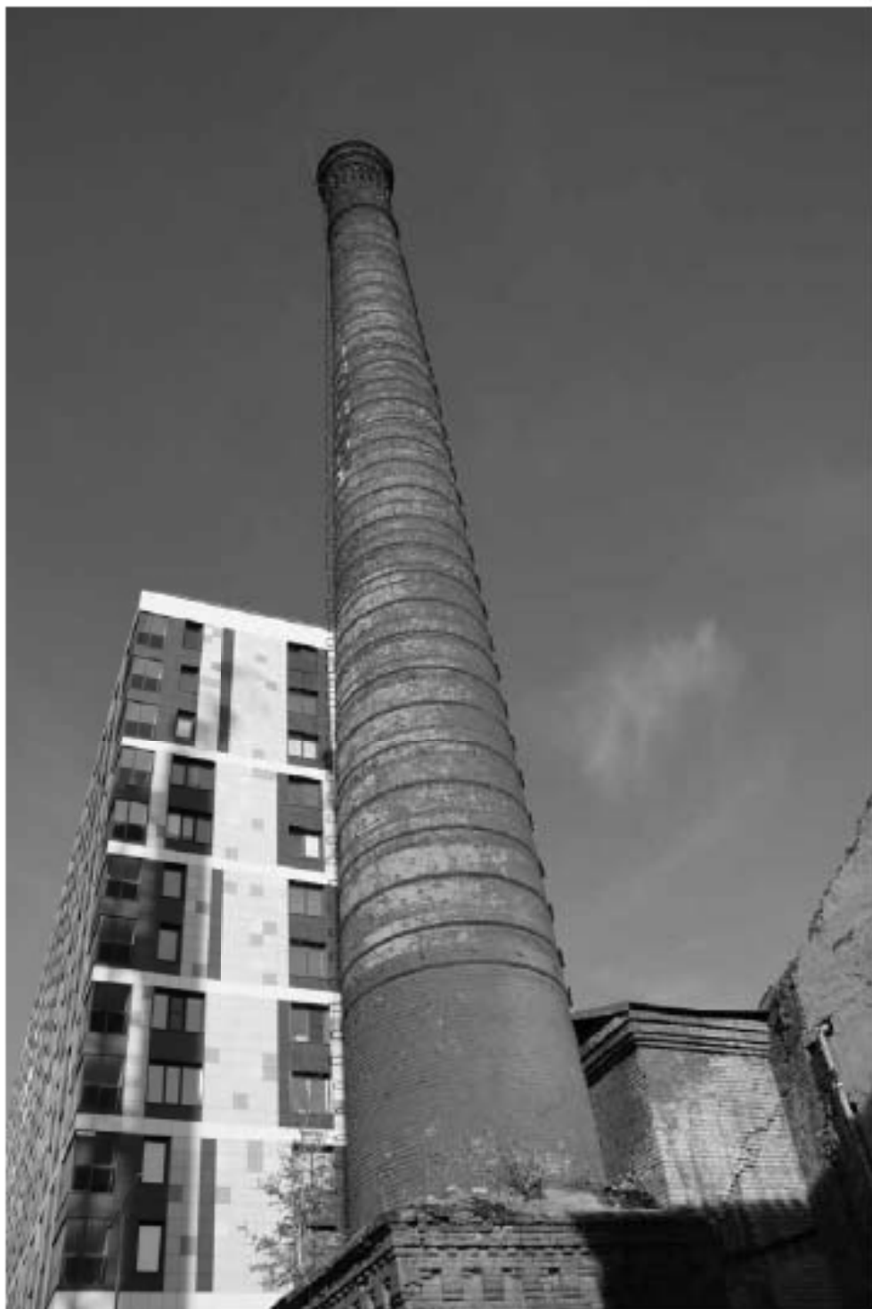
2 Выявленный ОКН «Производственное здание с дымовой трубой Киновисевского Ультрамаринного завода ГИ. Веге», по адресу: г. Санкт-Петербург, Октябрьская набережная, дом 38, литера АН. Ствол дымовой трубы литеры АН-10. Вид с юга. Дата съемки: 12.09.2022
