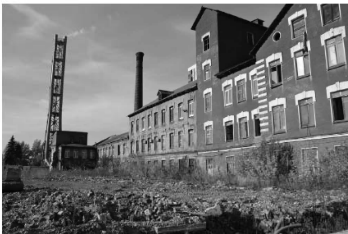
10 Выявленный ОКН «Производственное здание с дымовой трубой Кизованского Ультрамаринового завода Г.И. Веген», по адресу: г. Санкт-Петербург, Октябрьская набережная, дом 38, литера АН. Общий вид с востока. Дата съемки: 12.09.2022
