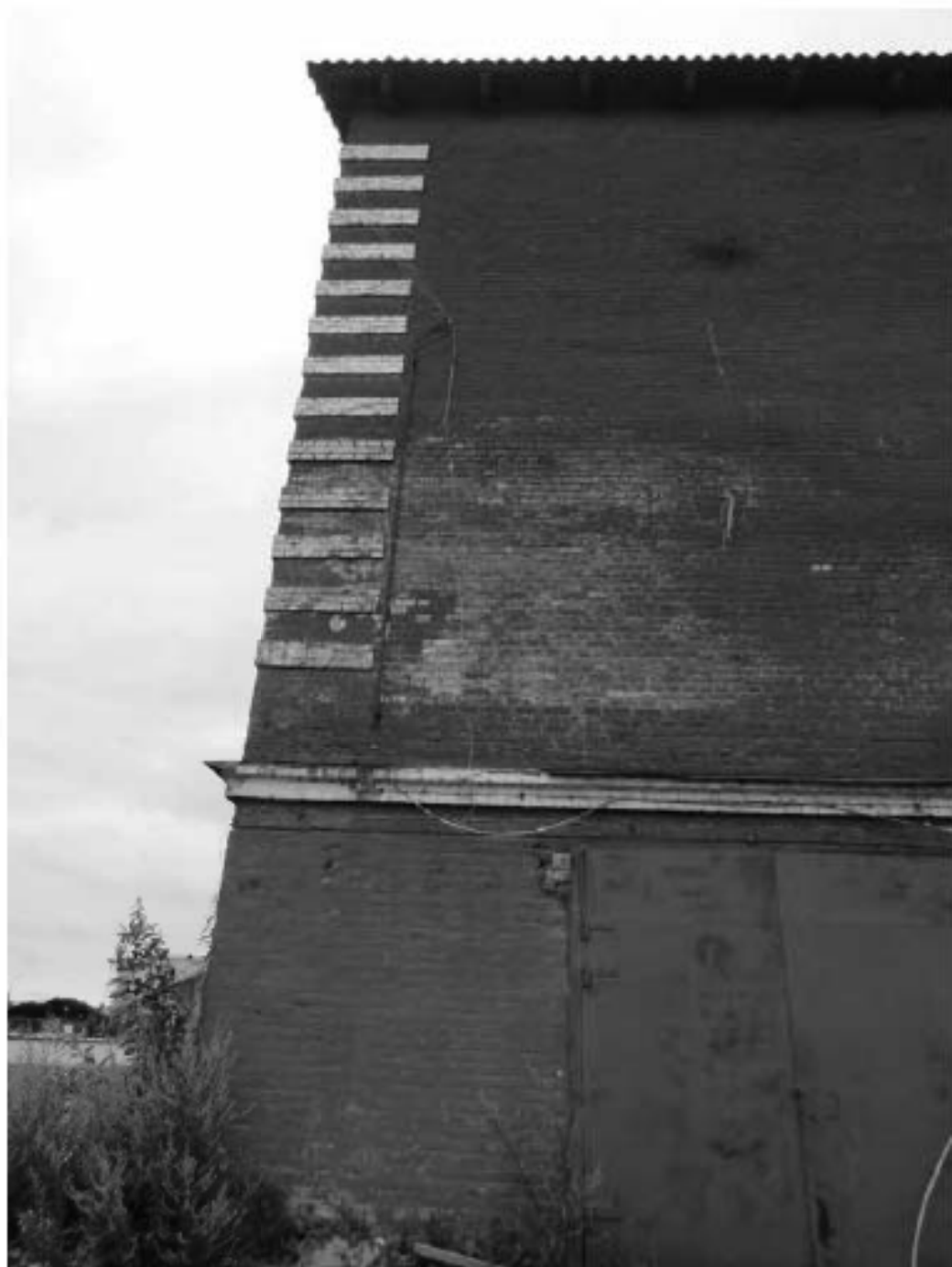
12 Выявленный ОКН «Производственное здание с дымовой трубой Киновисского Ультрамаринового завода Г.И. Веге», по адресу: г. Санкт-Петербург, Октябрьская набережная, дом 38, литера АН. Литера АН6. Фрагмент северного фасада 3-х этажного объема. Дата съемки: 12.09.2022
