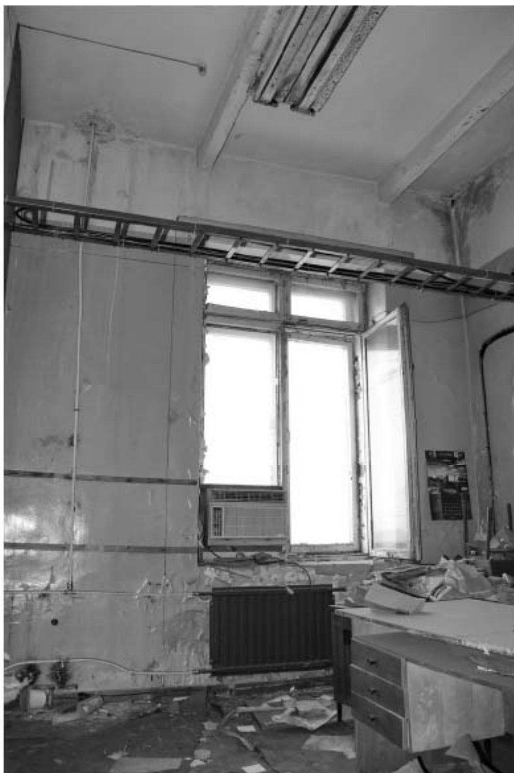
56 Выявленный ОКН «Производственное здание с дымовой трубой Киновиевского Ультрамаринового завода ГИ. Веге», по адресу: г. Санкт-Петербург, Октябрьская набережная, дом 38, литера АН, Лит. АН6, 2 этаж. Помещение 10 (согласно планам ПИБ) Дата съемки: 12.09.2022
