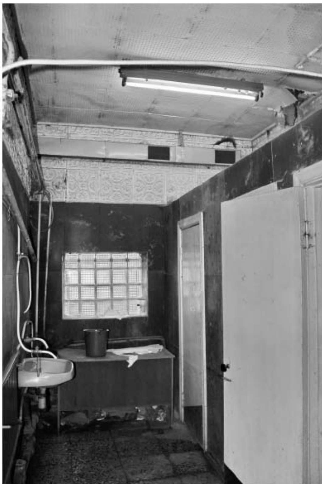
100 Выявленный ОКН «Производственное здание с дымовой трубой Киновиевского Ультрамаринного завода ГИ. Веге», по адресу: г. Санкт-Петербург, Октябрьская набережная, дом 38, литера АН, Лит. АН4, 1 этаж. Помещение 37 (согласно планам ПИБ) Дата съемки: 12.09.2022
