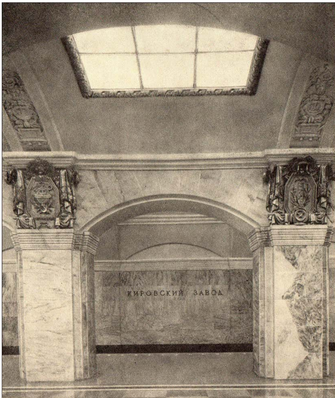
20. Капители противоположенных колонн соединены по своду лепными дугами, на которых изображены буквы «К», эмблемы Кировского завода, в окружении венков листьев и звезд. Фото 1956 г. — Станция метрополитена «Кировский завод» // Citywalls.ru – архитектурный сайт Петербурга [Электронный ресурс]. URL: https://www.citywalls.ru/house5194.html .
