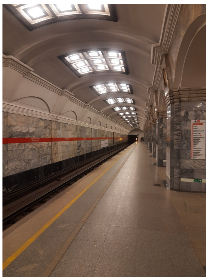
Фото 24 Фрагмент интерьера объекта культурного наследия регионального значения «Станция метро «Кировский завод», г. Санкт-Петербург, пр. Стачек, д. 70, литера А. (перронный зал)
