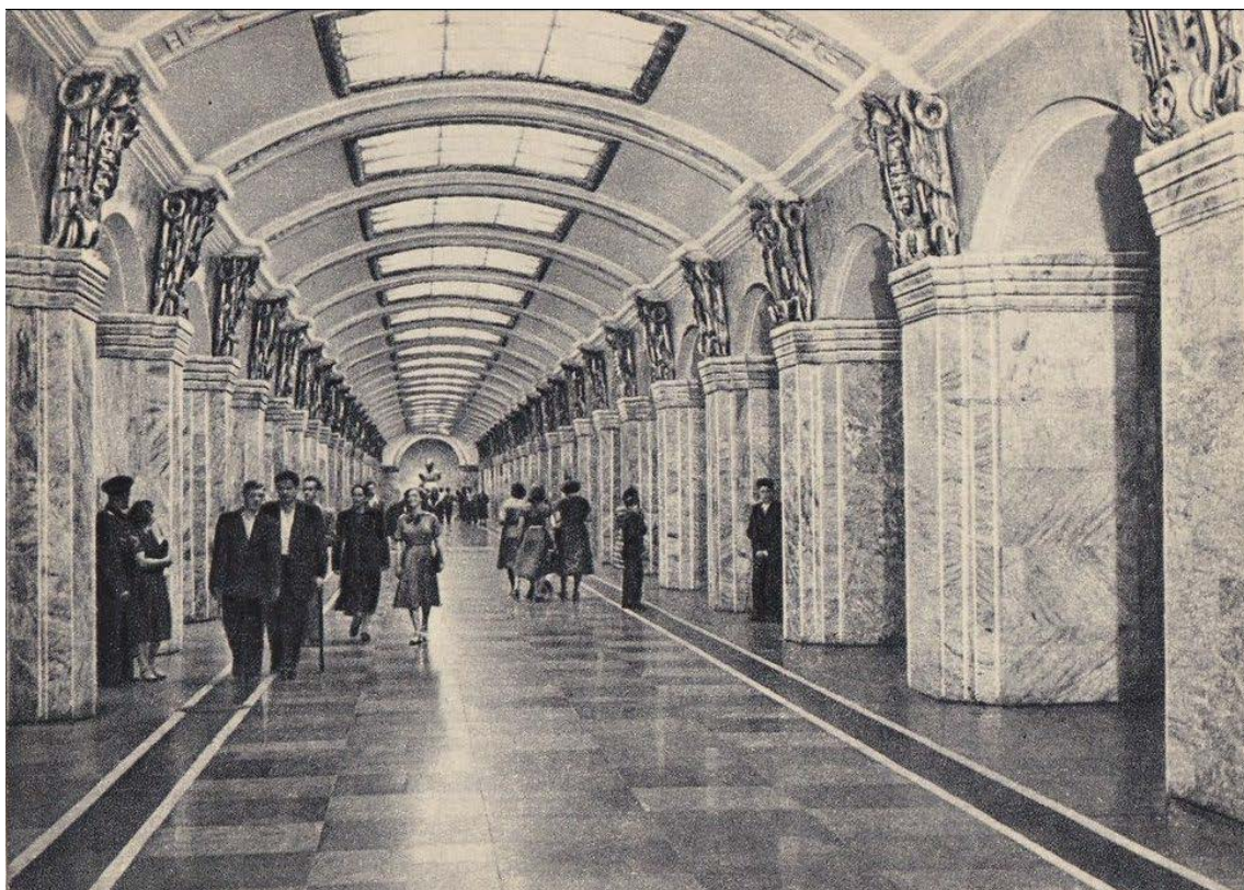
23. Арки и стены центрального и боковых залов завершает декоративный лепной карниз. Все три свода станции отделаны штукатуркой белого цвета. Фото 1957 г. — «PastVu» – ретро-фотографии стран и городов [Электронный ресурс]. URL: https://pastvu.com/p/146494 .
