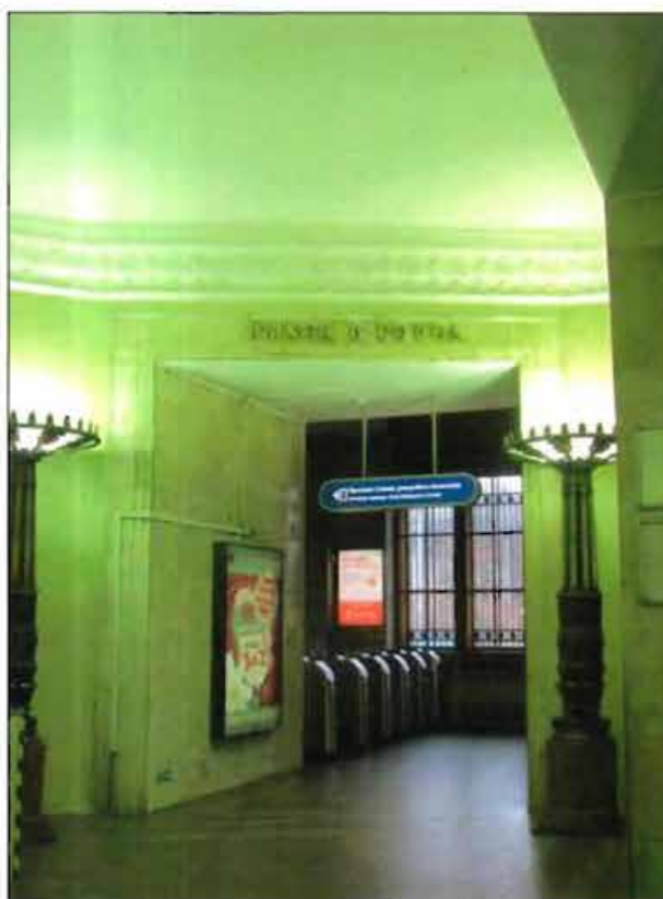
8. Верхний вестибюль. Фрагмент. Фотофиксация от 23.07.2021.
