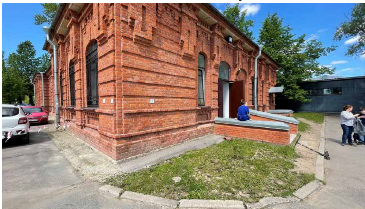
12.Общий вид на юго-восточный фасад здания;
