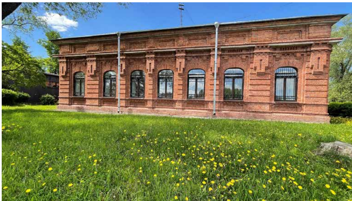
27.Общий вид на восточный фасад здания;
