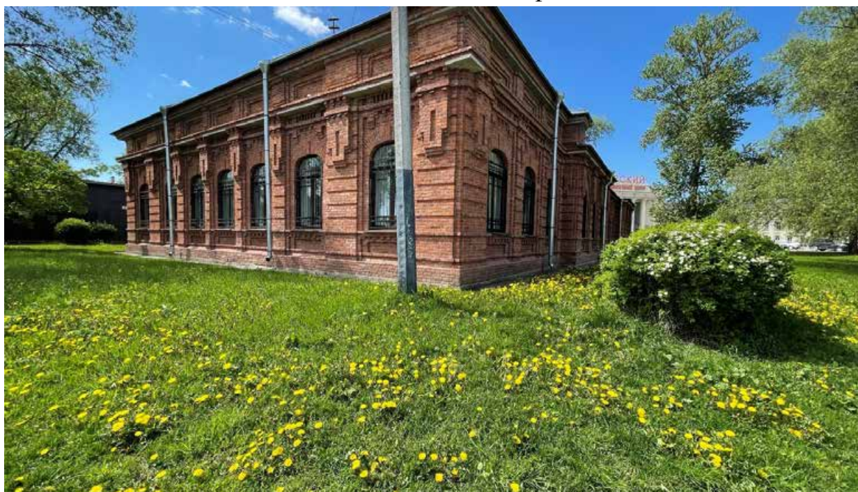
28.Общий вид на северо-восточный фасад здания;
