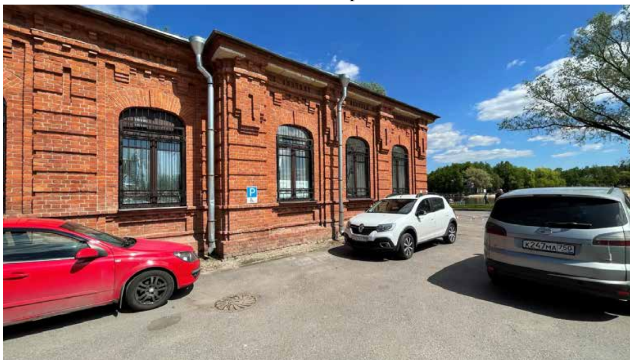
10. Вид на южный фасад здания;
