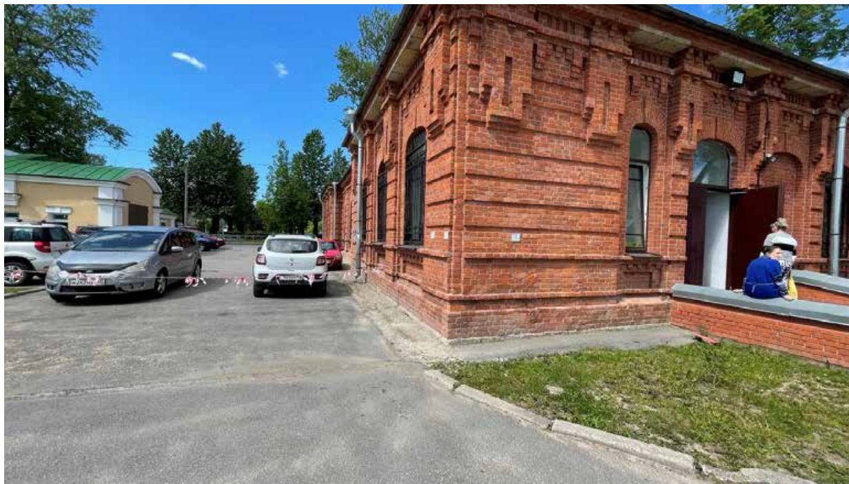
11.Общий вид на юго-восточный фасад здания;
