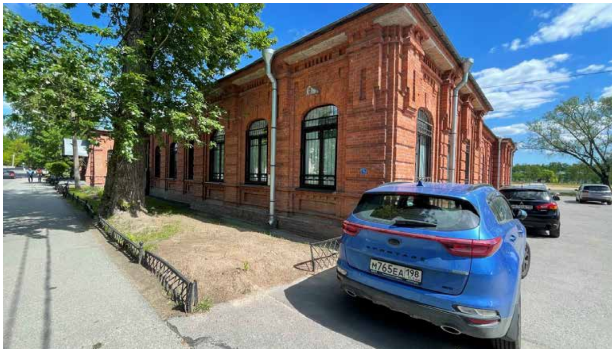
7. Вид на юго-западный фасад здания;
