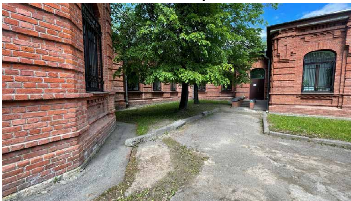
20. Вид на восточный фасад здания;
