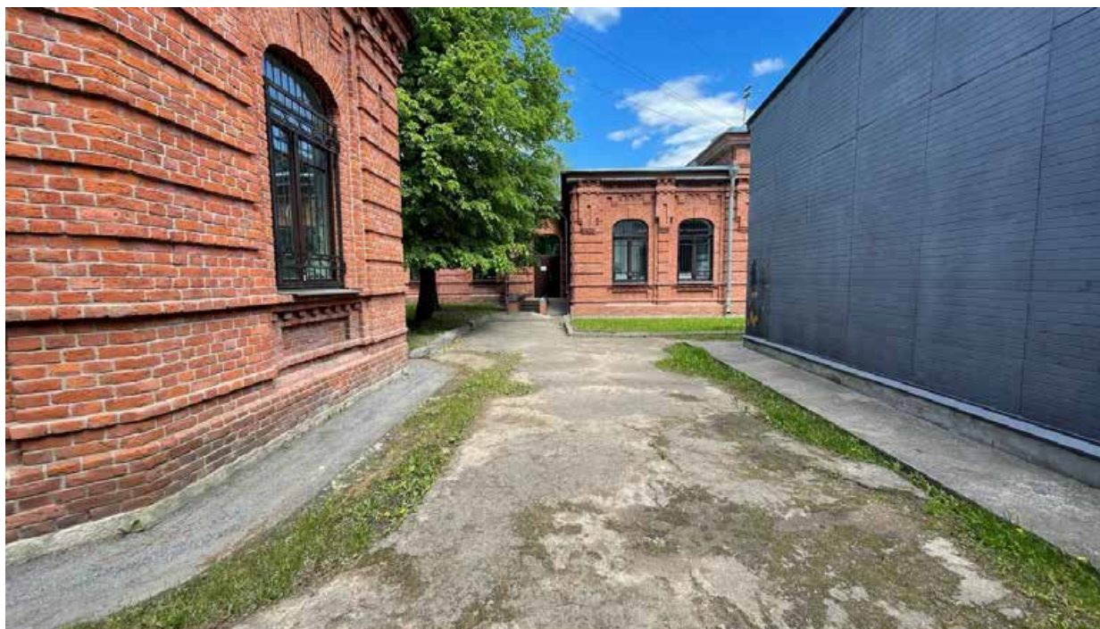
19. Вид на восточный фасад здания;
