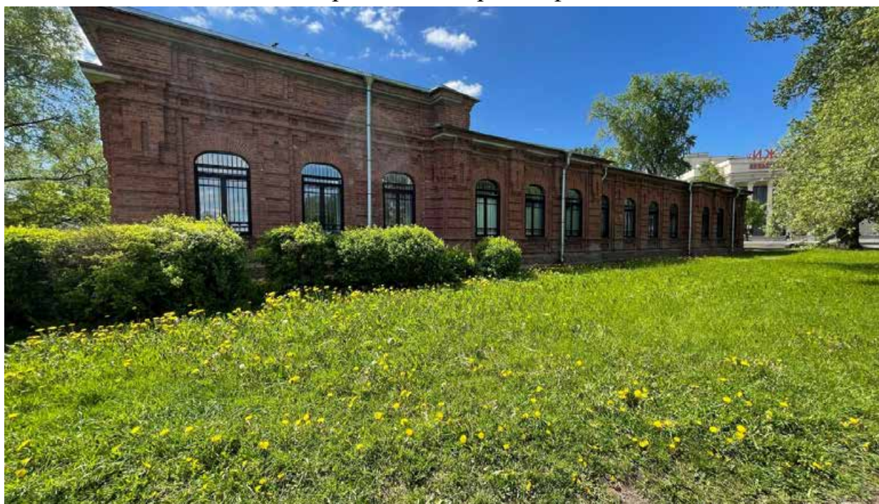
30.Общий вид северного фасада здания;
