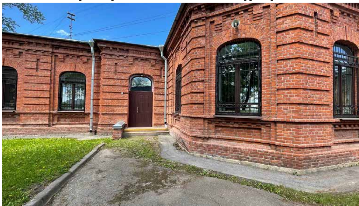
18.Вид на восточный фасад здания;
