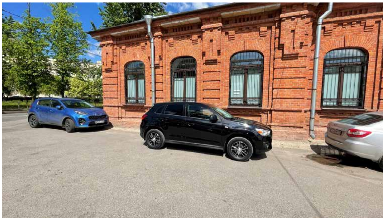
9. Вид на южный фасад здания;
