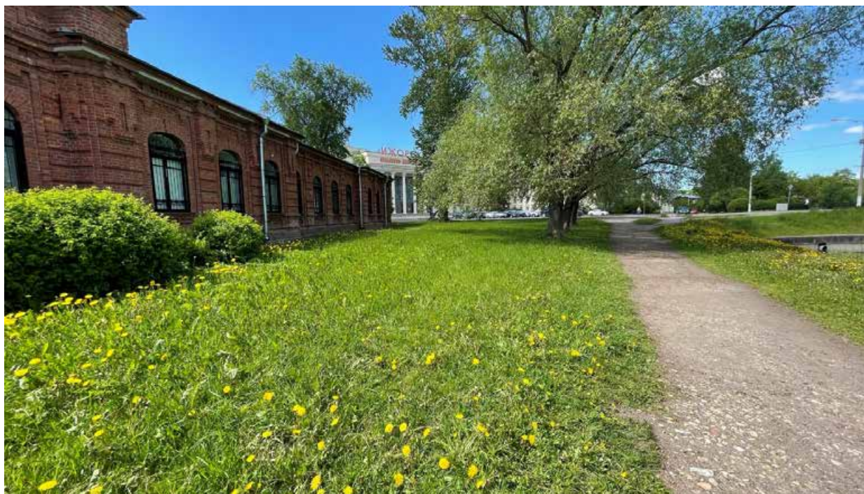
29.Фрагмент северного фасада;
