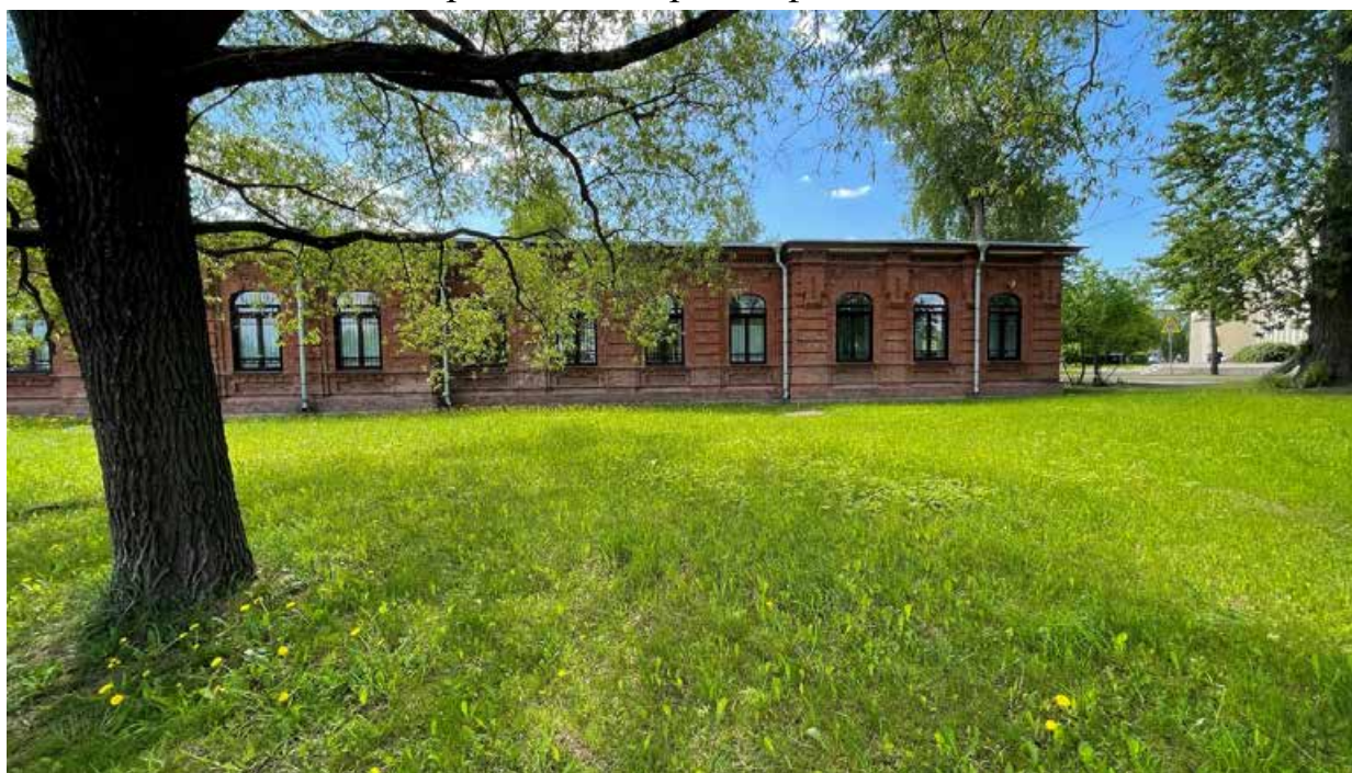
32.Фрагмент северного фасада здания;
