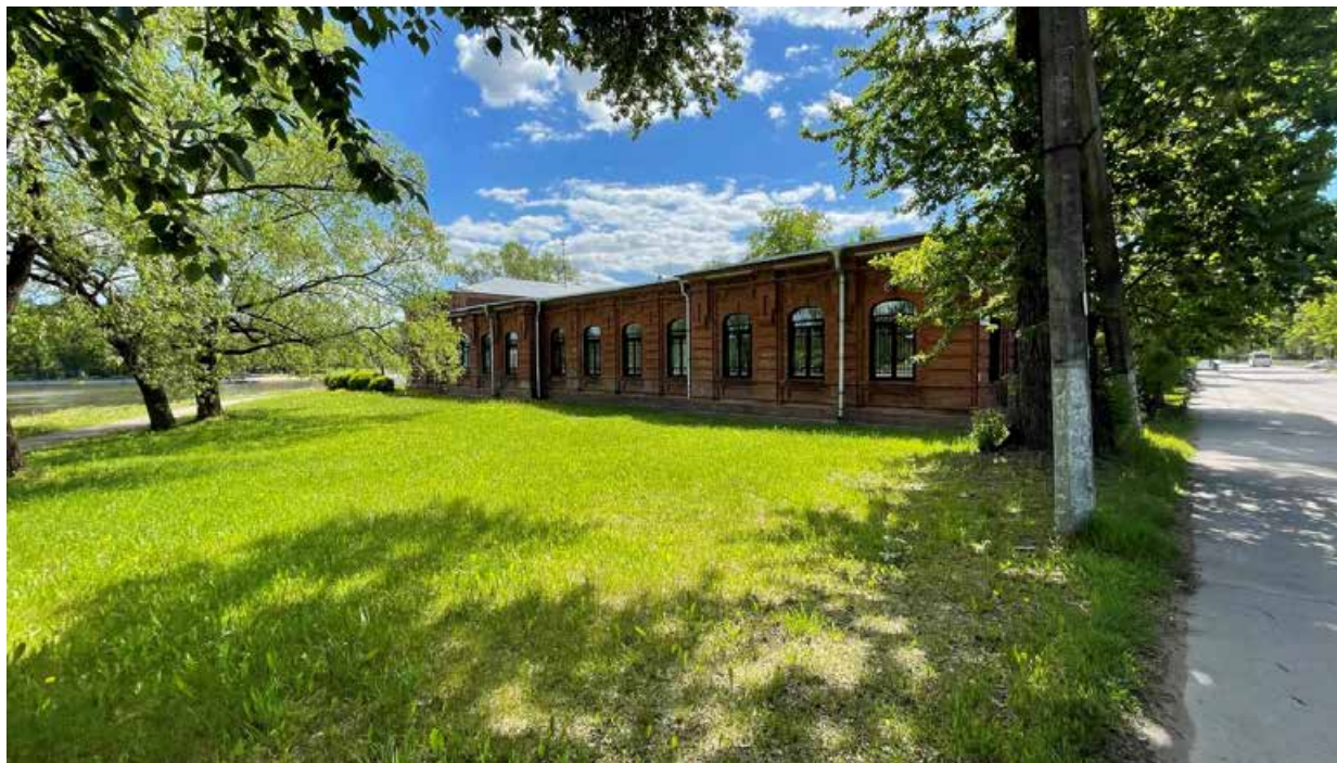
33. Фрагмент северного фасада здания с Адмиралтейской улицы;
