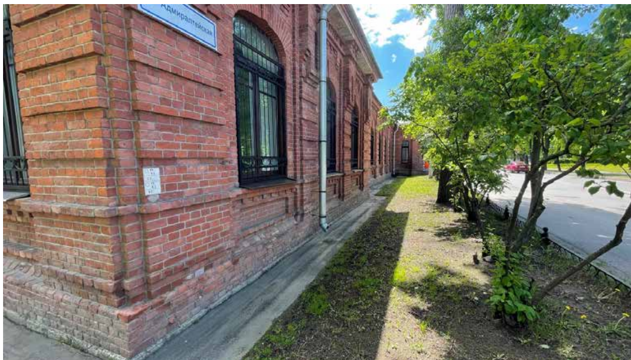
5. Вид на северо-западный фасад здания;
