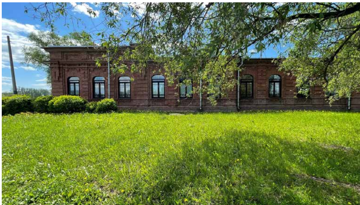
31.Фрагмент северного фасада здания;
