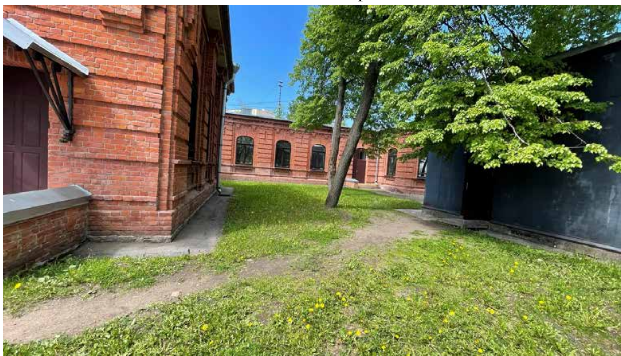
14. Вид на восточный фасад здания и территорию школы;
