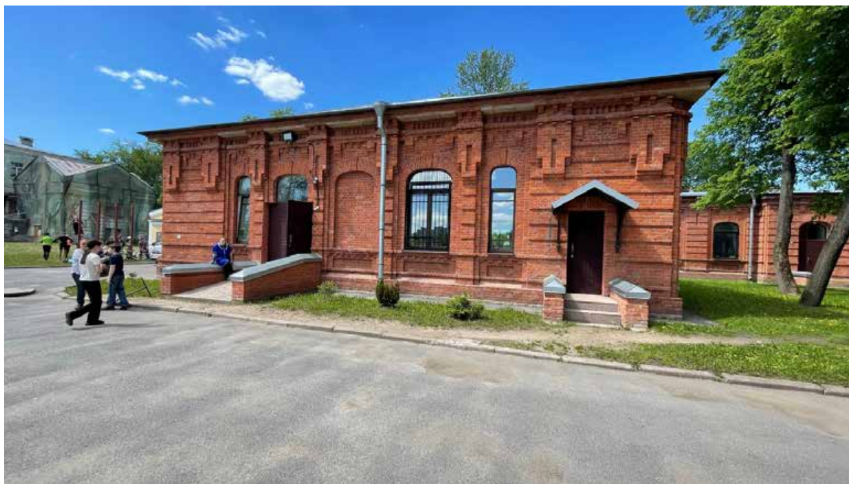
13. Вид на восточный фасад здания;
