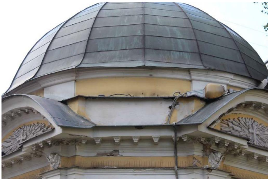
Фото 27. Южная часовня. Разрушение профиля горизонтальных тяг, очаги «бронзовой болезни» медной кровли, деформация фальцев
