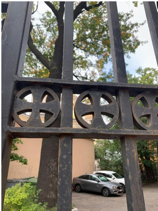
Фото 5. Современная секция. Следы коррозии металла.
