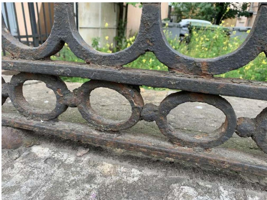
Фото 8. Фрагмент нижнего пояса решетки, коррозия металла, деструкция красочного слоя
