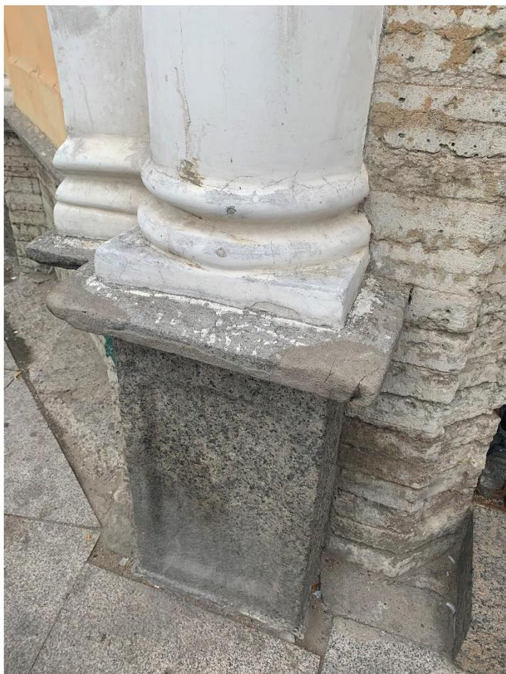
Фото 30. Южная часовня. Трещины в штукатурном слое колонн и в плинтах. Обитонирование горизонтальной полки цокольного карниза
