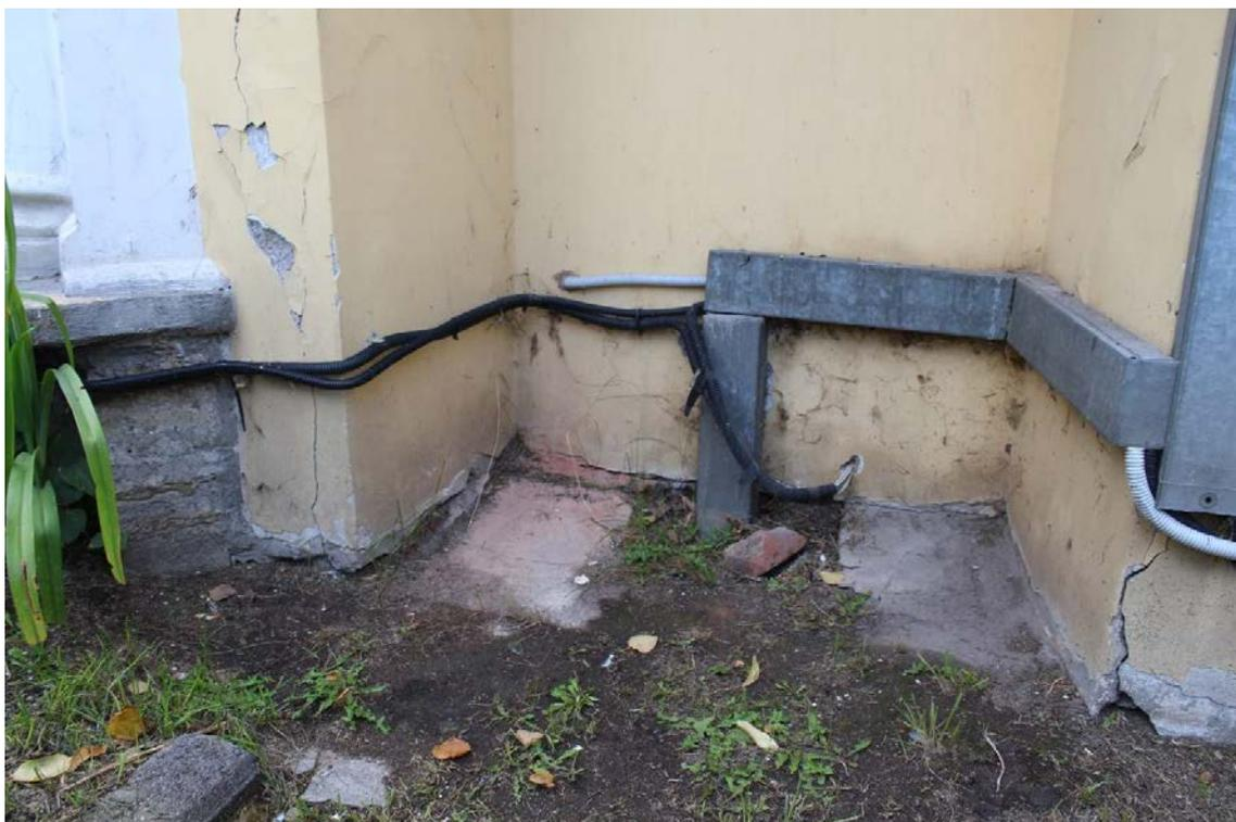
Фото 33. Южная часовня. Вид со стороны сада. Утрата части цоколя из известняковых плит. Трещины в штукатурном слое, деструкция красочного слоя.
