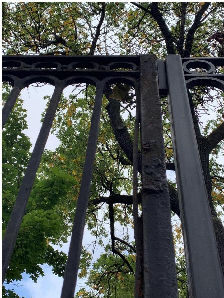
Фото 7. Стыковка подлинной секции с современной со стороны Кузнечного переуллка
