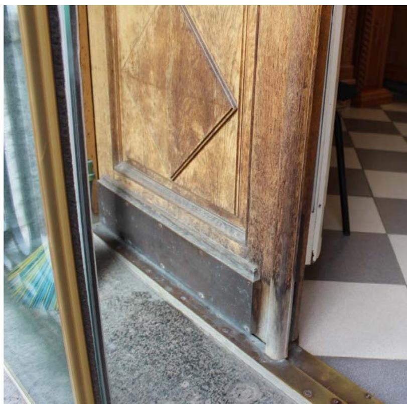
Фото 32. Дверное заполнение. Утрата защитного покрытия, потемнение дверного полотна в эксплуатационной зоне влагоудержания.
