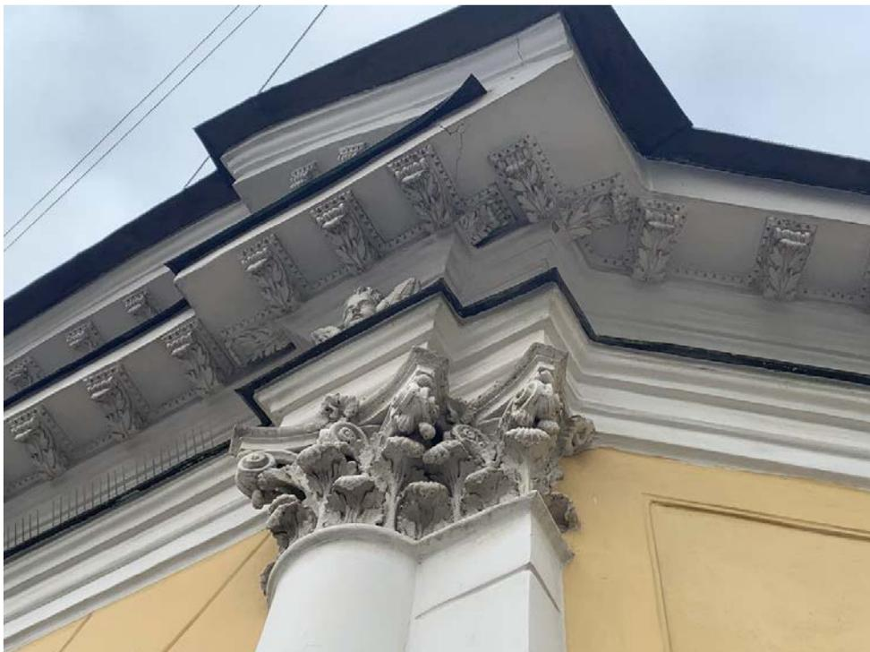
Фото 29. Южная часовня. Трещина в карнизном выступе
