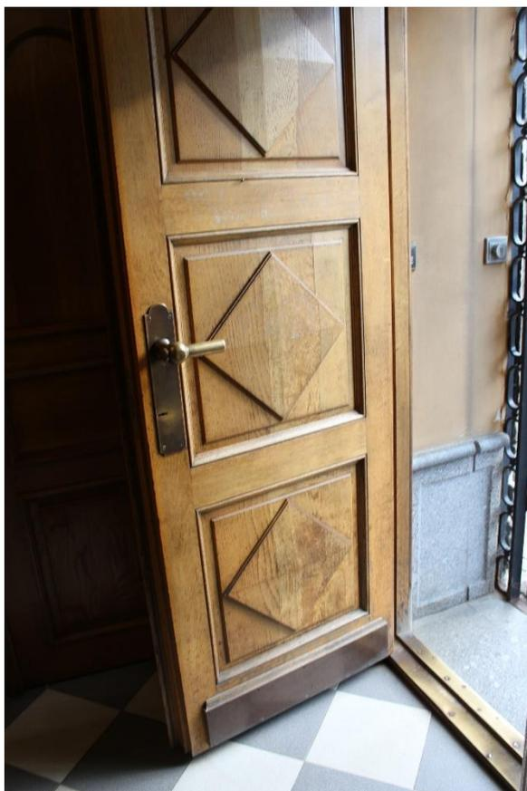
Фото 31. Дверное заполнение. Стыковые дефекты и трещины между отдельными элементами
