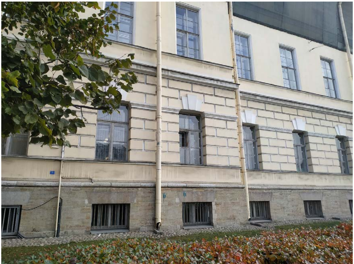
13. Фрагмент лицевого фасада.
