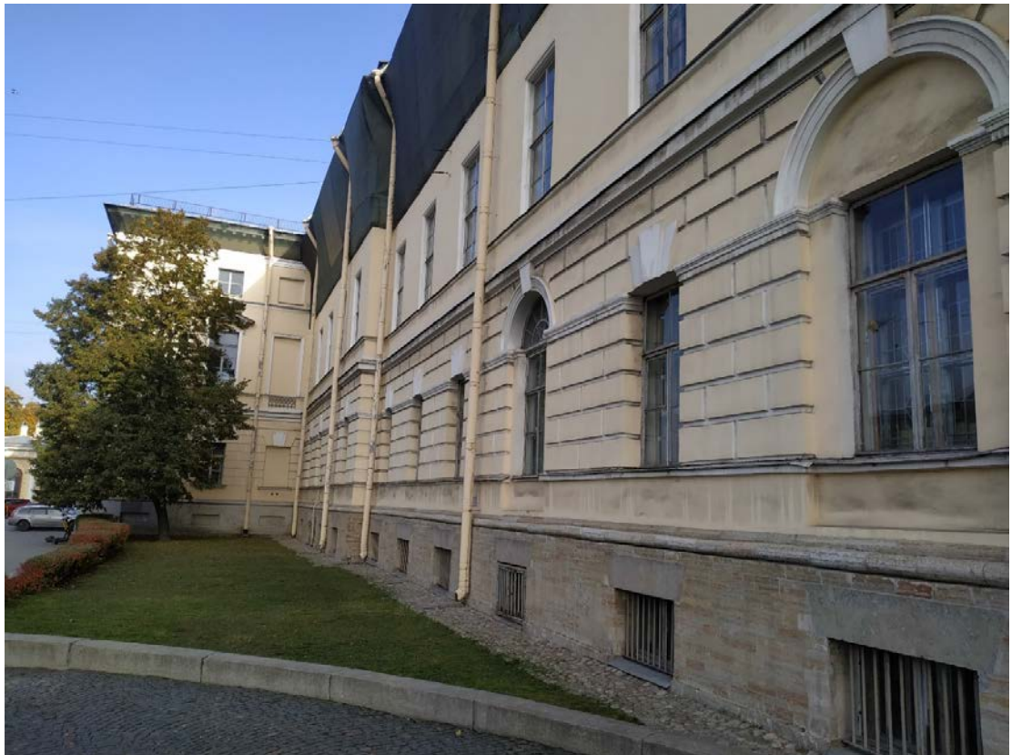
9. Северная часть лицевого фасада.
