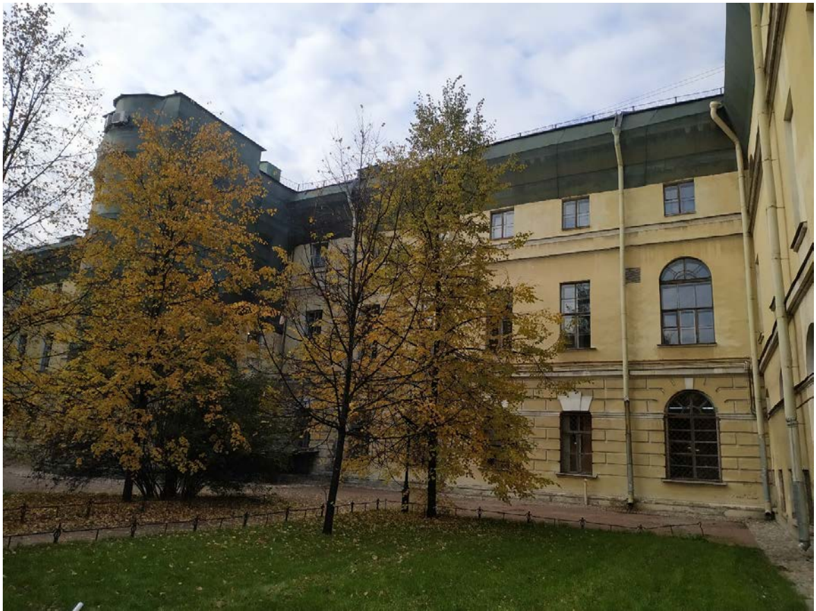
26. Фрагмент восточного фасада главного корпуса. Вид со стороны Итальянского сада.
