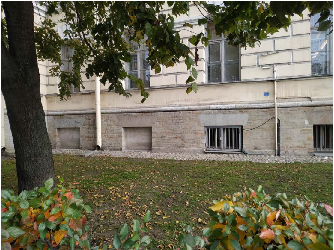
15. Заложённые оконные проемы цокольного этажа в северной части лицевого фасада.
