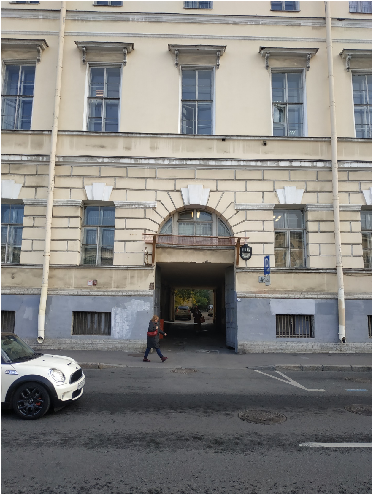
21. Фрагмент фасада южного ризалита.
