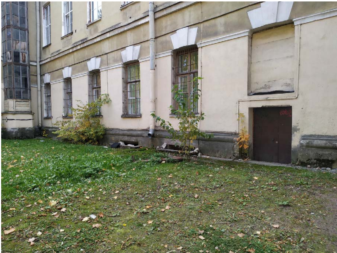
38. Окна первого этажа южного флигеля.
