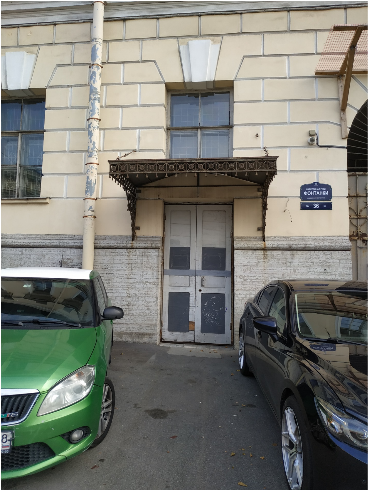
17. Кованый козырек северного ризалита.
