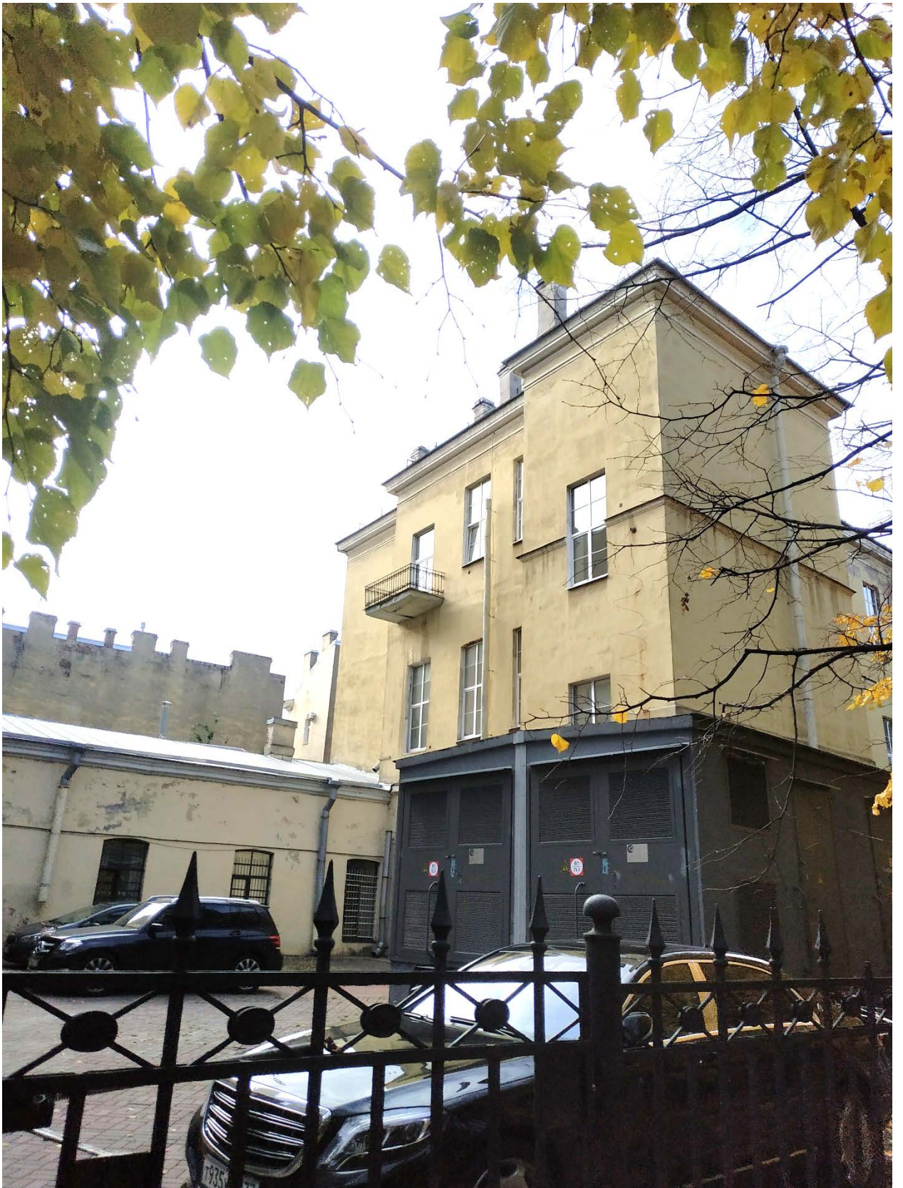
41. Торцевой (восточный) фасад южного ризалита.
