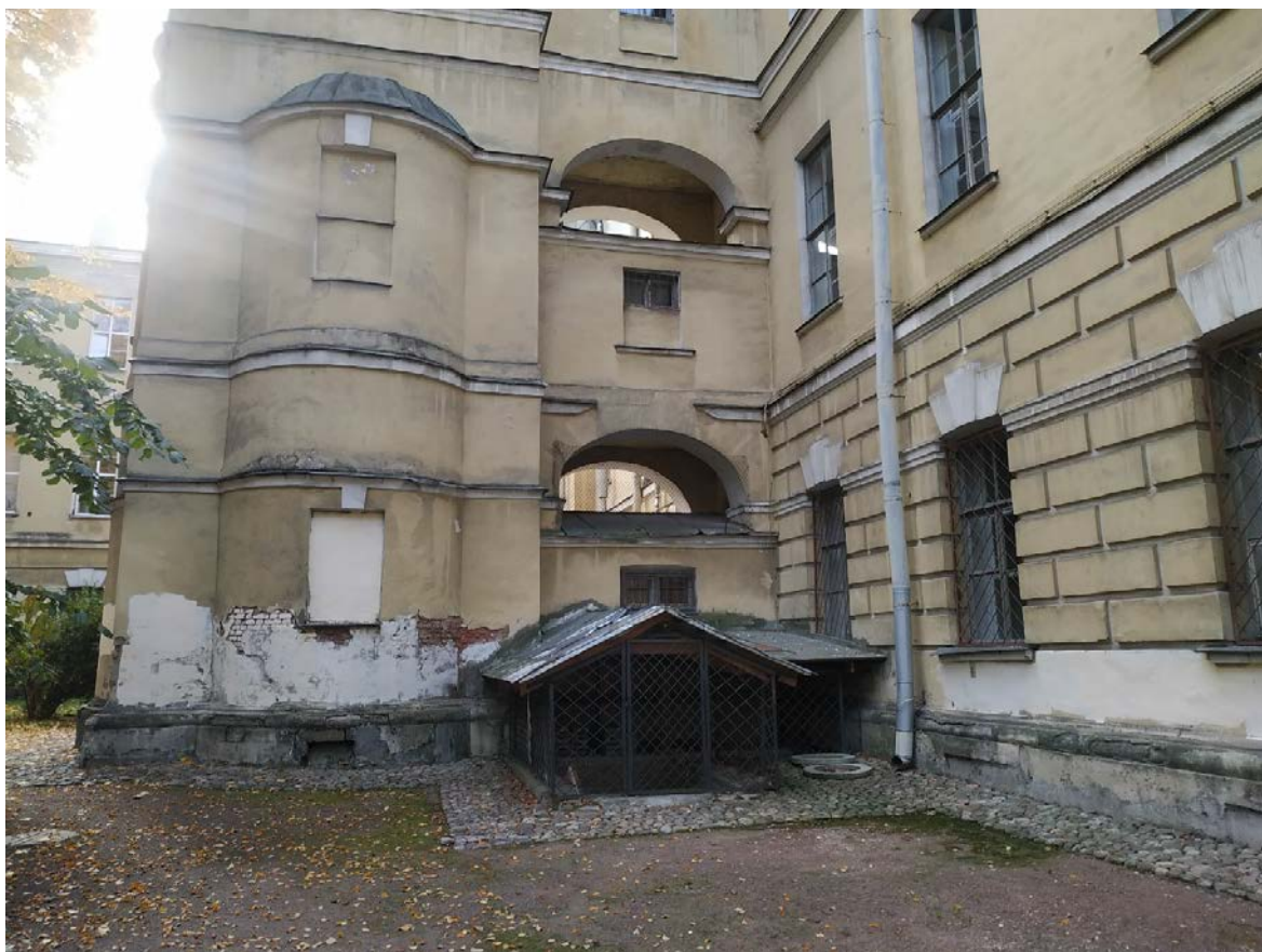
30. Северный фасад южной пристройки, выполнявшей функцию ретирадника.
