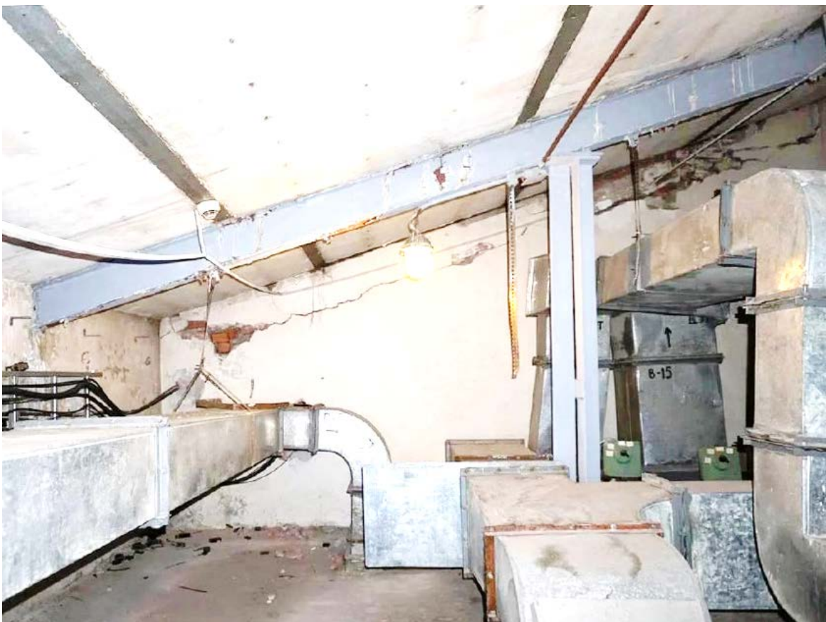
47. Металлические стропила (поздняя конструкция) над основным объёмом здания.
