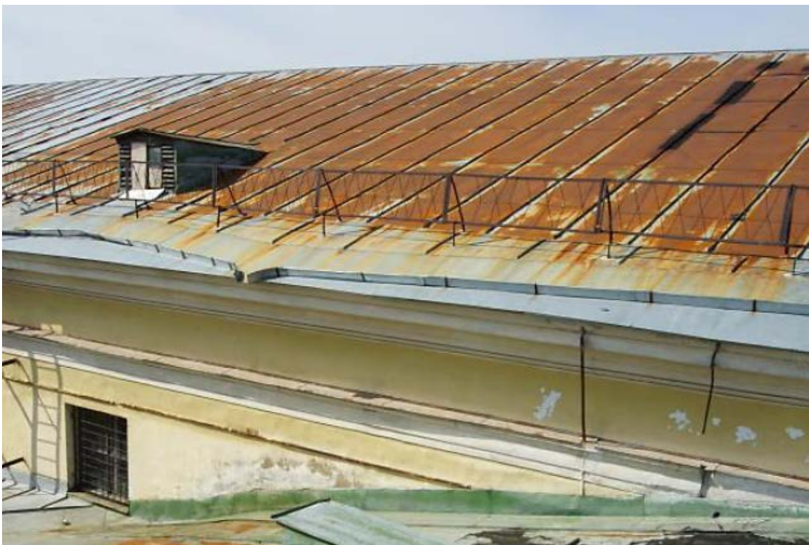
45. Крыша над основным объёмом здания (дворовый скат, вид с крыши церкви).
