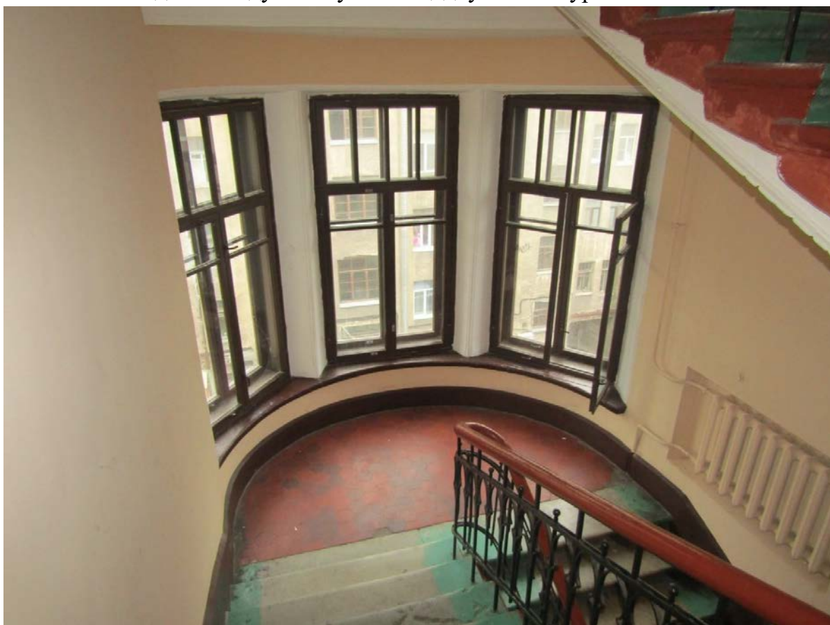
Фото 77. Вид на междуэтажную площадку 12ЛК в уровне 3-го – 4-го этажей.
