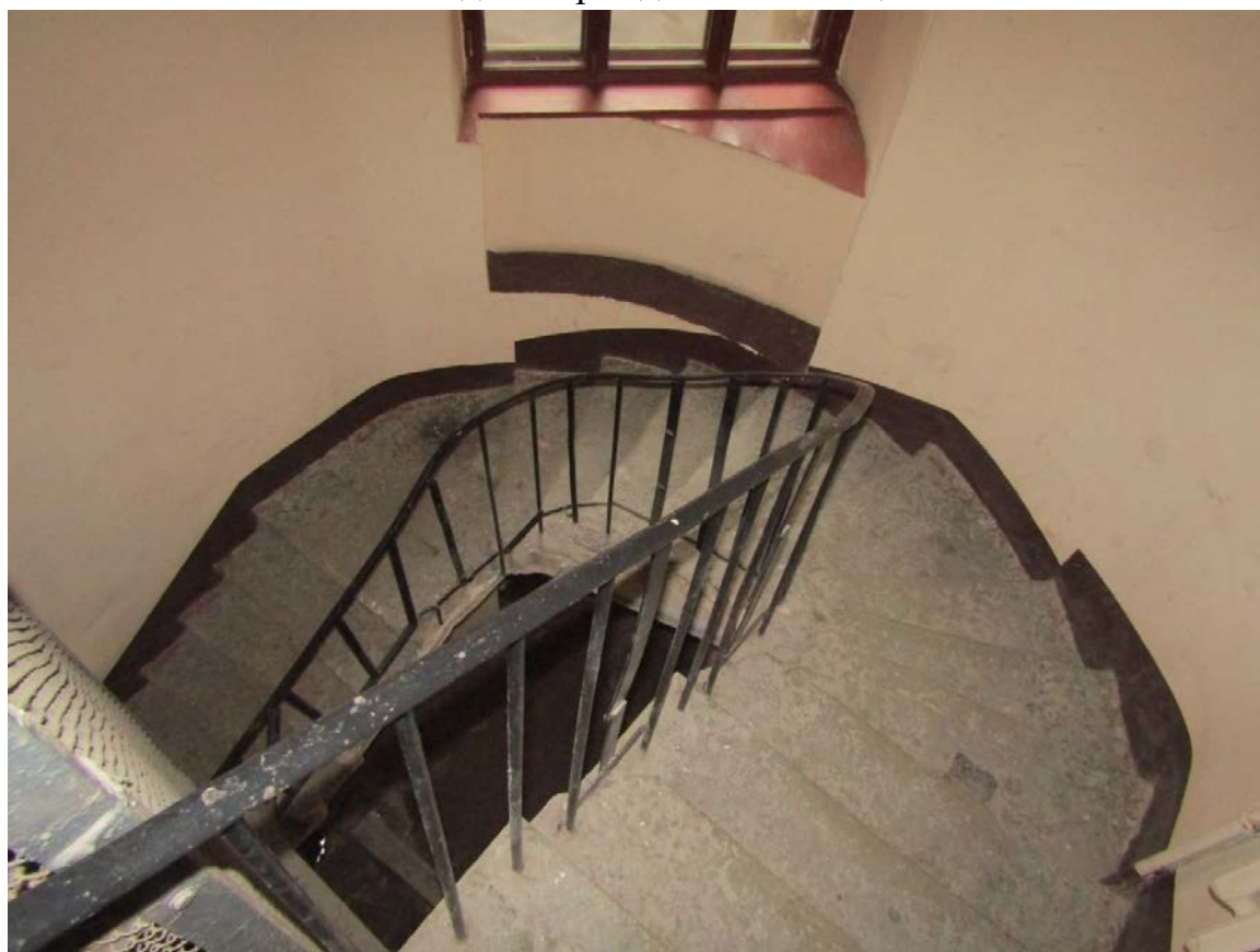
Фото 88. Вид лестницы 16ЛК в уровне 2-го этажа.
