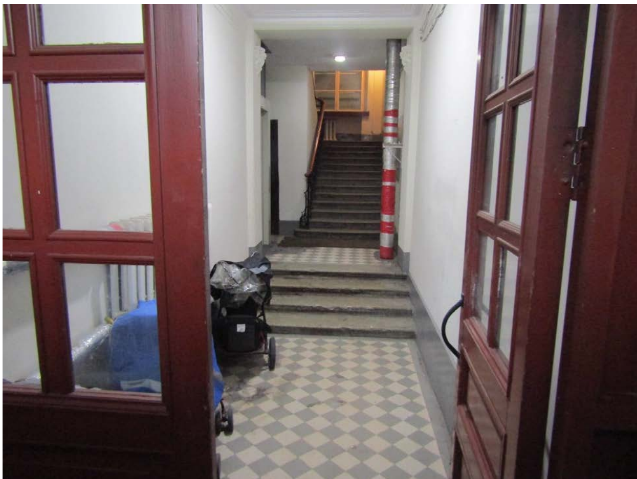
Фото 42. Вид на вестибюль 1ЛК.
