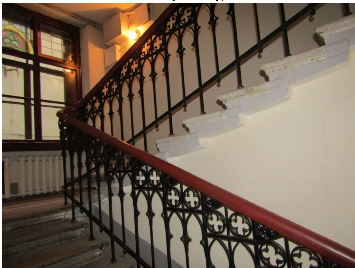
Фото 73. Вид на ограждение лестницы 11ЛК в уровне 1-го – 2-го этажей.
