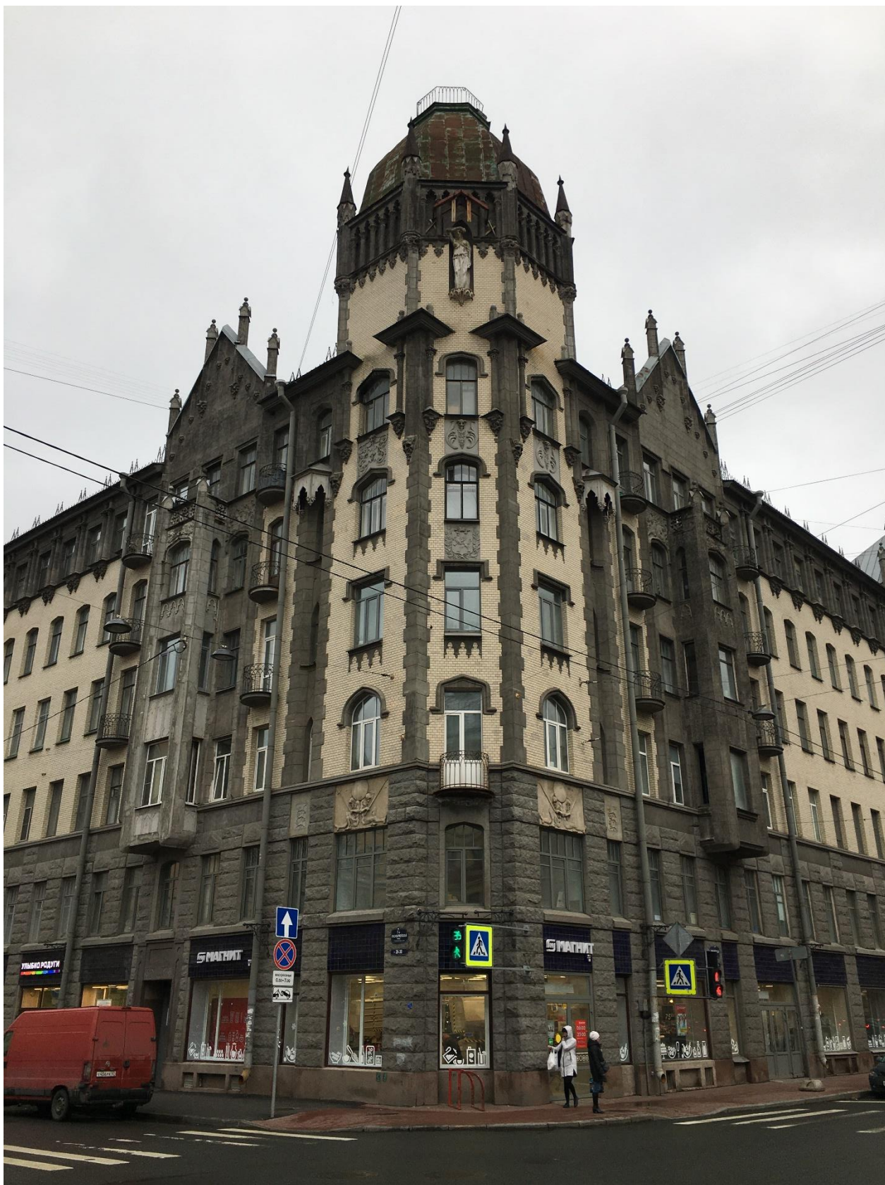
Фото 3. Вид на северо-западный угол здания.
