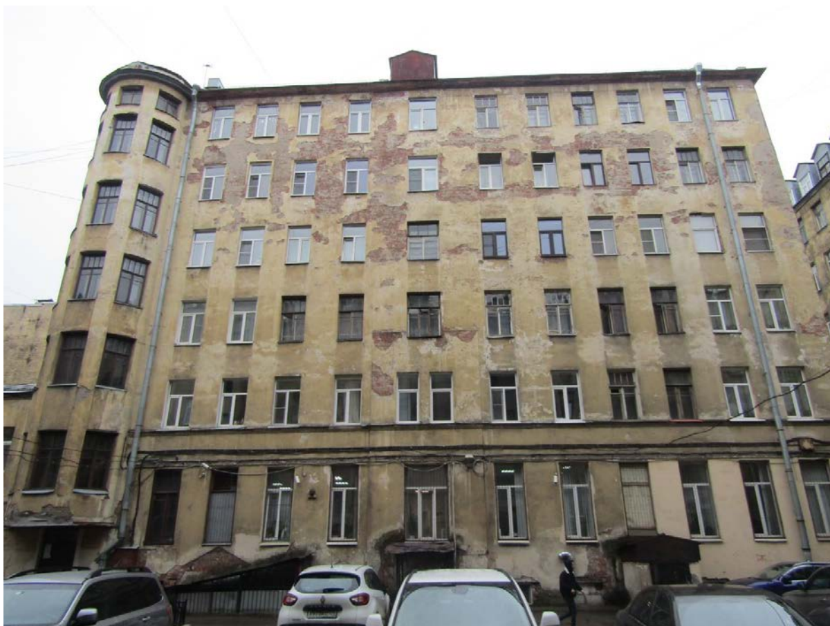
Фото 16. Вид на северный фасад шестиэтажного дворового корпуса с гаражом.
