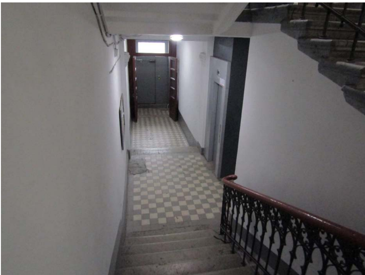
Фото 56. Вид на вестибюль 5ЛК.
