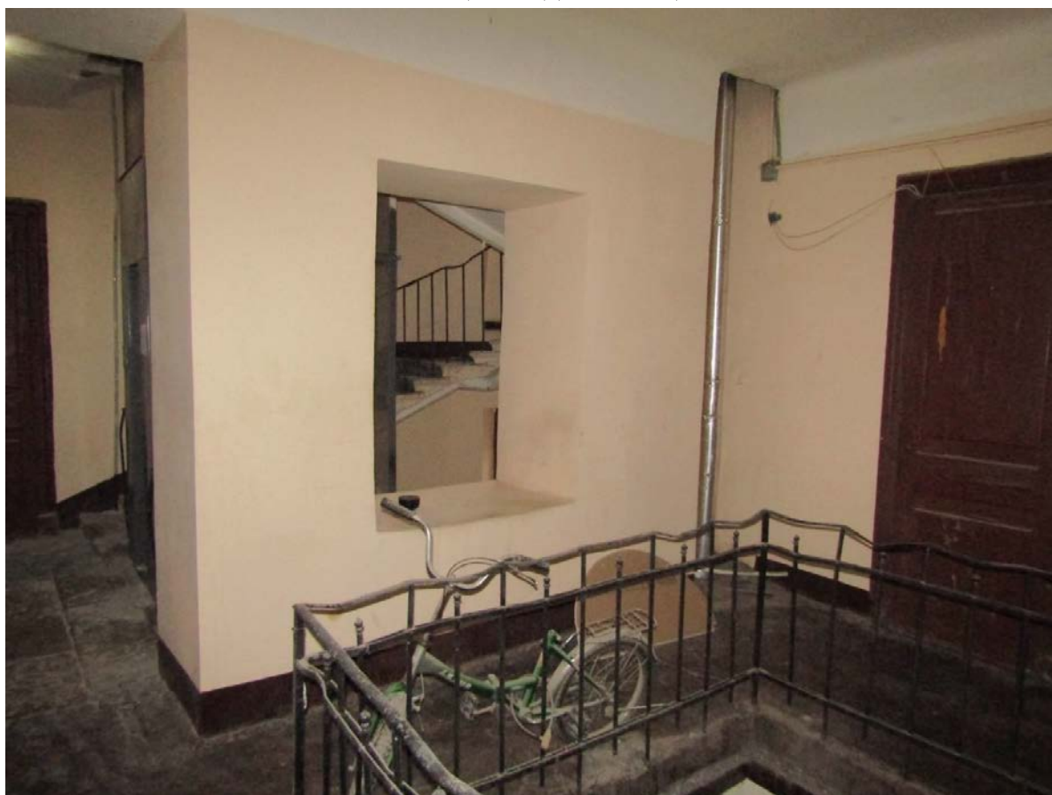
Фото 90. Вид на лестничную площадку 16ЛК в уровне 5-го этажа.
