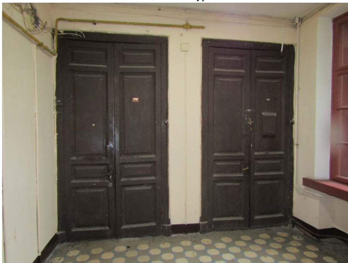
Фото 84. Вид на лестничную площадку 15ЛК в уровне 2-го этажа.
