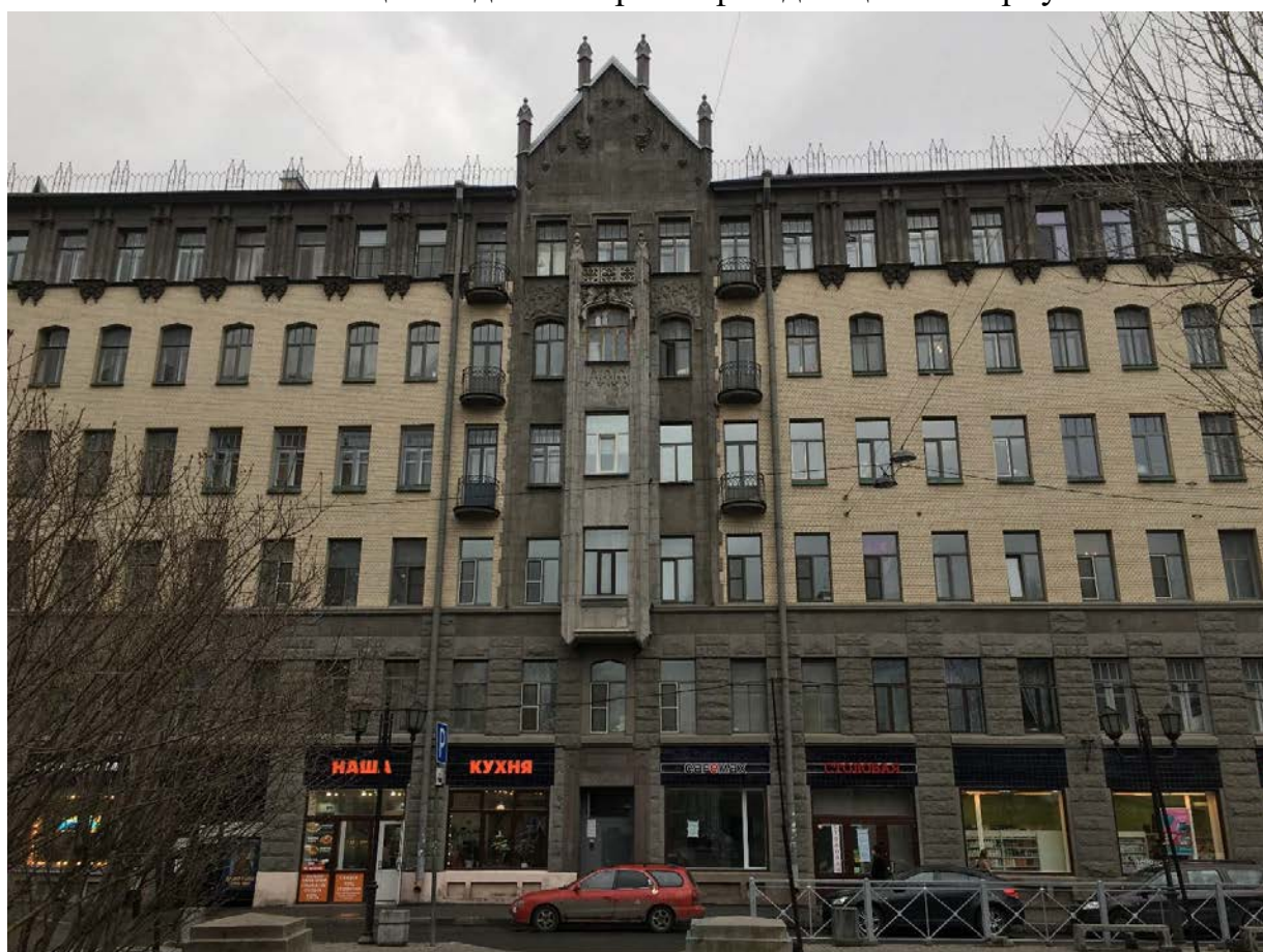
Фото 7. Вид на центральную часть северного фасада лицевого корпуса.
