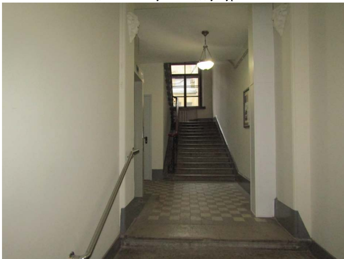
Фото 67. Вид на вестибюль 9ЛК.
