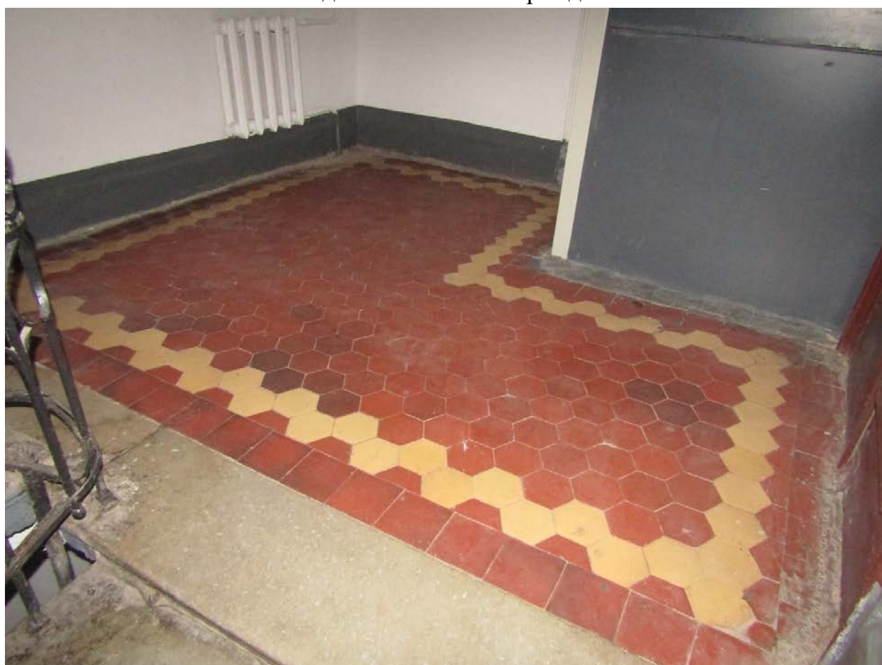
Фото 33. Вид на пол лестничной клетки 17ЛК в уровне 2-го этажа.
