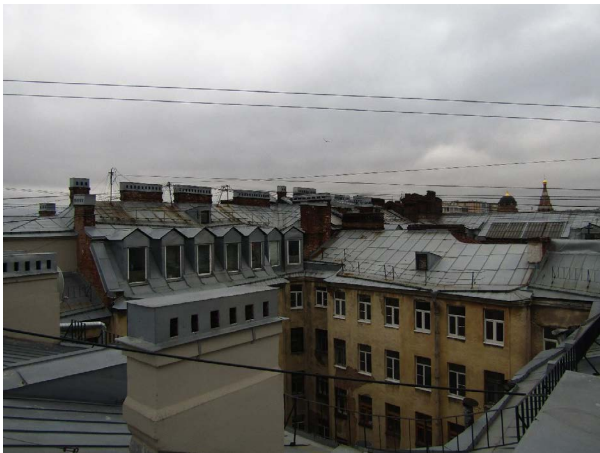
Фото 28. Вид на крышу дворовых корпусов.
