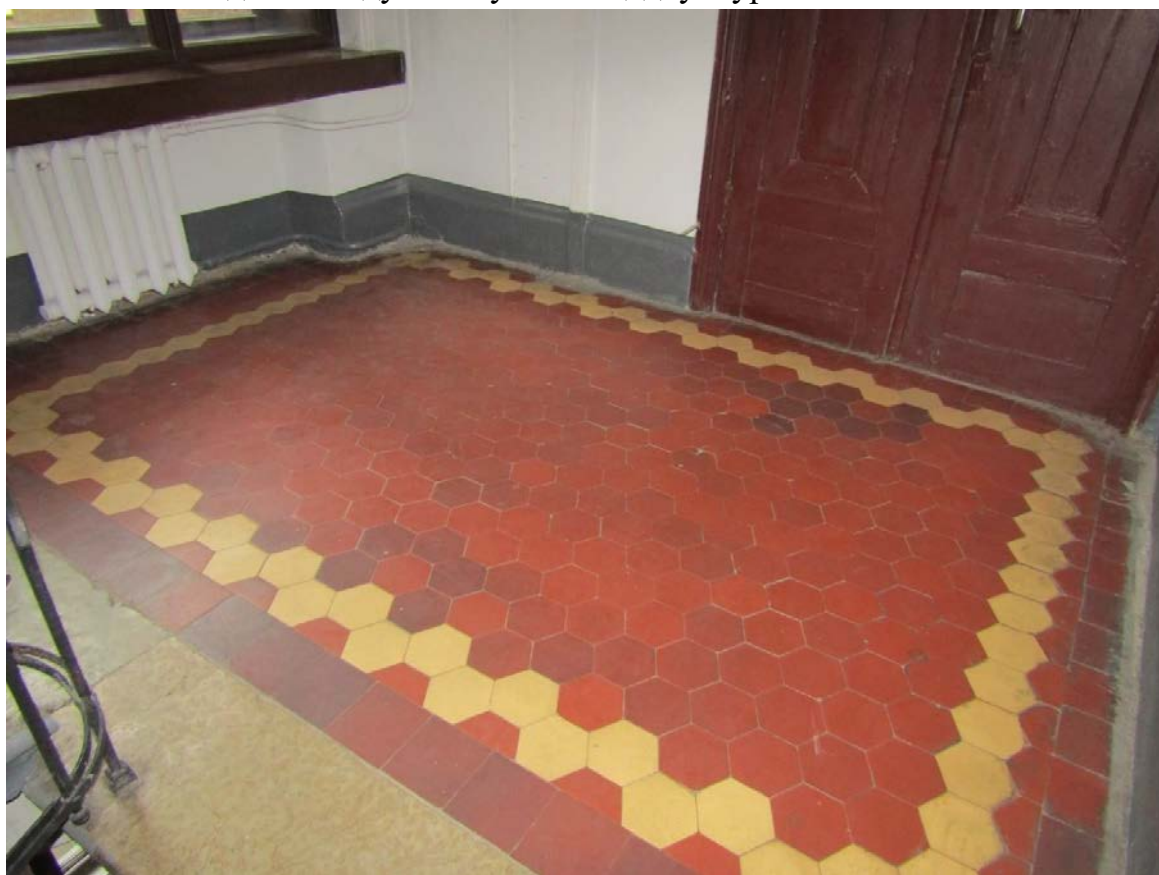
Фото 39. Вид на пол междуэтажной площадки в уровне 3-го – 4-го этажей.
