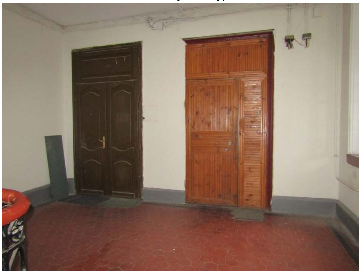
Фото 45. Вид на лестничную площадку 1ЛК в уровне 1-го – 2-го этажей.
