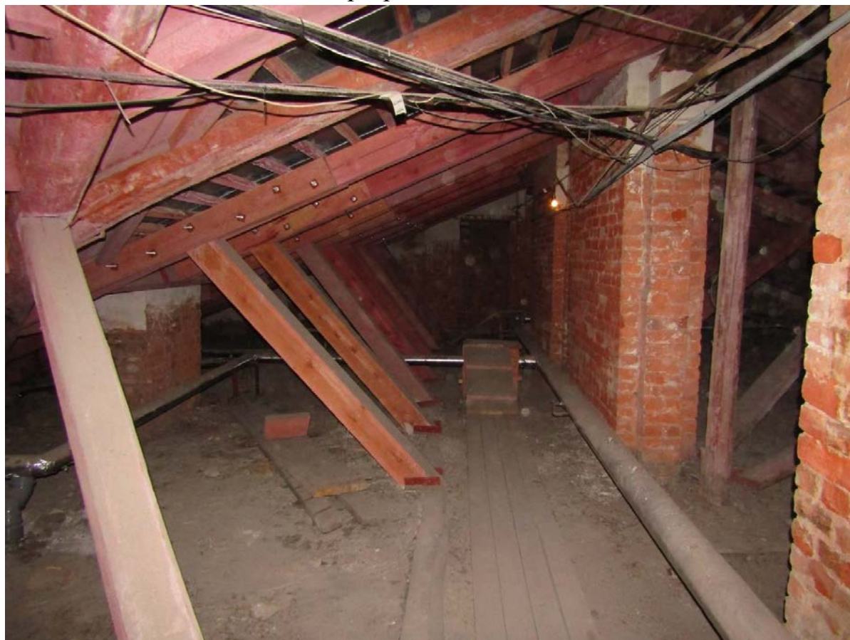
Фото 100. Интерьер чердачных помещений.
