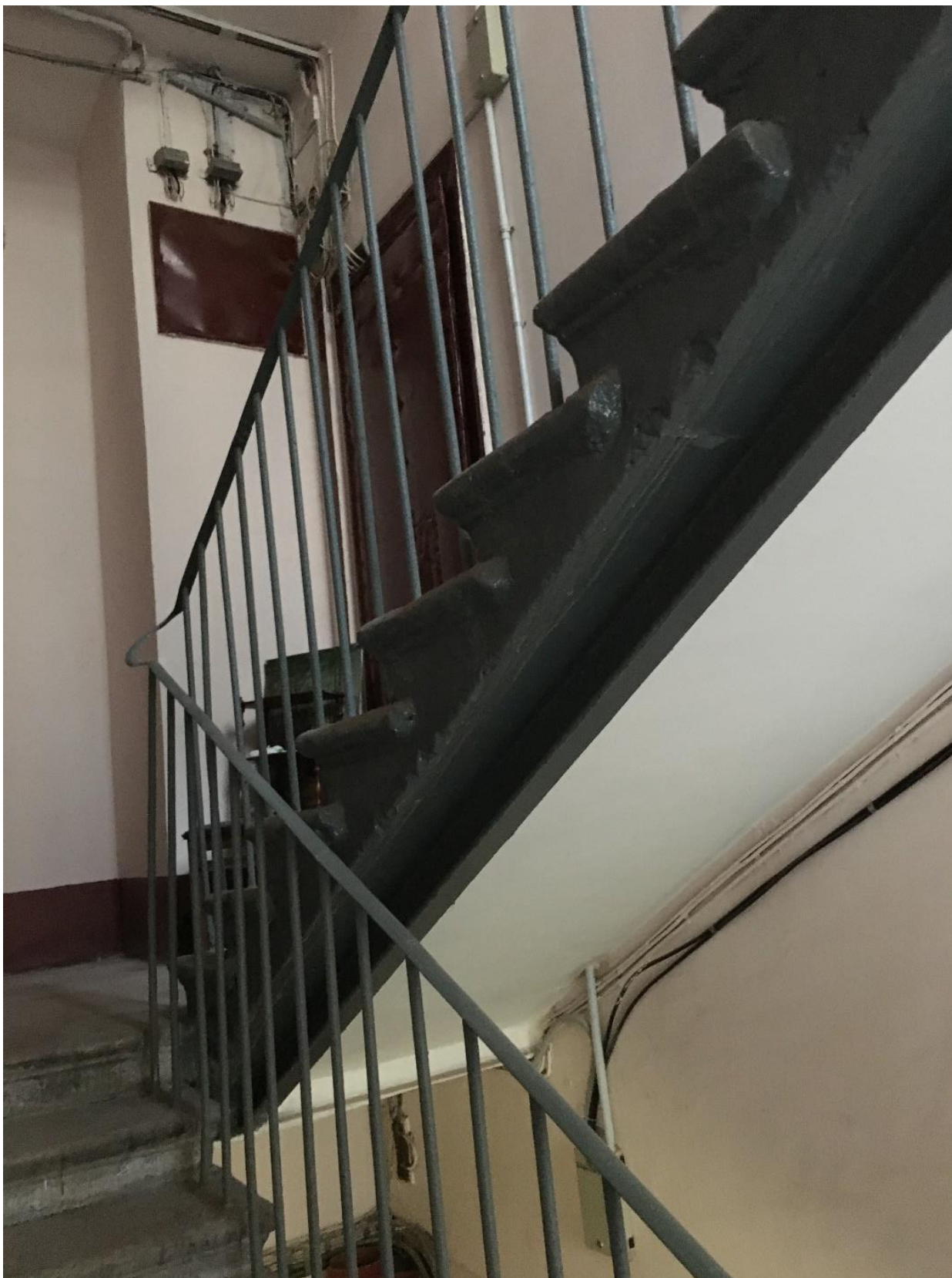
Фото 95. Общий вид лестницы 6ЛК.
