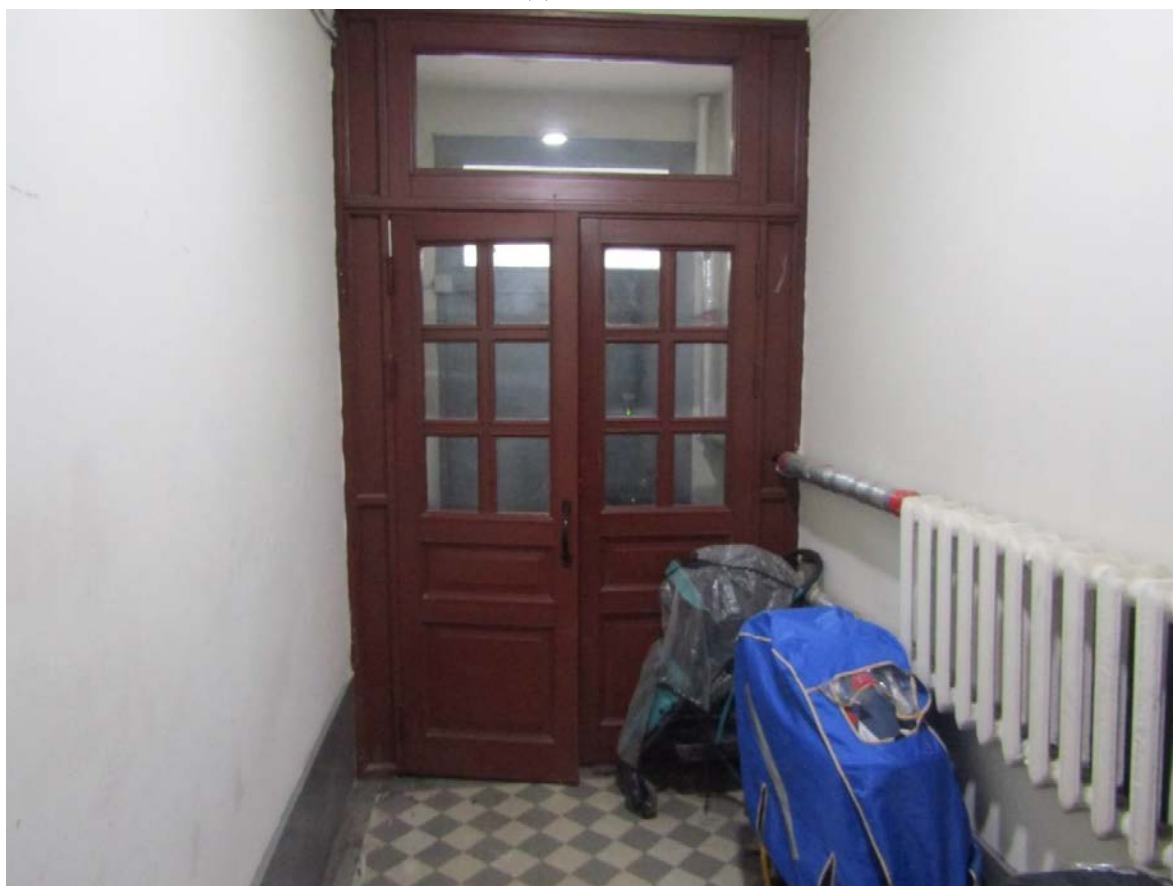
Фото 43. Вид на двери тамбура вестибюля 1ЛК.
