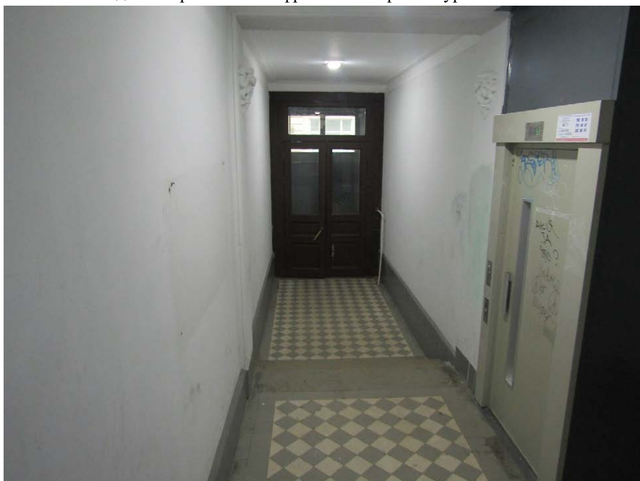
Фото 63. Вид на вестибюль 7ЛК.
