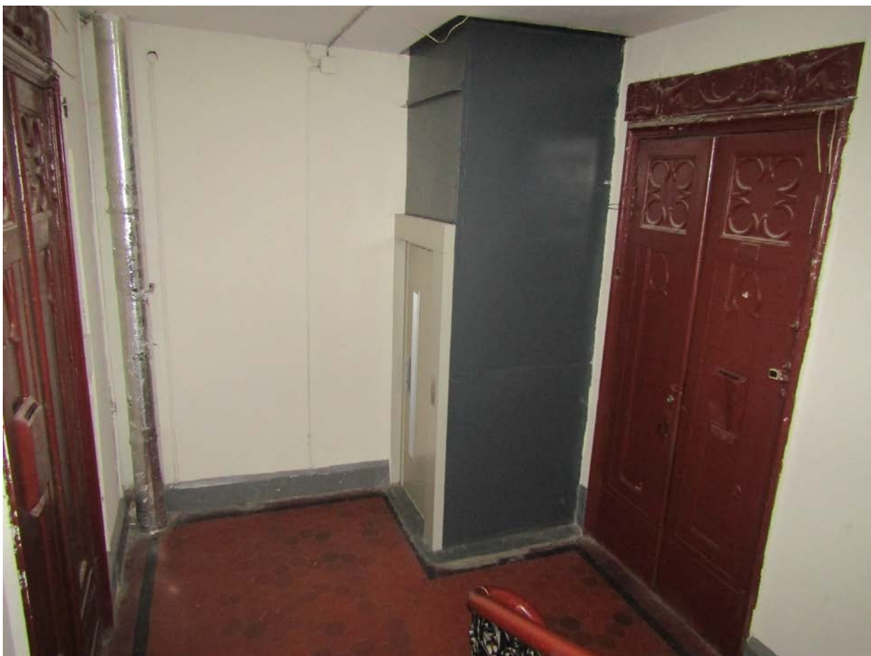
Фото 48. Вид на лестничную площадку 1ЛК в уровне 3-го этажа.
