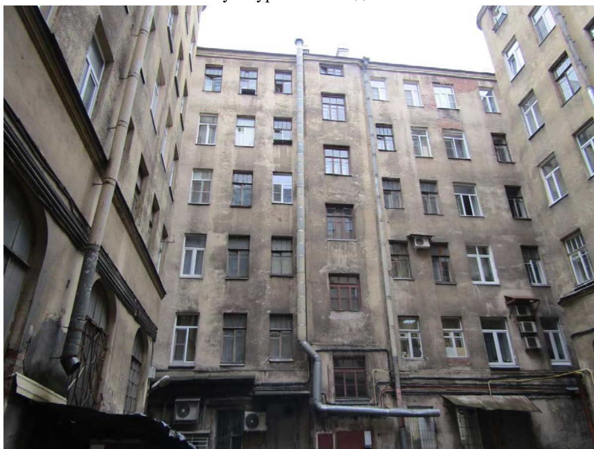
Фото 21. Вид на восточный фасад западного лицевого корпуса.
