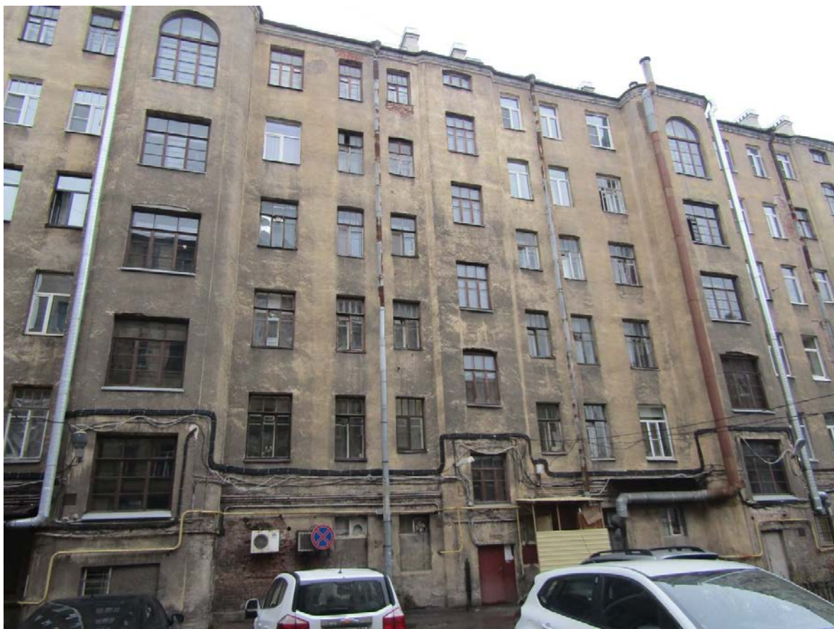
Фото 12. Вид на южный фасад северного лицевого корпуса.
