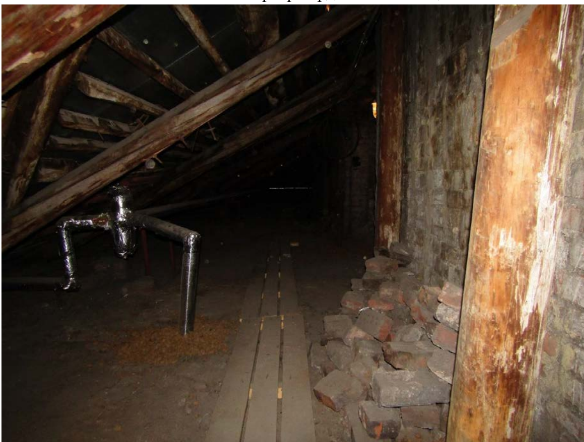
Фото 102. Интерьер чердачных помещений.
