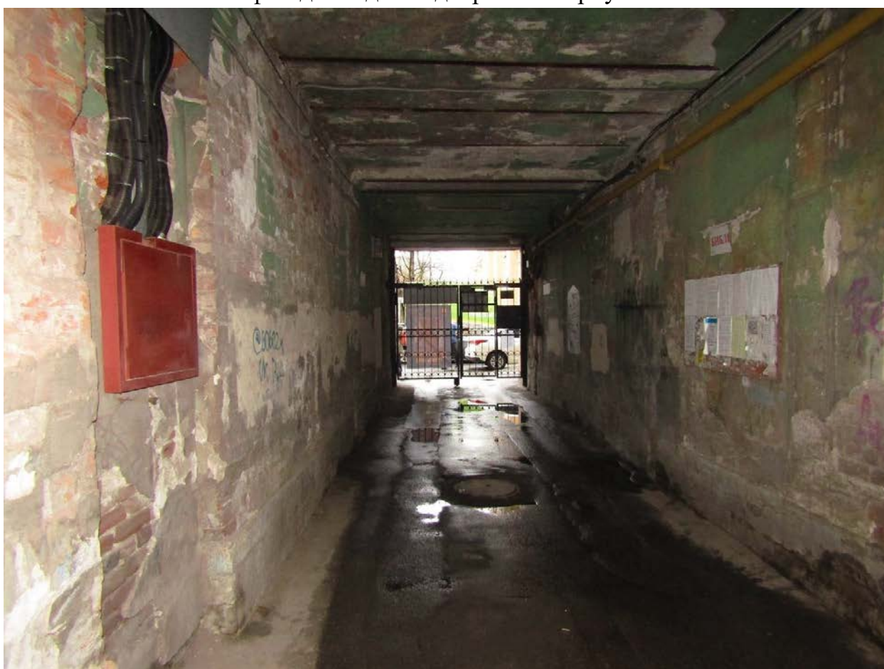
Фото 25. Вид на арку воротного проезда в северном лицевом корпусе.
