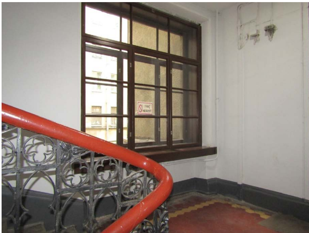
Фото 36. Вид на оконный проем междуэтажной площадки 17ЛК в уровне 2-го этажа.
