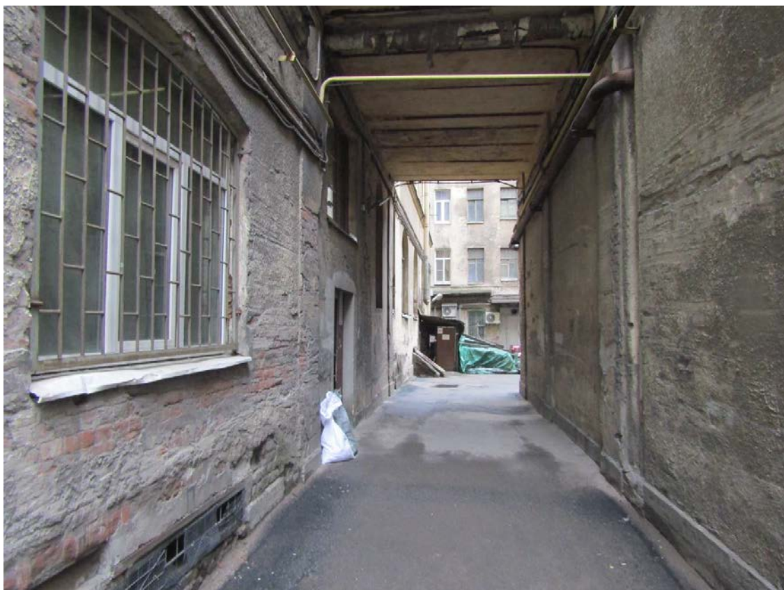
Фото 20. Вид на арку воротного проезда в юго-западной части объекта культурного наследия.
