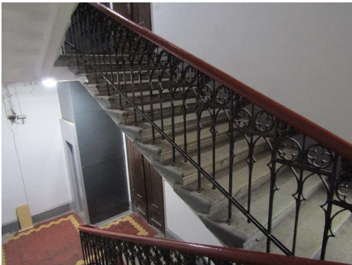
Фото 54. Вид на лестницу ЗЛК в уровне 4-го-5-го этажей.
