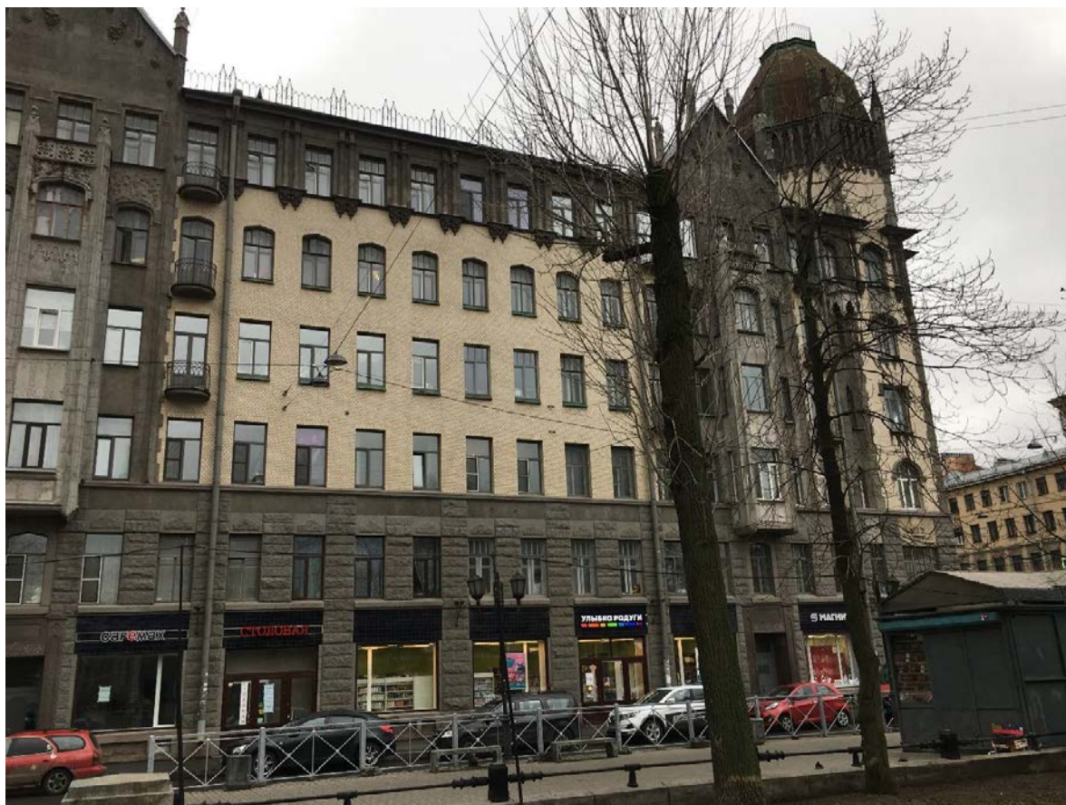
Фото 10. Вид на западную часть северного фасада лицевого корпуса.
