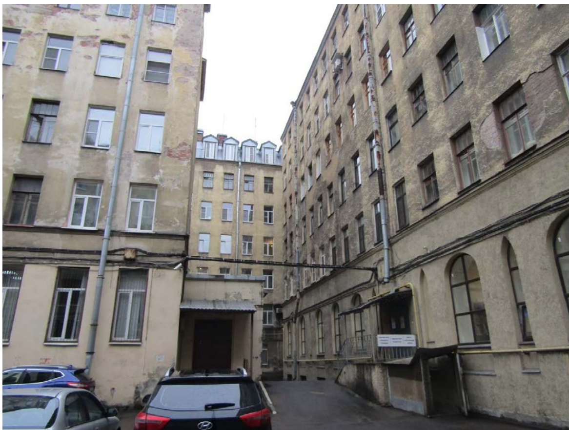
Фото 18. Вид на северный фасад южного шестиэтажного дворового корпуса с мансардой.
