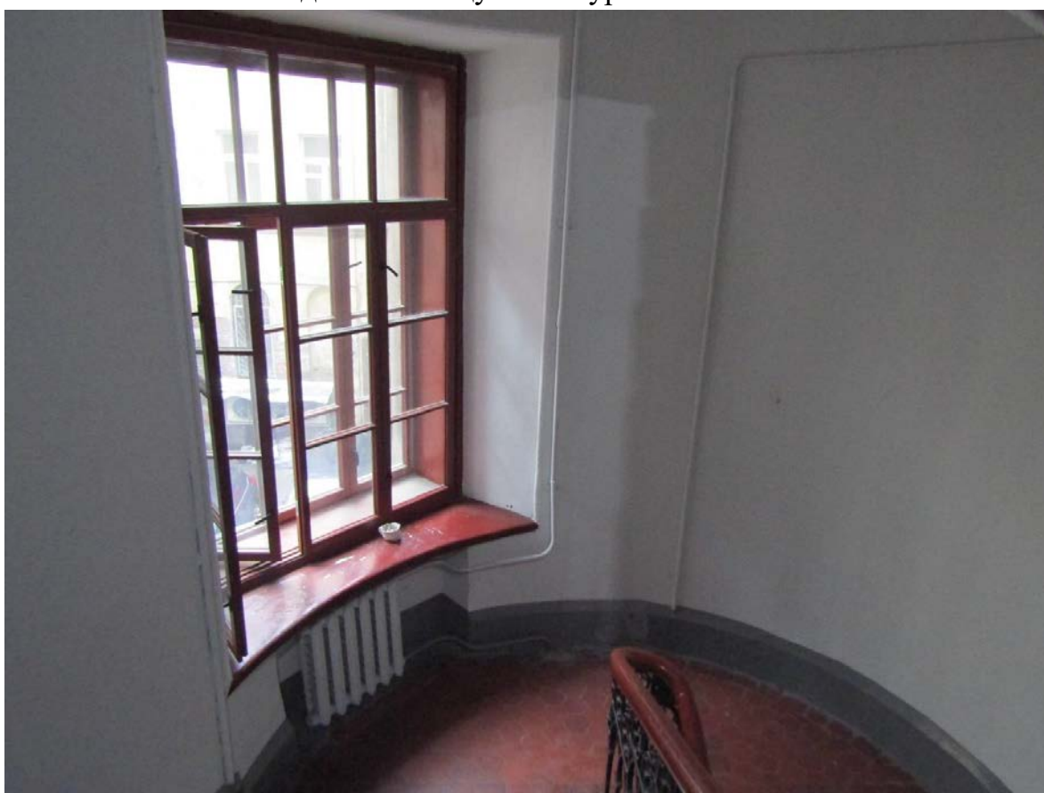
Фото 55. Вид на междуэтажную площадку ЗЛК в уровне 5-го – 6-го этажей.
