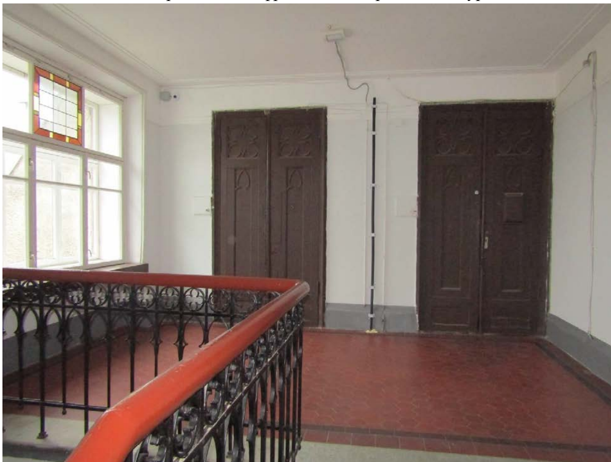
Фото 61. Вид на лестничную клетку 5ЛК в уровне 6-го этажа.
