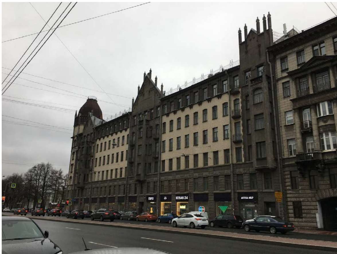
Фото 1. Общий вид на западный фасад лицевого корпуса.
