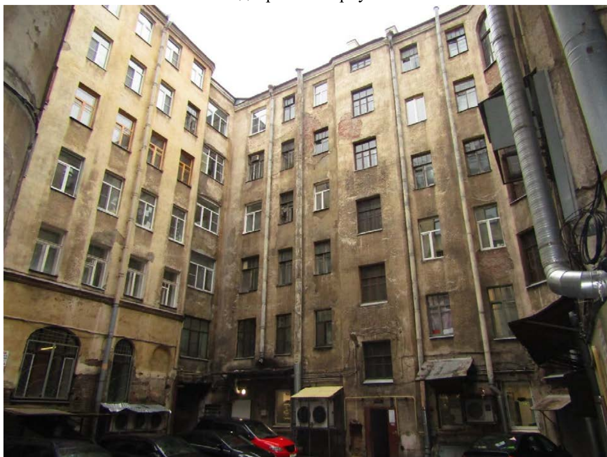
Фото 23. Вид на восточный фасад западного лицевого корпуса.
