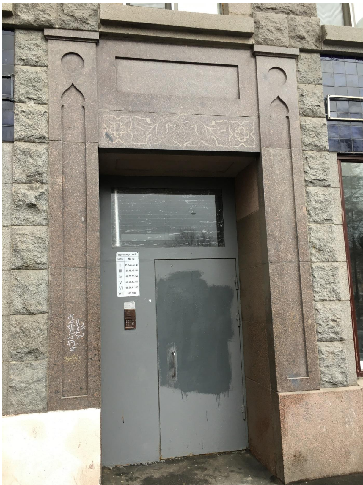
Фото 9. Вход в ЛК5.
