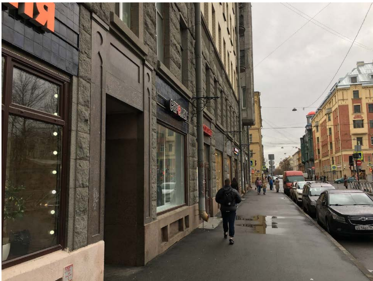
Фото 8. Вид на северный фасад в уровне 1-го этажа с востока.
