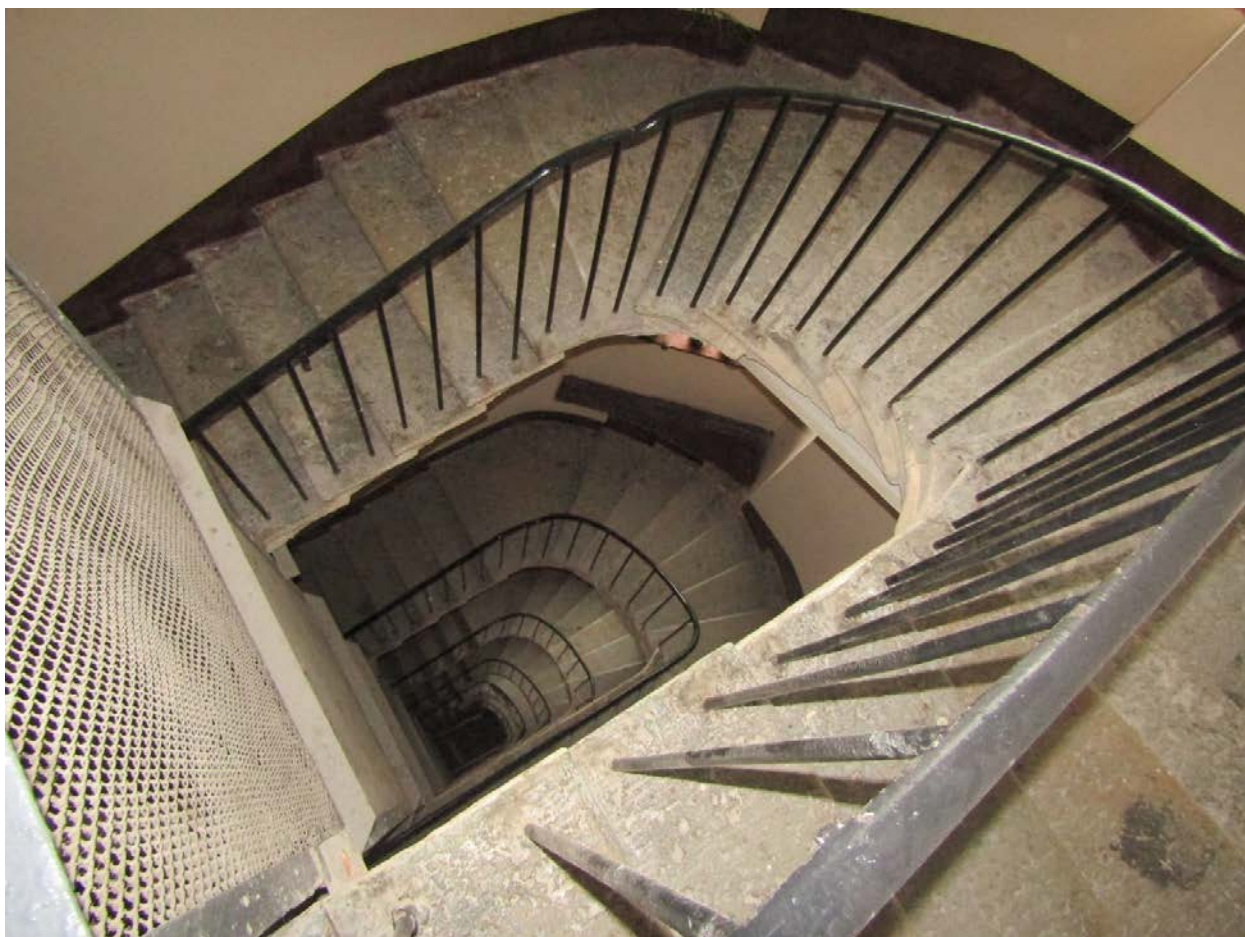
Фото 89. Общий вид лестницы 16ЛК.
