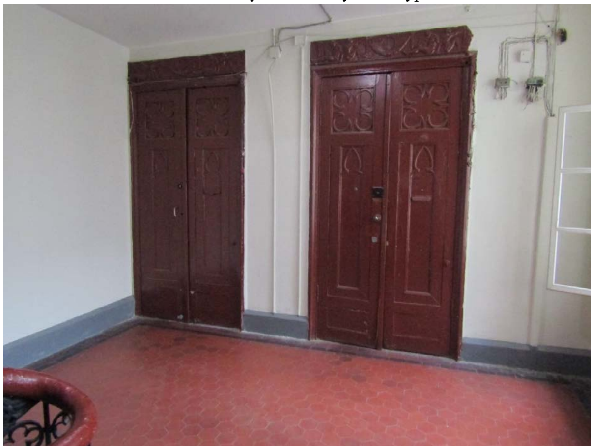
Фото 49. Вид на лестничную площадку 1ЛК в уровне 4-го – 5-го этажей.
