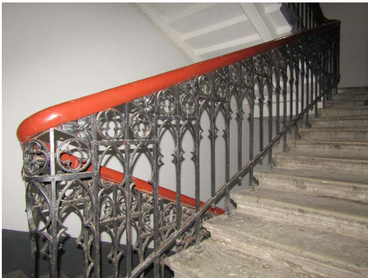
Фото 32. Вид на лестничное ограждение 17ЛК.
