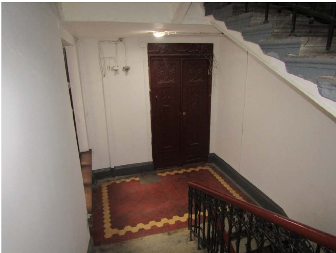
Фото 40. Общий вид лестничной площадки 17ЛК в уровне 5-го – 6-го этажей.
