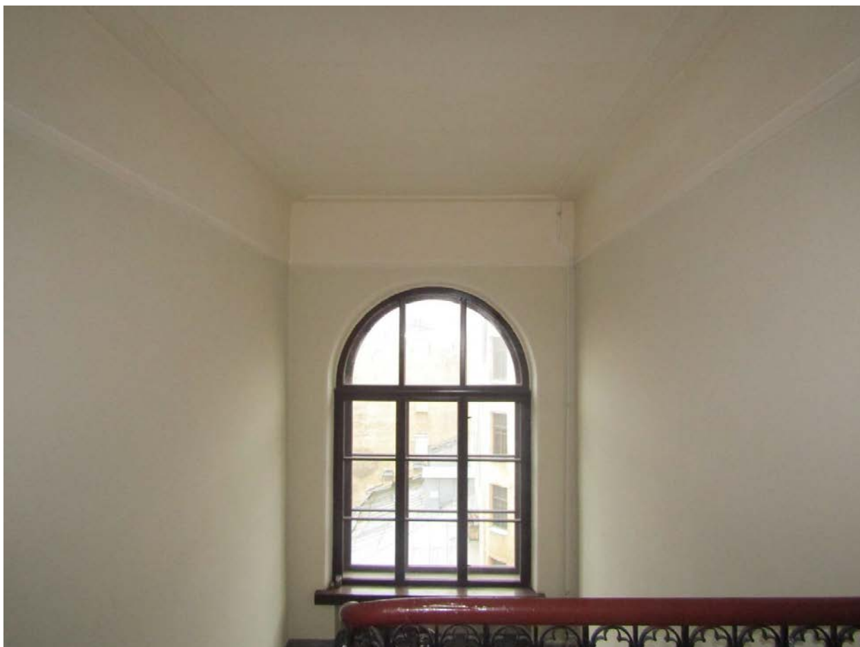
Фото 70. Вид на лестничную клетку 9ЛК в уровне 6-го этажа.
