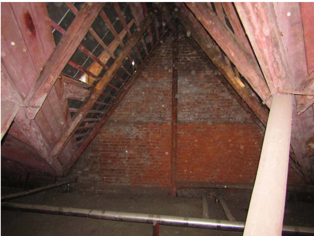
Фото 101. Интерьер чердачных помещений.
