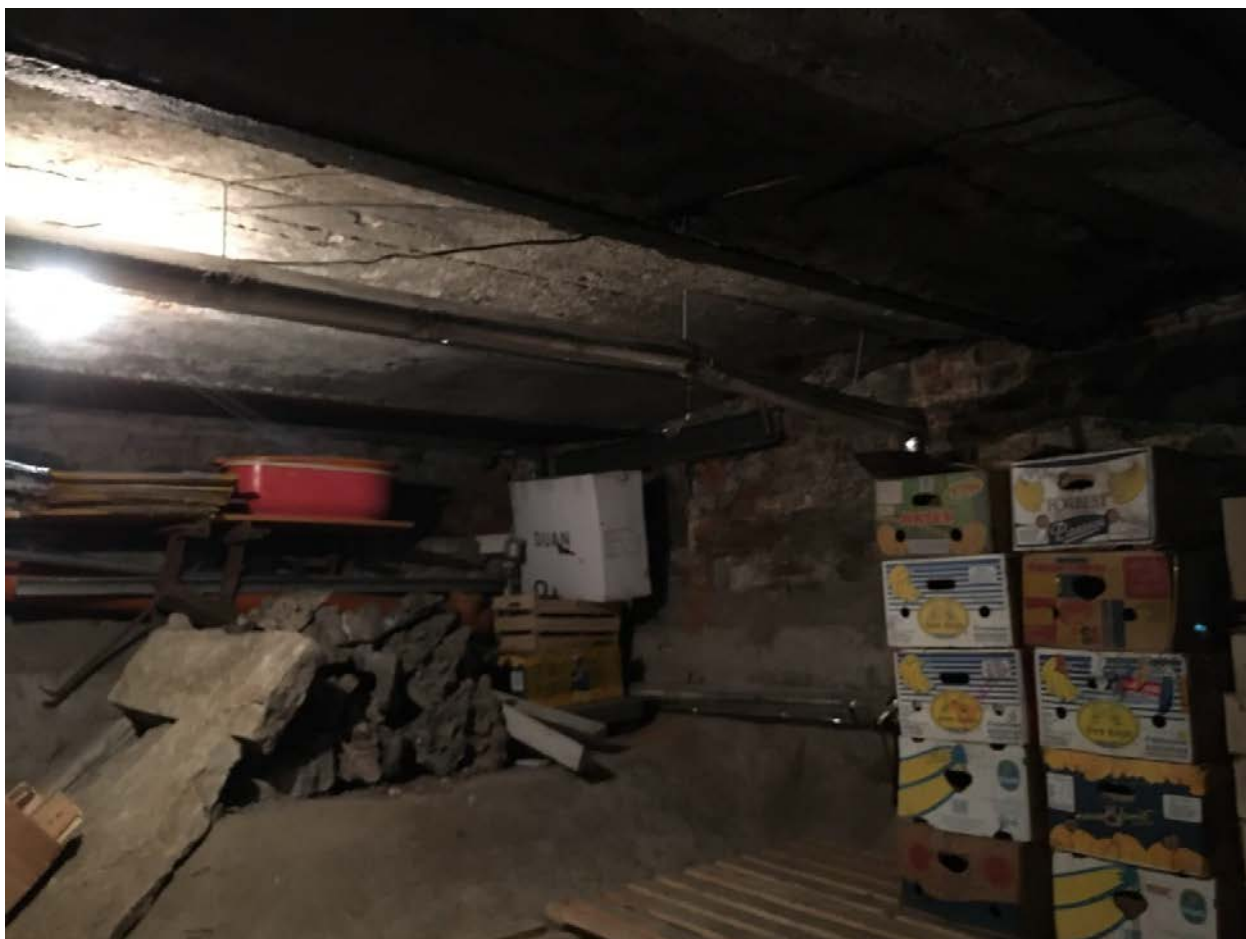
Фото 97. Интерьер подвальных помещений.
