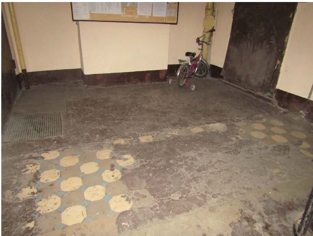
Фото 83. Лестница 15ЛК в уровне 1-го этажа.
