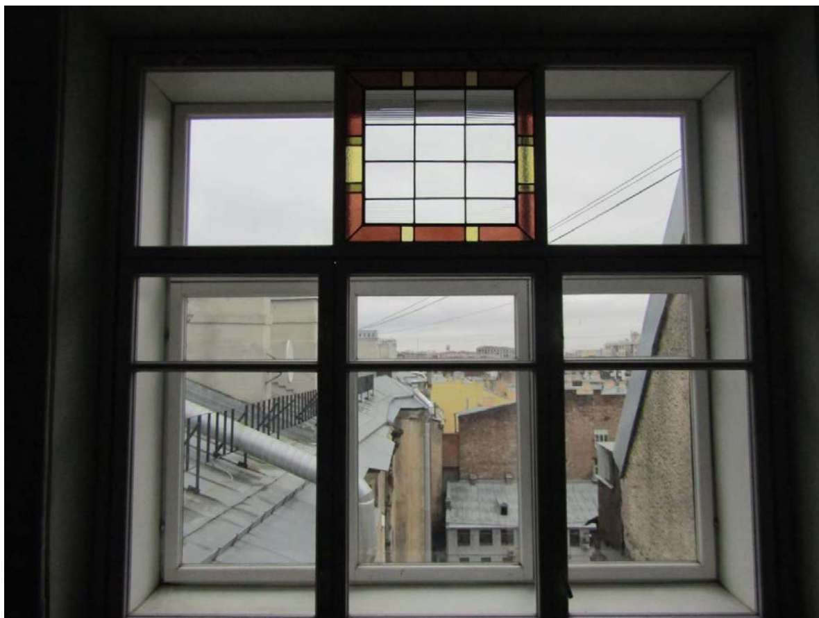
Фото 62. Вид на сохранившийся фрагмент витража в уровне 6-го этажа 5ЛК.
