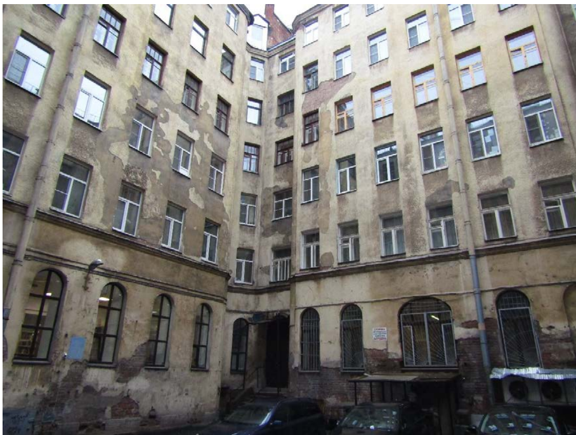
Фото 24. Вид на западный фасад центрального дворового корпуса и северный фасад западного дворового корпуса.
