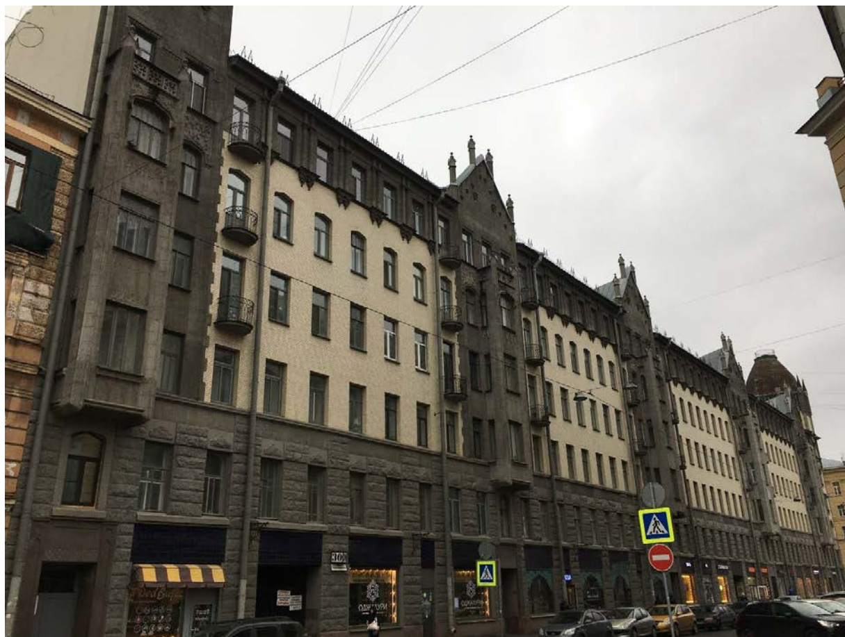
Фото 6. Общий вид на северный фасад лицевого корпуса.
