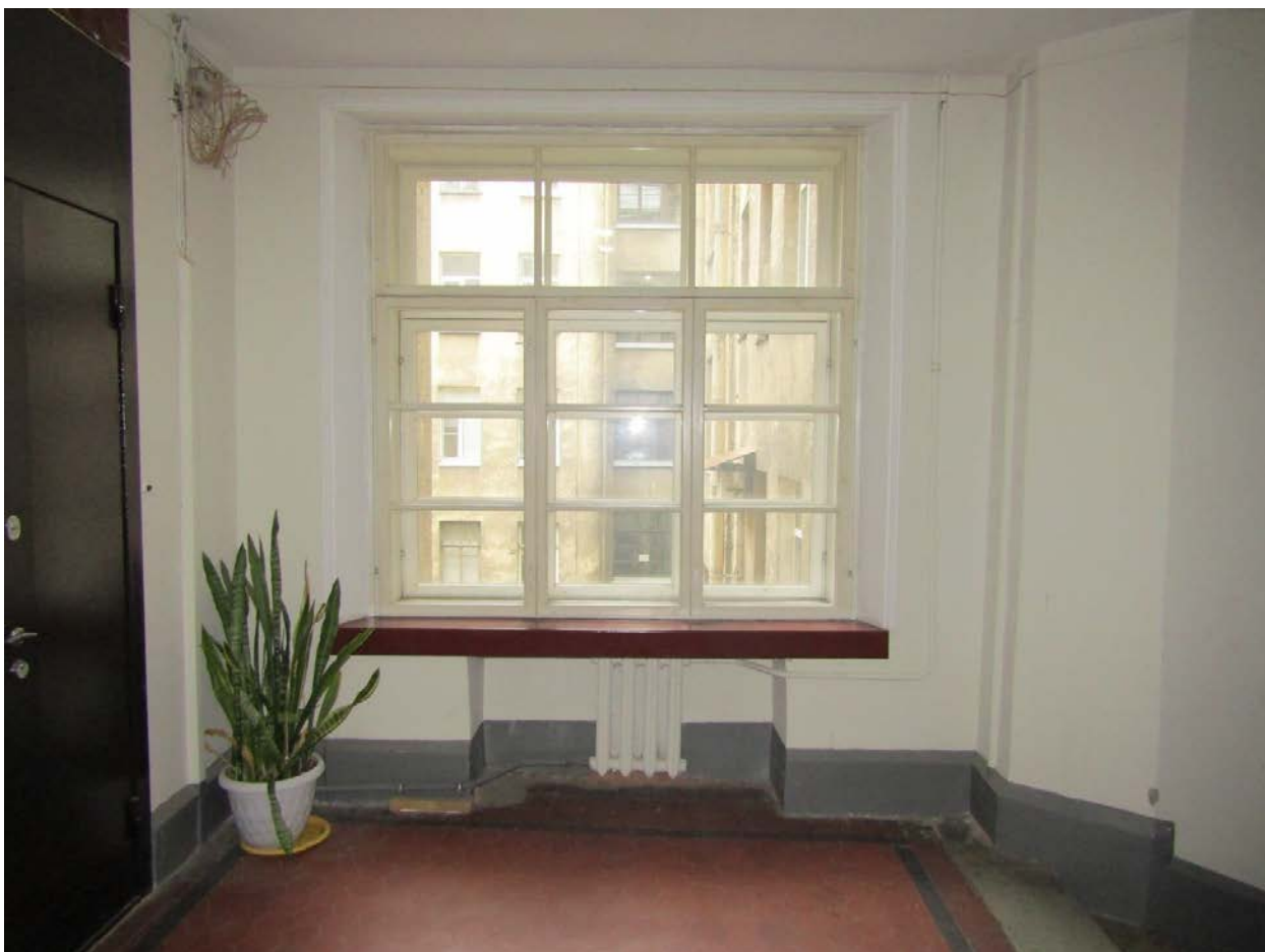
Фото 46. Вид на оконный проем 1ЛК в уровне 2-го – 3-го этажей.
