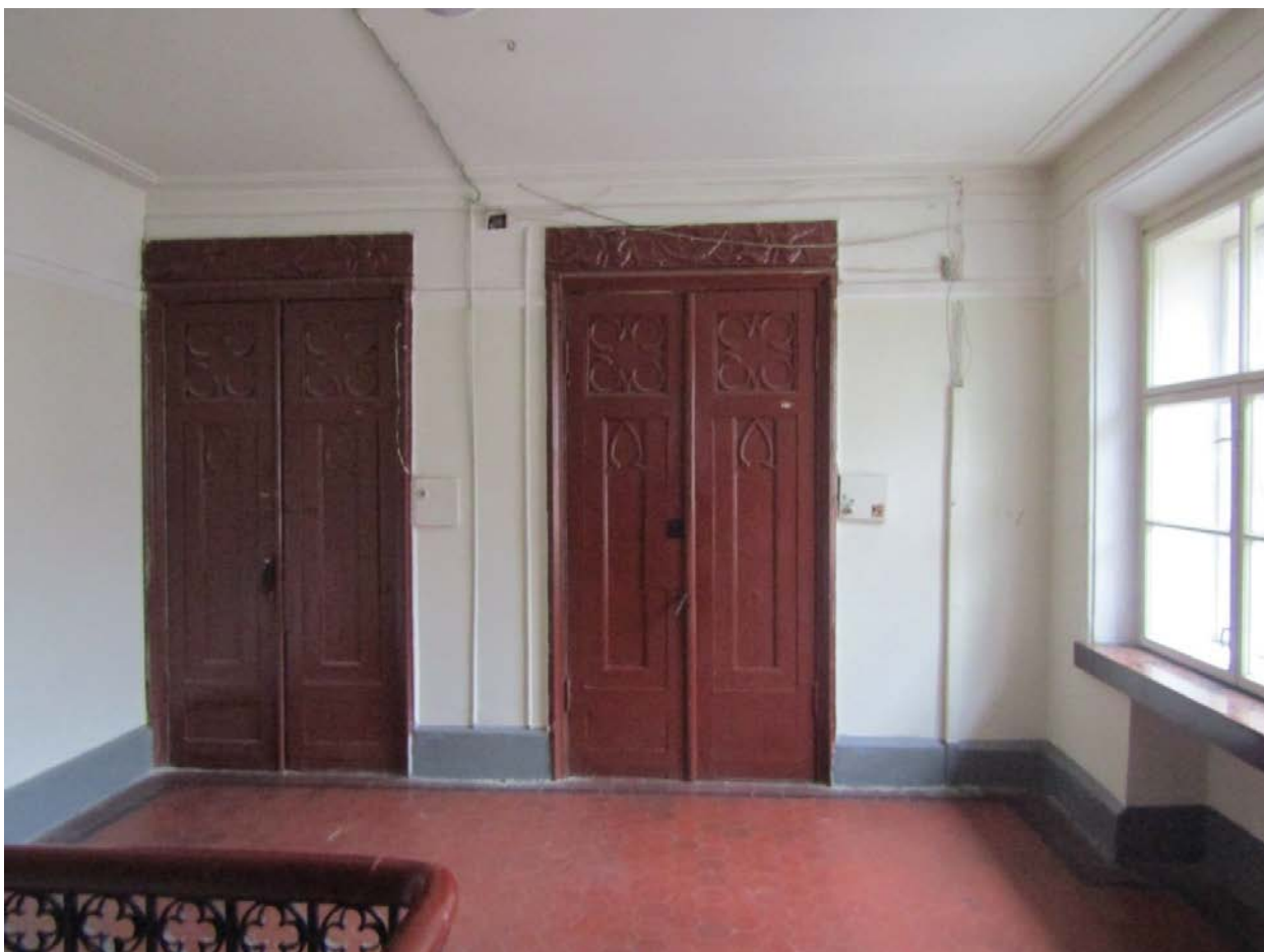
Фото 50. Вид на лестничную площадку 1ЛК в уровне 6-го этажа.
