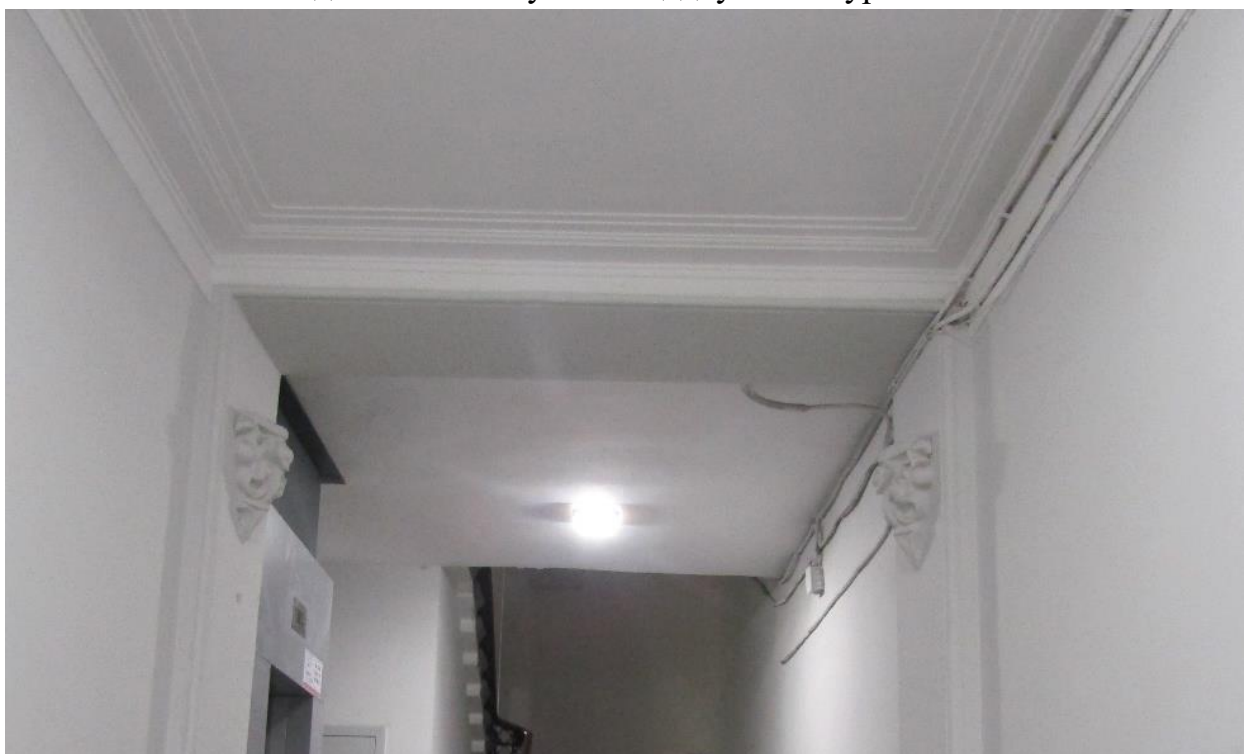
Фото 51. Вид на потолок вестибюля 3ЛК.
