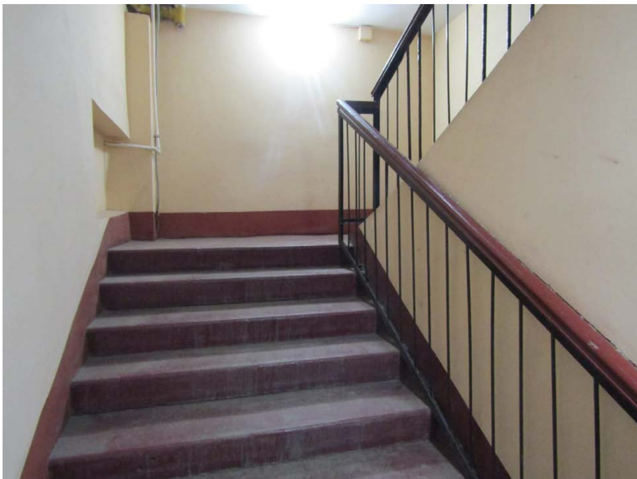
Фото 80. Вид на лестницу 14ЛК в уровне 1-го этажа.
