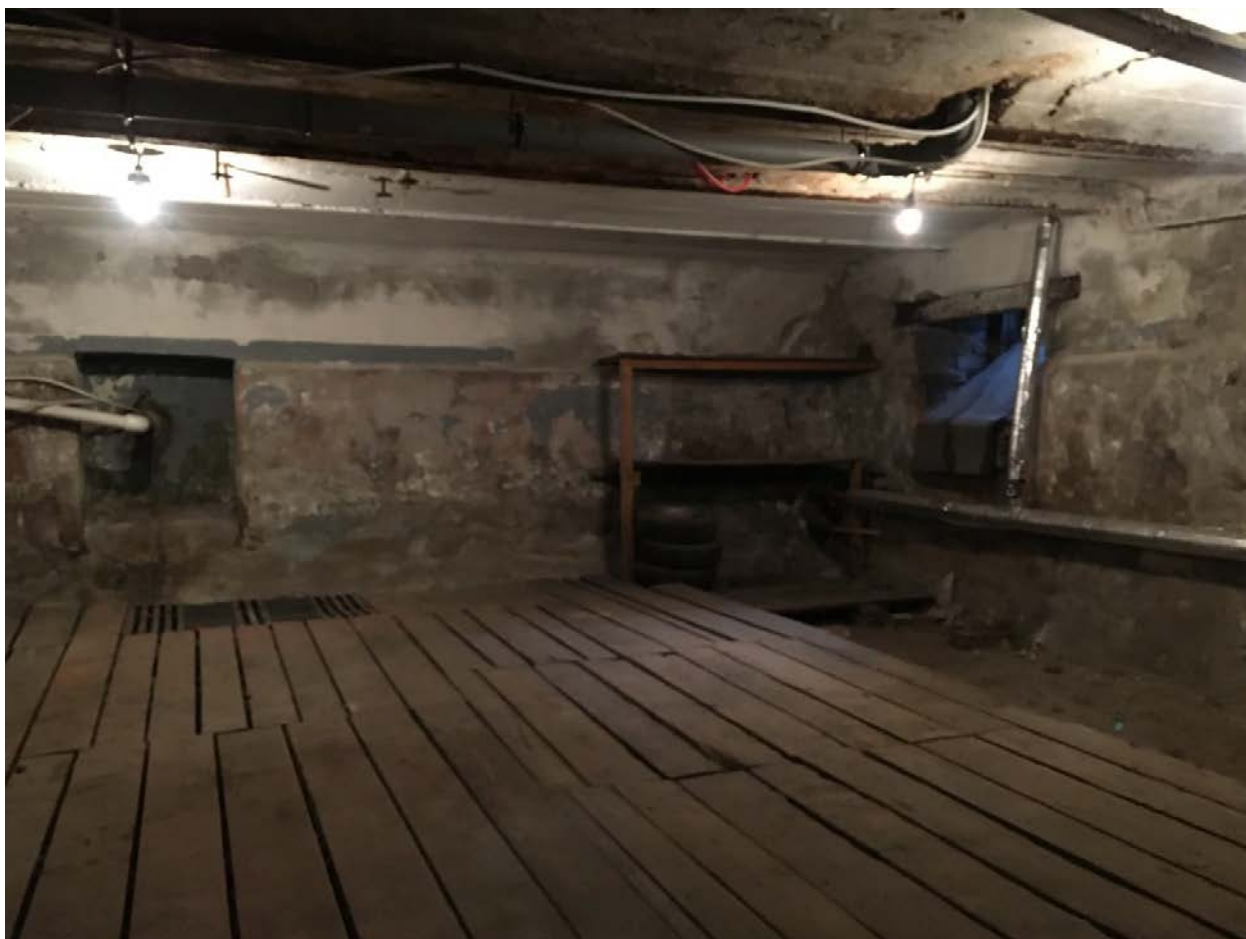
Фото 99. Интерьер подвальных помещений.
