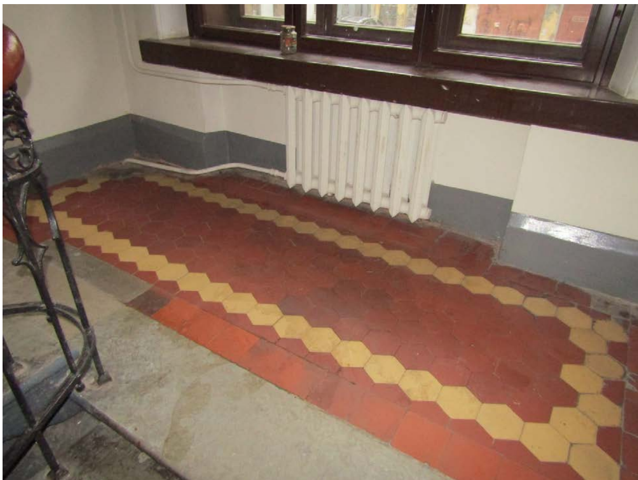
Фото 68. Вид на междуэтажную площадку 9ЛК в уровне 2-го – 3-го этажей.
