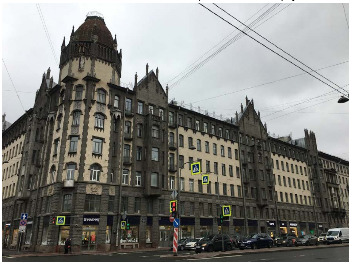
Фото 2. Общий вид на западный фасад лицевого корпуса.
