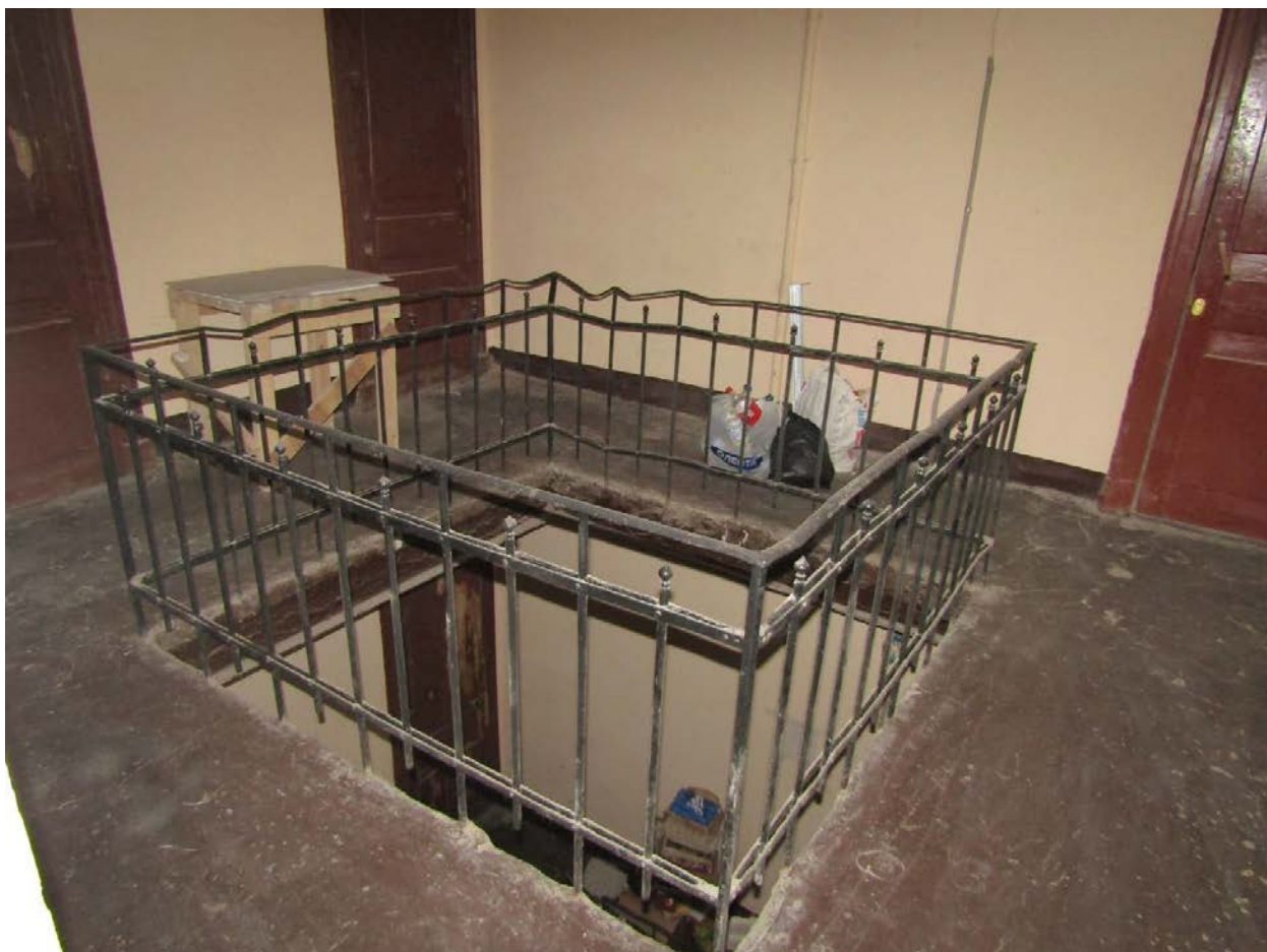
Фото 91. Вид лестничной площадки 16ЛК в уровне 6-го этажа.
