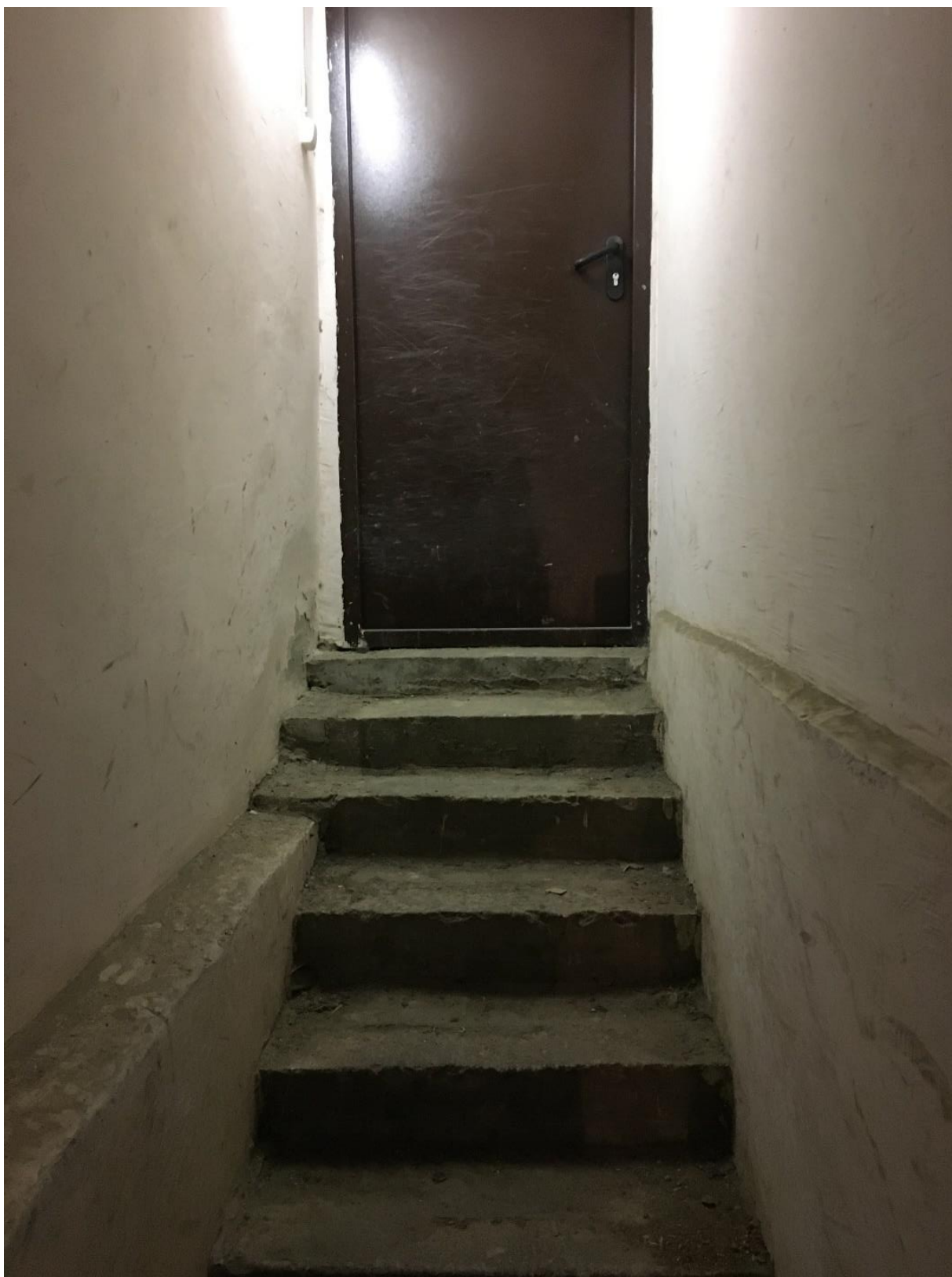
Фото 96. Вход в подвальные помещения.
