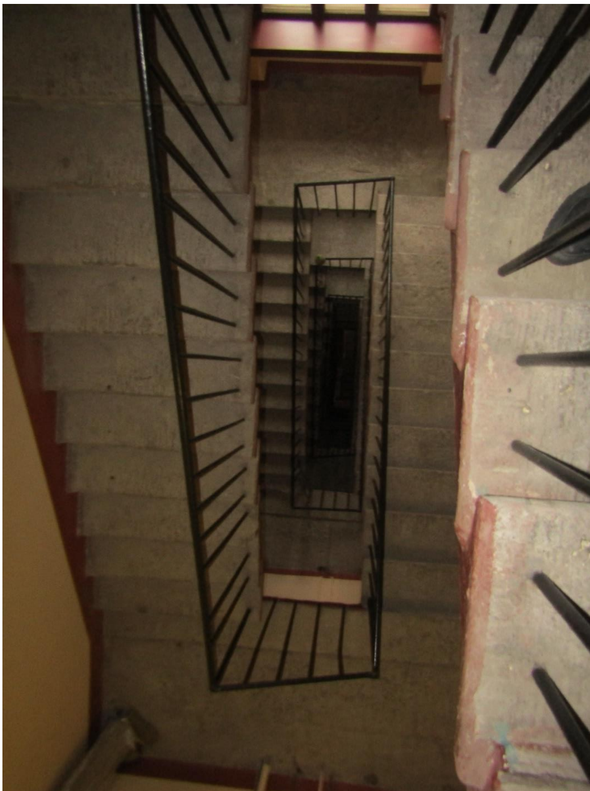
Фото 82. Общий вид лестницы 14ЛК.
