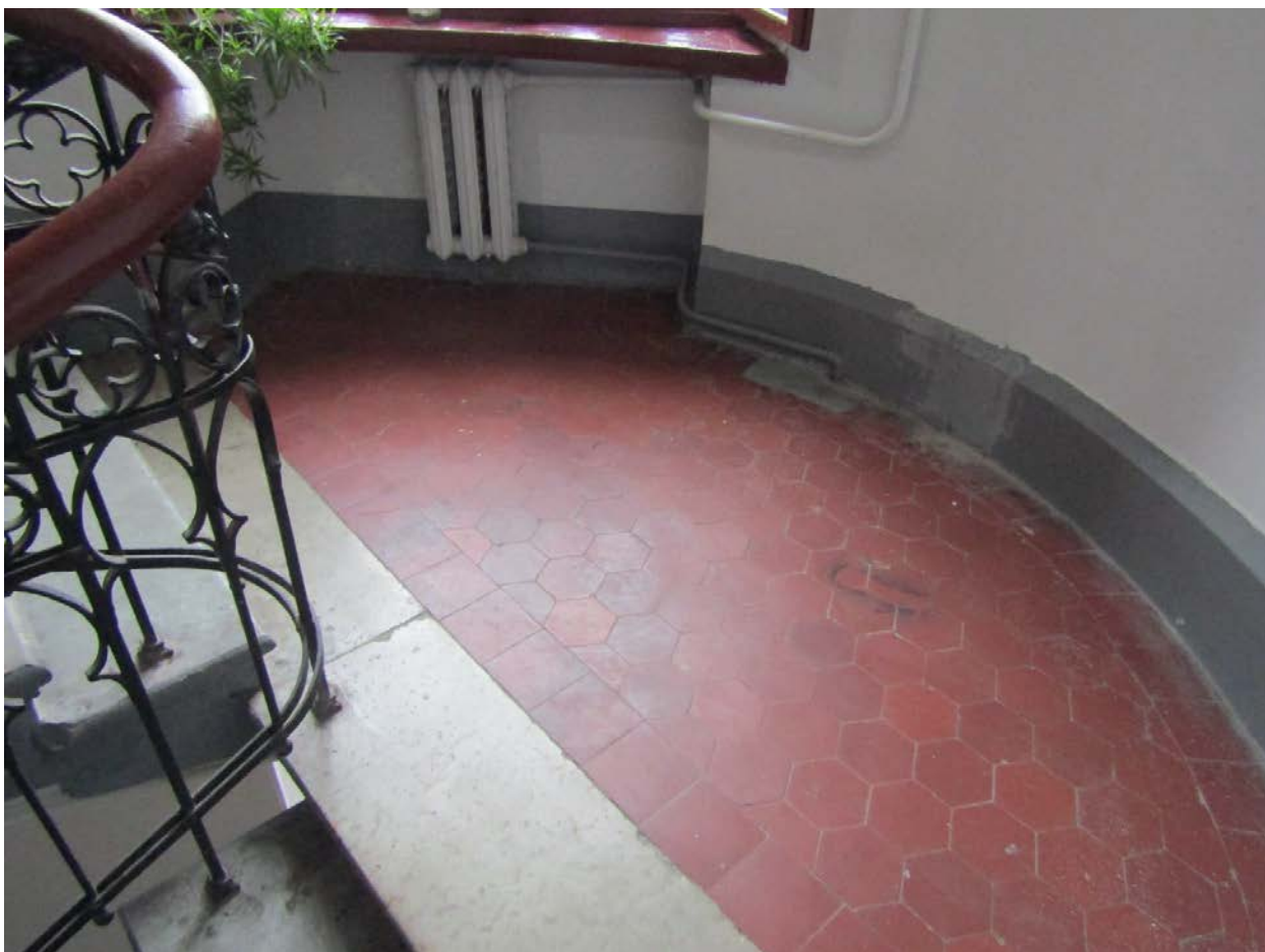
Фото 52. Вид на пол междуэтажной площадки ЗЛК в уровне 2-го – 3-го этажей.
