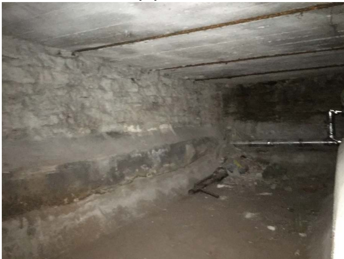
Фото 98. Интерьер подвальных помещений.
