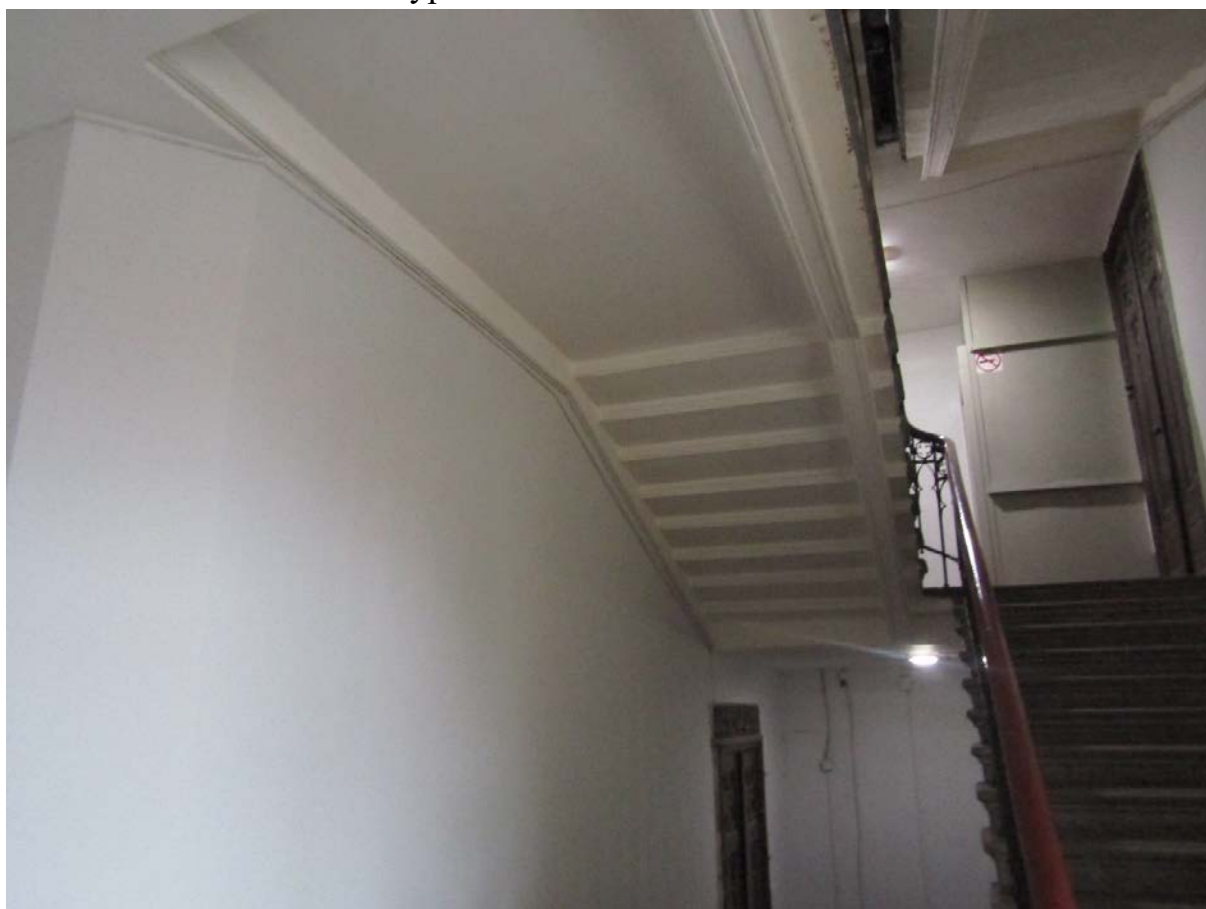
Фото 59. Вид на лестницу 5ЛК в уровне 3-го – 4-го этажей.
