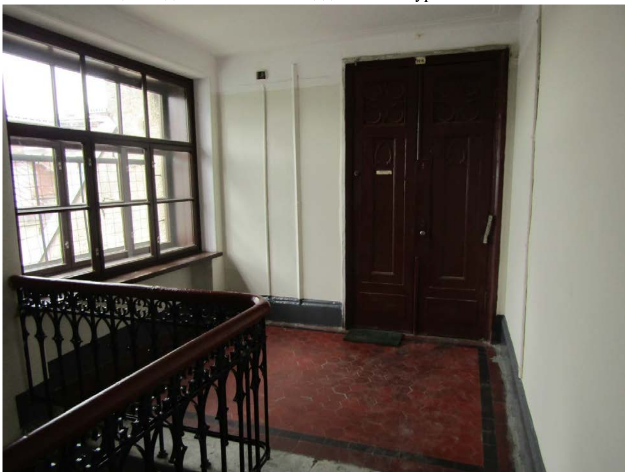
Фото 41. Вид на лестничную площадку в уровне 6-го этажа.
