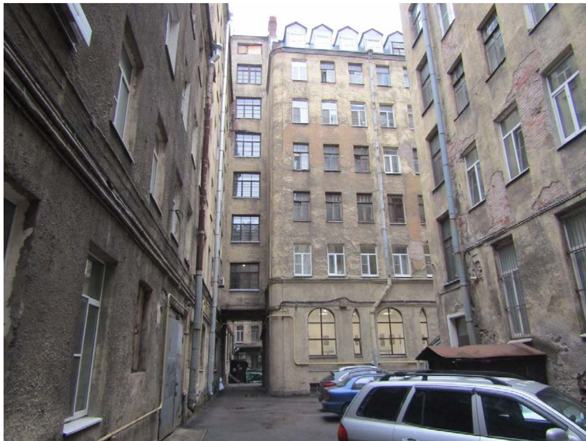
Фото 19. Вид на южную часть восточного фасада центрального дворового флигеля с мансардой.
