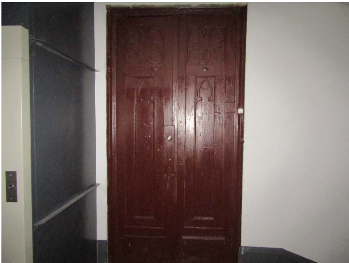
Фото 34. Сохранившееся историческое дверное заполнение в уровне 2-го этажа 17ЛК.
