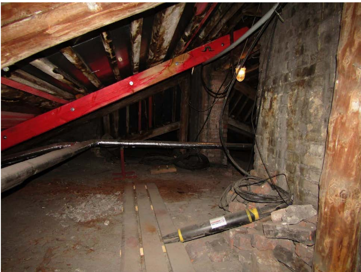
Фото 103. Интерьер чердачных помещений.
