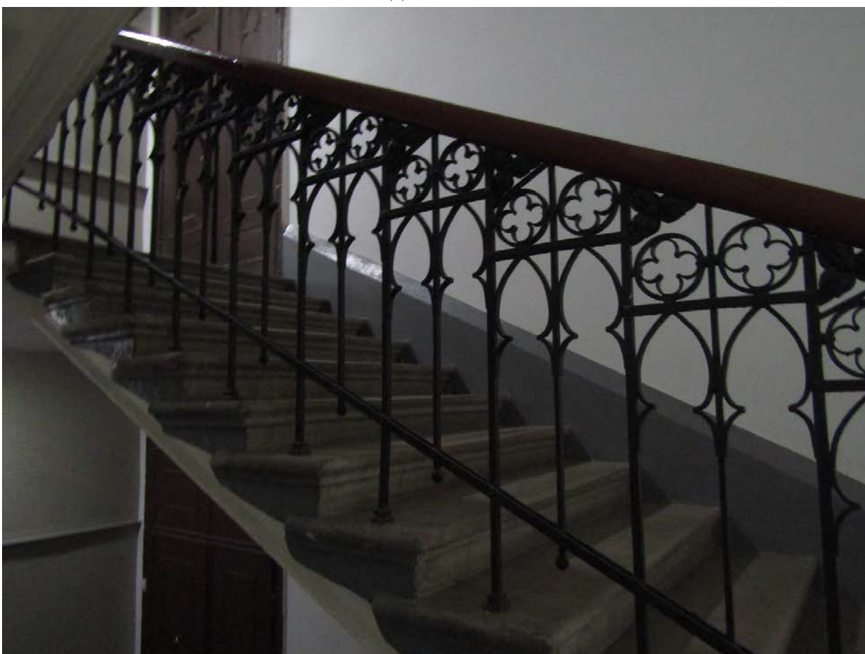
Фото 57. Вид на лестничное ограждение 5ЛК.
