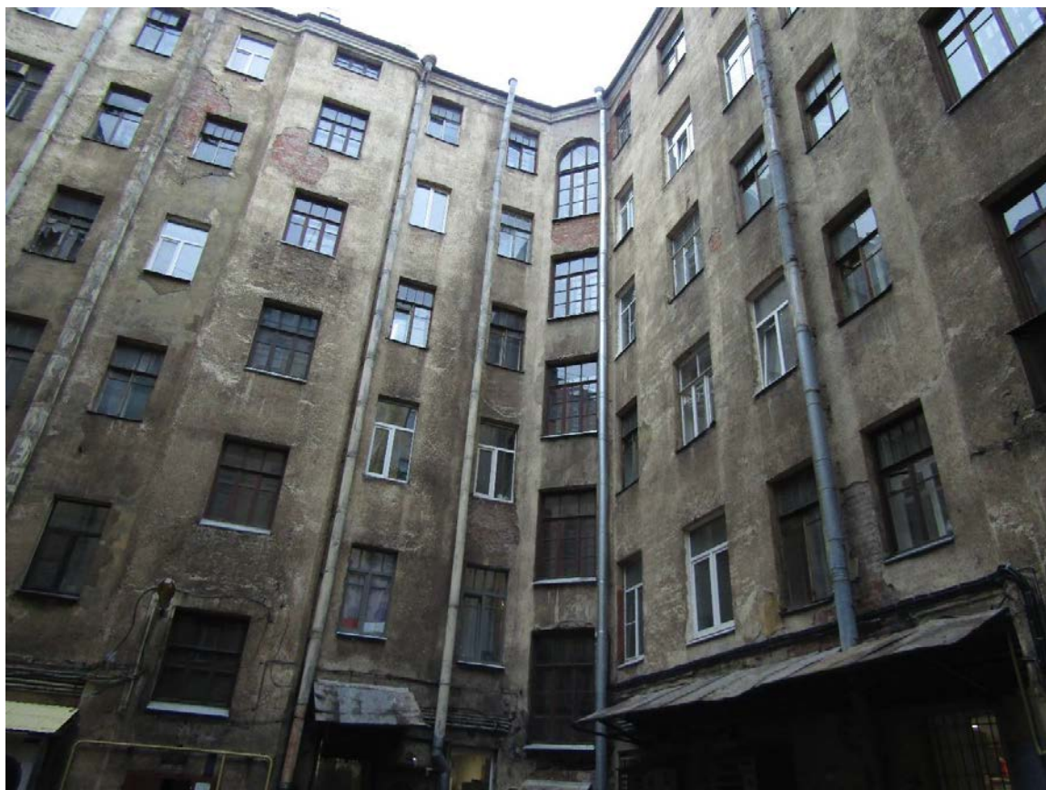
Фото 22. Вид на южный дворовый корпус и западный фасад центрального дворового корпуса.
