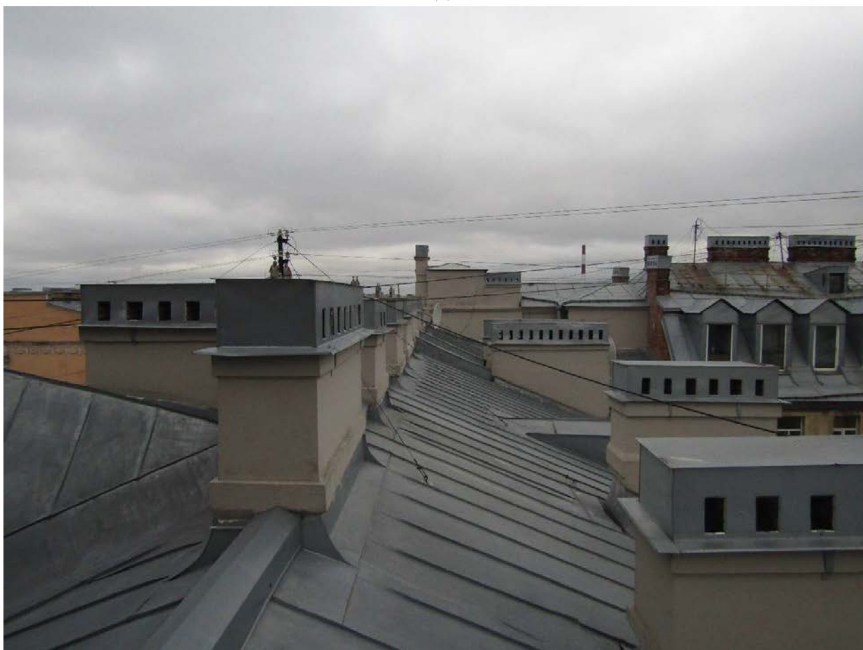
Фото 27. Вид на крышу лицевого корпуса.
