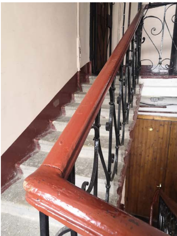
117. Лестница Л-3 в уровне 5-6-го этажей
