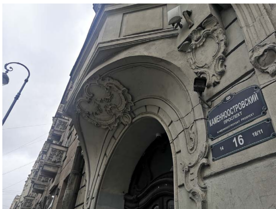
10. Фрагмент лицевого фасада по Каменноостровскому проспекту. Лепная барочная композиция над порталом парадного входа
