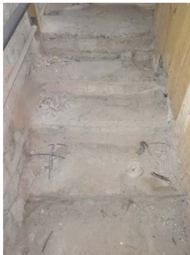
100. Помещение чердака над лестницей Л-2
