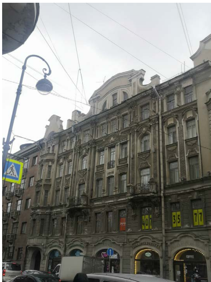
4. Фрагмент лицевого фасада по Каменноостровскому проспекту
