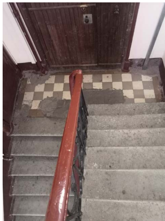
108. Лестница Л-3 в уровне 3-го этажа
