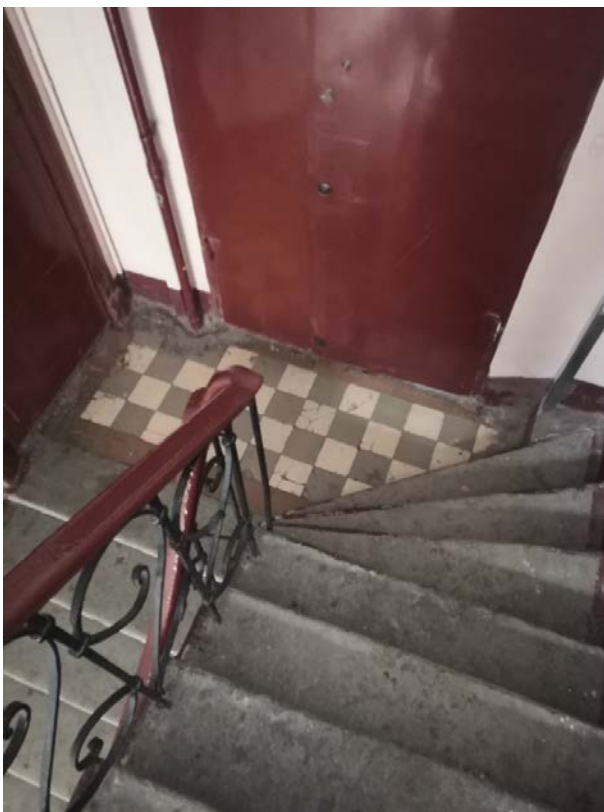
111. Лестница Л-3 в уровне 4-го этажа
