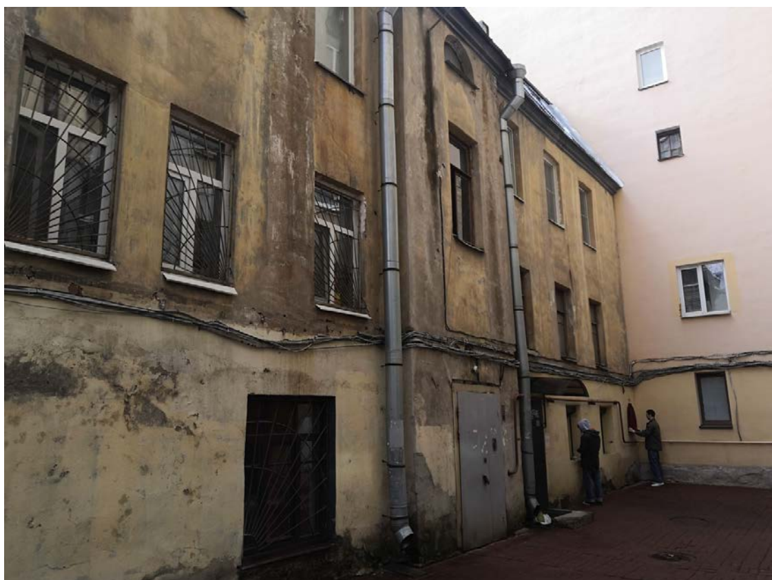
36. Фрагмент дворового фасада
