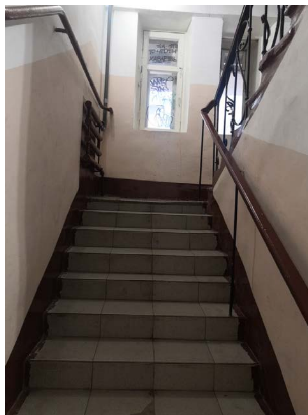
103. Лестница Л-3 в уровне 1-го этажа
