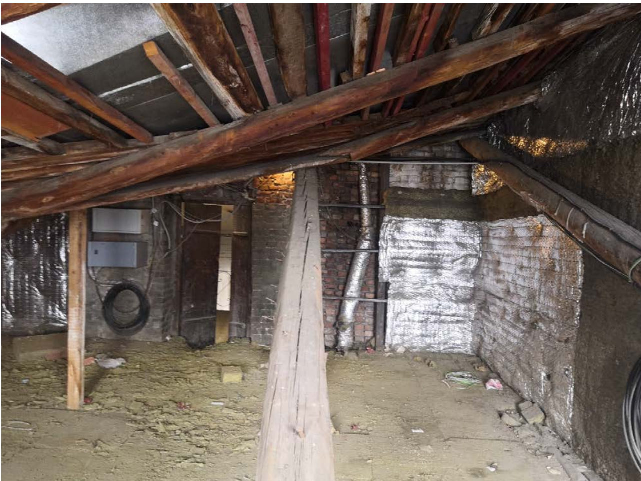
98. Помещение чердака над лестницей Л-2
