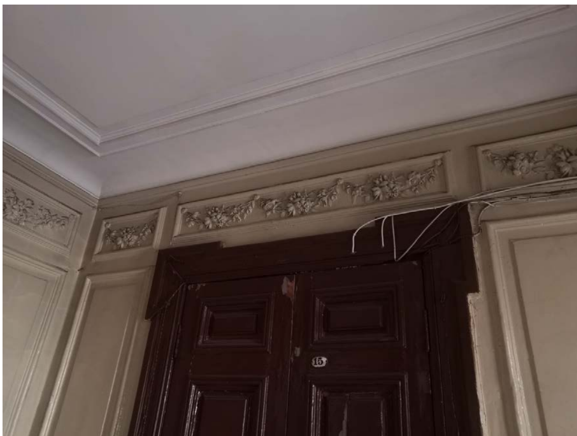
79. Лестница Л-1 в уровне 4-го этажа
