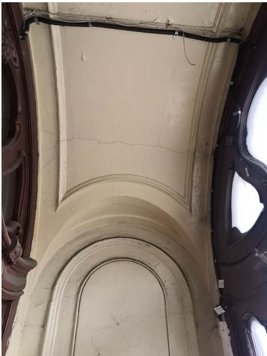
68. Тамбур лестницы Л-1. Полуциркульные своды с филенками на стенах
