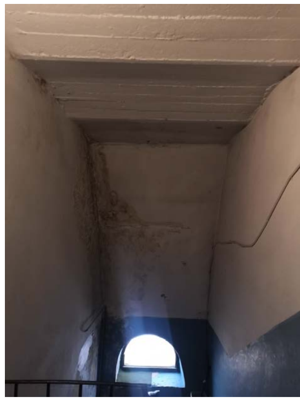
129. Лестница Л-4 в уровне 4-го этажа
