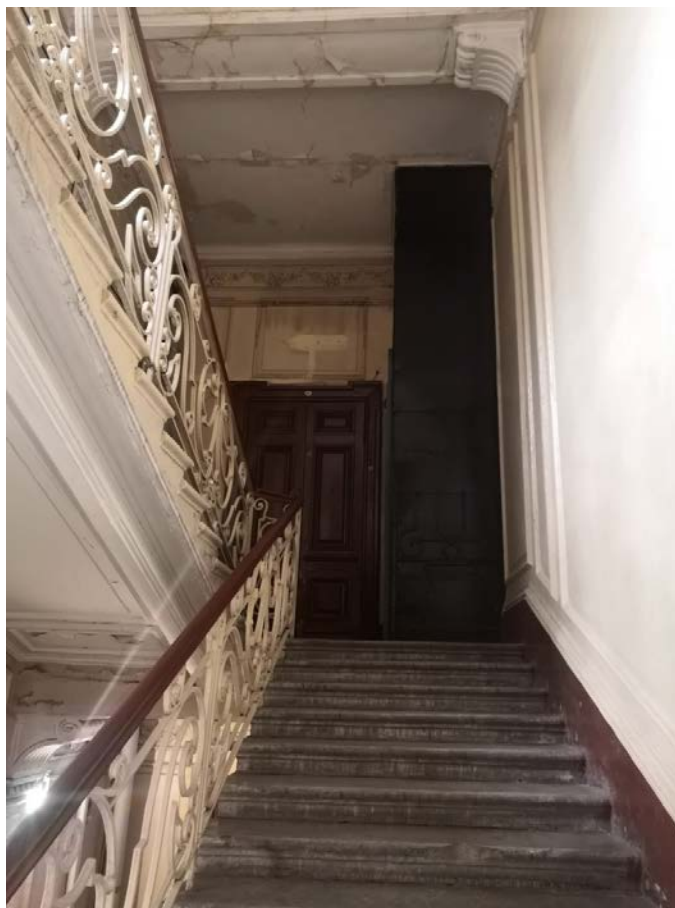
81. Лестница Л-1 в уровне 4-5-го этажей
