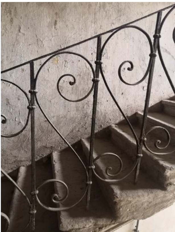
93. Лестница Л-2 в уровне 4-го этажа
