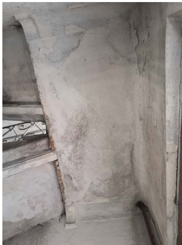
86. Лестница Л-2 в уровне 1-2-го этажей
