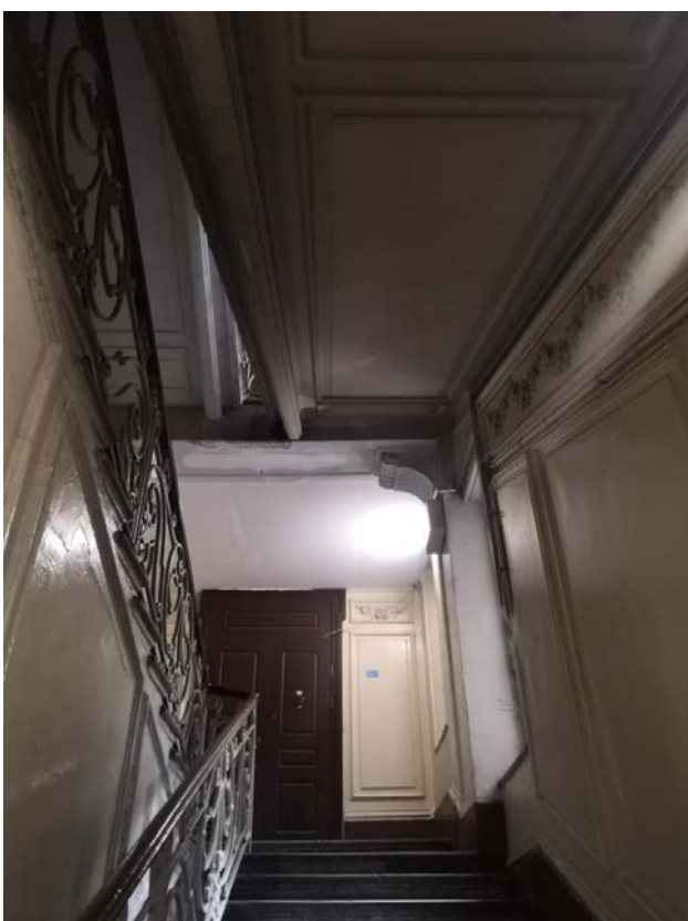
75. Лестница Л-1 в уровне 1-го этажа
