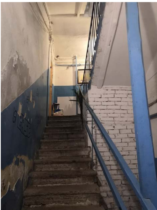
121. Лестница Л-4 в уровне 1-го этажа
