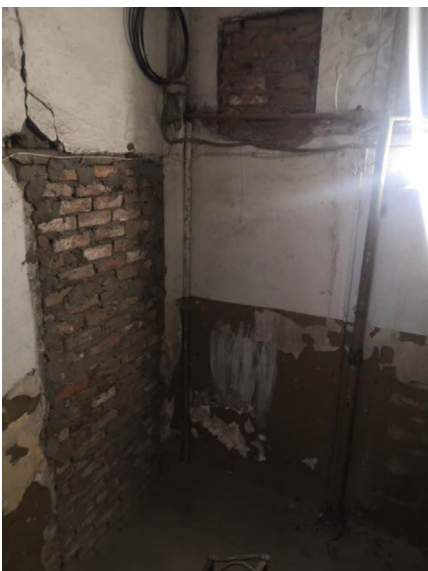
97. Лестница Л-2 в уровне 2-го этажа
