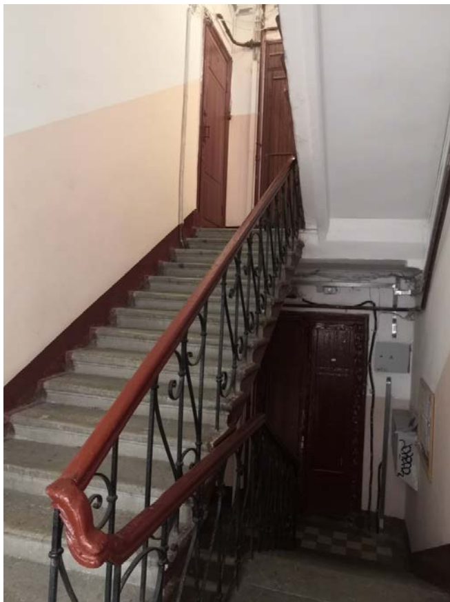
104. Лестница Л-3 в уровне 1-2-го этажей
