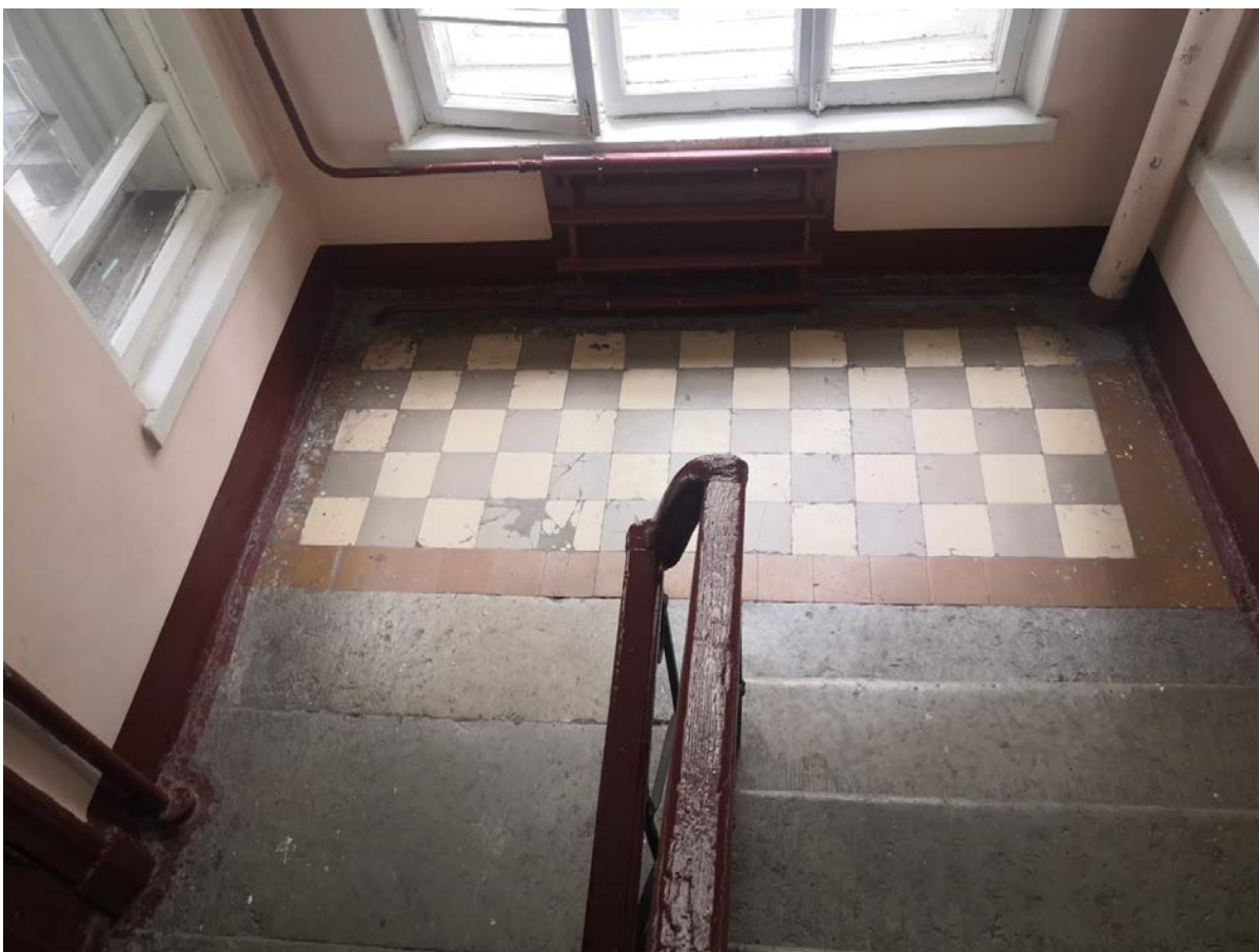
110. Лестница Л-3 в уровне 3-4-го этажей
