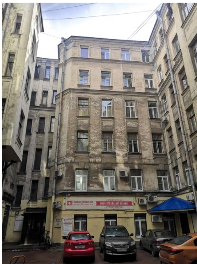
27. Фрагмент дворового фасада
