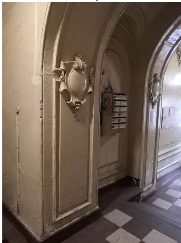
70. Парадный вестибюль лестницы Л-1. Лепные картуши
