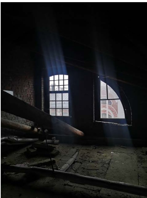
99. Помещение чердака над лестницей Л-2
