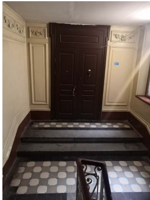
76. Лестница Л-1 в уровне 2-го этажа
