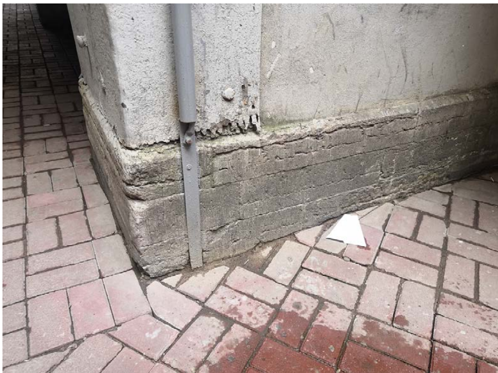
30. Фрагмент дворового фасада. Известняковый цоколь
