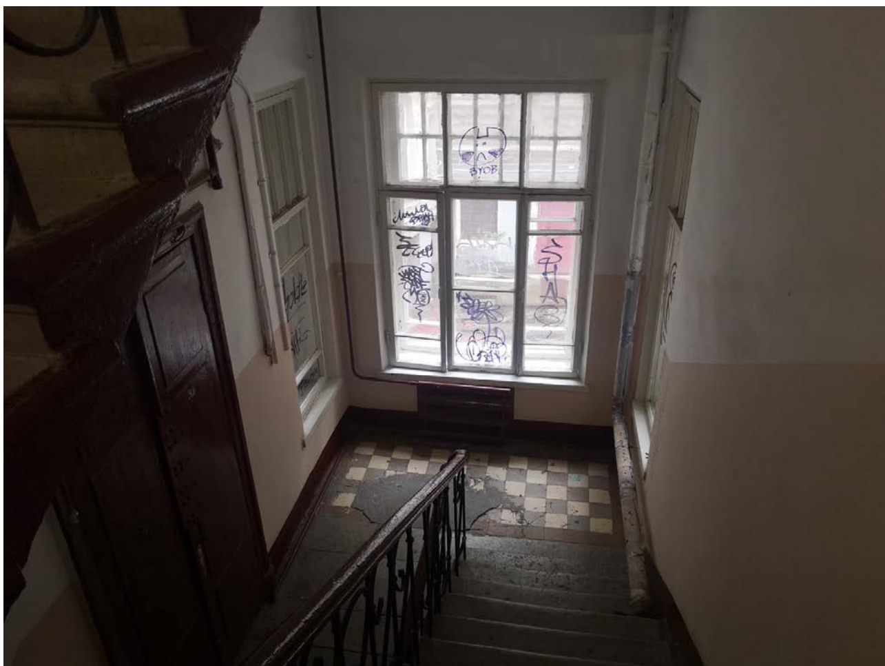
106. Лестница Л-3 в уровне 2-3-го этажей
