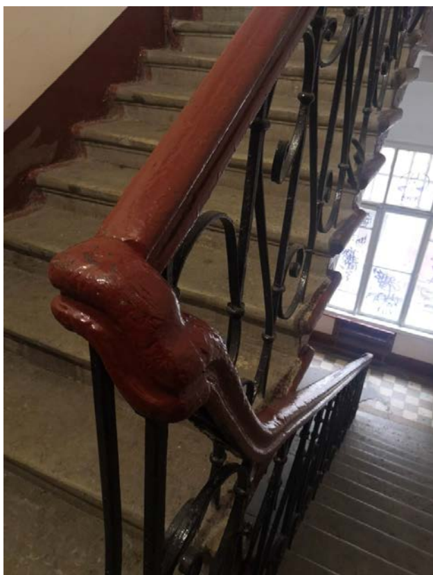
107. Лестница Л-3 в уровне 3-го этажа
