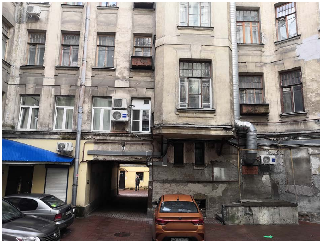
28. Фрагмент дворового фасада
