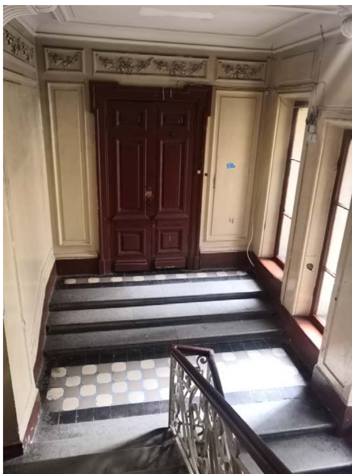
78. Лестница Л-1 в уровне 3-го этажа
