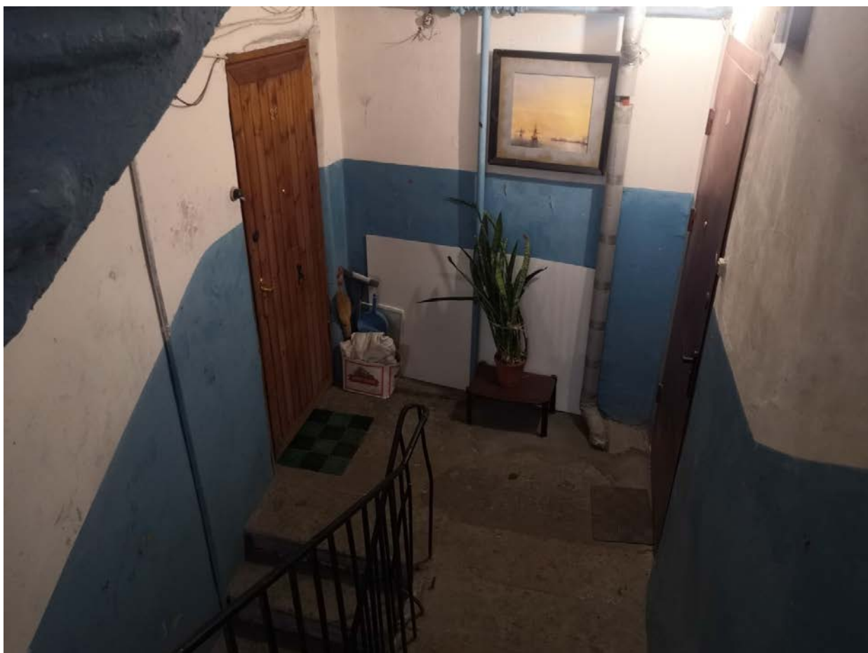
123. Лестница Л-4 в уровне 2-го этажа
