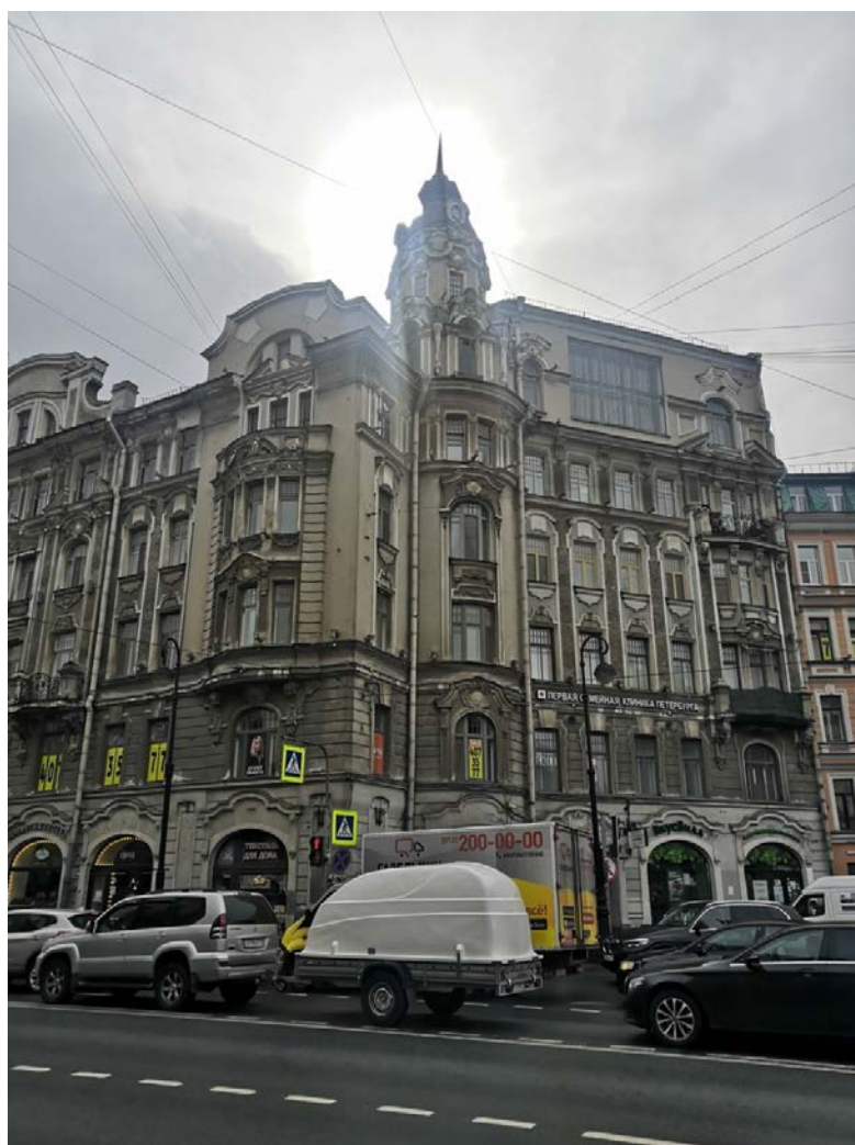
12. Фрагмент лицевых фасадов
