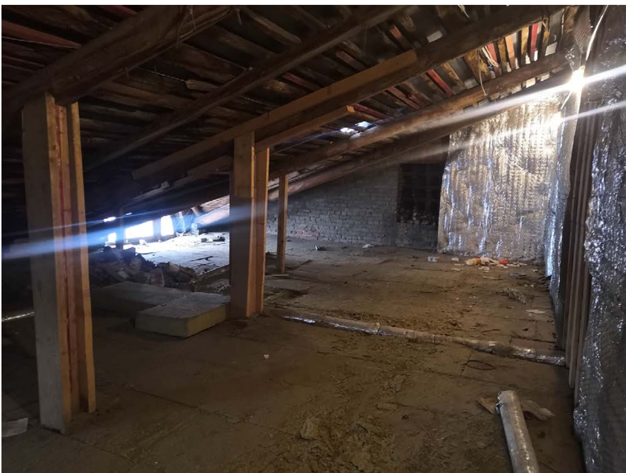
97. Помещение чердака над лестницей Л-2
