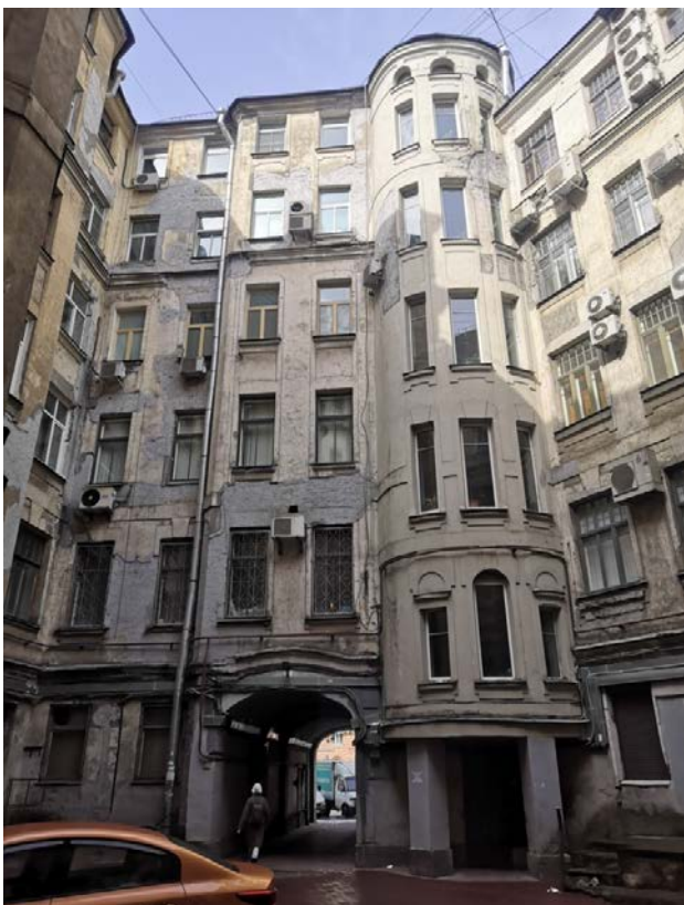
23. Фрагмент дворового фасада
