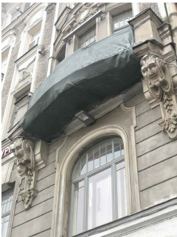
18. Фрагмент лицевого фасада по Австрийской площади. Оформление балконов
