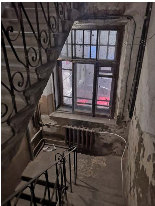
85. Лестница Л-2 в уровне 1-2-го этажей
