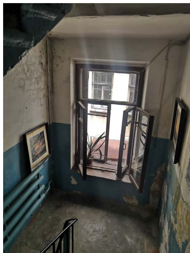
125. Лестница Л-4 в уровне 2-3-го этажей
