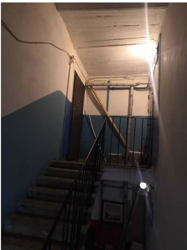
128. Лестница Л-4 в уровне 4-го этажа
