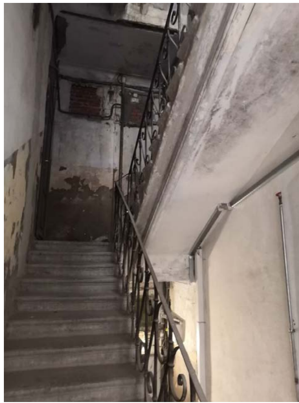
88. Лестница Л-2 в уровне 2-3-го этажей
