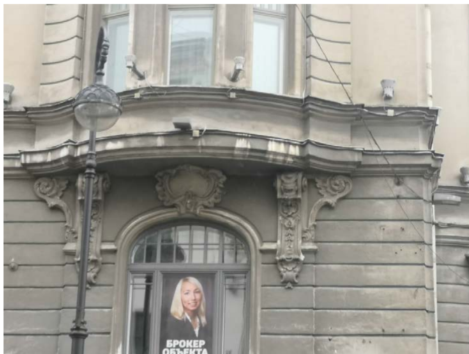
8. Фрагмент лицевого фасада по Каменноостровскому проспекту
