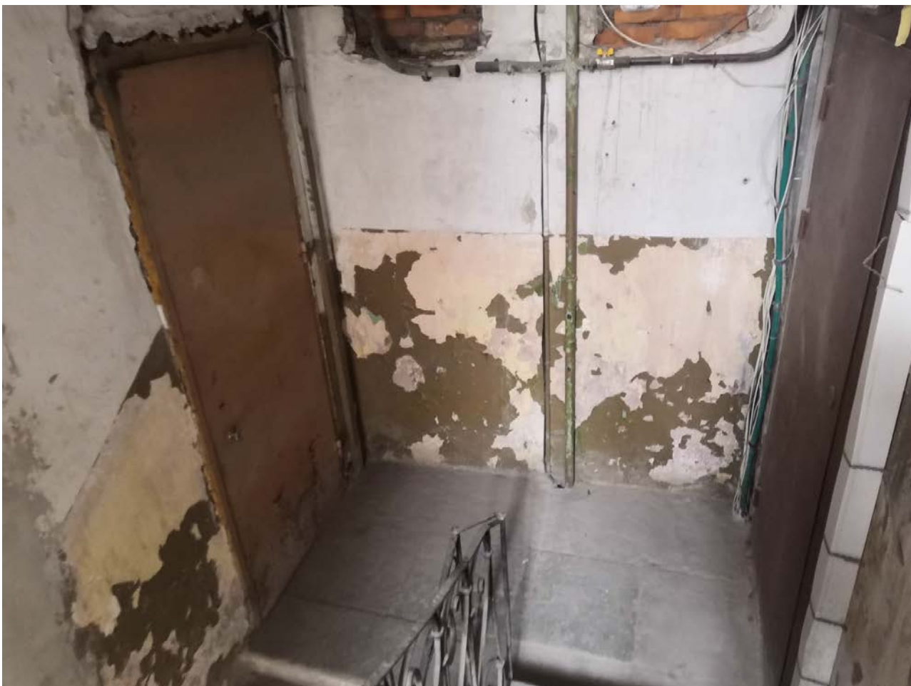
92. Лестница Л-2 в уровне 4-го этажа
