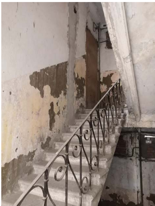
90. Лестница Л-2 в уровне 3-4-го этажей
