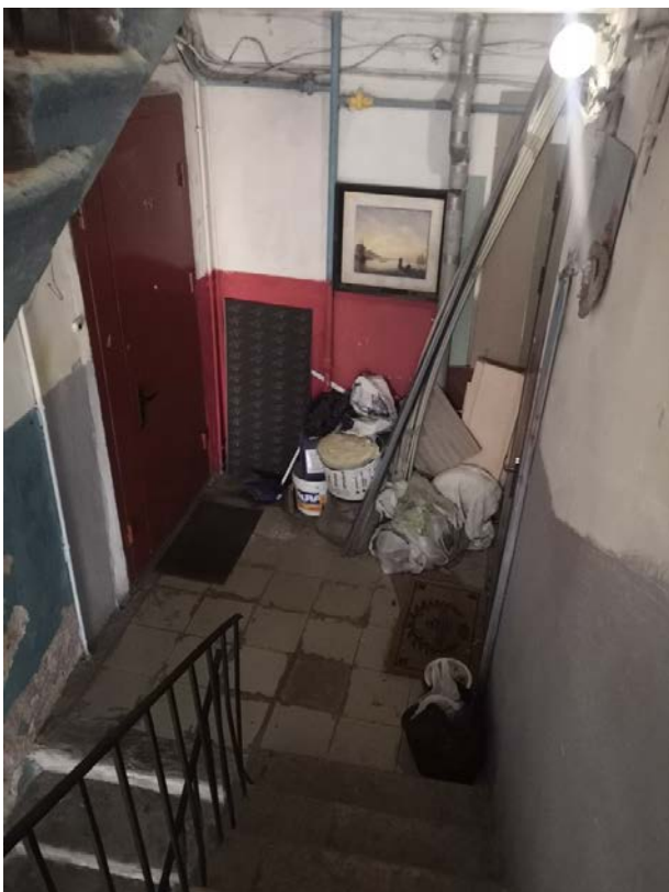
126. Лестница Л-4 в уровне 3-го этажа
