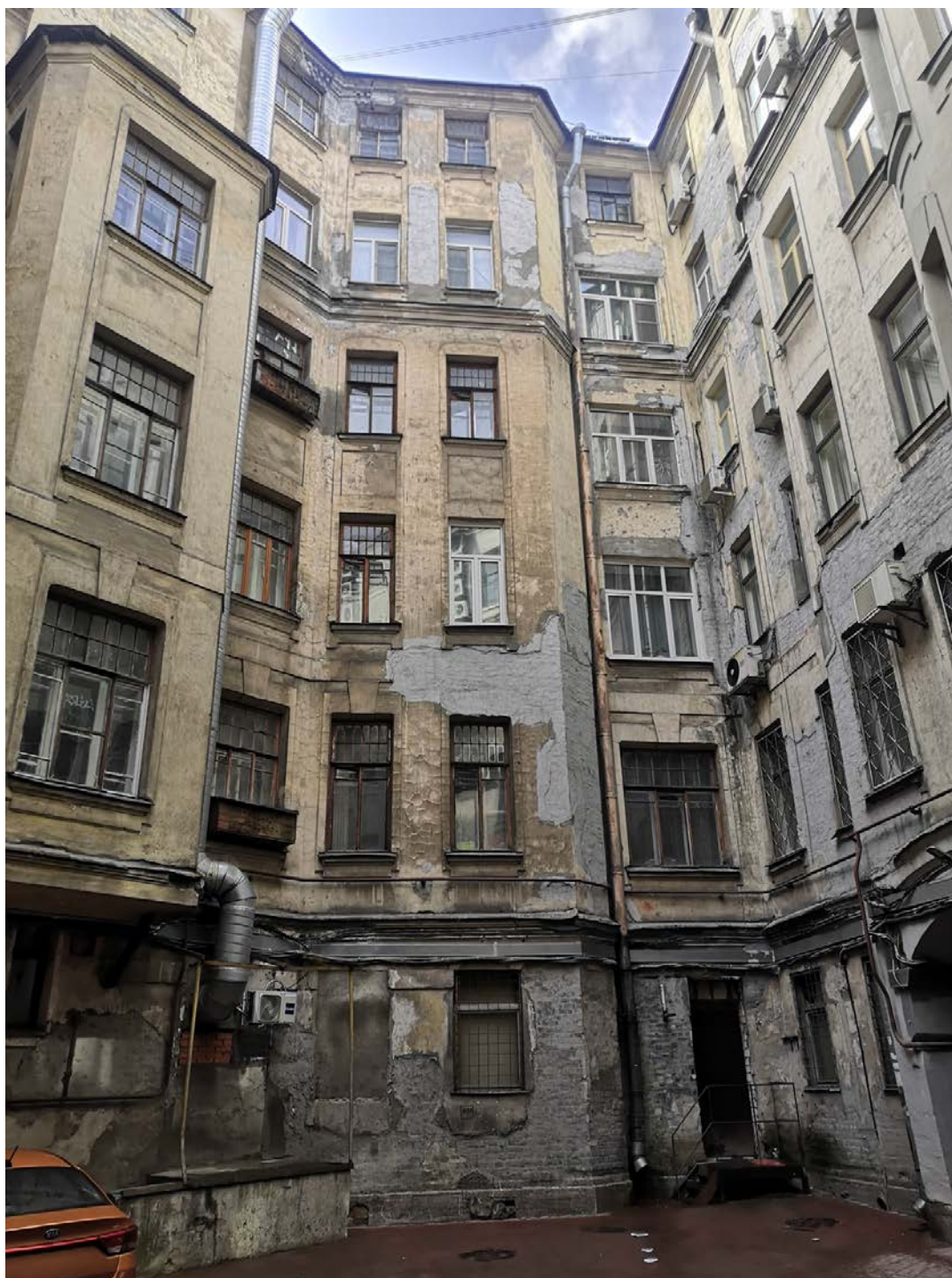
29. Фрагмент дворового фасада
