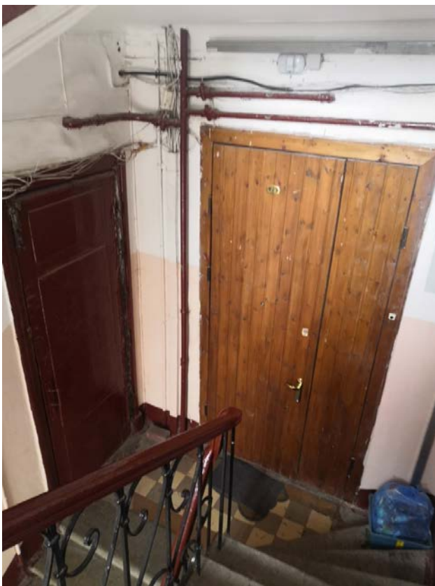
115. Лестница Л-3 в уровне 5-го этажа
