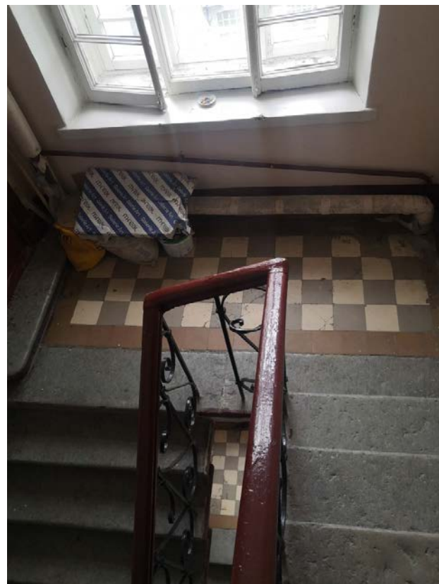
116. Лестница Л-3 в уровне 5-6-го этажей
