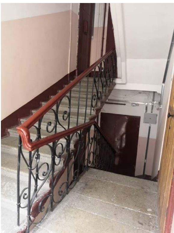
113. Лестница Л-3 в уровне 4-5-го этажей
