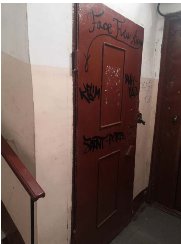
102. Лестница Л-3 в уровне 1-го этажа
