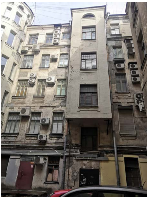
25. Фрагмент дворового фасада
