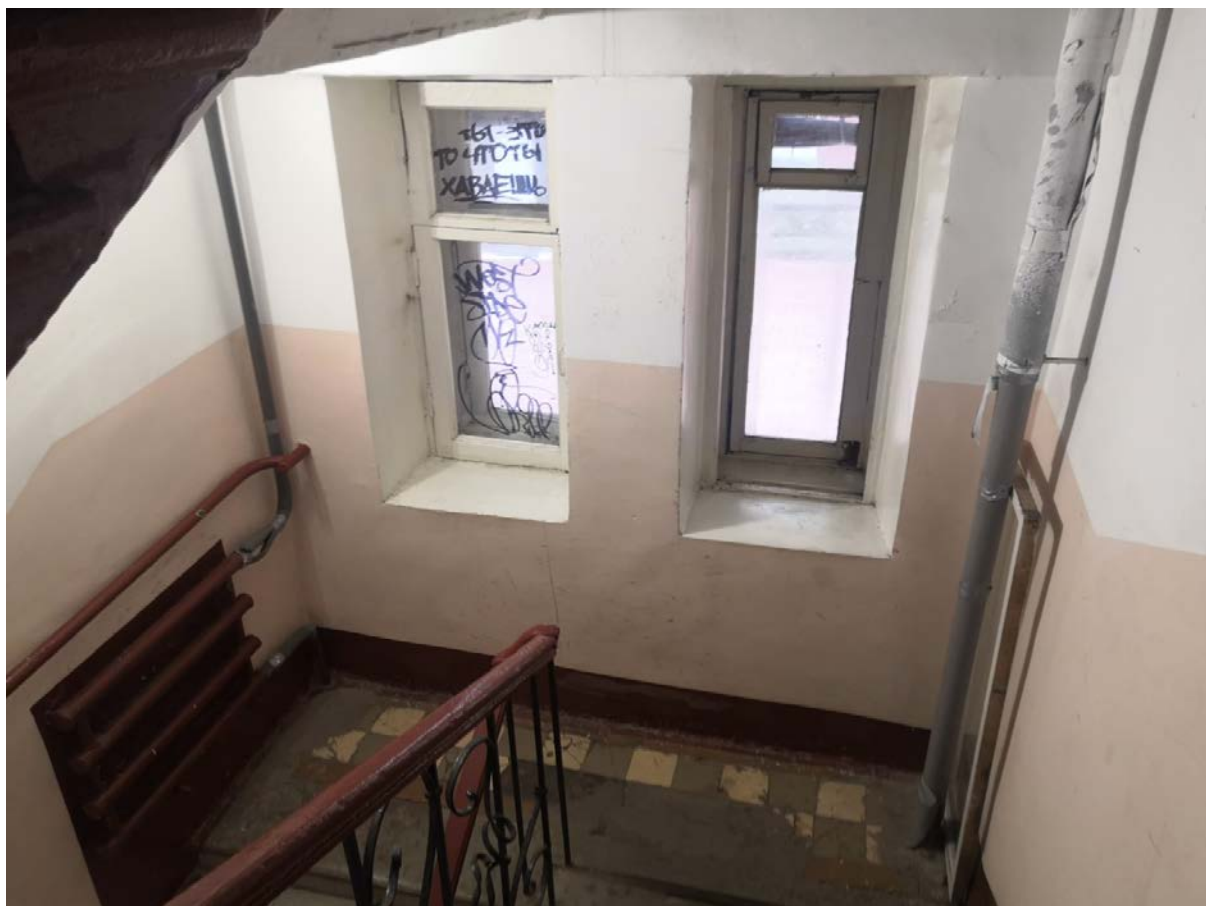
105. Лестница Л-3 в уровне 1-2-го этажей
