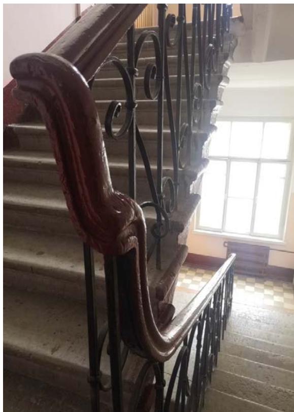
112. Лестница Л-3 в уровне 4-го этажа
