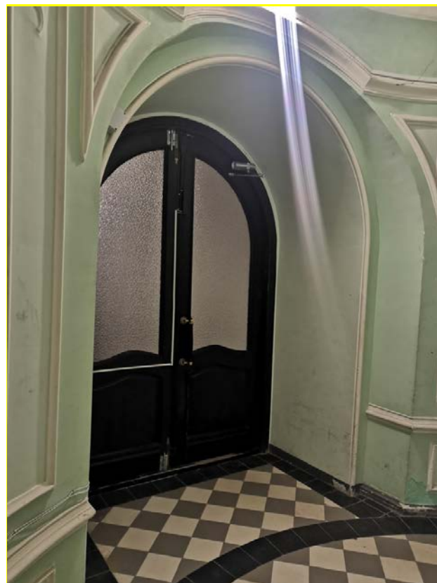
51. Дверной проем вестибюля парадной лестницы
