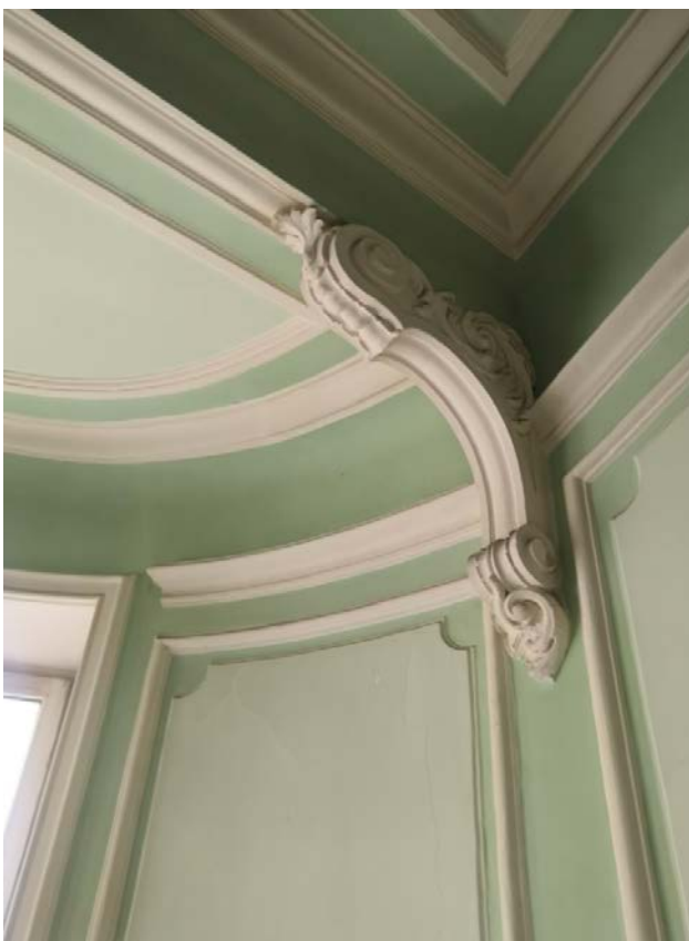
58. Волютообразный кронштейн в уровне 1-2-го этажей
