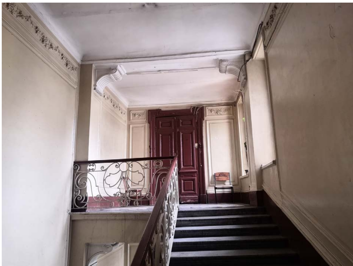
82. Лестница Л-1 в уровне 6-го этажа
