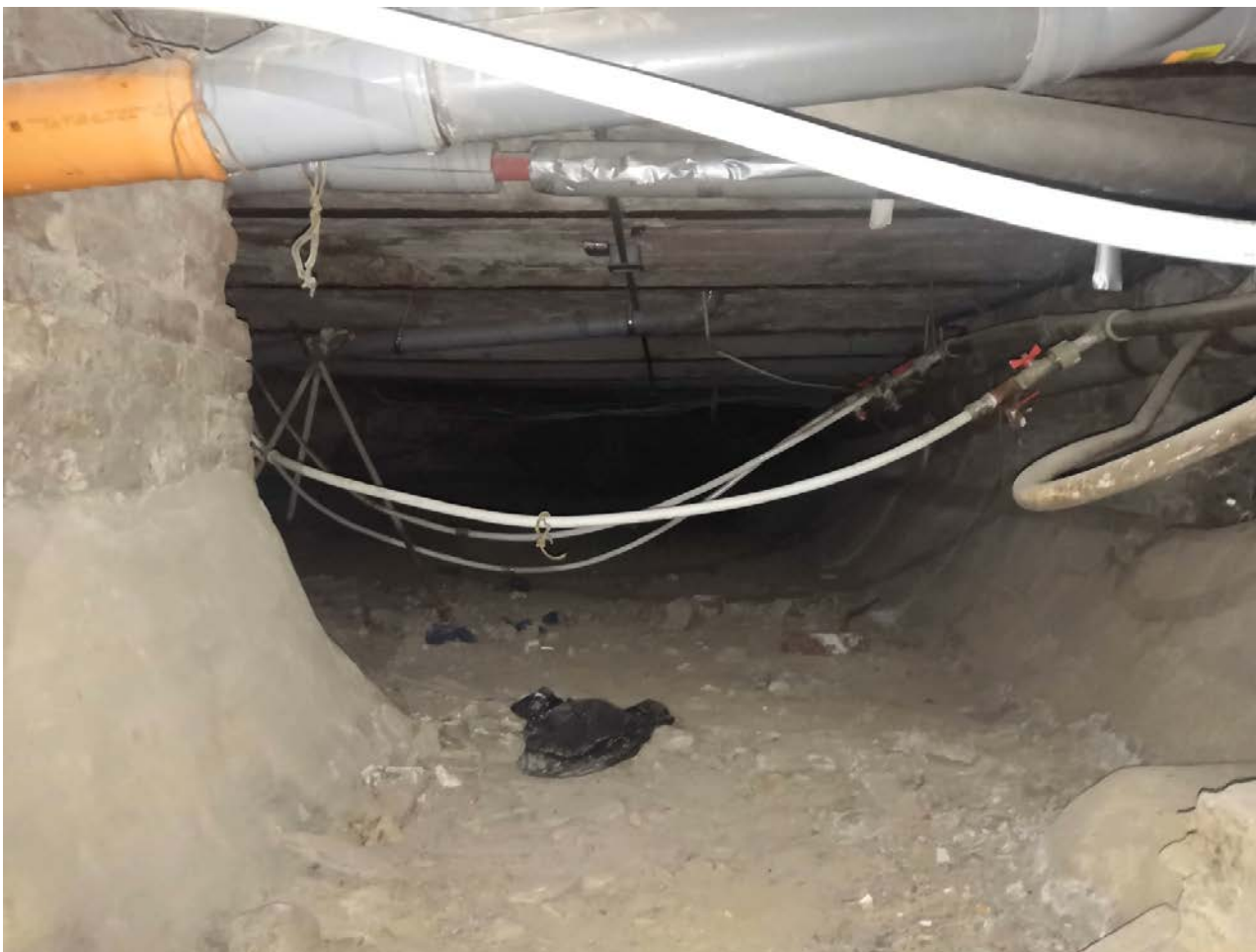
101. Помещение чердака над лестницей Л-2
