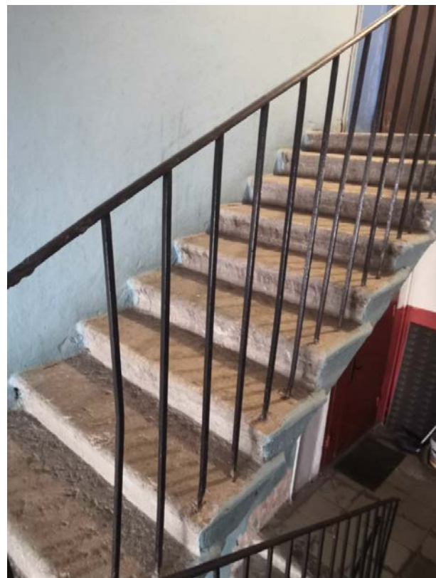
127. Лестница Л-4 в уровне 3-4-го этажей
