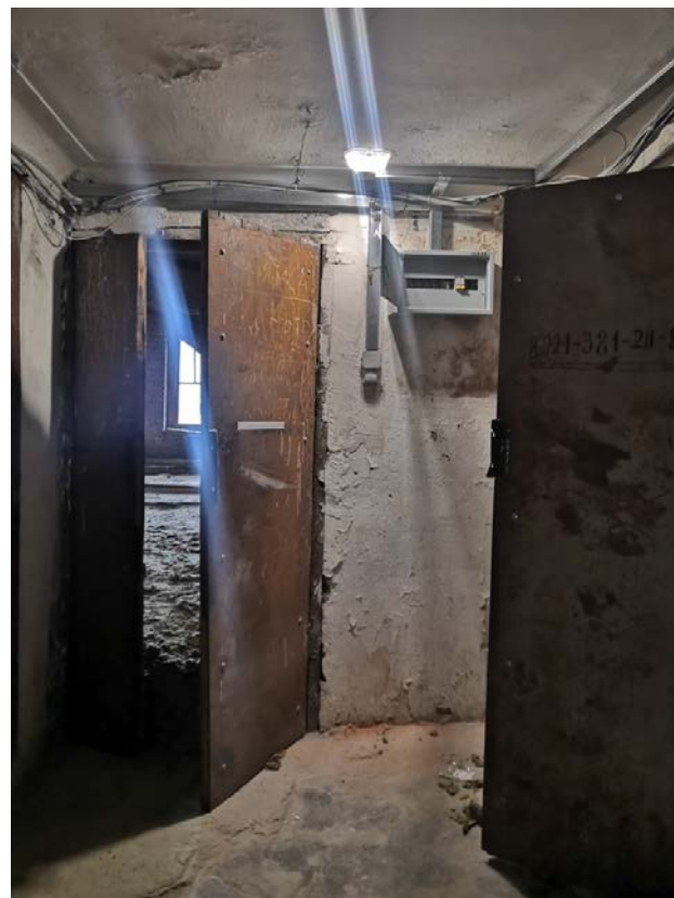
96. Помещение чердака над лестницей Л-2
