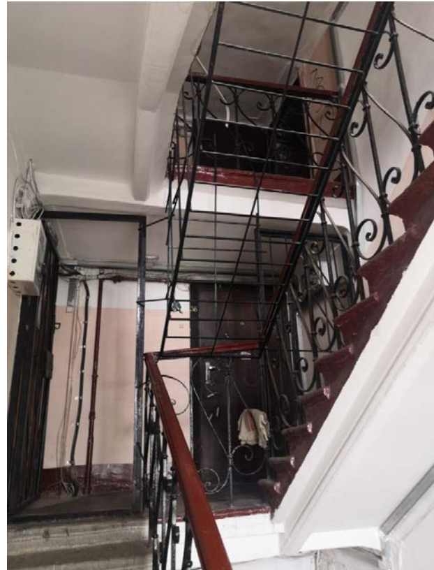
118. Лестница Л-3 в уровне 6-го этажа
