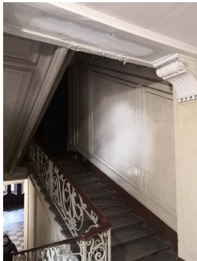
74. Лестница Л-1 в уровне 1-2-го этажей
