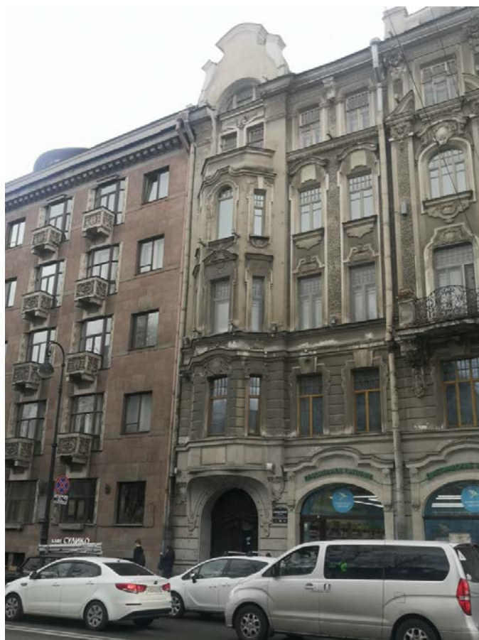
3. Фрагмент лицевого фасада по Каменноостровскому проспекту
