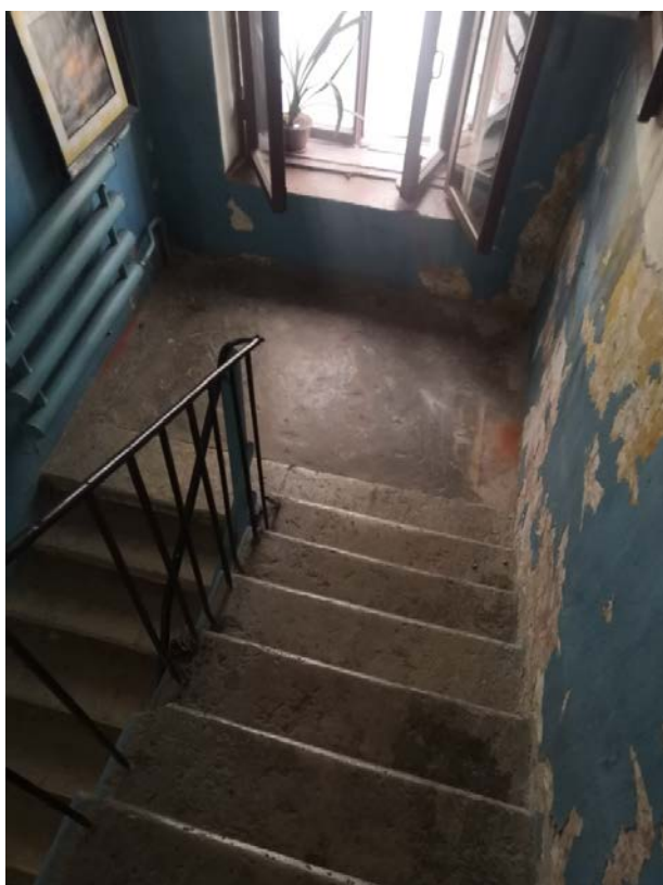
124. Лестница Л-4 в уровне 2-3-го этажей
