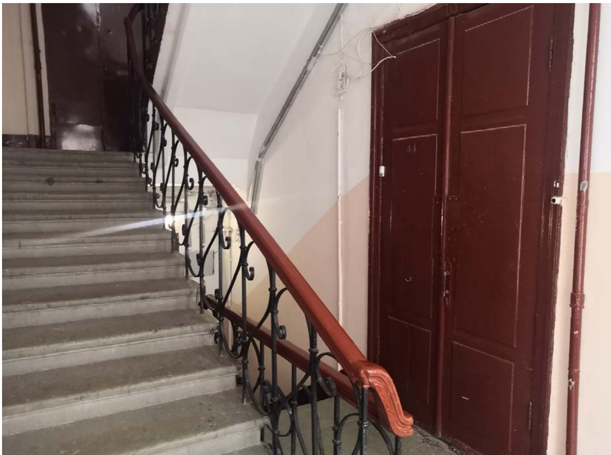
109. Лестница Л-3 в уровне 3-4-го этажей
