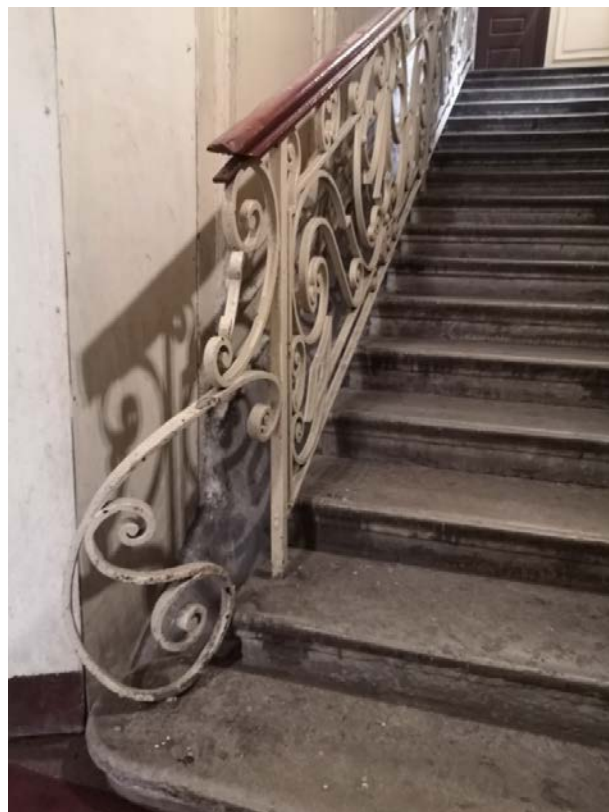
72. Лестница Л-1 в уровне 1-го этажа
