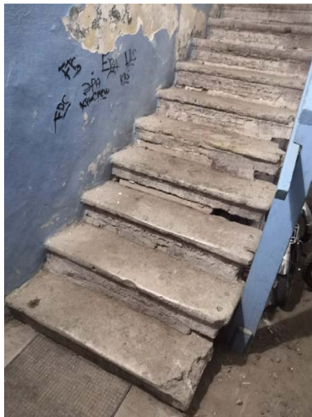
120. Лестница Л-4 в уровне 1-го этажа
