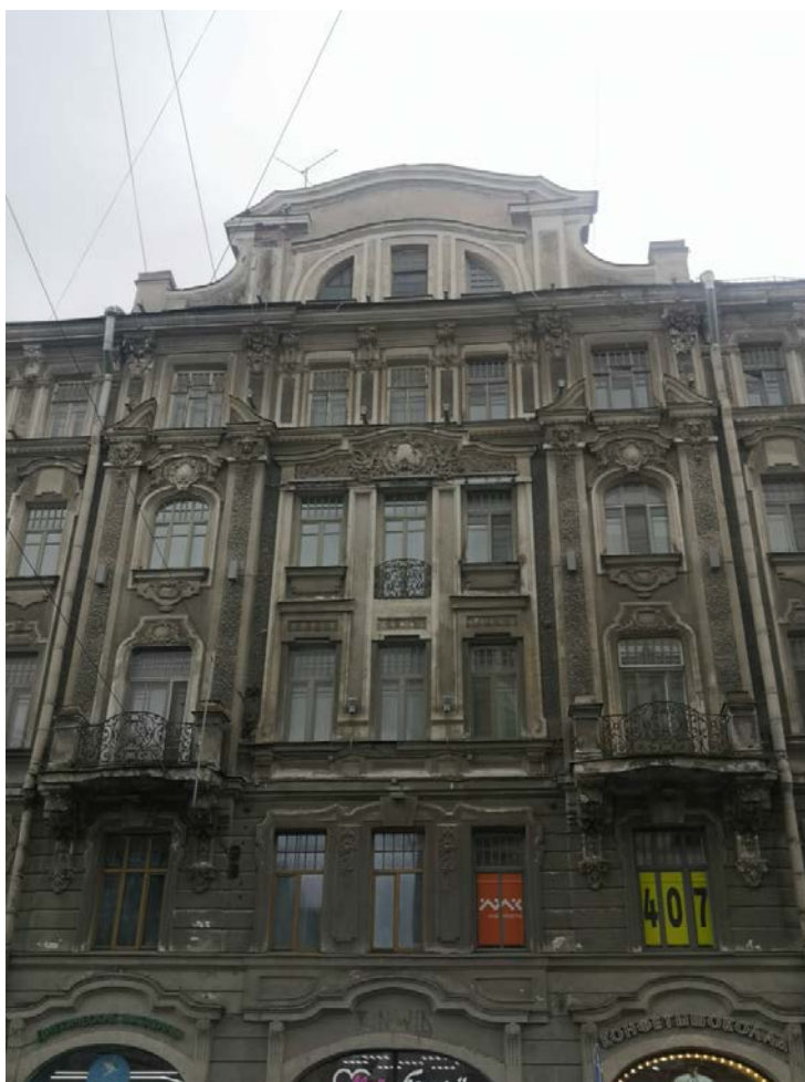
5. Фрагмент лицевого фасада по Каменноостровскому проспекту
