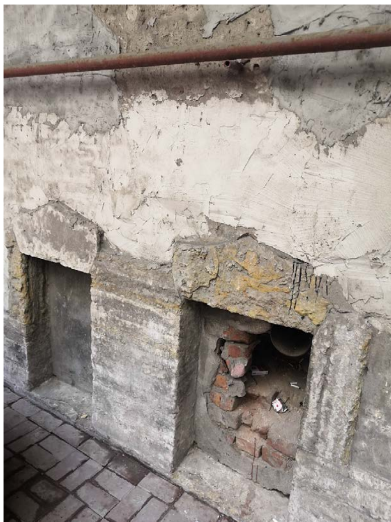
31. Фрагмент дворового фасада. Оформление цокольных проемов
