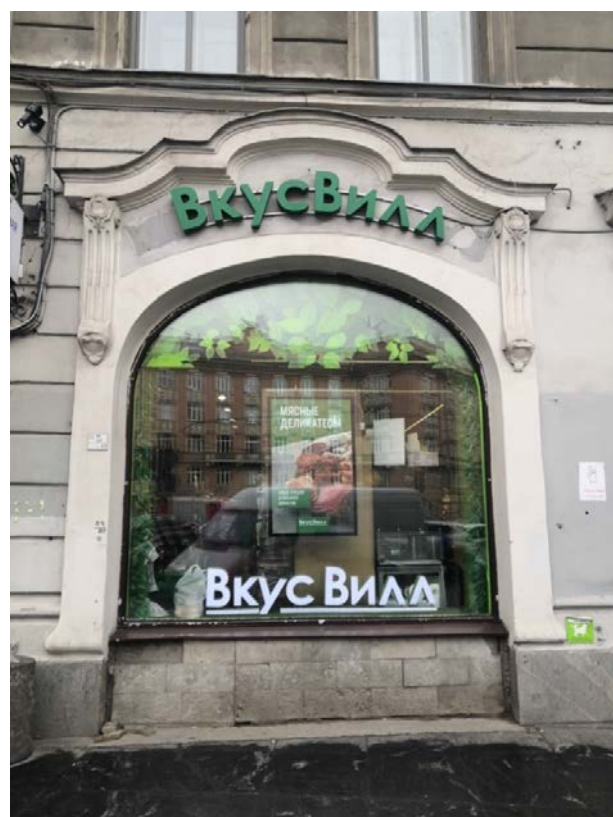
19. Фрагмент лицевого фасада по Австрийской площади. Оконный проем первого этажа
