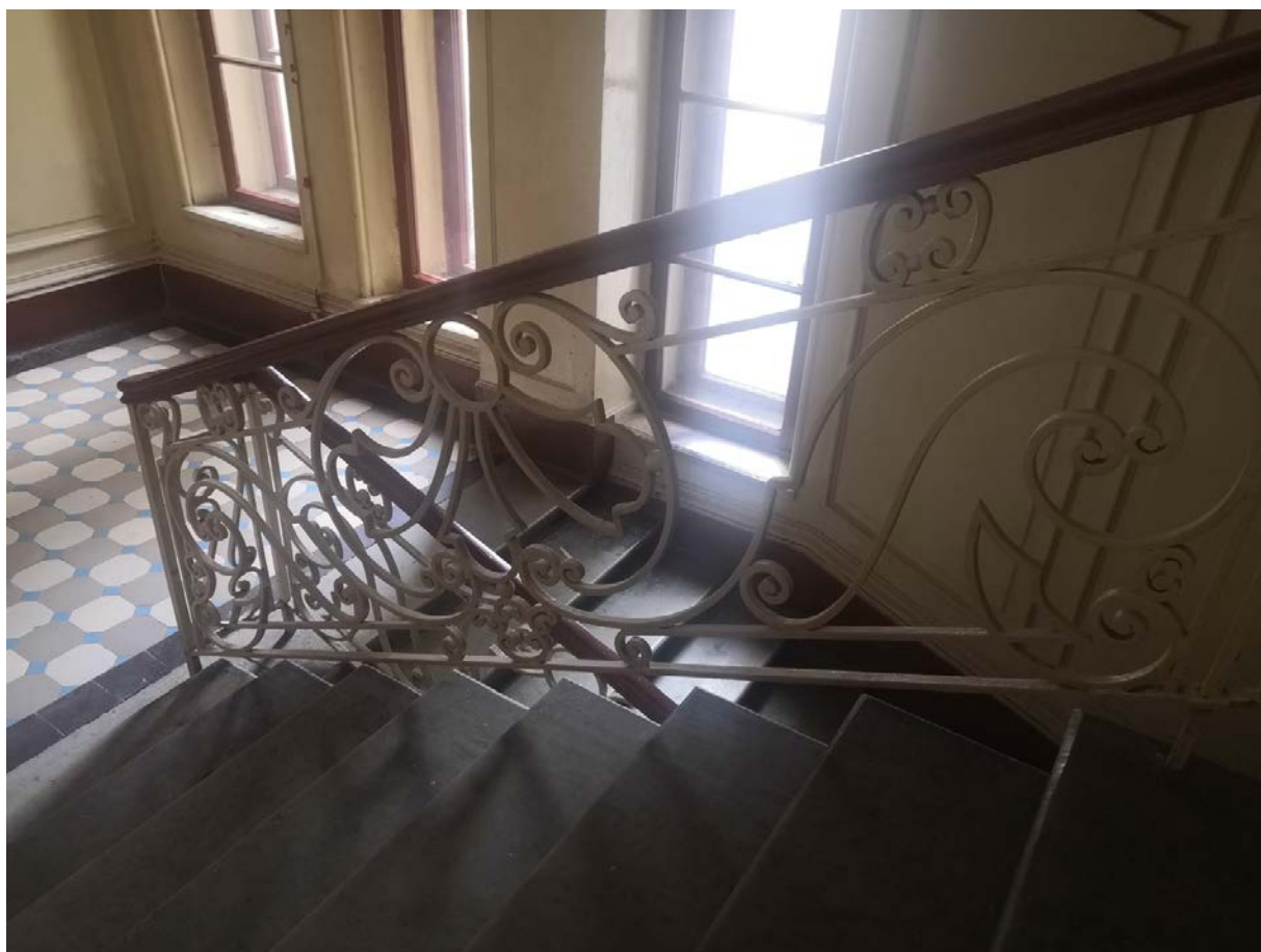
80. Лестница Л-1 в уровне 4-го этажа
