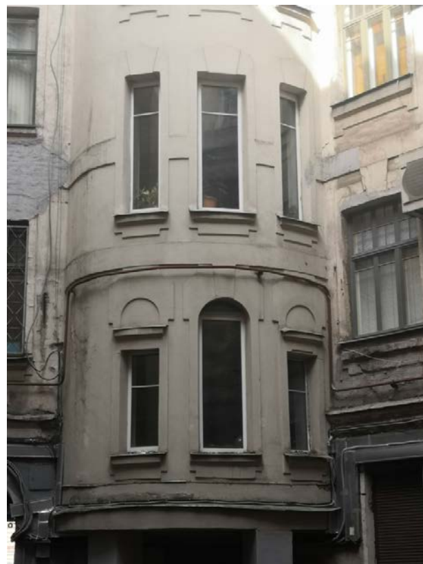
24. Фрагмент дворового фасада. Полуциркульный эркер в зоне входного проема на двух пилонах с объемом лестницы внутри
