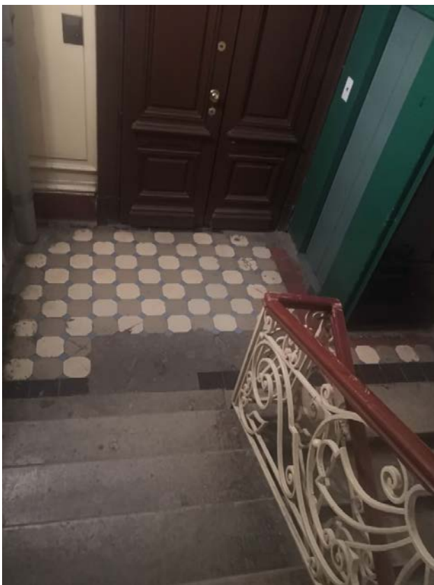
73. Лестница Л-1 в уровне 1-2-го этажей
