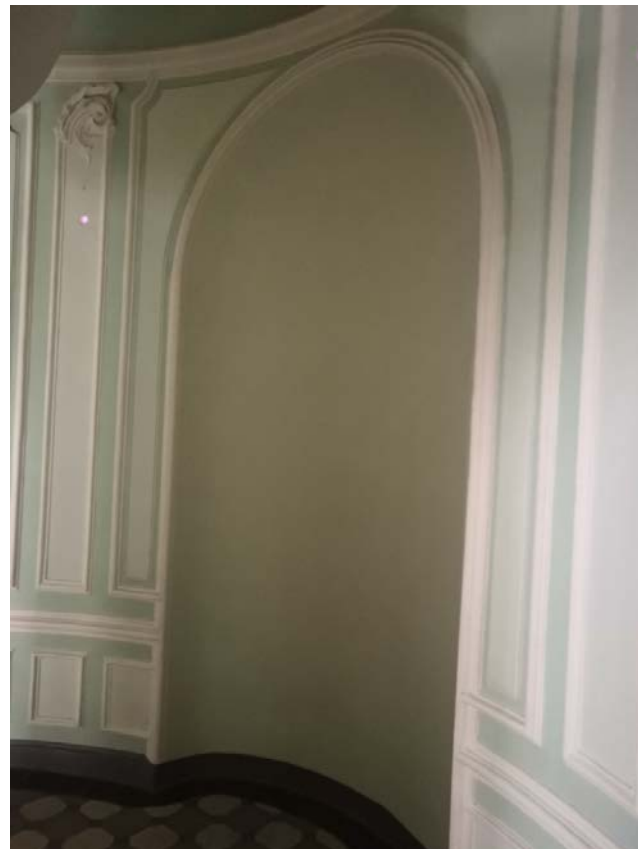
59. Арка в уровне 2-го этажа
