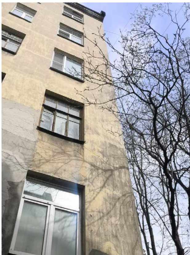
33. Фрагмент дворового фасада
