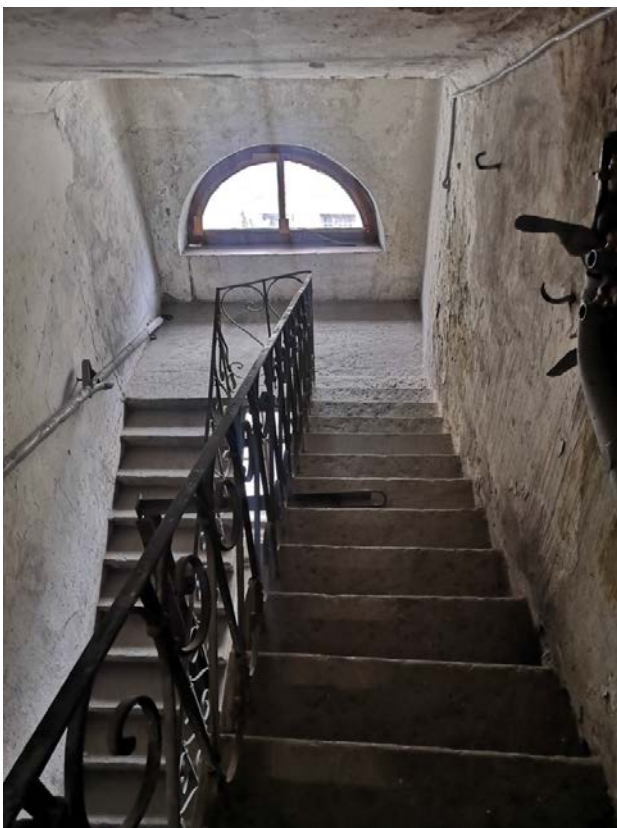
95. Лестница Л-2 в уровне 5-6-го этажей
