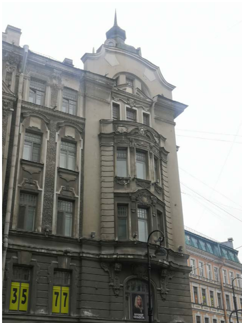
7. Фрагмент лицевого фасада по Каменноостровскому проспекту. Эркер.
