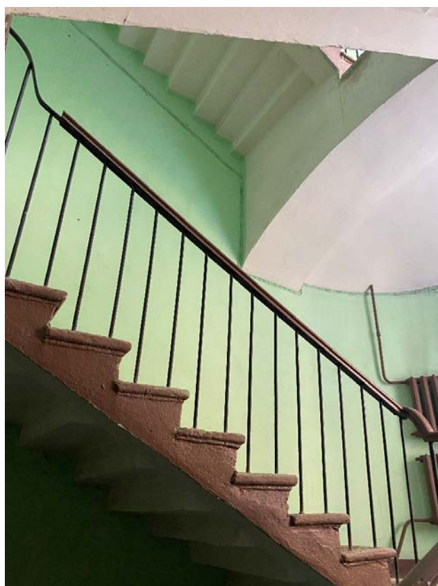
Фото 16. Ограждение маршей из черного металла, в виде вертикальных прутьев круглого сечения; профилированный деревянный поручень.
