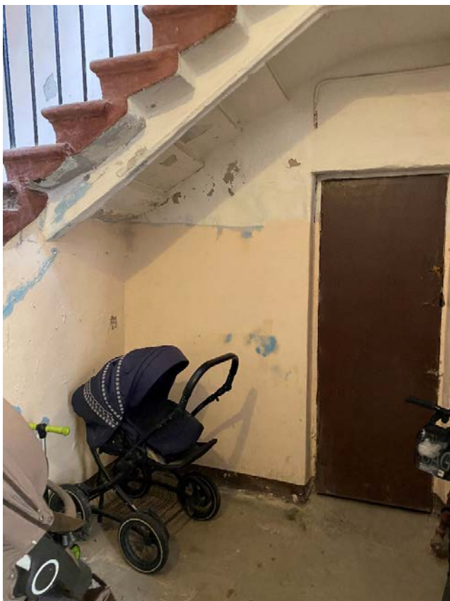
Фото 21. Лестничная клетка 2ЛК в уровне 1-го этажа.
