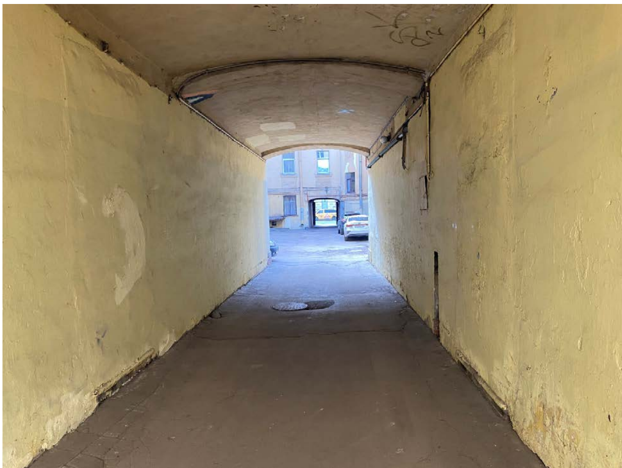
Фото 6. Уп্লощенный цилиндрический свод в воротном проезде восточного флигеля.
