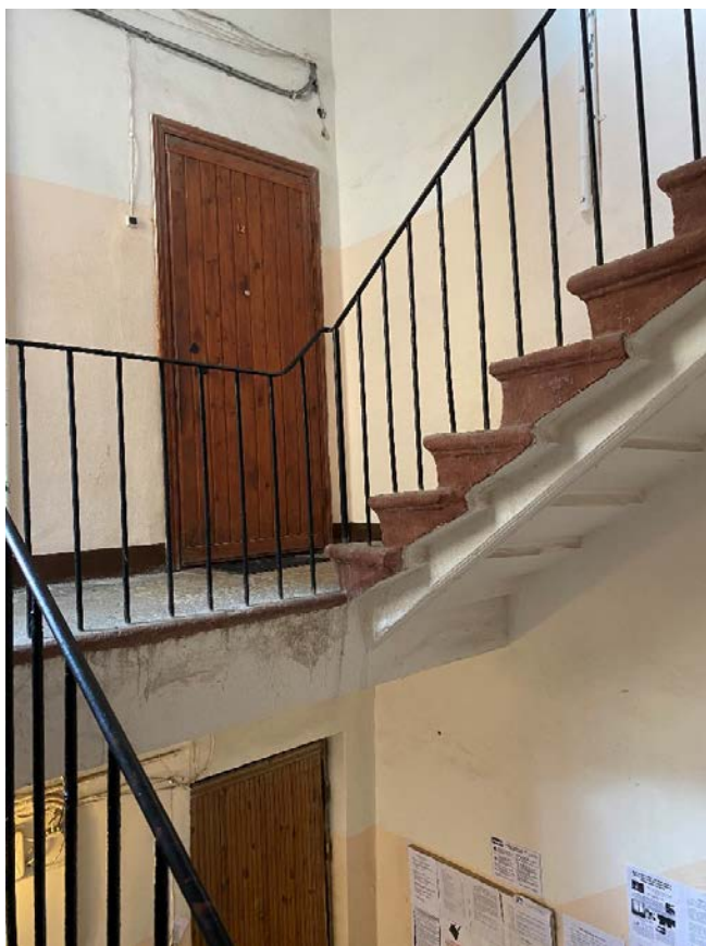
Фото 23. Лестничная клетка 2ЛК в уровне 2-го этажа.
