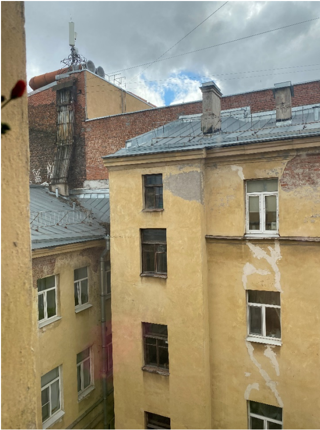
Фото 10. Фрагмент дворового фасада. Открытие кровли.
