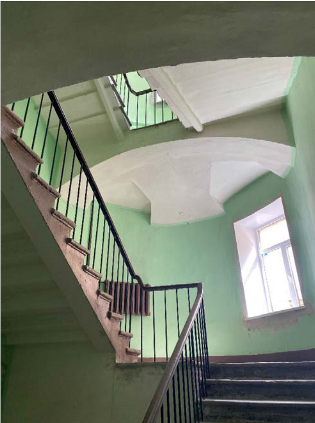
Фото 17. Лестничные площадки на уплощенных цилиндрических сводах, в том числе с распалубками.
