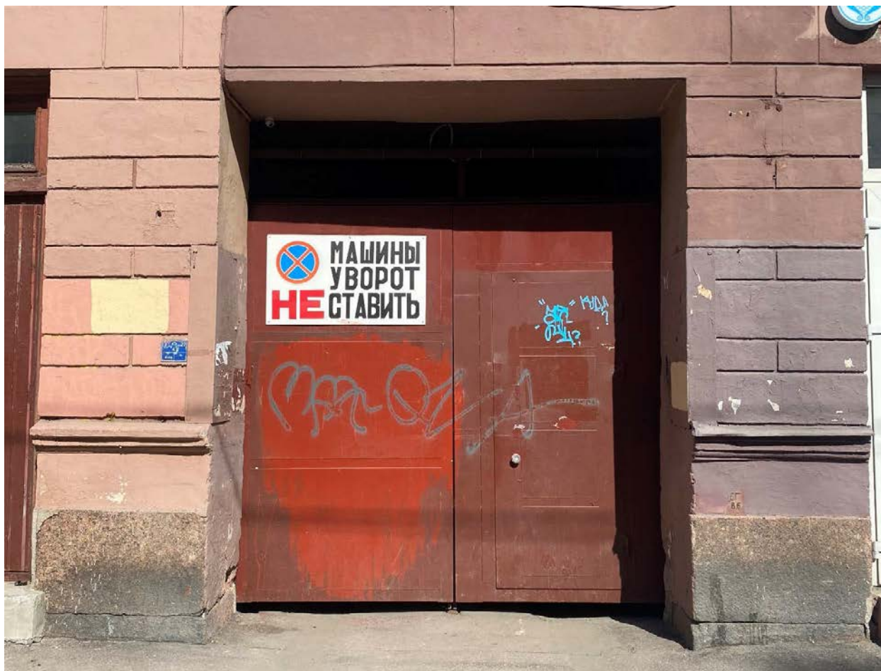
Фото 3. Воротный проезд прямоугольной конфигурации по центральной оси лицевого фасада с поздним металлическим заполнением.
