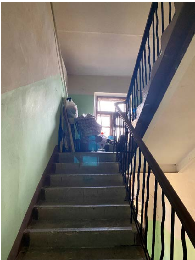
Фото 33. Лестничная клетка 4ЛК в уровне 4-го этажа.
