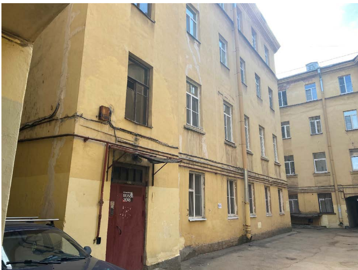
Фото 9. Юго-восточный дворовый фасад.
