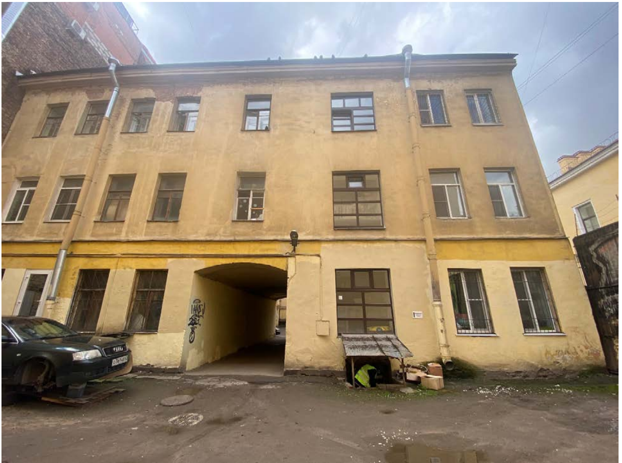
Фото 12. Восточный дворовый флигель.
