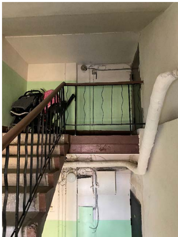
Фото 34. Лестничная клетка 4ЛК в уровне 4-го этажа.
