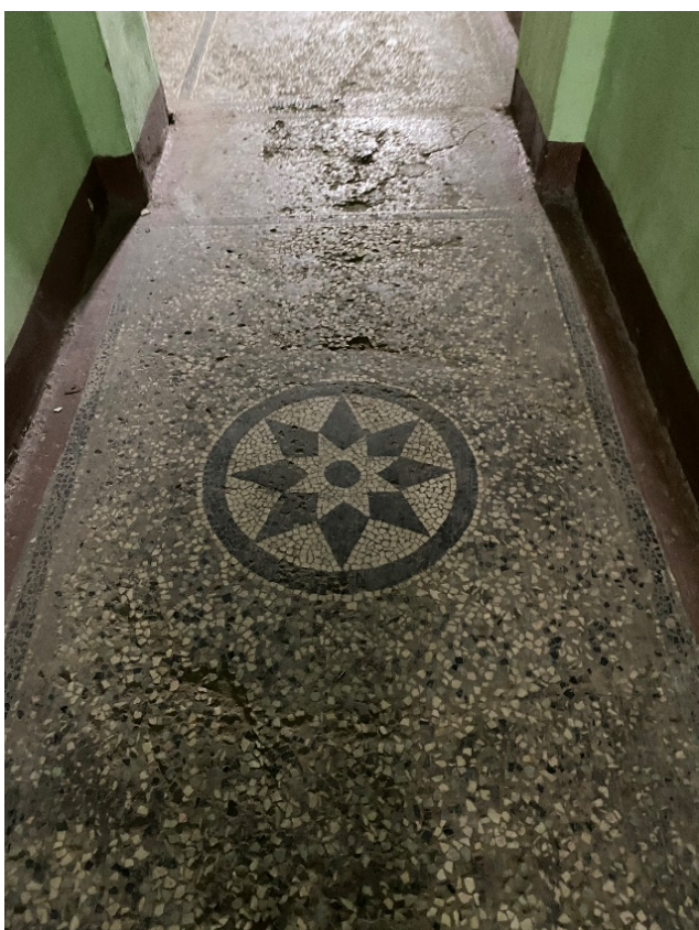
Фото 15. Покрытие пола вестибюля парадного входа в технике терраццо с рисунком в виде восьмиконечной звезды, вписанной в круг и бордюром по периметру.
