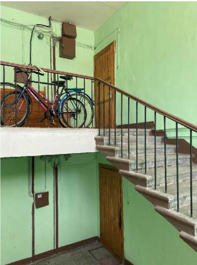
Фото 19. Лестничная клетка 1ЛК в уровне 4-го этажа.
