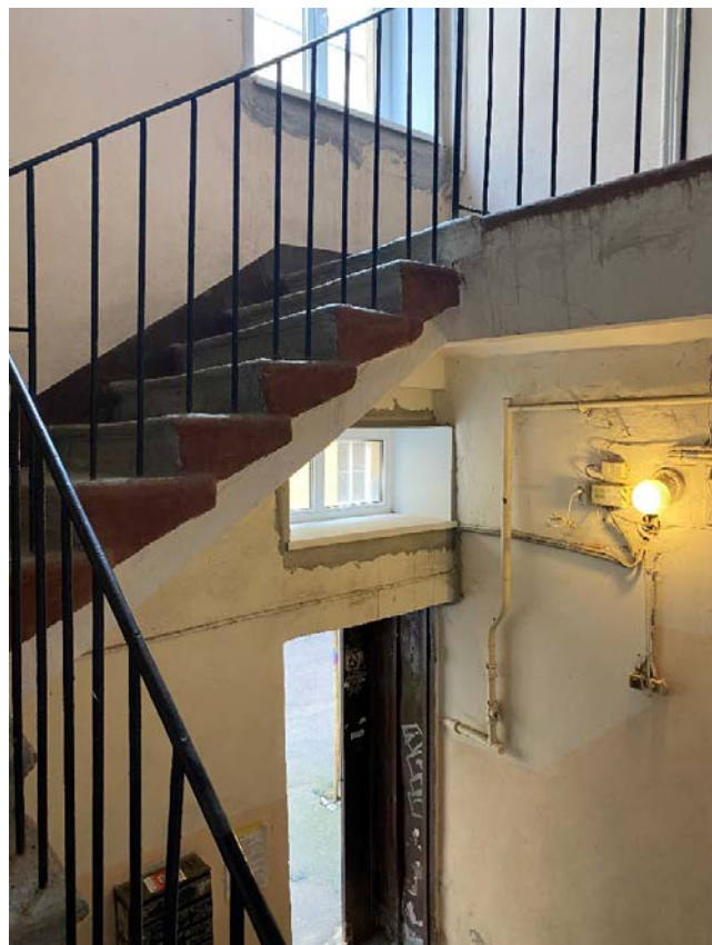
Фото 22. Лестничная клетка 2ЛК между 1-м и 2-м этажами.
