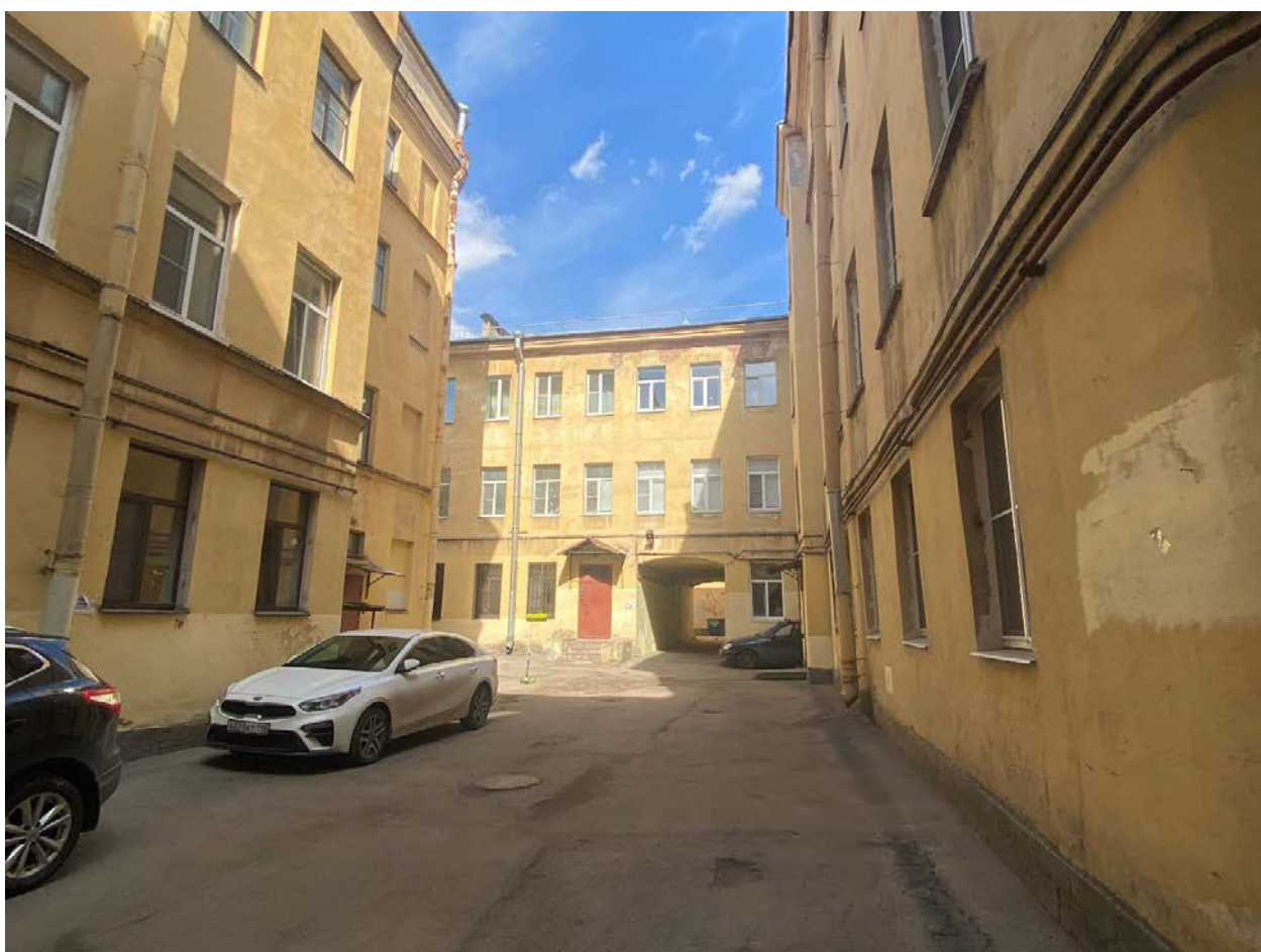
Фото 7. Юго-западный дворовый фасад.
