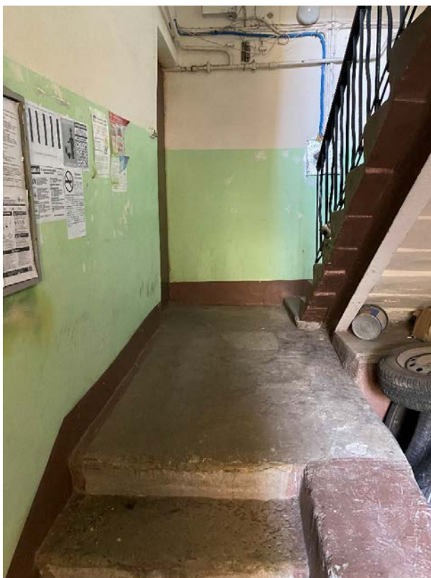
Фото 31. Лестничная клетка 4ЛК в уровне 1-го этажа.
