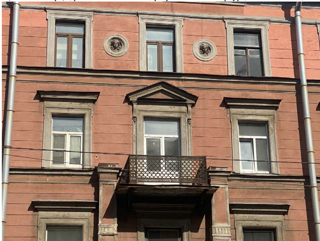
Фото 2. Центральная световая ось, акцентированная балконом на чугунных литых кронштейнах с кованым ограждением; балконный входной проем оформленный треугольным сандриком на каннелированных кронштейнах; два круглых медальона с горельефным изображением женских голов.
