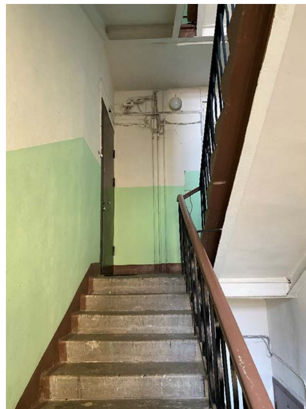
Фото 32. Общий вид типового этажа лестничной клетки 4ЛК.
