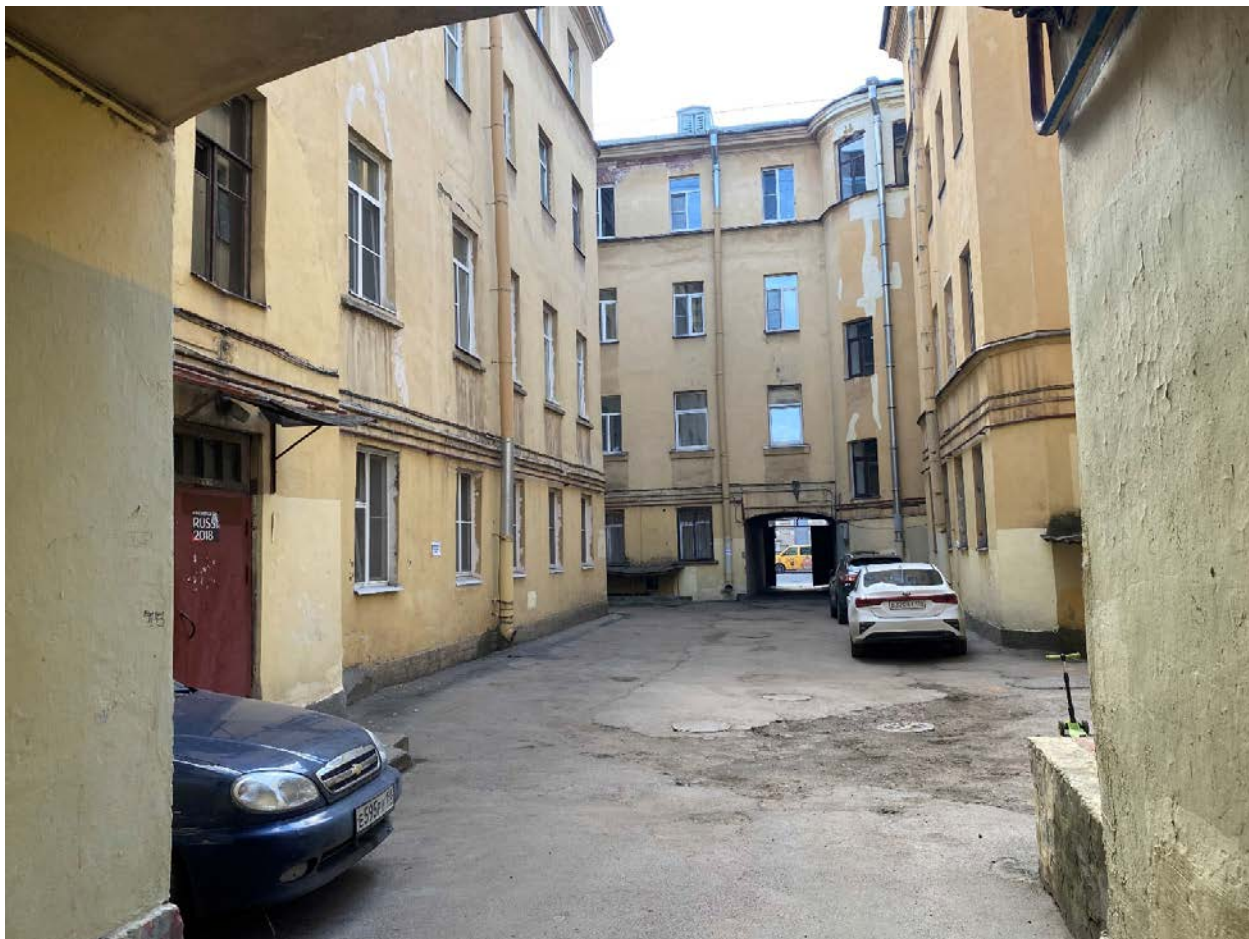
Фото 8. Северо-восточный дворовый фасад.
