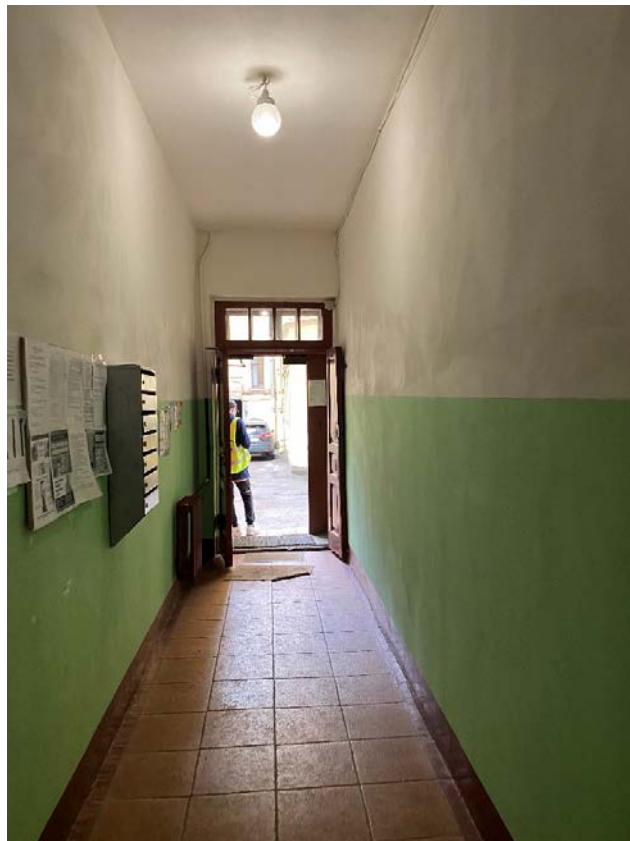
Фото 26. Вестибюль лестничной клетки ЗЛК.
