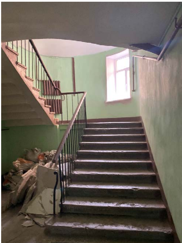
Фото 13. Лестничная клетка 1ЛК в уровне 1-го этажа.
