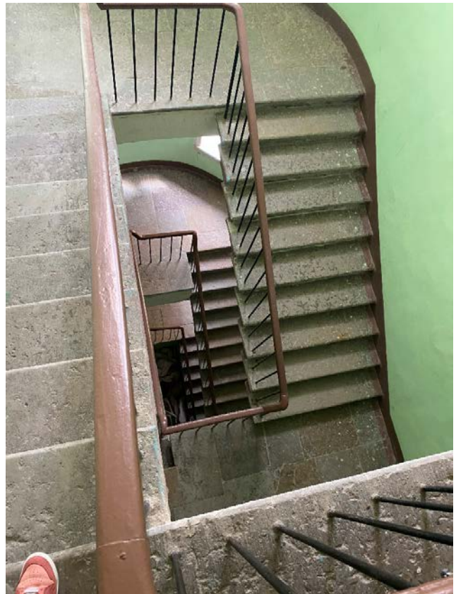
Фото 20. Общий вид лестничной клетки 1ЛК в уровне 4-го этажа.
