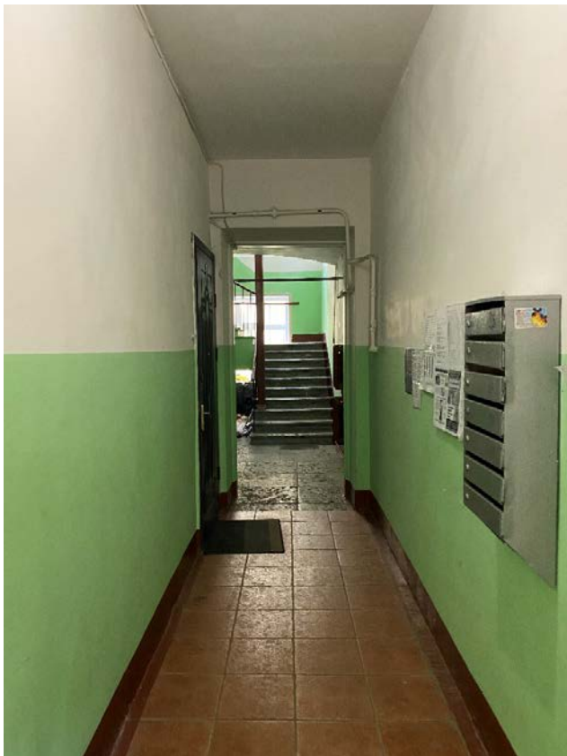
Фото 25. Вестибюль лестничной клетки ЗЛК.
