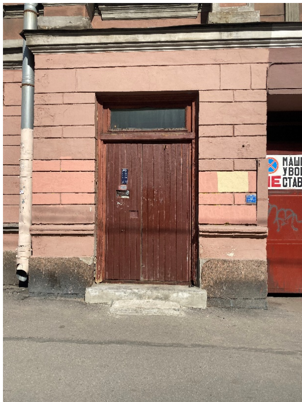
Фото 4. Дверной проем со стороны лицевого фасада с поздним деревянным заполнением.
