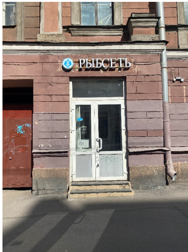
Фото 5. Дверной проем со стороны лицевого фасада с поздним металлопластиковым заполнением.
