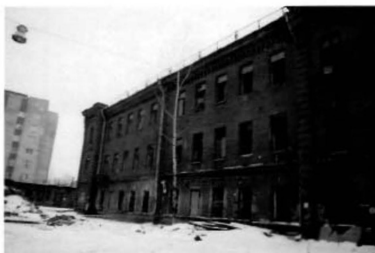
4. (Фрагмент восточного фасада)
