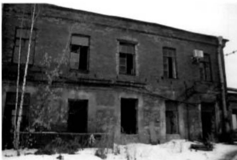
3. (Фрагмент южного фасада)
