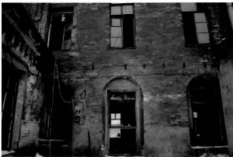
4. (Фрагмент южного фасада)
