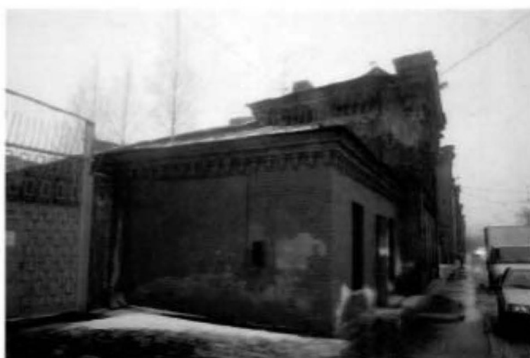
2. (Фрагмент северного фасада)
