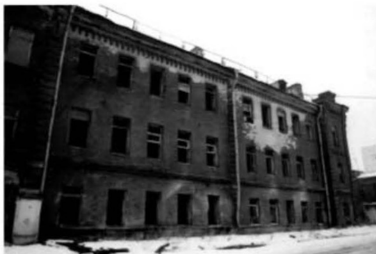
3. (Фрагмент восточного фасада)
