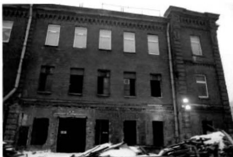
3. (Фрагмент восточного фасада)
