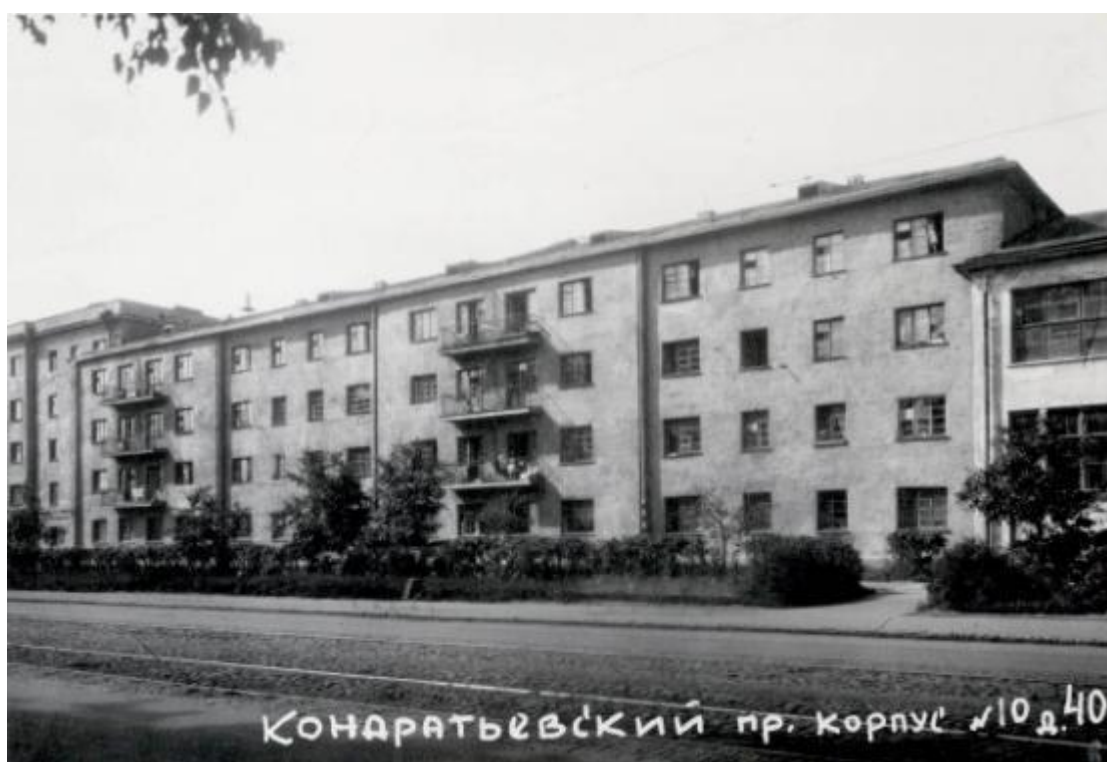
16. Корпус 10. Вид со стороны улицы. 1949 г. Фотография. ЦГА КФФД СПб. Гр-83200.
