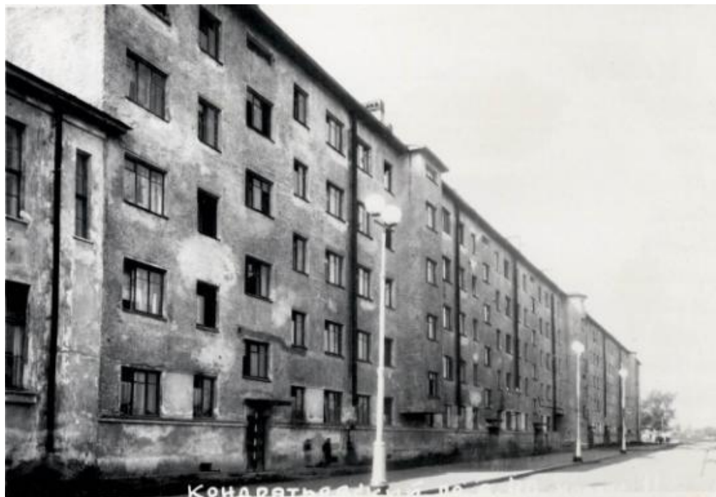
17. Корпус 11. Вид со стороны улицы. 1949 г. Фотография. ЦГА КФФД СПб. Гр-83201.
