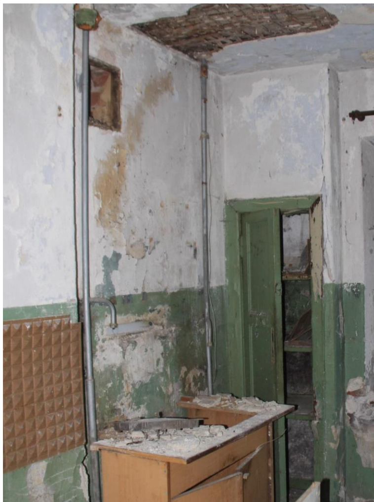
33. Здание по адресу: г. Санкт-Петербург, Кондратьевский пр., д. 40, литера А, корпус 7, являющееся частью объекта культурного наследия регионального значения «Жилые здания», входящее в состав объекта культурного наследия регионального значения «Кондратьевский жилмассив» (г. Санкт-Петербург, Калининский район, Кондратьевский пр., д. 40. На основании Распоряжения КГИОП от 27.02.2014 № 10-89). Фрагмент интерьера помещения третьего этажа.
