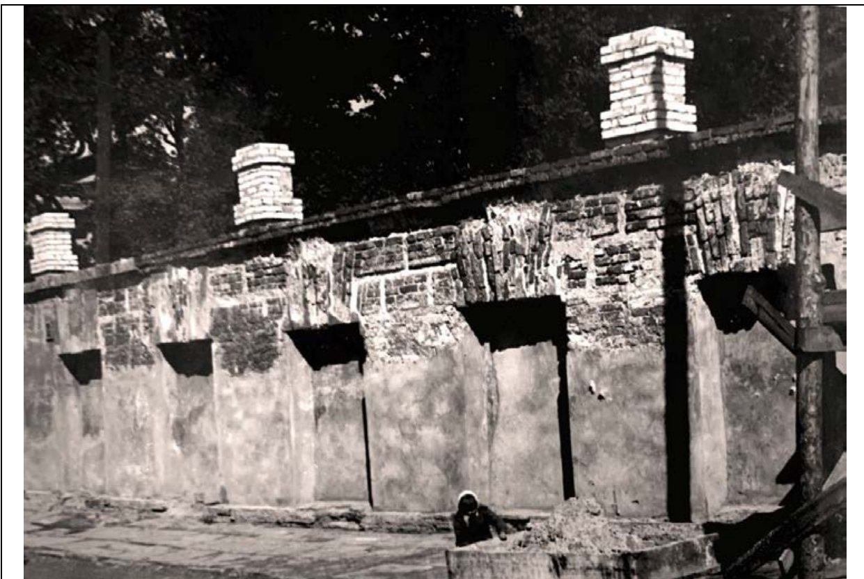
10. Архив КГИОП. Инв. № 56433. Дом Бобринских. Ограда по наб. Ново-Адмиралтейского канала. Восстановленные столбы, расчистка кладки стены. 1954 г.
