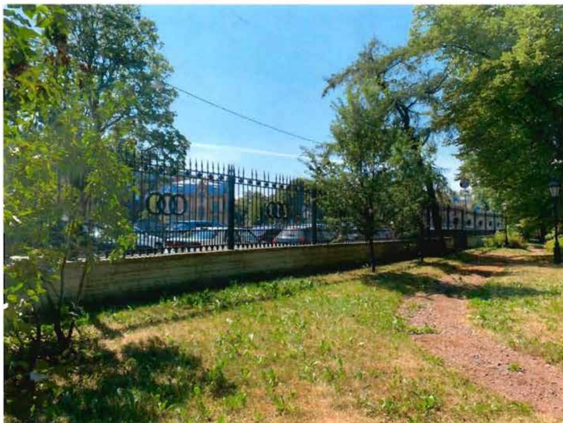
3. Фрагмент северного фасада объекта культурного наследия.
