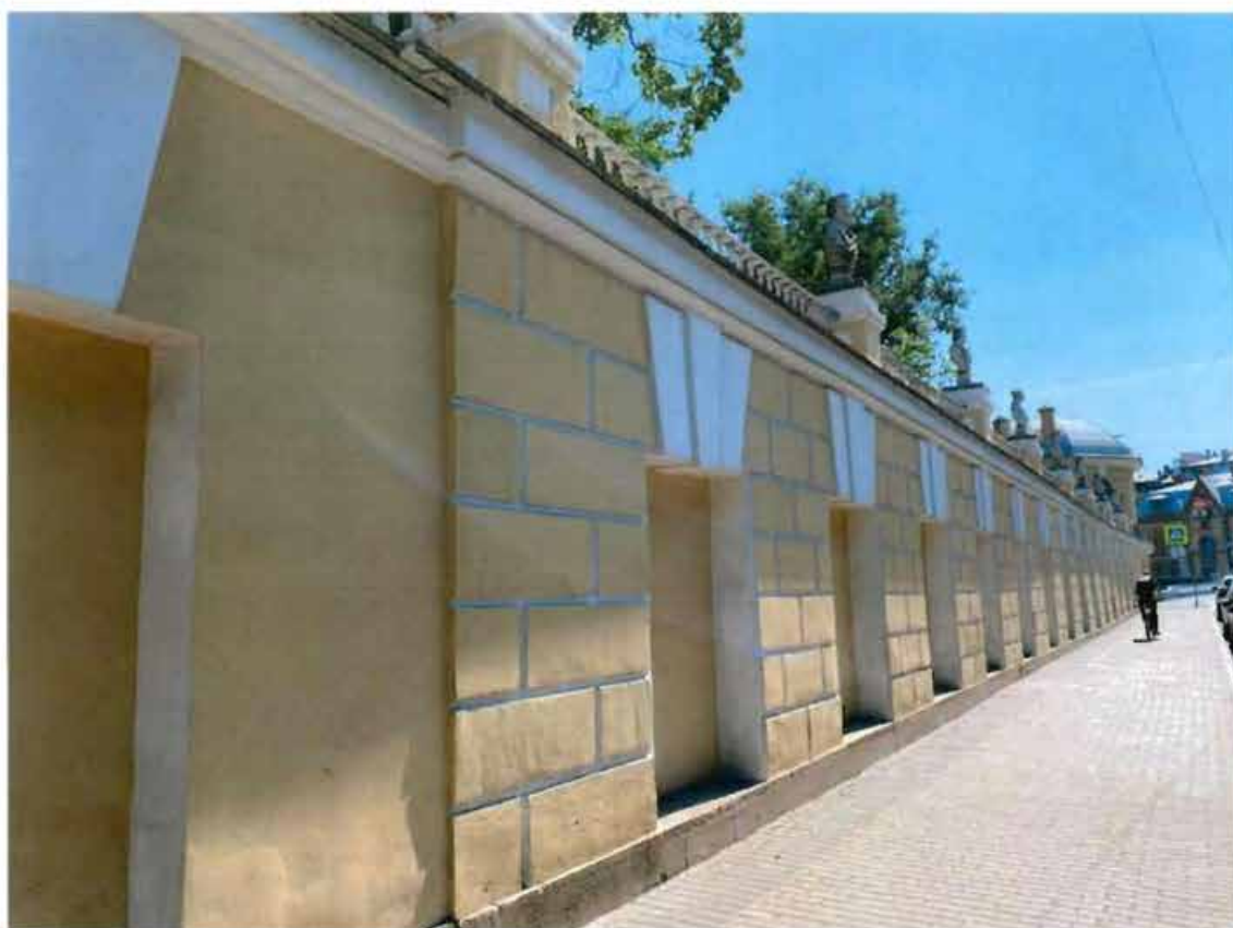
3. Фрагмент западного фасада объекта культурного наследия.
