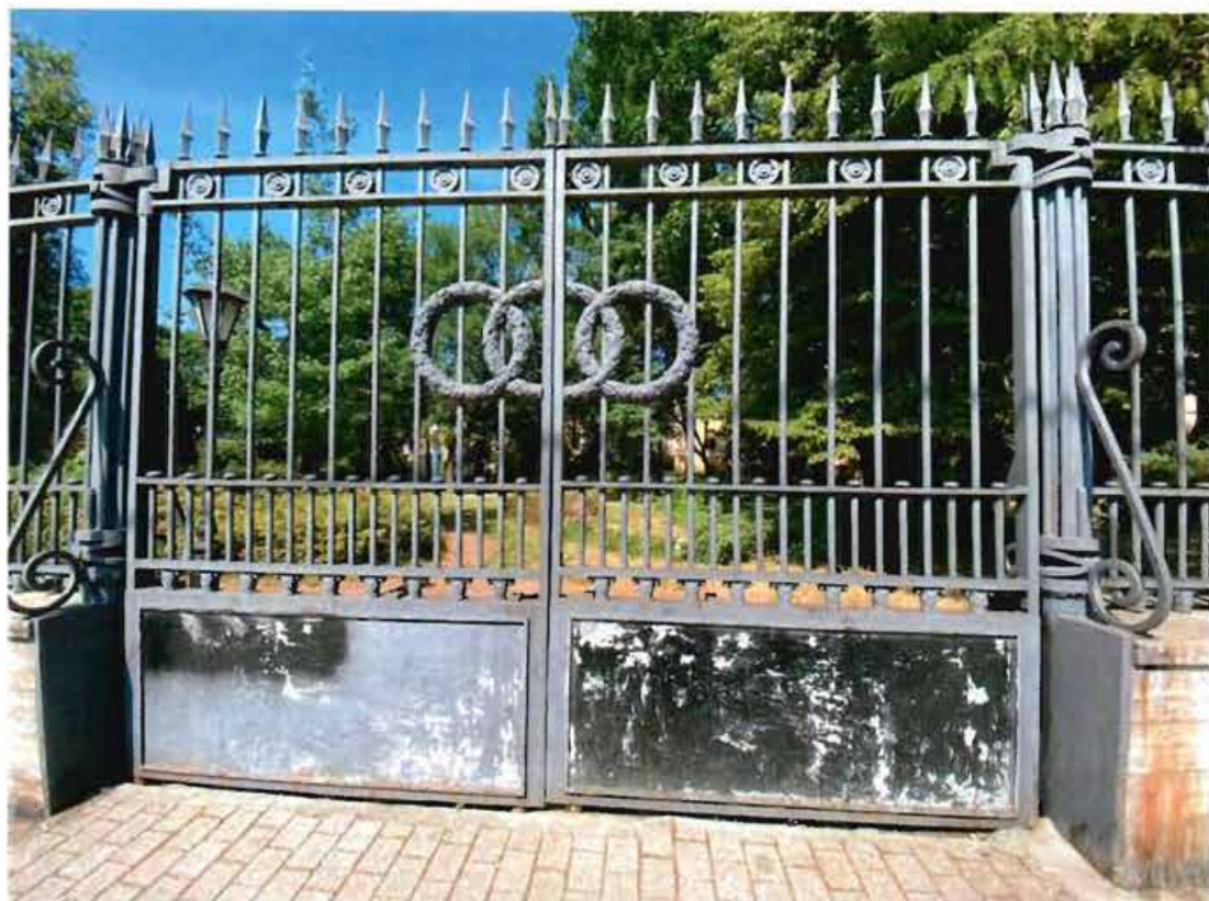
4. Общий вид ворот на южном фасаде объекта культурного наследия.
