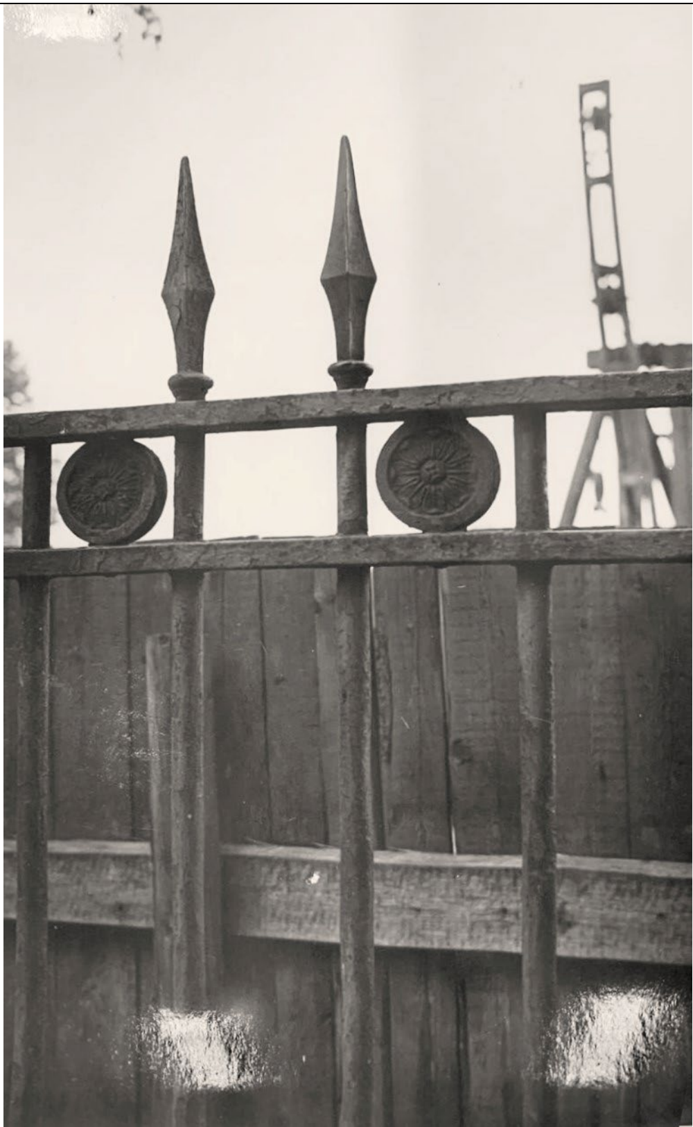
12. Архив КГИОП. Инв. № 58998-2. Ограда у сада дома Бобринских. Фрагмент верха решётки. 1958 г.
