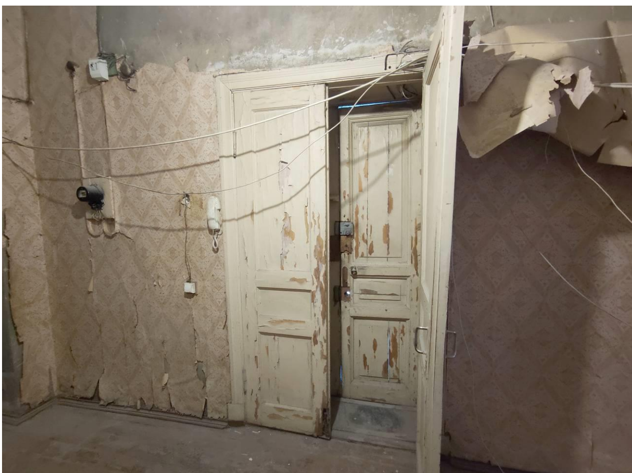
Фото 12. Интерьер квартиры, ч.п. 1. Вид на выход из квартиры
