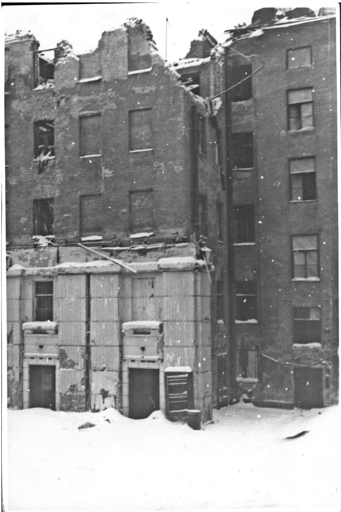
24. Театр имени ЛОСПС, разрушенный авиабомбой. 1941. Фотохроника ЛенТАСС ; № 41030 28 января 1944 г.
