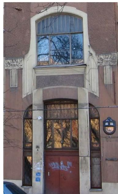
исторические оконные проемы – местоположение, габариты, конфигурация, включая проемы с лучковыми перемычками и тройные окна, вписанные в трехцентровую арку;\*
