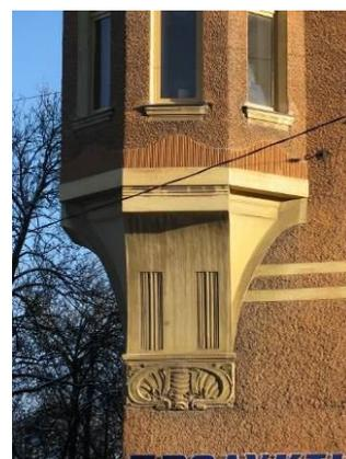
балконы – местоположение (в уровне 3-4-го этажей), габариты, конфигурация, конструкция - на оштукатуренных кронштейнах;
