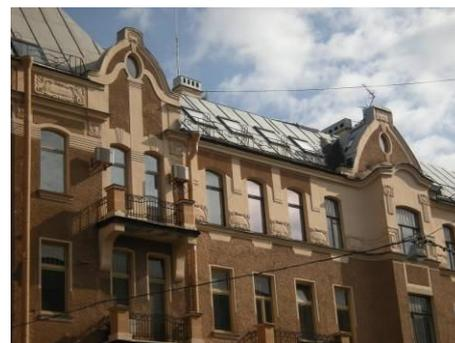
элементы архитектурно-художественного решения лицевых фасадов: оформление простенков фигурными филенками с заполнением рифленой штукатуркой (межконные простенки 1-го этажа) и штукатуркой «внабрызг» (надоконные простенки 1-го этажа); рельефные картуши в межконных простенках 4-го этажа;
