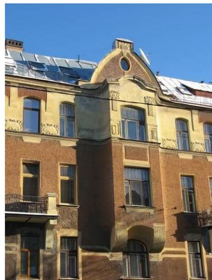
угловой граненый эркер в уровне 3-4-го этажей, завершенный башенкой с граненым куполом со шпилем, с основанием, врезанным в угловое сопряжение фасадов, декорированным рельефным орнаментом в стиле модерн;
