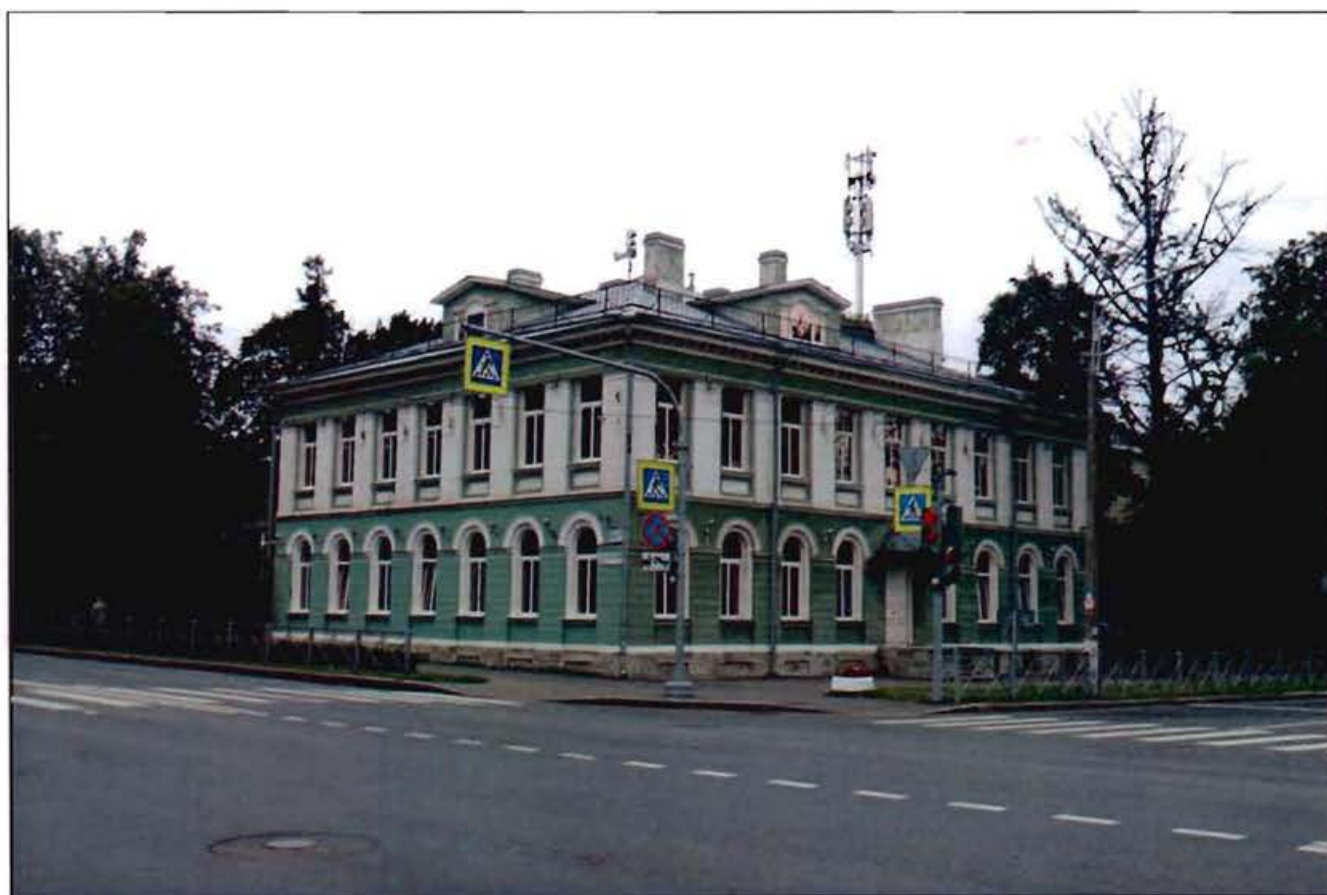
1. Общий вид с юго-востока.
