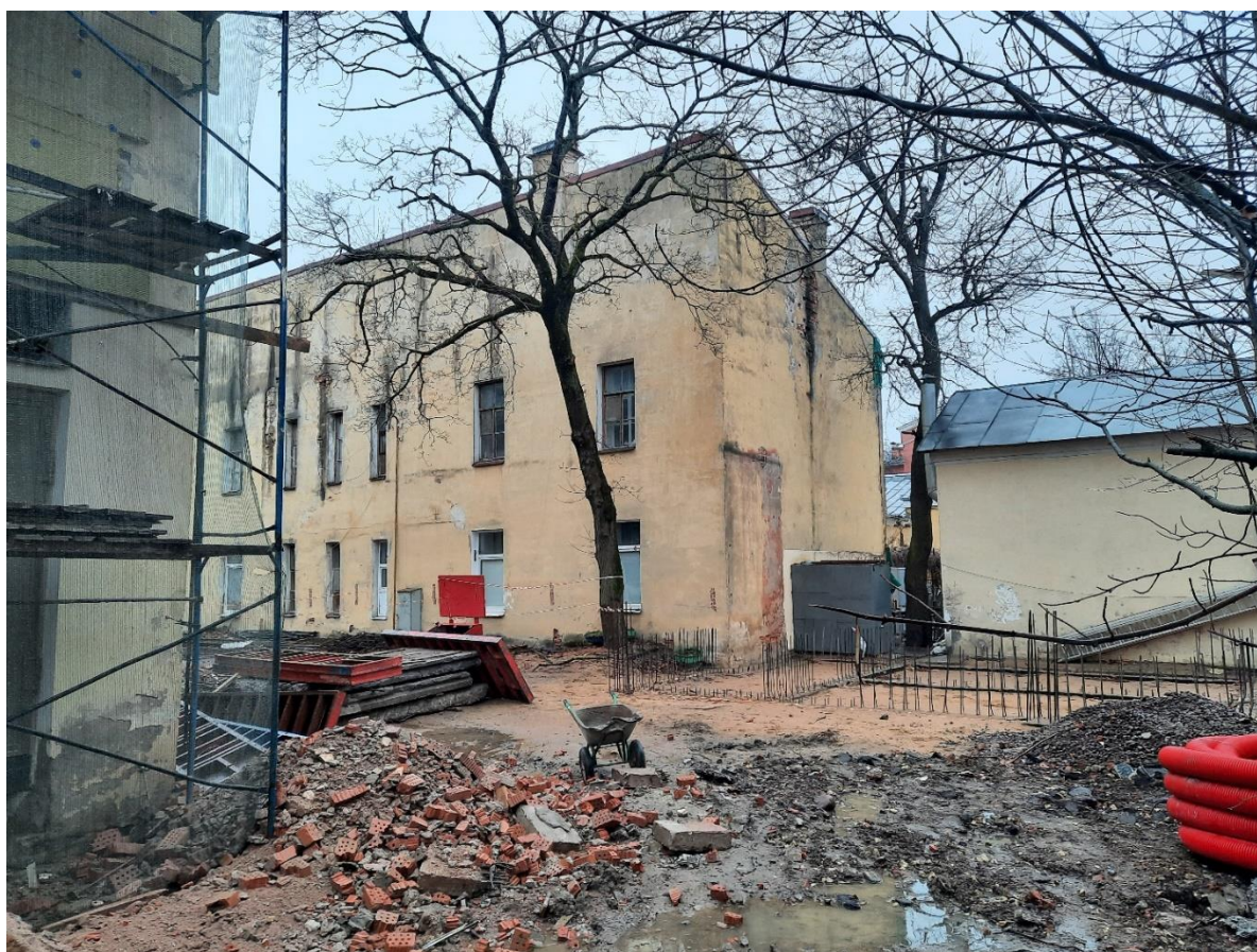
Фото 4. Реконструируемое здание по адресу: г. Санкт-Петербург, город Петергоф, улица Аврова, дом 5, литера Б. Дата фотосъемки: 1 декабря 2021 г.
