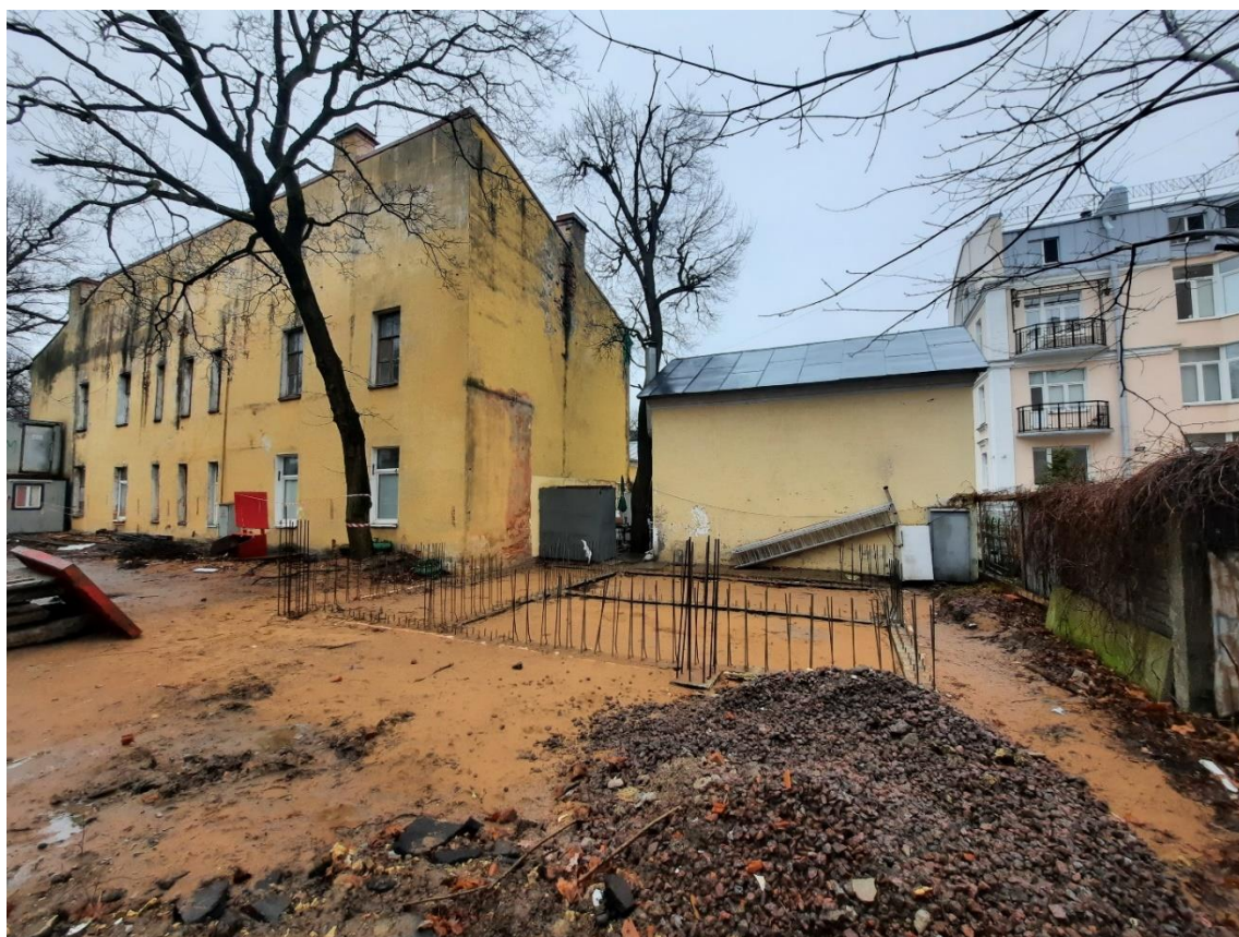
Фото 1. Реконструируемое здание по адресу: г. Санкт-Петербург, город Петергоф, улица Аврова, дом 5, литера Б и объект культурного наследия федерального значения «Почта». Дата фотосъемки: 1 декабря 2021 г.
