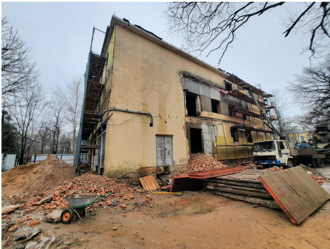
Фото 3. Место предполагаемого устройства временной переходной галереи. Дата фотосъемки: 1 декабря 2021 г.
