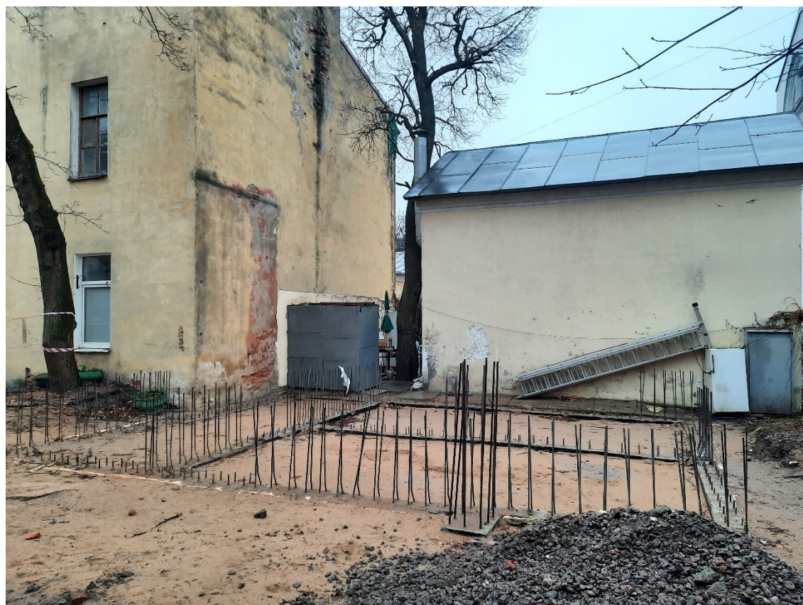
Фото 2. Реконструируемое здание по адресу: г. Санкт-Петербург, город Петергоф, улица Аврова, дом 5, литера Б. Дата фотосъемки: 1 декабря 2021 г.
