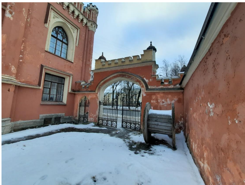
Фото 11. Объект культурного наследия федерального значения «Почта», расположенный по адресу г. Санкт-Петербург, г. Петергоф, Санкт-Петербургский пр., д. 15, лит. А, Б, В, Д (в составе: «Главный корпус», «Флигели (три)», «Ограда с воротами»). Ограда. Северный фасад. Дата фотосъемки: 25 декабря 2022 г.
