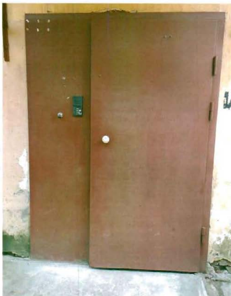
16. Дверное заполнение западного фасада.
