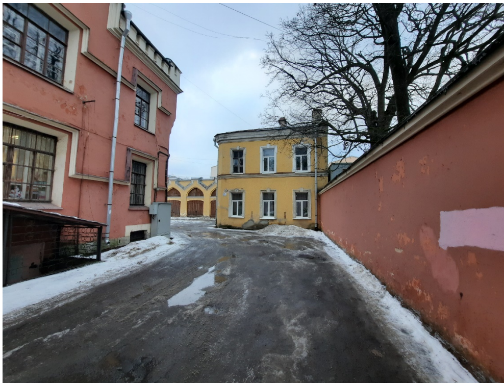
Фото 13. Объект культурного наследия федерального значения «Почта», расположенный по адресу г. Санкт-Петербург, г. Петергоф, Санкт-Петербургский пр., д. 15, лит. А, Б, В, Д (в составе: «Главный корпус», «Флигели (три)», «Ограда с воротами»). Флигель (литера Б). Южный фасад. Дата фотосъемки: 25 декабря 2022 г.
