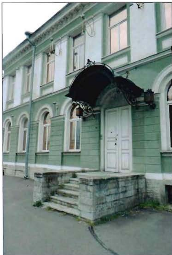
5. Восточный фасад. Фрагмент. Главный вход
