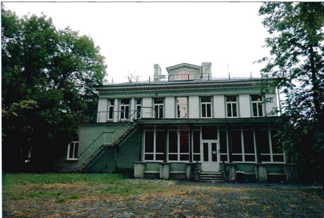
4. Западный фасад. Общий вид.
