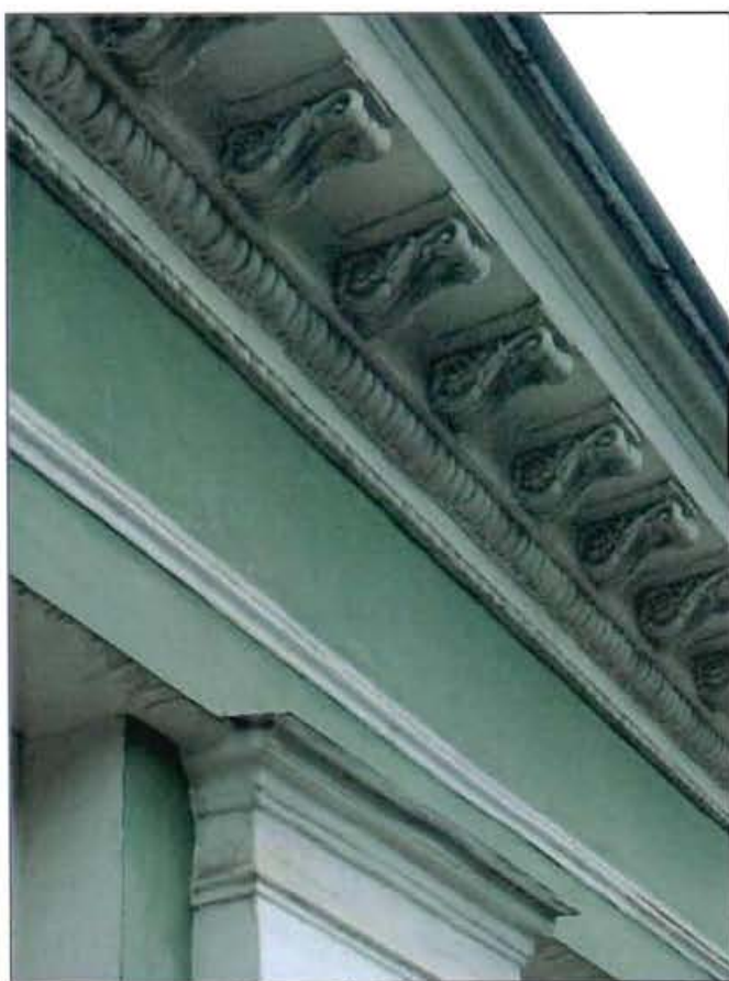
6. Западный фасад. Фрагмент. Венчающий карниз.
