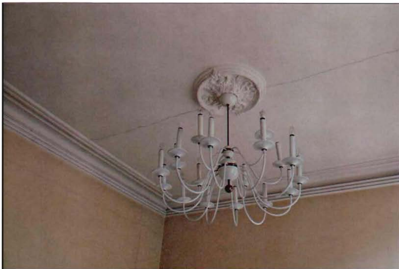
9. Интерьер. Фрагмент. Оформление потолка помещения лестницы.
