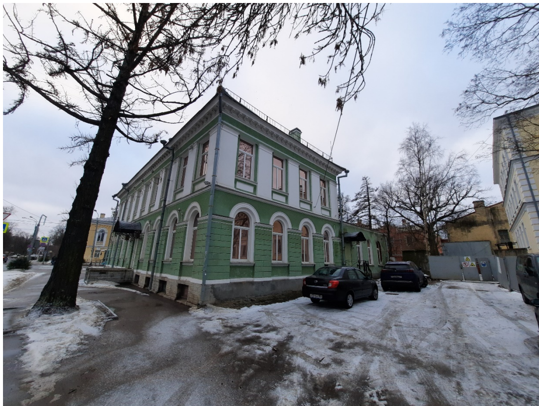
Фото 5. Объект культурного наследия регионального значения «Дом командира Уланского полка», расположенный по адресу г. Санкт-Петербург, г. Петергоф, Санкт-Петербургский пр., д. 13, ул. Аврова, д. 7. Вид с севера. Дата фотосъемки: 25 декабря 2022 г.
