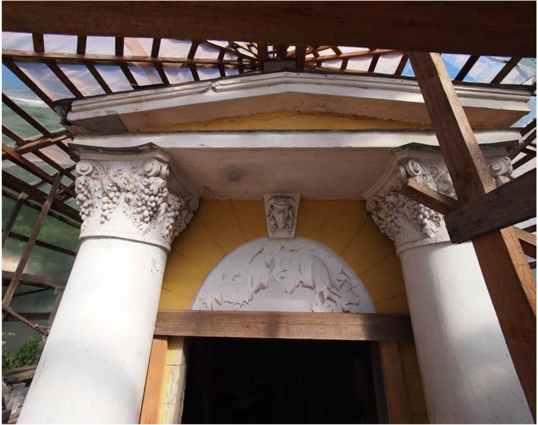
Фото 6. Фрагмент портика входа с треугольным фронтоном на колоннах композитного ордера (исторический антаблемент трапециевидной формы с надписью фирмы Бодо Эгесторф утрачен). 20.09.2022 г.
