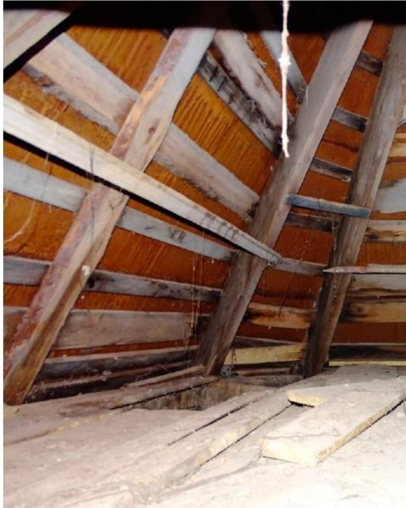
Фото 31. Фрагмент стропильной системы крыши (деревянные конструкции позднейшие). 20.09.2022 г.
