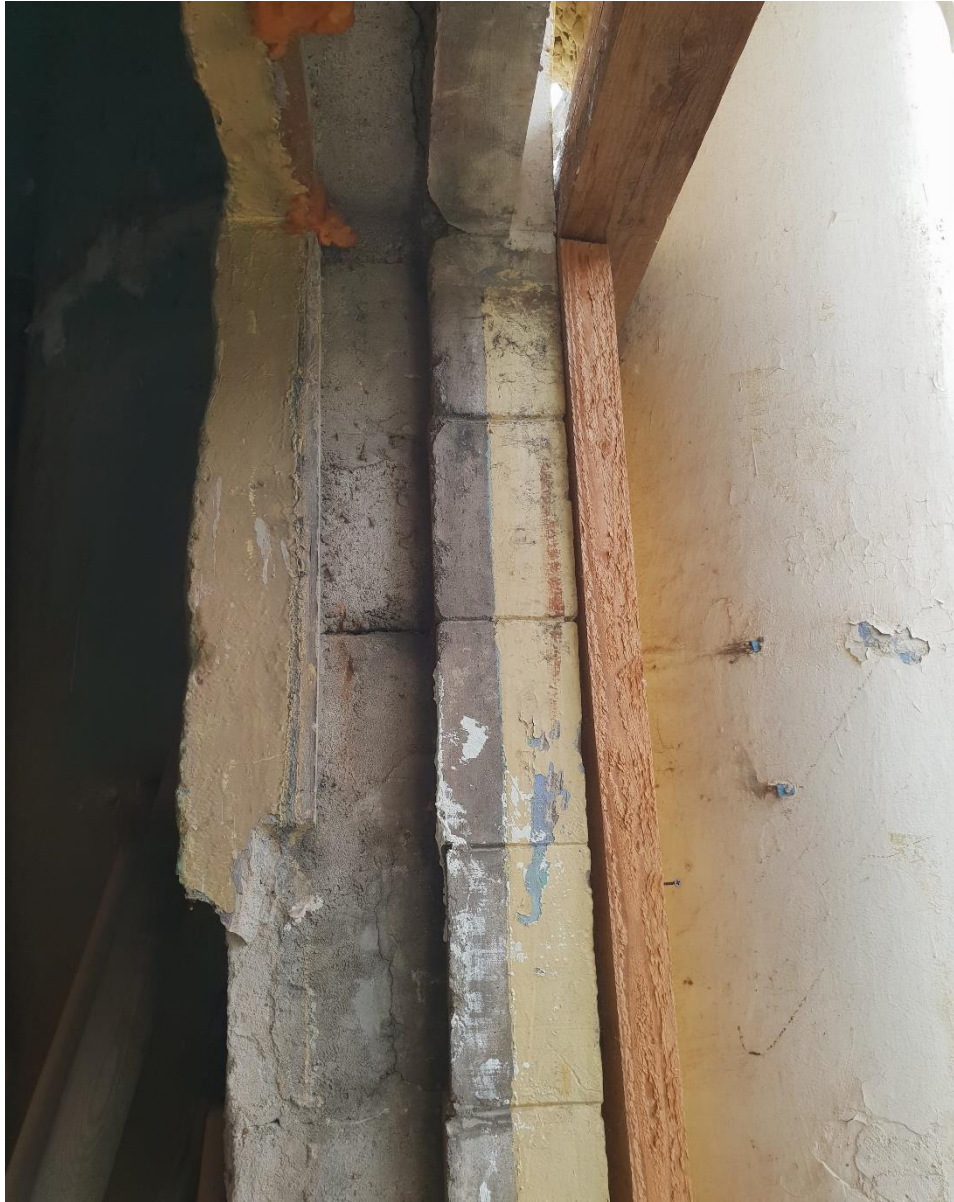
Фото 17. Фрагмент дверного проема северо-западного фасада с временным усилением деревянными элементами. 20.09.2022 г.
