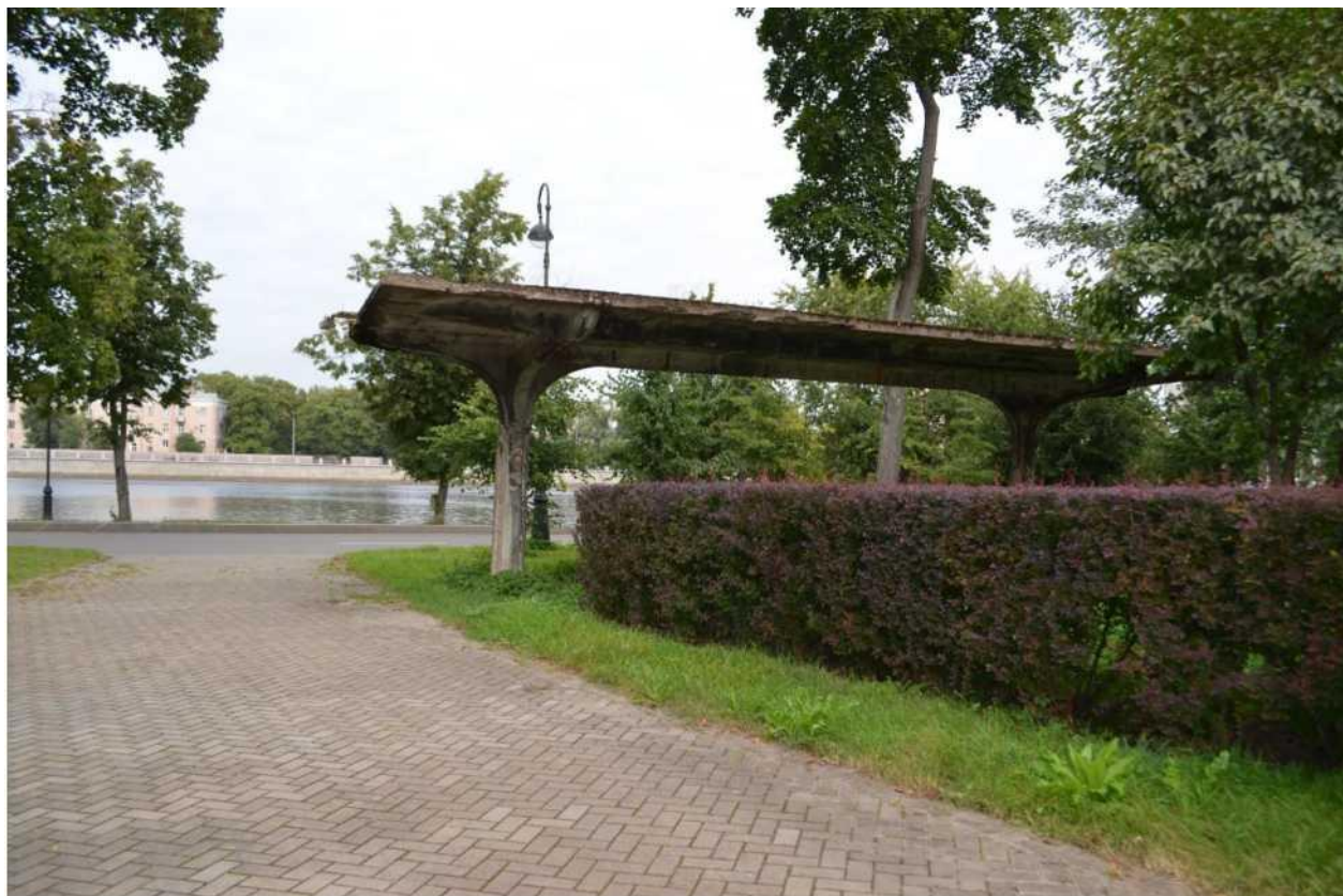
Фото 01. Вид на Железобетонный навес. Дата фотофиксации 20.09.2022 г
