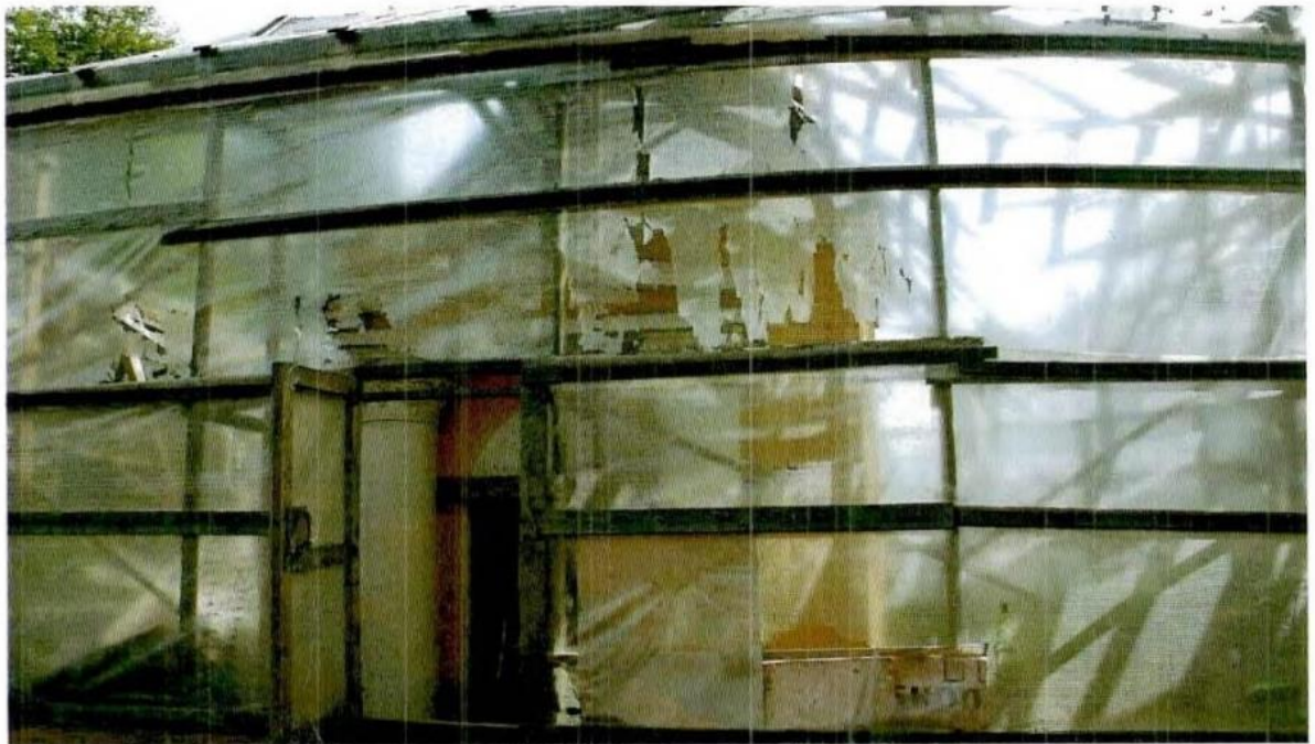
Фото №2. «Железобетонная беседка».
