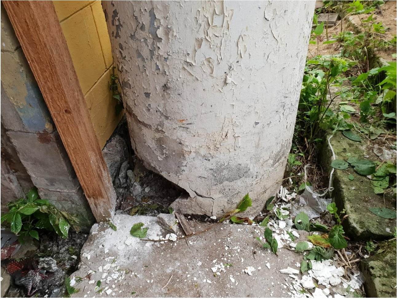
Фото 10. Фрагмент колонны портика входа со стороны северо-западного фасада. 20.09.2022 г.
