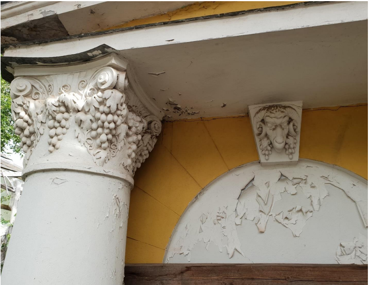
Фото 11. Фрагмент колонны композитного ордера, полуциркульный тимпан над дверным проемом, замковый камень с букранием (в виде головы овна). 20.09.2022 г.
