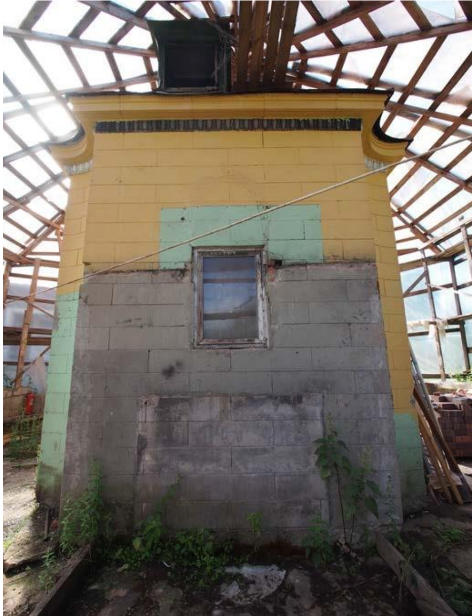
Фото 4. Юго-восточный фасад. Поздний оконный проем прямоугольной конфигурации (исторический проем овального очертания утрачен) 20.09.2022 г.
