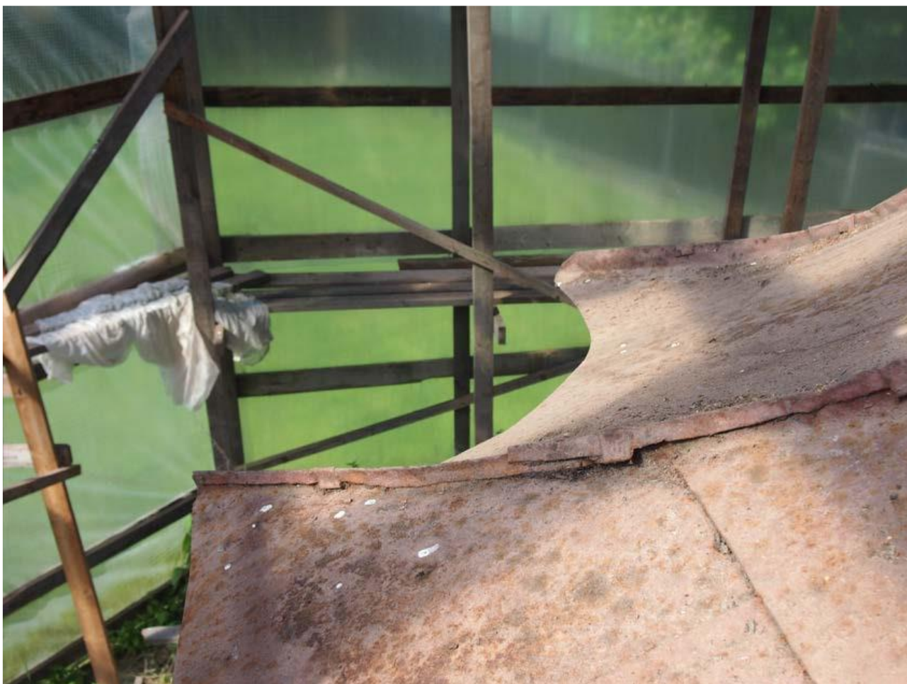
Фото 32. Фрагмент металлического покрытия крыши (тип соединения картин – одинарный стоячий фальц). 20.09.2022 г.
