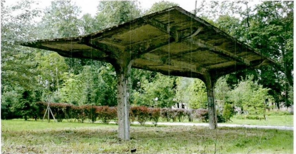
Фото №1. «Железобетонный навес товарищества "Железо-бетон"».
