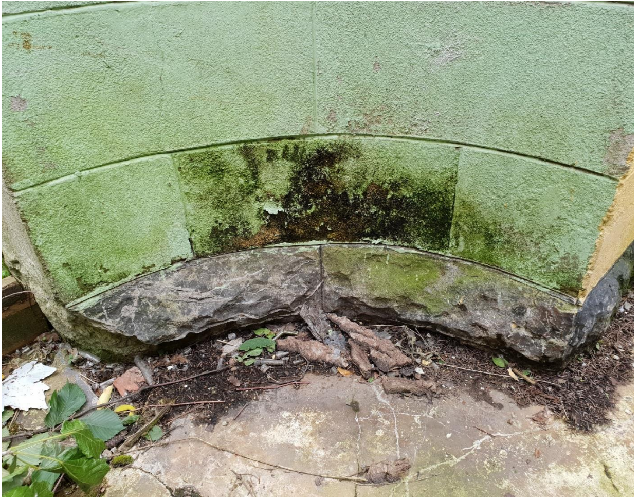
Фото 14. Фрагмент участка цоколя. 20.09.2022 г.
