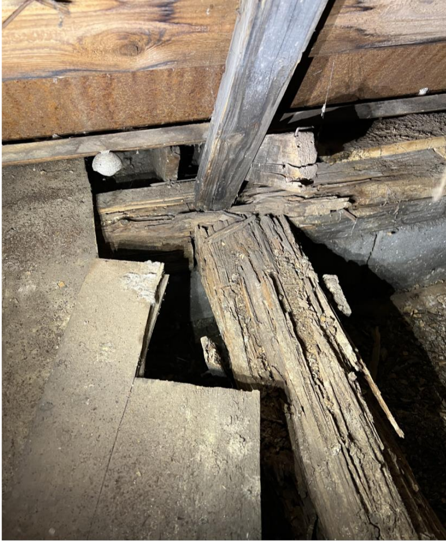
Фото 30. Участок перекрытия беседки. Доштовое по деревянным балкам (позднейшее). 20.09.2022 г.
