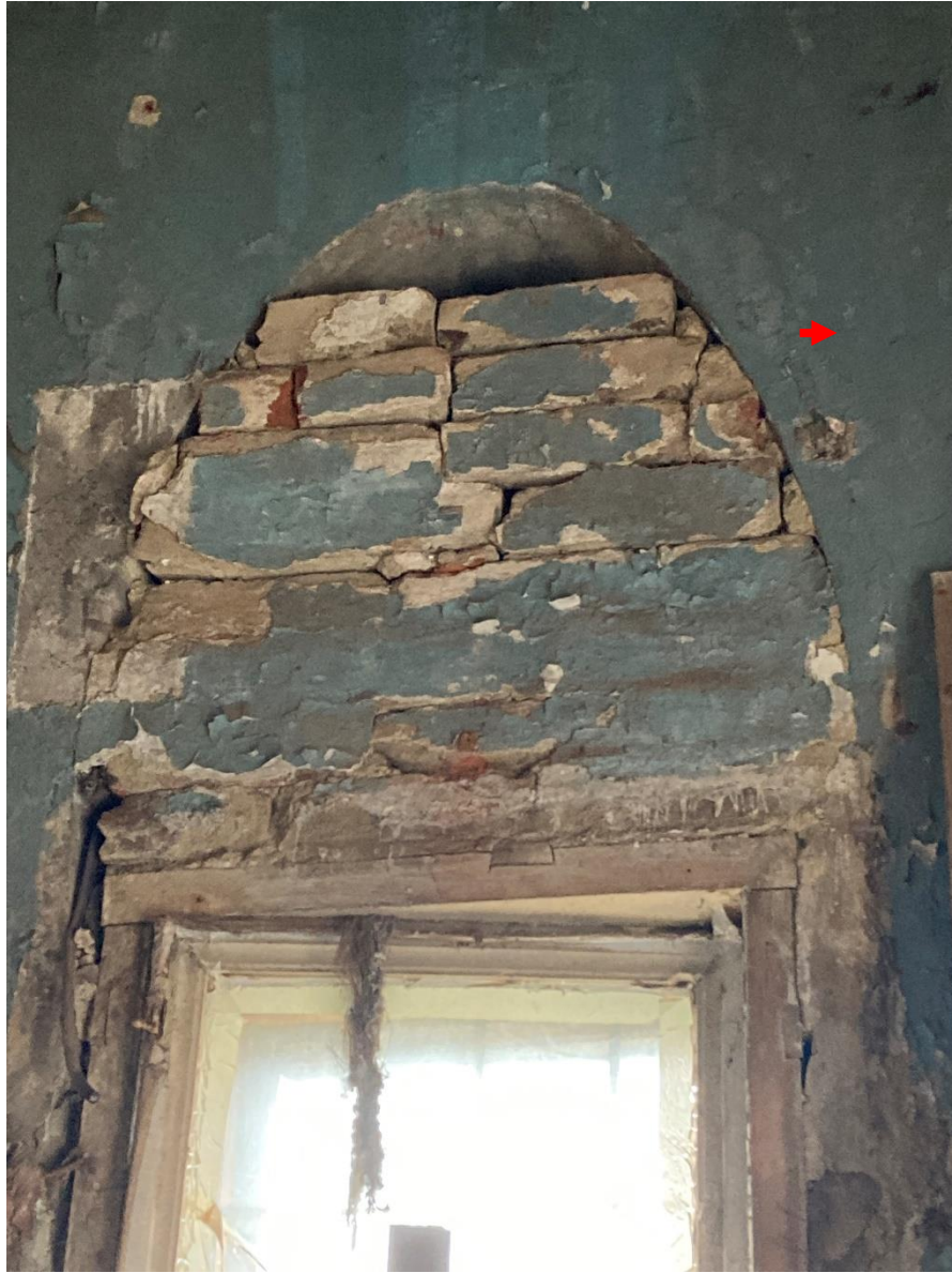
Фото 27. Фрагмент участка стены с закладкой кирпичом исторического оконного проема овального очертания. 20.09.2022 г.
