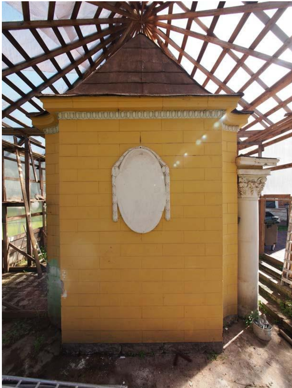
Фото 3. Северо-восточный фасад. Исторический оконный проем овального очертания заложен и оформлен в виде штукатурного медальона в обрамлении лепного декора. 20.09.2022 г.
