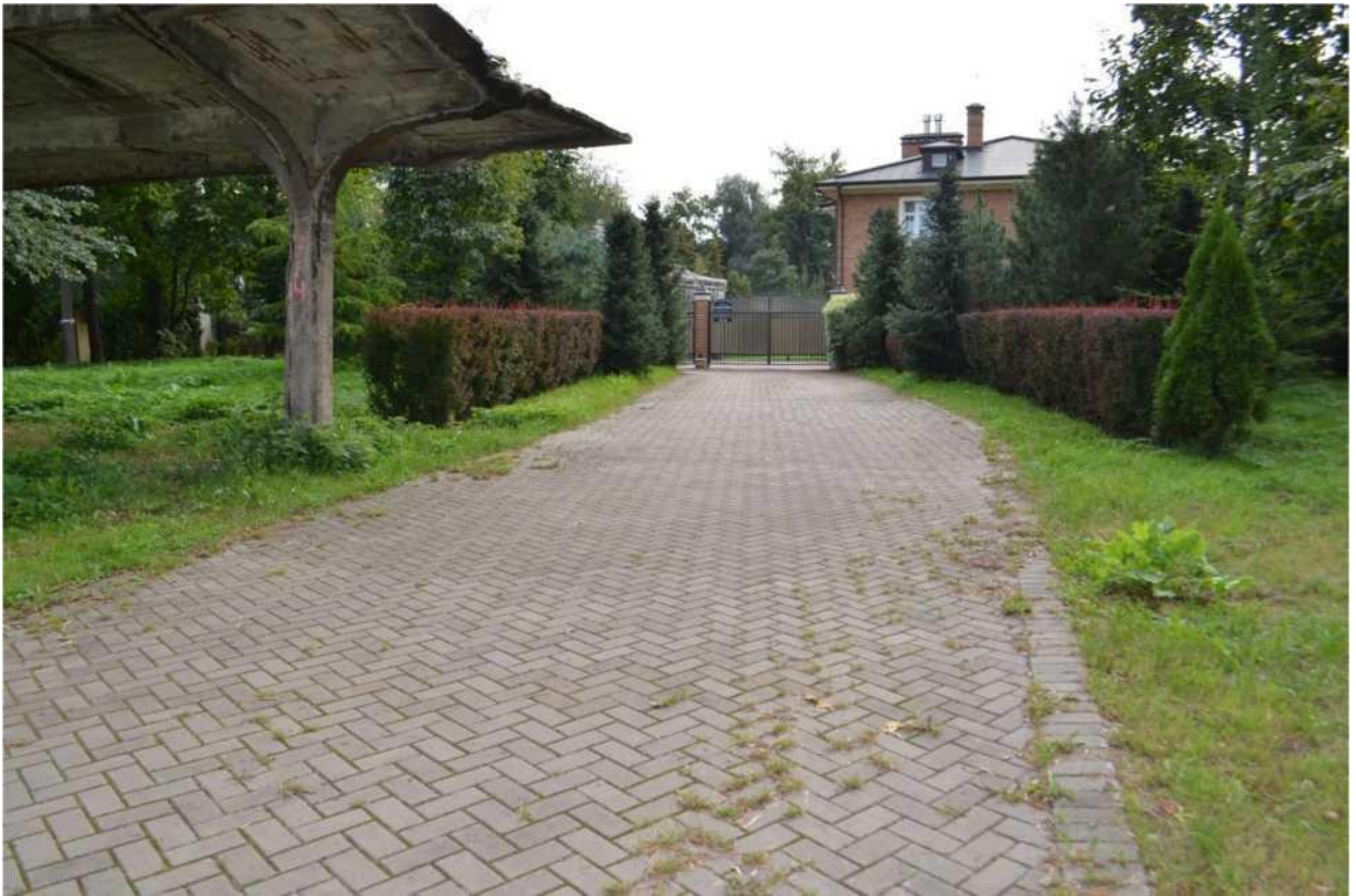
Фото 03. Вид на Железобетонный навес и пешеходную дорожку. Дата фотофиксации. 20.09.2022 г.
