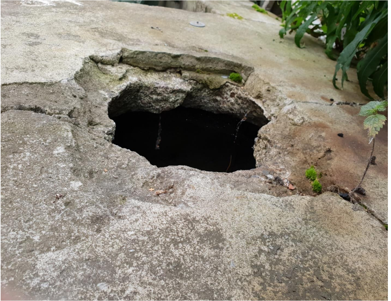
Фото 23. Фрагмент бетонной скамейки. 20.09.2022 г.
