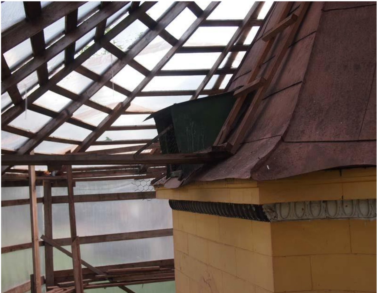
Фото 18. Фрагмент крыши (юго-восточный фасад) со слуховым окном. 20.09.2022 г.
