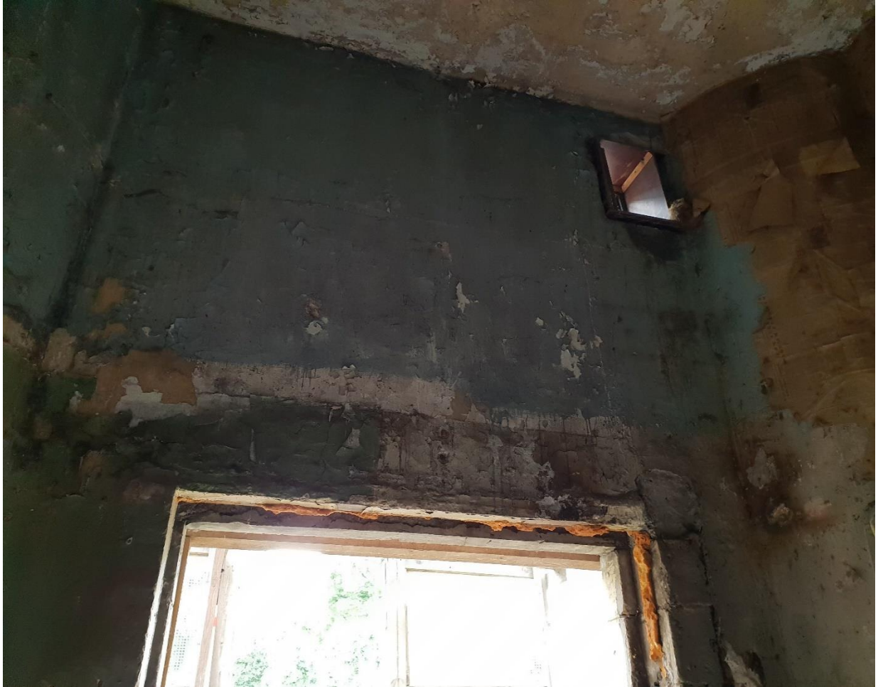
Фото 24. Фрагмент помещения. Стена с дверным проемом. 20.09.2022 г.
