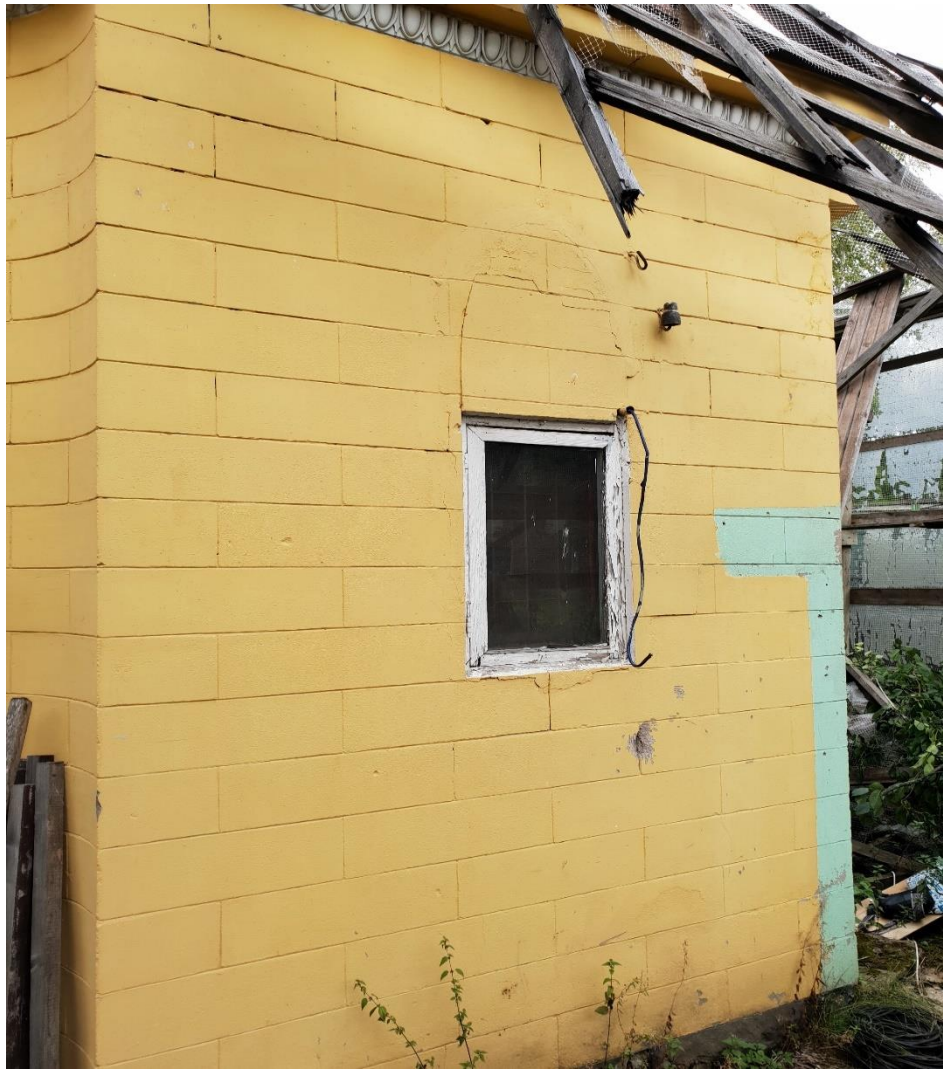
Фото 5. Юго-западный фасад. Поздний оконный проем прямоугольной конфигурации (исторический проем овального очертания утрачен) 20.09.2022 г.
