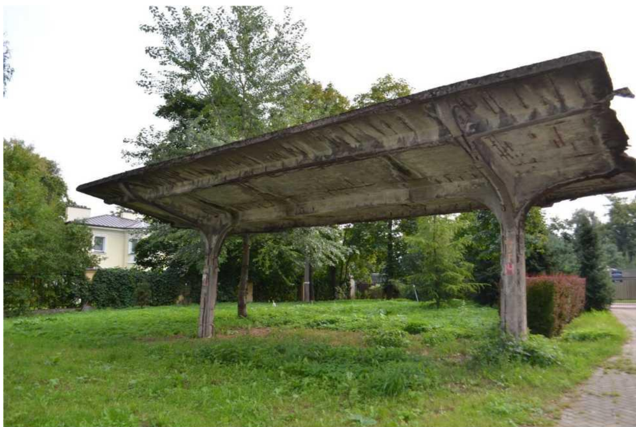
Фото 02. Вид на Железобетонный навес. Дата фотофиксации 20.09.2022 г.
