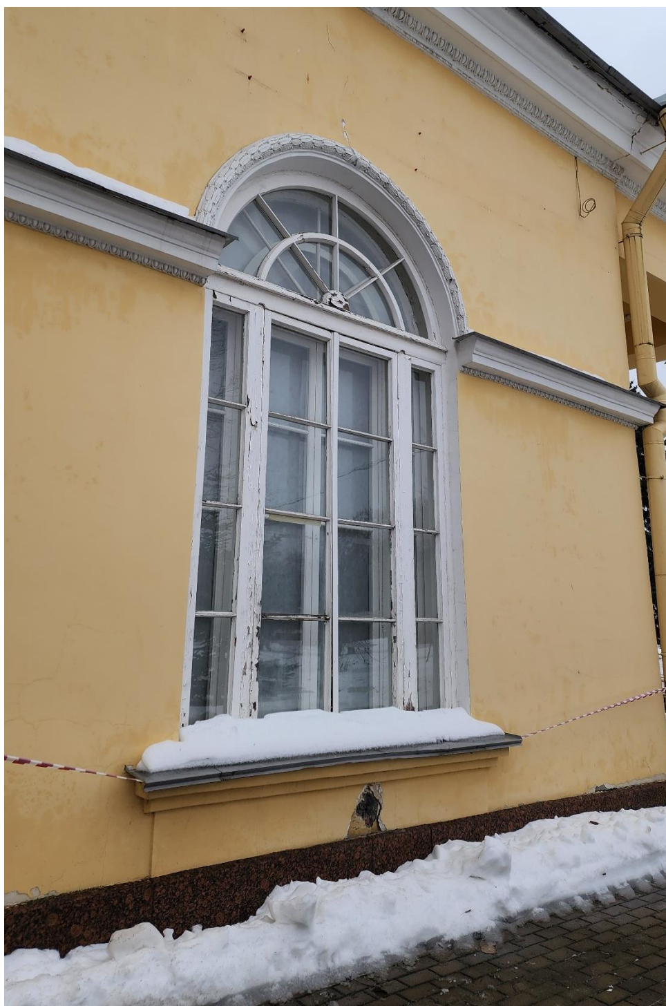
Фото 7. Западный фасад. Оконное заполнение.
