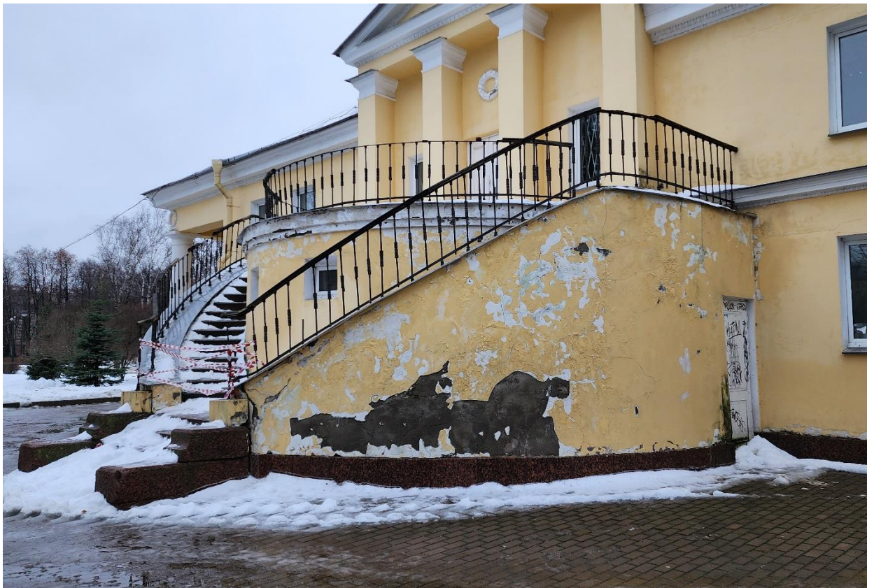
Фото 2. Южный фасад. Распашная лестница.
