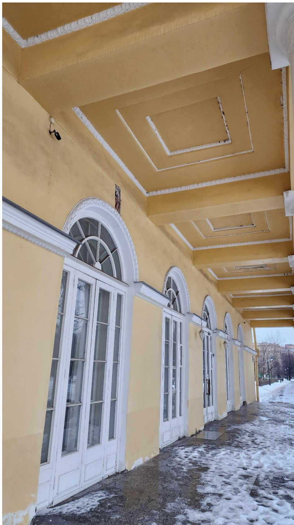
Фото 10. Дверные и оконные проемы северного фасада.
