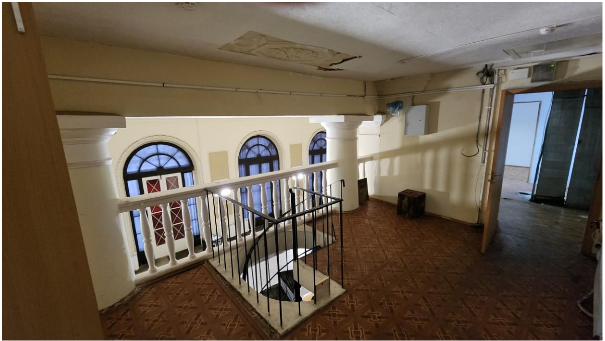
Фото 20. Помещение № 16. Вид на лестницу.
