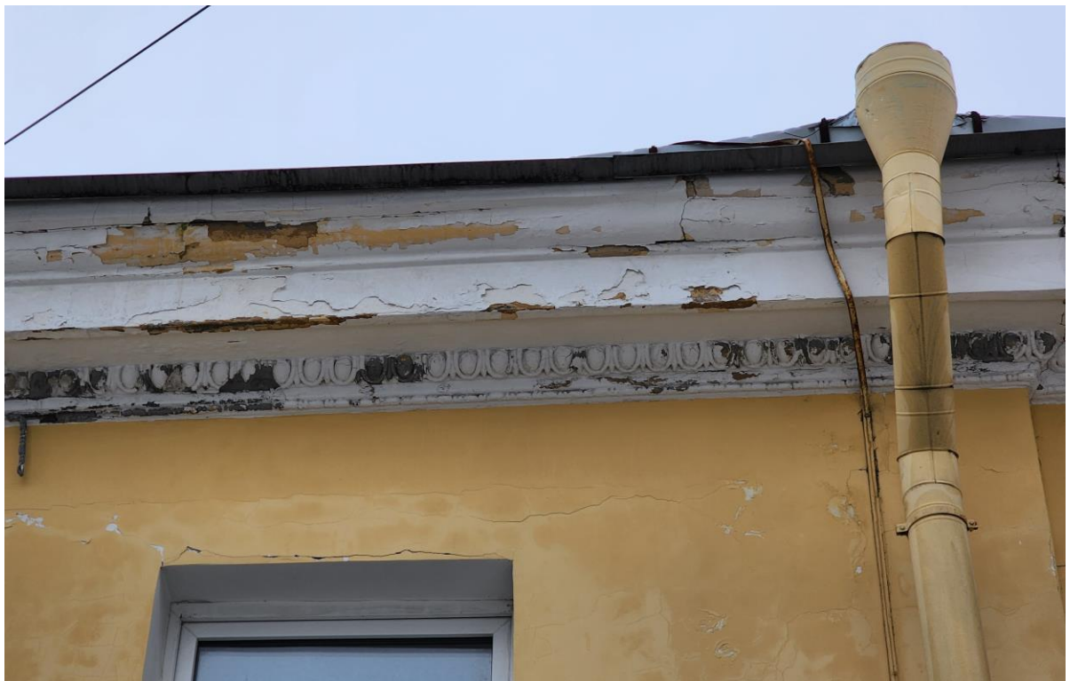
Фото 4. Южный фасад. Венчающий карниз.
