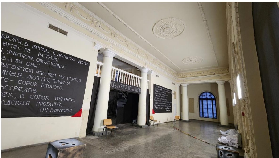
Фото 17. Помещение № 1. Вид на лестницу.
