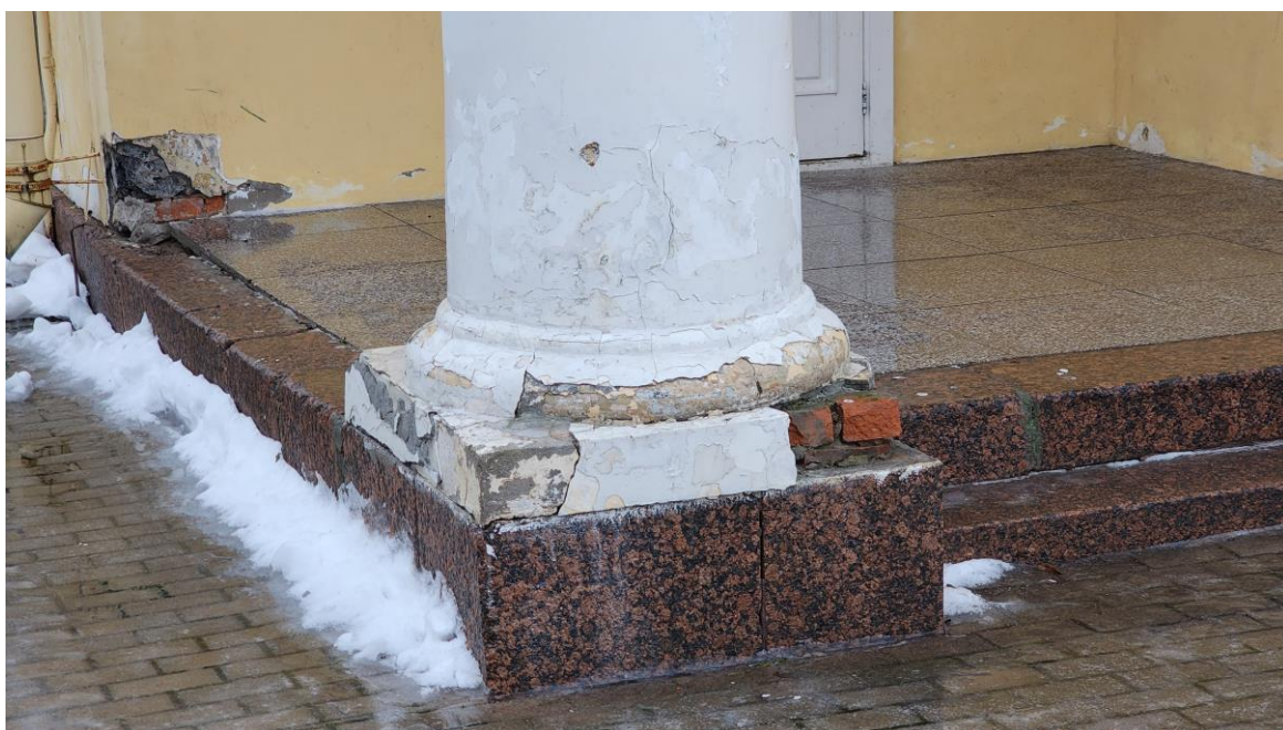
Фото 12. Восточный фасад. База колонны. Ступени.
