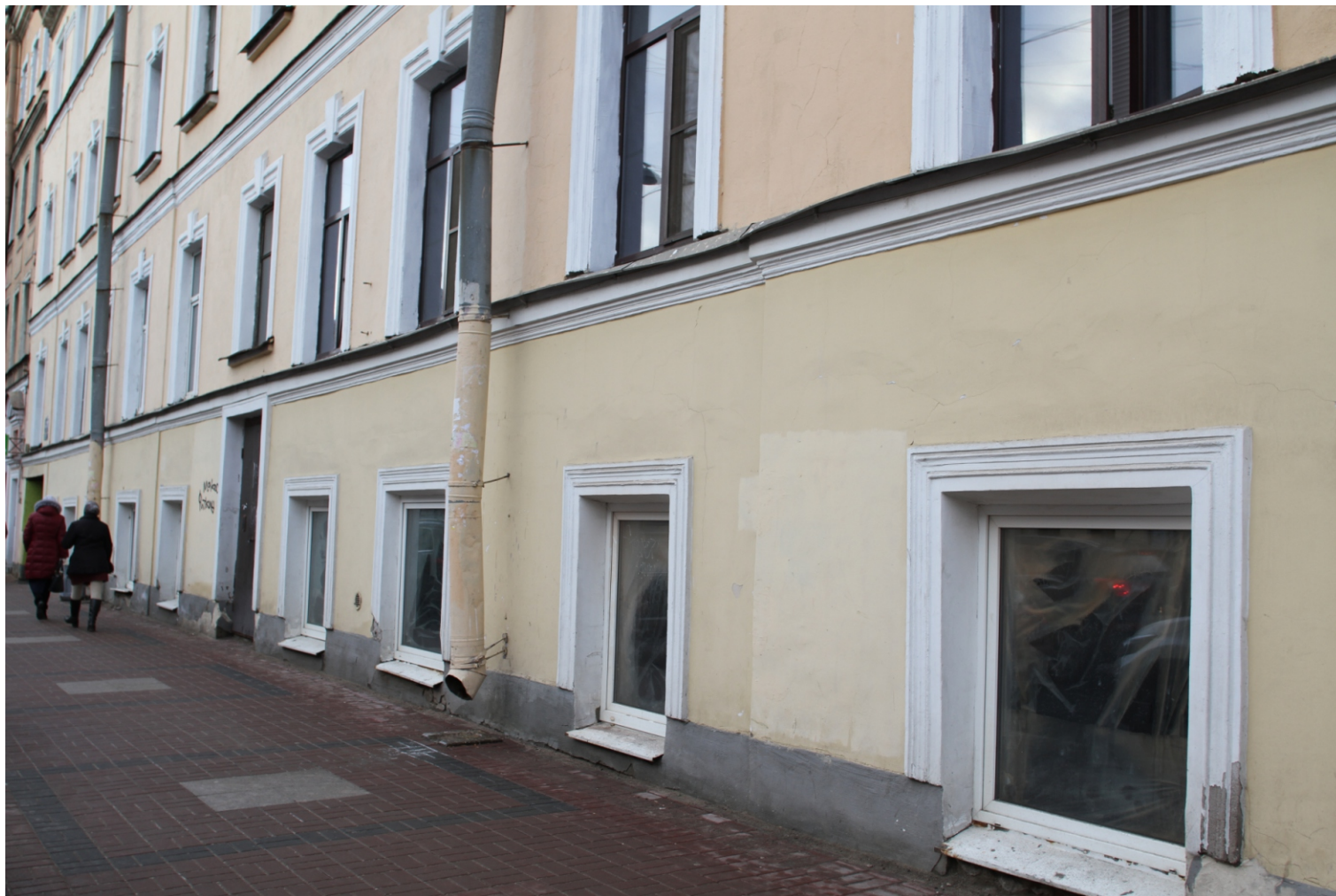
10. “Дом с флигелями семьи Брюлловых”. Средний пр. В.О., д.17, литера А (Средний пр., д.17) Лицевой фасад. Левая часть. Оконные проемы в уровне первого этажа. Фото: 01.11.2022.
