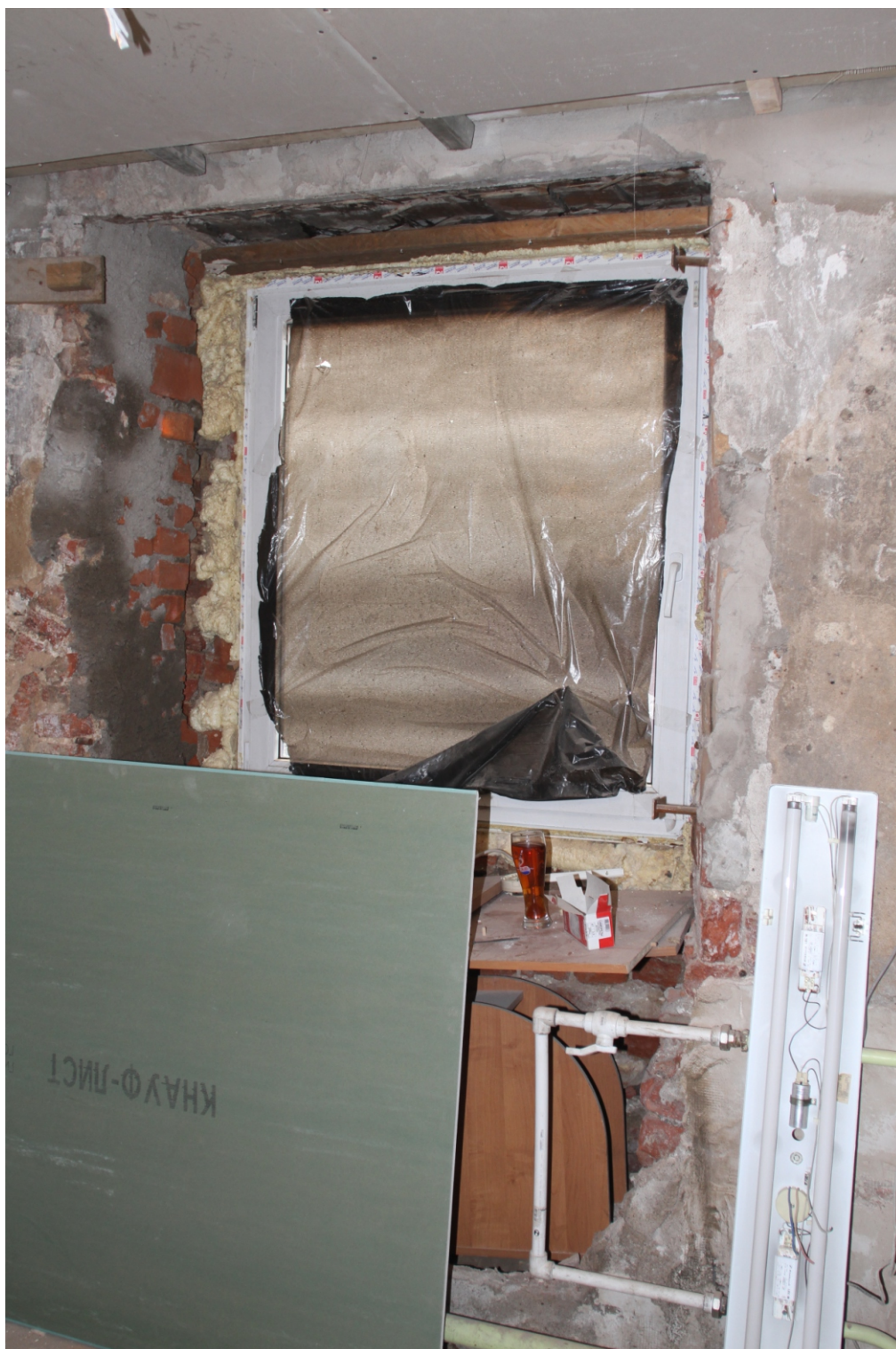
17. “Дом с флигелями семьи Брюлловых”. Средний пр. В.О., д.17, литера А (Средний пр., д.17) Фрагмент интерьера. Оконный проем. Фото: 01.11.2022.
