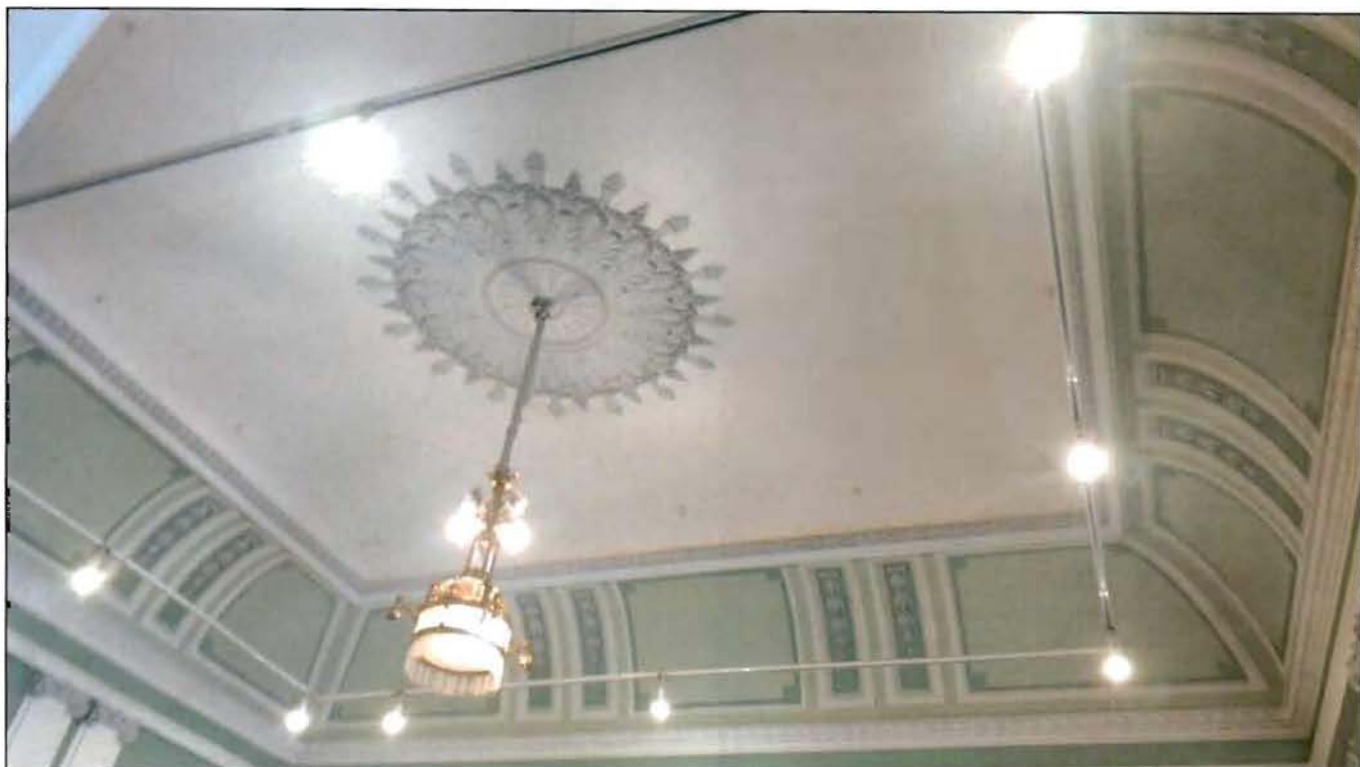
15. Интерьер. Фрагмент. Пом. 4-Н(65).
