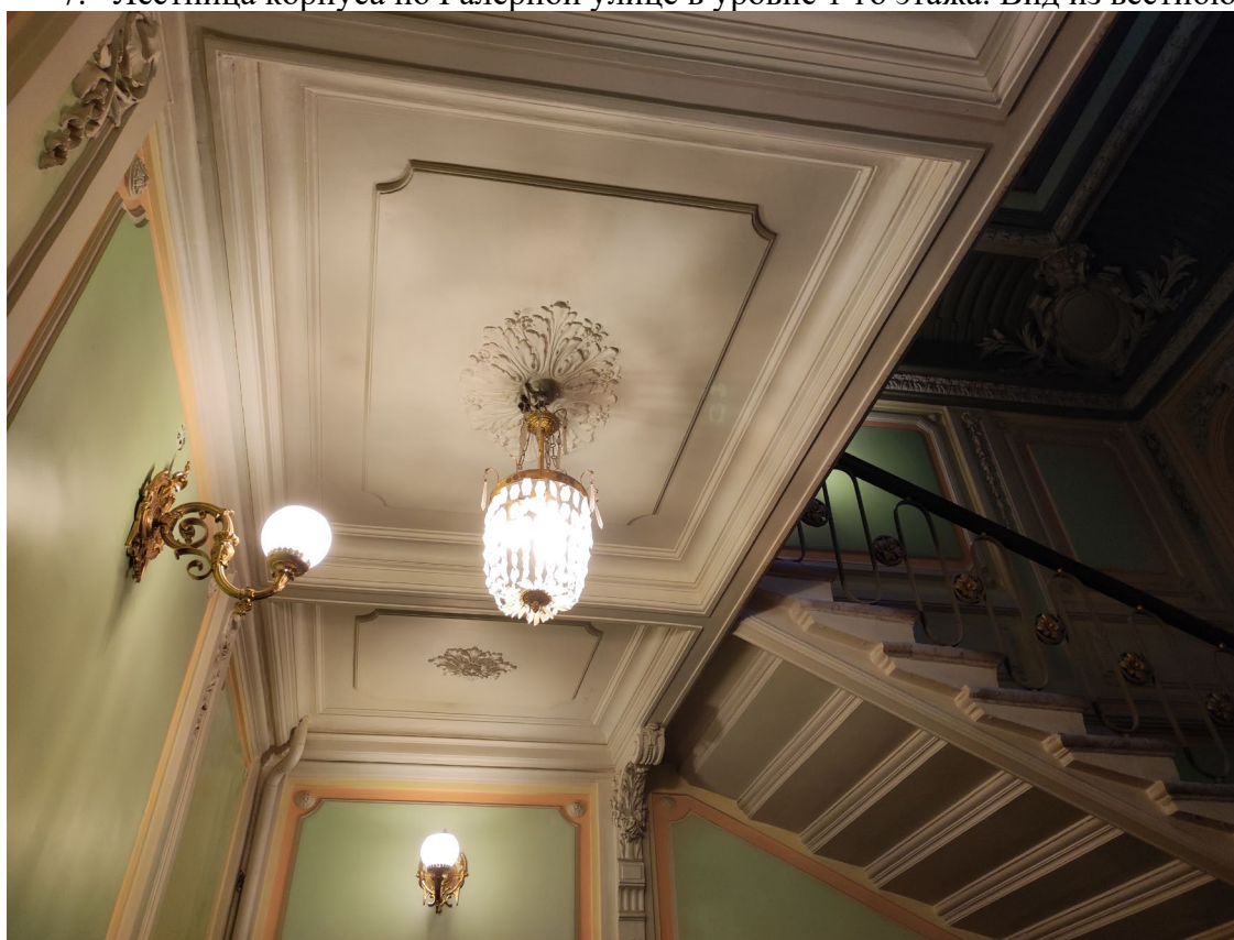
8. Лестница корпуса по Галерной улице в уровне 2-го этажа (пом. № 4-Н).
