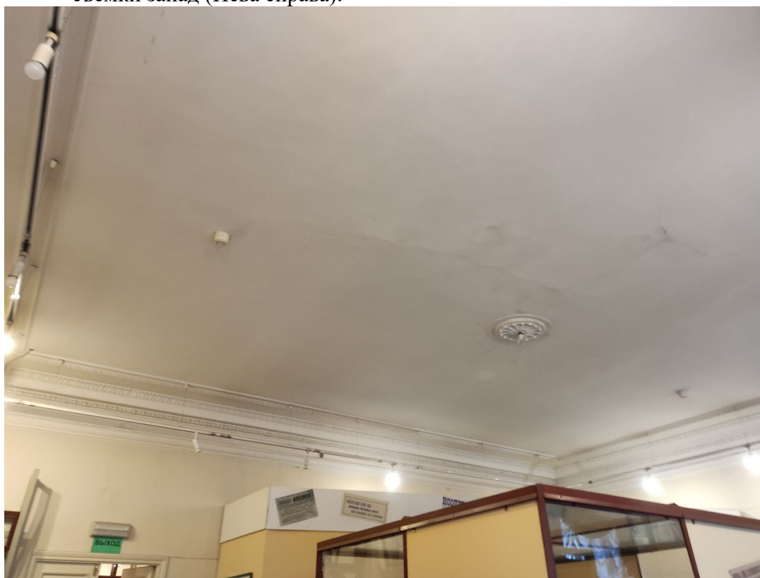
34. Вид помещения № 64 на 3-м этаже лицевого корпуса по Английской наб. Направление съемки юг (Нева сзади).
