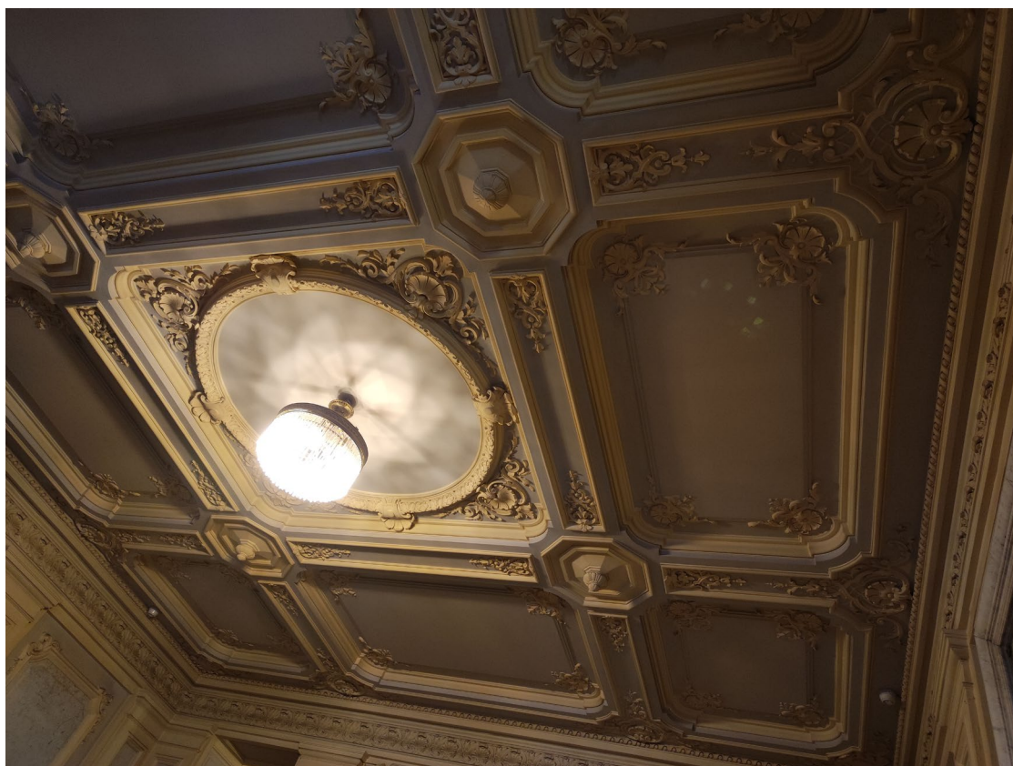
1. Потолок вестибюля корпуса по Английской набережной (пом. № 16).
