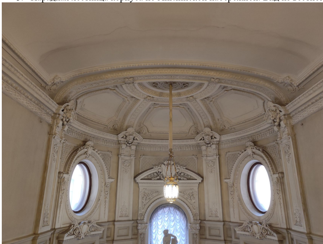
4. Парадная лестница корпуса по Английской набережной. Вид с площадки 2-го этажа (пом. № 52).
