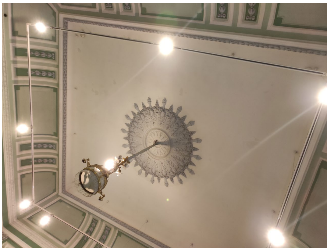
35. Вид потолка помещения № 65 на 3-м этаже лицевого корпуса по Английской наб.
