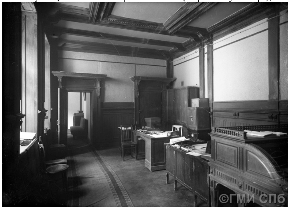
39. 1939 – 1940 гг. Набережная Красного Флота (Английская набережная), дом 44. Особняк Румянцева. Фрагмент помещения бухгалтерии. ГМИ СПб Инв. № П-А318н.
