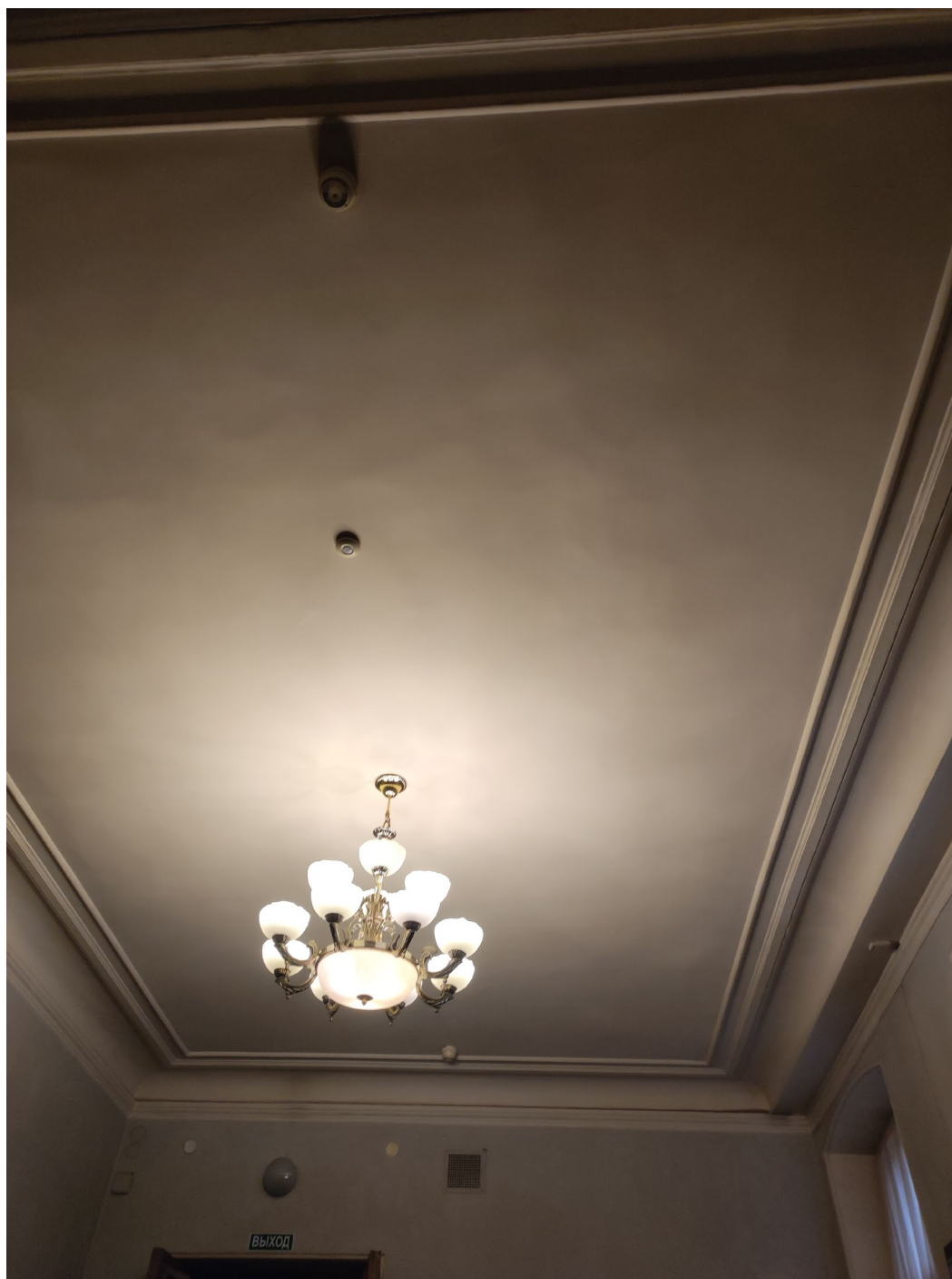
12. Вид помещения № 11 в 1 этаже лицевого корпуса по Английской набережной.
