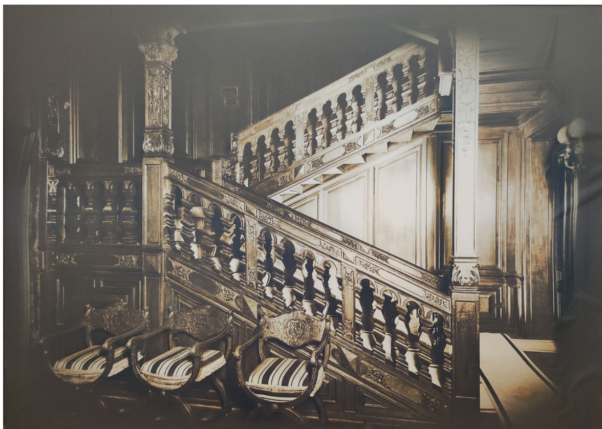
26. 1906 г. Дубовая лестница. К. К. Булла. ЦГАКФФД СПб № Е-290.
