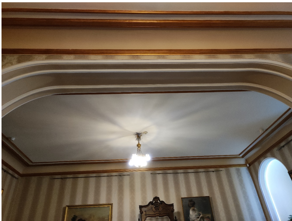
13. Вид западной стены пом. № 12 на 1-м этаже лицевого корпуса по Английской наб.
