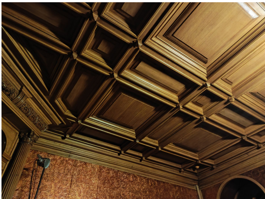
15. Вид западной стены пом. № 17 на 1-м этаже лицевого корпуса по Английской наб.
