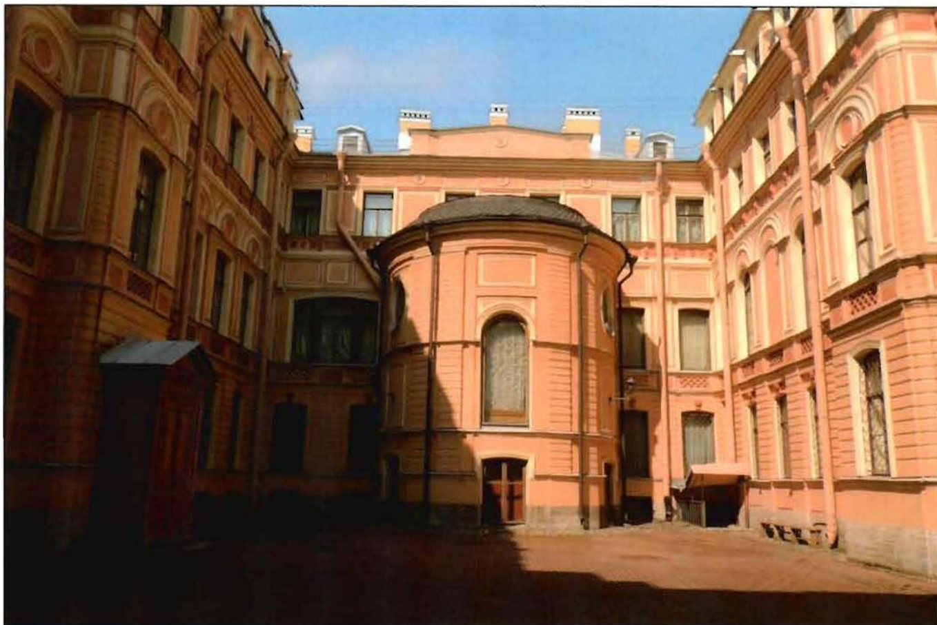
2. Общий вид фасадов северного двора объекта культурного наследия с юго-востока.
