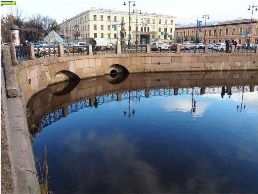
3. Крюков канал. Заложенные коллекторы на месте впадения засыпанного участка Адмиралтейского канала в Крюков канал. Вид с запада.
