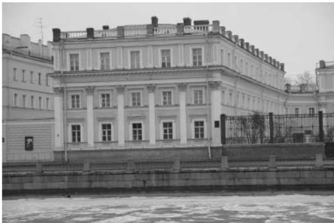
Фото 5. Общий вид фасада (со стороны наб. р. Фонтанки) в осях 14-20.
