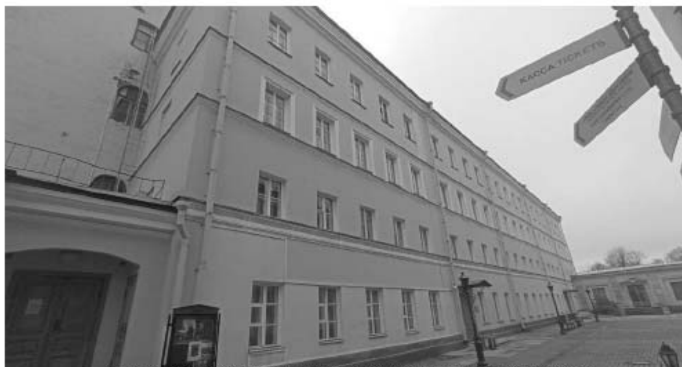
Фото 43. Угловой вид фасада (со стороны восточного двора) в осях П'-Б'
