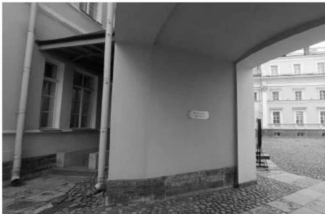
Фото 32. Фрагмент сквозной арки (со стороны восточного двора) в осях 13-Е.
