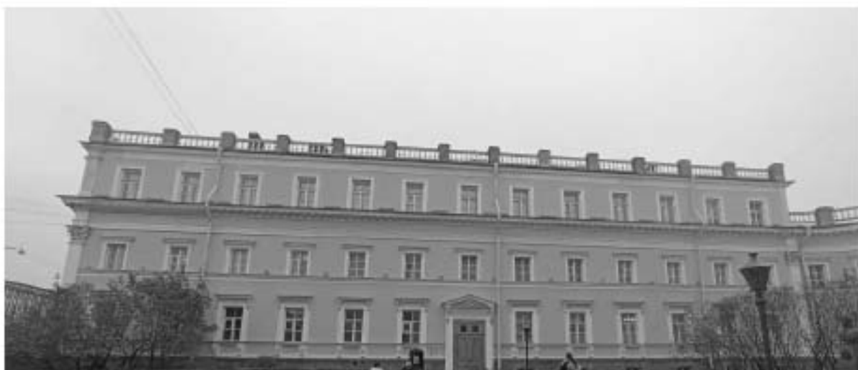
Фото 29. Удлин вид фасада (со стороны курдонера) в осях Ж-М.
