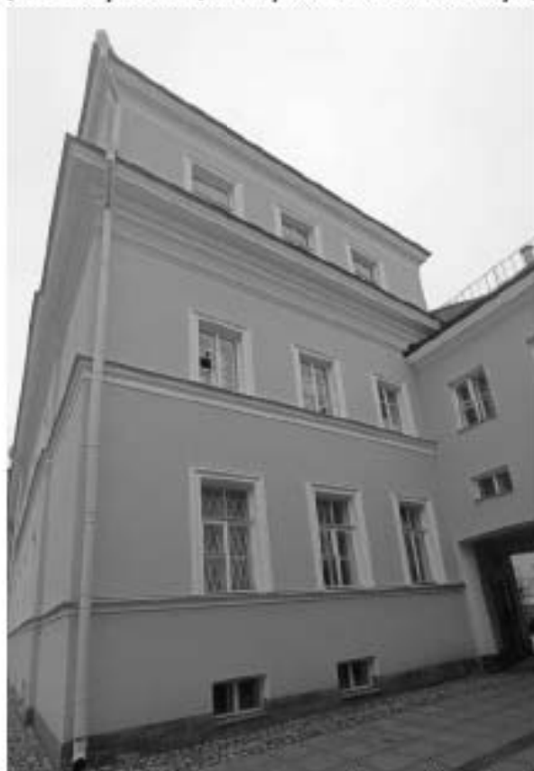
Фото 20. Общий вид фасада (со стороны западного двора) по оси Д в осях 6-7.
