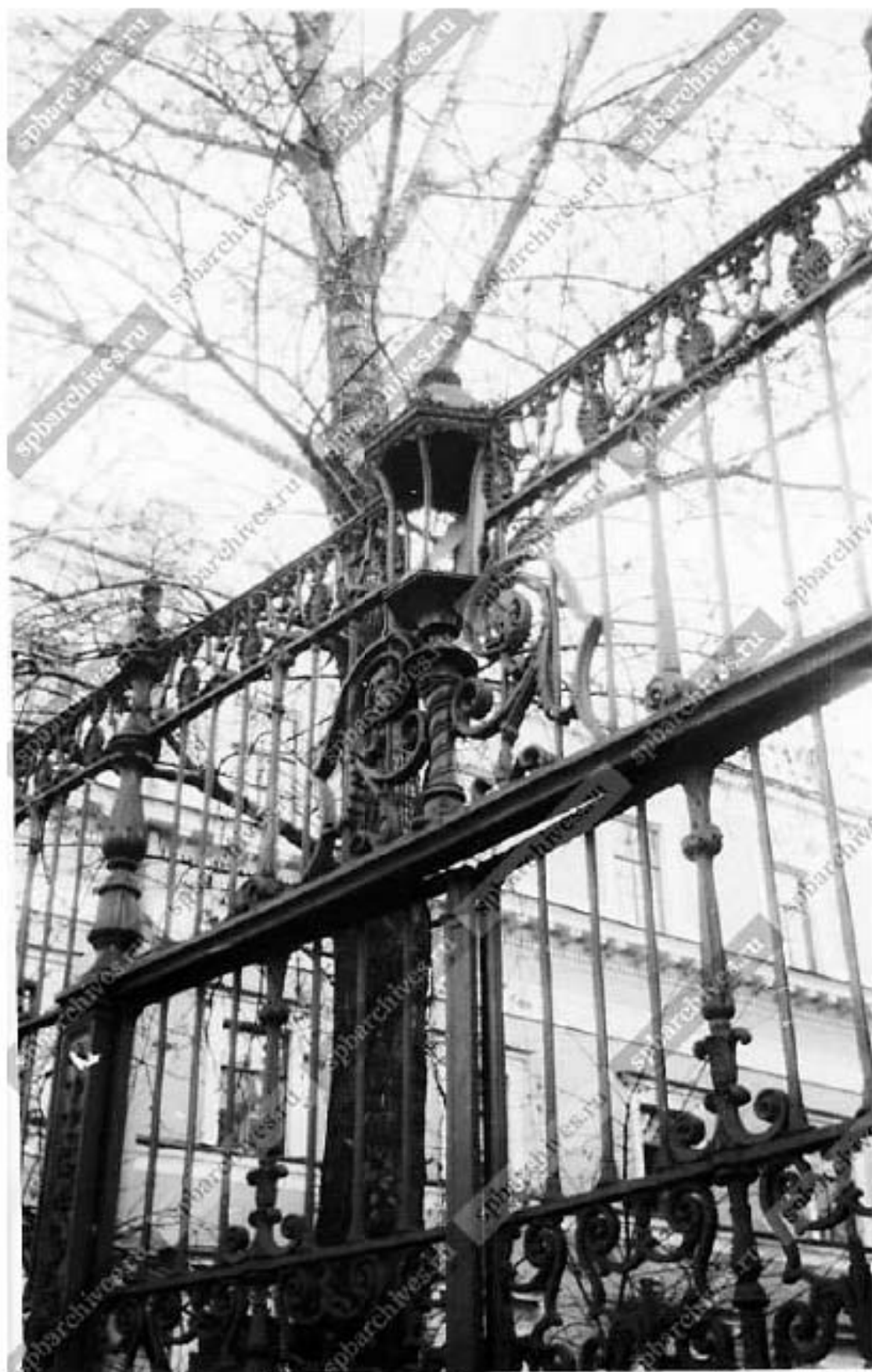
33. Фрагмент центральной части ограды. Фото 29 октября 1986 г. ЦГАКФФД СПб. Ар225967.
