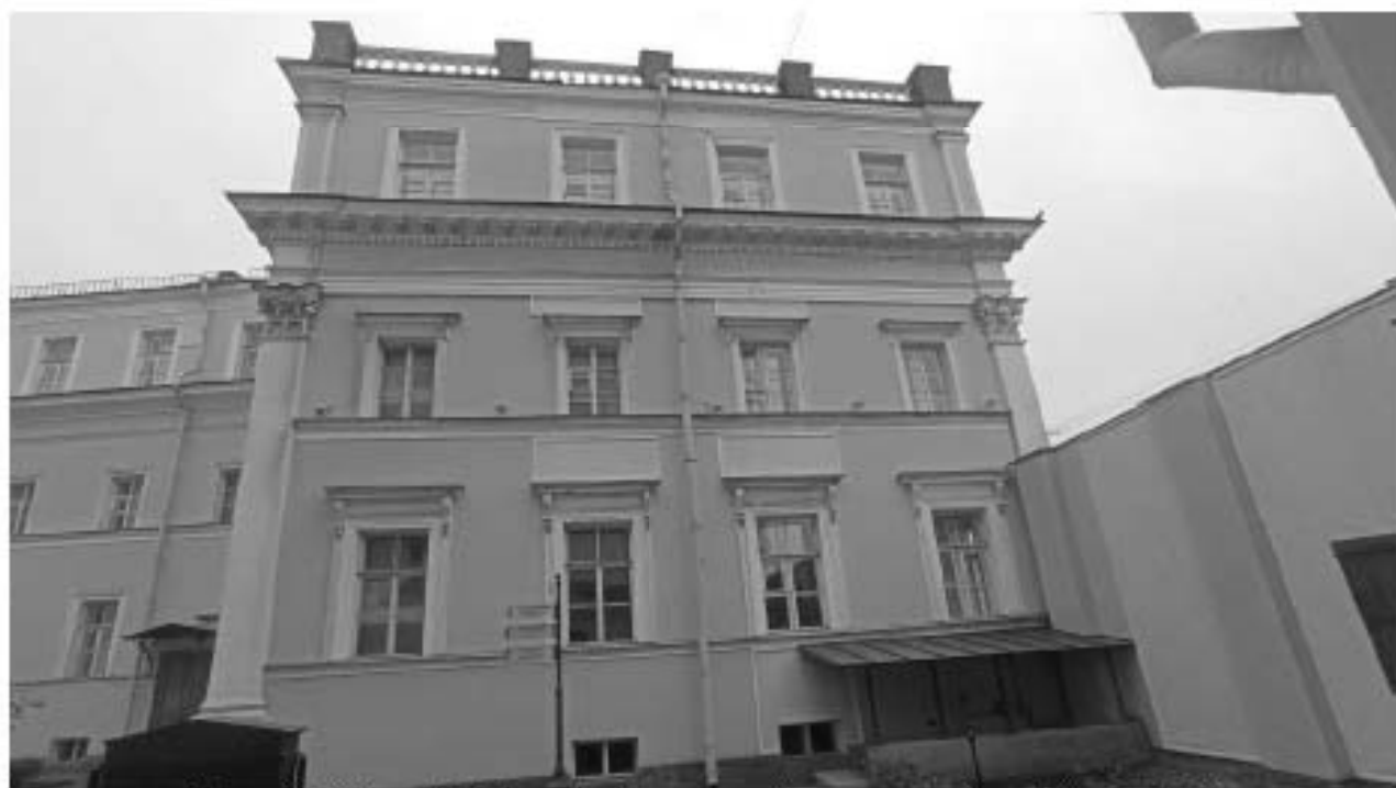
Фото 40. Вид фасада (со стороны восточного двора) в осях Л-М.
