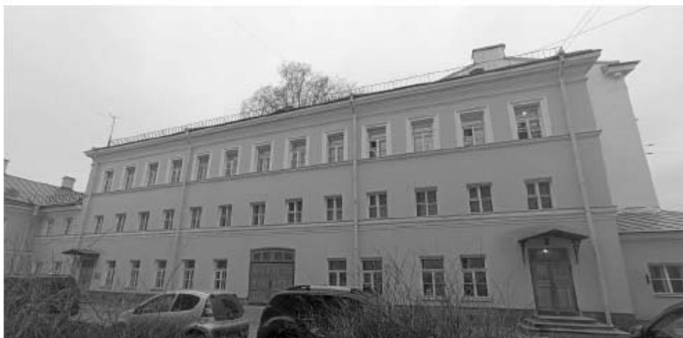
Фото 18. Удцил вид фасада (со стороны западного двора) в осях К'-В.
