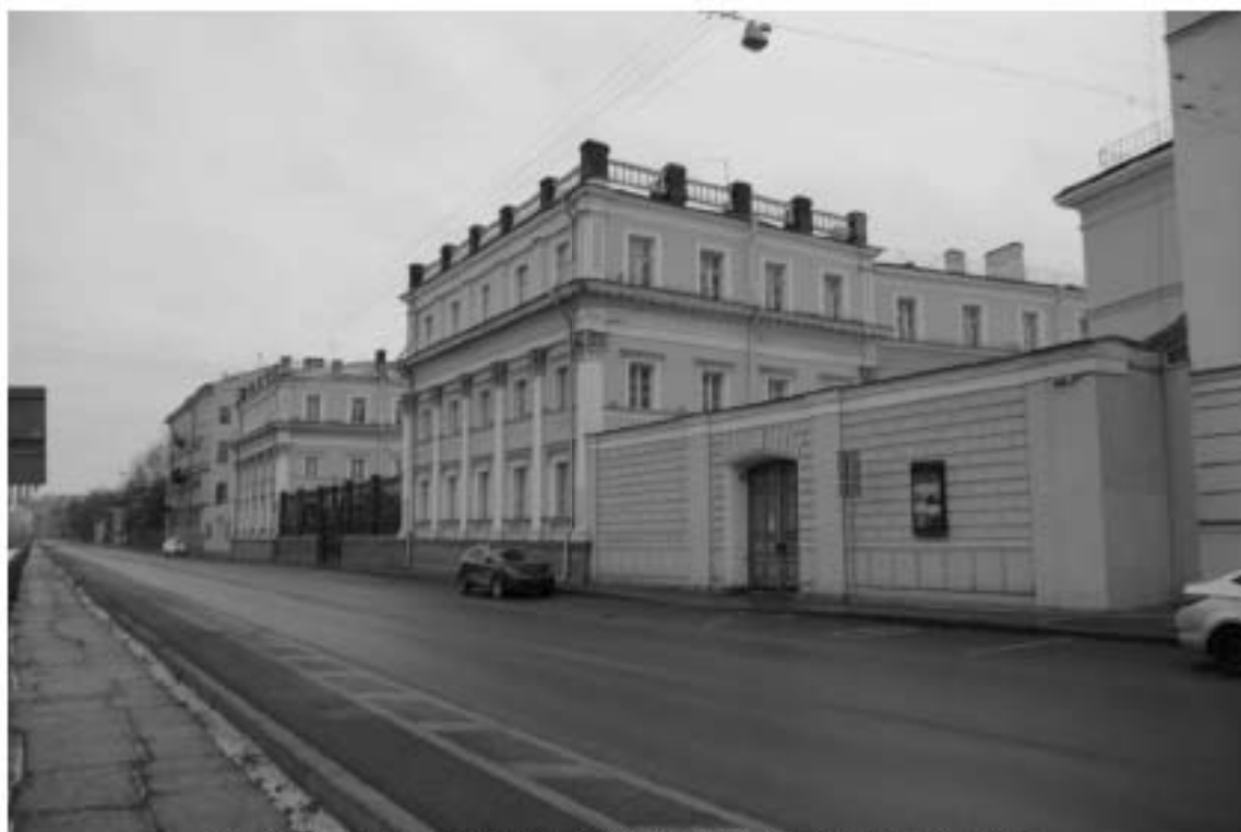
Фото 11. Фасад 1-9 (со стороны наб. р. Фонтанки). Общий вид
