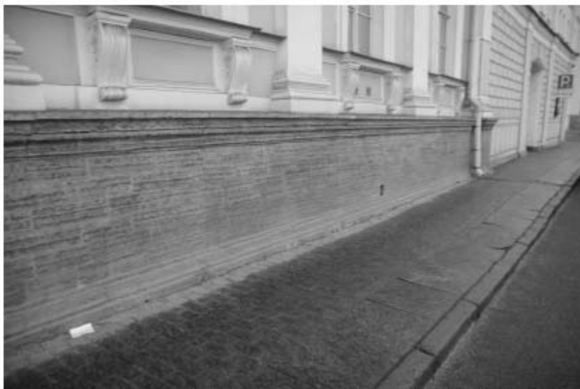
Фото 9. Фрагмент известнякового цоколя фасада (со стороны наб. р.Фонтанки) в осях 4-9.
