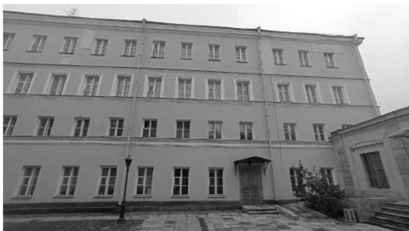
Фото 44. Фрагмент фасада (со стороны восточного двора) в осях П'-Б'
