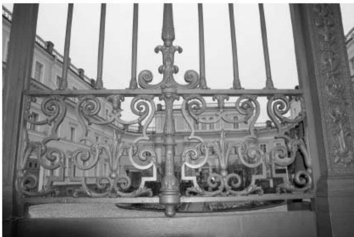
Фото 8. Фрагмент кованной ограды (со стороны над. р.Фонтанки). в осях 14-9.
