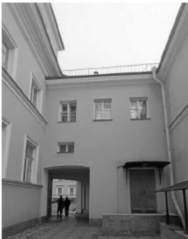
Фото 21. Общий вид фасада (со стороны западного двора) в осях Д-Б.
