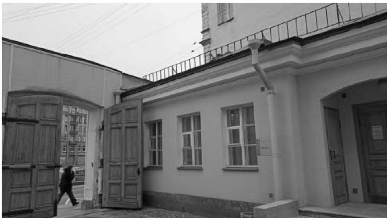
Фото 41. Вид из двора (со стороны восточного двора) в осях М-П'
