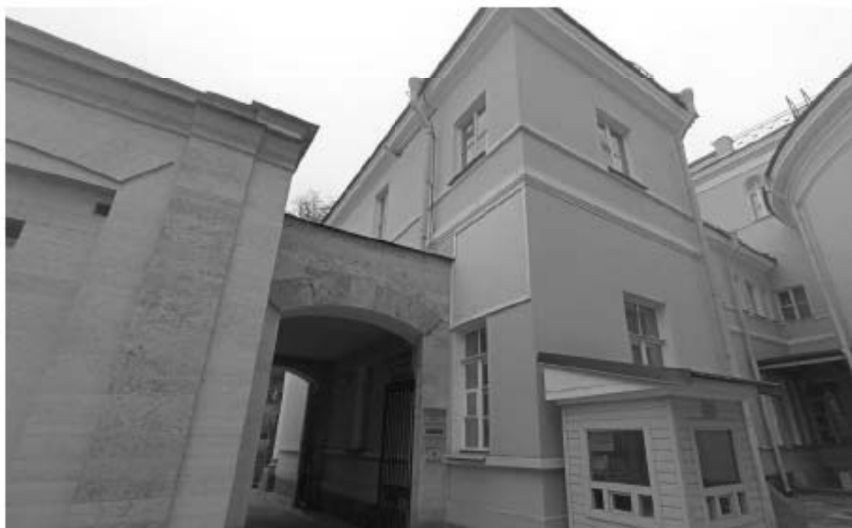
Фото 36. Вид из фасадов (со стороны восточного двора) в осях 21-13.
