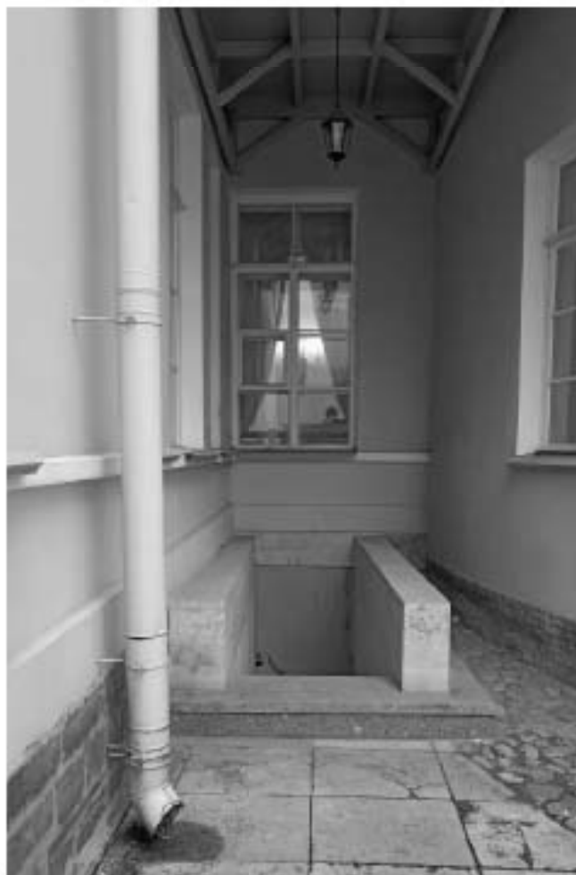
Фото 34. Вид на приямок (со стороны восточного двора) в осях Б-В.
