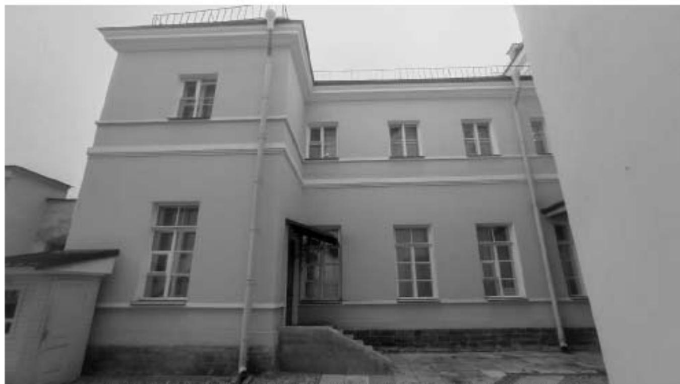
Фото 35. Вид из фасада (со стороны восточного двора) в осях 11-13.
