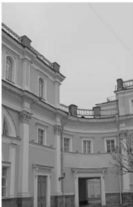
Фото 22. Вид на сквозную арку на фасаде (со стороны курдонера) в осях Д-Б.
