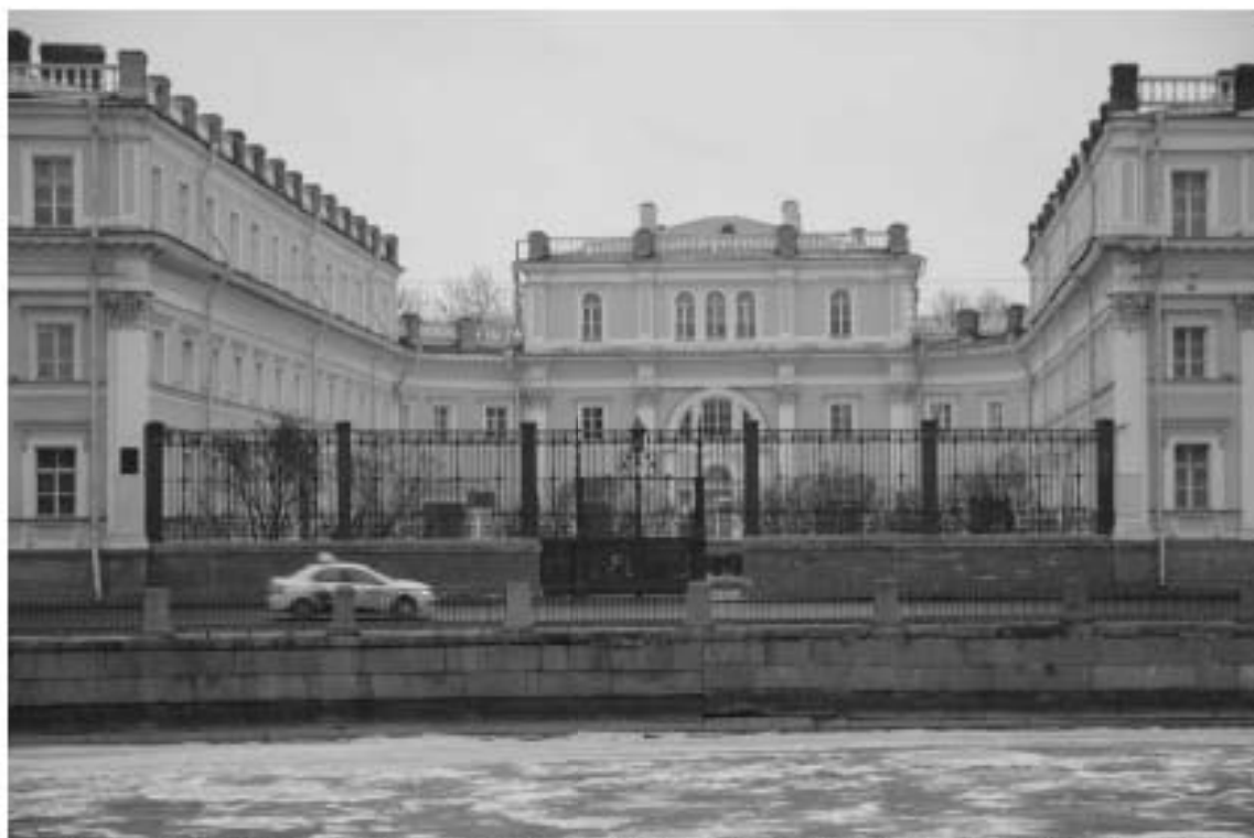
Фото 6. Вид кованной ограды (со стороны наб. р. Фонтанки). в осях 14-9.
