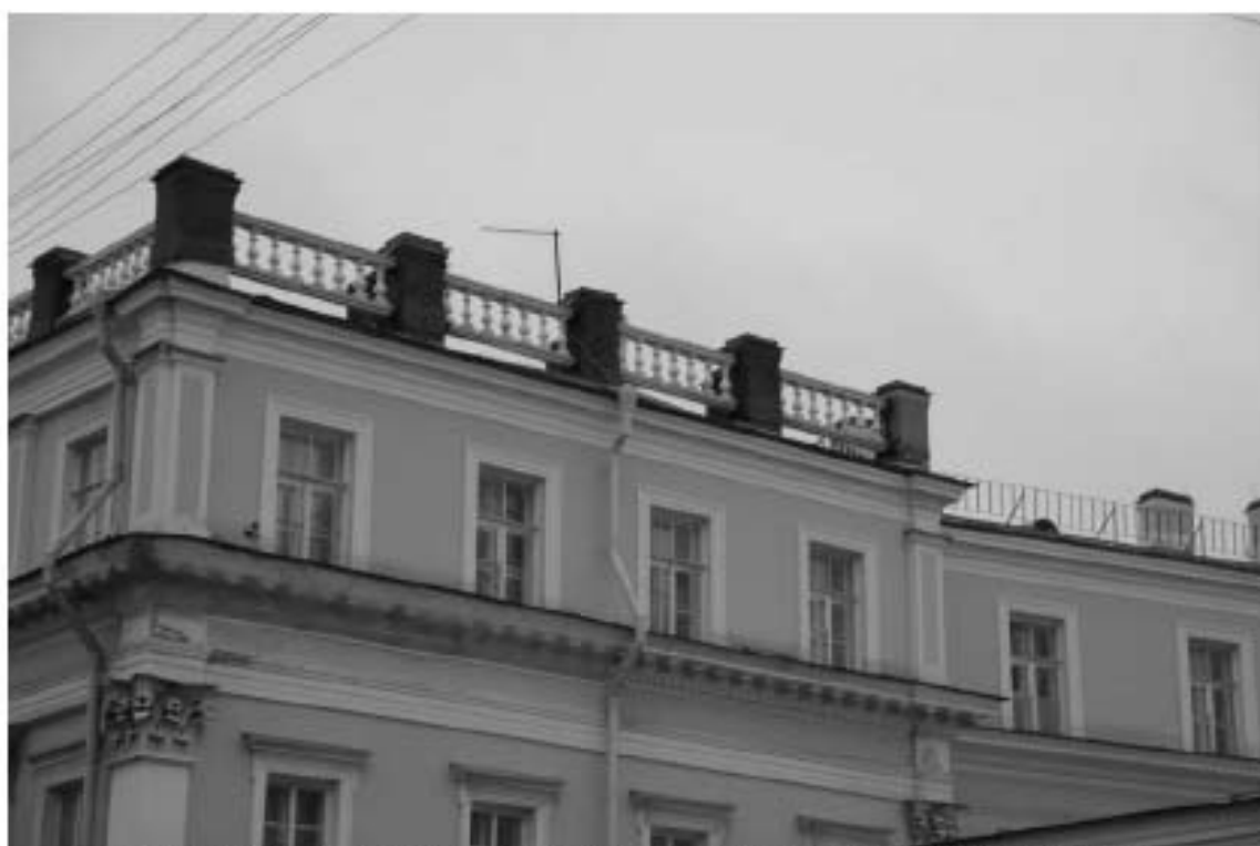
Фото 12. Фрагмент фасада (со стороны западного двора) в осях М-И.
