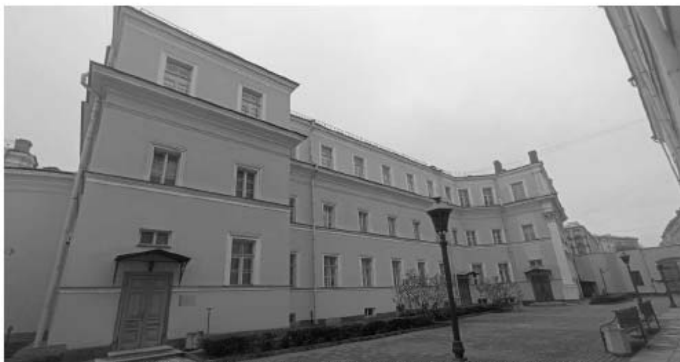
Фото 38. Вид фасада (со стороны восточного двора) в осях Е-Л.
