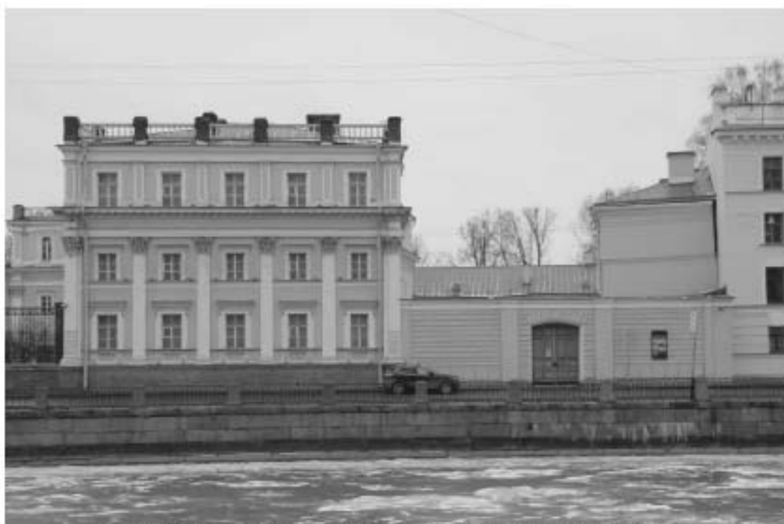
Фото 10. Фасад 4-9 (со стороны наб. р. Фонтанки). Общий вид.
