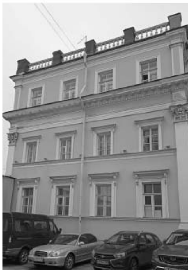
Фото 19. Общий вид фасада (со стороны западного двора) в осях М-И.
