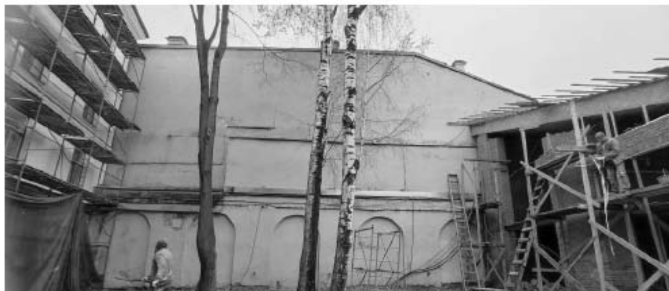
Фото 53. Общий вид фасад (торец) в осях И'-В
