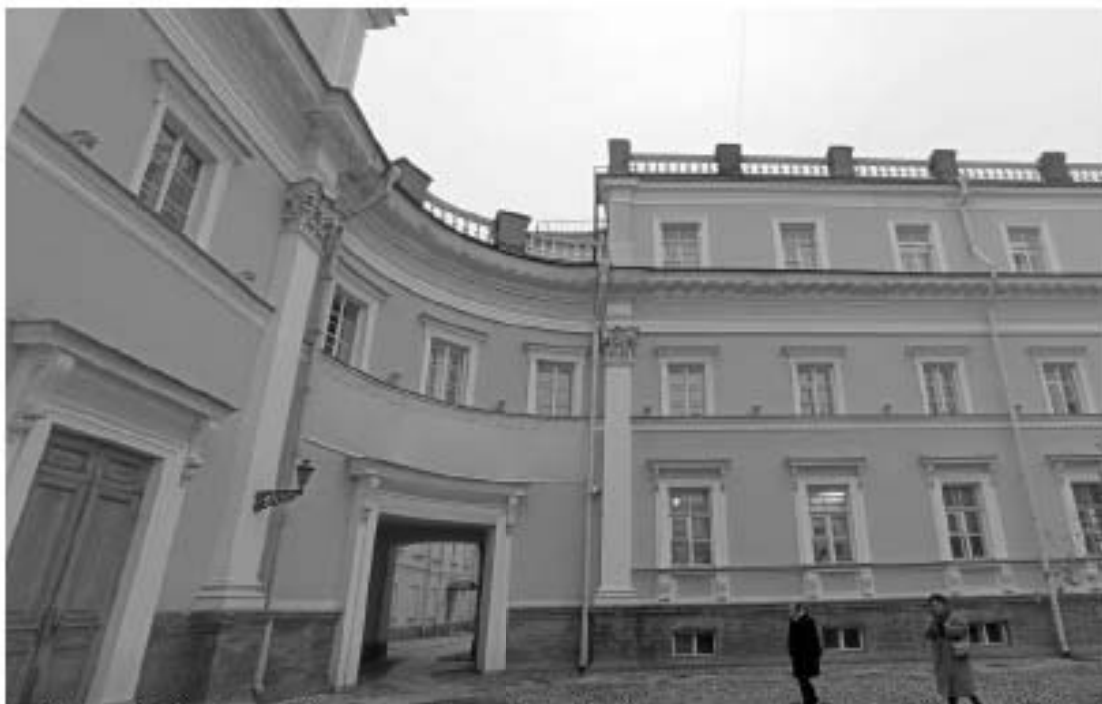
Фото 25. Вид на сквозную арку на фасаде (со стороны курдонера) в осях Д-в.
