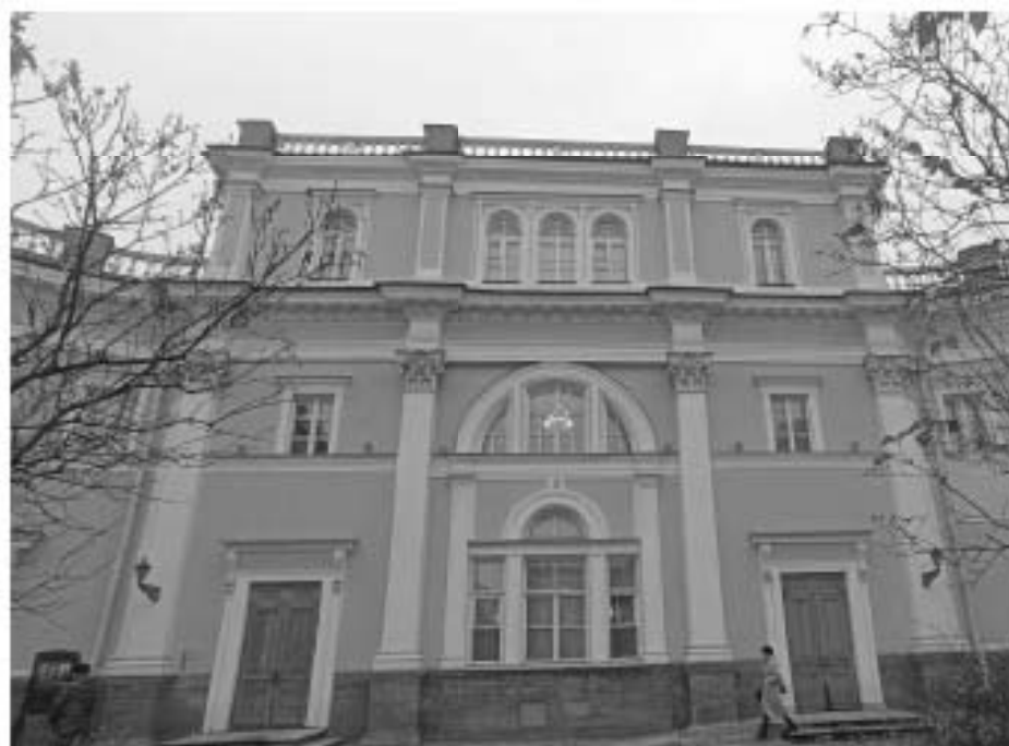
Фото 26. Улицный вид фасада (со стороны курдонера) в осях 13-10.
