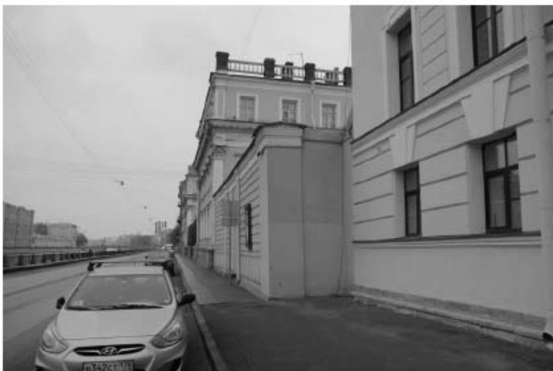
Фото 14. Фрагмент каменной ограды (со стороны наб. р. Фонтанки) в осях 4-1.
