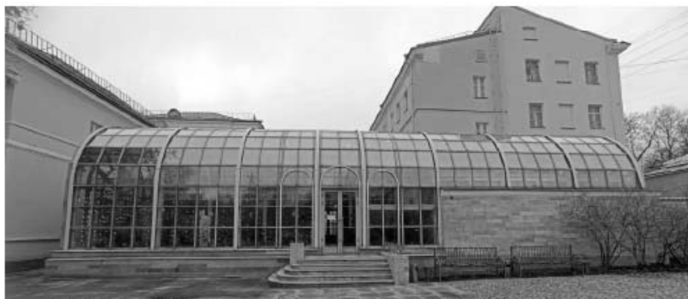
Фото 46. Удший вид фасада кафе-оранжереи (со стороны Усадебного сада) в осях 21-17.
