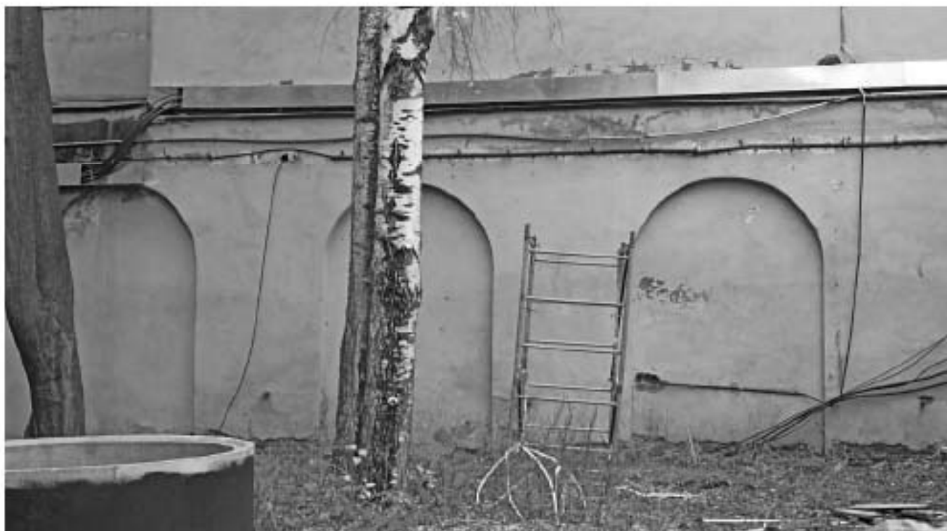
Фото 54. Фрагмент фасада (торец) в осях И'-В
