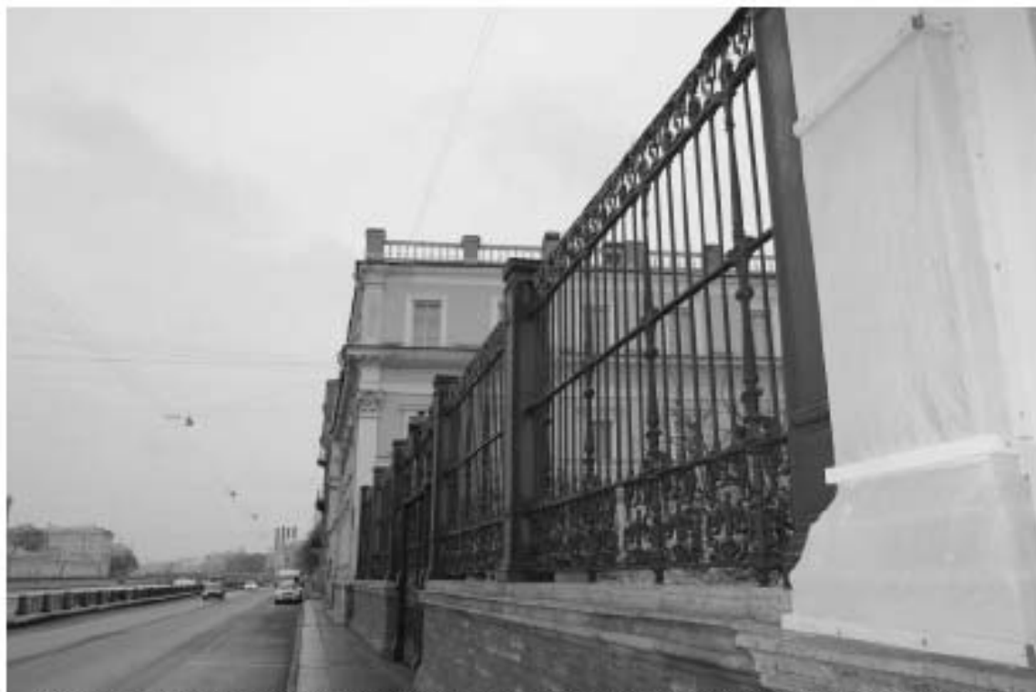
Фото 7. Фрагмент кованной ограды (со стороны над. р.Фонтанки). в осях 14-9.
