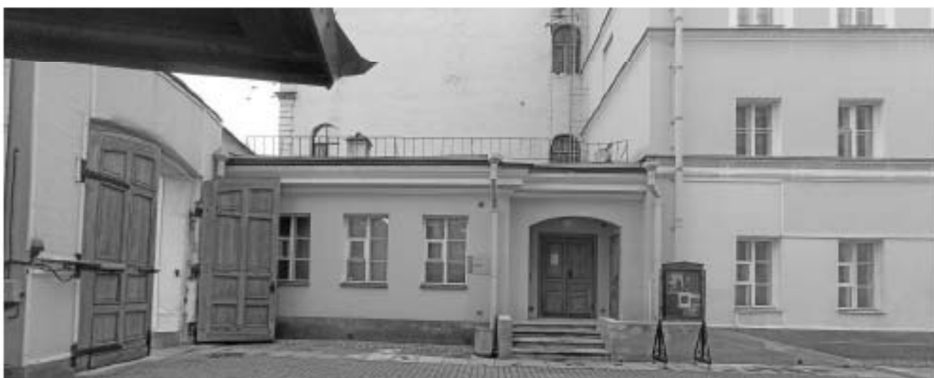
Фото 42. Вид из двора (со стороны восточного двора) в осях М-П'
