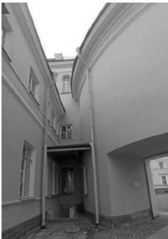
Фото 33. Вид на приямок (со стороны восточного двора) в осях Б-В.
