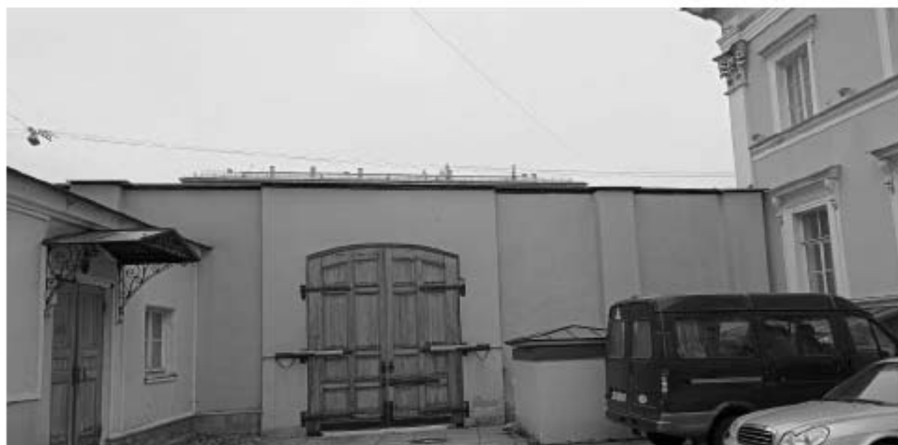
Фото 16. Общий вид каменной ограды (со стороны западного двора) в осях 4-1.
