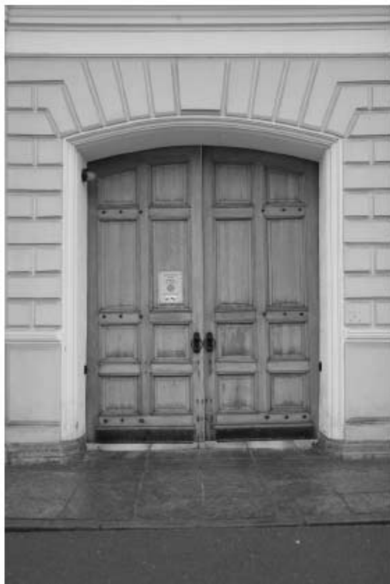
Фото 15. Фрагмент двери каменной ограды (со стороны наб. р. Фонтанки) в осях 4-1.
