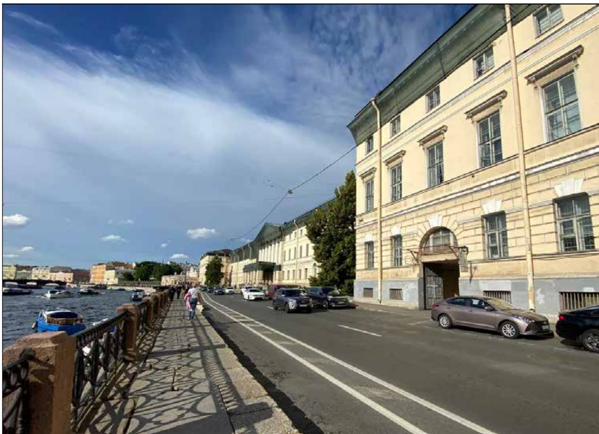
1. Главный фасад Екатерининского института. Вид на юго-восток с набережной реки Фонтанки. 08.09.2022 г.
