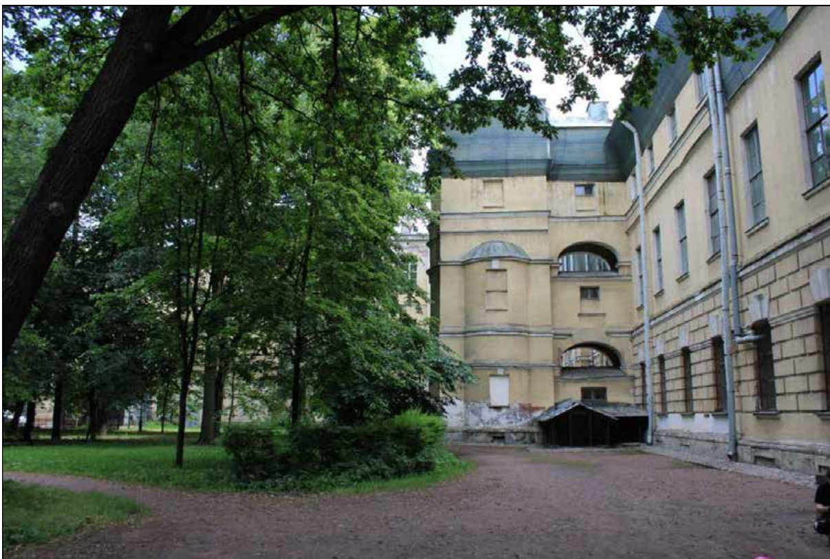
5. Фрагмент садового фасада Екатерининского института. Южный ретирадник. Вид на юг от крыльца главного входа. 08.09.2022 г.
