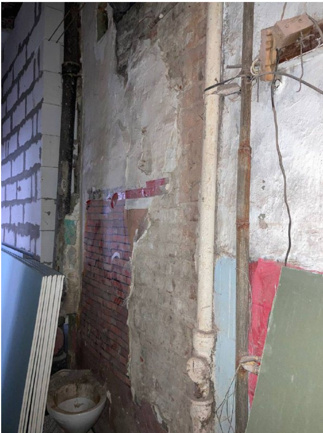
Фото 4. Фрагмент стены в коридоре. Канализационные стояки.
