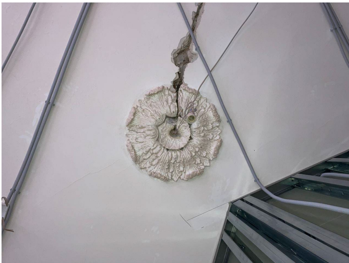
Фото 34. Помещение 7. Потолочная розетка.
