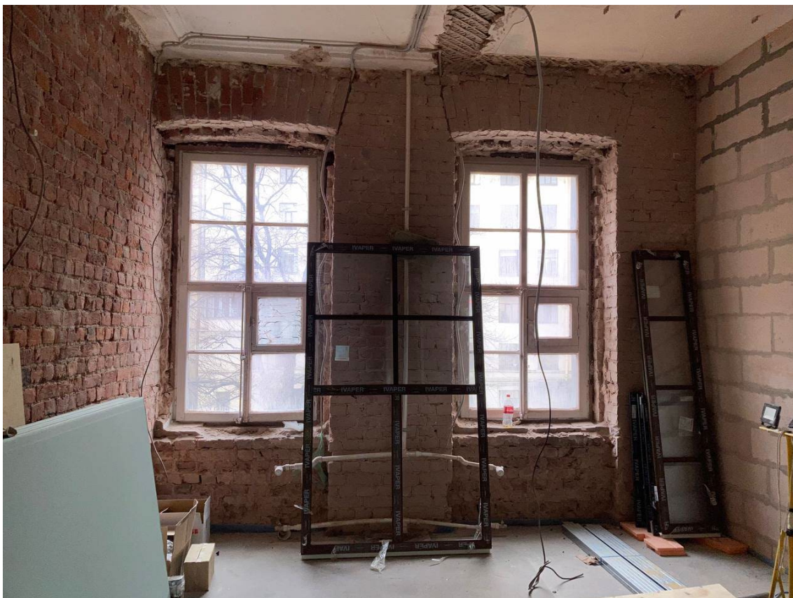
Фото 11. Помещение 2. Вид на стену с окнами.
