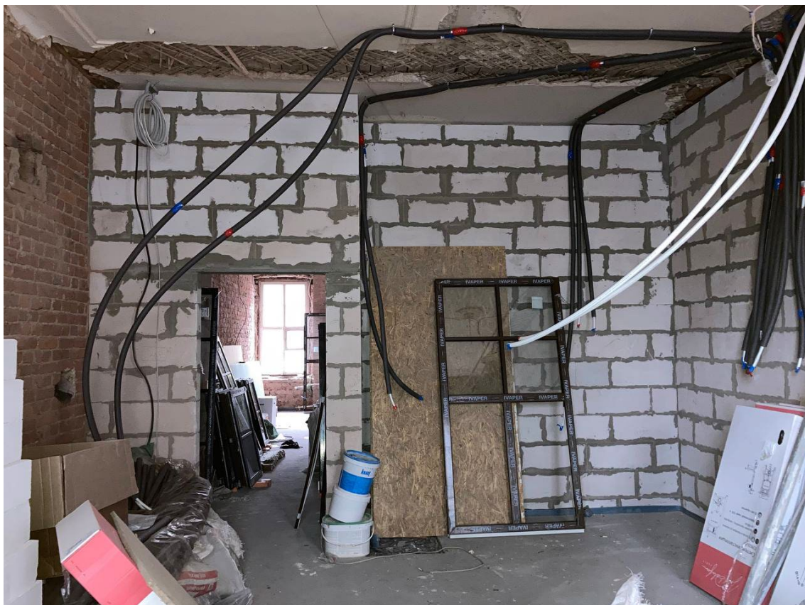
Фото 9. Помещение 1. Вид на вход в помещение.
