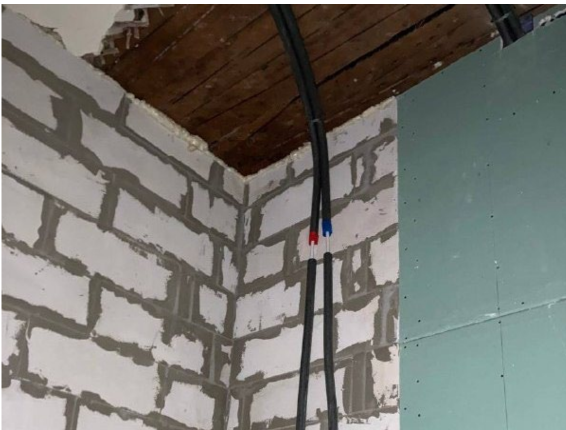
Фото 19. Помещение 4. Потолок во вспомогательном помещении.
