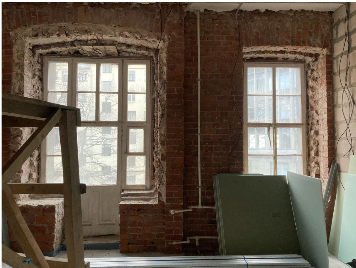
Фото 24. Помещение 5. Вид на стену с окнами.
