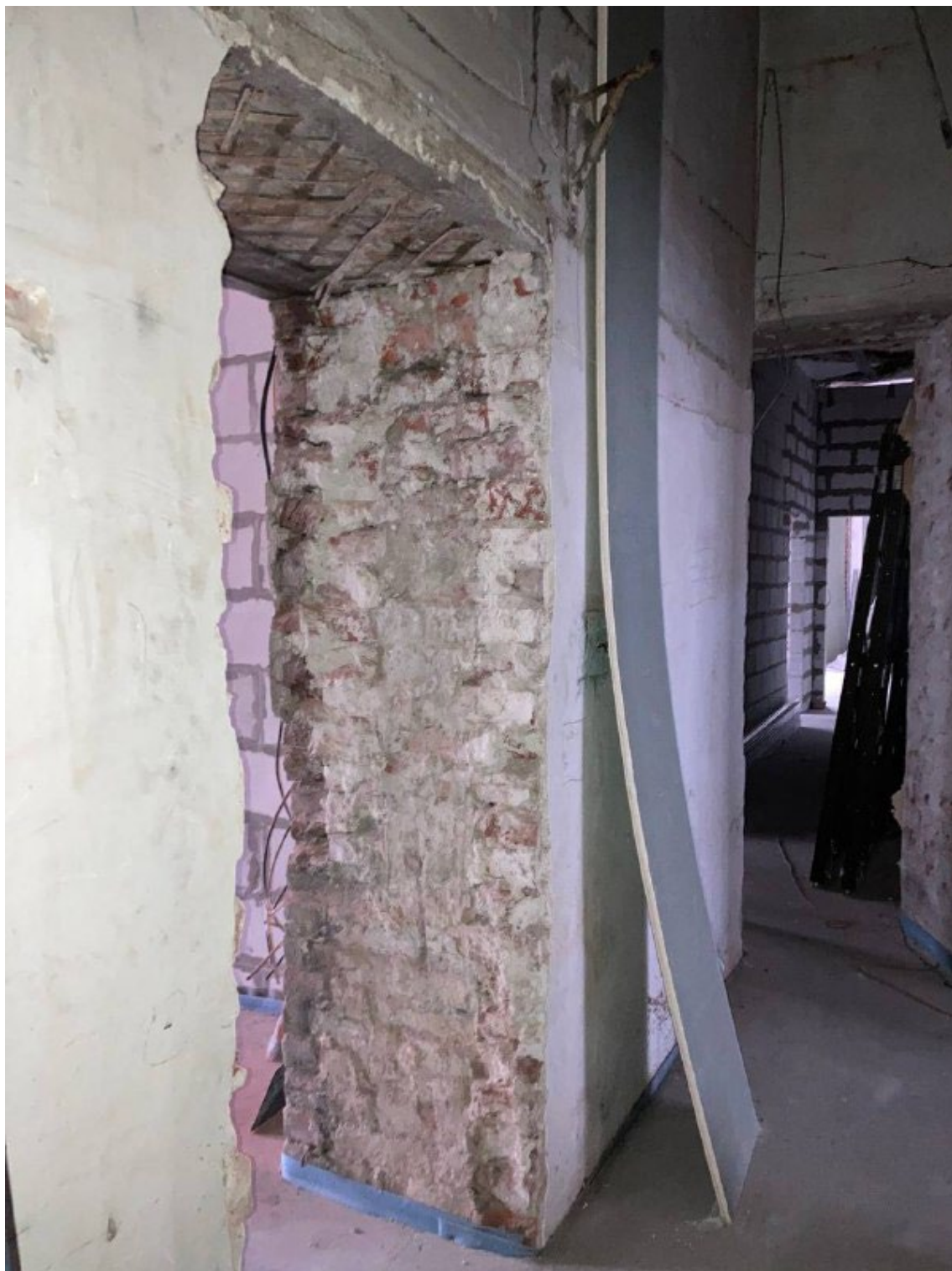
Фото 5. Несущая стена. Пром в помещение 3
