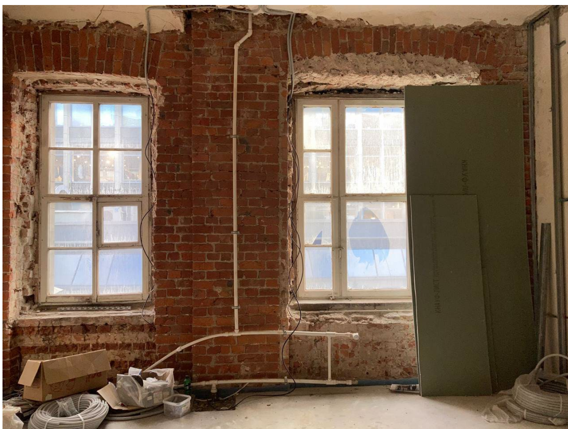
Фото 32. Помещение 7. Вид на стену с окнами.
