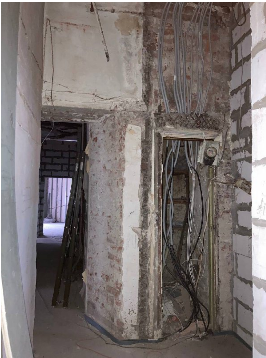
Фото 6. Коридор. Проем в несущей стене и дверной проем в кладовую.
