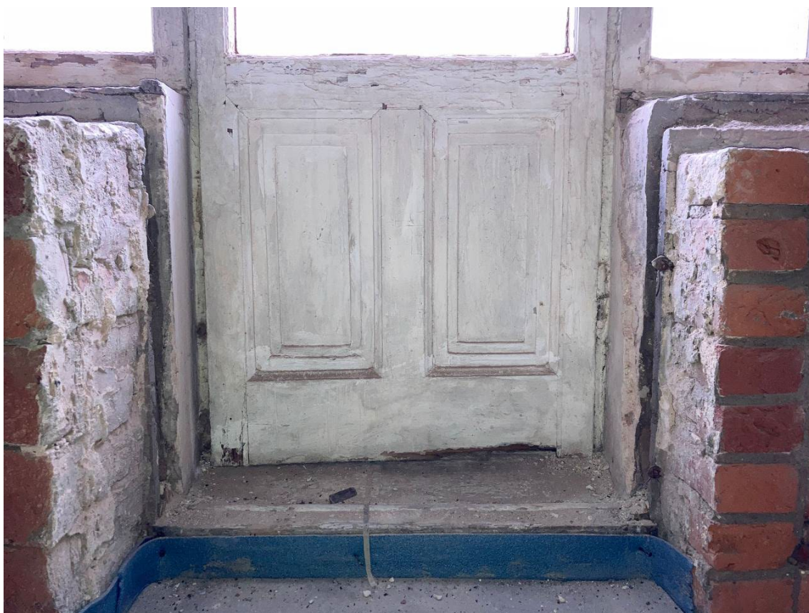
Фото 25. Помещение 5. Фрагмент балконной двери.
