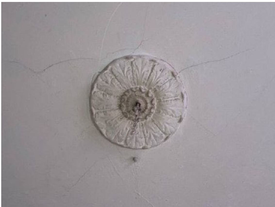
Фото 10. Помещение 1. Потолочная розетка.
