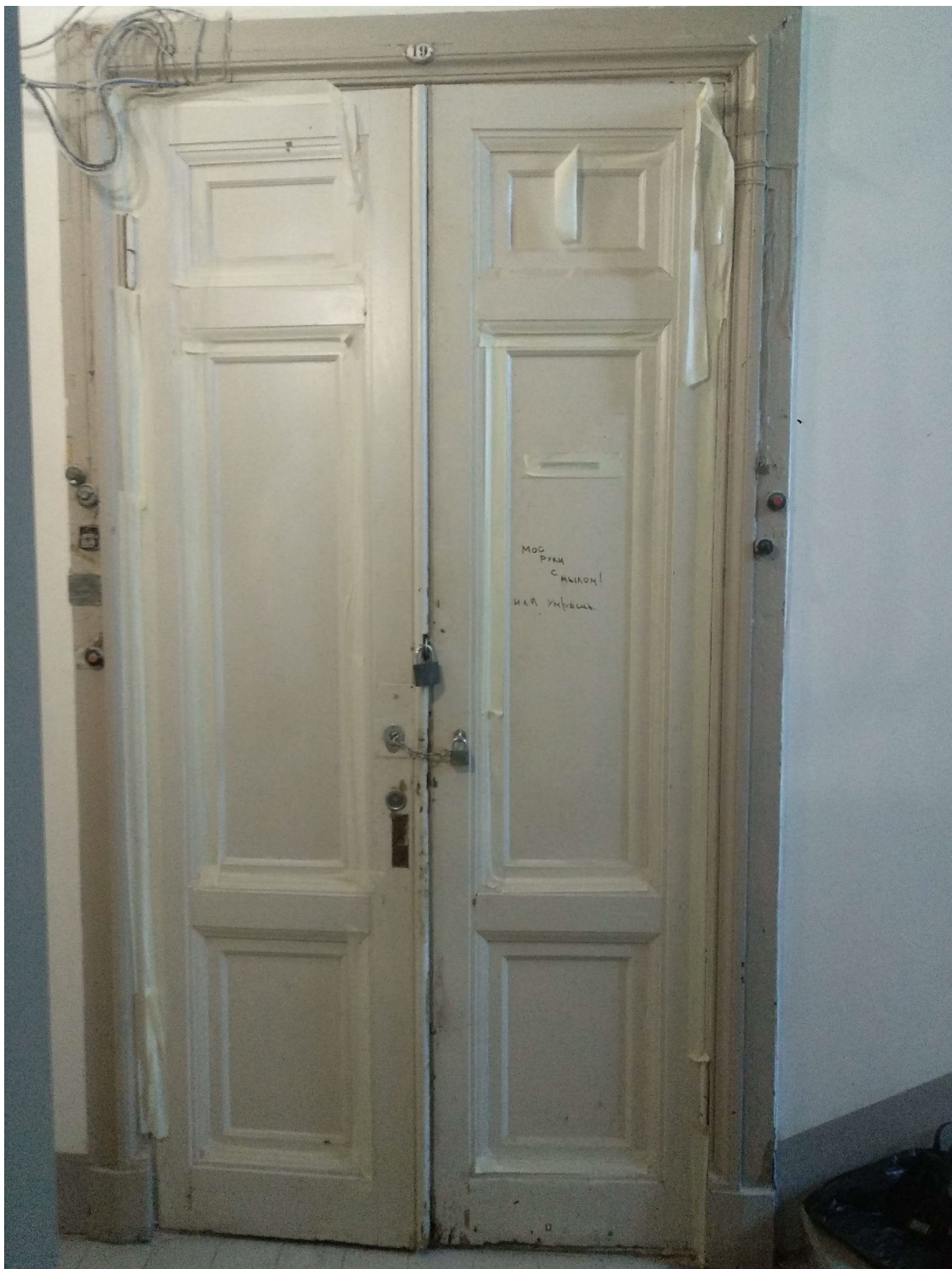
Фото 1. Входная дверь в квартиру 19.
