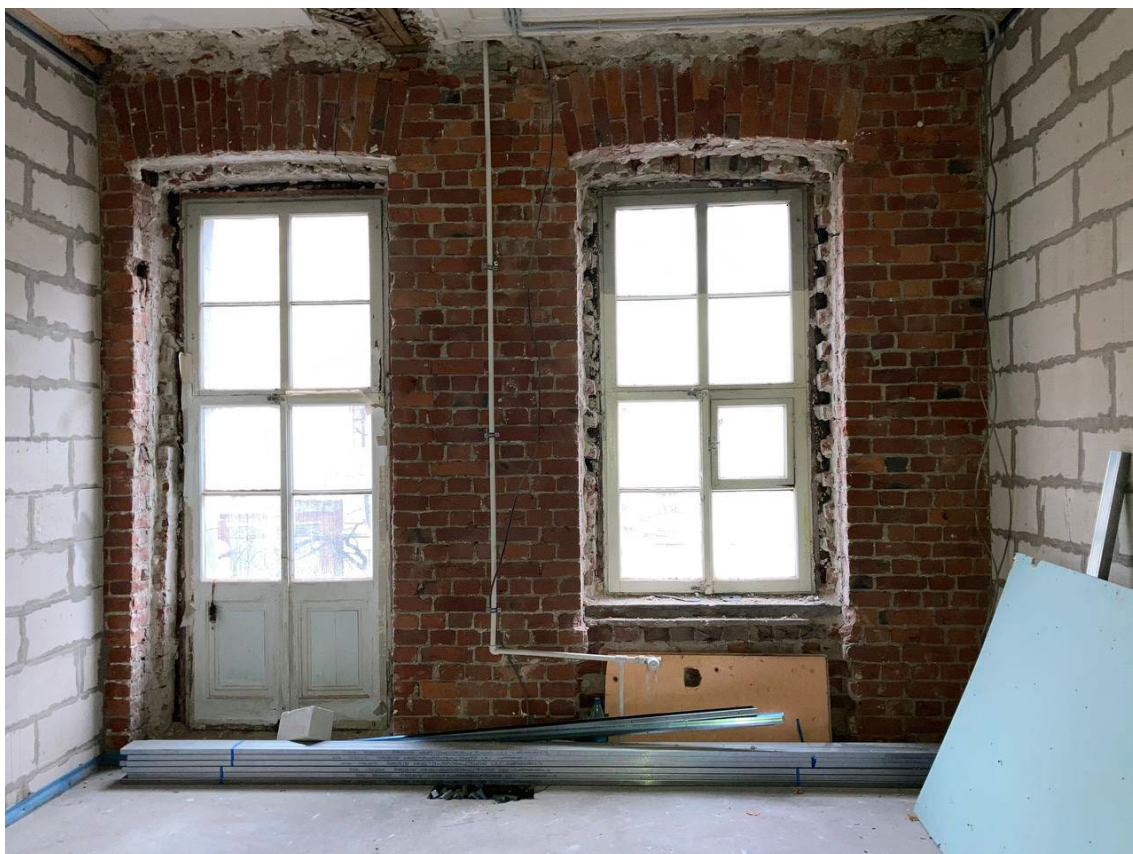
Фото 15. Помещение 3. Вид на стену с окнами.
