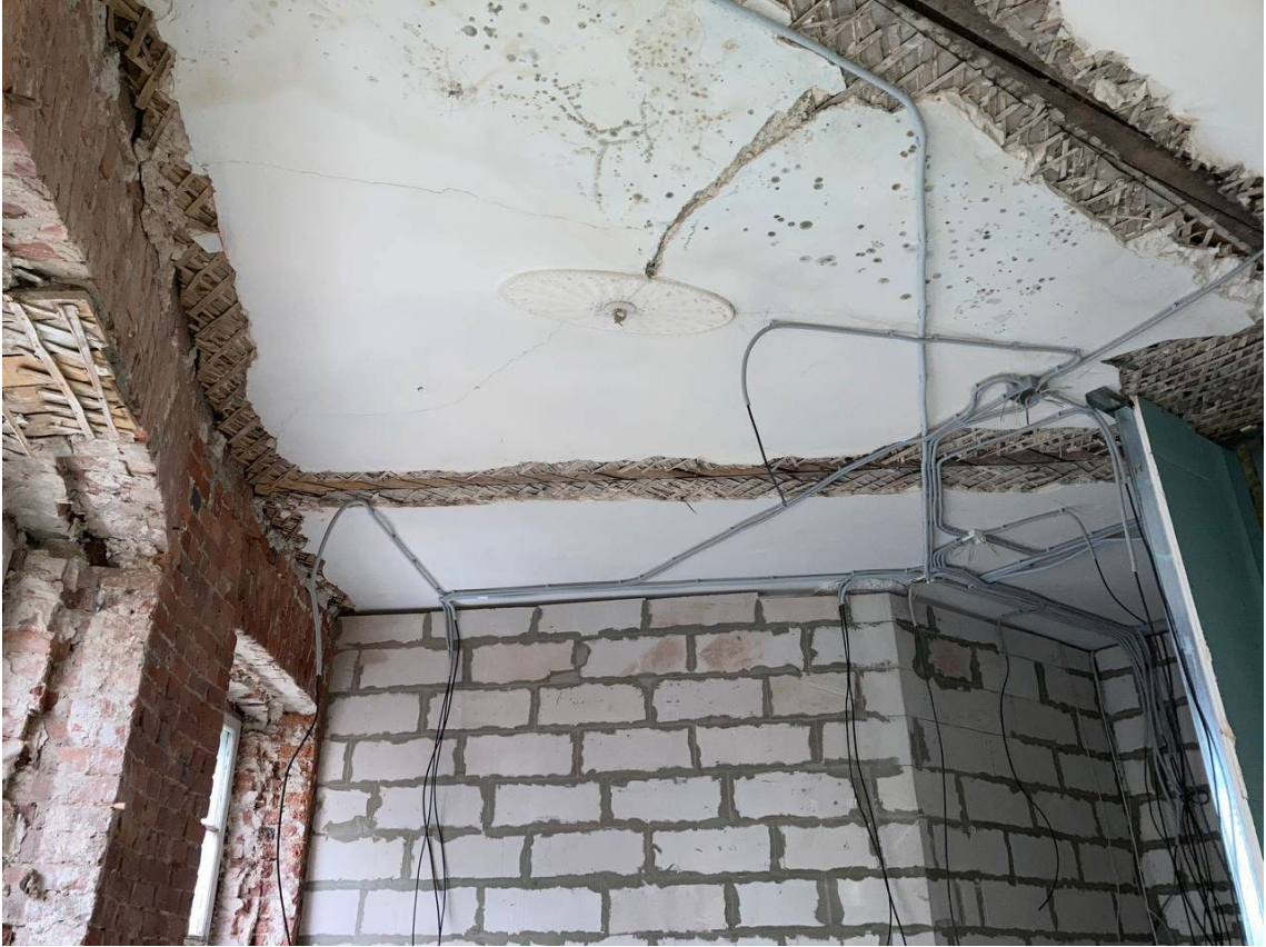
Фото 29. Помещение 6. Перегородка и фрагмент потолка.
