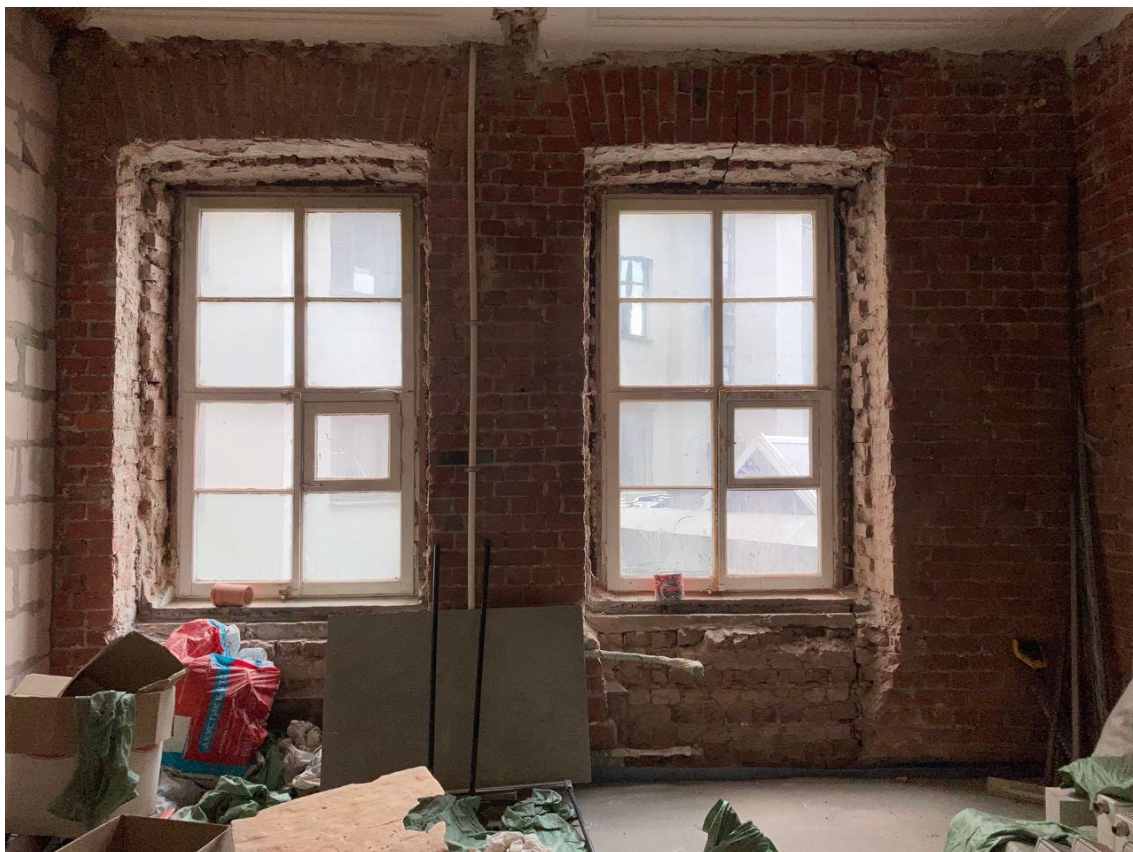
Фото 7. Помещение 1. Вид на стену с окнами.
