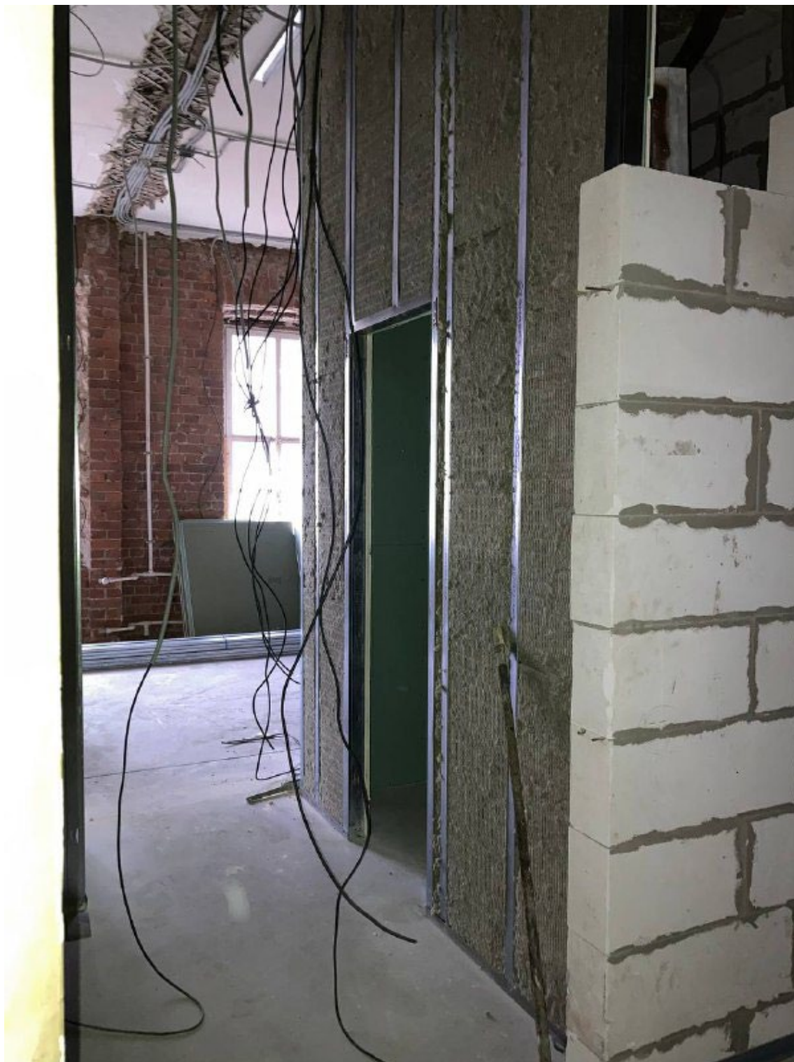
Фото 23. Помещение 5. Проход в помещение.
