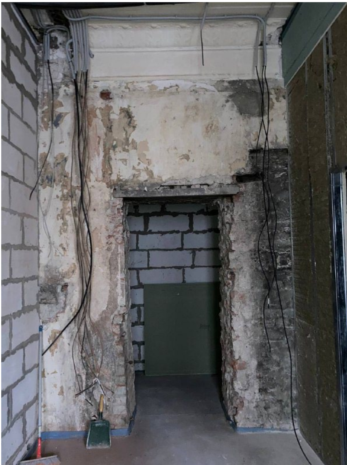
Фото 16. Помещение 3. Несущая стена. Выход из помещения.
