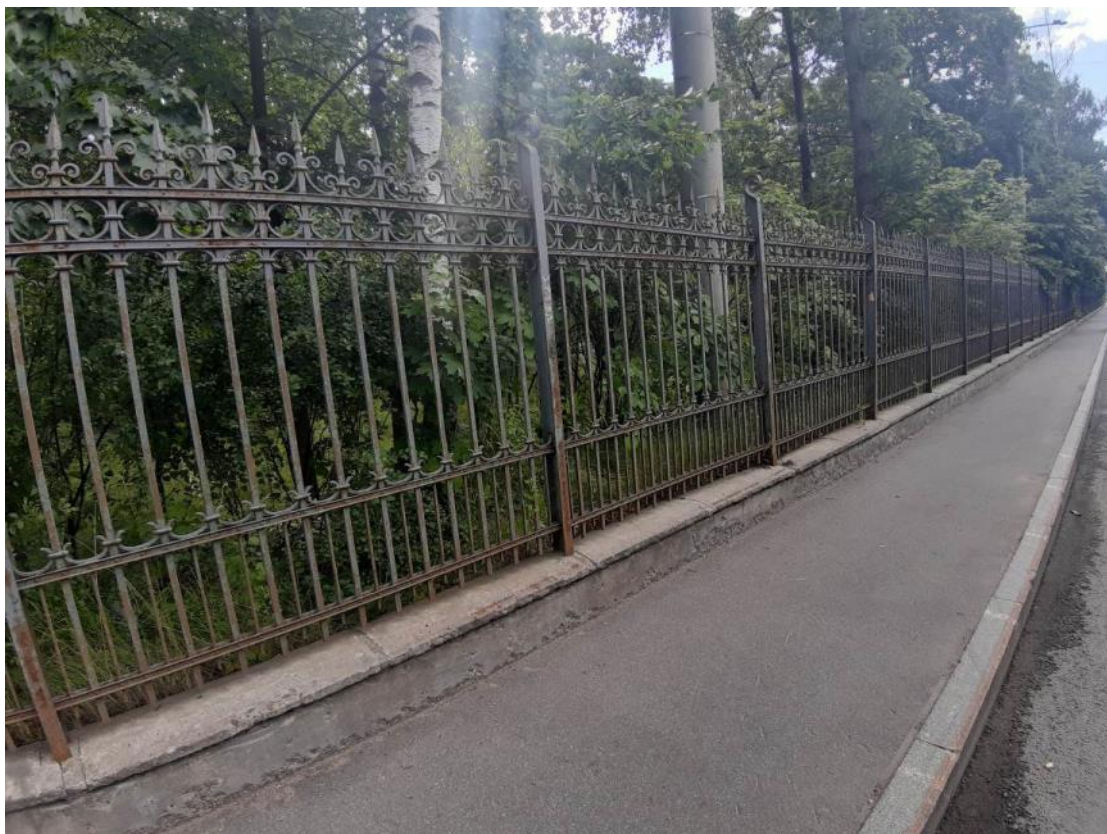
7. Парк. Ограда. Институт Санкт-Петербургский Политехнический императора Петра Великого. Вид на зону проектируемой прокладки кабельных трасс. Полетайкин В.В. 02.08.2022.
