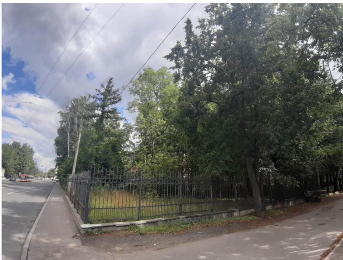
8. Парк. Ограда. Институт Санкт-Петербургский Политехнический императора Петра Великого. Вид на зону проектируемой прокладки кабельных трасс. Полетайкин В.В. 02.08.2022.
