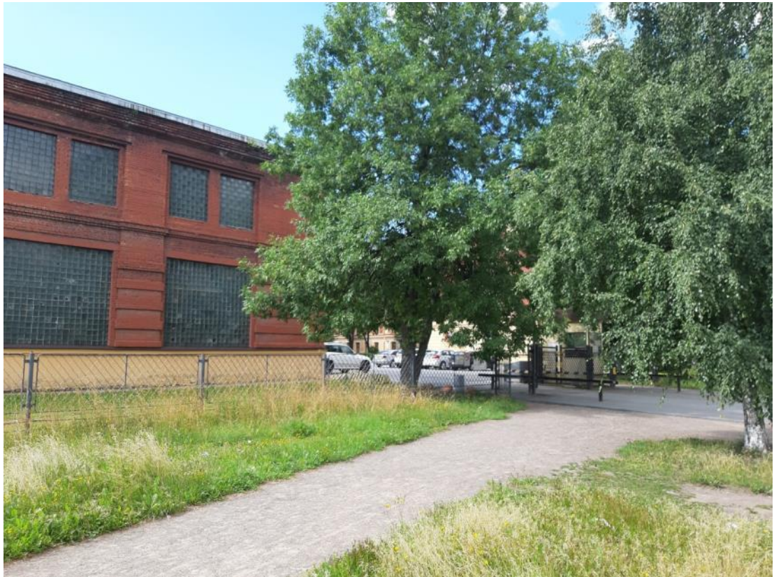
9. Институт Санкт-Петербургский Политехнический императора Петра Великого. Вид на зону проектируемой прокладки кабельных трасс. Полетайкин В.В. 02.08.2022.
