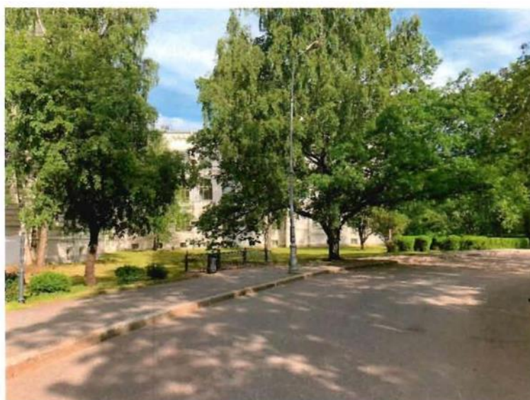
4. Центральная часть объекта культурного наследия.
