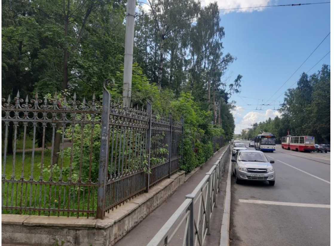
5. Парк. Ограда. Институт Санкт-Петербургский Политехнический императора Петра Великого. Вид на зону проектируемой прокладки кабельных трасс. Полетайкин В.В. 02.08.2022.
