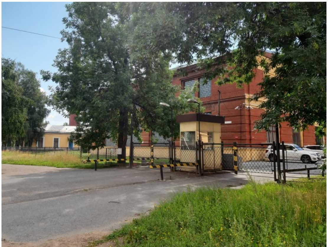
10. Институт Санкт-Петербургский Политехнический императора Петра Великого. Вид на зону проектируемой прокладки кабельных трасс. Полетайкин В.В. 02.08.2022.
