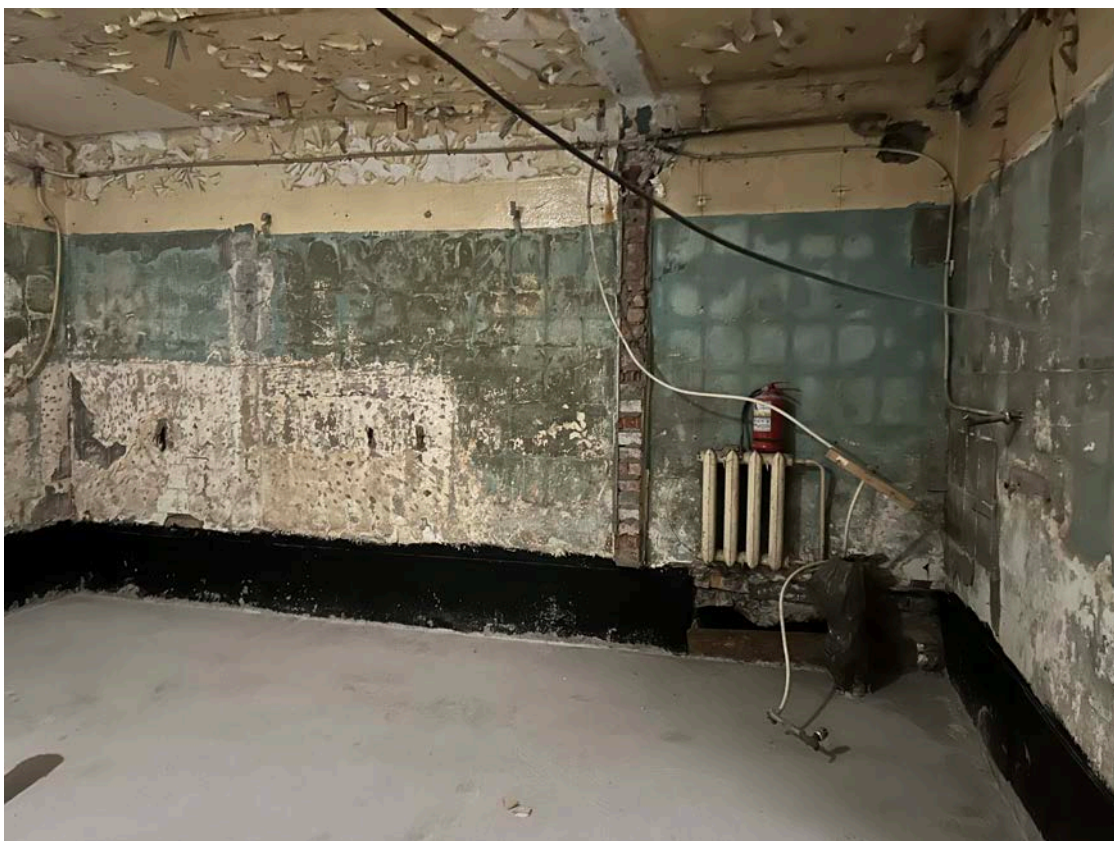
Фото 15. Интерьер объекта культурного наследия регионального значения «Дом просветительских учреждений в память 19 февраля 1861 года», подвальный этаж
