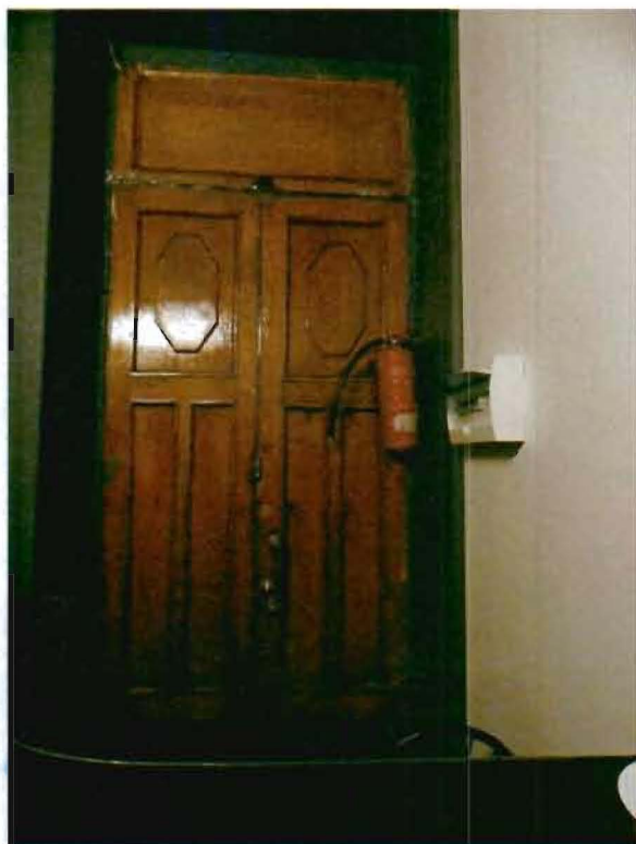
11. Дверные заполнения помещений.
