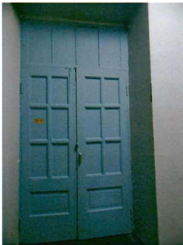
12. Дверные заполнения помещений.
