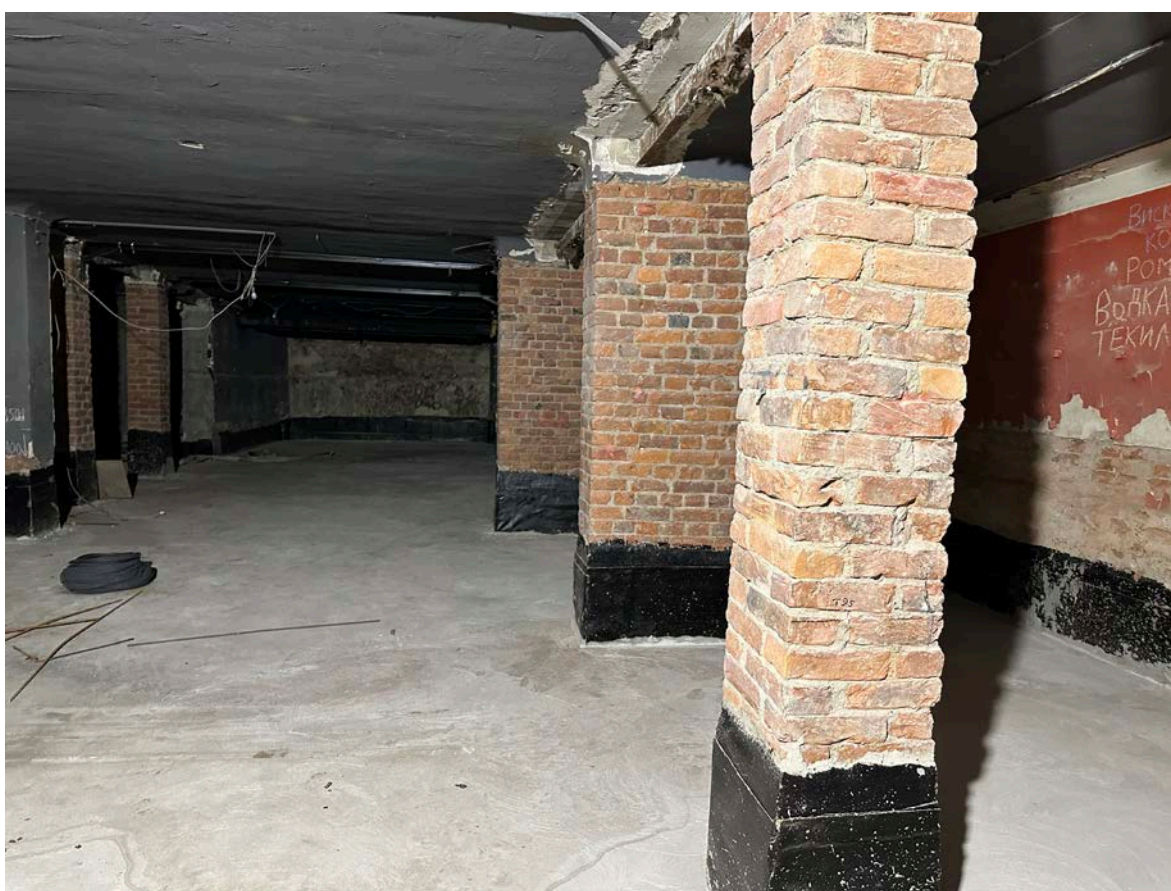
Фото 14. Интерьер объекта культурного наследия регионального значения «Дом просветительских учреждений в память 19 февраля 1861 года», подвальный этаж
