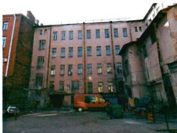
6. Северный дворовой фасад.
