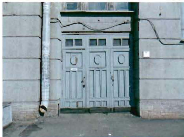
2. Фрагмент южного фасада.
