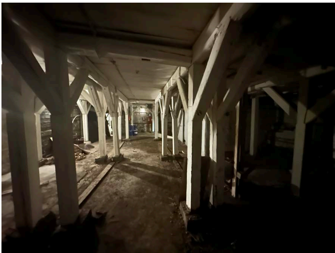
Фото 20. Интерьер объекта культурного наследия регионального значения «Дом просветительских учреждений в память 19 февраля 1861 года», подвальный этаж
