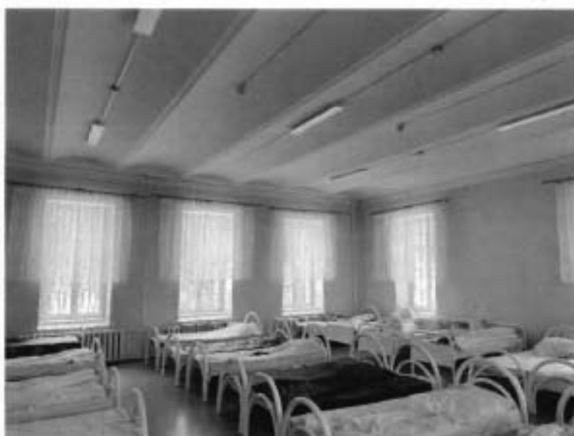
17. Пом. 3-Н ч.п. 11. Восточная часть помещения. Своды.
