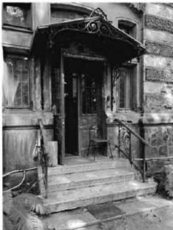
6. Южный фасад. Крыльцо.
