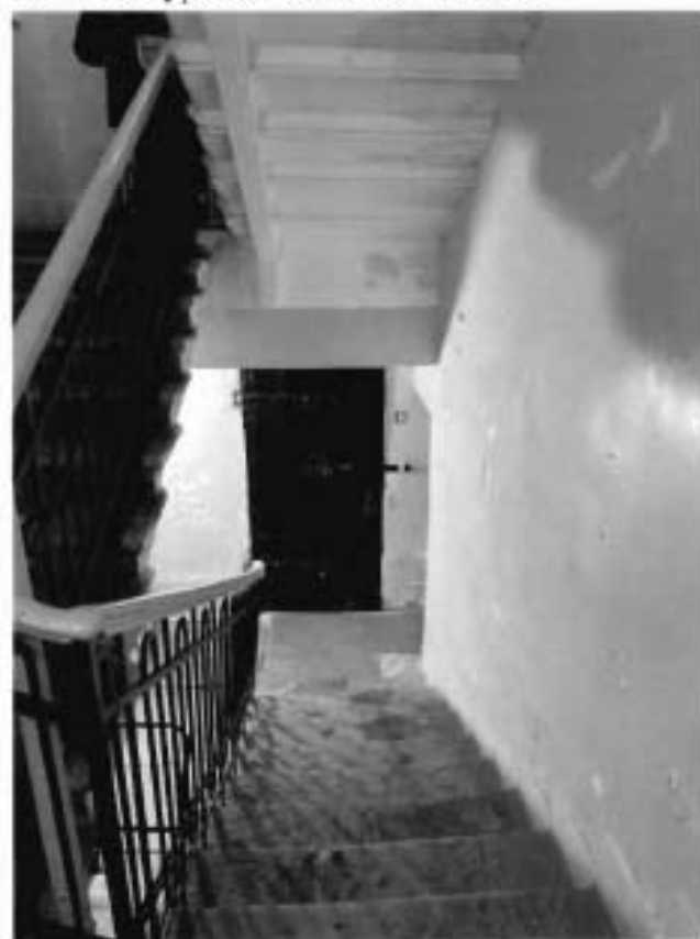
19. 1ЛК в уровне цокольного этажа.
