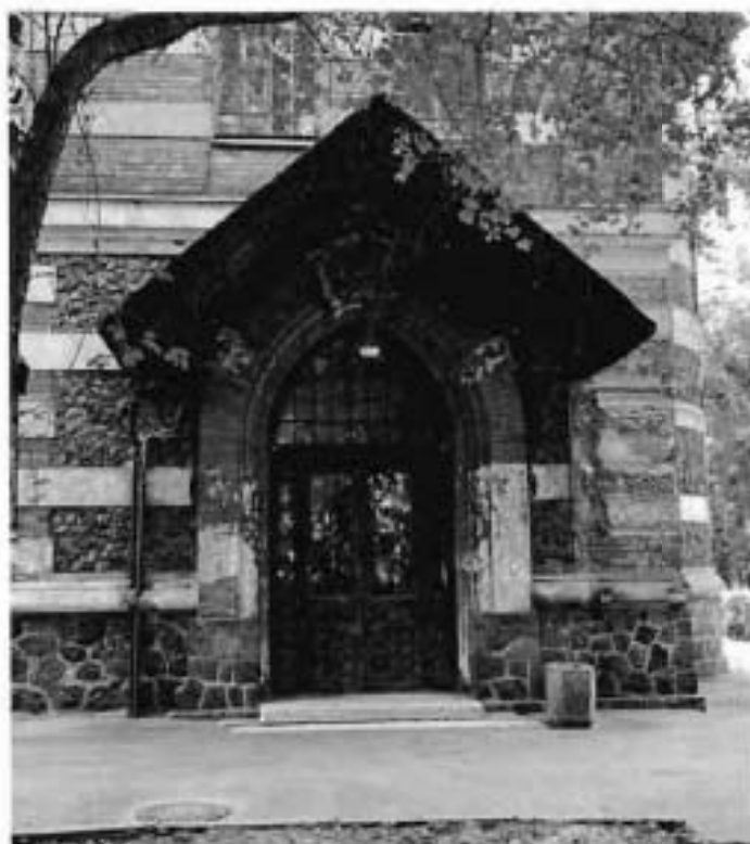
5. Северный фасад. Входной портал.
