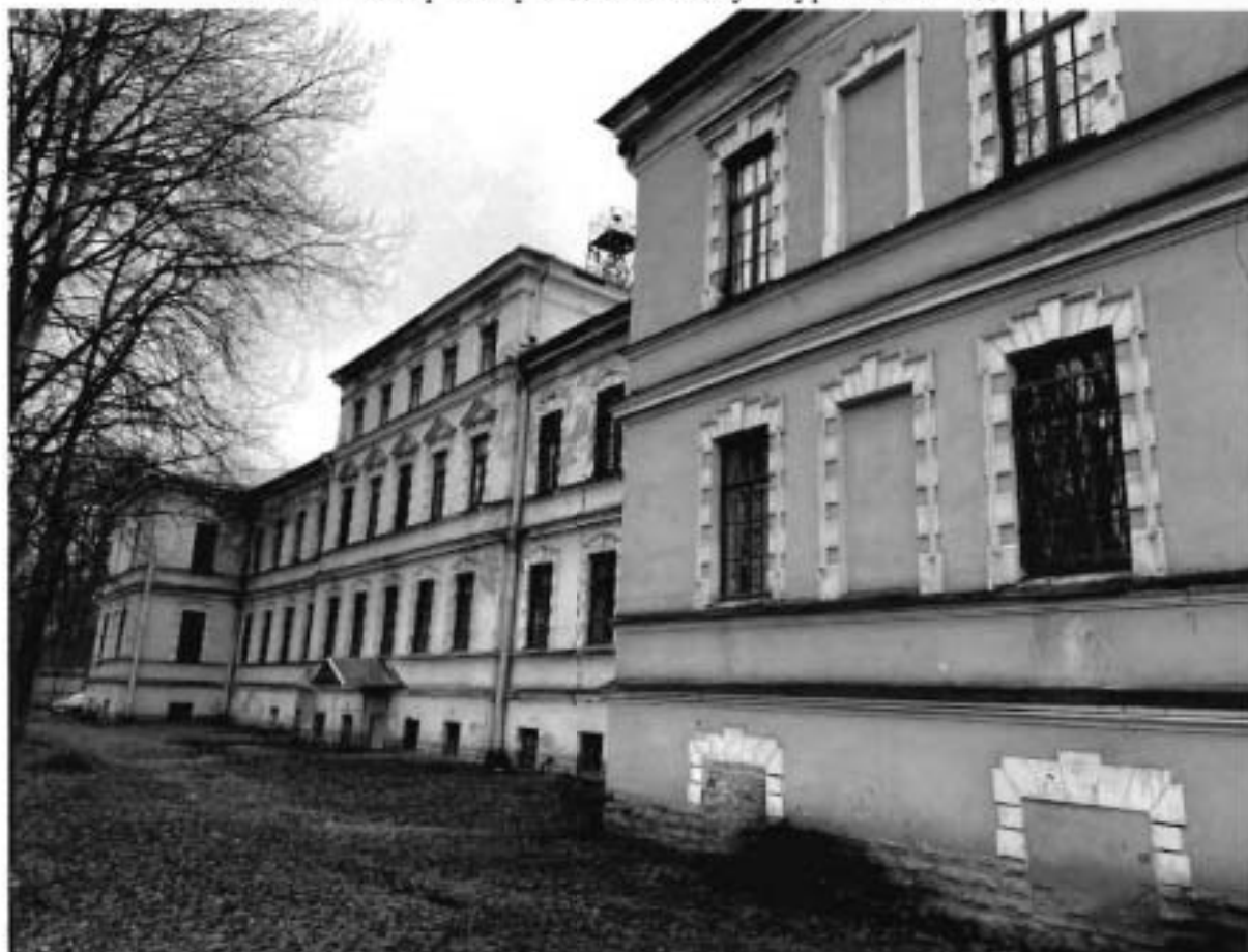
5. Вид на северный фасад объекта культурного наследия.
