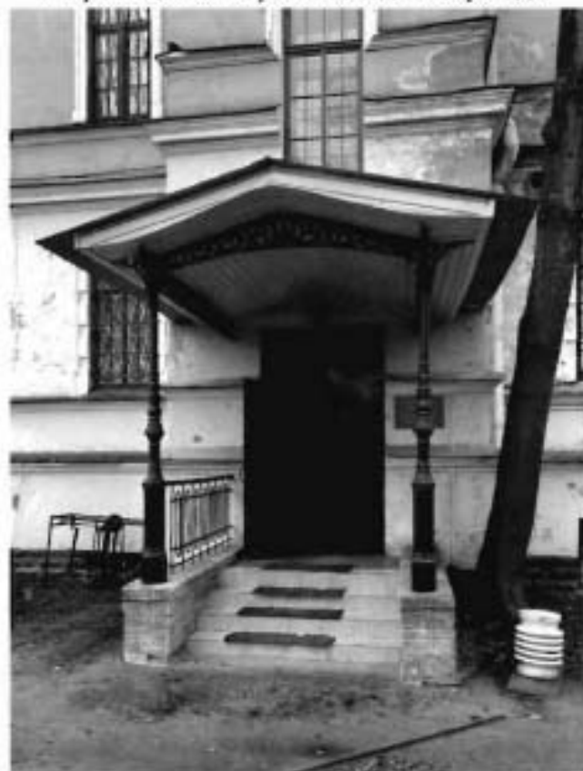
7. Крыльцо со стороны западного фасада.
