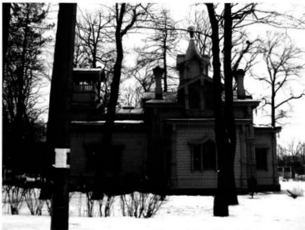
Фото 4. «Церковь св. целителя Пантелеймона», Южный фасад.
