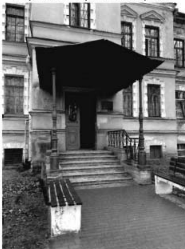
6. Крыльцо со стороны южного фасада.
