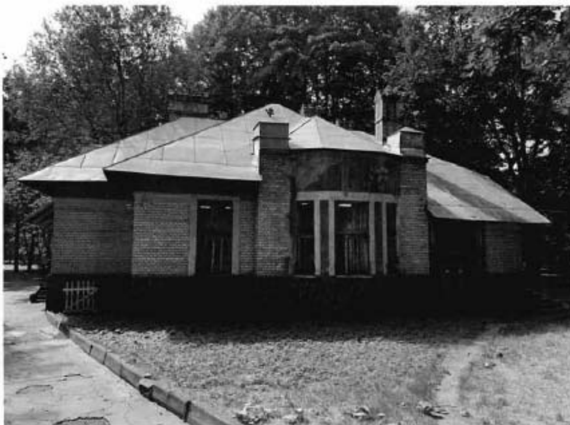
4. Вид на северный фасад объекта культурного наследия.
